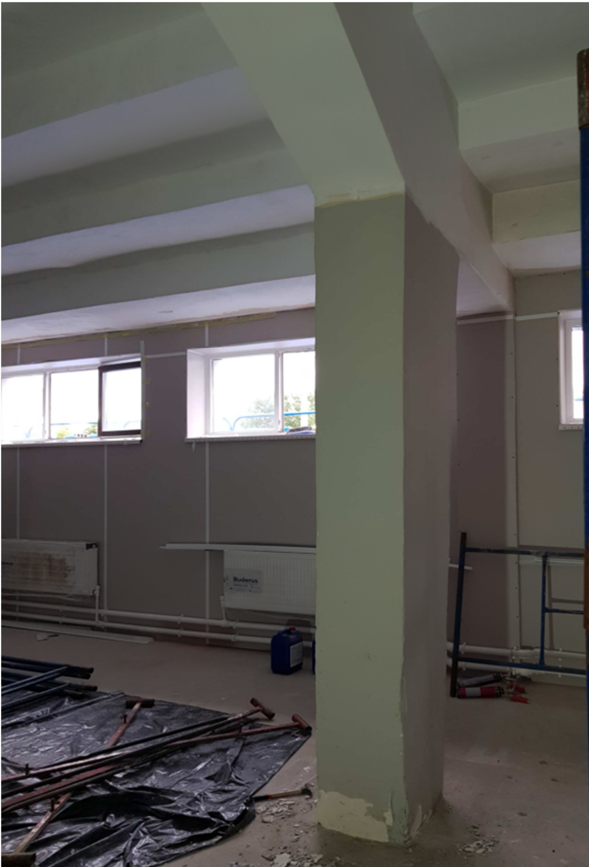
24. Подтрибунные помещения. Вид конструкций.
