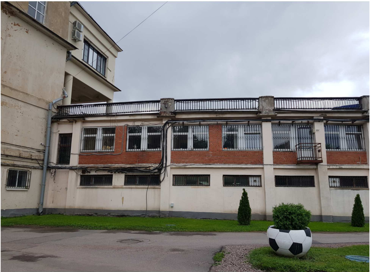
12. Фрагмент северного фасада северной части здания.
