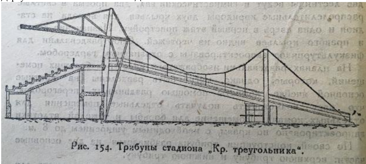
22. Проект стадиона «Красный треугольник». Разрез трибуны и лестницы-трапа. 1929 – 1932. (Зверинцев С.П. Физкультурные сооружения. Л.-М. 1932).
