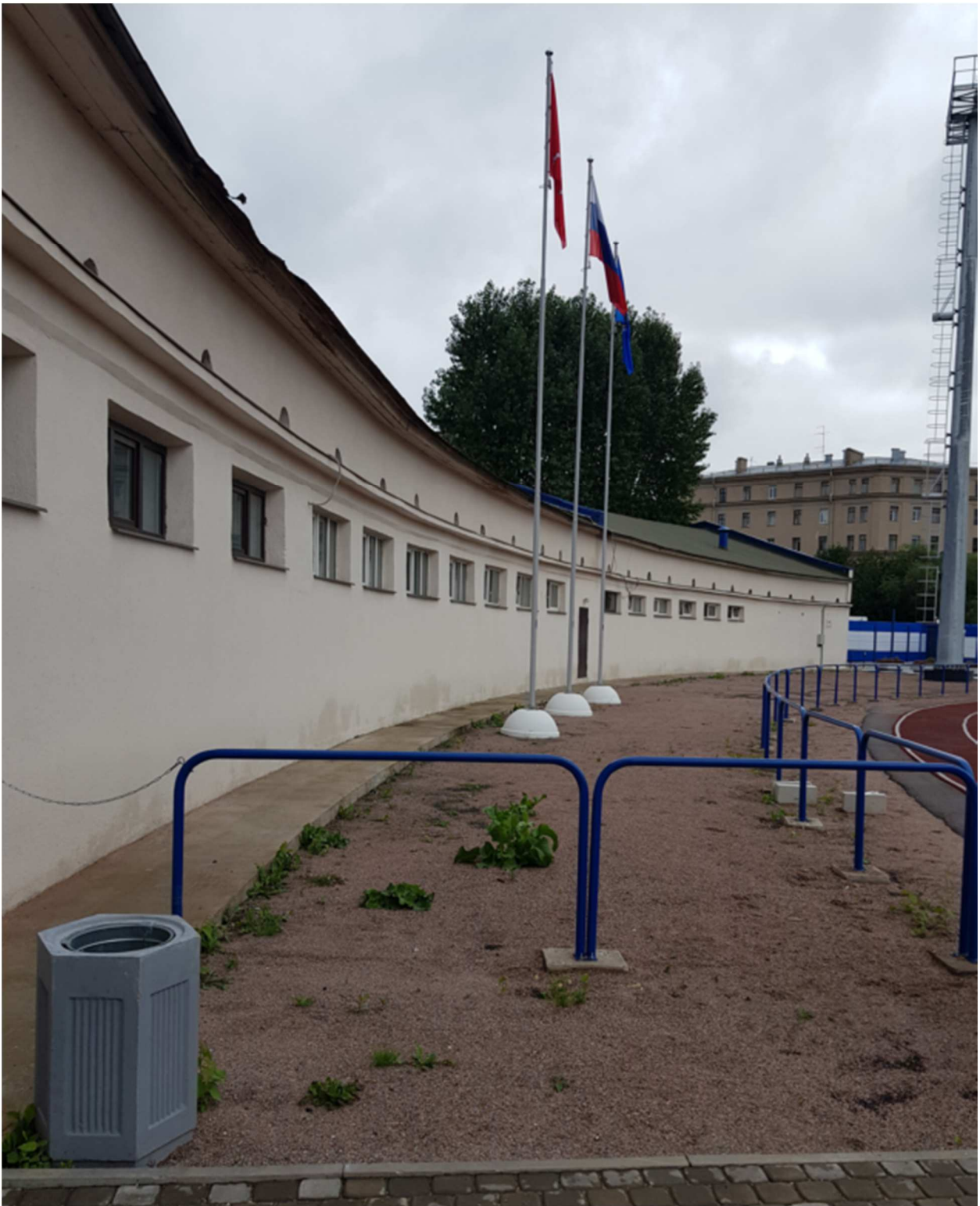
9. Северо-восточная часть здания. Фрагмент южного фасада.
