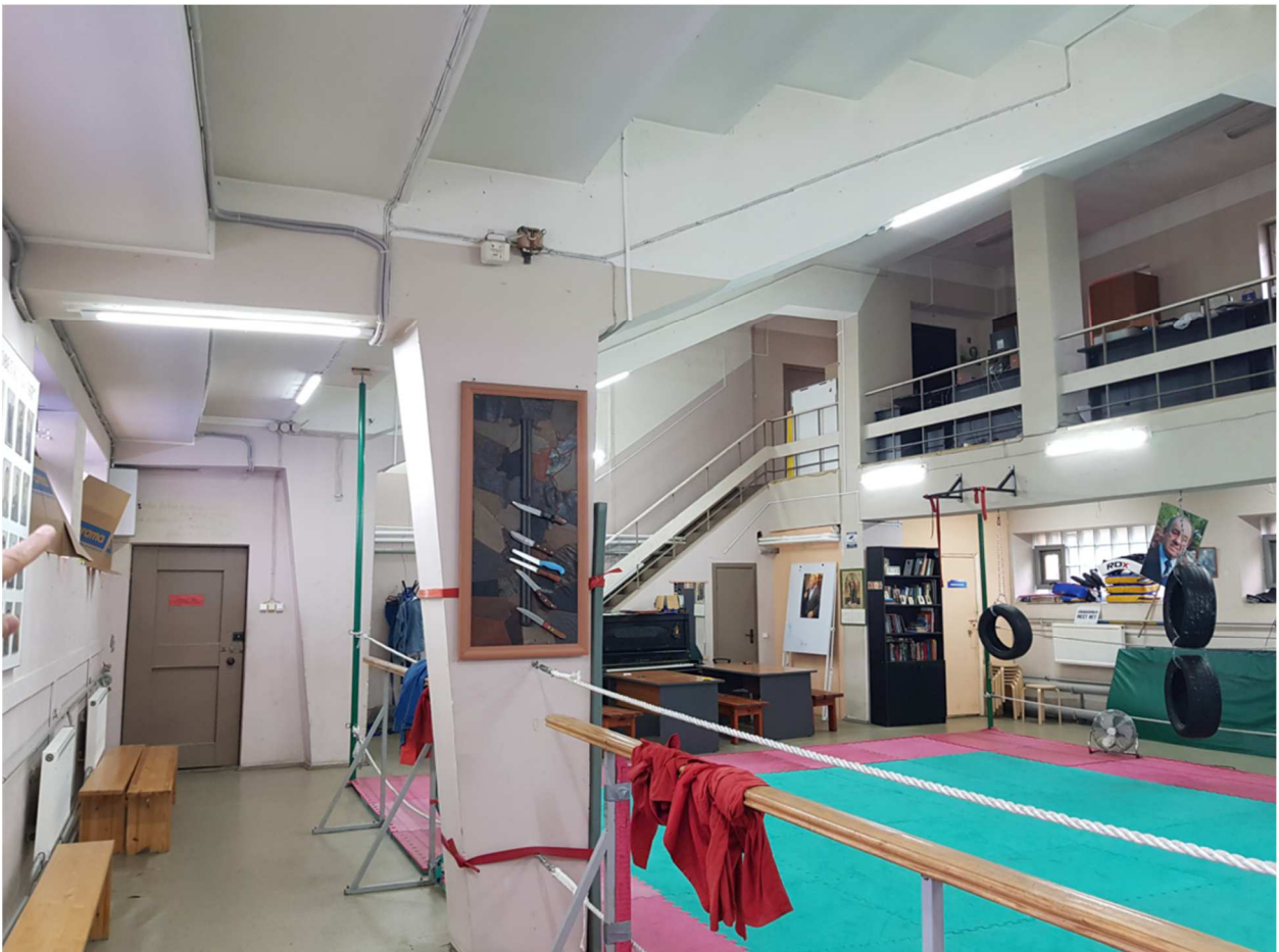
25. Использование подтрибунных помещений (видны оригинальные конструкции потолочного перекрытия).
