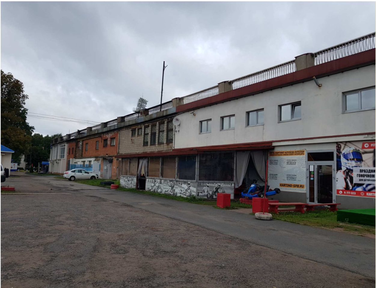
17. Фрагмент западного фасада.
