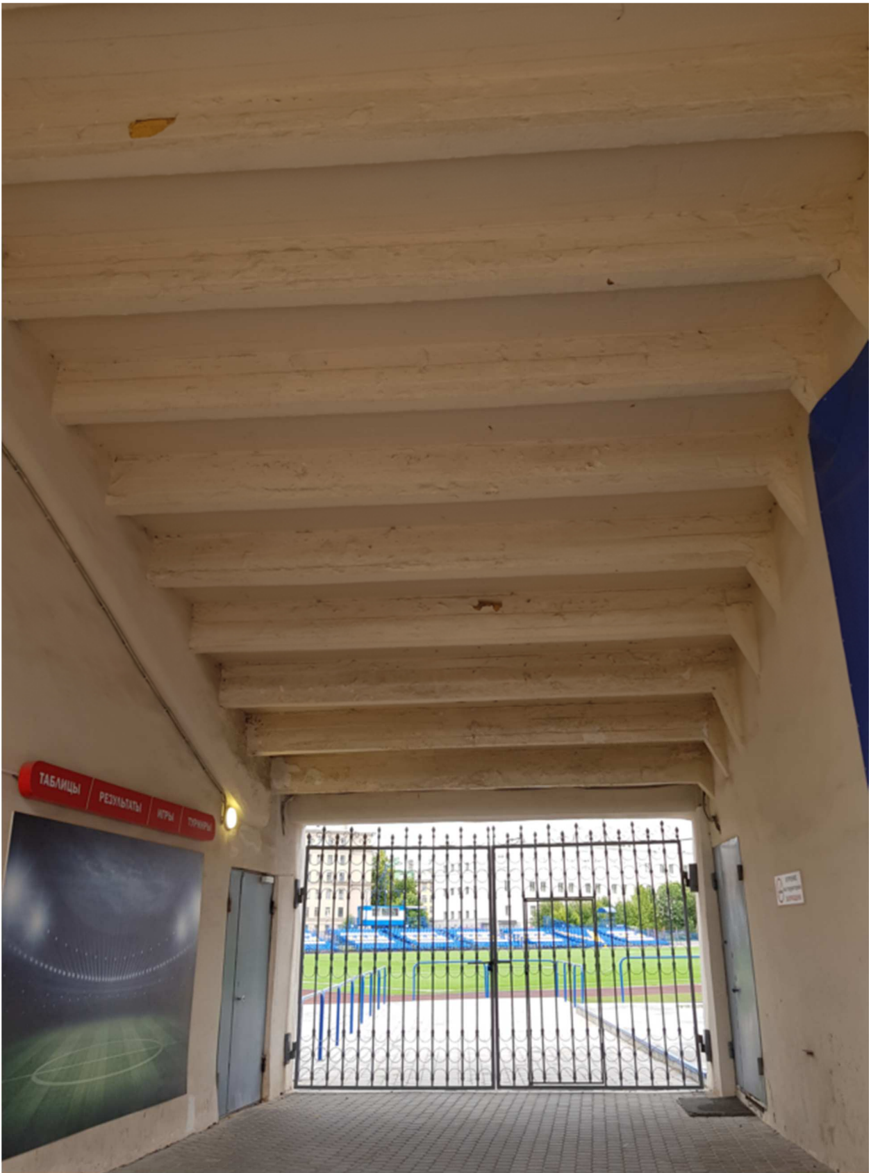
14. Арка с выходом на поле в северной части здания.
