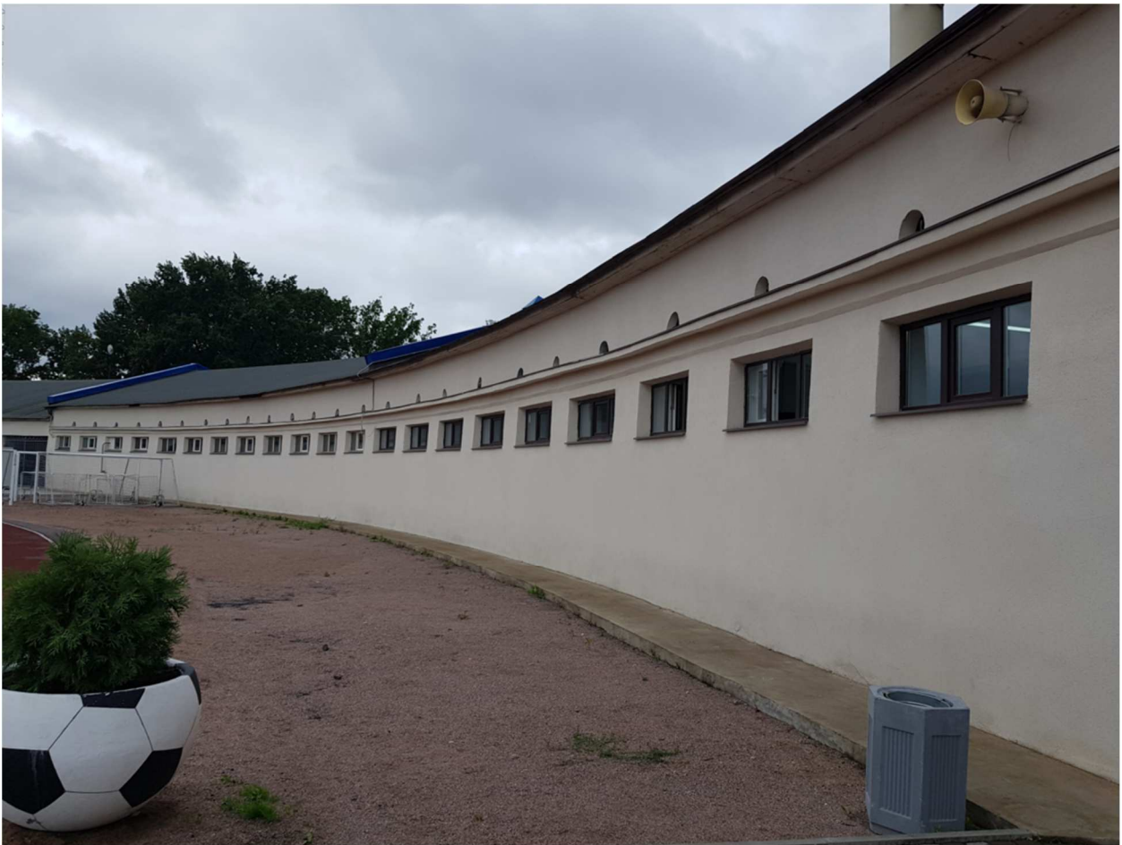
10. Северо-западная часть здания. Фрагмент южного фасада.
