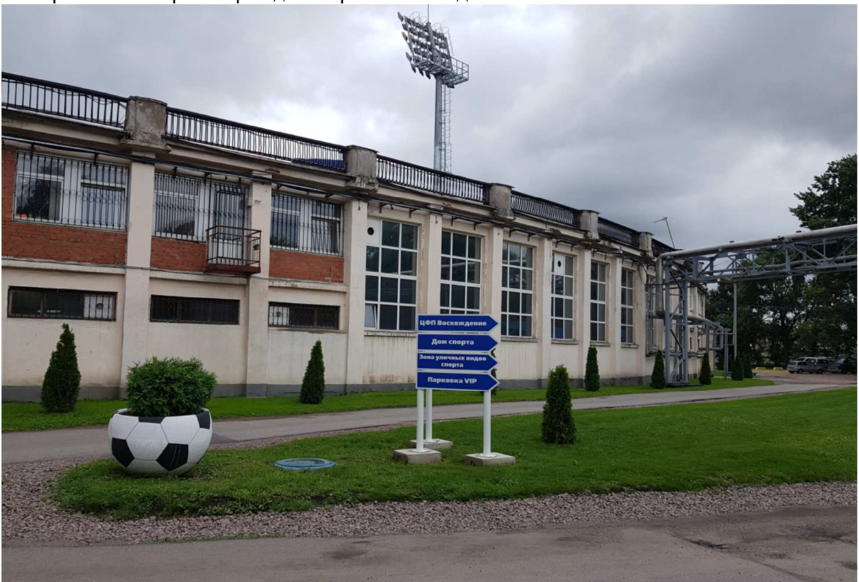
13. Фрагмент северного фасада северной части здания.
