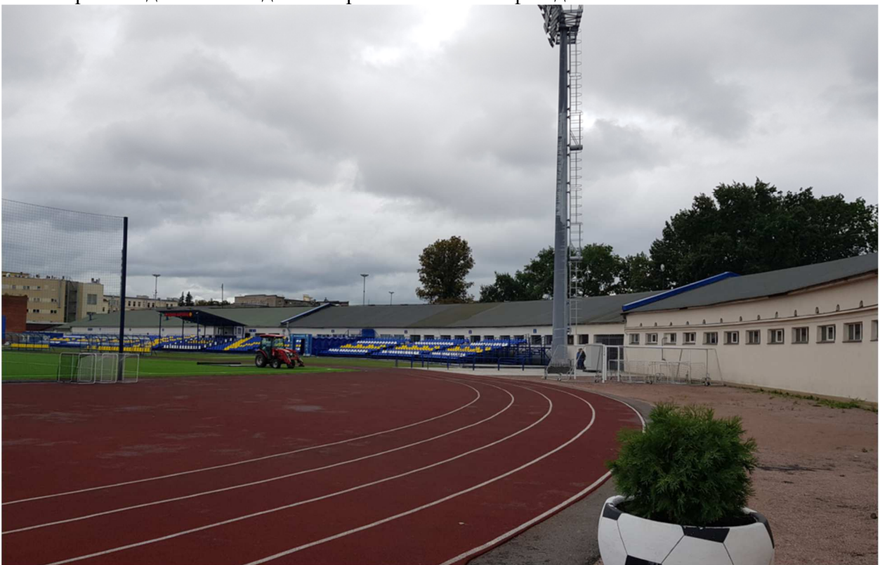
11. Общий вид северо-западной и западной частей здания.
