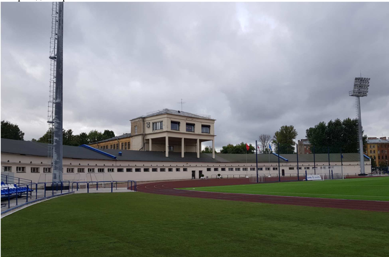
7. Вид на здание стадиона «Кировец» с юго-запада.
