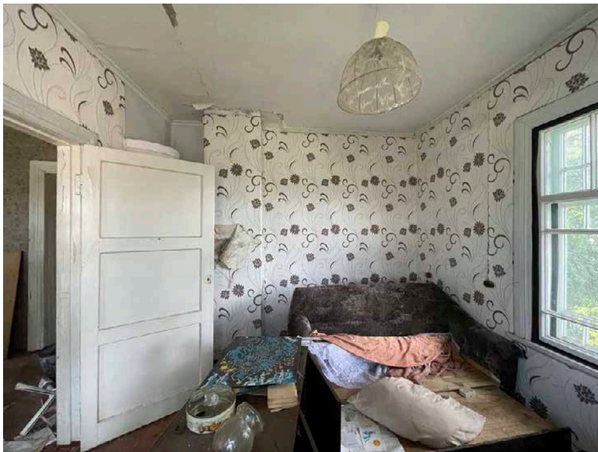
40. Фрагмент интерьера второго этажа
