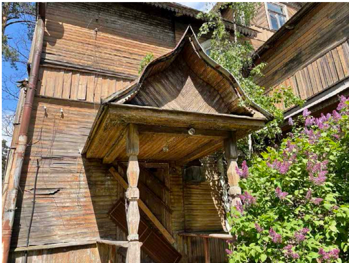
3. Вид на крыльцо
