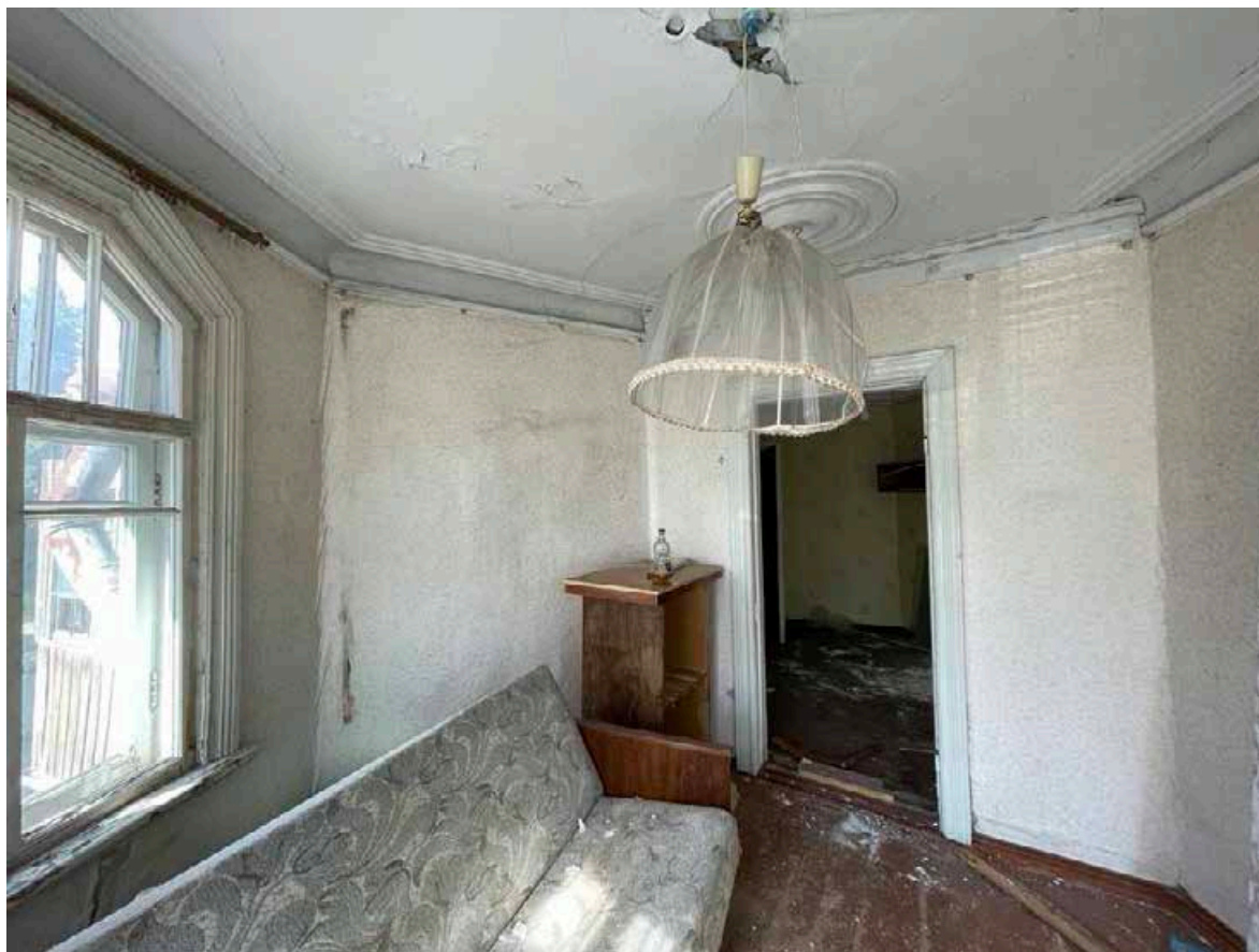
32. Фрагмент интерьера второго этажа
