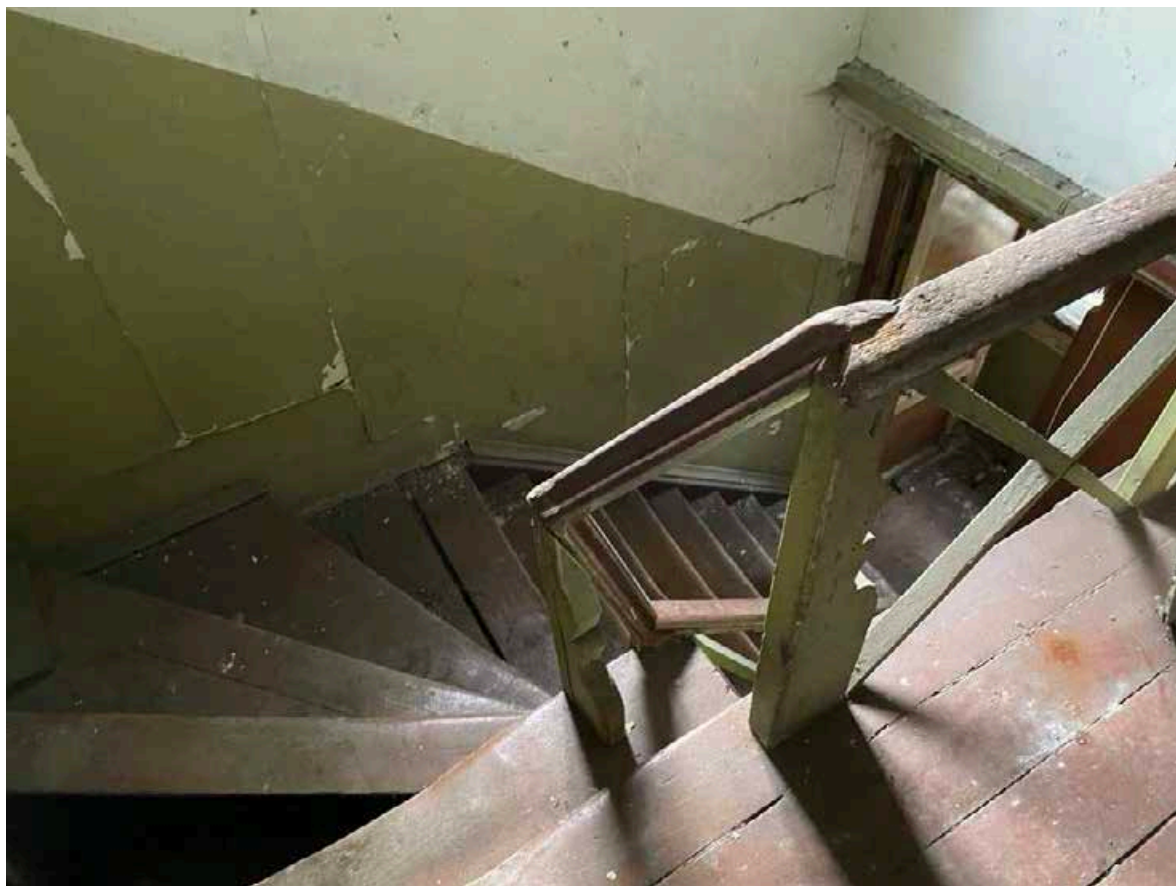
24. Фрагмент интерьера второго этажа
