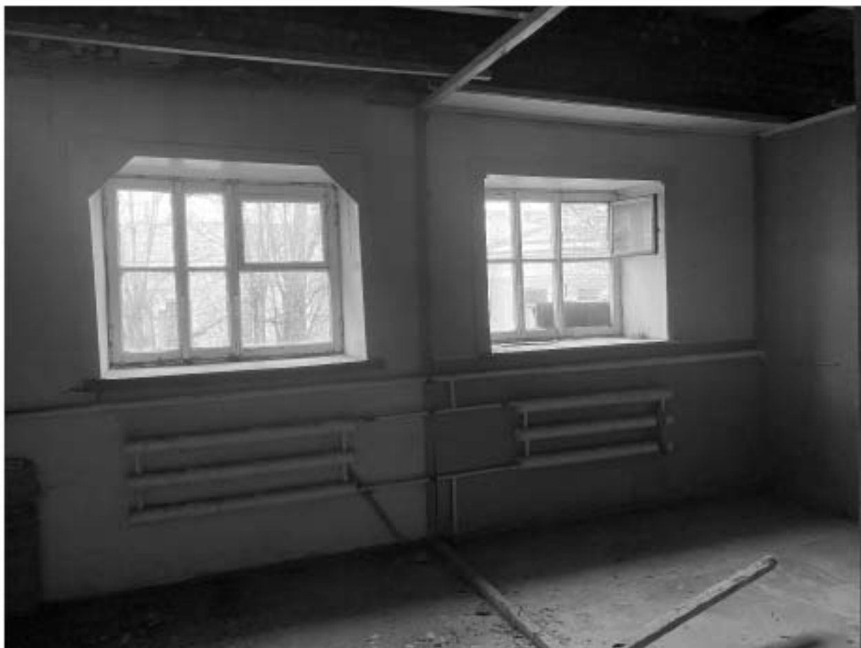
99. Помещение на четвёртом этаже. Фрагмент интерьера;
