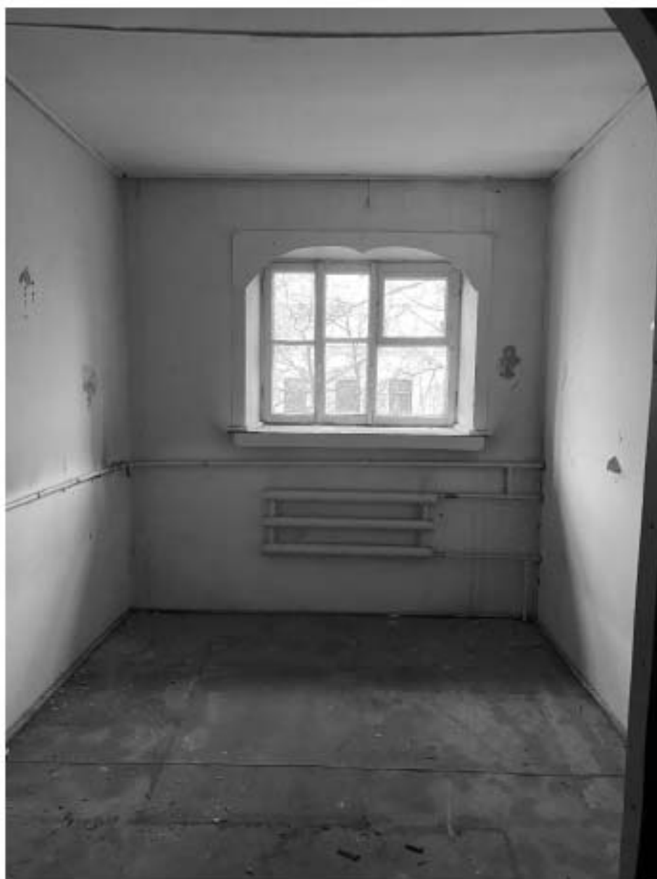
96. Помещение на четвёртом этаже. Фрагмент интерьера;
