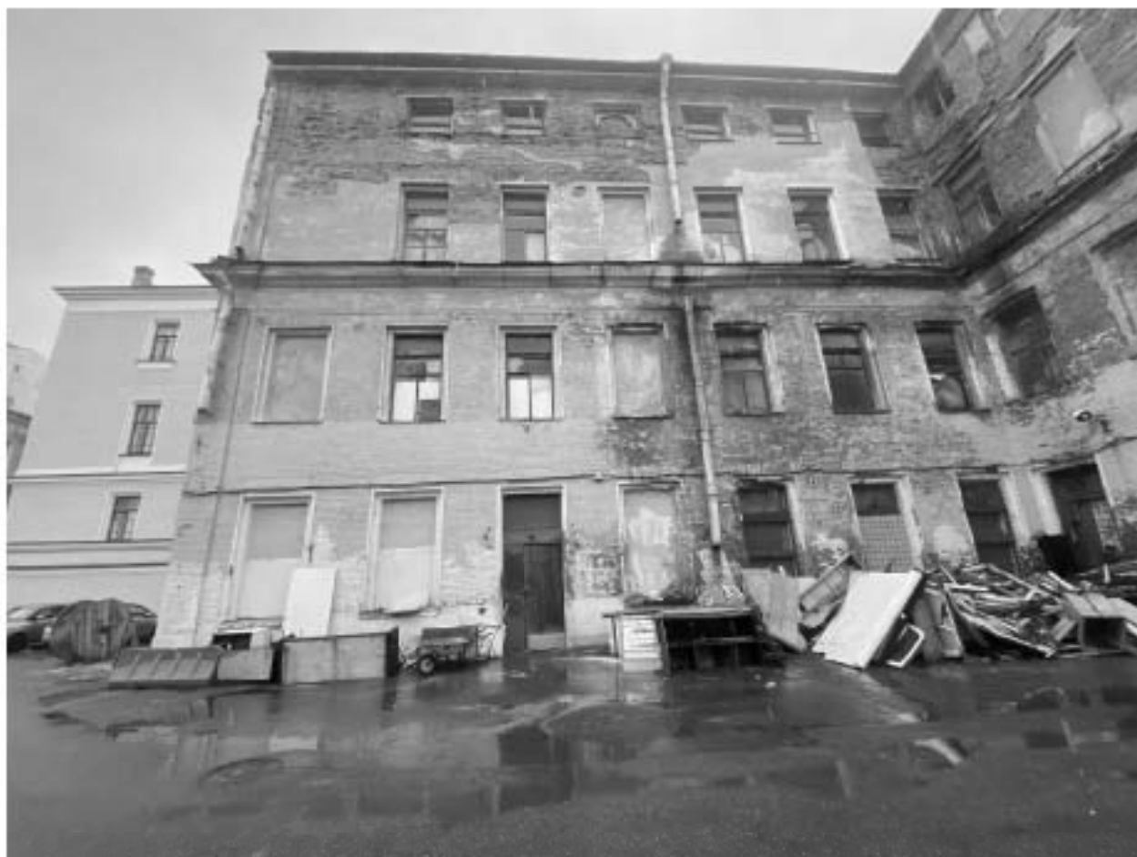
1. Вид на восточный фасад здания;
