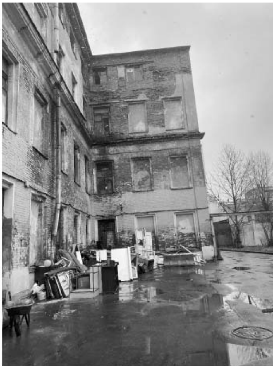
4. Вид на юго-восточный фасад здания;
