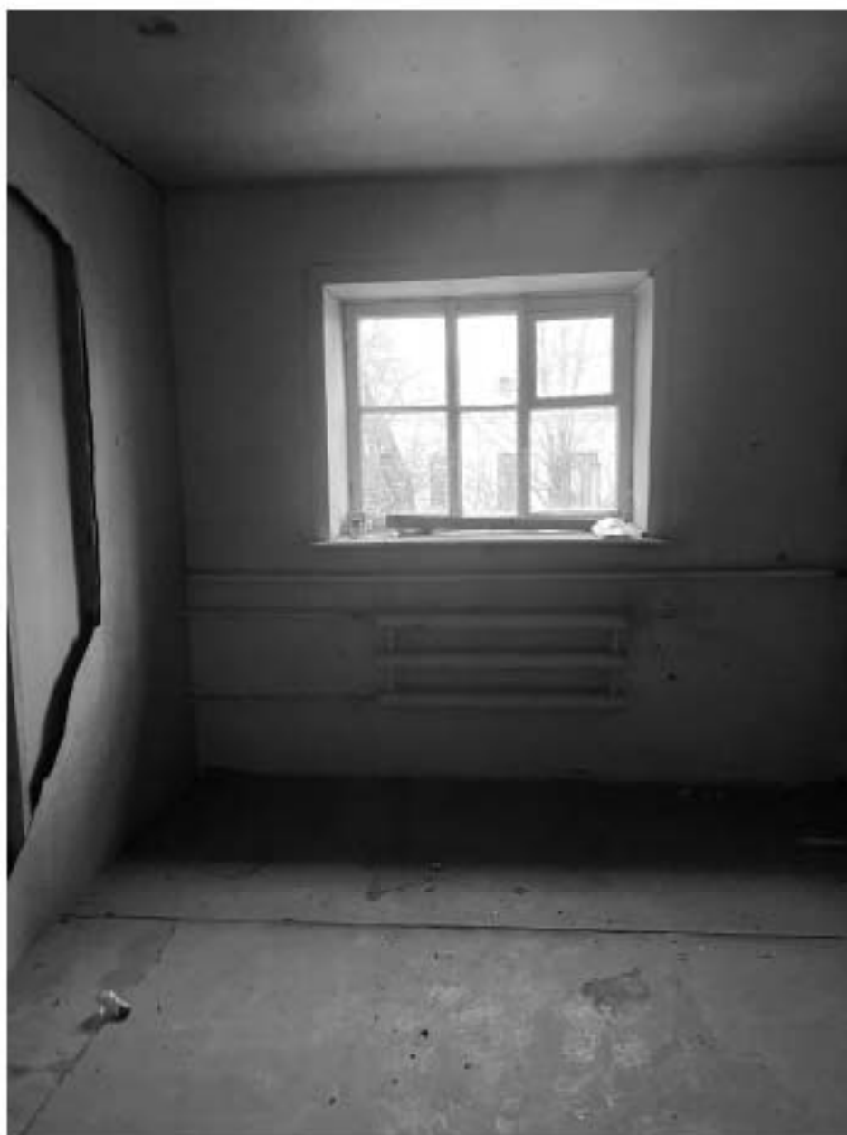
98. Помещение на четвёртом этаже. Фрагмент интерьера;
