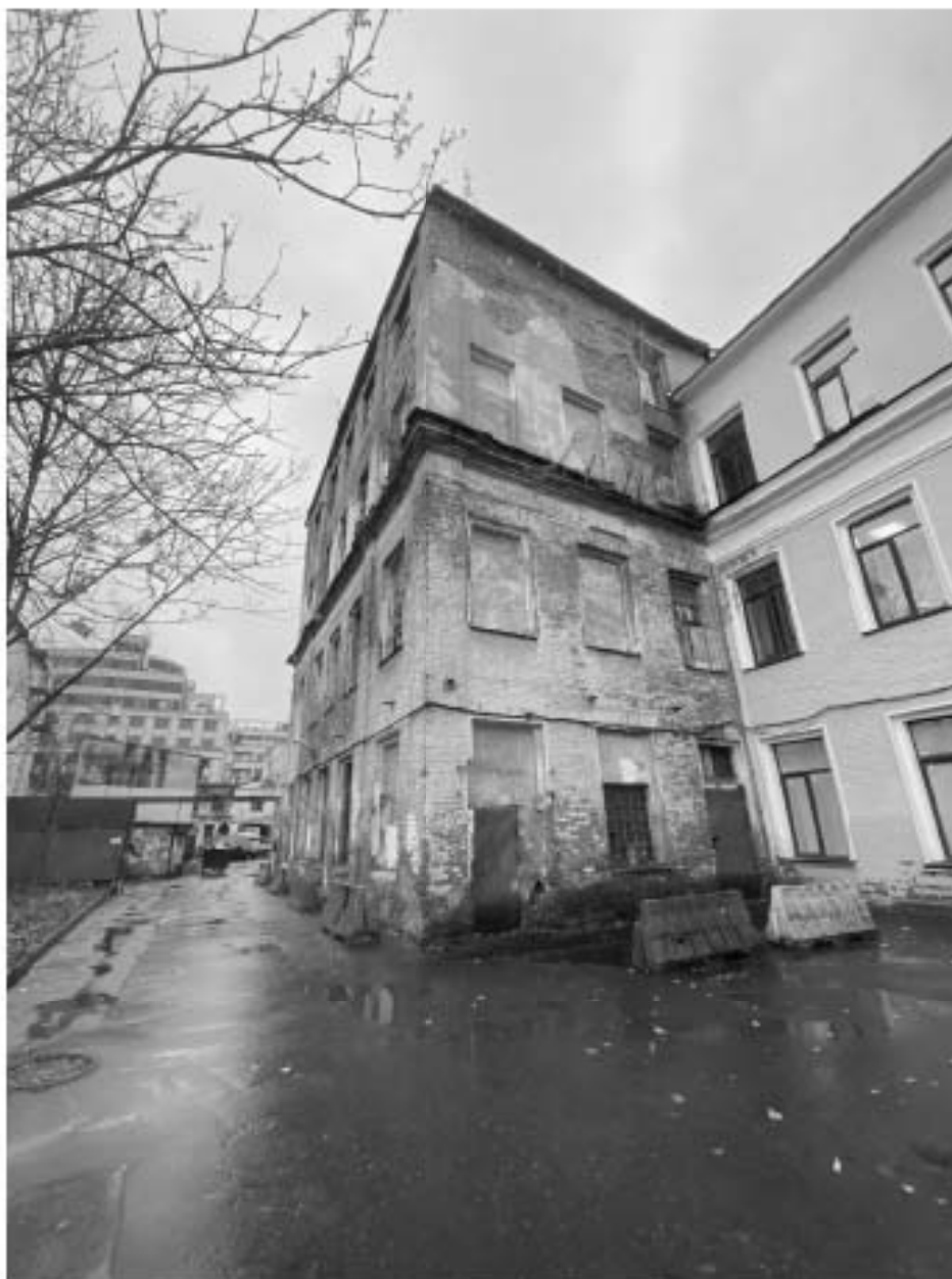
7. Общий вид на северный фасад здания;
