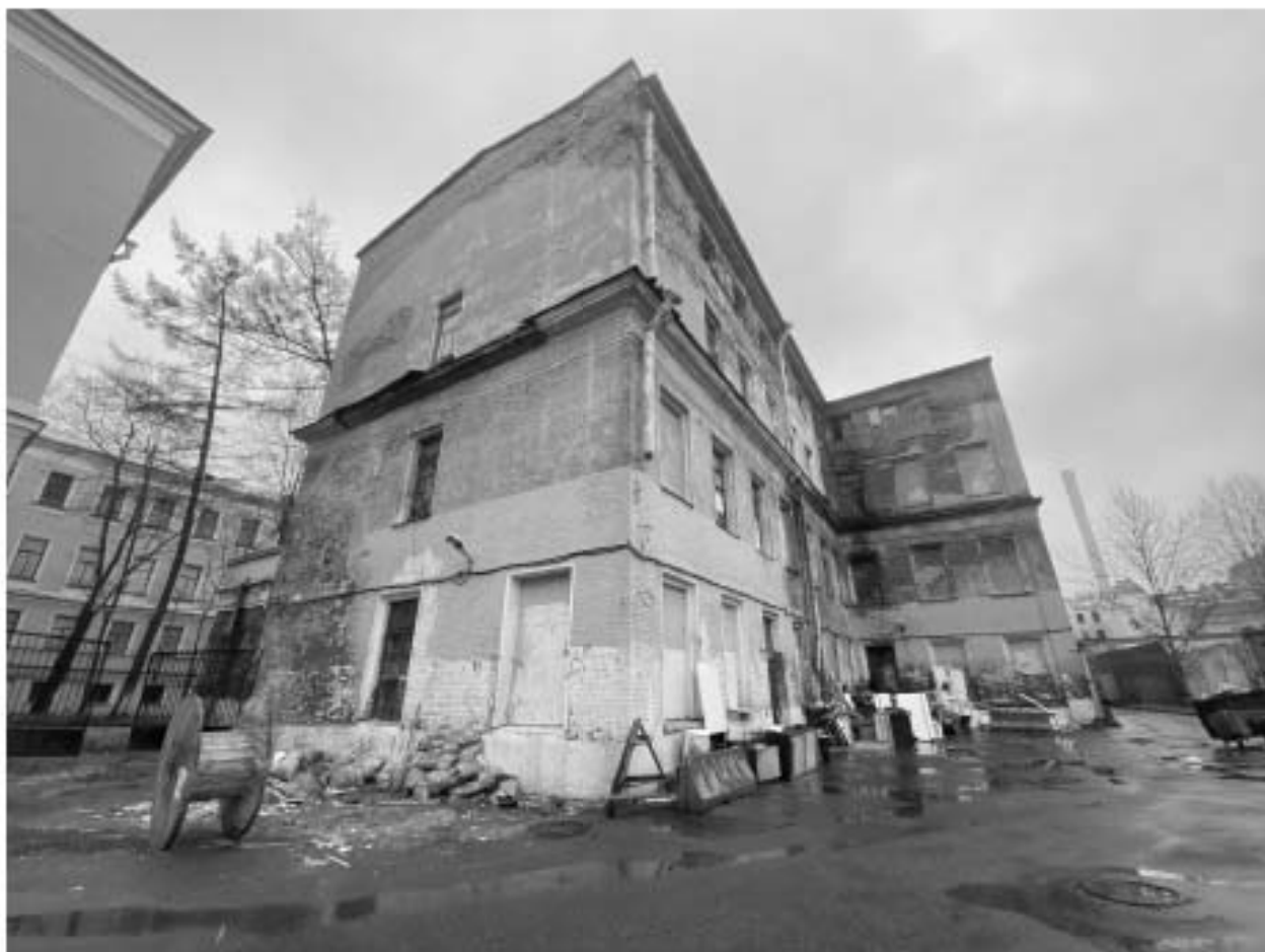
5. Общий вид на юго-восточный фасад здания,
