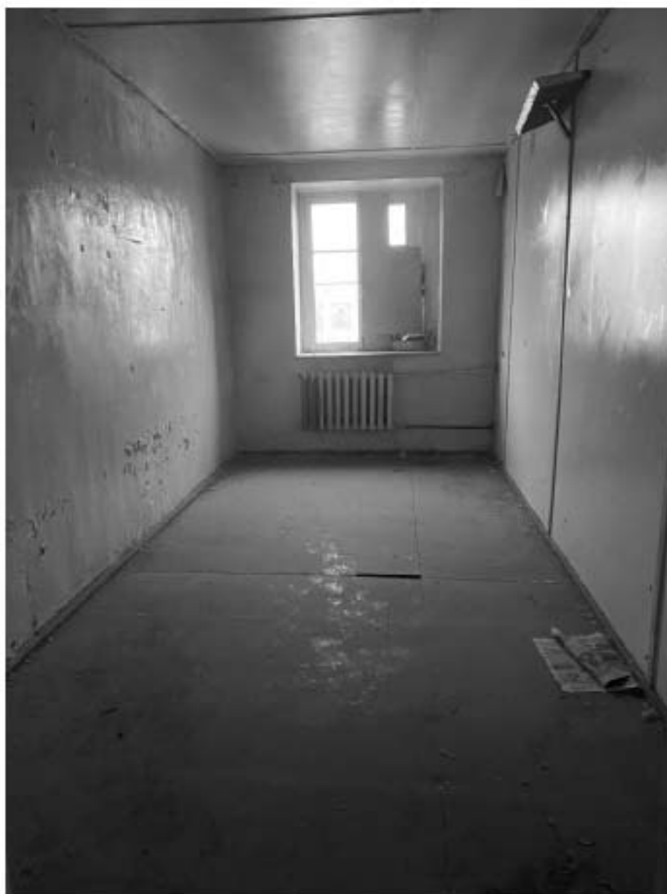
94. Помещение на четвёртом этаже. Фрагмент интерьера;
