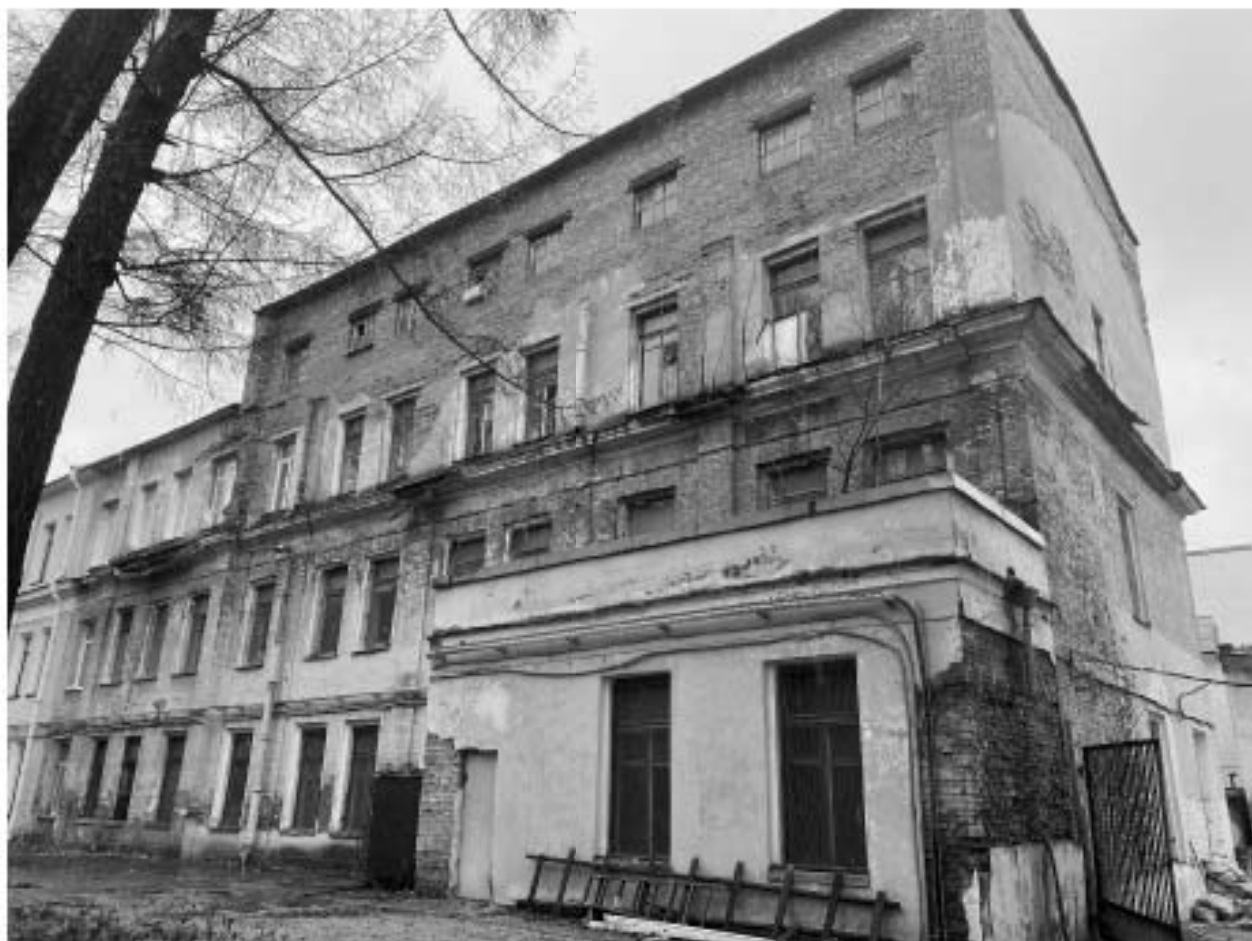
6. Общий вид на западный фасад здания,
