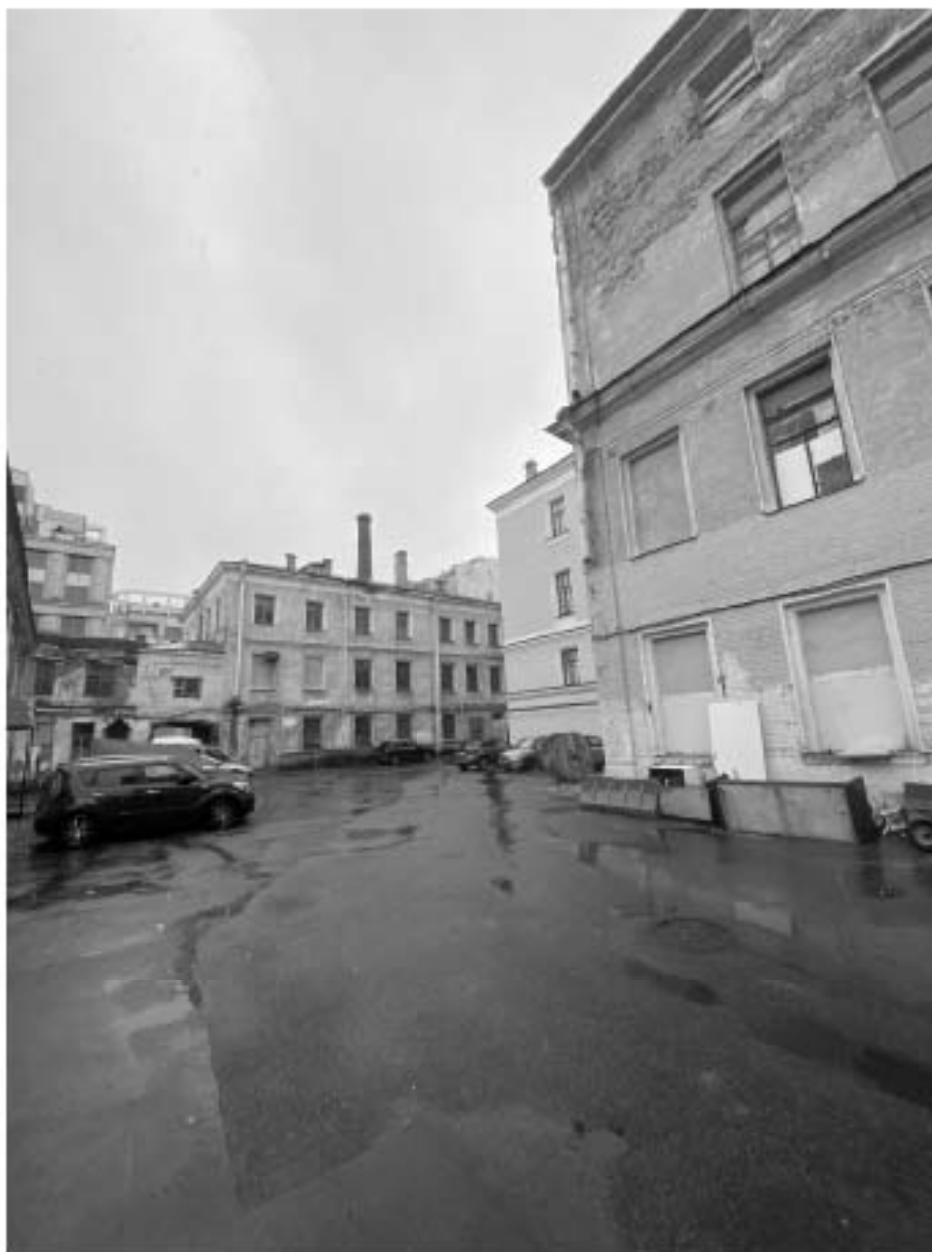
3. Вид на восточный фасад здания.
