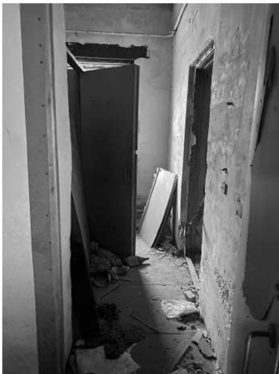
86. Помещение на четвёртом этаже. Фрагмент интерьера;
