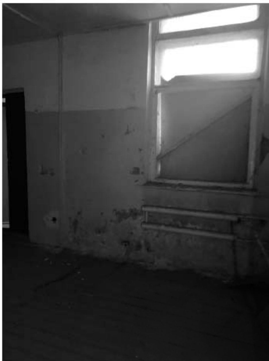
78. Фрагмент интерьера коридора на третьем этаже;
