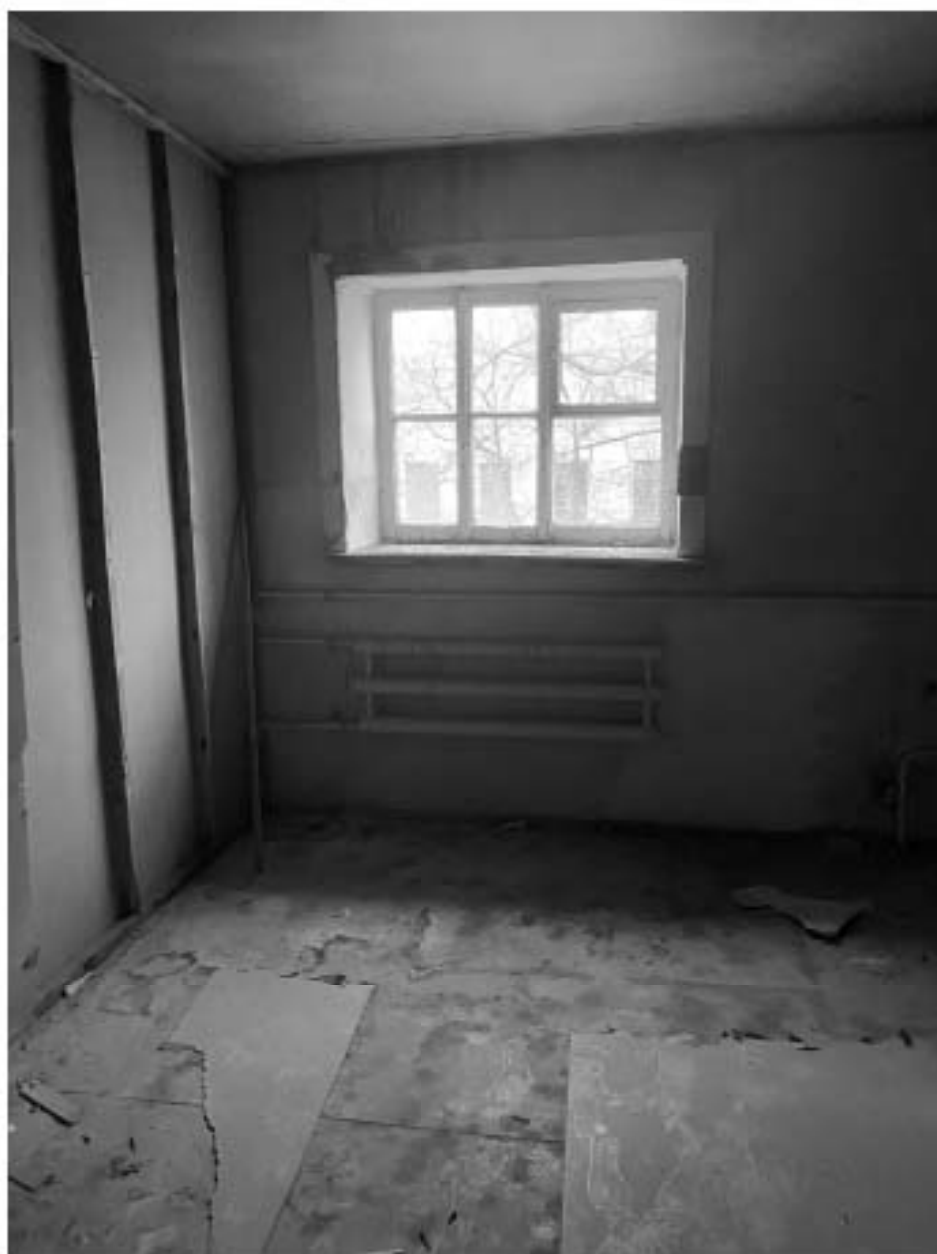
97. Помещение на четвёртом этаже. Фрагмент интерьера;
