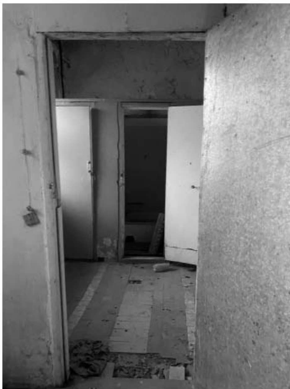
88. Помещение на четвёртом этаже. Фрагмент интерьера;
