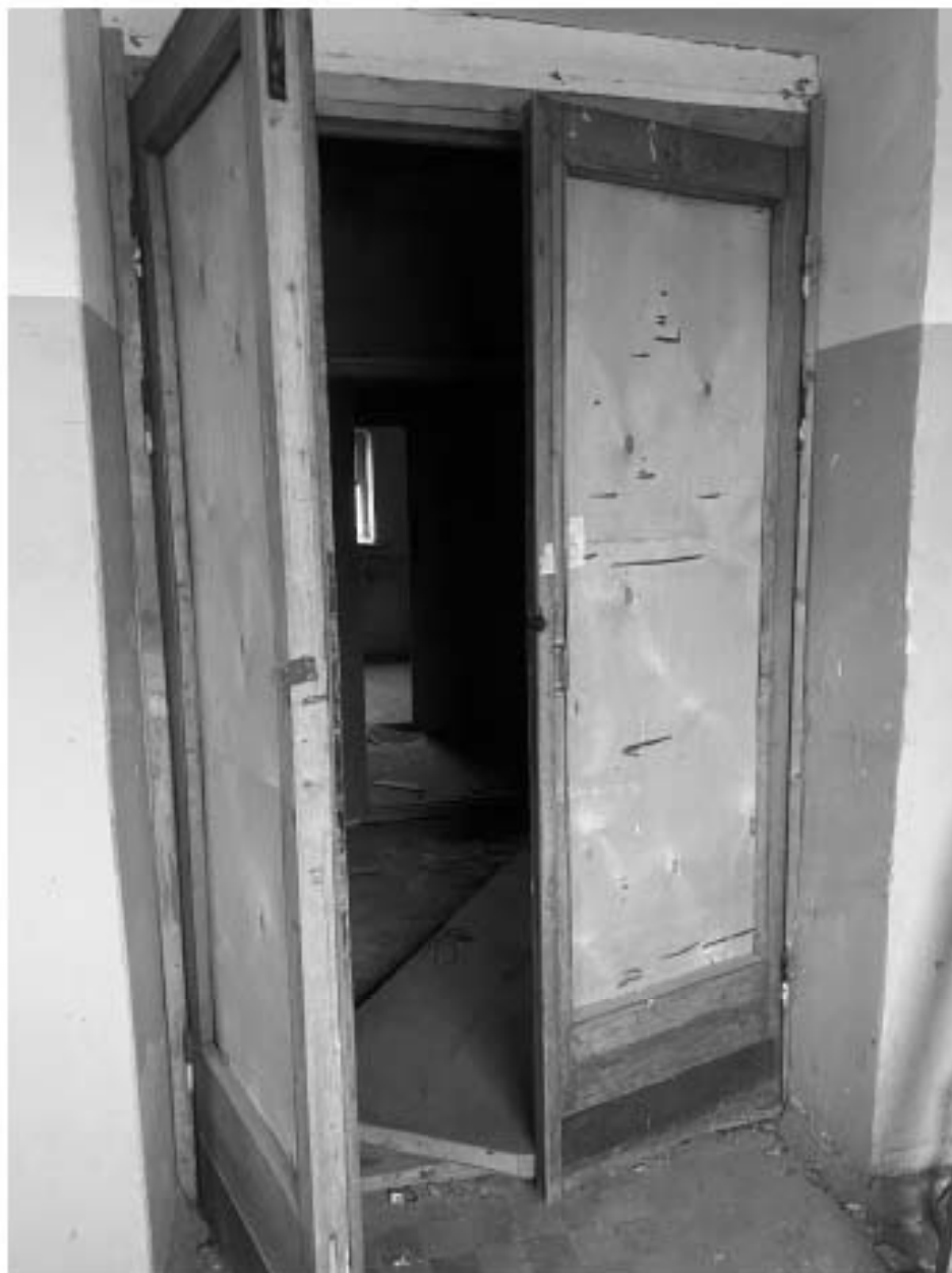
83. Вид на дверь в коридор;
