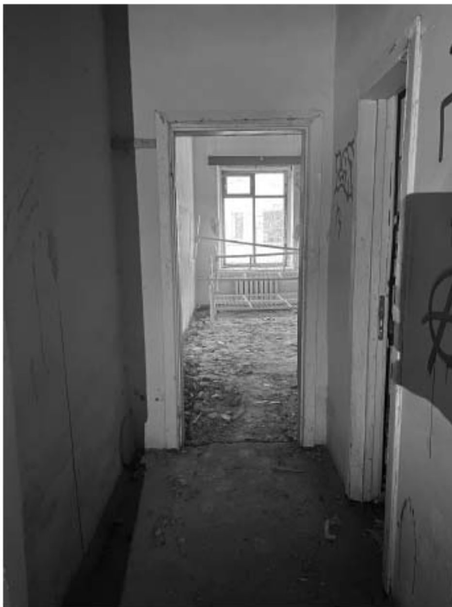
59. Помещение на втором этаже. Фрагмент интерьера;
