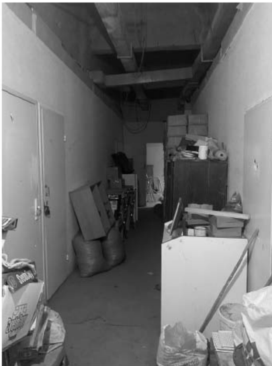
21. Фрагмент интерьера коридора;
