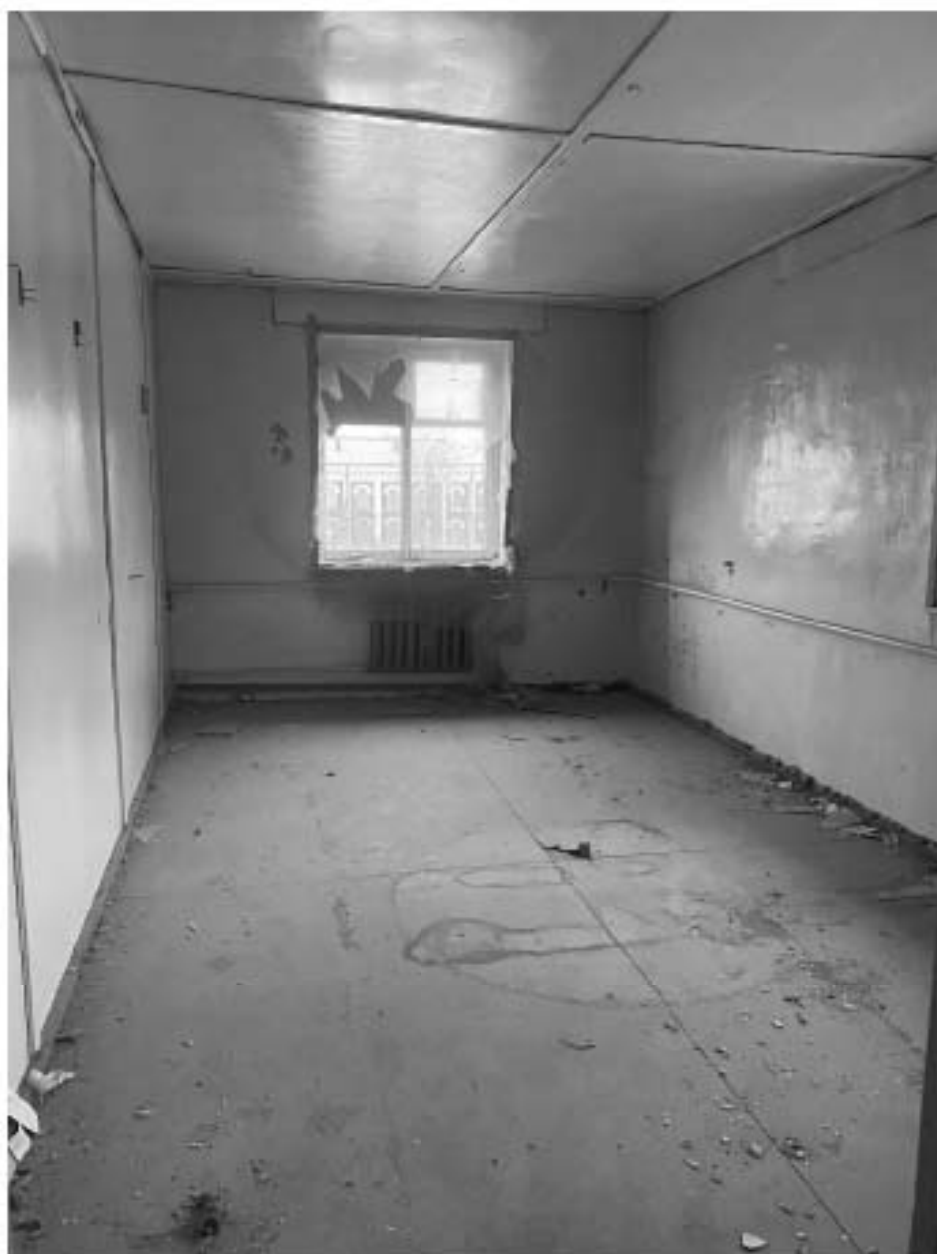
91. Помещение на четвёртом этаже. Фрагмент интерьера;
