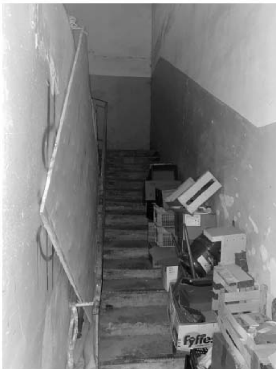
9. Лестница на второй этаж;
