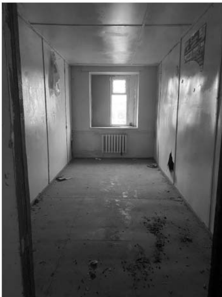
93. Помещение на четвёртом этаже. Фрагмент интерьера;
