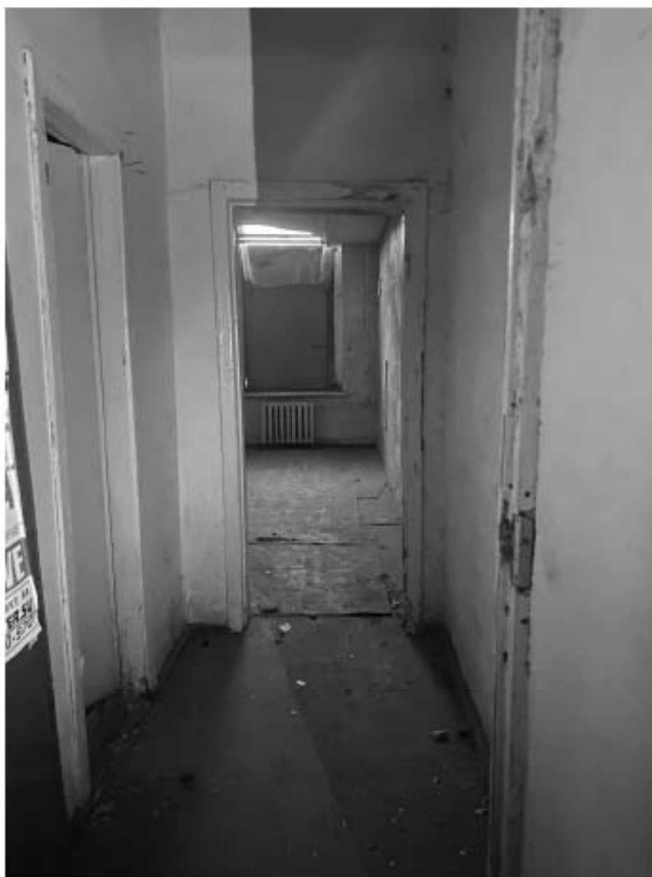
62. Помещение на втором этаже. Фрагмент интерьера;
