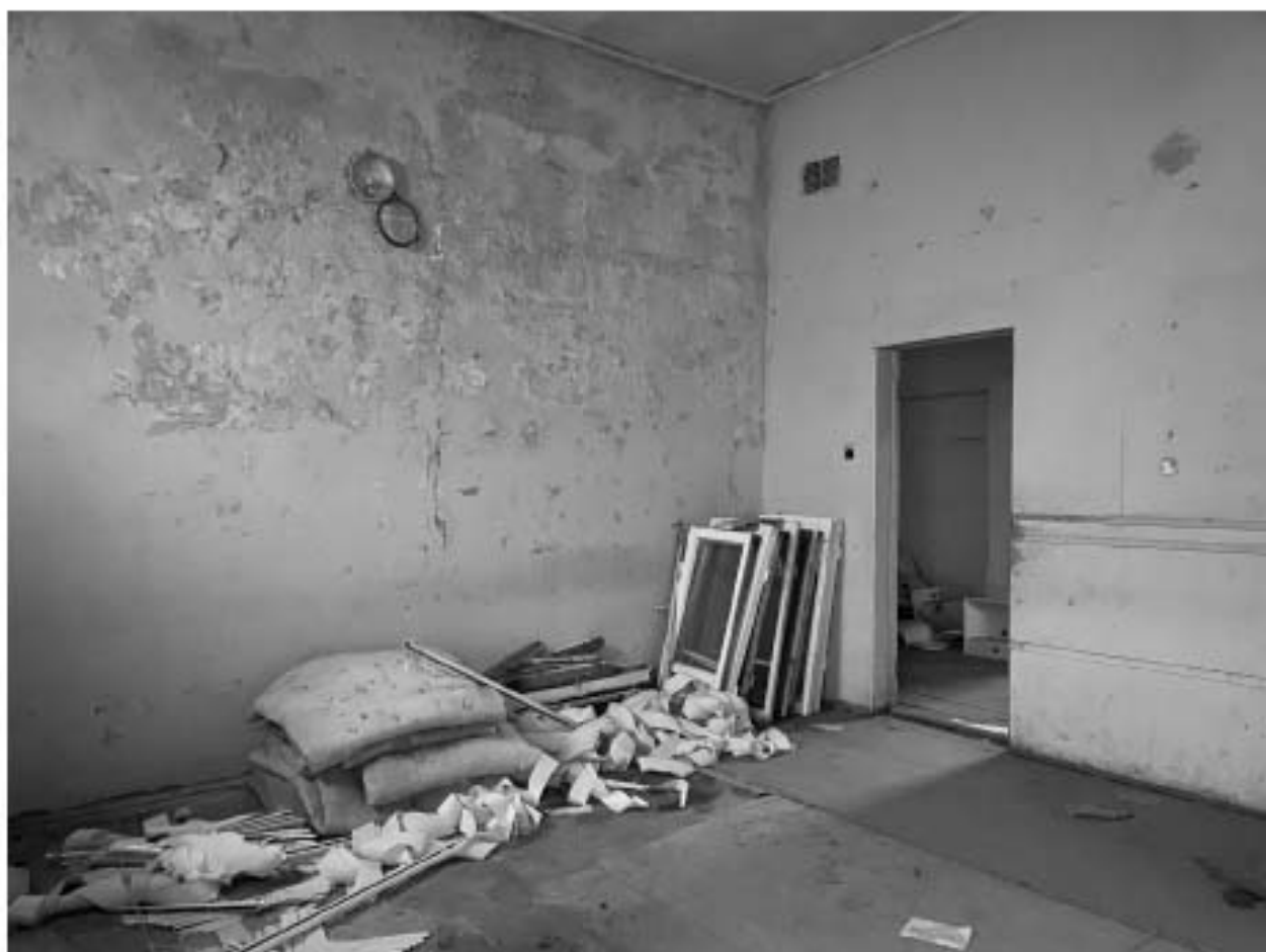
49. Помещение на втором этаже. Фрагмент интерьера;
