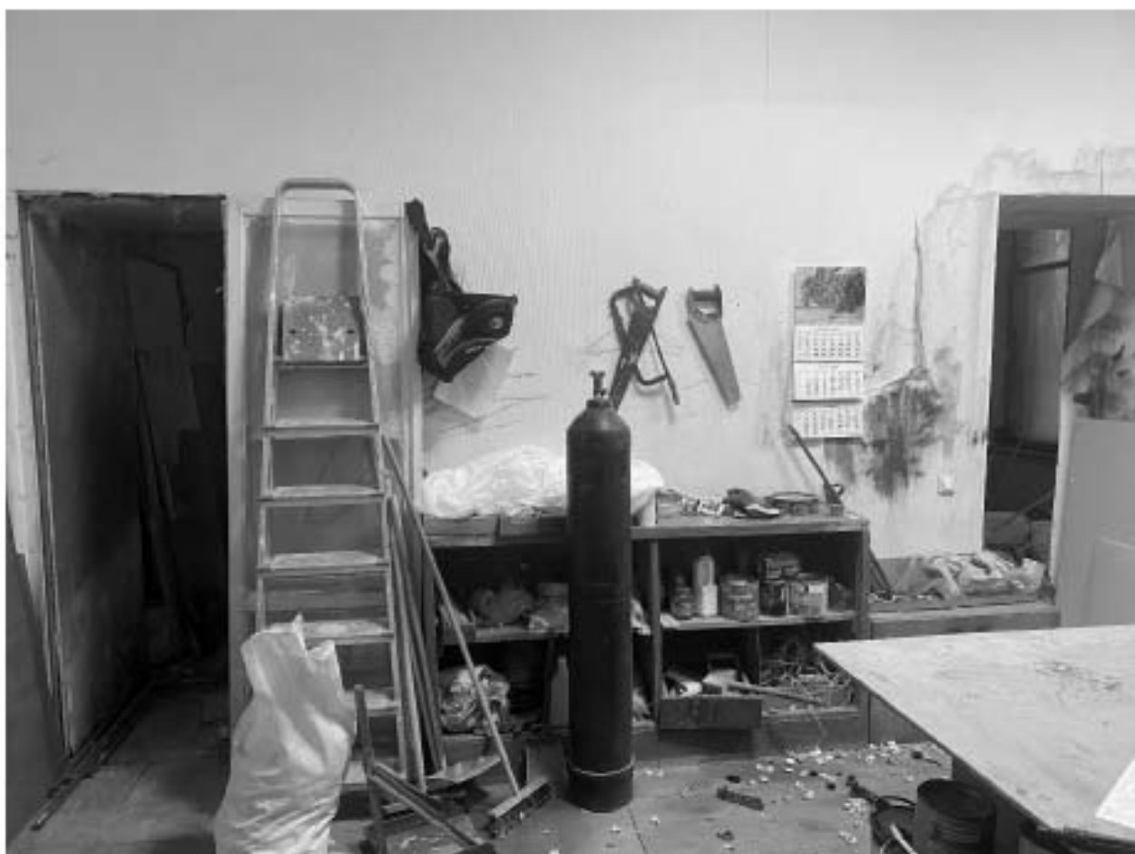
13. Помещение на первом этаже. Интерьер,
