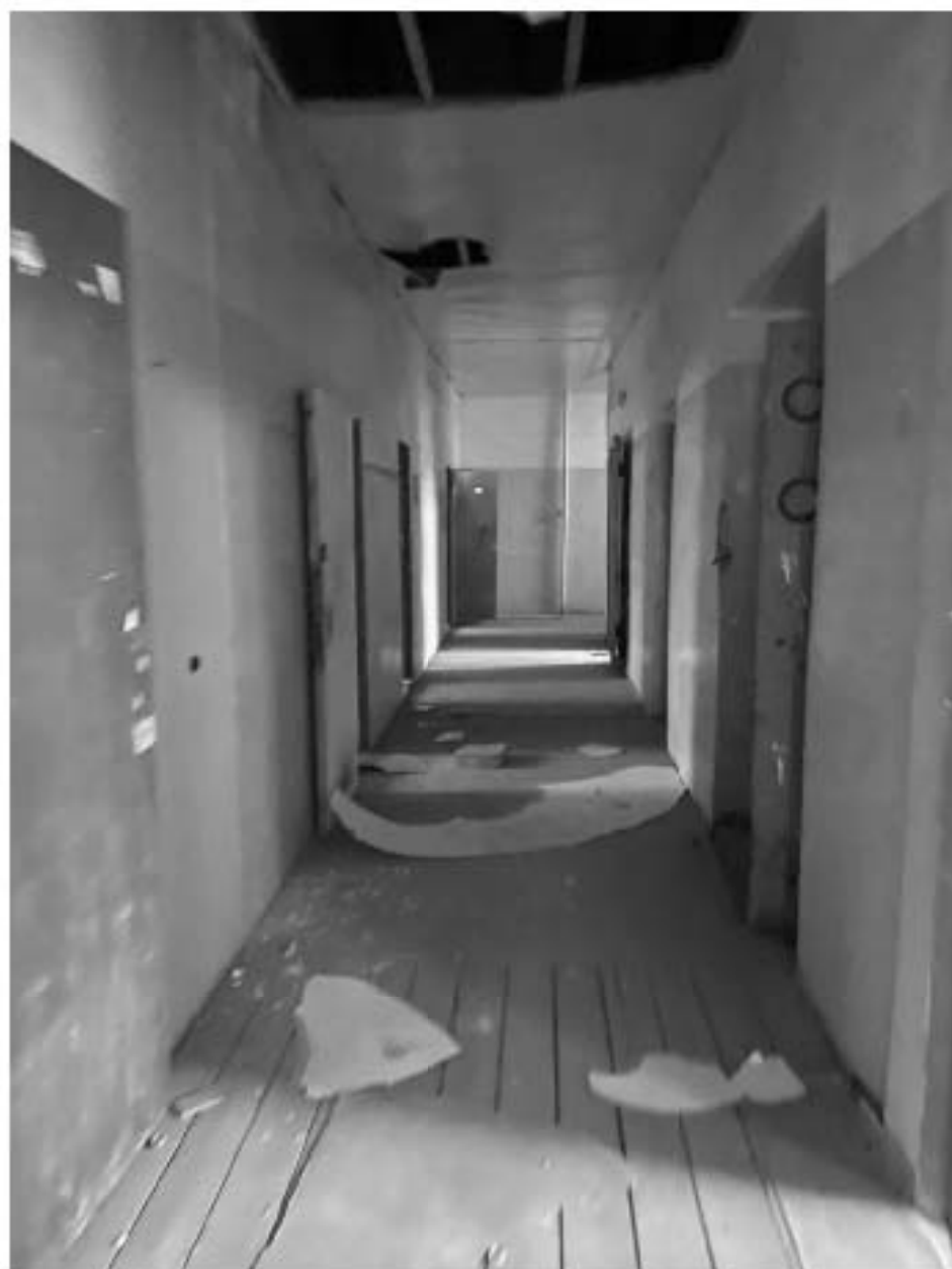
71. Фрагмент интерьера коридора на третьем этаже;
