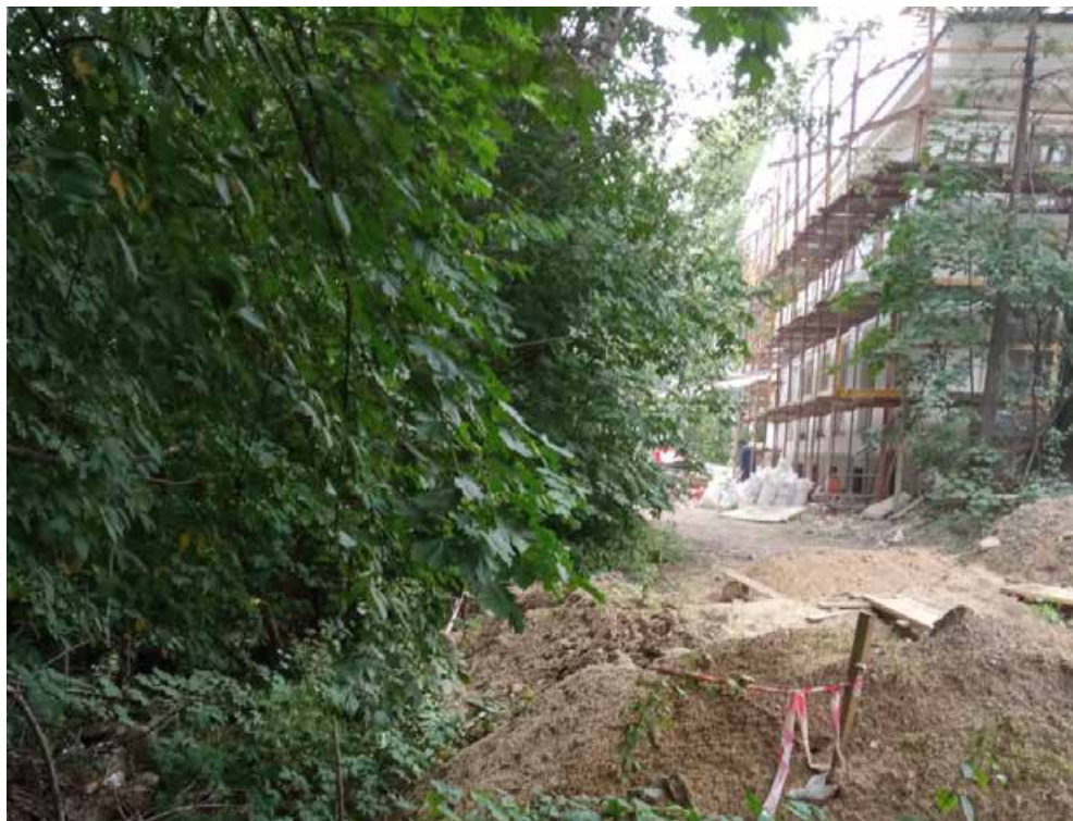
51. Объект культурного наследия федерального значения «Сад», входящий в состав объекта культурного наследия федерального значения «Уткина дача» по адресу: г. Санкт-Петербург, Красногвардейский район, Уткин проспект, дом 2, литеры А, Б (Уткин просп., 2, 2-а). Фрагмент территории. Вид в сторону главного дома.
