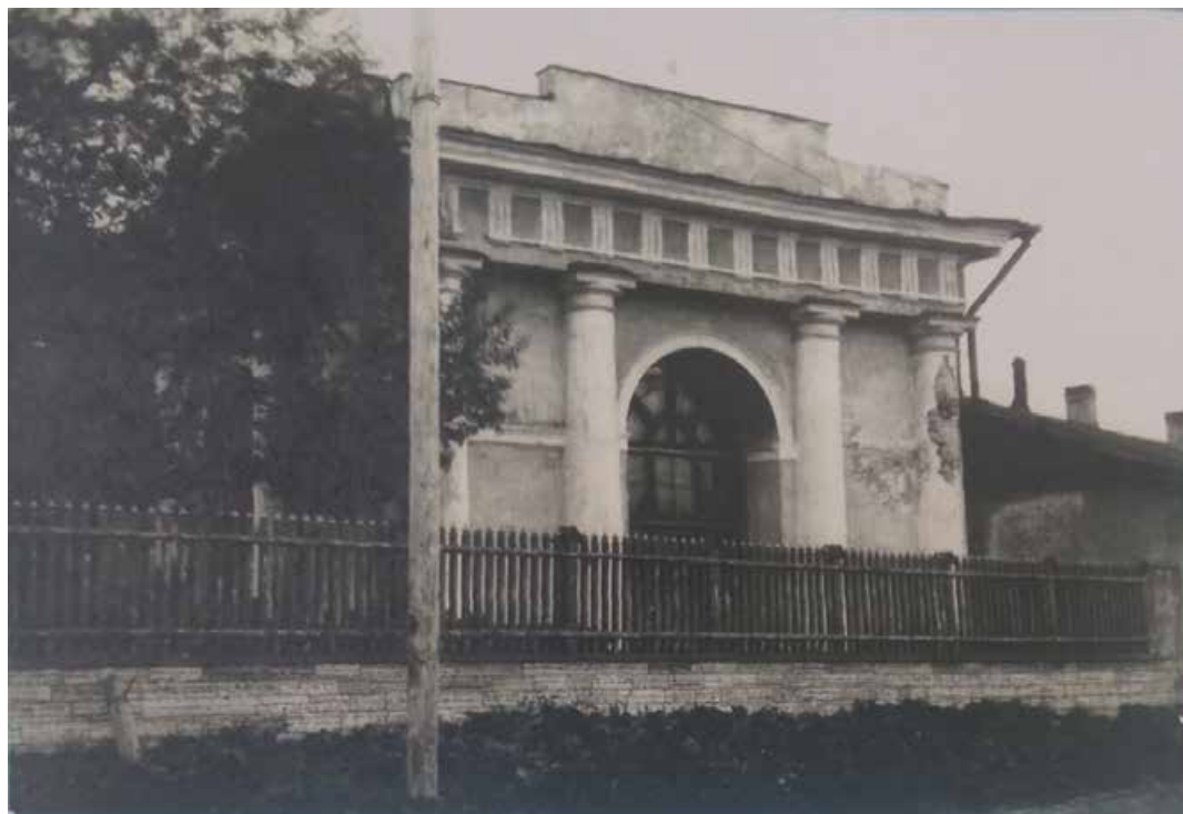
11. Уткина дача. Служебный корпус (флигель). Вид на торец здания. 1914 г. Фототека ИИМК РАН. Инв. № Q-823-29.
