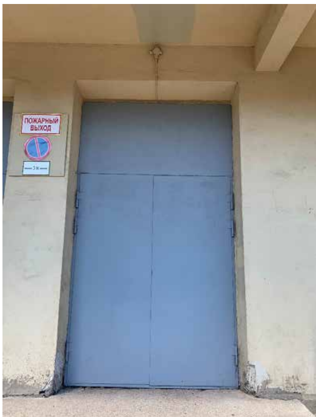
Фото №159. Фрагмент металлической входной двери. Наблюдается деградация красочного слоя, сколы, сеть волосяных трещин, поздние ремонтные вмешательства, общая загрязненность.
