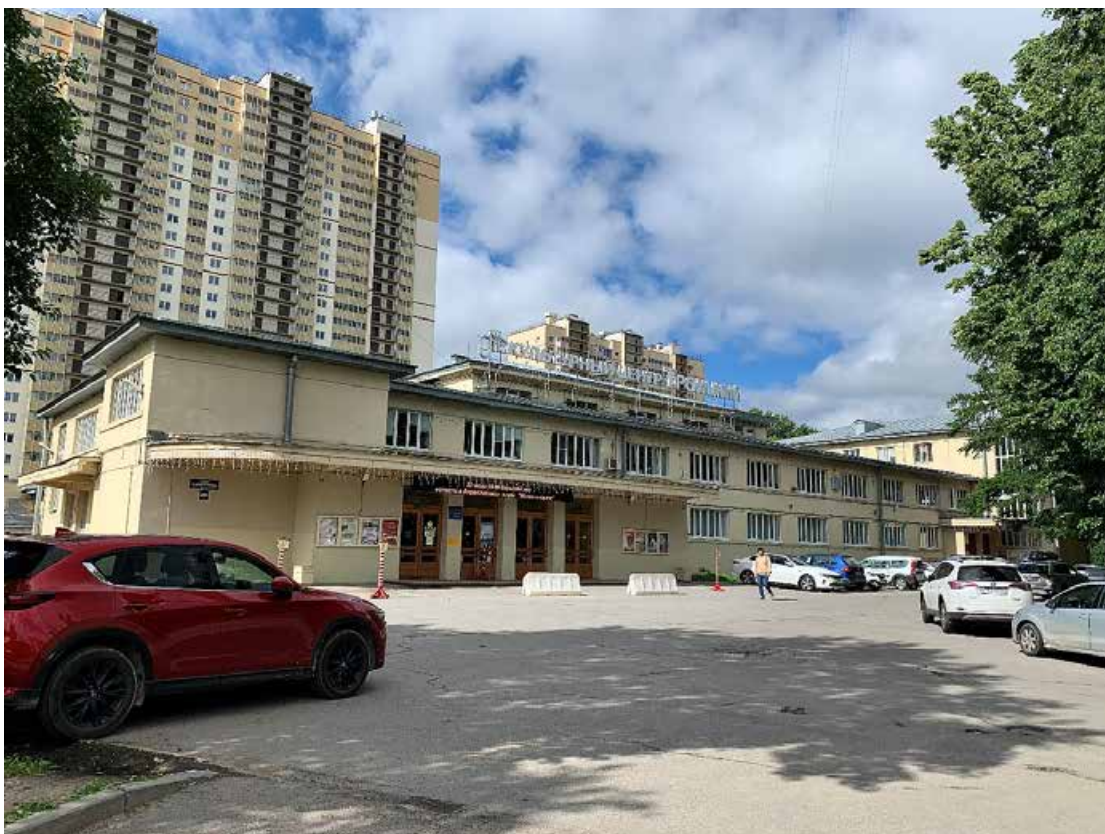
Фото №1. Общий вид на главный фасад со стороны проспекта Обуховской Обороны. Наблюдается деструкция штукатурного слоя, современные стеклопакеты, общая загрязненность фасада, трещины.
