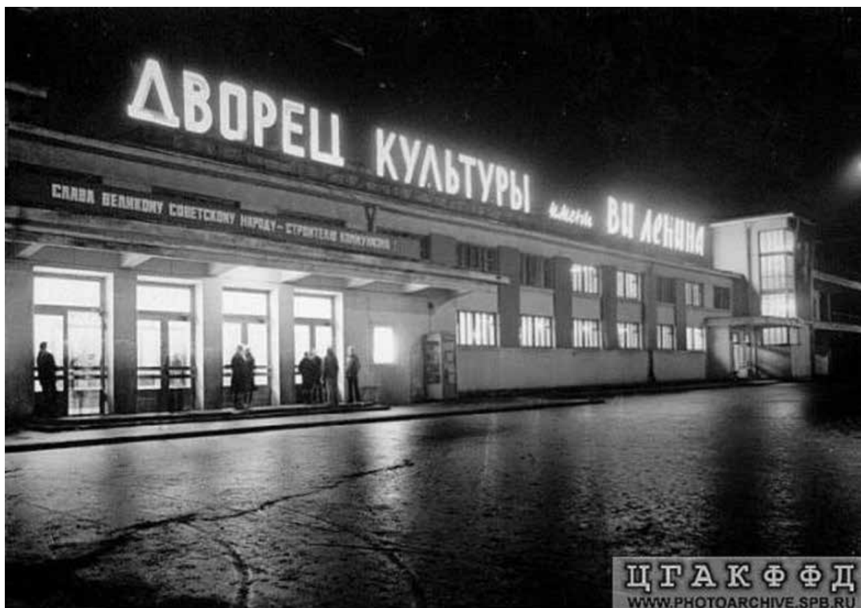
44. Северо-восточный фасад, вид с северо-востока. Фото 1974-1979 гг. www.pastvu.com
