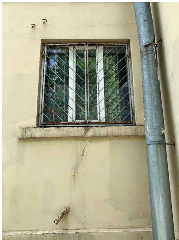
Фото №143. Фрагмент оконного проема. Наблюдается деградация красочного слоя, общая загрязненность, трещины, позднее ремонтные вмешательства.
