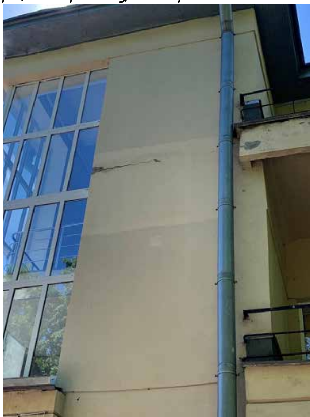
Фото №18. Фрагмент главного фасада. Наблюдаются трещины, разрушения красочного и штукатурного слоя, многочисленные волосяные трещины по красочному слою, поздние ремонтные вмешательства и общая загрязненность.
