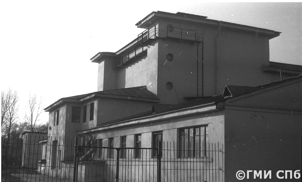
71. Северная часть юго-восточного фасада, вид с северо-запада. Фото 1979 г. www.goskatalog.ru
