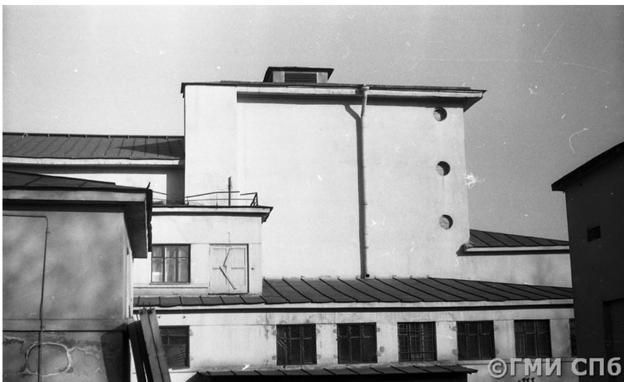
72. Фрагмент северо-западного (дворового) фасада. 1979 г. www.goskatalog.ru
