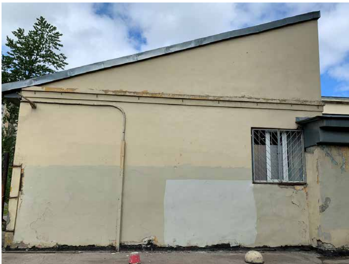
Фото №149. Фрагмент докового фасада. Наблюдается деградация красочного и штукатурного слоя, общая загрязненность, сколы, сеть волосяных трещин, поздние ремонтные вмешательства.
