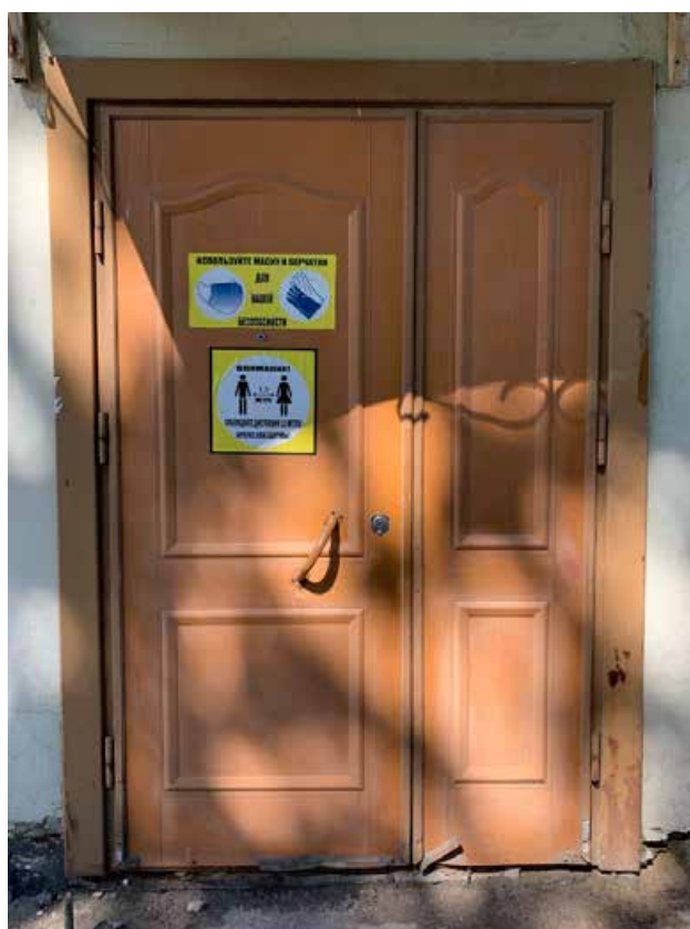
Фото №176. Фрагмент входной деревянной двери. Наблюдается деструкция красочного слоя, общая загрязненность.
