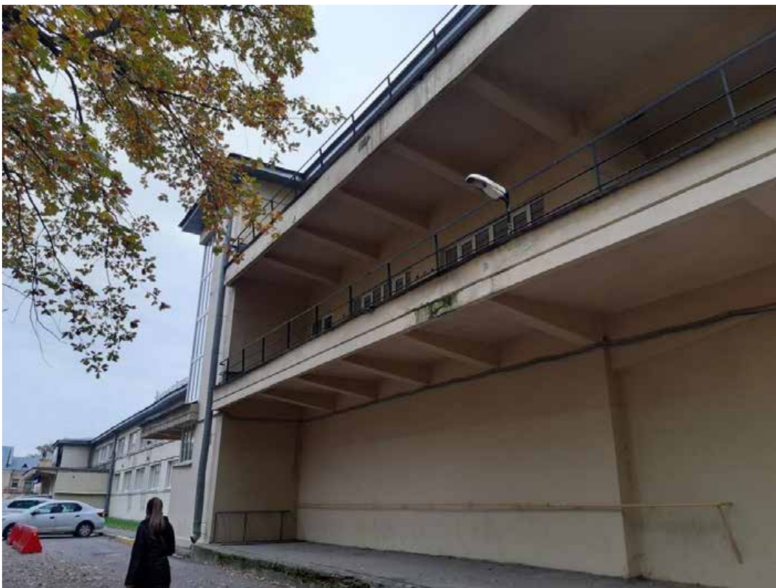
53. Вид снизу северную часть северо-восточного фасада. Фото 2020 г. www.citywalls.ru
