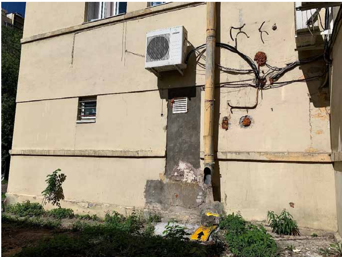
Фото №137. Фрагмент фасада. Наблюдаются деструкция красочного слоя, поздние ремонтные вмешательства, общая загрязненность.
