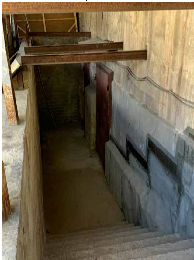
Фото №104. Фрагмент подвала.
