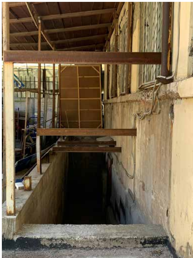
Фото №103. Фрагмент подвала.
