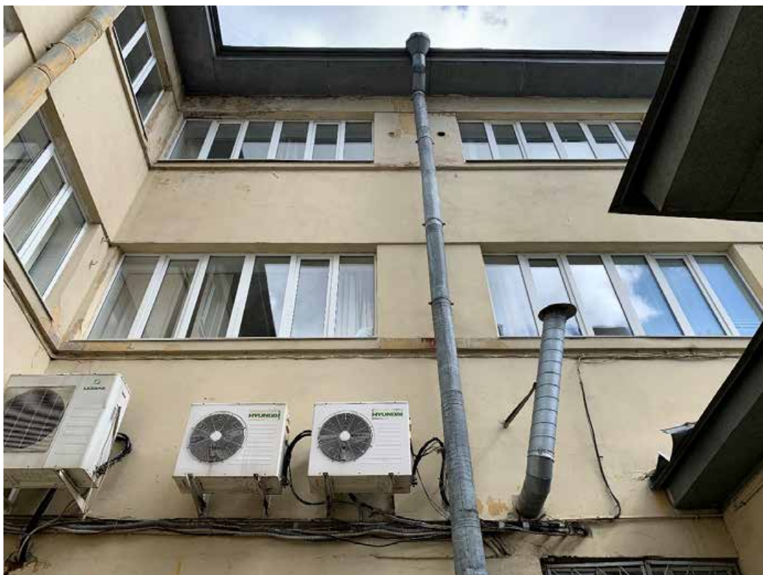
Фото №133. Фрагмент дворового фасада.
