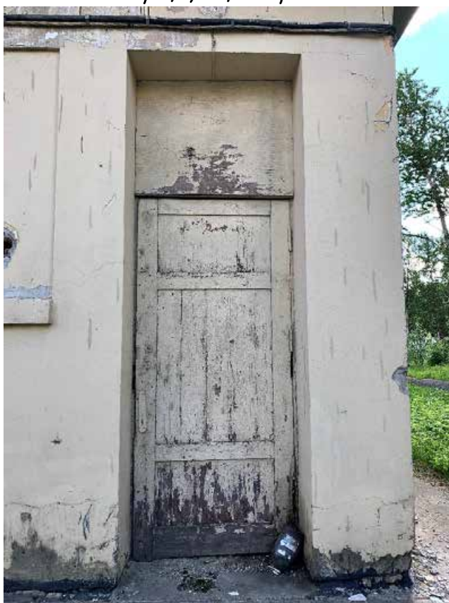
Фото №94. Фрагмент входной деревянной двери. Наблюдается деструкция красочного слоя, общая загрязненность.
