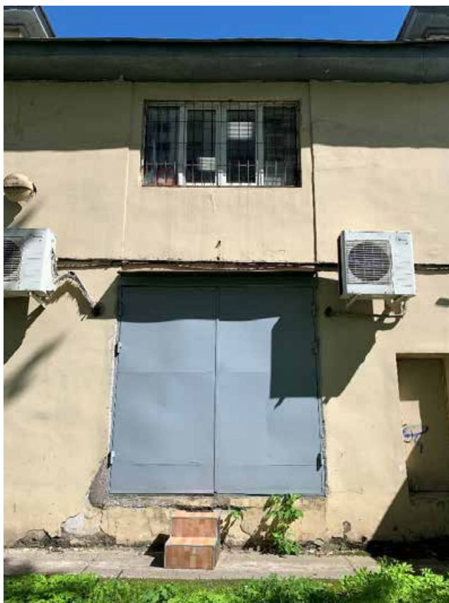
Фото №77. Фрагмент дворового фасада. Наблюдается деструкция красочного и штукатурного слоя сеть волосяных трещин, общая загрязненность фасада.
