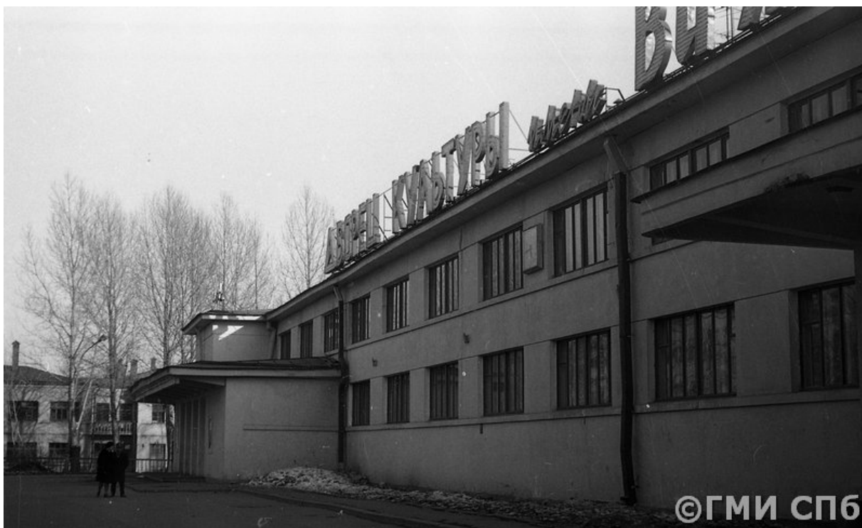
45. Северо-восточный (главный) фасад, вид с северо-запада. Фото 1979 г. www.goskatalog.ru
