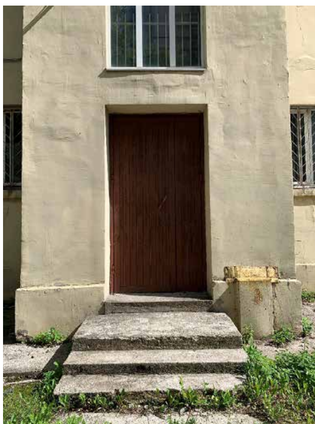
Фото №146. Фрагмент входной деревянной двери оборотового фасада. Наблюдается деструкция красочного слоя, общая загрязненность, сеть волосяных трещин.
