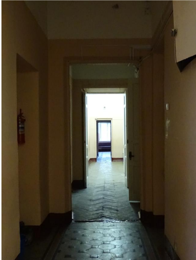
50. Объект культурного наследия регионального значения «Реальное училище с садом и оградой», входящий в состав «Комплекс домов по ул. Пролеткульта», расположенный по адресу: Санкт-Петербург, г. Пушкин, Госпитальная улица, дом 24, литера А. Коридор третьего этажа левого крыла (помещение 89). Общий вид.
