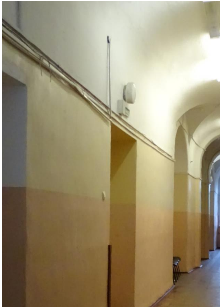
41. Объект культурного наследия регионального значения «Реальное училище с садом и оградой», входящий в состав «Комплекс домов по ул. Пролеткульта», расположенный по адресу: Санкт-Петербург, г. Пушкин, Госпитальная улица, дом 24, литера А. Второй этаж. Коридор (помещение №50). Фрагмент интерьера.
