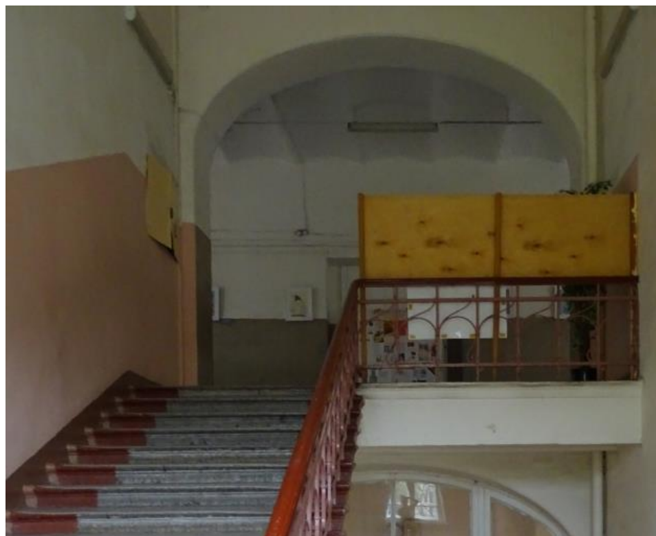
55. Объект культурного наследия регионального значения «Реальное училище с садом и оградой», входящий в состав «Комплекс домов по ул. Пролеткульта», расположенный по адресу: Санкт-Петербург, г. Пушкин, Госпитальная улица, дом 24, литера А. Вид на помещение 102 в уровне третьего этажа.
