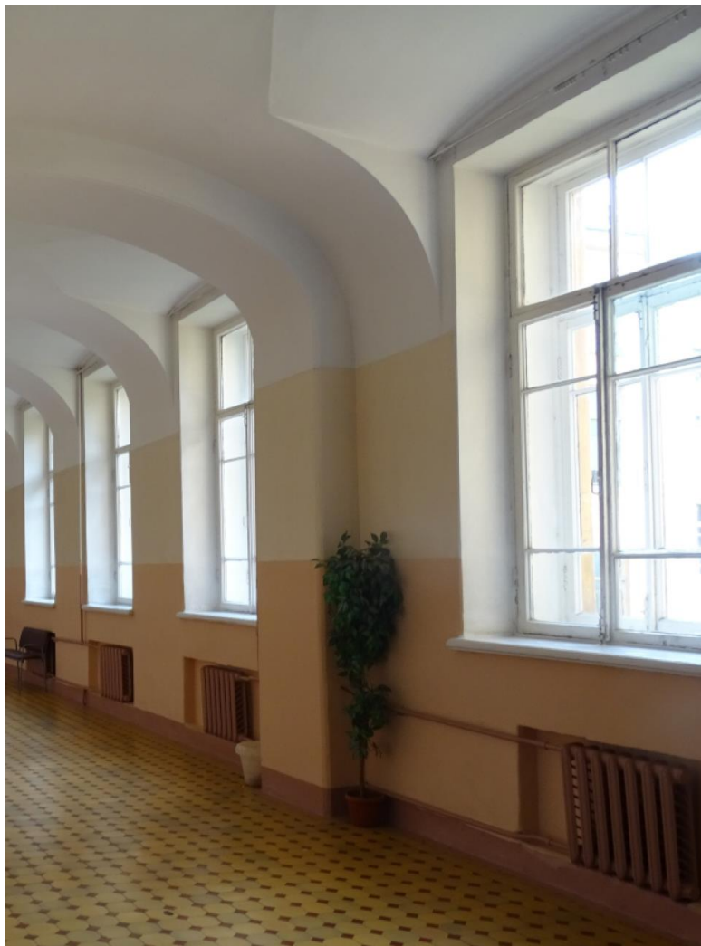
36. Объект культурного наследия регионального значения «Реальное училище с садом и оградой», входящий в состав «Комплекс домов по ул. Пролеткульта», расположенный по адресу: Санкт-Петербург, г. Пушкин, Госпитальная улица, дом 24, литера А. Второй этаж. Коридор (помещения №62). Фрагмент интерьера.
