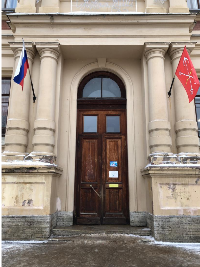
15. Объект культурного наследия регионального значения «Реальное училище с садом и оградой», входящий в состав «Комплекс домов по ул. Пролеткульта», расположенный по адресу: Санкт-Петербург, г. Пушкин, Госпитальная улица, дом 24, литера А. Юго-восточный (главный) фасад. Фрагмент. Главный вход.
