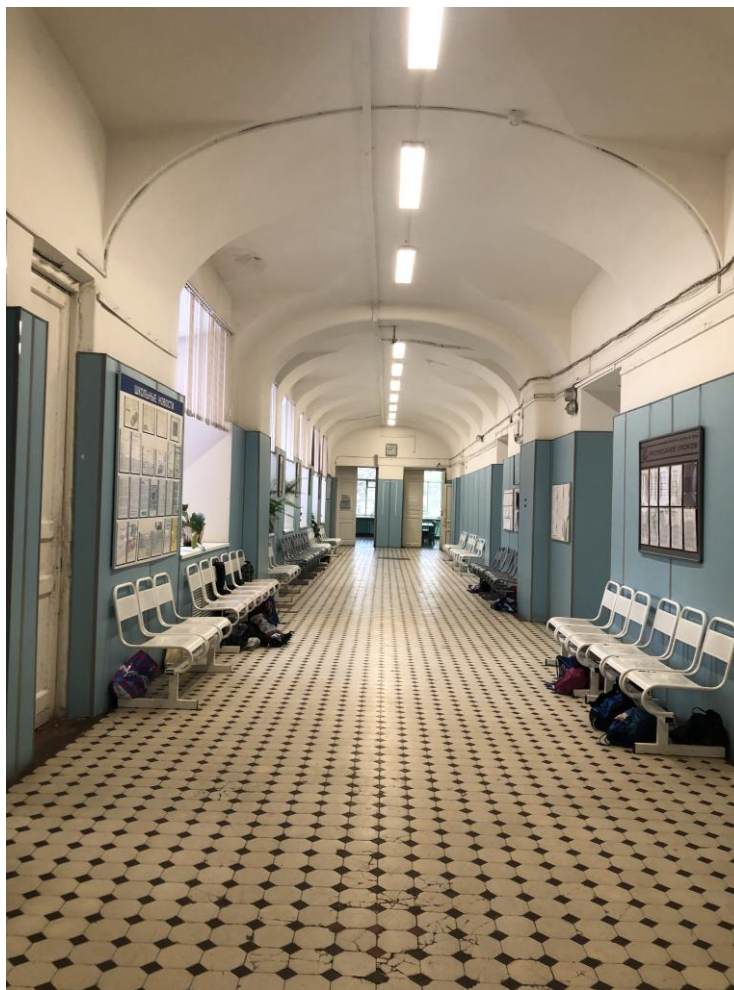
29. Объект культурного наследия регионального значения «Реальное училище с садом и оградой», входящий в состав «Комплекс домов по ул. Пролеткульта», расположенный по адресу: Санкт-Петербург, г. Пушкин, Госпитальная улица, дом 24, литера А. Первый этаж. Коридор (помещение 9). Общий вид.
