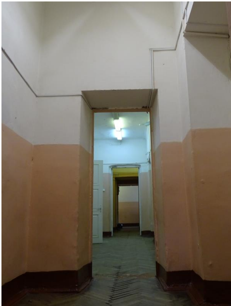
49. Объект культурного наследия регионального значения «Реальное училище с садом и оградой», входящий в состав «Комплекс домов по ул. Пролеткульта», расположенный по адресу: Санкт-Петербург, г. Пушкин, Госпитальная улица, дом 24, литера А. Коридор третьего этажа левого крыла (помещение 89). Общий вид.
