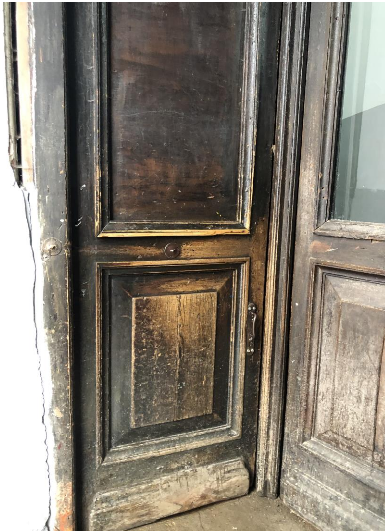
20. Объект культурного наследия регионального значения «Реальное училище с садом и оградой», входящий в состав «Комплекс домов по ул. Пролеткульта», расположенный по адресу: Санкт-Петербург, г. Пушкин, Госпитальная улица, дом 24, литера А. Главный вход. Тамбур. Фрагмент.
