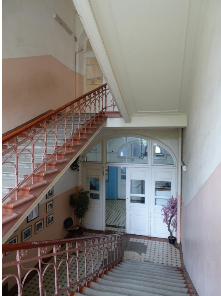
26. Объект культурного наследия регионального значения «Реальное училище с садом и оградой», входящий в состав «Комплекс домов по ул. Пролеткульта», расположенный по адресу: Санкт-Петербург, г. Пушкин, Госпитальная улица, дом 24, литера А. Лестница главного корпуса. Общий вид.
