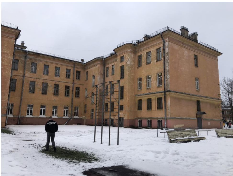
11. Объект культурного наследия регионального значения «Реальное училище с садом и оградой», входящий в состав «Комплекс домов по ул. Пролеткульта», расположенный по адресу: Санкт-Петербург, г. Пушкин, Госпитальная улица, дом 24, литера А. Северо-западный (дворовый) фасад.
