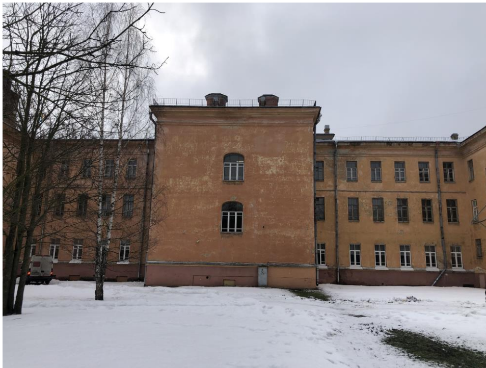
10. Объект культурного наследия регионального значения «Реальное училище с садом и оградой», входящий в состав «Комплекс домов по ул. Пролеткульта», расположенный по адресу: Санкт-Петербург, г. Пушкин, Госпитальная улица, дом 24, литера А. Северо-западный (дворовый) фасад.
