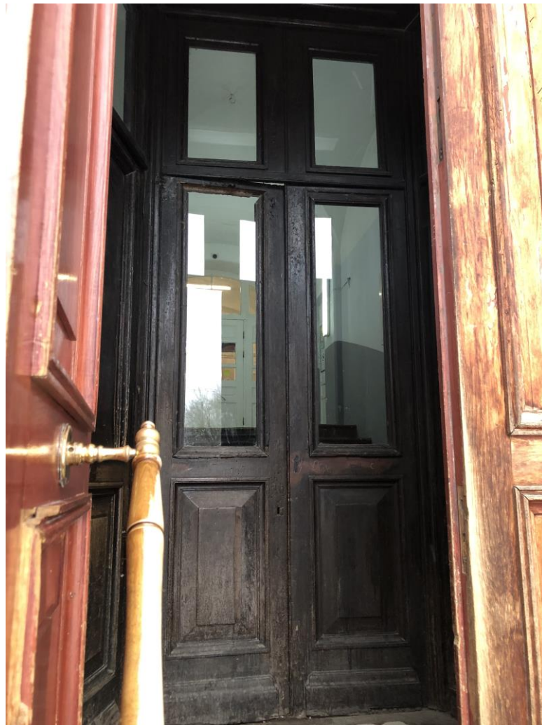
19. Объект культурного наследия регионального значения «Реальное училище с садом и оградой», входящий в состав «Комплекс домов по ул. Пролеткульта», расположенный по адресу: Санкт-Петербург, г. Пушкин, Госпитальная улица, дом 24, литера А. Главный вход. Тамбур. Фрагмент.
