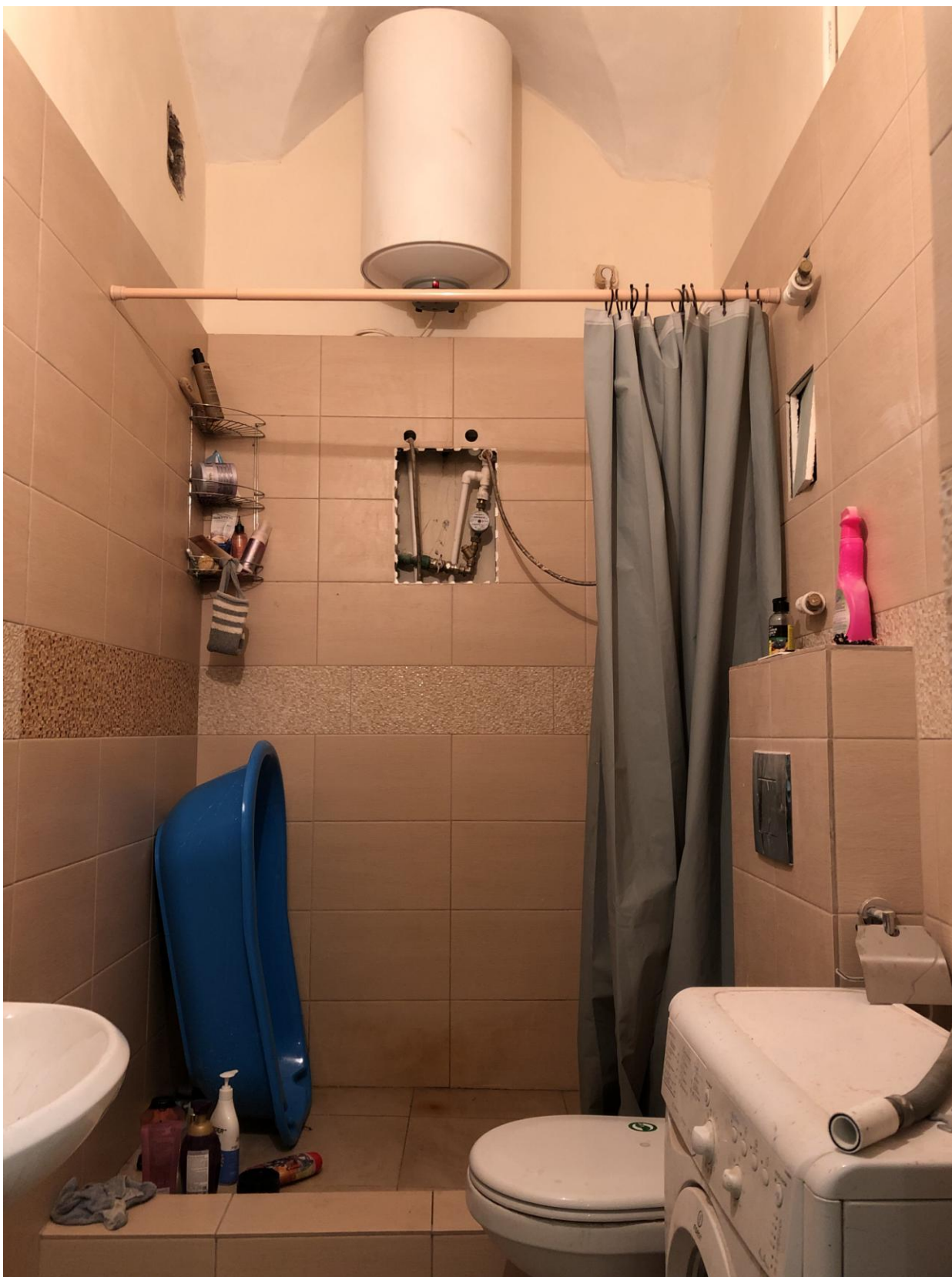
Фото 5. Вид на санузел (помещение № 13).
