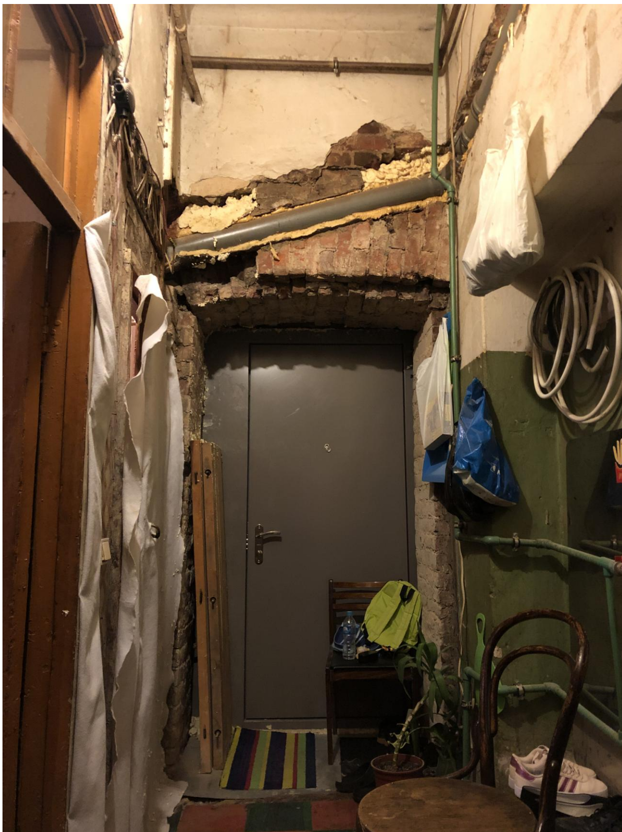
Фото 15. Вид на входную дверь в кв. № 32 из коридора.
