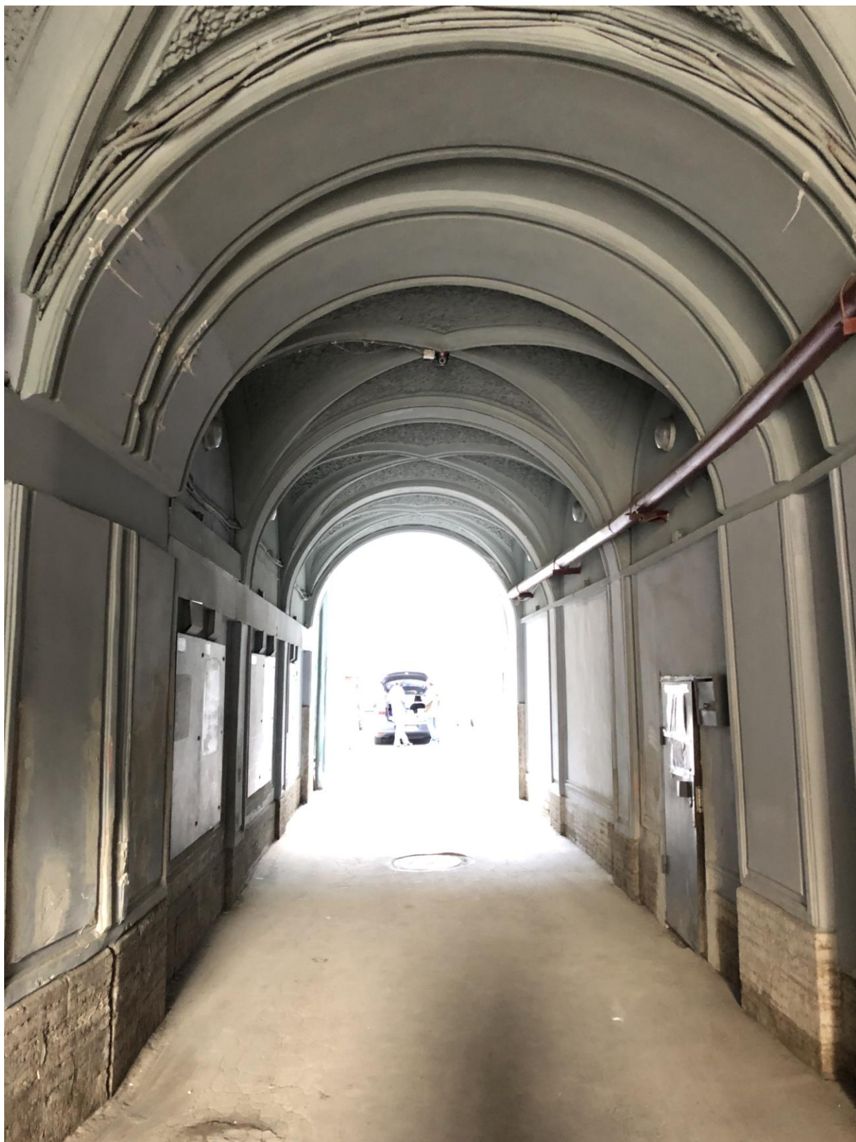
Фото 5. Вид на арочный проезд дома № 26 по Загородному проспекту.
