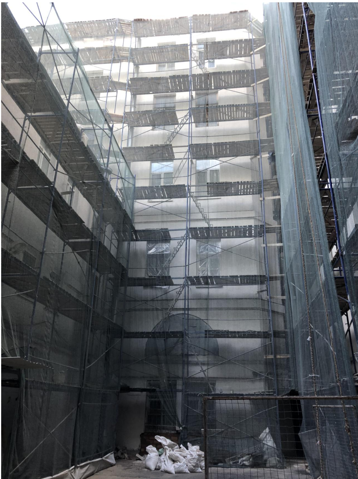
Фото 8. Вид на юго-запад второго двора дома № 26 по Загородному проспекту.
