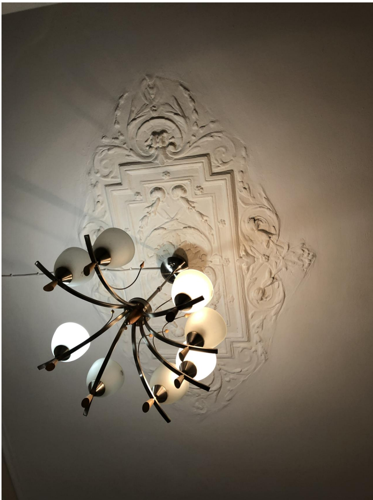
Фото 11. Вид на розетку в спальне (помещение № 3).
