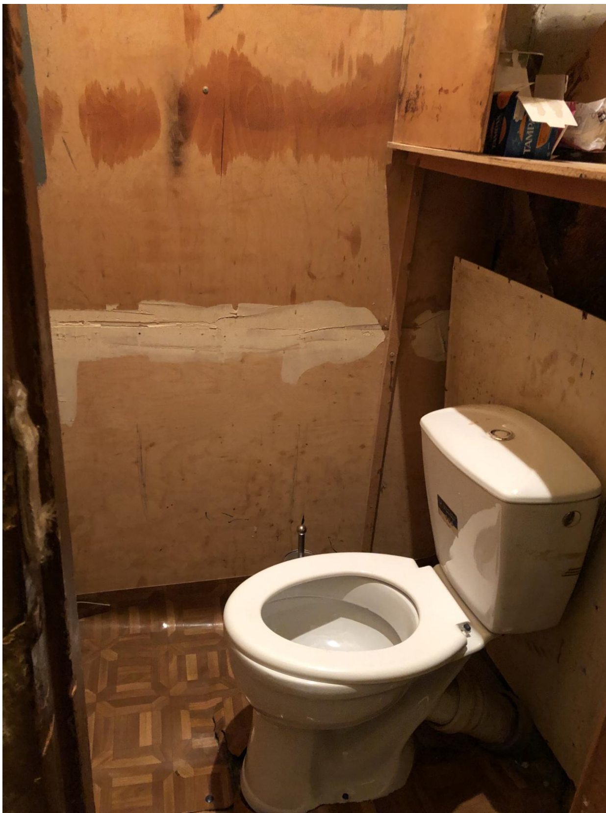
Фото 24. Вид на санузел (помещение № 12).
