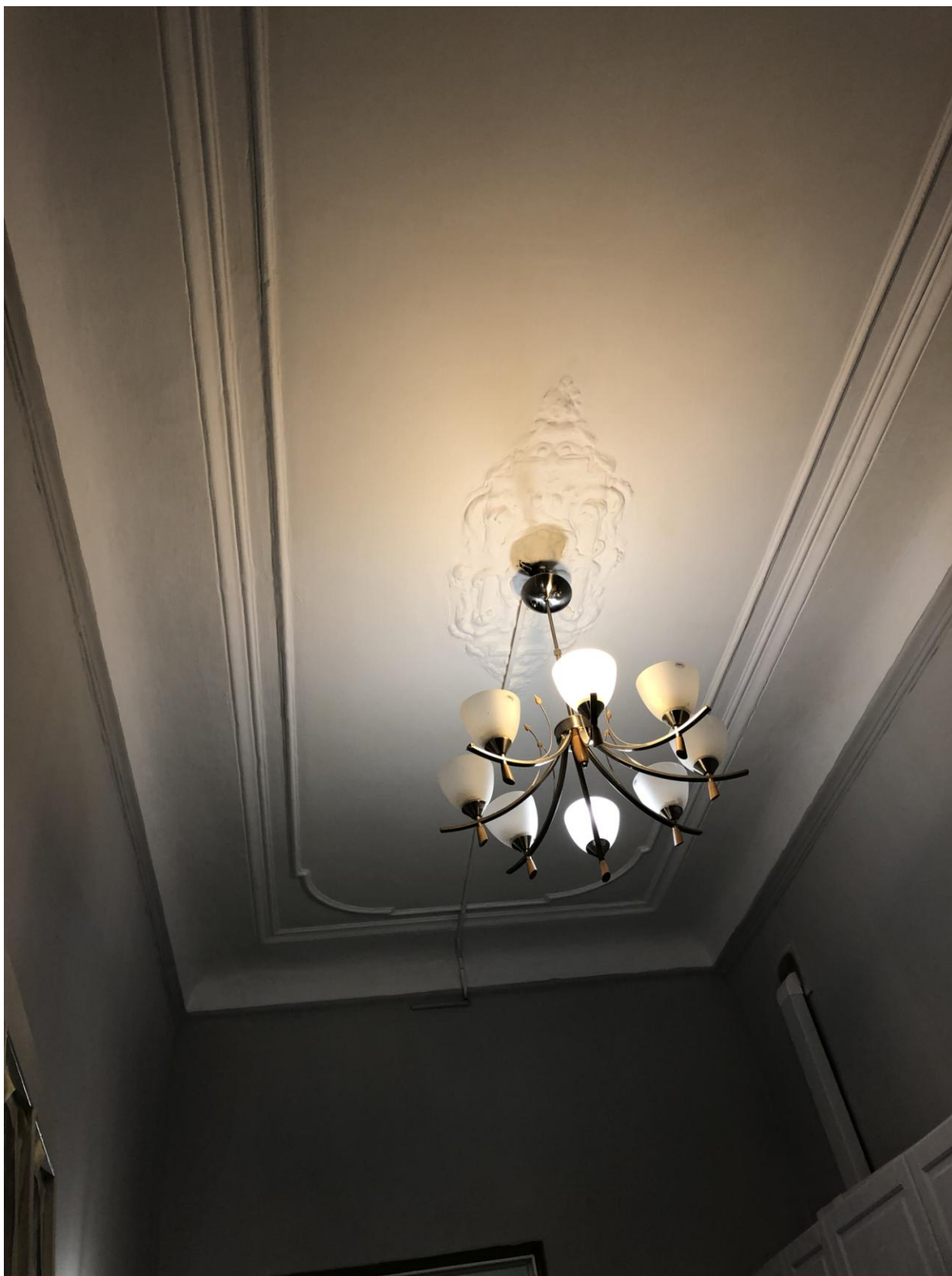
Фото 8. Вид на плафон в помещении кухни (помещение № 2).
