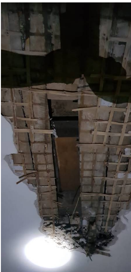
Фото 23. Интерьер кв. №44, вскрытие потолка в рамках визуального обследования несущих конструкций (07.03.2022 г.)
