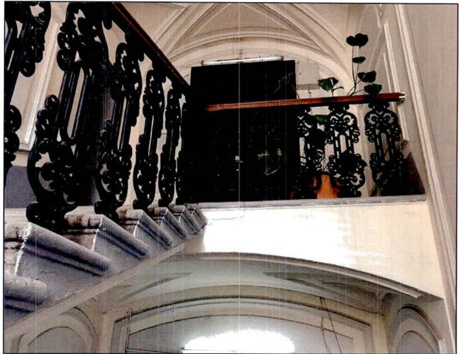
4. Двухмаршевая лестница 6-ЛК. Верхняя площадка.
