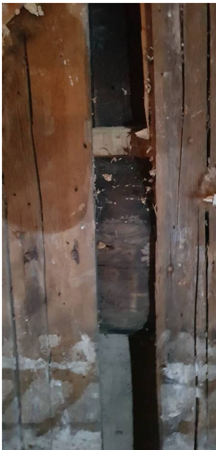
Фото 25. Интерьер кв. №44, вскрытие пола в рамках визуального обследования несущих конструкций (07.03.2022 г.)
