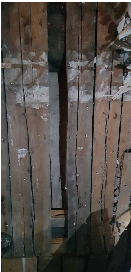
Фото 24. Интерьер кв. №44, вскрытие пола в рамках визуального обследования несущих конструкций (07.03.2022 г.)
