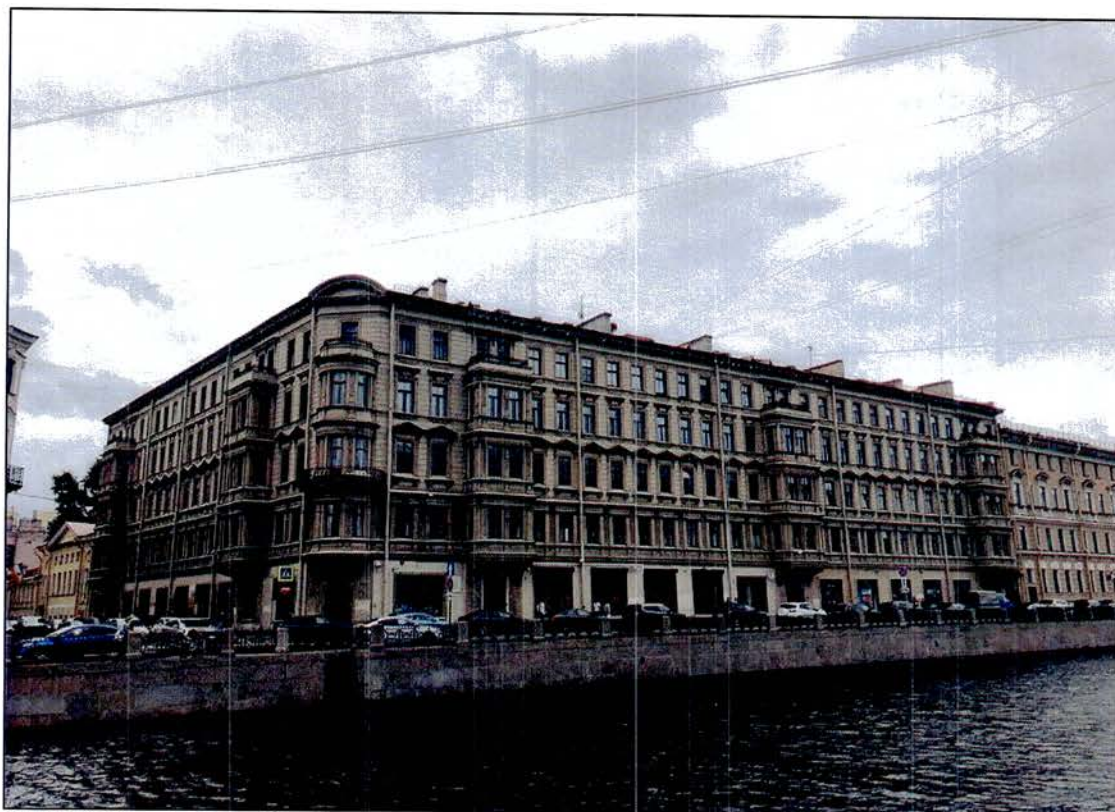
1. Общий вид с северо-востока.
