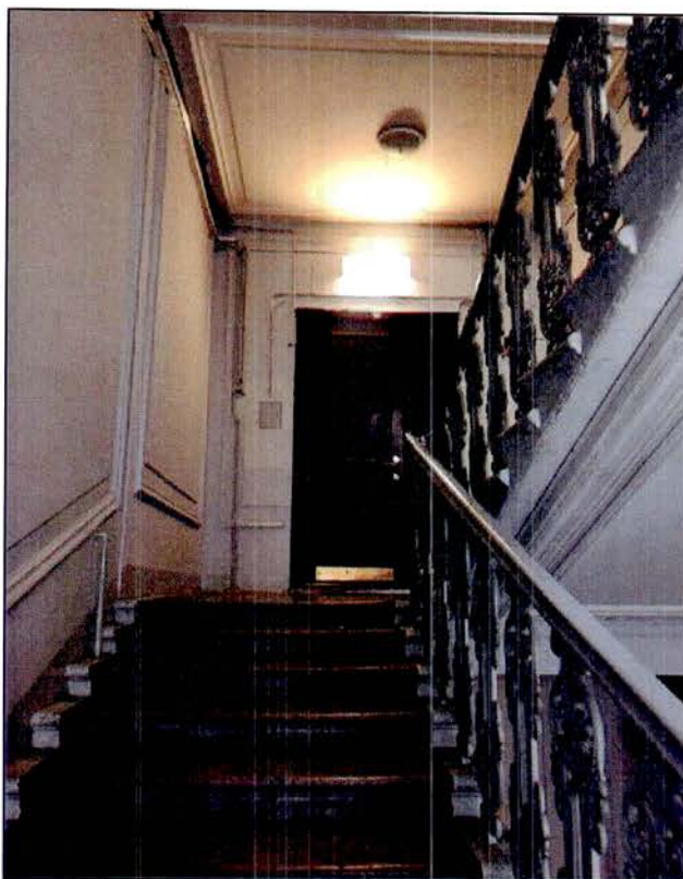
3. Двухмаршевая лестница 7-ЛК. Общий вид.
