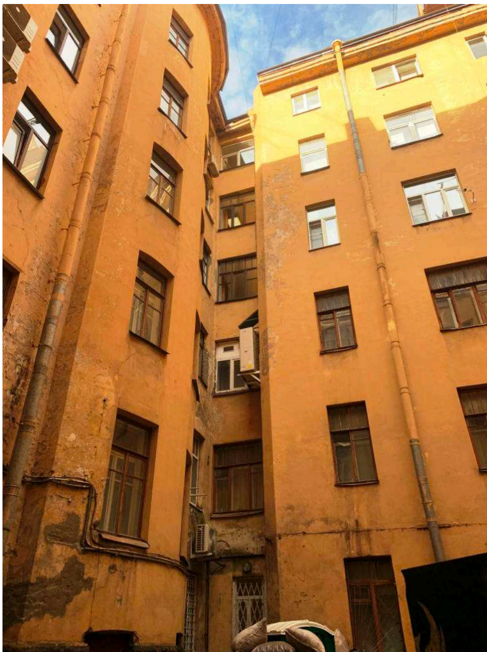
6. Выявленный объект культурного наследия «Дом К.В. Маркова», Каменноостровский пр., д.67, лит.А. Северный дворовый фасад.
