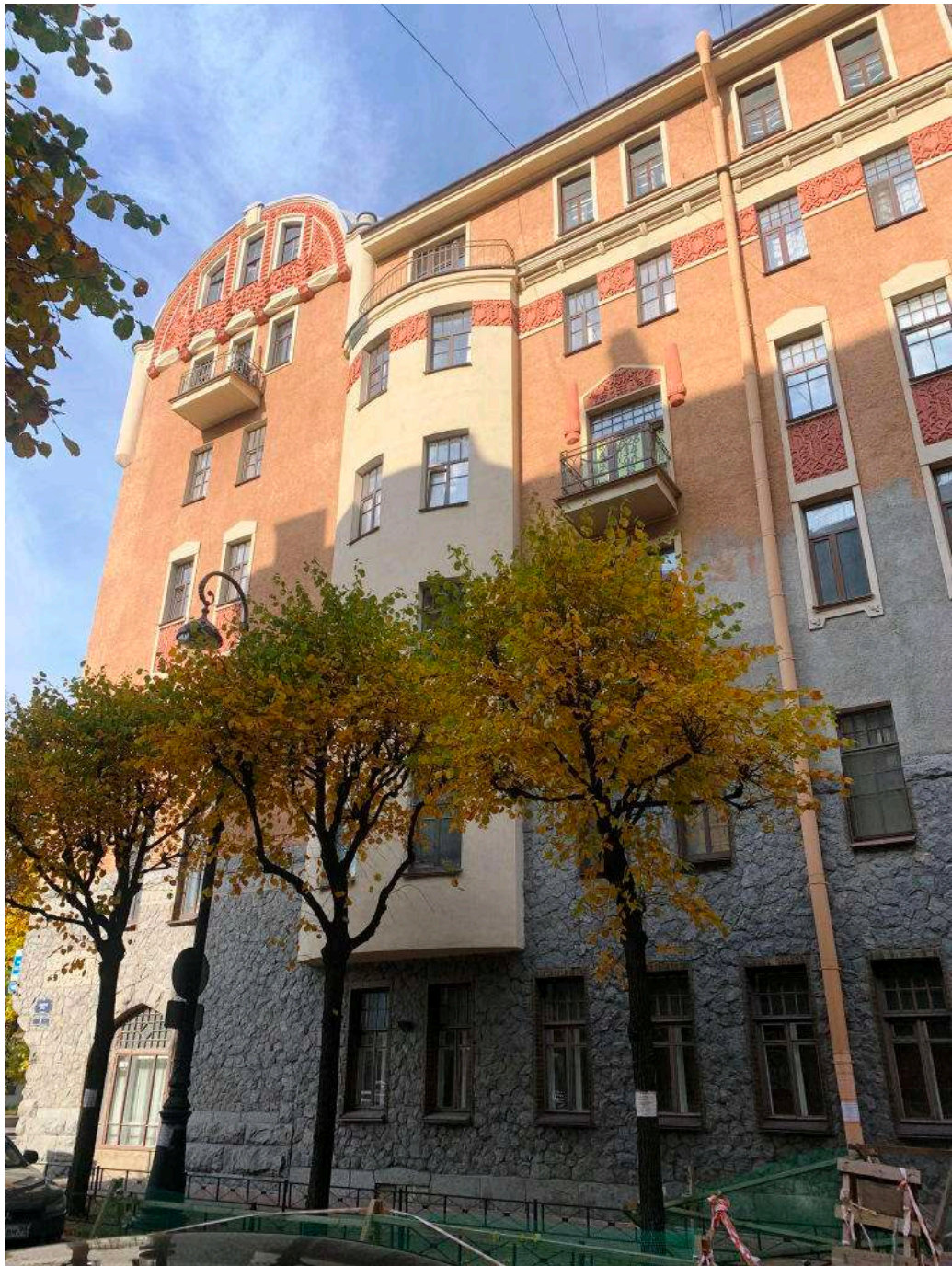
3. Выявленный объект культурного наследия «Дом К.В. Маркова», Каменноостровский пр., д.67, лит.А. Фрагмент южного фасада ( по ул. Графтио).
