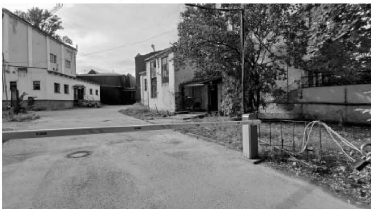
Фото 2. Вид с Заозерной улицы на здания лит А и Д (на запад)
