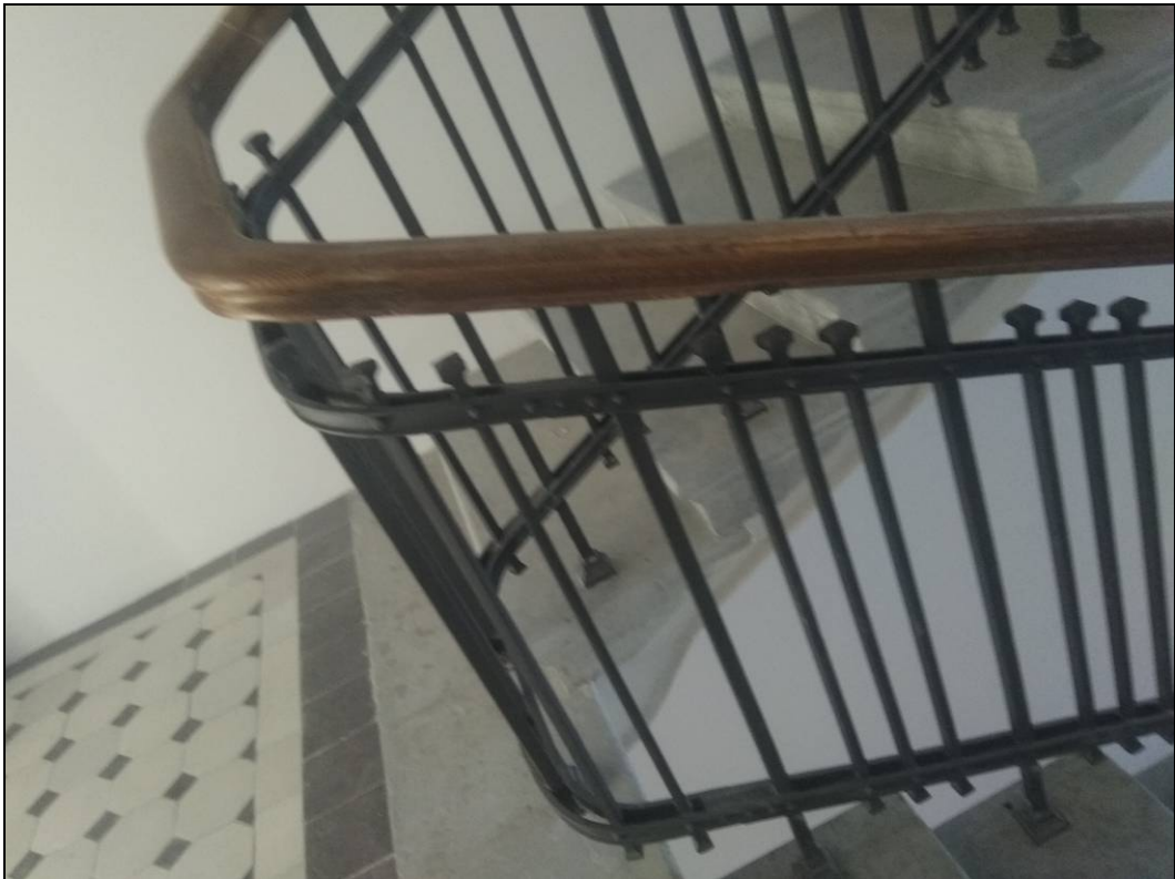
33, 34, 35. Лестница в осях Г-Ж/12-13. Общий вид. Фрагмент ограждения
