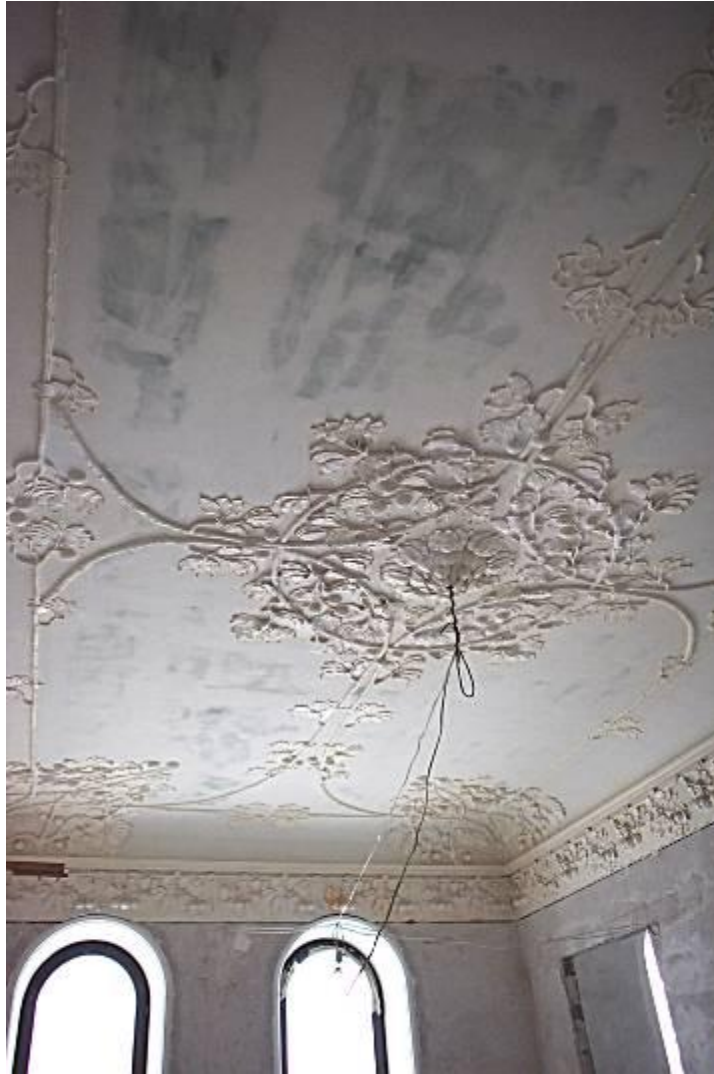
94. 3 этаж, кв. 14, комната, восстановленная в результате объединения пом. 5, 14, 22. Общий вид плафона.
