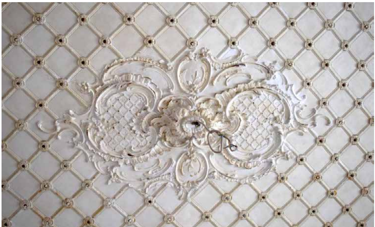
153. 3 этаж, кв. 6, пом. 4. Центральная розетка плафона.
