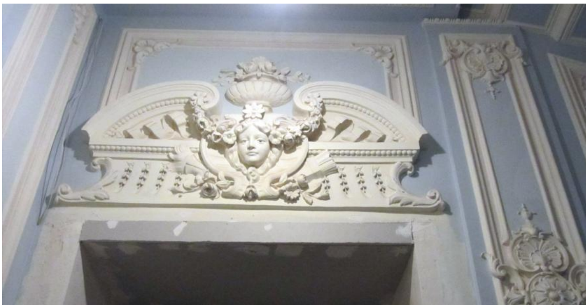
16. Фрагмент интерьера парадной лестницы со стороны Потемкинской улицы. Дессю-де-порты дверных проемов. Штукатурный декор лестничных площадок.
