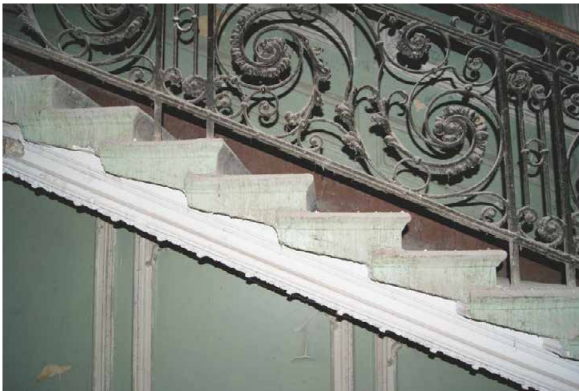
24. Фрагмент интерьера парадной лестницы со стороны Захарьевской улицы. Фрагмент лестничного ограждения (воссоздается).
