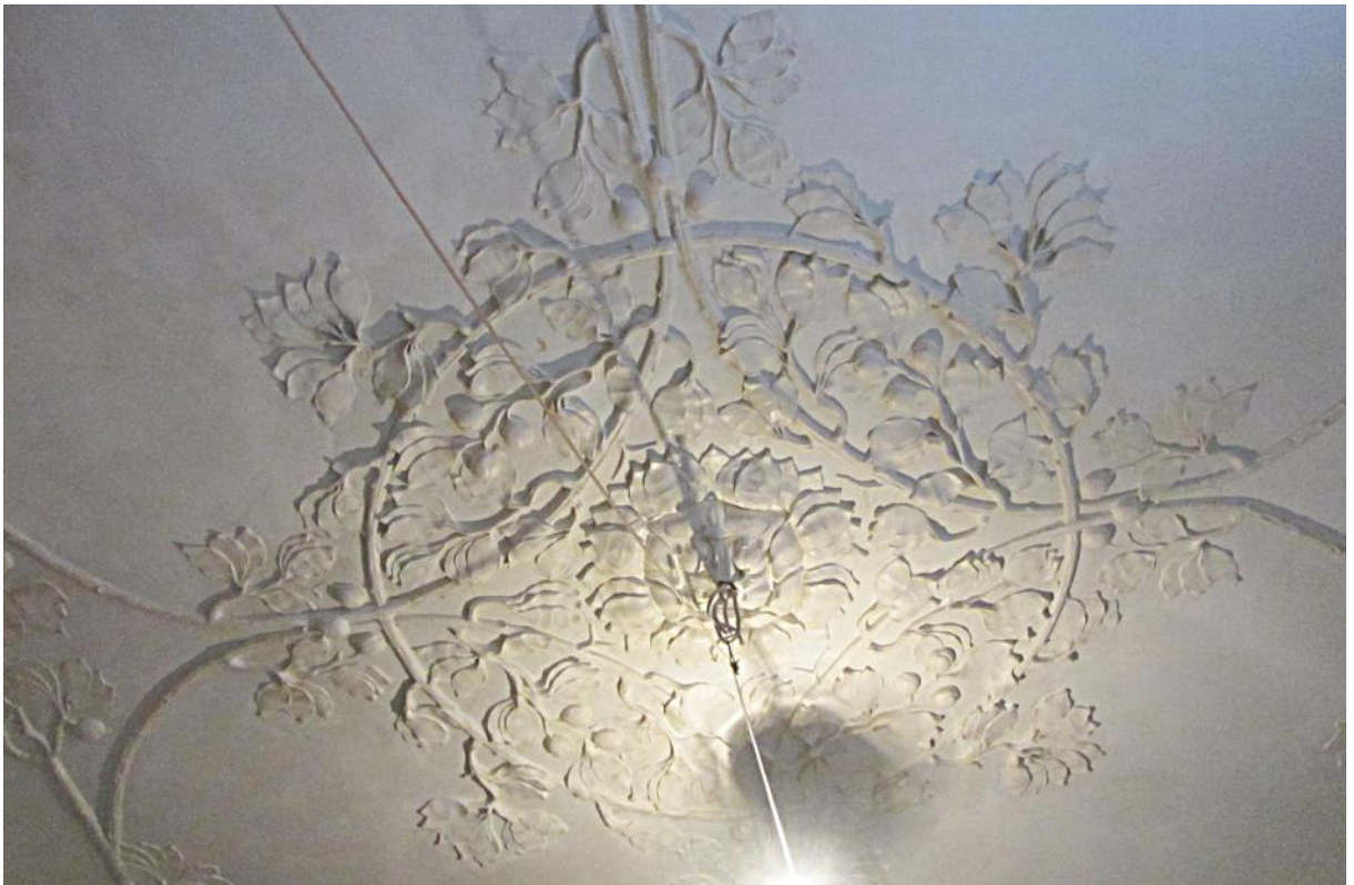
163. 3 этаж, кв. 6, пом. 8. Центральная часть плафона.
