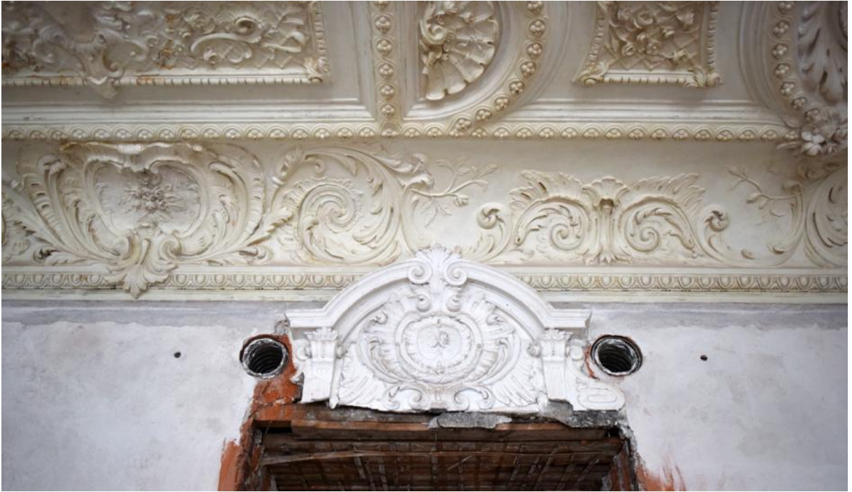
170. 4 этаж, кв. 8, пом. 3. Десюдепорт над дверным проемом в пом. 1.
