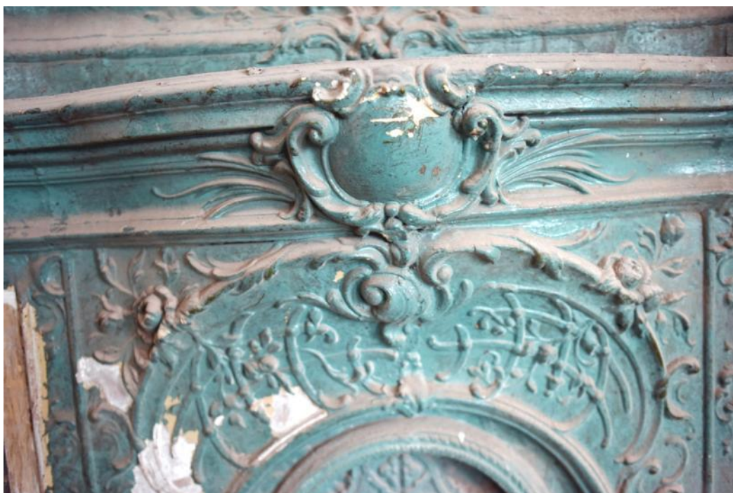
149. 3 этаж, кв. 6, пом. 3. Печь угловая. Фрагмент.
