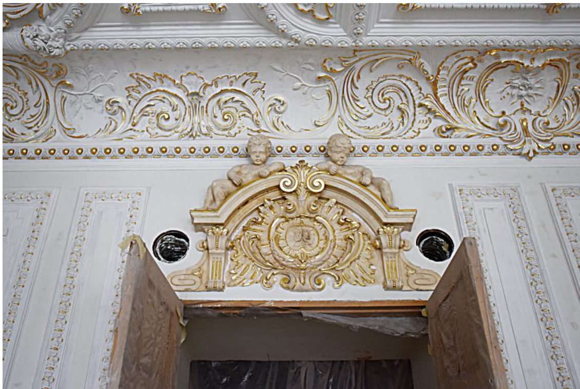
59. 3 этаж, кв. 5, пом. 10. Десюдепорт над дверным проемом в пом.1. Фрагмент падуги.
