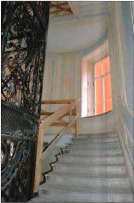
10. Лестница 2ЛК. Фотофиксация от 15.09.2021.
