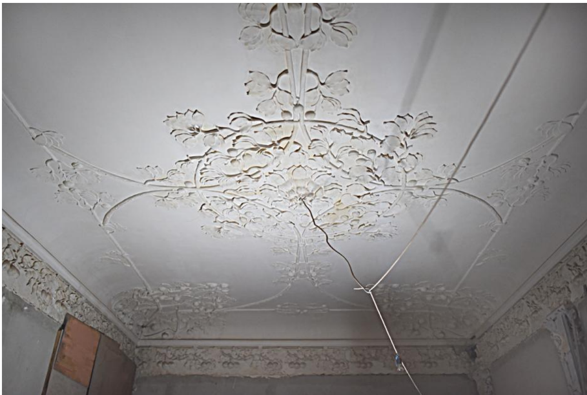
116. 1 этаж, кв. 2, пом. 7. Общий вид помещения
