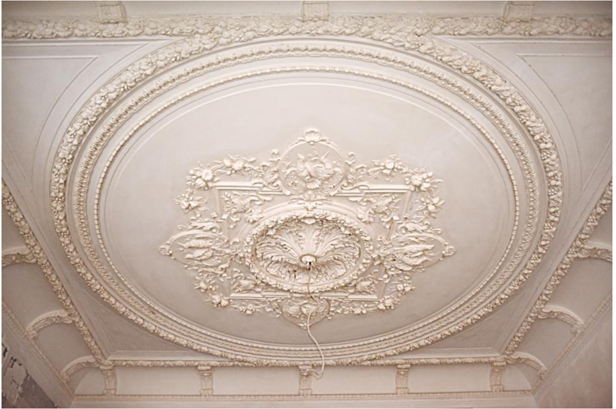
40. 3 этаж, кв. 5, пом.3. Общий вид плафона центральной части.
