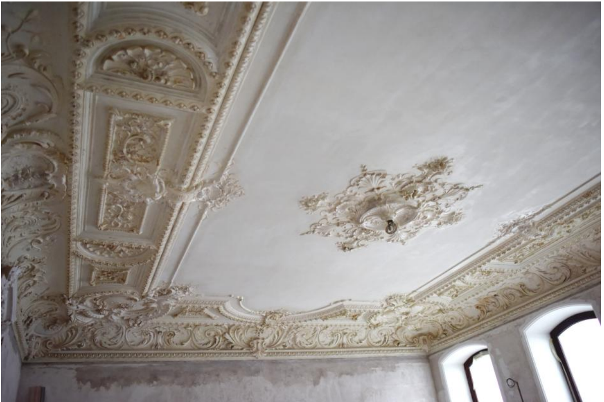
165. 4 этаж, кв. 8, пом. 3. Общий вид плафона пом. 3.
