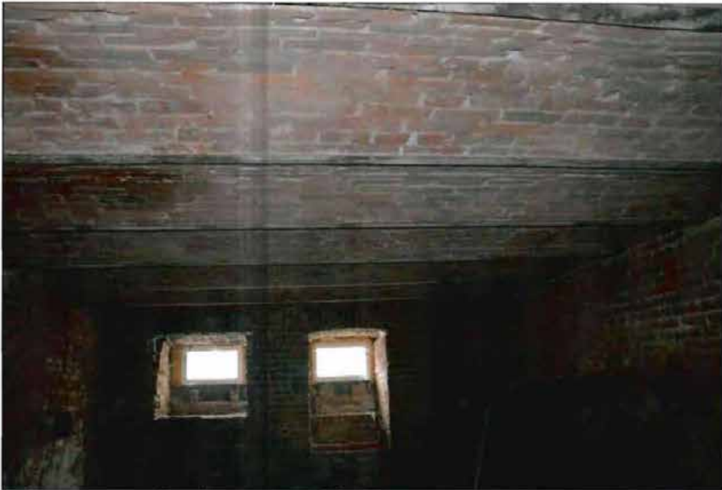
7. Своды подвала. Фотофиксация от 15.09.2021.
