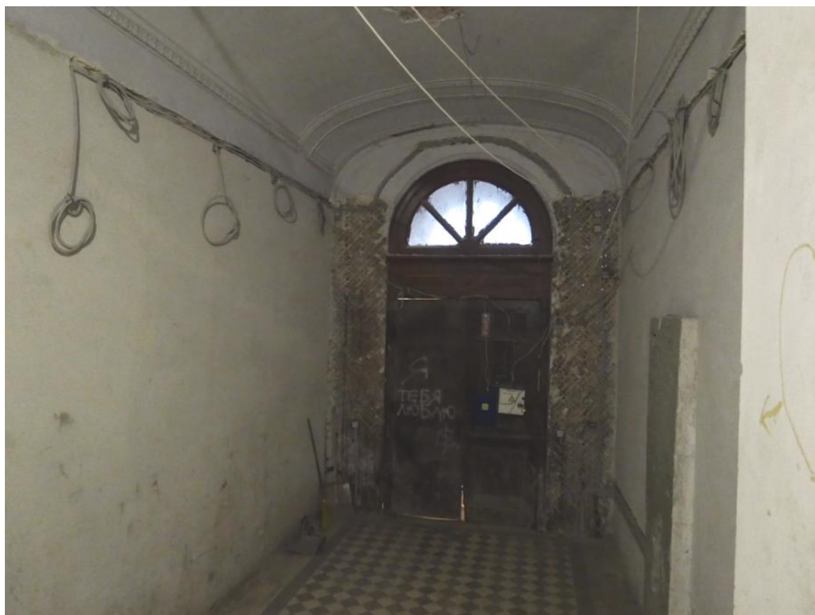
18. Объект культурного наследия регионального значения «Дом К.А. Шрейбера». Общий вид вестибюля парадной лестницы со стороны Захарьевской улицы. Вид в сторону главного входа. Пол с метлахской плиткой.
