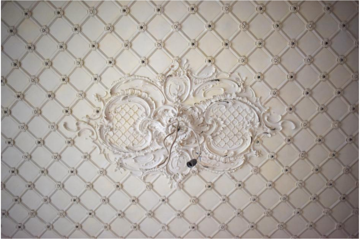
127. 2 этаж, кв. 4, пом. 4. Центральная часть плафона. Розетка.
