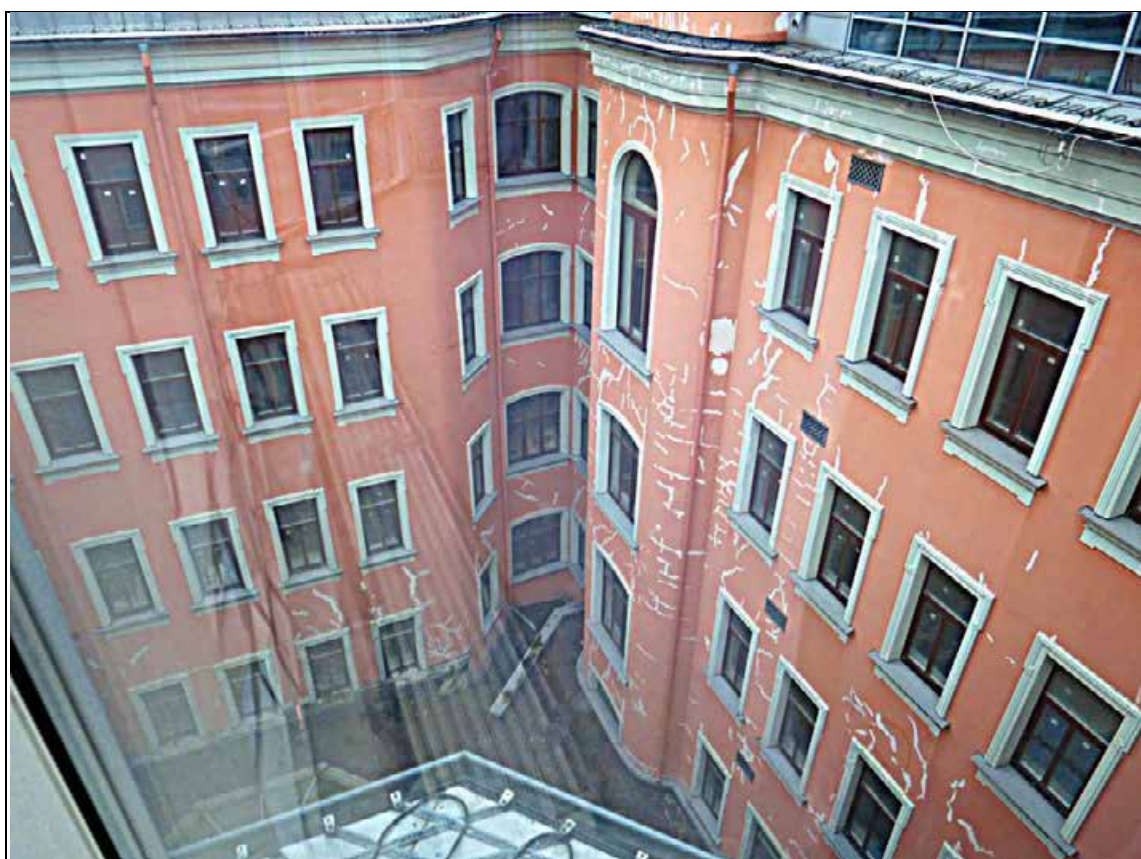
8. Объект культурного наследия регионального значения «Дом К.А. Шрейбера», дворовые фасады, общий вид
