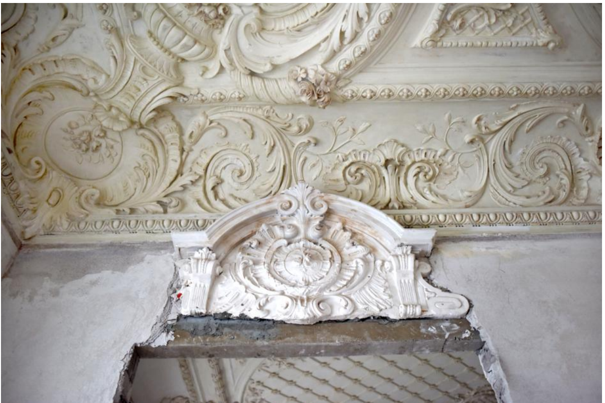
171. 4 этаж, кв. 8, пом. 3. Десюдепорт над дверным проемом в пом. 4.
