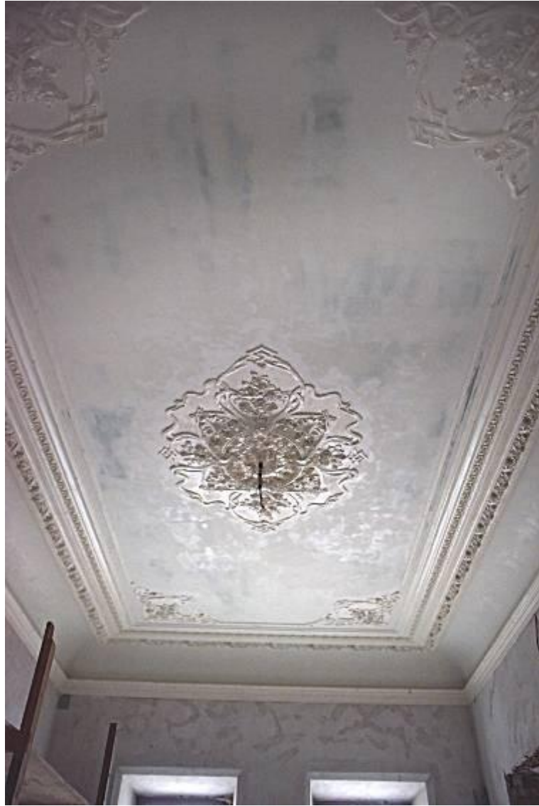
84. 2 этаж, кв. 12, пом. 6. Общий вид помещения.
