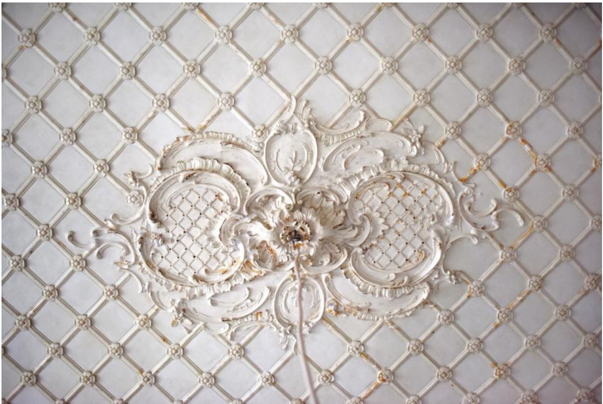
173. 4 этаж, кв. 8, пом. 4. Центральная розетка плафона.
