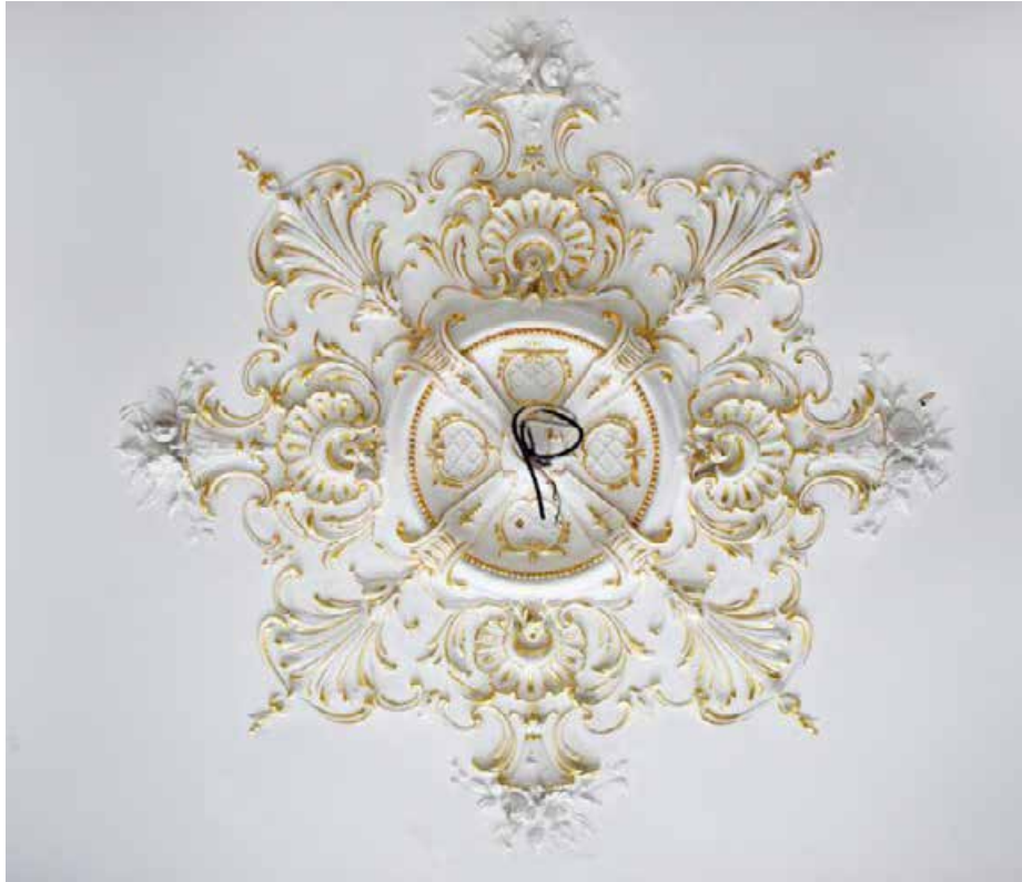
57. 3 этаж, кв. 5, пом. 10. Центральная розетка плафона.
