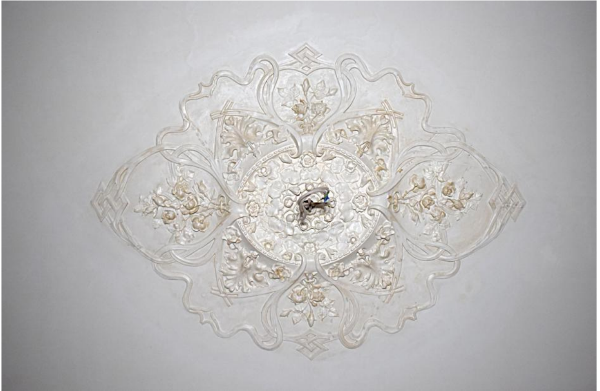
132. 2 этаж, кв. 4, пом. 5. Центральная розетка плафона.
