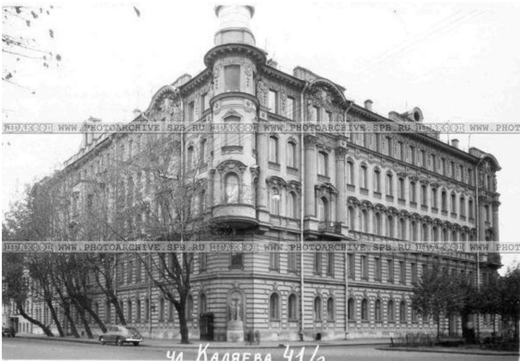
Илл. 38. 1950-е годы. Общий вид здания. Отсутствуют шатровые башенки и круглые скульптуры на ризалитах на фасаде по Потемкинской ул. Авторское объемно – пространственное решение в целом сохранилось. ЦГА КФФД (электронный ресурс).
