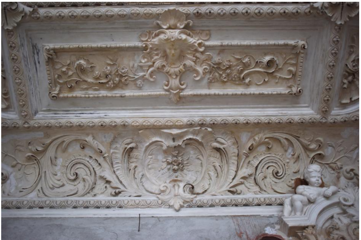
104. 1 этаж, кв. 2, пом. 2. Фрагмент падуги плафона. Фрагмент десюдепорта.
