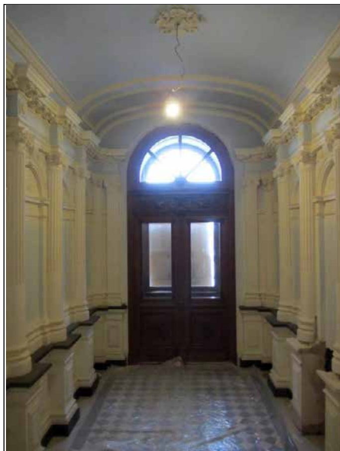
13. Объект культурного наследия регионального значения «Дом К.А. Шрейбера». Общий вид вестибюля парадной лестницы со стороны Потемкинской улицы. Вид в сторону главного входа.
