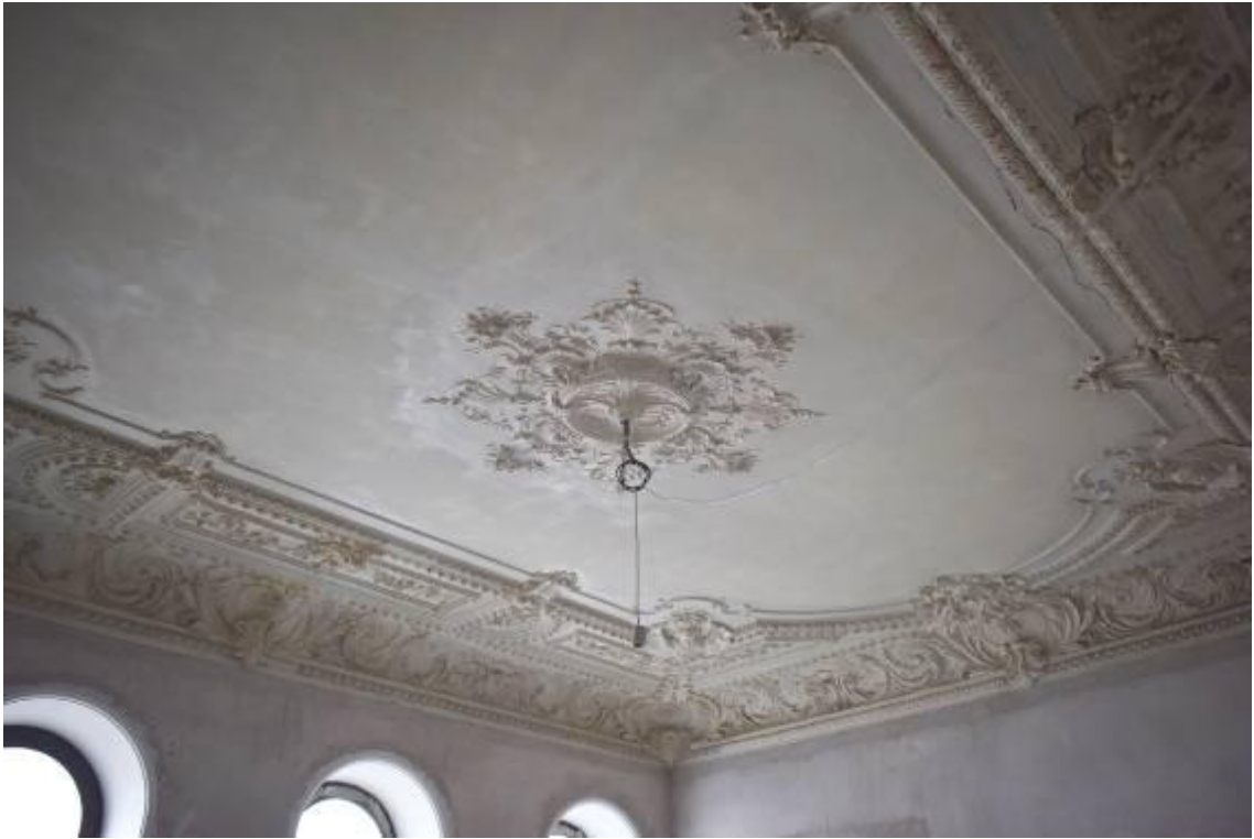
87. 3 этаж, кв. 14, пом. 4,3, объединенные посредством объединения и возвращения первоначальных габаритов комнаты. Общий вид плафона.
