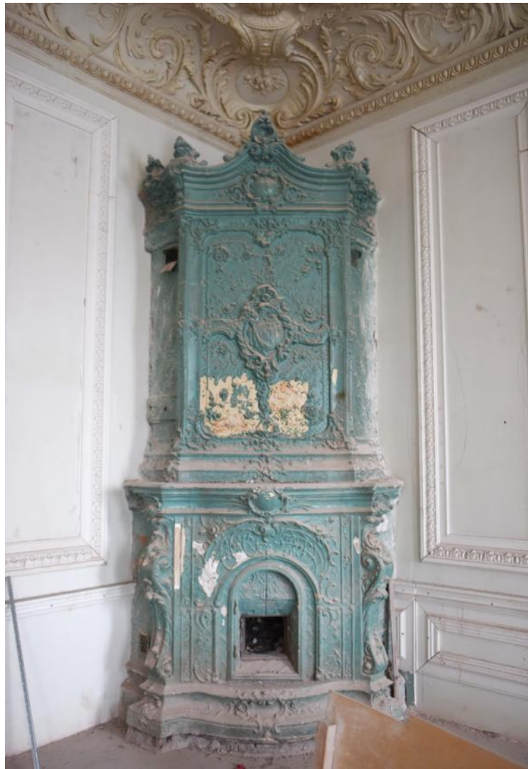
148. 3 этаж, кв. 6, пом. 3. Печь угловая. Общий вид.
