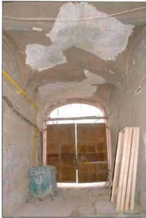
5. Своды арочного проезда со стороны Захарьевской улицы. Фотофиксация от 15.09.2021.
