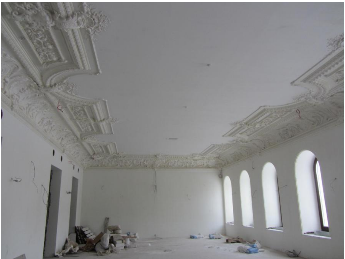
68, 69. 1 этаж, кв. 11. Объединенные помещения 2, 3, 4, 5, 13. Общий вид.
