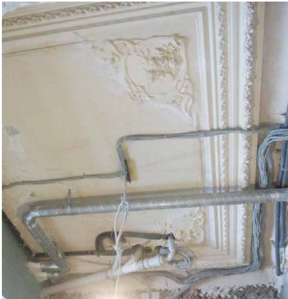
48, 49. 3 этаж, кв. 5, пом. 8.
