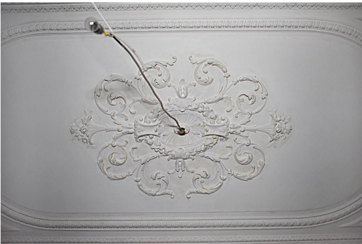
112. 1 этаж, кв. 2, пом. 6. Центральная розетка плафона.
