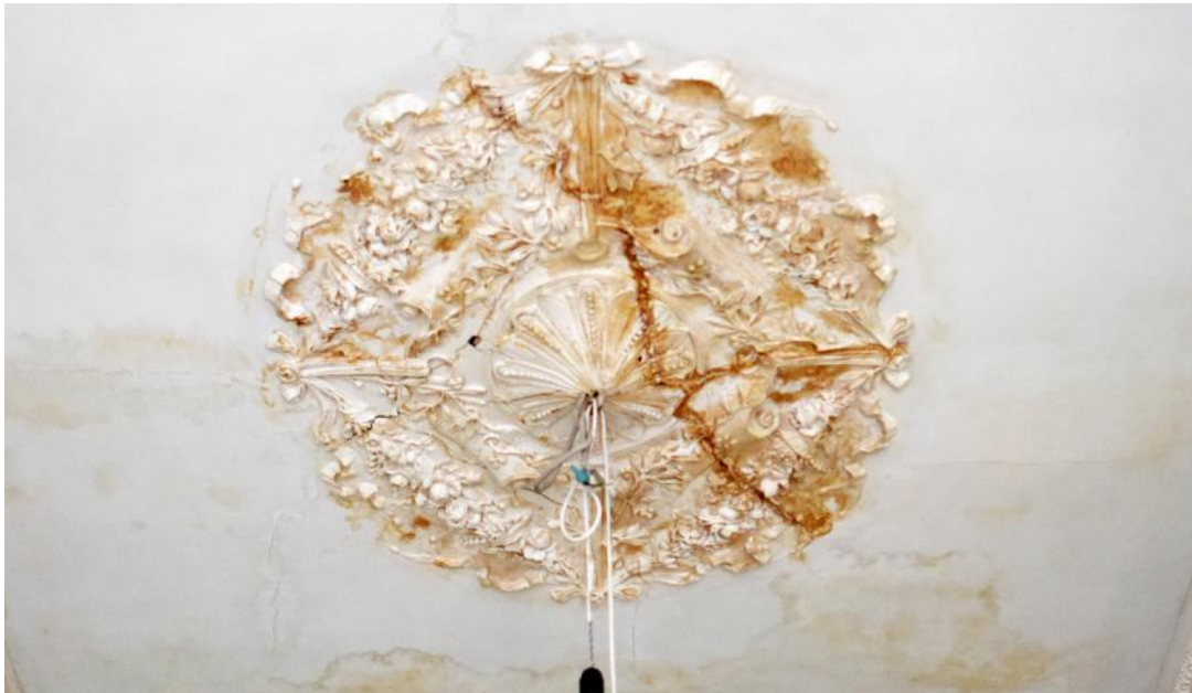
46. 3 этаж, кв. 5, пом.7. Центральная розетка плафона.
