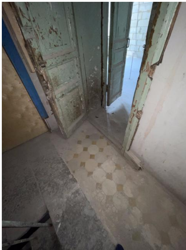
28. Объект культурного наследия регионального значения «Дом К.А. Шрейбера». Лестничная площадка «черной» лестницы (Л-4).
