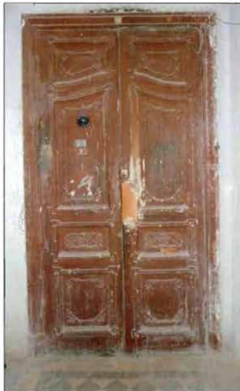
13. Двери на лестничной клетке 1ЛК. Фотофиксация от 14.10.2021.
