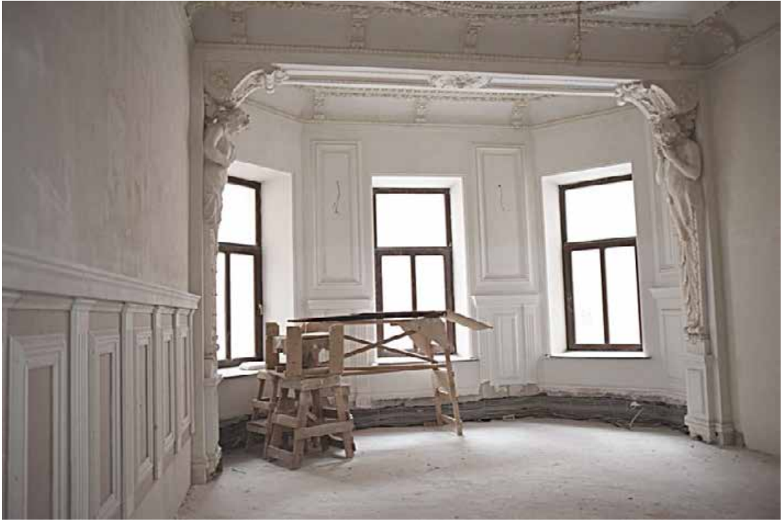
38. 3 этаж, кв. 5, пом.3. Общий вид пом. 3 в сторону эркера.
