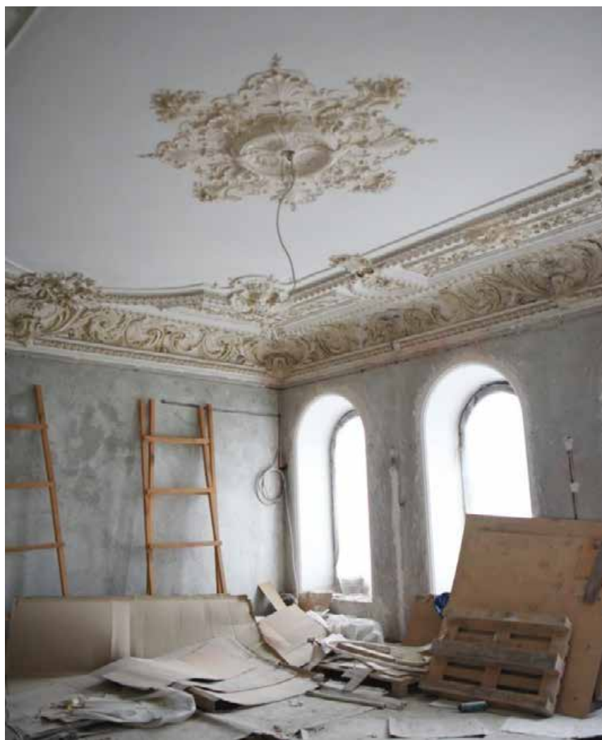
98. 1 этаж, кв. 2, пом. 2. Общий вид помещения.
