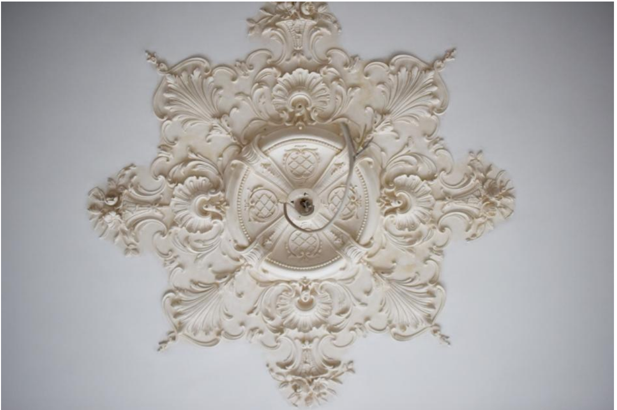
100. 1 этаж, кв. 2, пом. 2. Центральная часть плафона. Розетка.
