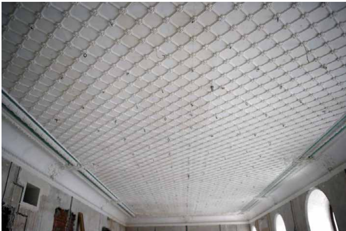
29. 1 этаж, кв. 1. Лицевая анфилада, объединенная в одно помещение (7, 8, 9, 10).
