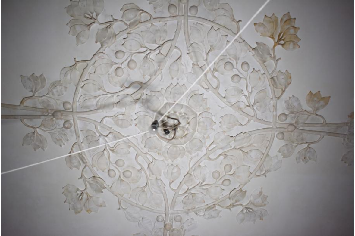
139. 2 этаж, кв. 4, пом. 7. Центральная розетка плафона.
