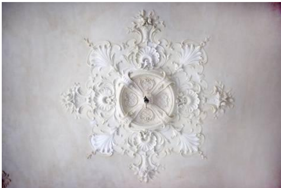
77. 2 этаж, кв. 12, пом.3,4. Центральная часть плафона. Розетка.
