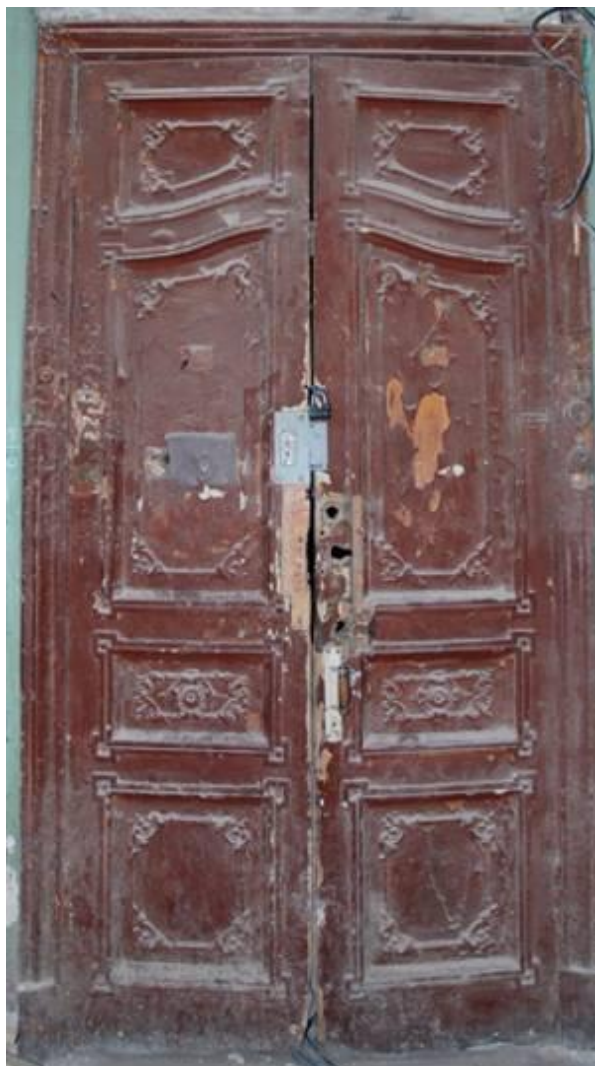
17. Фрагмент интерьера парадной лестницы со стороны Потемкинской улицы. Дверные заполнения.
