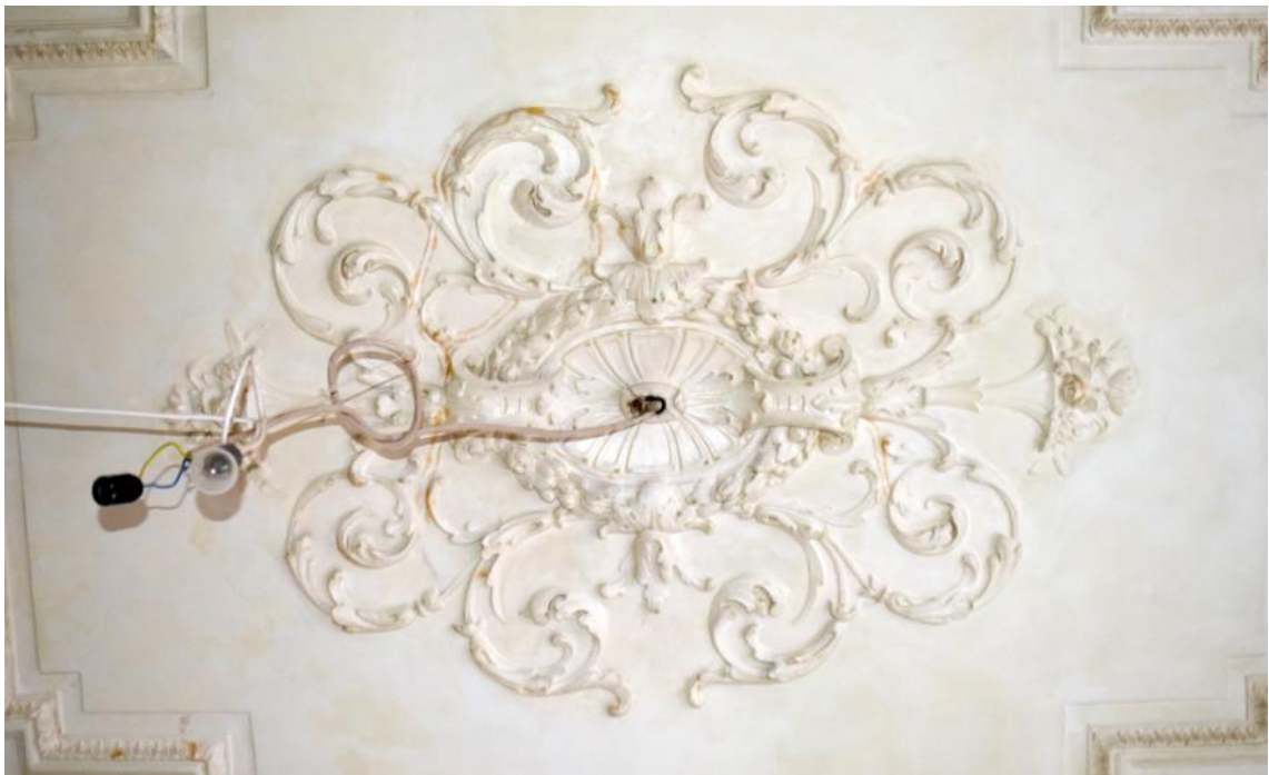
36. 3 этаж, кв. 5, пом.2. Центральная розетка плафона.
