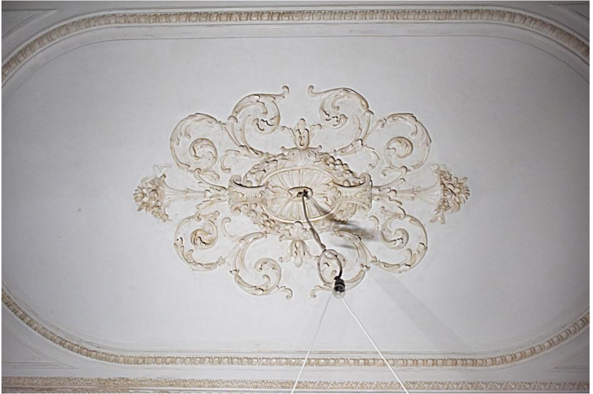
135. 2 этаж, кв. 4, пом. 6. Центральная розетка плафона.
