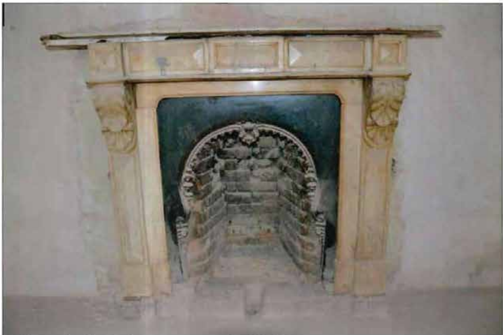
27. Камин (кв. № 12). Фотофиксация от 15.09.2021.
