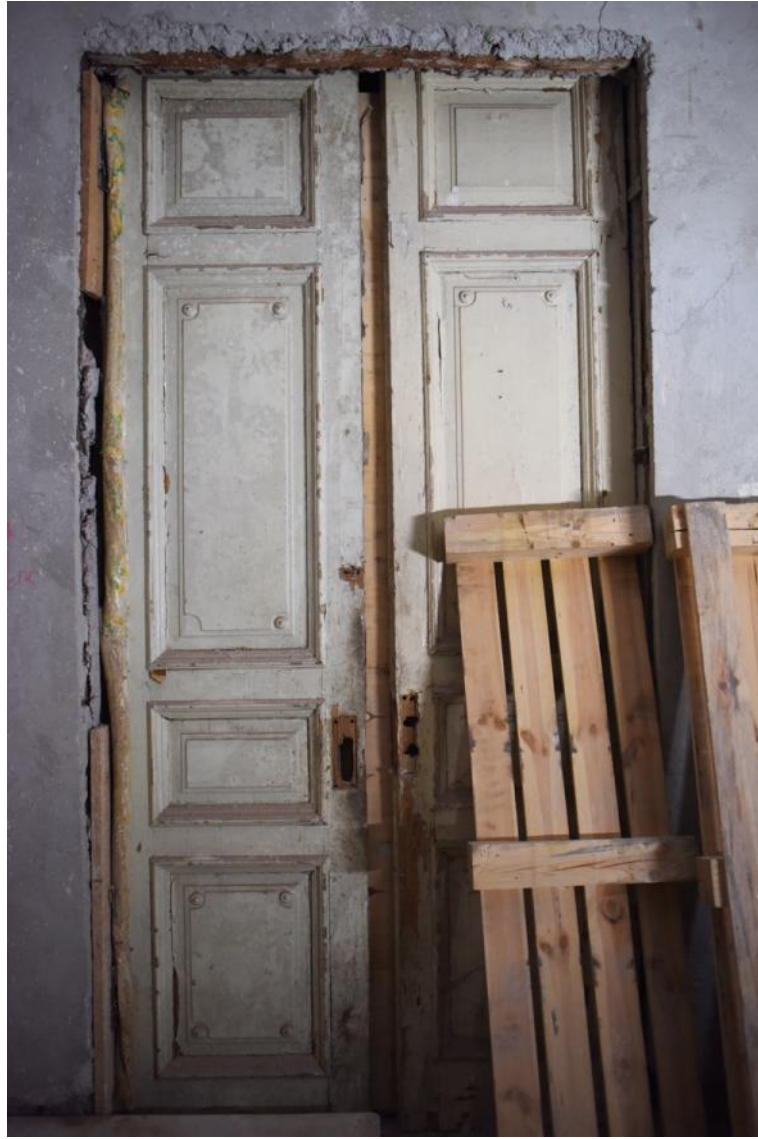
115. 1 этаж, кв. 2, пом. 6. Заполнение дверного проема.
