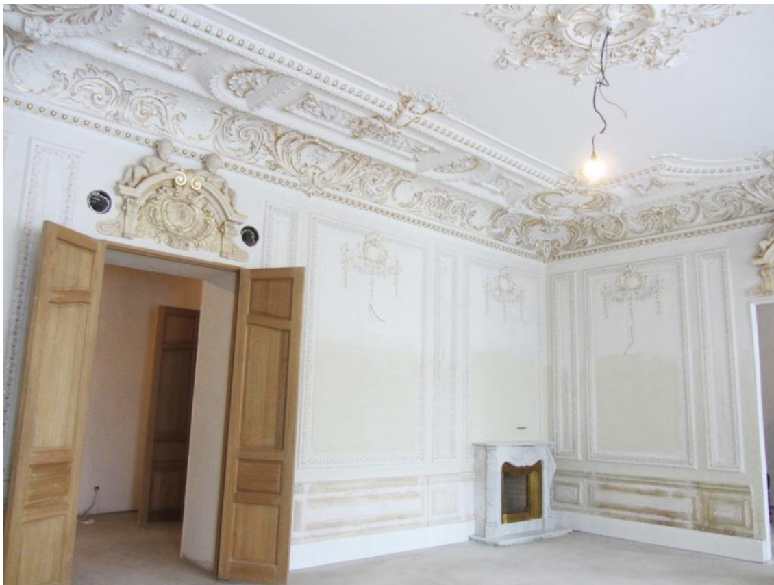
61. 3 этаж, кв. 5, пом. 10. Общий вид помещения в сторону камина.
