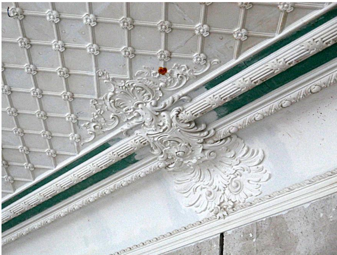
30. 1 этаж, кв. 1. Лицевая анфилада, объединенная в одно помещение (7, 8, 9, 10). Фрагмент лепного декора.
