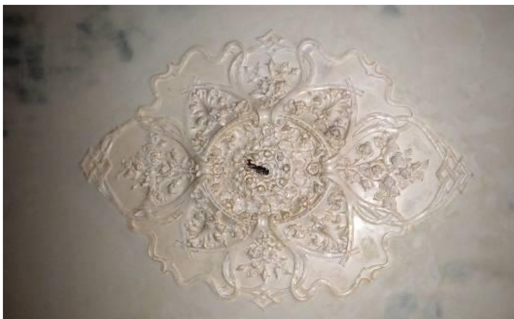
85. 2 этаж, кв. 12, пом. 6. Центральная розетка плафона.
