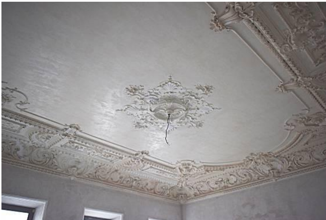
76. 2 этаж, кв. 12, пом.3,4. Комната, восстановленная из пом. 3 и 4 в результате их объединения и демонтажа поздних перегородок. Общий вид плафона.
