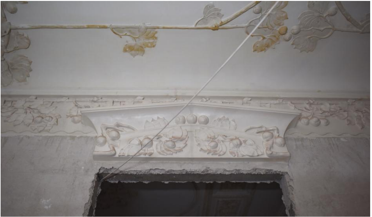
137. 2 этаж, кв. 4, пом. 7. Десюдепорт дверного проема в комнату пом. 6.
