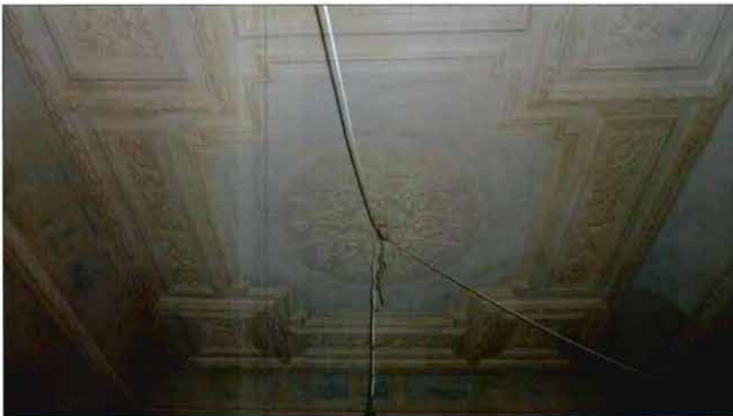
15. Оформление потолка (кв. № 3). Фотофиксация от 14.10.2021.
