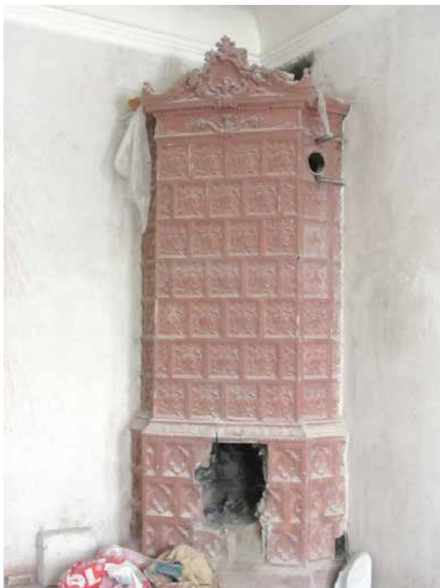
67. 5 этаж, кв. 9, пом. 6. Угловая печь.
