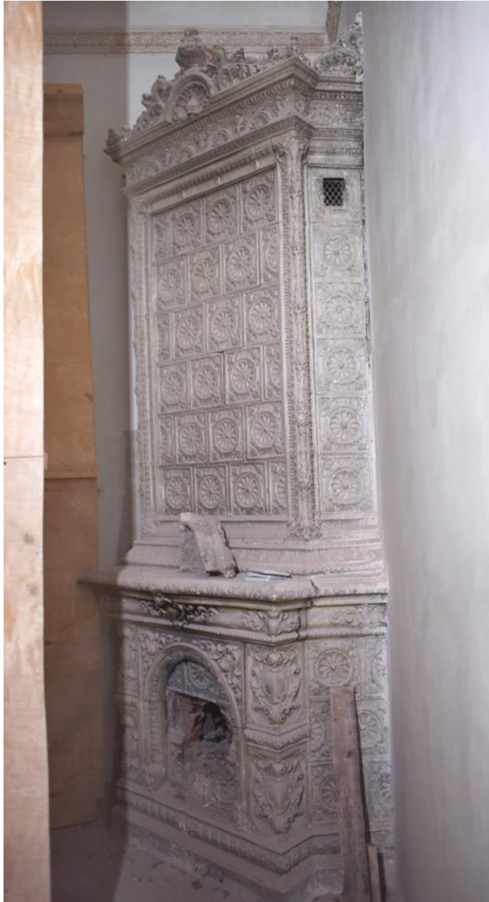
161. 3 этаж, кв. 6, пом. 7. Общий вид угловой печи.
