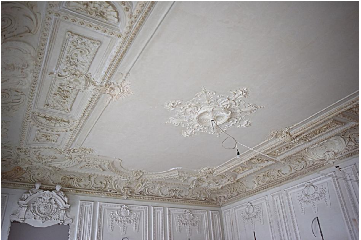
141. 3 этаж, кв. 6, пом. 3. Общий вид помещения.
