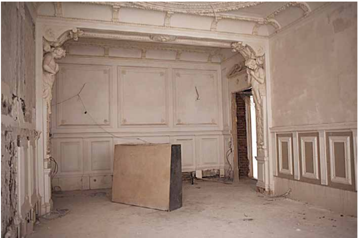
39. 3 этаж, кв. 5, пом.3. Общий вид пом. 3 от эркера.
