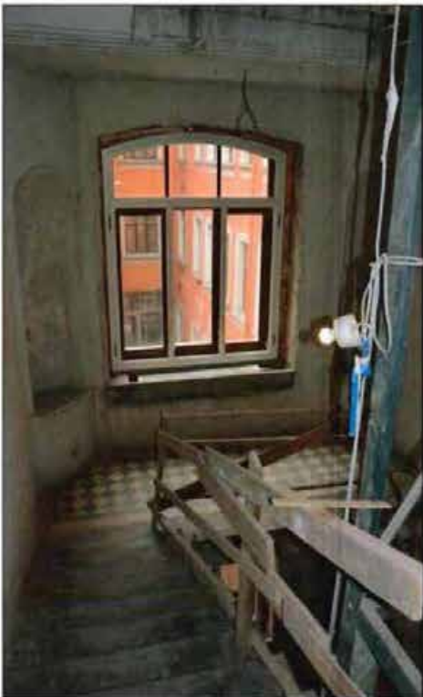
12. Лестница 1ЛК. Фотофиксация от 15.09.2021.
