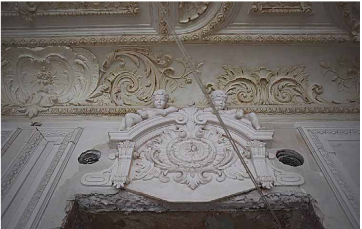
144. 3 этаж, кв. 6, пом. 3. Десюдепорт дверного проема в помещении 1. Фрагмент падуги.
