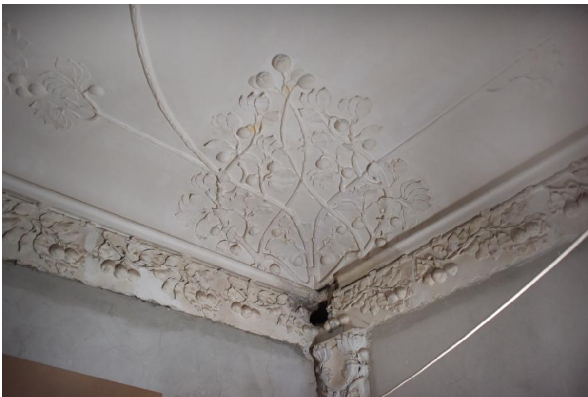
117. 1 этаж, кв. 2, пом. 7. Угловая часть: плафон, фриз, капитель, пилястра.
