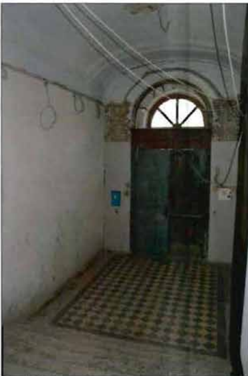
8. 1ЛК. Вестибюль. Фотофиксация от 15.09.2021.
