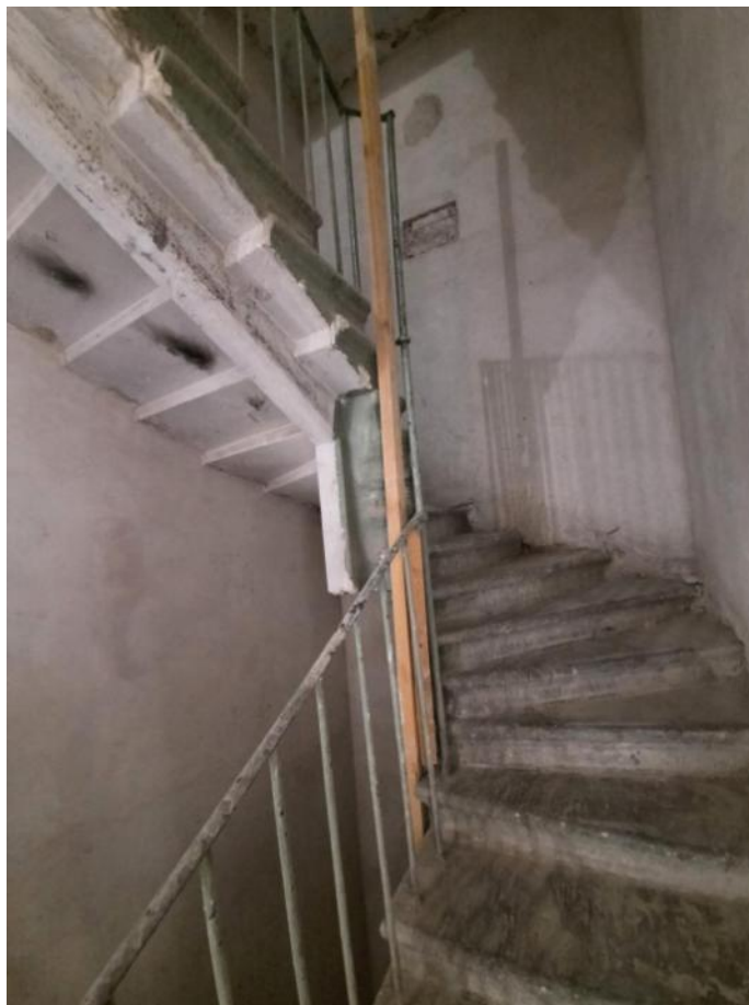
27. Объект культурного наследия регионального значения «Дом К.А. Шрейбера». Общий вид «черной» лестницы (Л-4).
