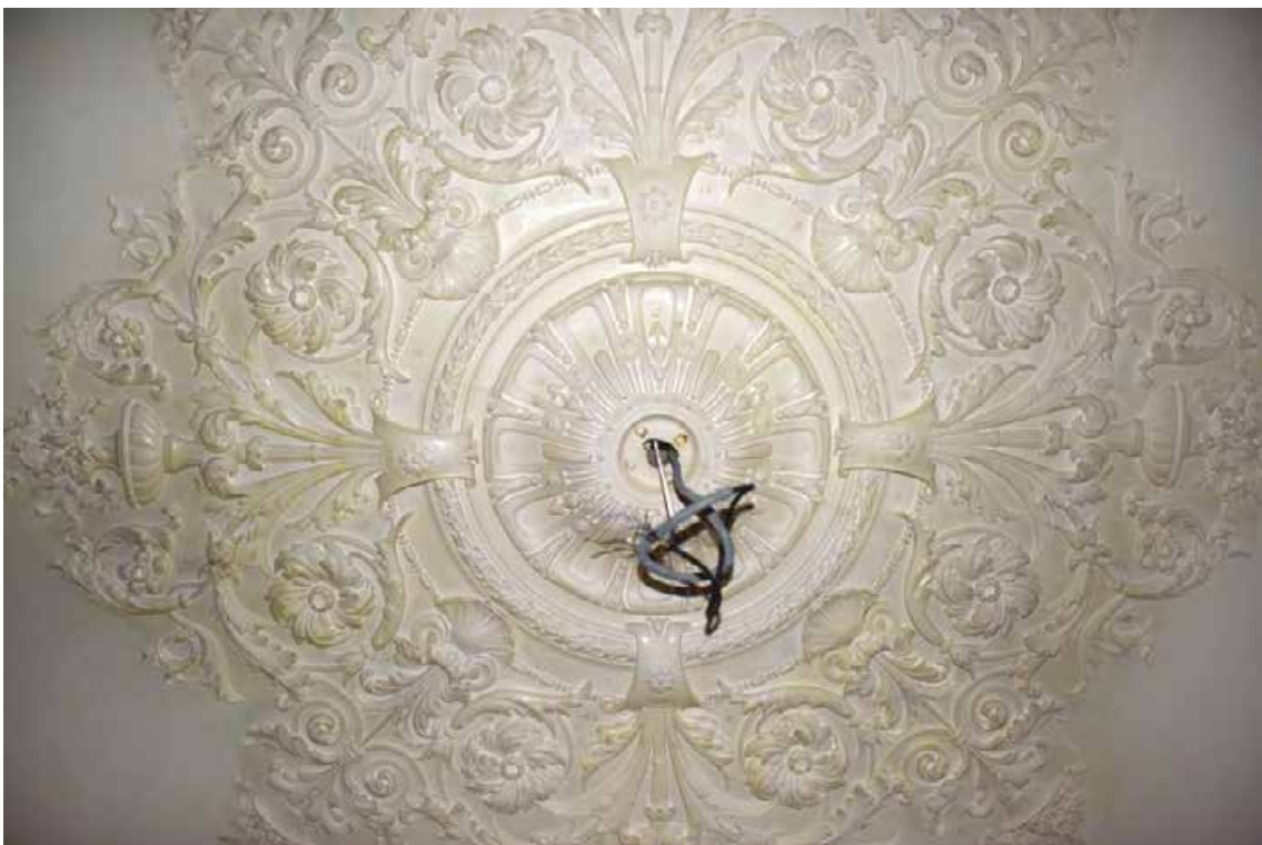
33. 1 этаж, кв. 1, пом. 3. Центральная лепная розетка.
