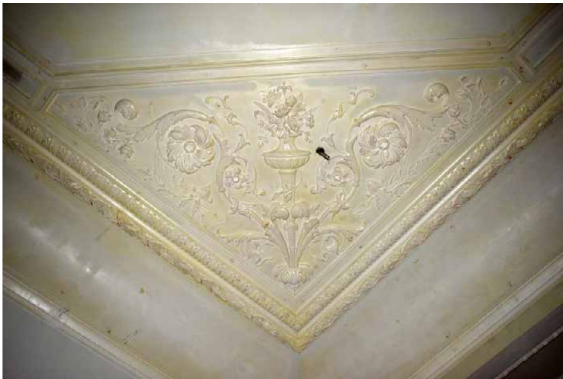
34. 1 этаж, кв. 1, пом. 3. Угловая часть плафона.
