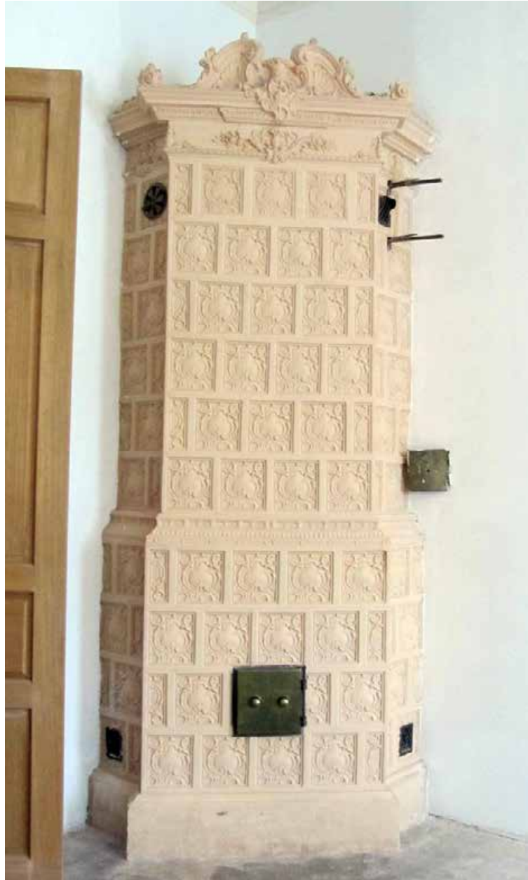
47. 3 этаж, кв. 5, пом.7. Угловая печь.
