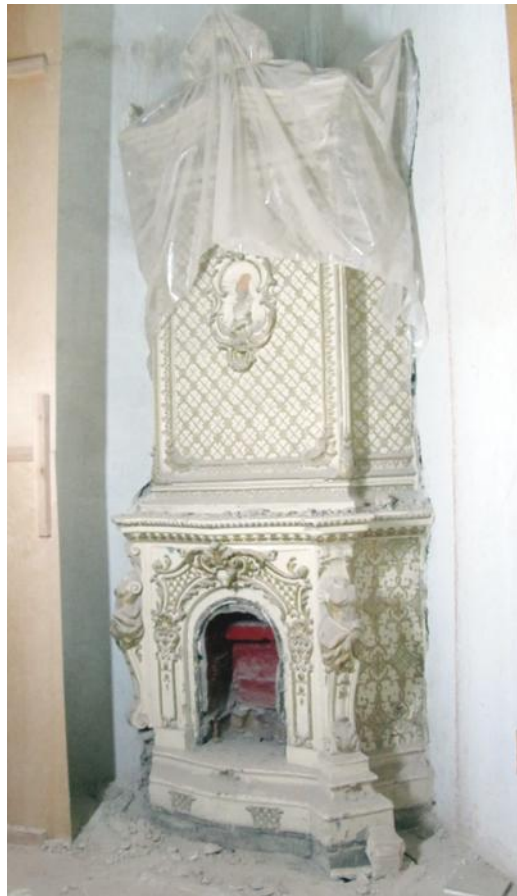
126. 2 этаж, кв. 4, пом. 4. Общий вид угловой печи.
