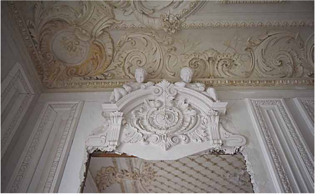
143. 3 этаж, кв. 6, пом. 3. Десюдепорт дверного проема в помещении 4.
