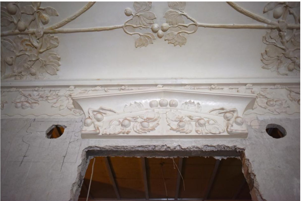
138. 2 этаж, кв. 4, пом. 7. Десюдепорт дверного проема в комнату пом. 1.
