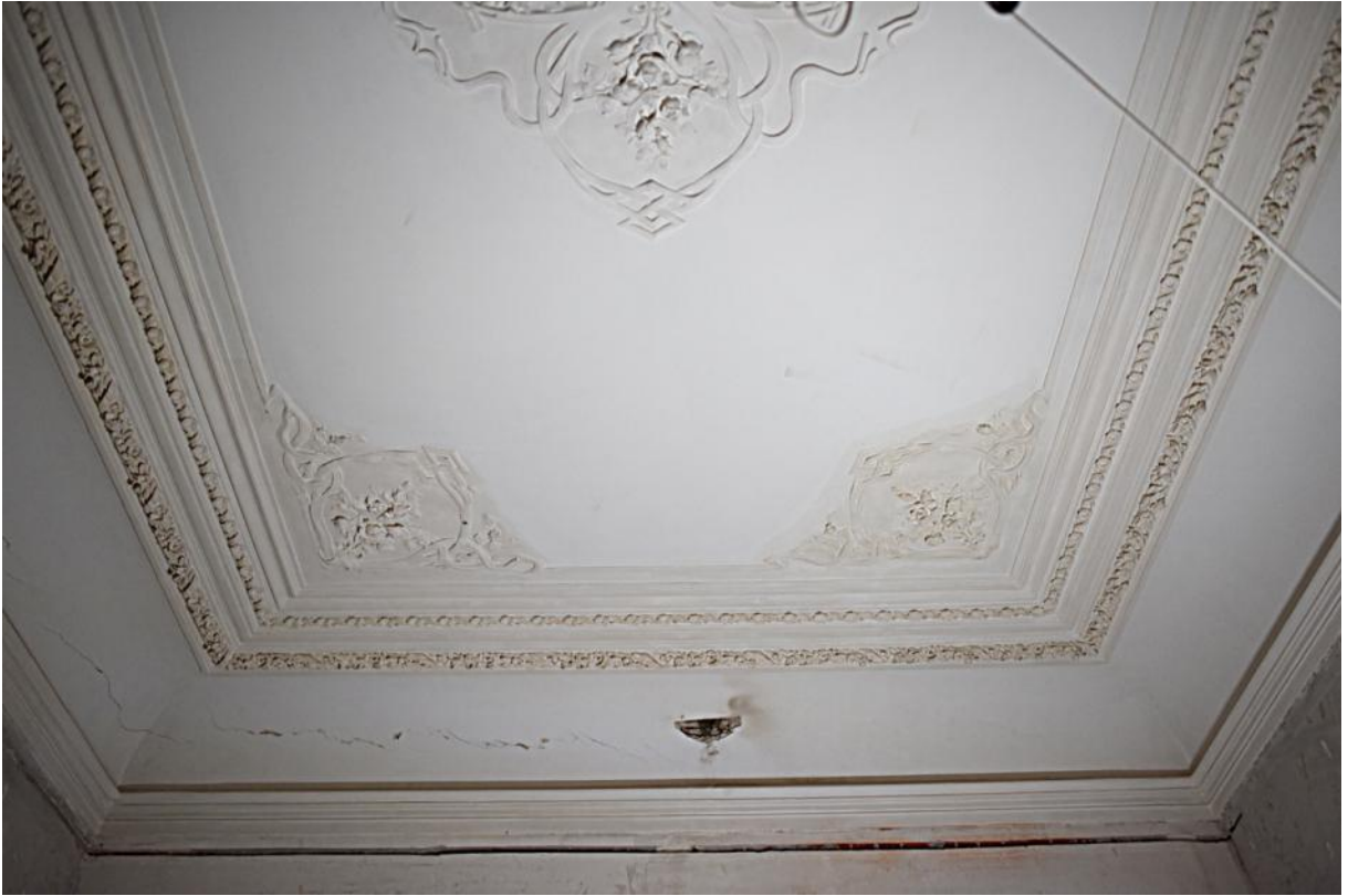
109. 1 этаж, кв. 2, пом. 5. Лепной декор плафона. Фрагмент
