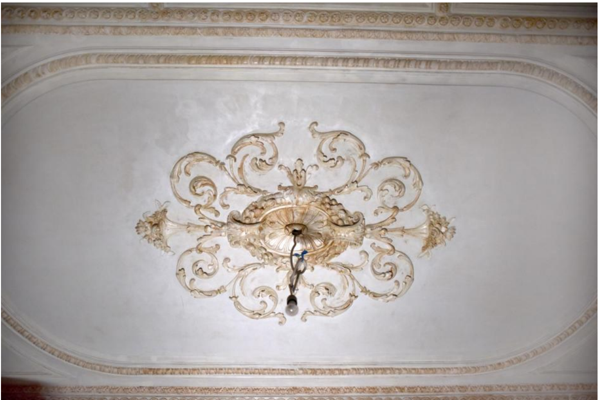
160. 3 этаж, кв. 6, пом. 7. Центральная розетка плафона.
