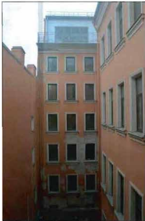
6. Дворовые фасады (южный двор) объекта культурного наследия. Фотофиксация от 15.09.2021.
