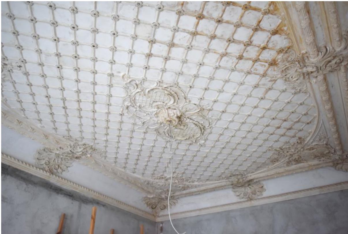
105. 1 этаж, кв. 2, пом. 3. Общий вид помещения.
