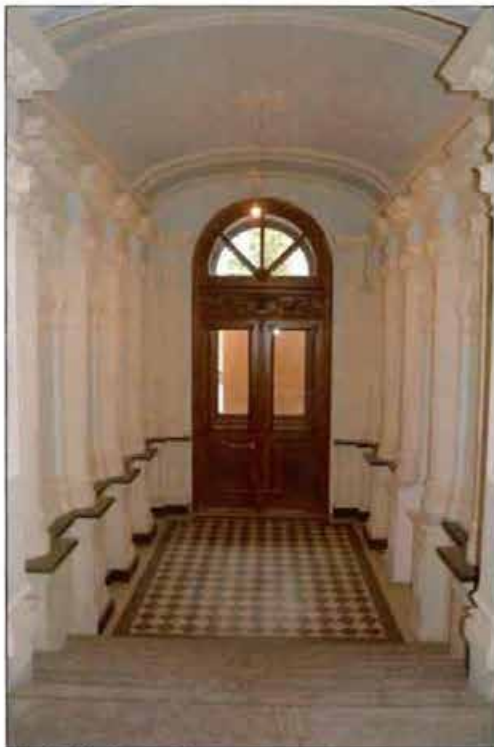
9. 2ЛК. Вестибюль. Фотофиксация от 15.09.2021.
