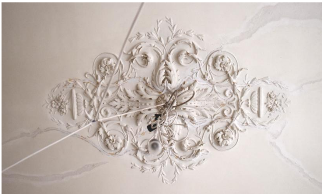
44. 3 этаж, кв. 5, пом.4. Центральная розетка плафона.
