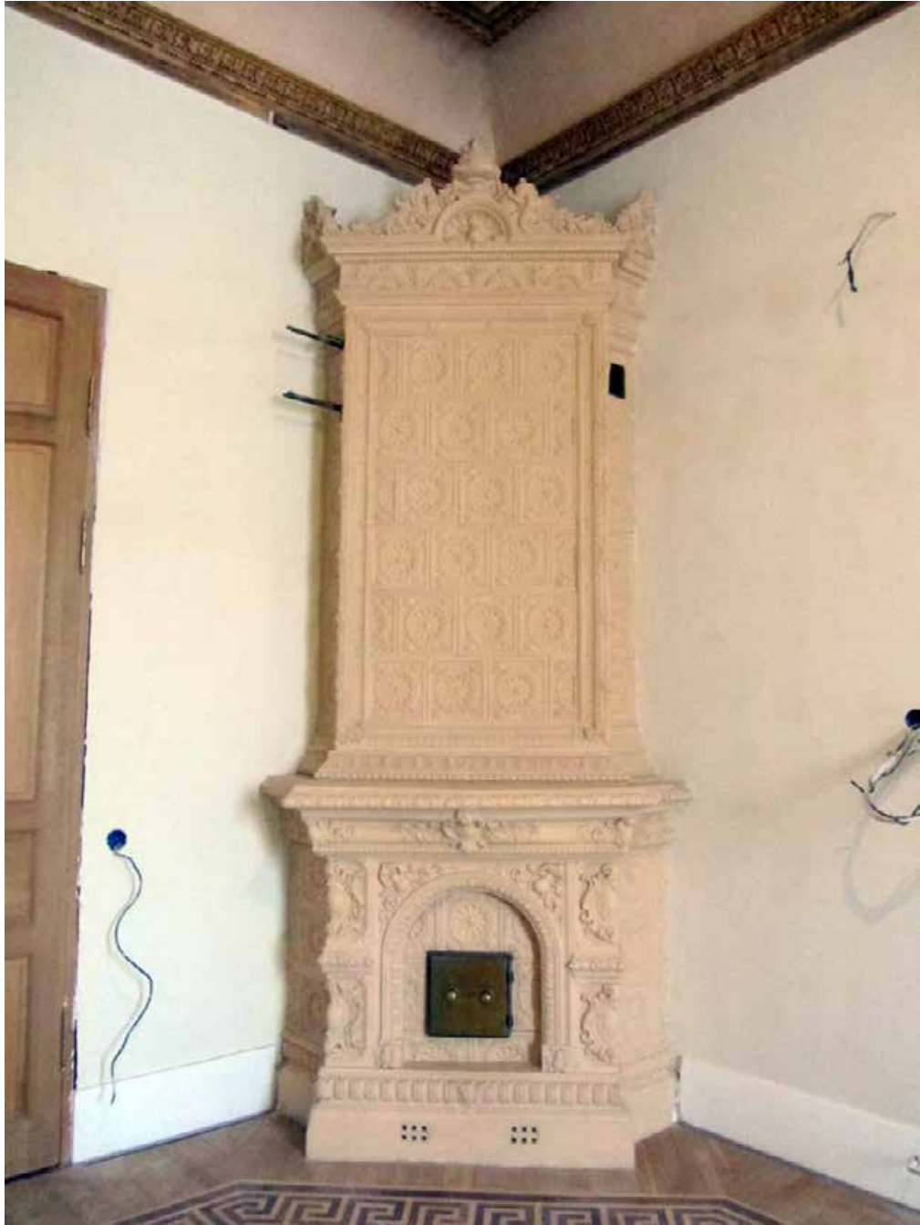
65. 3 этаж, кв. 5, пом. 11. Угловая изразцовая печь.
