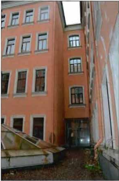
4. Дворовые фасады объекта культурного наследия (северный двор). Фотофиксация от 15.09.2021.
