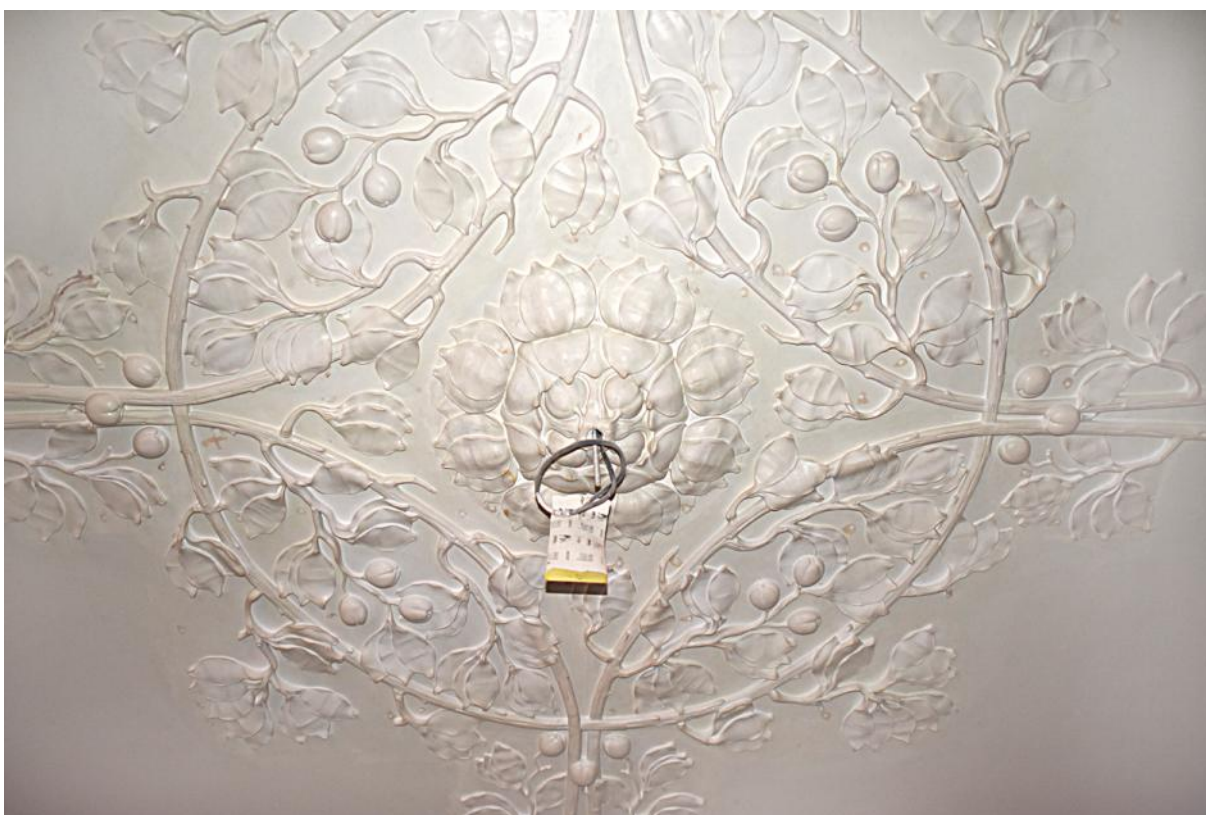
197. 5 этаж, кв. 10, пом. 8. Центральная розетка плафона.
