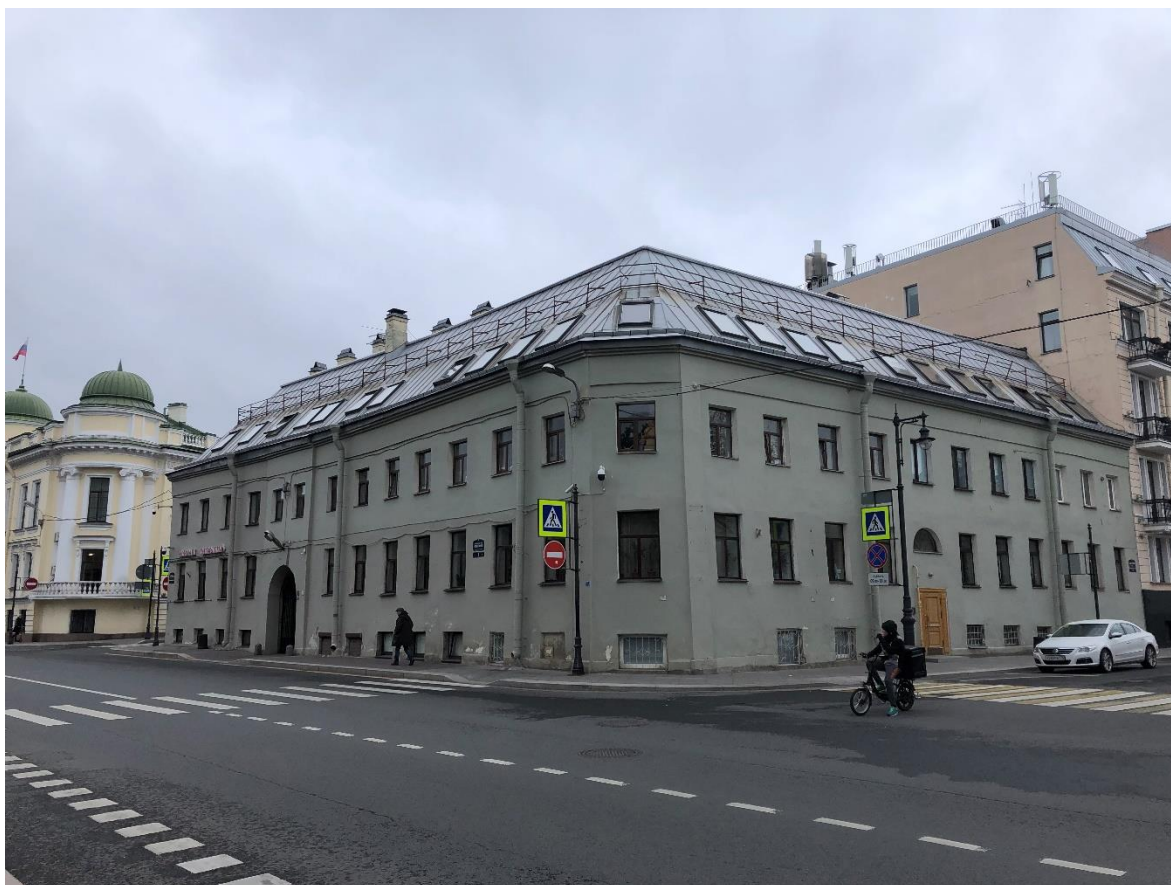
Фото 2. Вид на угол западного и южного фасадов.
