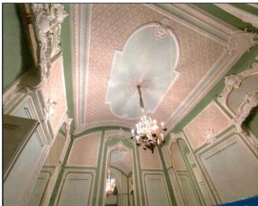
53. Декоративная отделка с зеркалами и лепными элементами (пом. 3-Н (12)). Фото от 16.11.2021 г.
