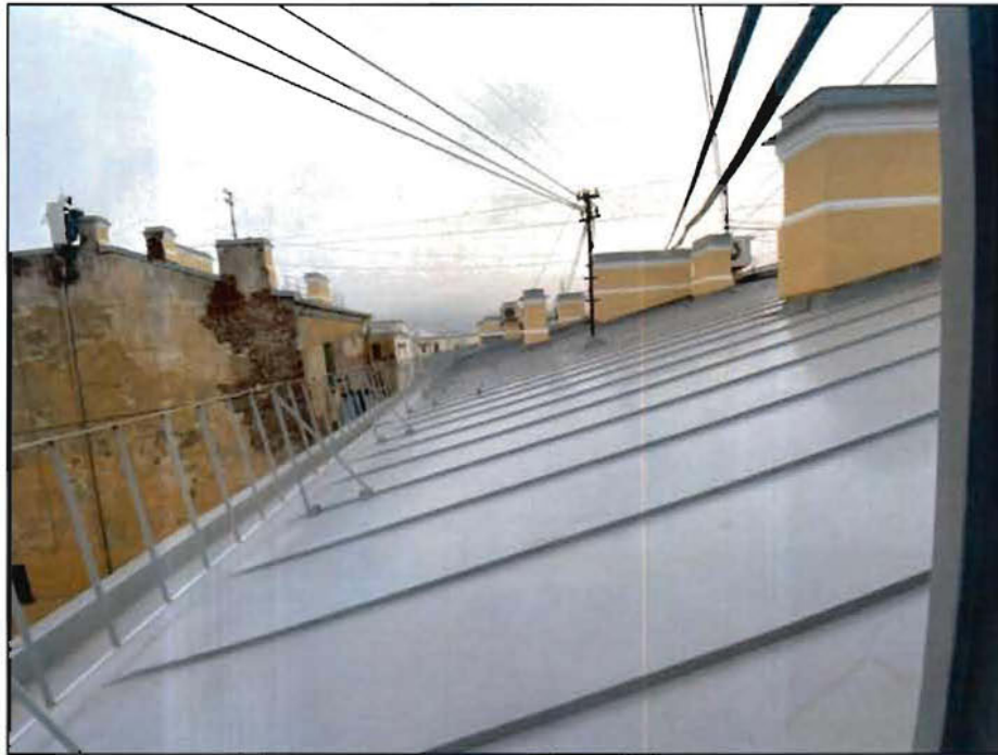
23. Металлическая кровля лицевого корпуса (со стороны пл. Ломоносова и ул. Зодчего Росси). Фото от 16.11.2021 г.
