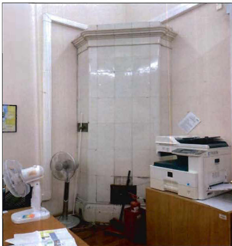
48. Печь белого изразца с профилированным карнизом (пом. 38-Н (8)) в уровне 5-го этажа. Фото от 16.11.2021 г.
