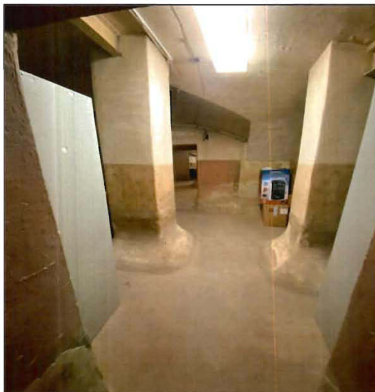
52. Пилоны подвальных помещений. Фото от 19.11.2021 г.
