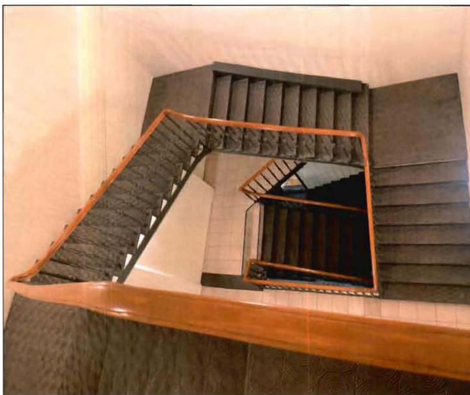
31. Четырехмаршевая железная лестница в пом. 21-Н (20) в угловой части корпусов по пл. Ломоносова и ул. Зодчего Росси. Фото от 16.11.2021 г.
