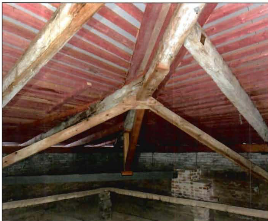
21. Стропильная система лицевого корпуса (со стороны пл. Ломоносова и ул. Зодчего Росси). Фото от 16.11.2021 г.
