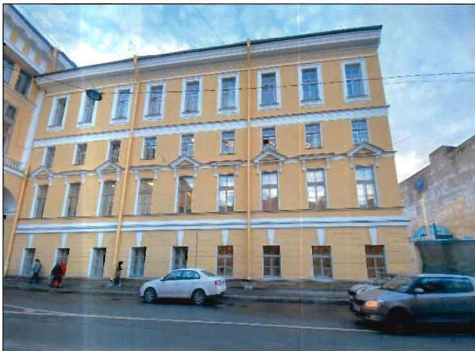
5. Восточный фасад центрального флигеля объекта культурного наследия, обращенного на улицу Ломоносова. Фото от 19.11.2021 г.
