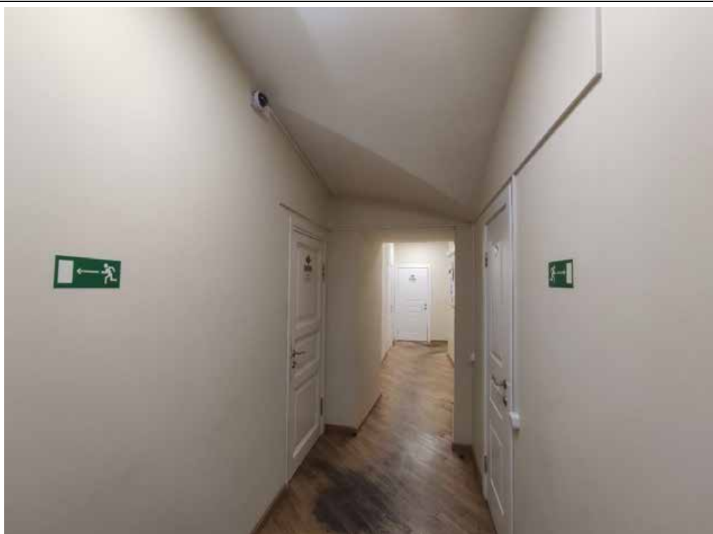
15. Объект культурного наследия федерального значения «Министерство народного просвещения», расположенный по адресу: г. Санкт-Петербург, улица Зодчего Росси, дом 1-3, литера А, входящий в состав объекта культурного наследия федерального значения «Ансамбль улицы Зодчего Росси». Общий вид помещений №№ 23-Н(1,6) антресоли первого этажа.
