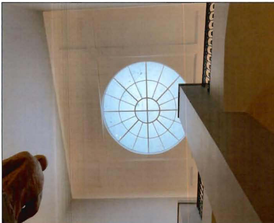
34. Круглый в плане световой фонарь над парадной лестницей № 5 в уровне 6-го этажа (пом.112-Н (67)). Фото от 16.11.2021 г.
