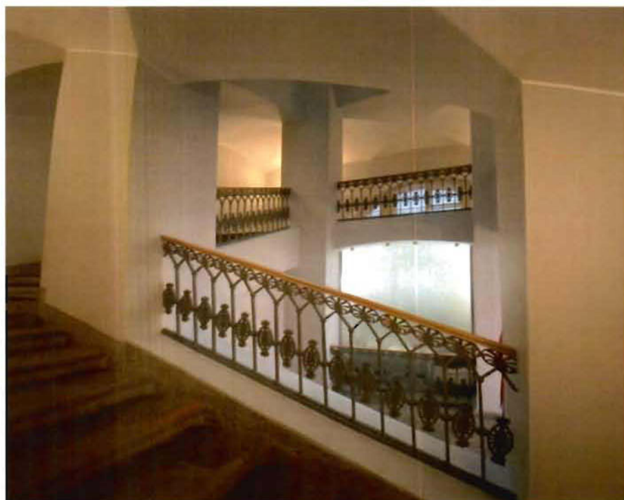
28. Парадная лестница (ЗЛК) со стороны пл. Ломоносова, многомаршевая, на пилонах по ползучим с распалубками и крестовым сводам на подпружных арках. Фото от 16.11.2021 г.
