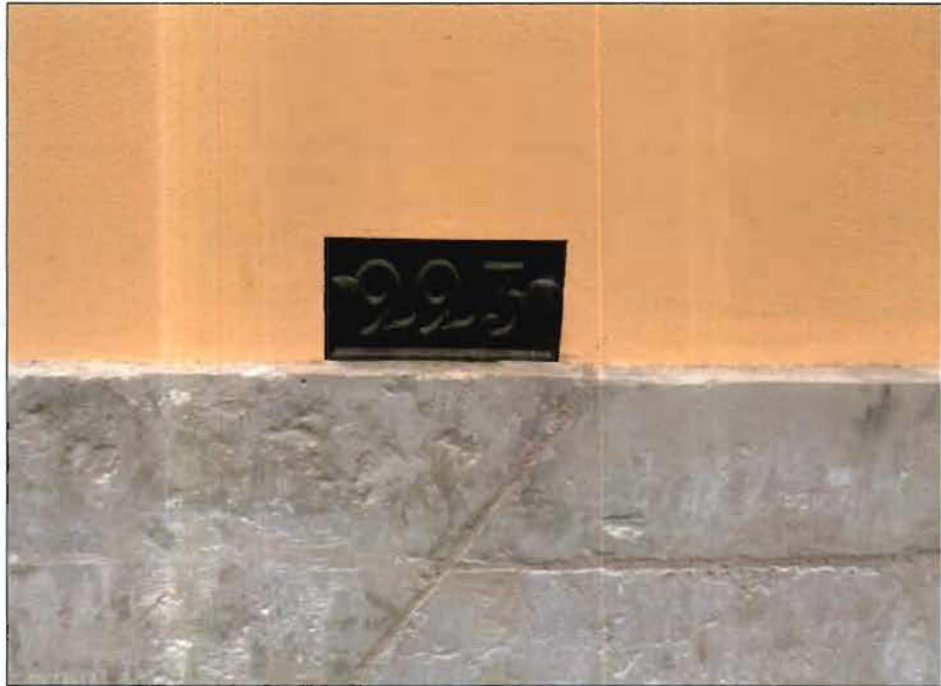
13. Исторический геодезический знак, размещенный со стороны лицевого фасада по улице Зодчего Росси. Фото от 19.11.2021 г.
