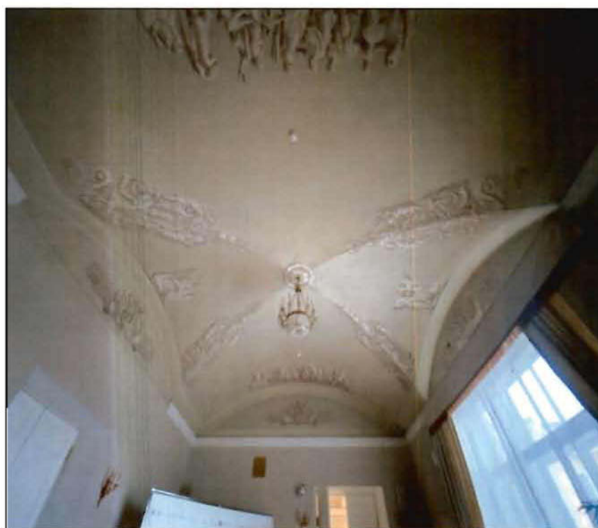
36. Декоративно художественная отделка помещений (пом. 30-Н (33)) в уровне 3-го этажа Живописный плафон. Фото от 16.11.2021 г.
