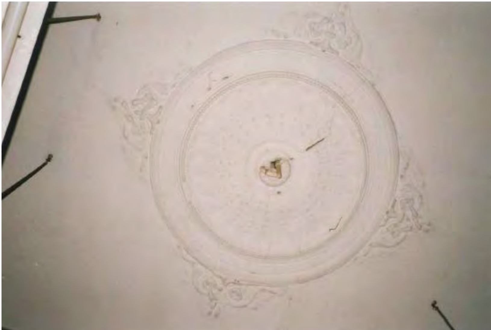
75. Общий вид центральной лепной розетки плафона фойе. 2002 г. // ООО «Капитал-Строй». Проект реконструкции учебного корпуса детского дома-школы № 51. Том 1. Книга 1. Часть 1. Альбом фотоиллюстраций № 1. Дефекты и общие виды фасадов здания. СПб., 2002. С. 12. / КГИОП. П. 1500Б/Пр. 79.
