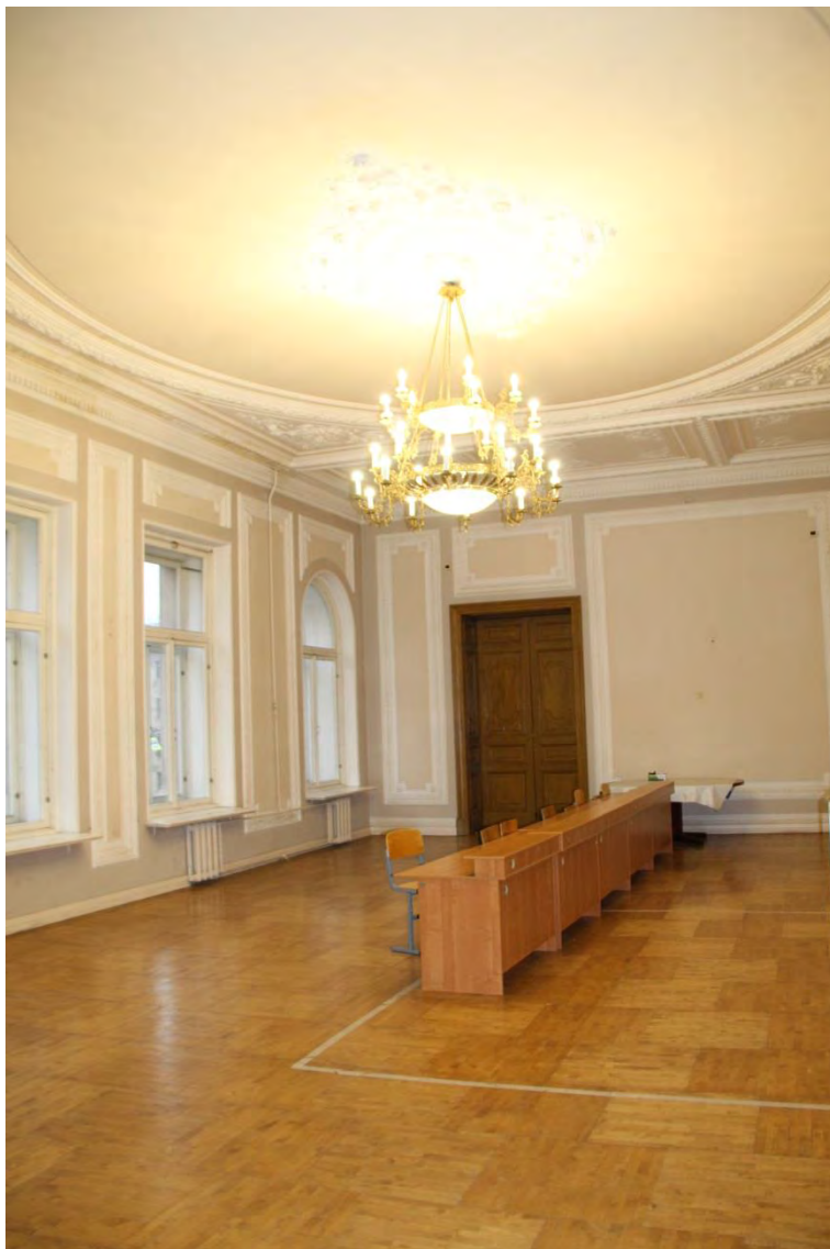
22. Объект культурного наследия регионального значения «Особняк Н.М. Полежаева» по адресу: г. Санкт-Петербург, проспект Бакунина, дом 8, литера А Помещения 2 этажа Дата съемки: 01 апреля 2021 г.
