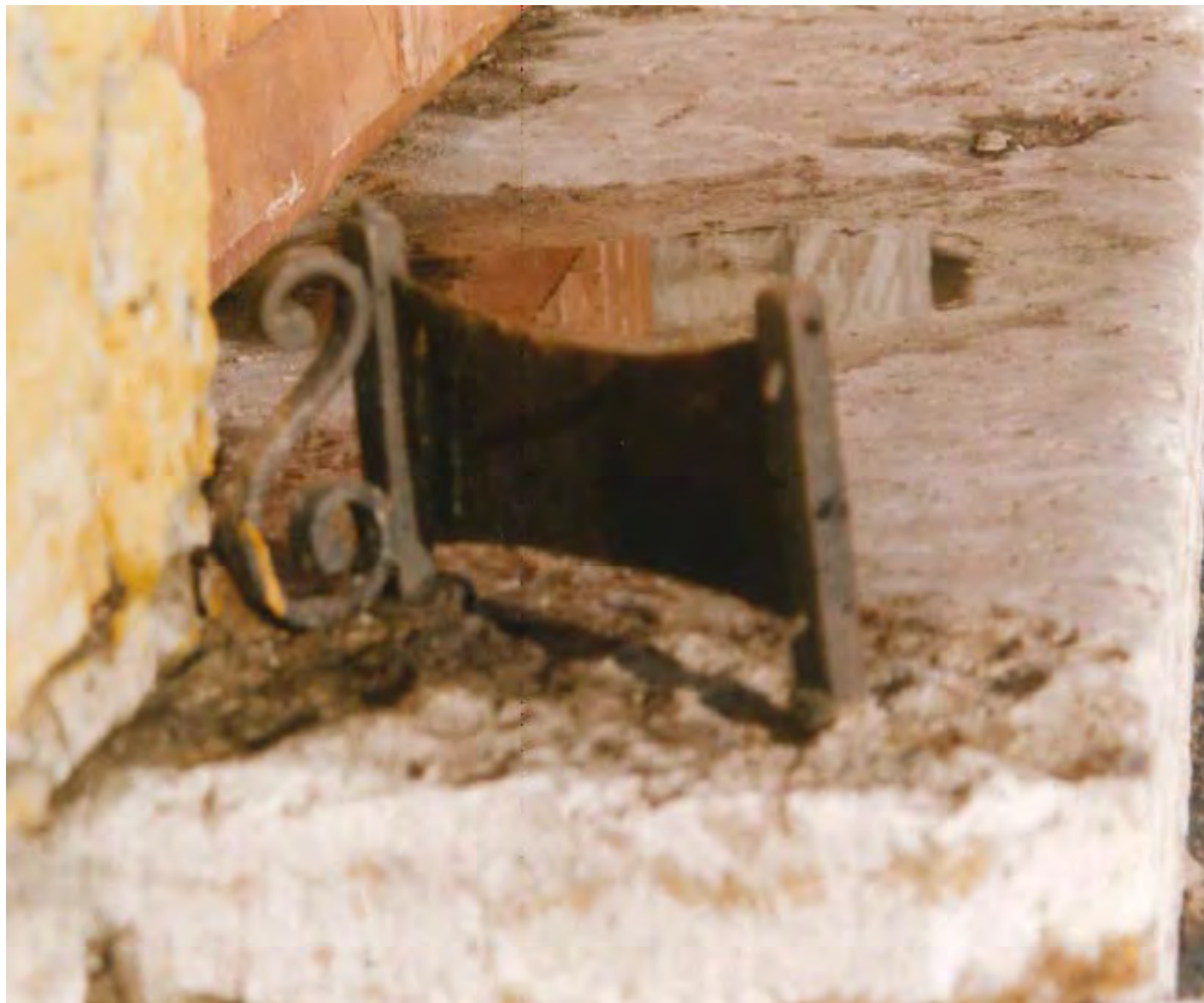
85. Скоба для очистки обуви. 2003 г. // ООО «Капитал-Строй». Проект реконструкции учебного корпуса детского дома-школы № 51. Том 3. Книга 1. Часть 1. Проект реставрации архитектурных элементов лицевых фасадов здания. СПб., 2003. / КГИОП. П. 1500Б/Пр. 80.
