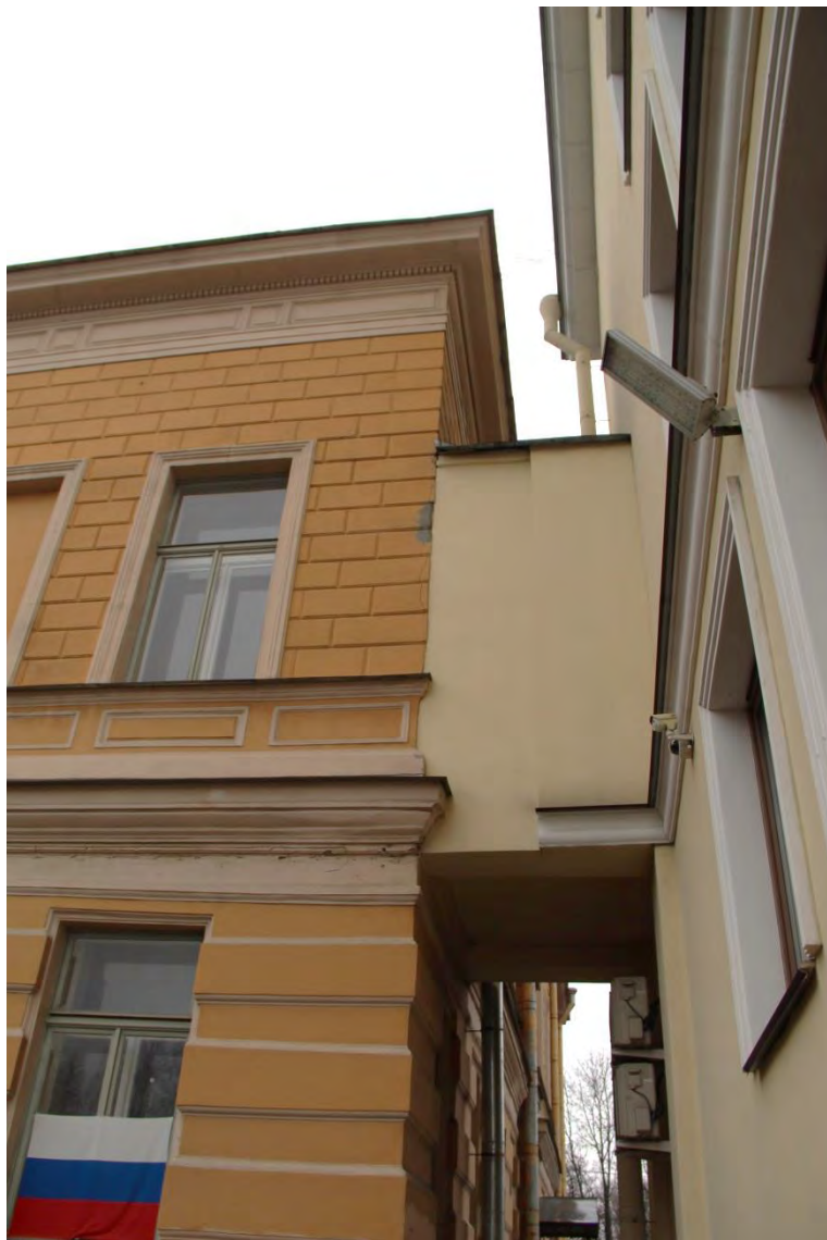
15. Объект культурного наследия регионального значения «Особняк Н.М. Полежаева» по адресу: г. Санкт-Петербург, проспект Бакунина, дом 8, литера А Общий вид Вид с востока Дата съемки: 01 апреля 2021 г.
