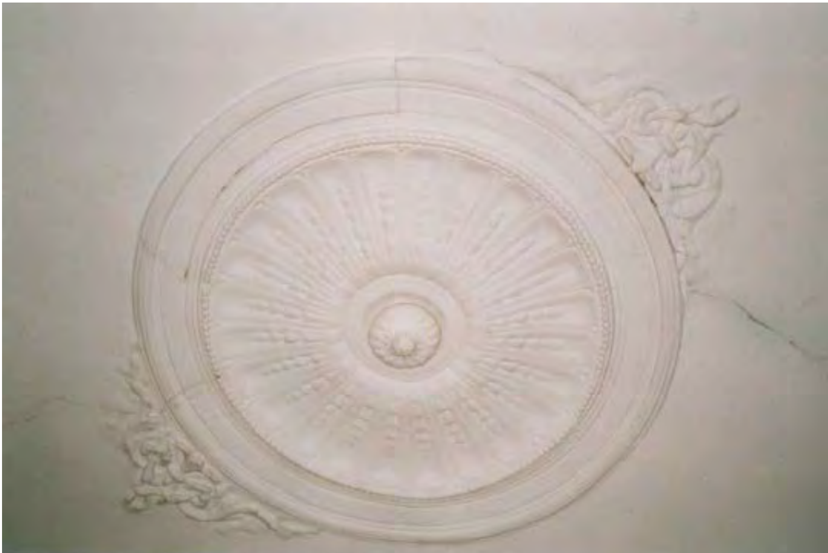
80. Общий вид центральной розетки плафона парадной лестницы. 2002 г. // ООО «Капитал-Строй». Проект реконструкции учебного корпуса детского дома-школы № 51. Том 1. Книга 1. Часть 1. Альбом фотоиллюстраций № 1. Дефекты и общие виды фасадов здания. СПб., 2002. С. 25. / КГИОП. П. 1500Б/Пр. 79.
