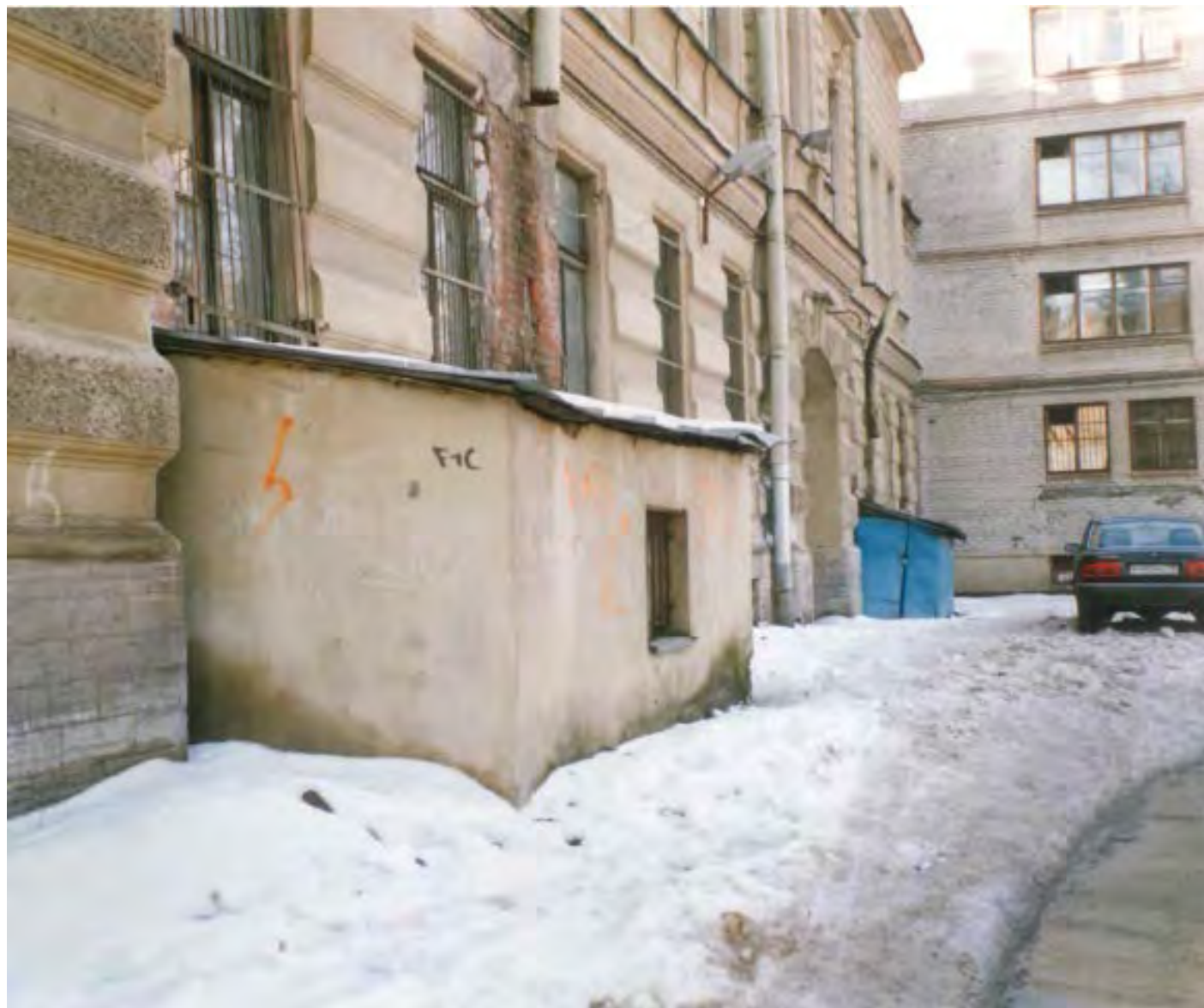
82. Фасад со стороны двора по пр. Бакунина. 2003 г. // ООО «Капитал-Строй». Проект реконструкции учебного корпуса детского дома-школы № 51. Том 3. Книга 1. Часть 1. Проект реставрации архитектурных элементов лицевых фасадов здания. СПб., 2003. / КГИОП. П. 1500Б/Пр. 80.
