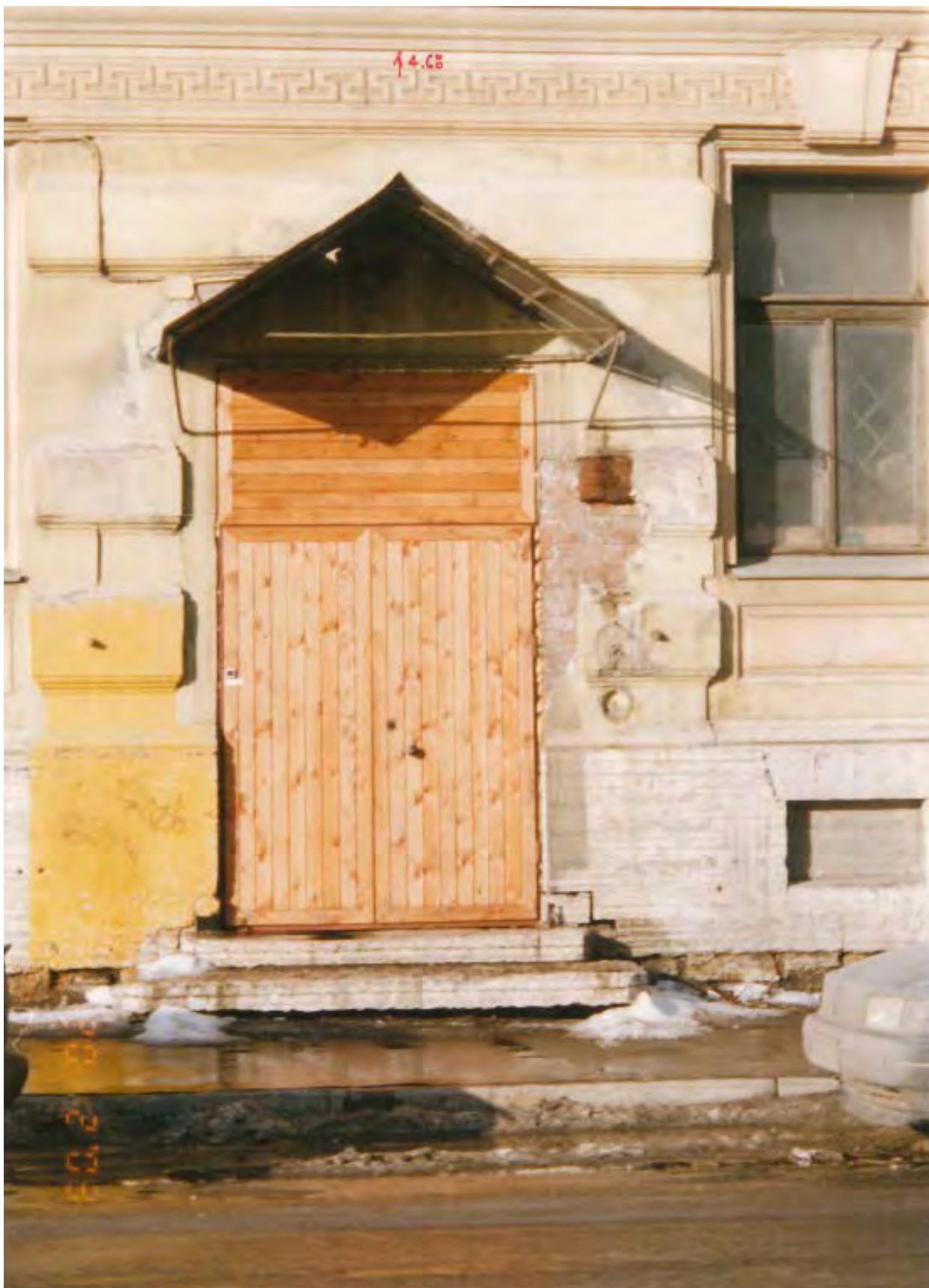
84. Крыльцо со стороны проспекта Бакунина. 2003 г. // ООО «Капитал-Строй». Проект реконструкции учебного корпуса детского дома-школы № 51. Том 3. Книга 1. Часть 1. Проект реставрации архитектурных элементов лицевых фасадов здания. СПб., 2003. / КГИОП. П. 1500Б/Пр. 80.
