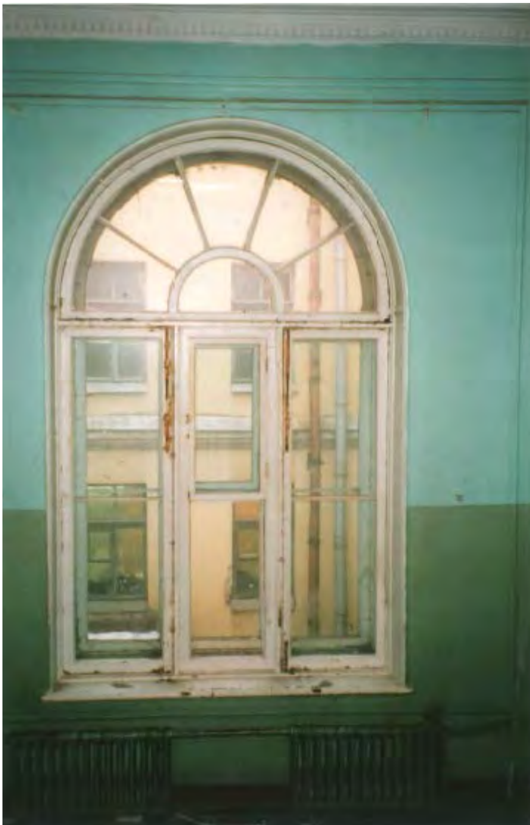
77. Общий вид заполнения оконного проема парадной лестницы. 2002 г. // ООО «Капитал-Строй». Проект реконструкции учебного корпуса детского дома-школы № 51. Том 1. Книга 1. Часть 1. Альбом фотоиллюстраций № 1. Дефекты и общие виды фасадов здания. СПб., 2002. С. 17. / КГИОП. П. 1500Б/Пр. 79.
