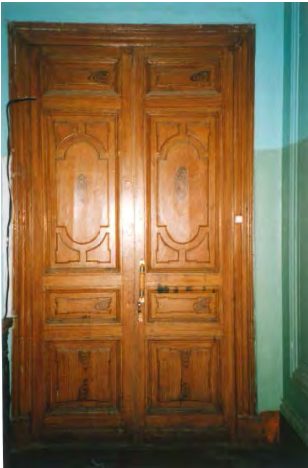
78. Общий вид заполнения дверных проемов парадной лестницы. 2002 г. // ООО «Капитал-Строй». Проект реконструкции учебного корпуса детского дома-школы № 51. Том 1. Книга 1. Часть 1. Альбом фотоиллюстраций № 1. Дефекты и общие виды фасадов здания. СПб., 2002. С. 19. / КГИОП. П. 1500Б/Пр. 79.
