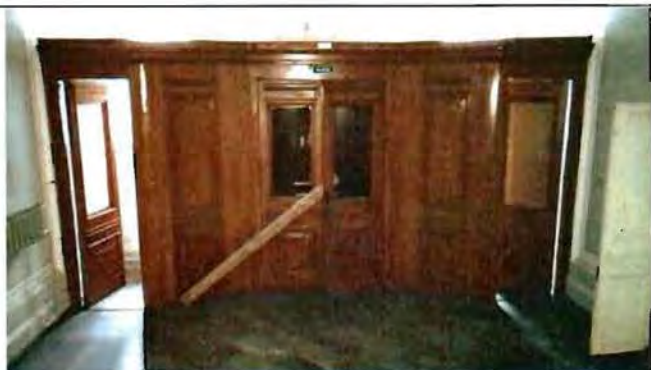
8. Тамбур парадного входа
