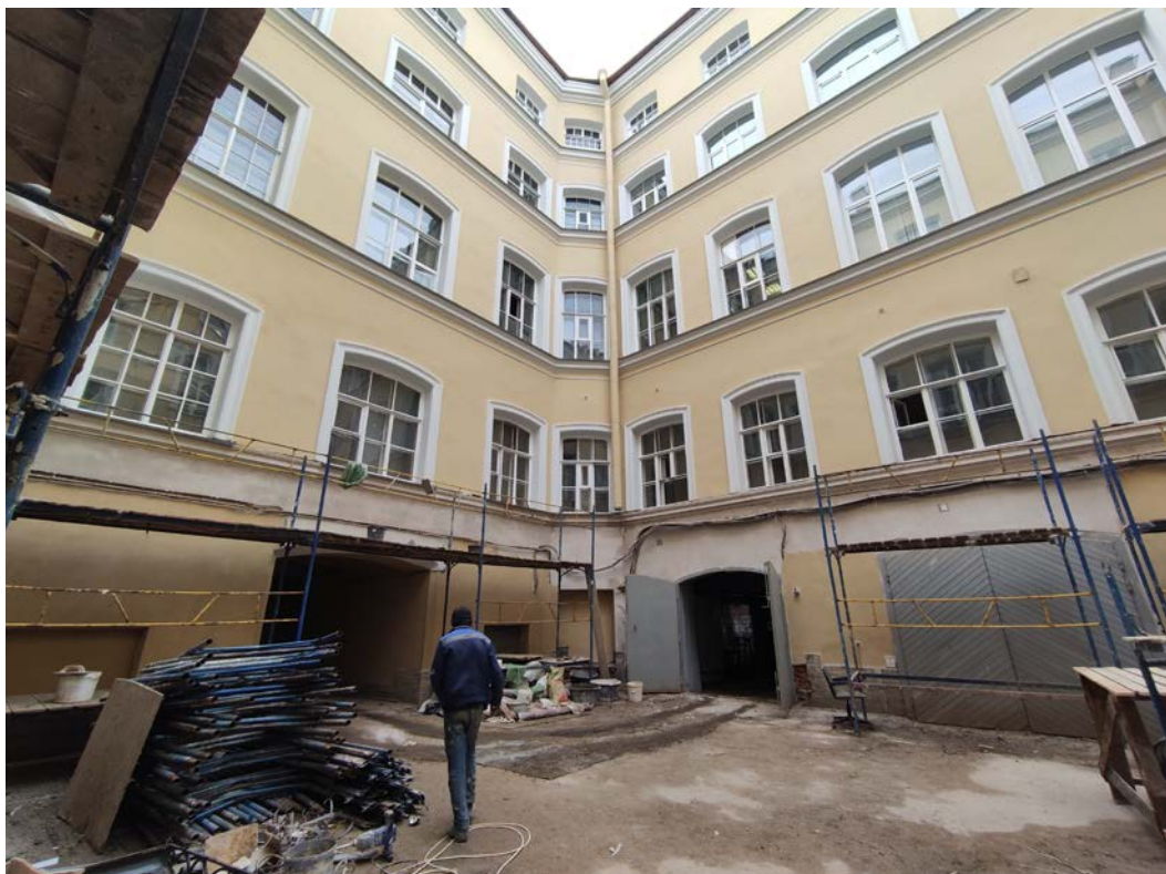
Фото 9. Фрагмент дворового фасада объекта культурного наследия федерального значения «Корпус для прислуги», входящего в состав объекта культурного наследия федерального значения «Дворец Великого князя Николая Николаевича (Ксенинский институт)» (дата фотофиксации: 08.10.2021)
