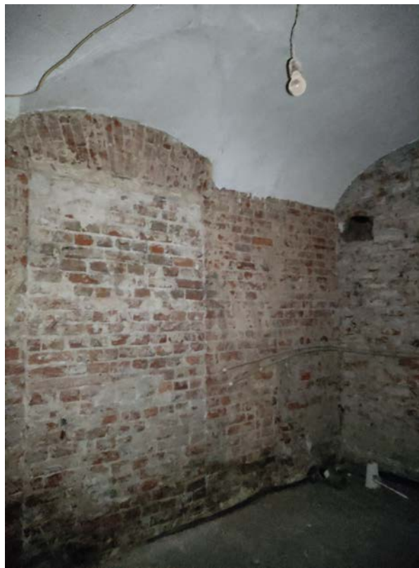
Фото 24. Интерьер квартиры, ч.п.№ 13, ч.п.№1(дата фотофиксации: 08.10.2021)
