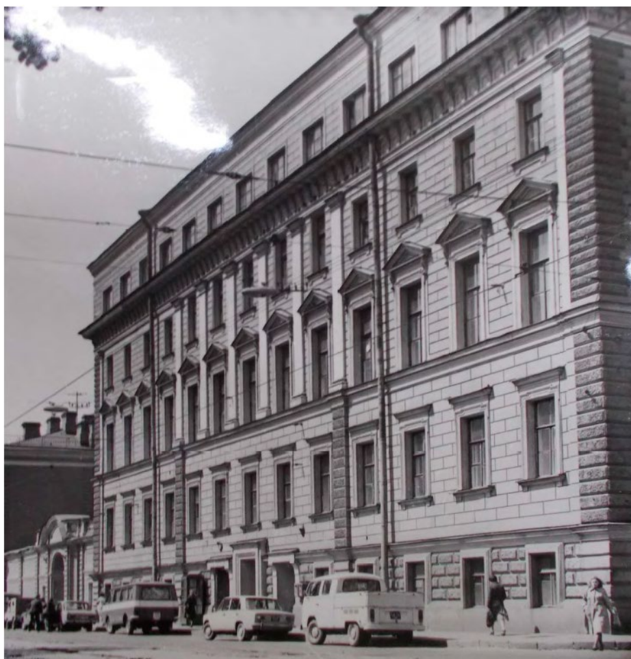
45. Фасад корпуса для прислуги со стороны бульвара Профсоюзов. 1985 г. — Архив КГИОП.
