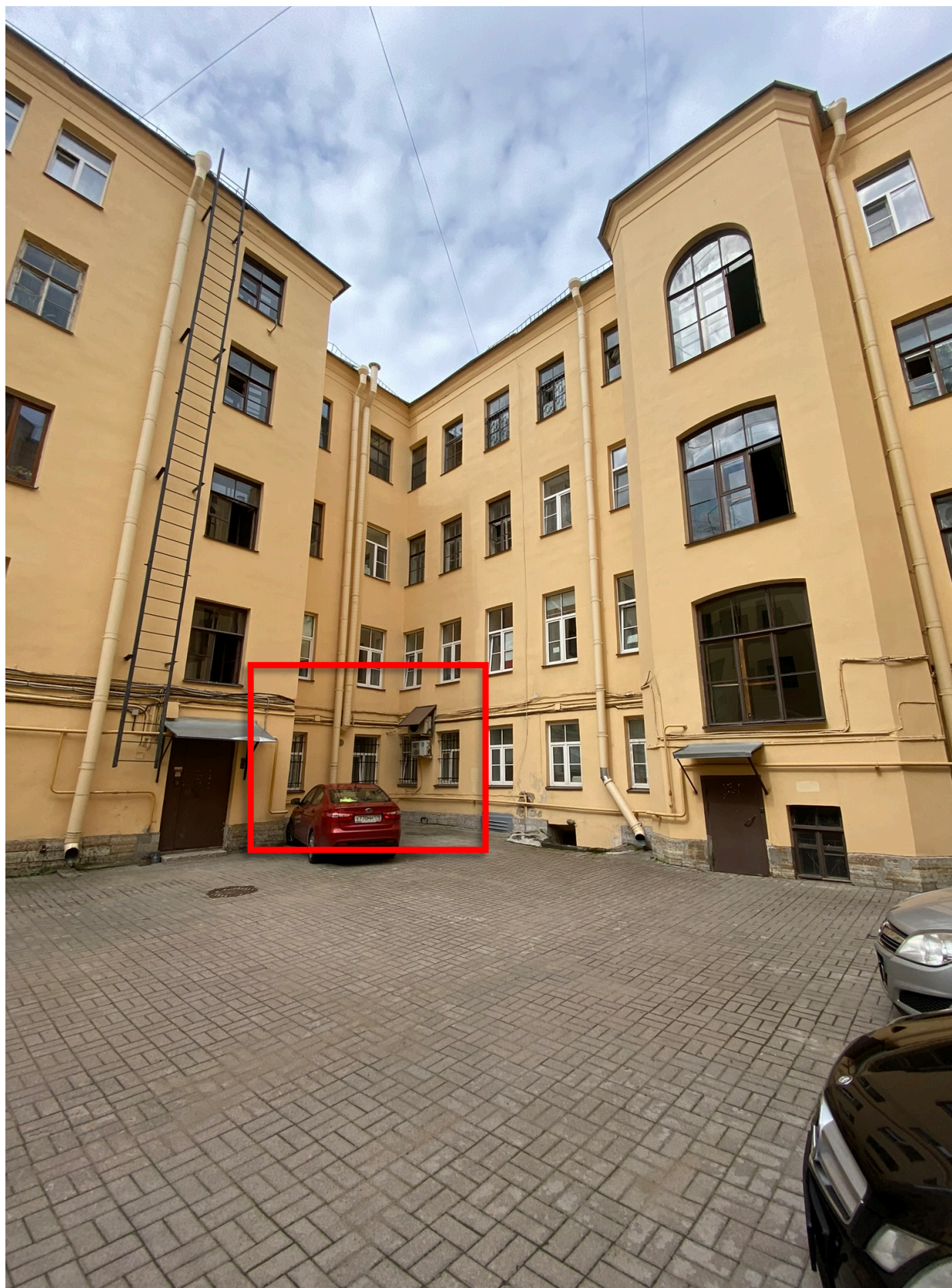
4. Вид на дворовой фасад здания и окна помещения 1-Н;
