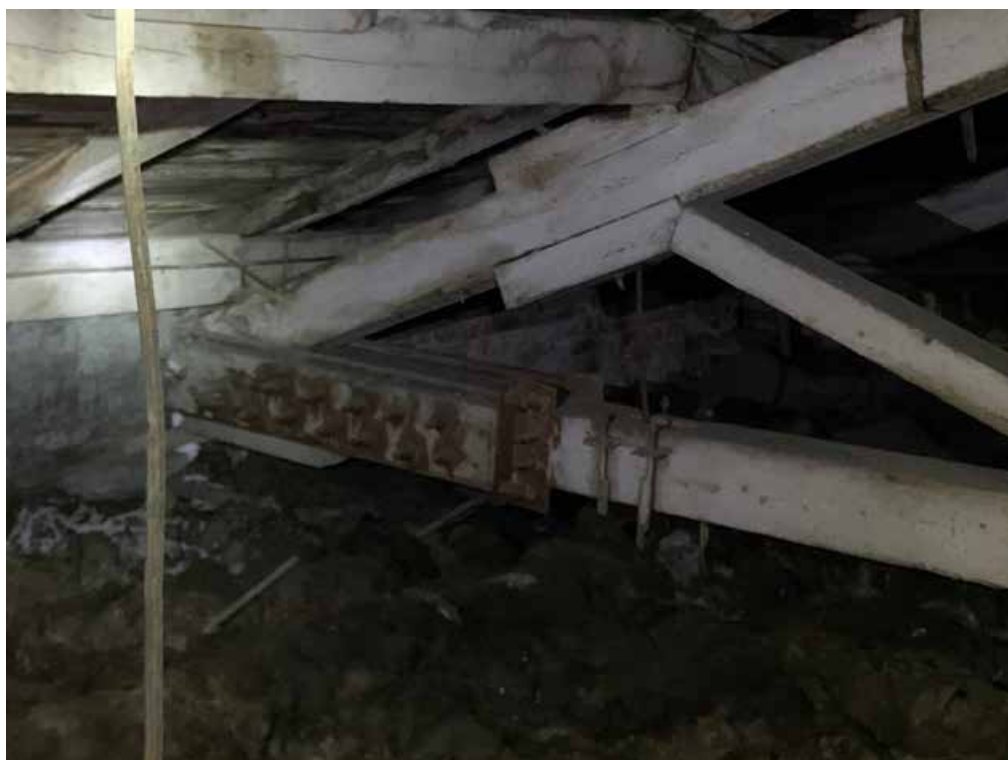
Фото 36. Узел опирания стропильной фермы
