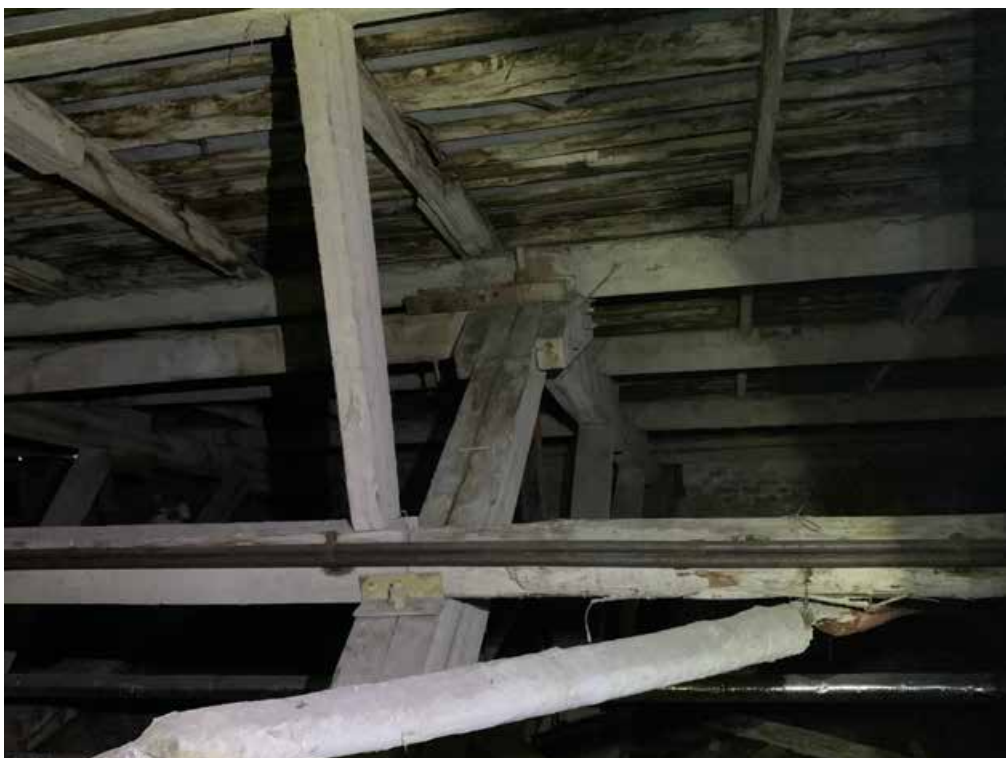
Фото 41. Фрагмент конструкции стропильных ферм
