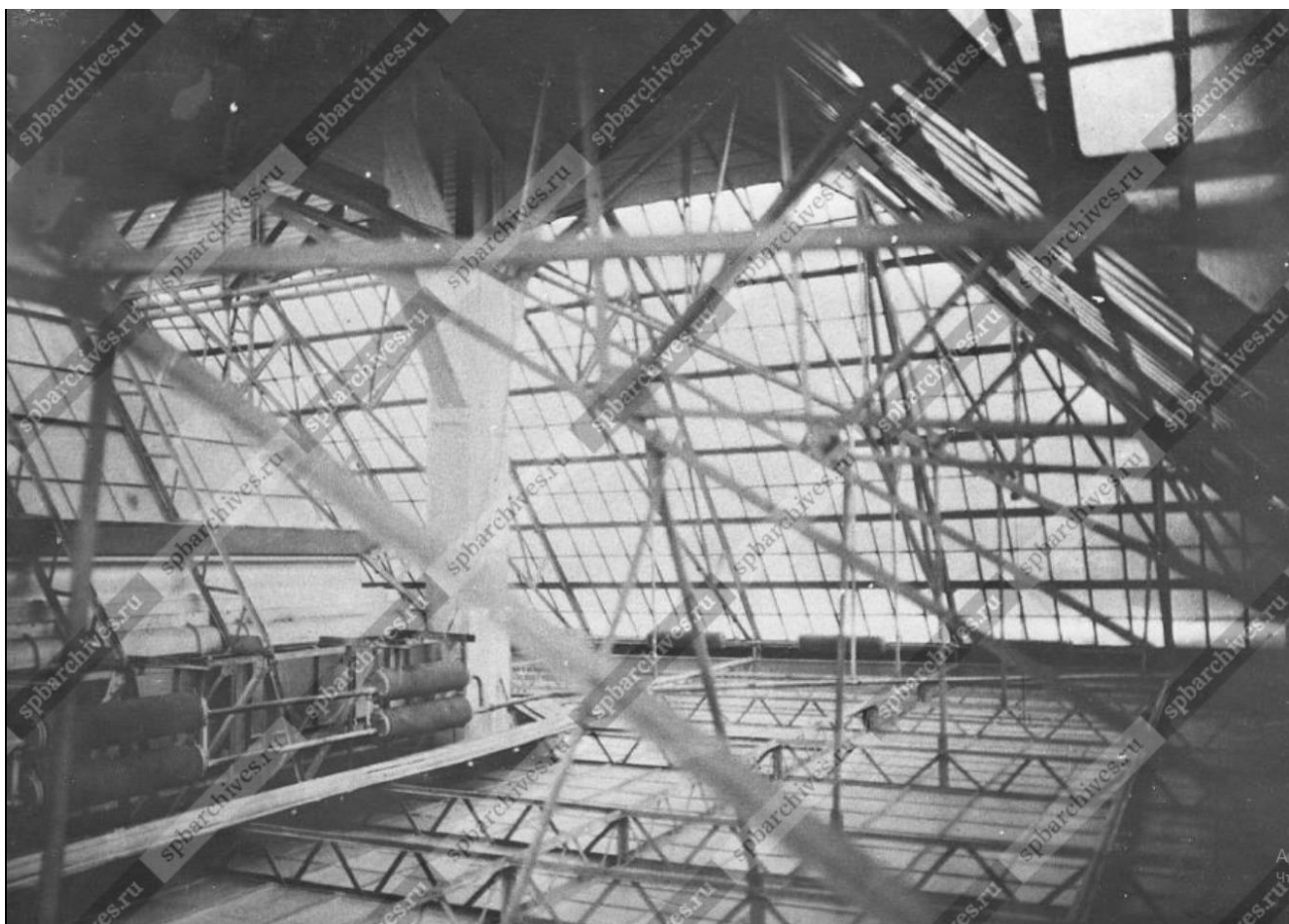
42. Общий вид части крыши во время перестройки. Автор съемки не установлен. 1903 год. ЦГАКФФД СПб. Шифр: А 5621.
