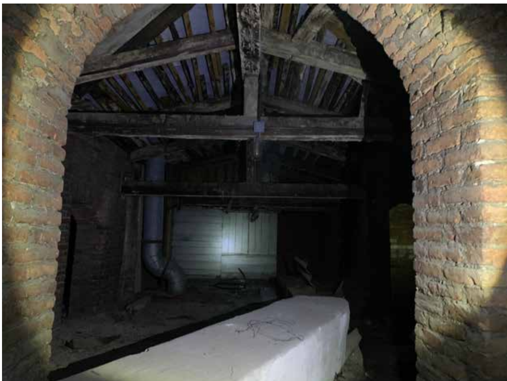
Фото 24. Стропильные фермы, поздние вентиляционные каналы над чердачным перекрытием.
