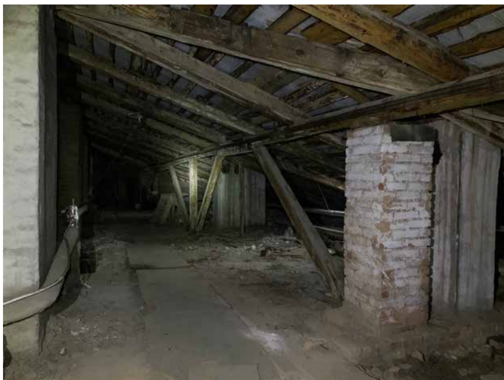
Фото 16. Ферма и конструкции кровли.
