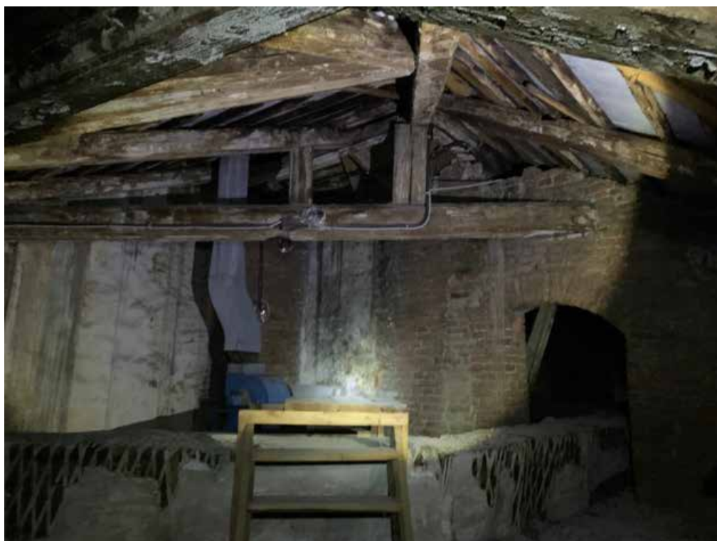
Фото 32. Узел перекоса кровли
