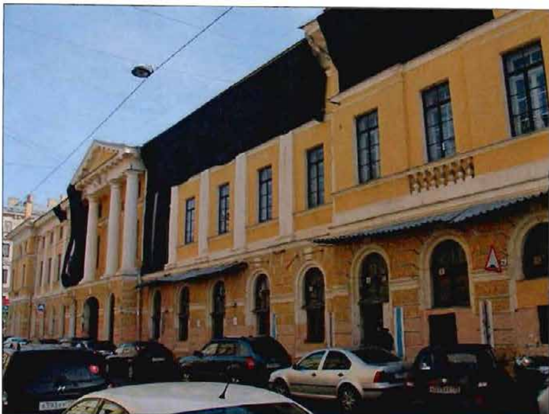
3. Северный лицевой фасад. Вид с запада.
