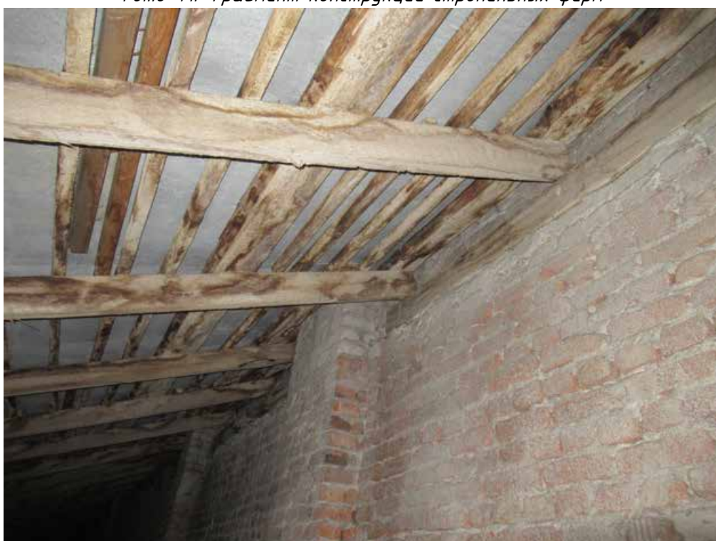
Фото 42. Узел опирания стропил на стены.
