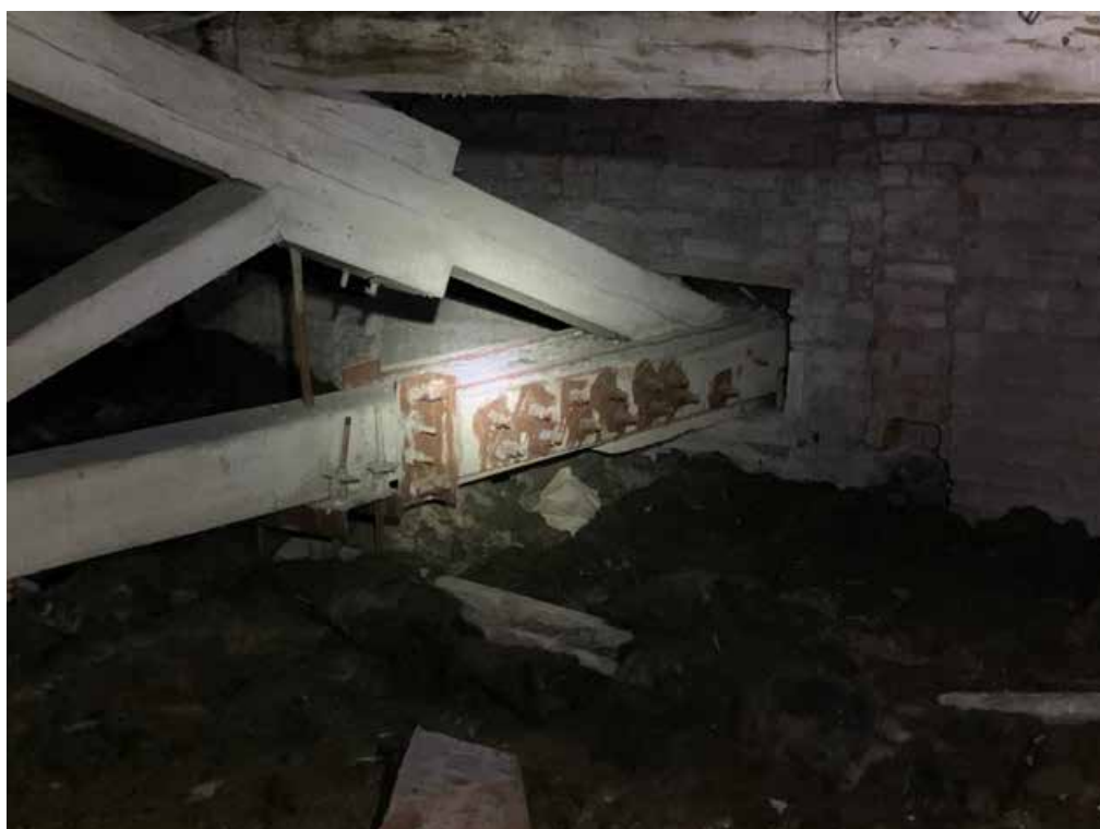
Фото 38. Фрагмент узла стропильной системы.
