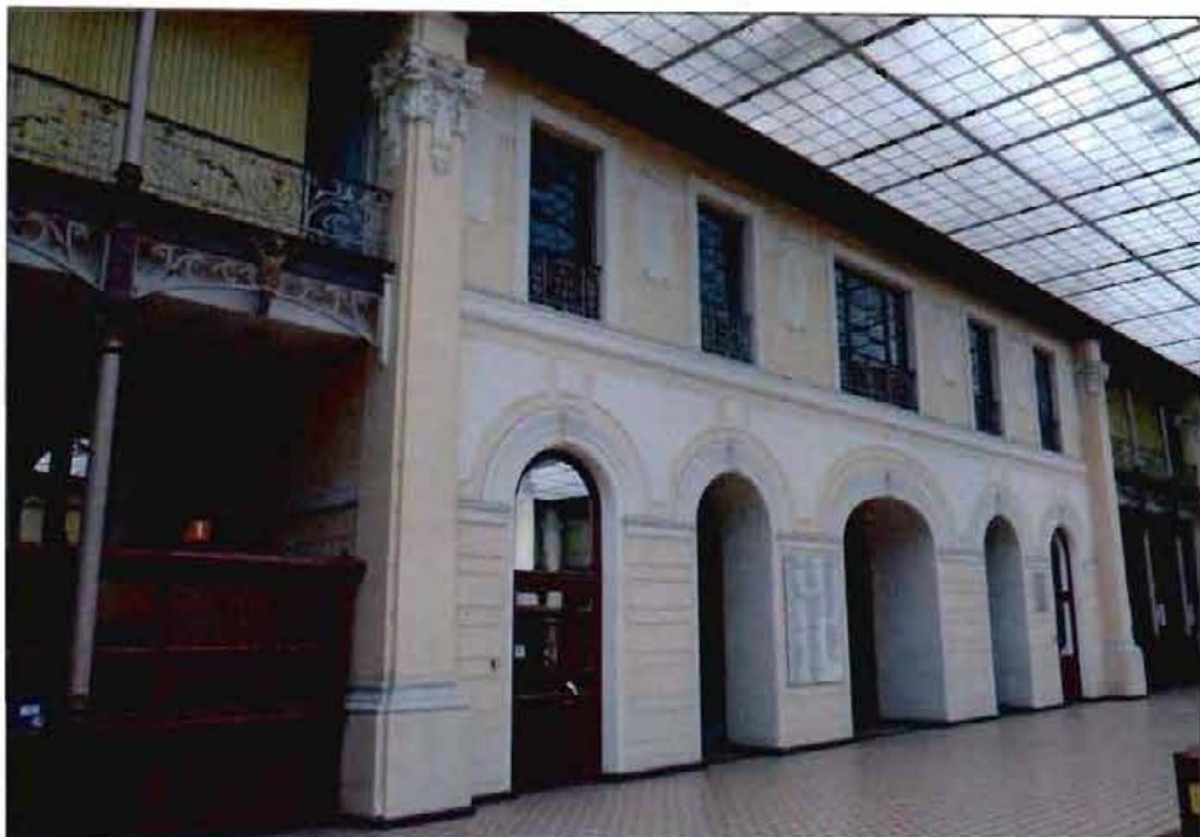
9. Северный фасад южного корпуса по ул. Почтамтской в интерьере операционного зала.
