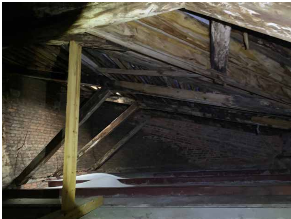
Фото 27. Поздняя стойка усиления, поздняя замена перекрытия
