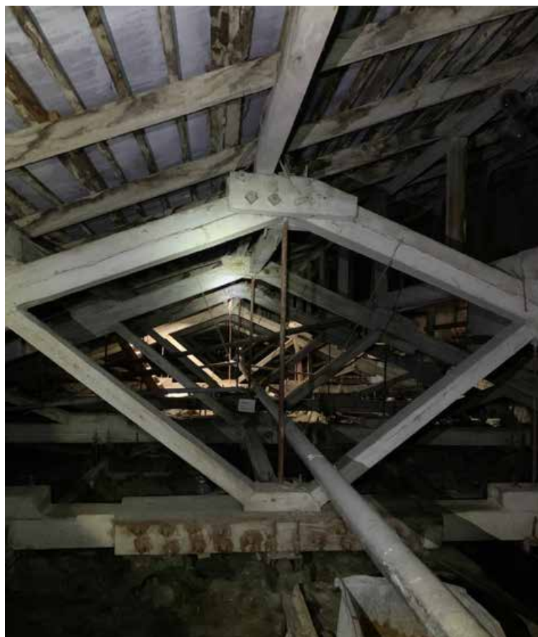
Фото 37. Коньковая часть стропильной фермы.
