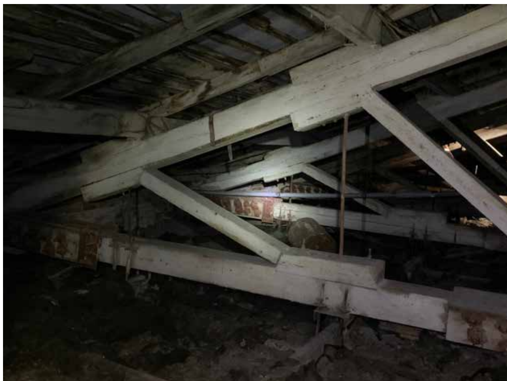
Фото 35. Фрагмент стропильной фермы
