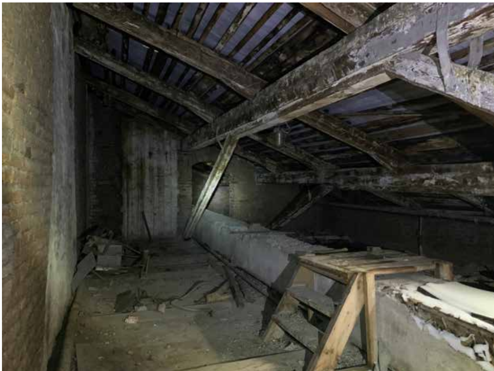
Фото 23. Поздние вентиляционные каналы над чердачным перекрытием.
