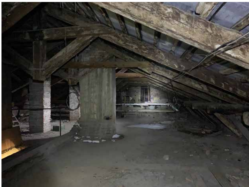
Фото 1. Общий вид чердака.
