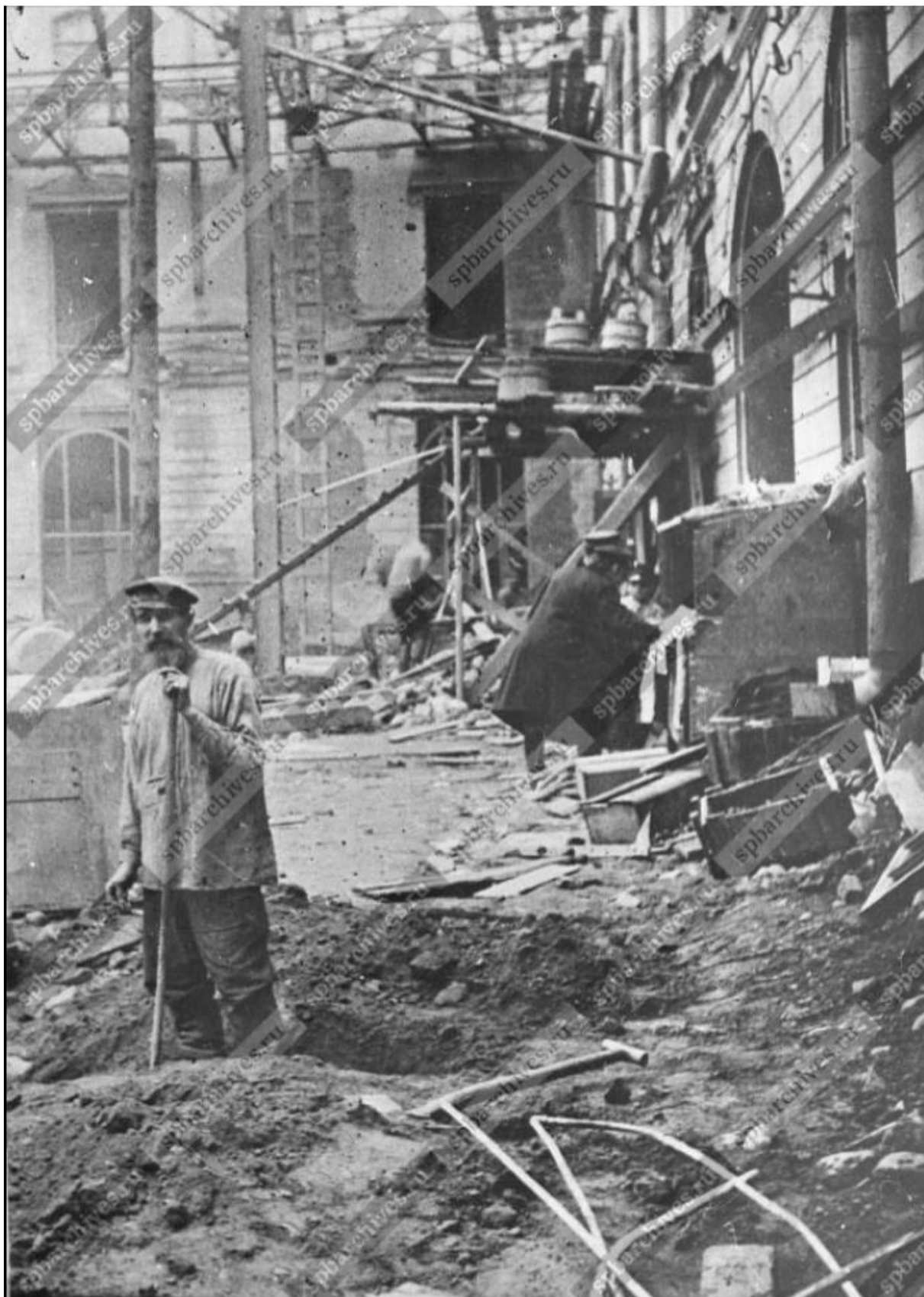
44. Вид части зала почтамта во время перестройки. Автор съемки не установлен. 1903 год. ЦГАКФФД СПб. Шифр: А 5612.
