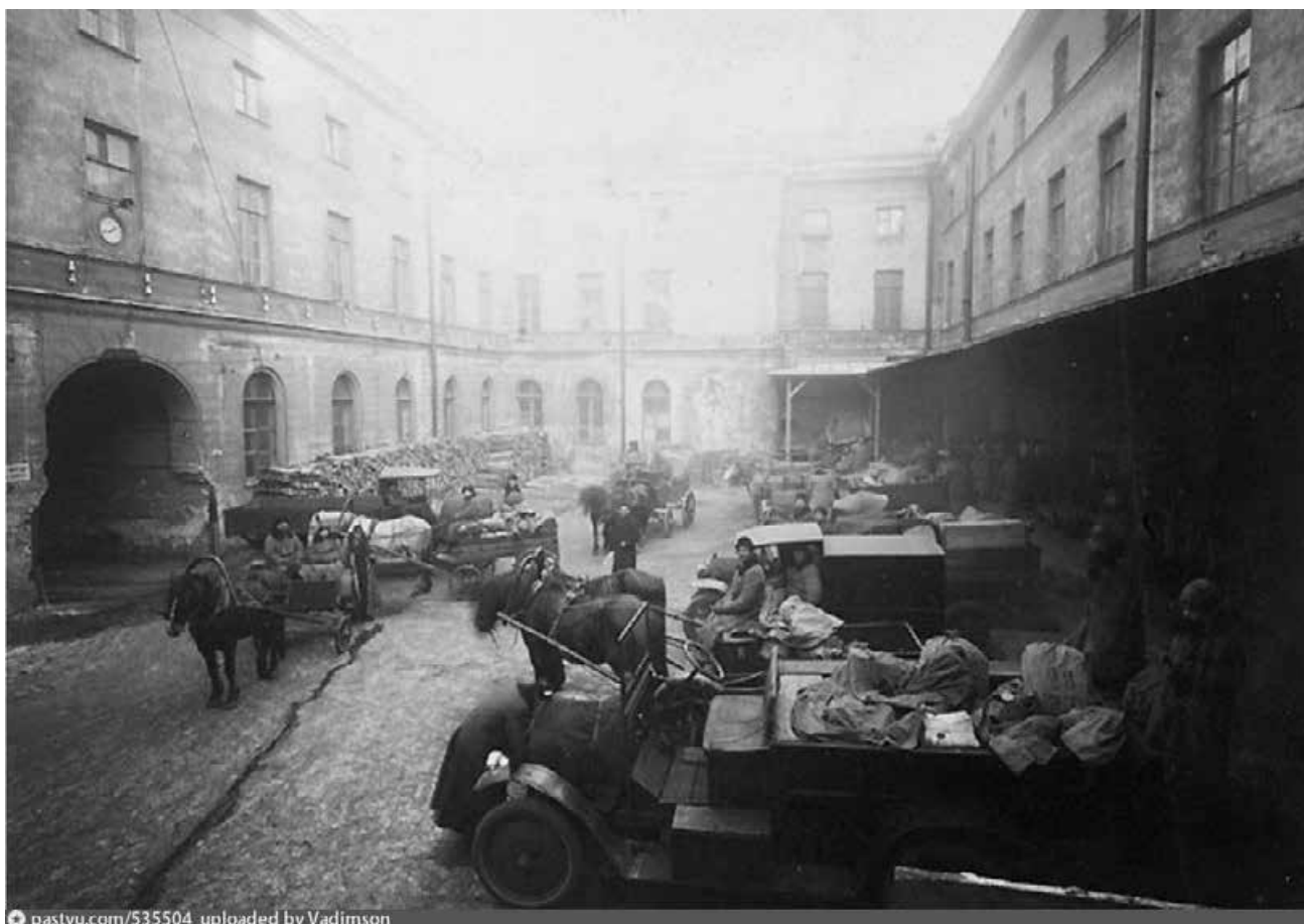
78. Грузовой двор Петроградского почтамта. Автор съемки не установлен. 1920 – 1926 гг. [Электронный доступ]: https://pastvu.com/p/535504
