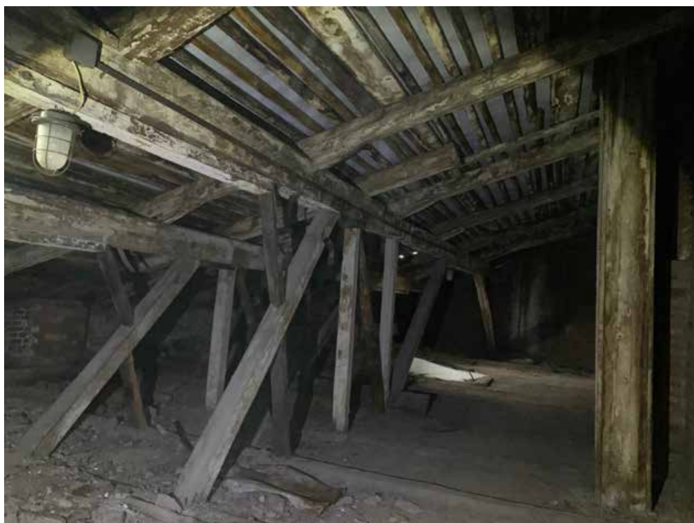
Фото 28. Стойки и подкосы. Замачивание.
