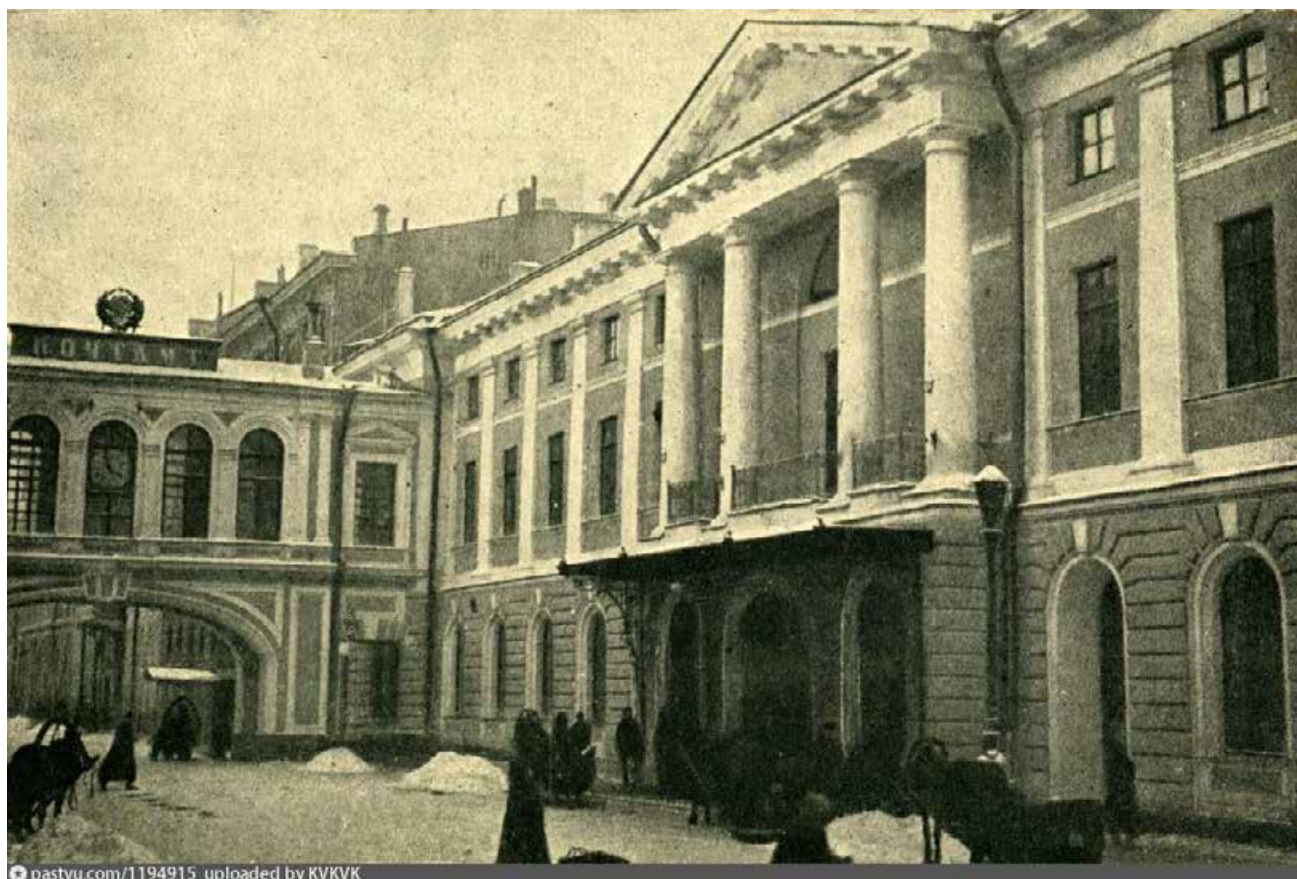
80. Ленинградский Почтамт. Автор съемки не установлен. 1920 – 1929 гг. [Электронный доступ]: https://pastvu.com/p/1194915
