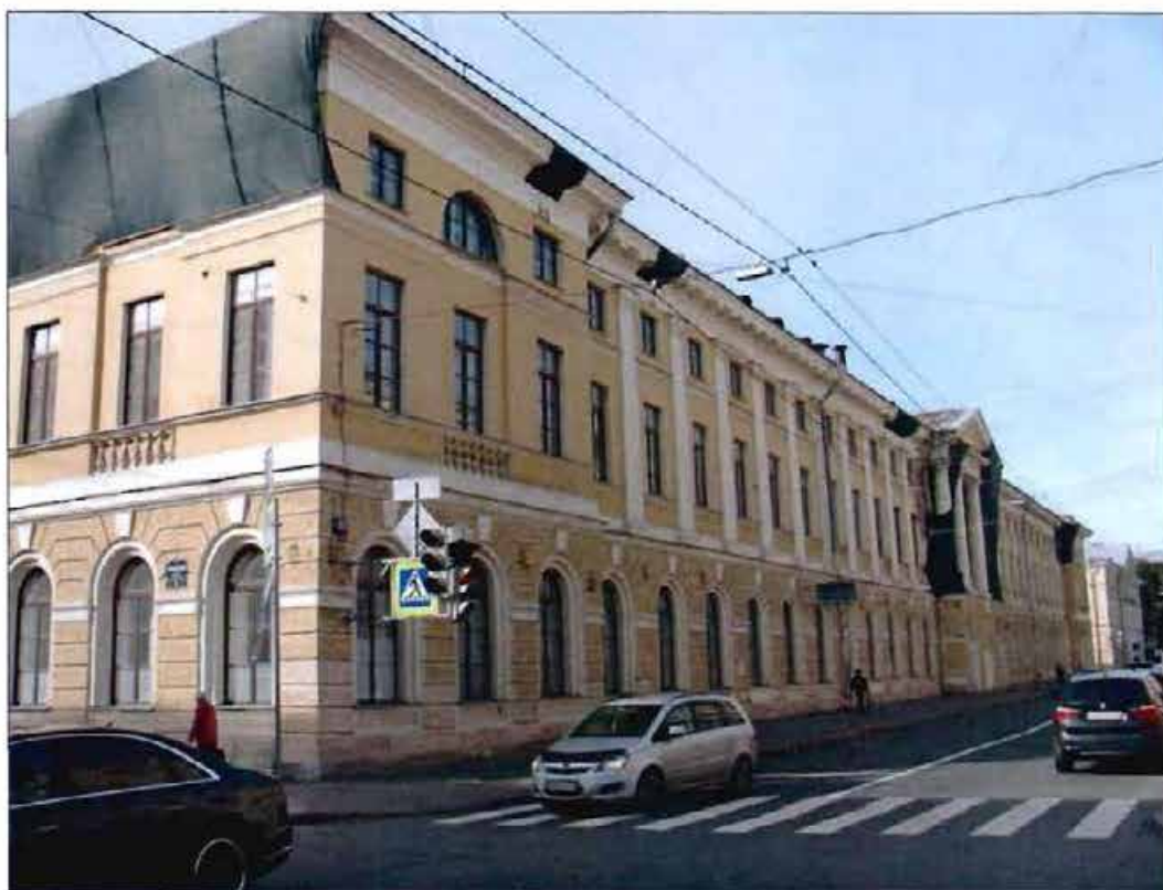
2. Восточный лицевой фасад. Вид с юго-востока.
