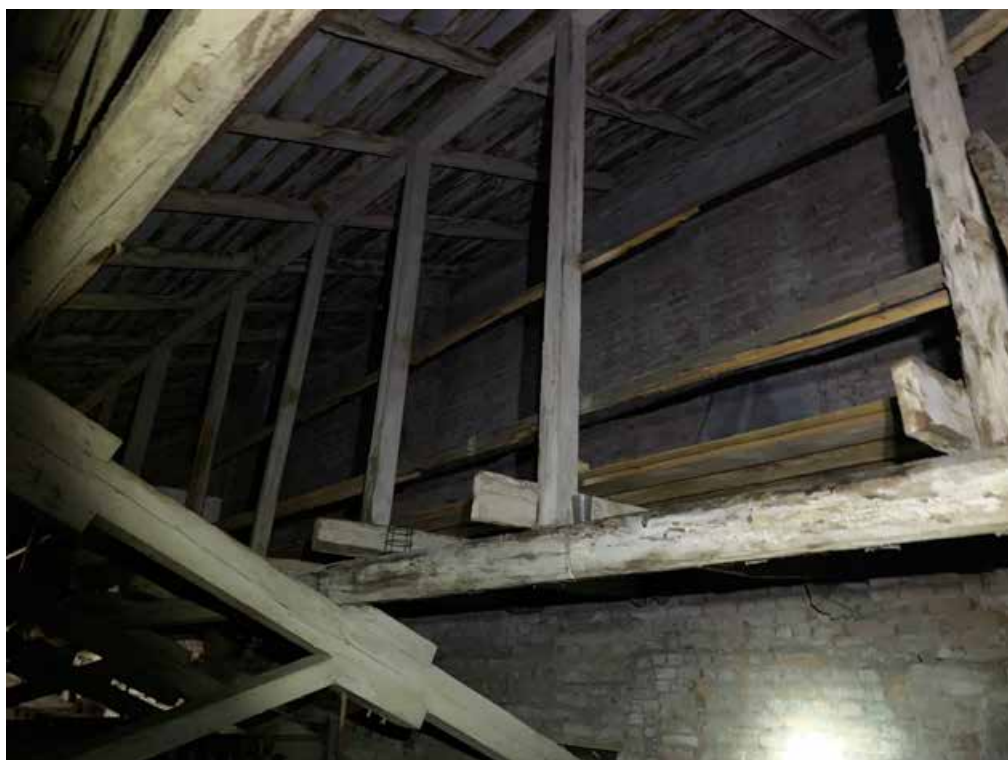
Фото 40. Помост на стропильными фермами
