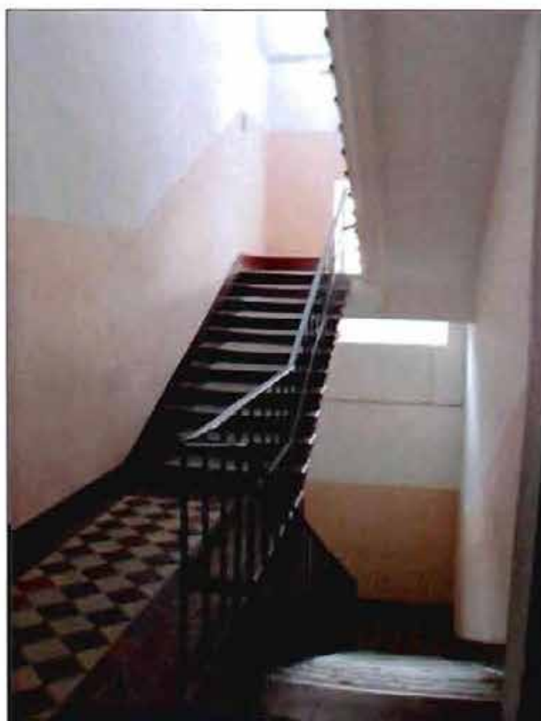
12. Лестница в южном корпусе по ул. Почтамтской.
