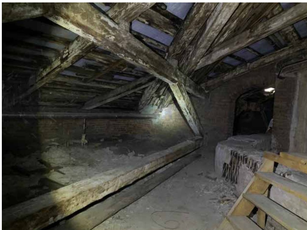
Фото 31. Фрагмент узла диагональных стропил.
