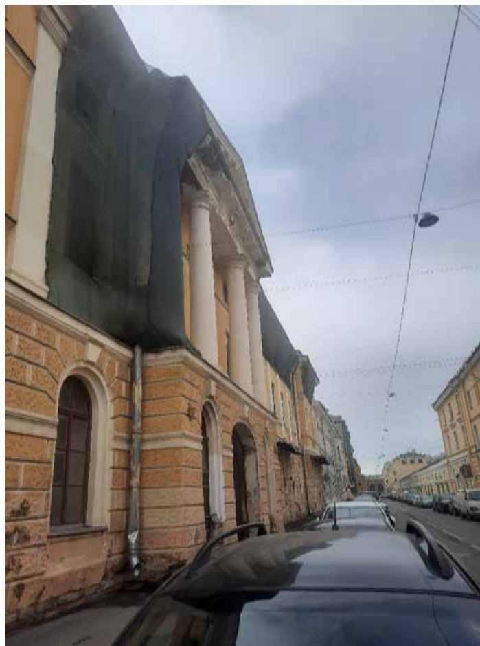
Фото 1. Вид на фасад со стороны Почтамтского переулка
