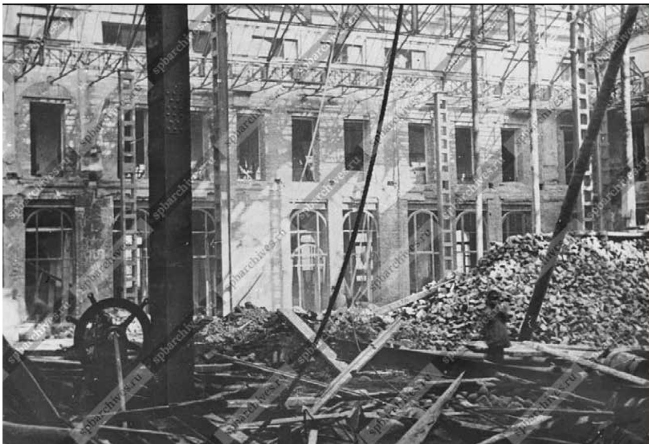
46. Общий вид части зала почтамта во время перестройки. Автор съемки не установлен. 1903 год. ЦГАКФФД СПб. Шифр: А 5618.
