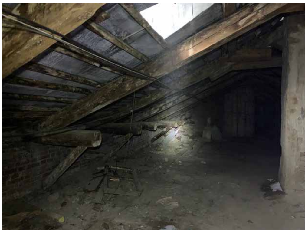
Фото 4. Фрагмент конструкции покрытия. Стропильные ноги, обрешетка.
