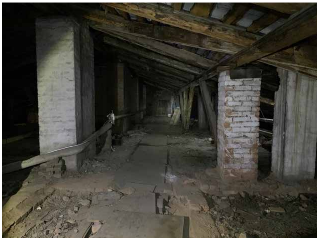
Фото 15. Общий вид чердака. Кирпичные стойки
