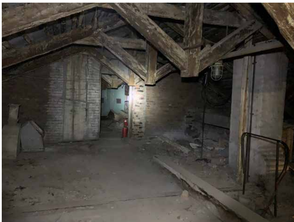
Фото 2. Вид на участок чердака и стропильные фермы.
