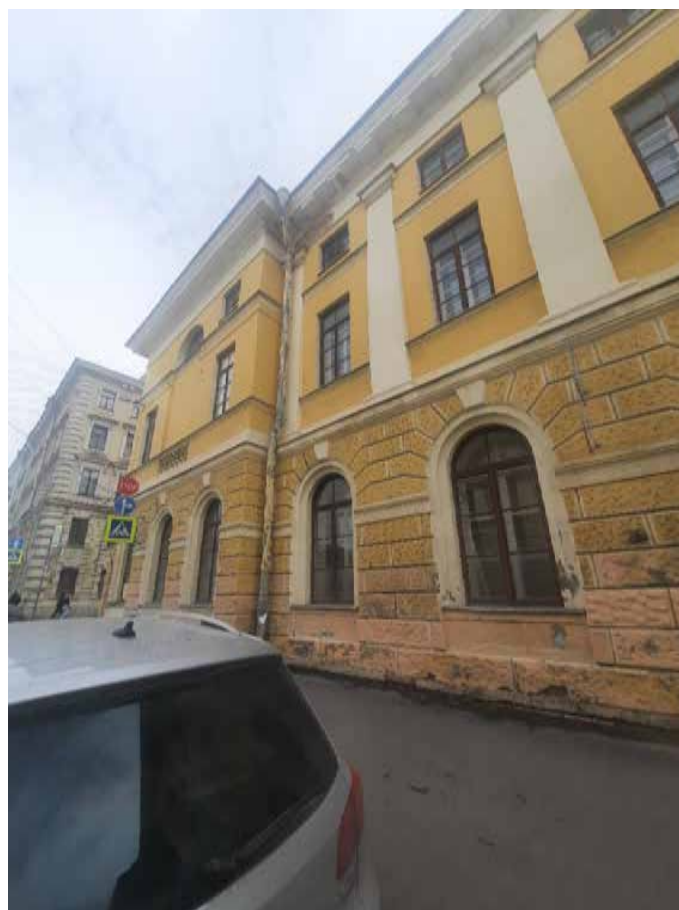
Фото 2. Вид на фасад со стороны Почтамтского переулка
