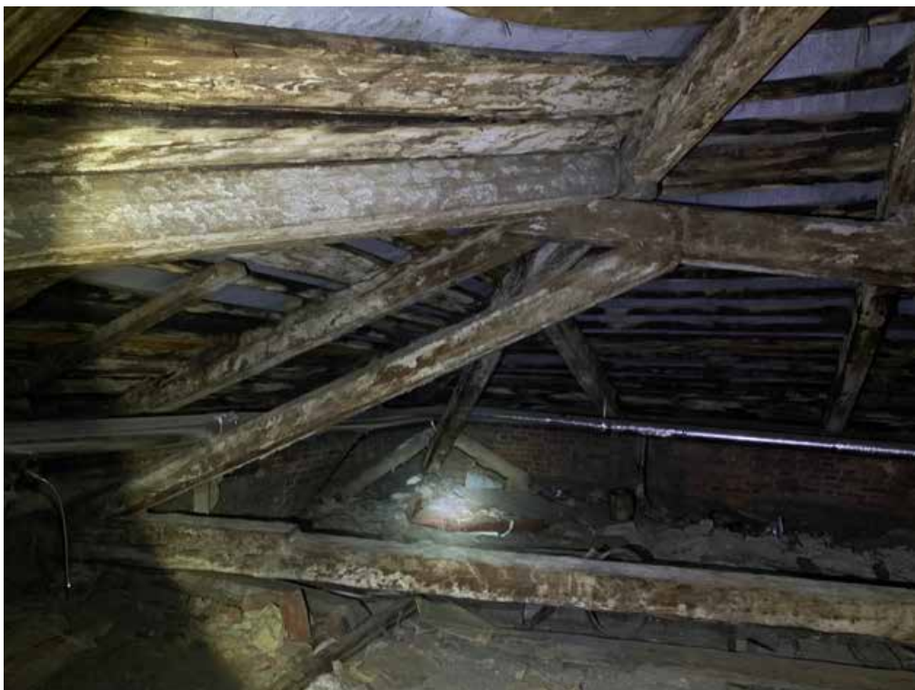
Фото 30. Замачивание деревянных конструкций.
