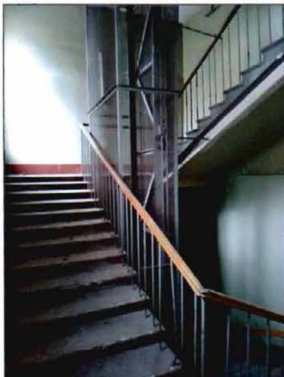
14. Лестница в западном корпусе по ул. Якубовича.
