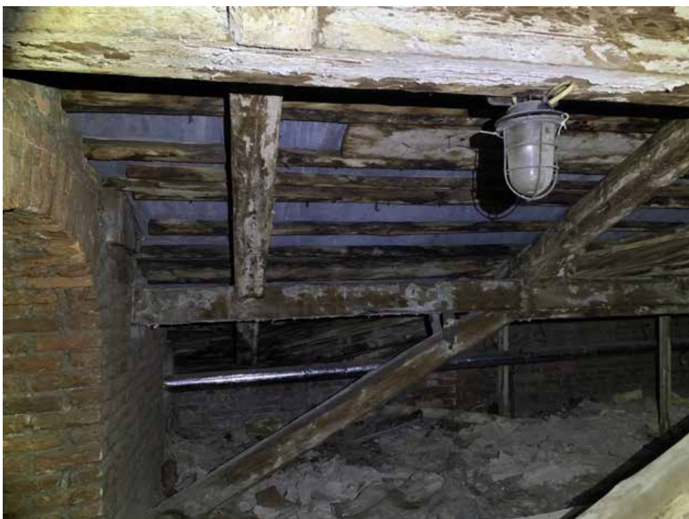
Фото 26. Подкосы, поздние вентиляционные каналы над чердачным перекрытием.
