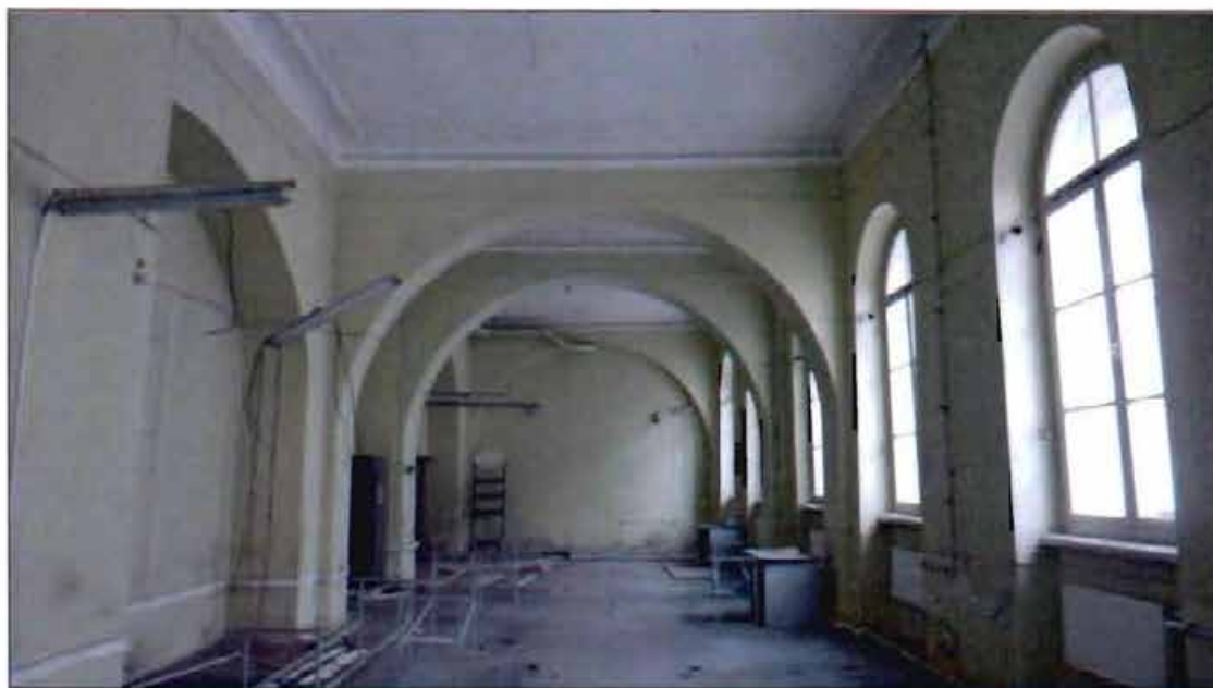
10. Перекрытие на арках. Первый этаж.
