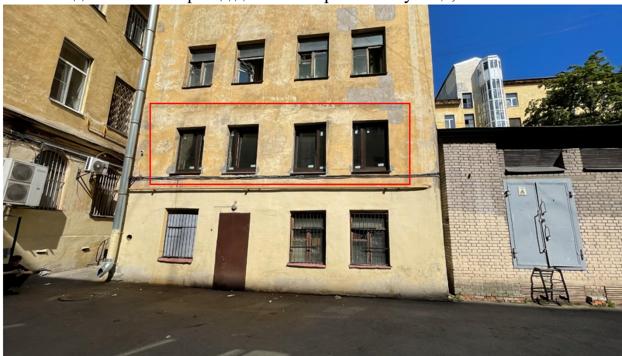
2. Вид на южный дворовой фасад здания;
