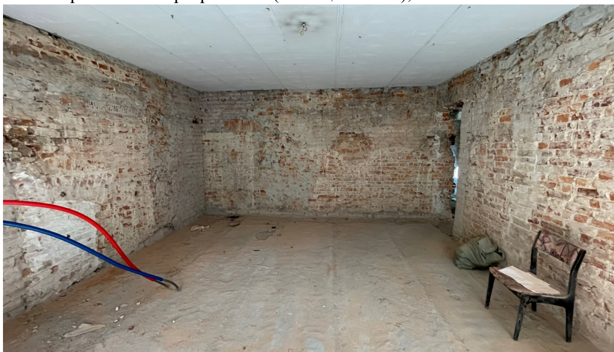
13. Фрагмент интеръера холла (помещение №6);
