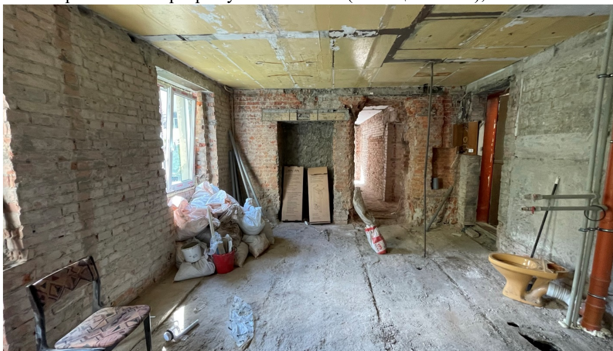
7. Фрагмент интерьера кухни столовой. Вид на санузел и коридор (помещение №3);
