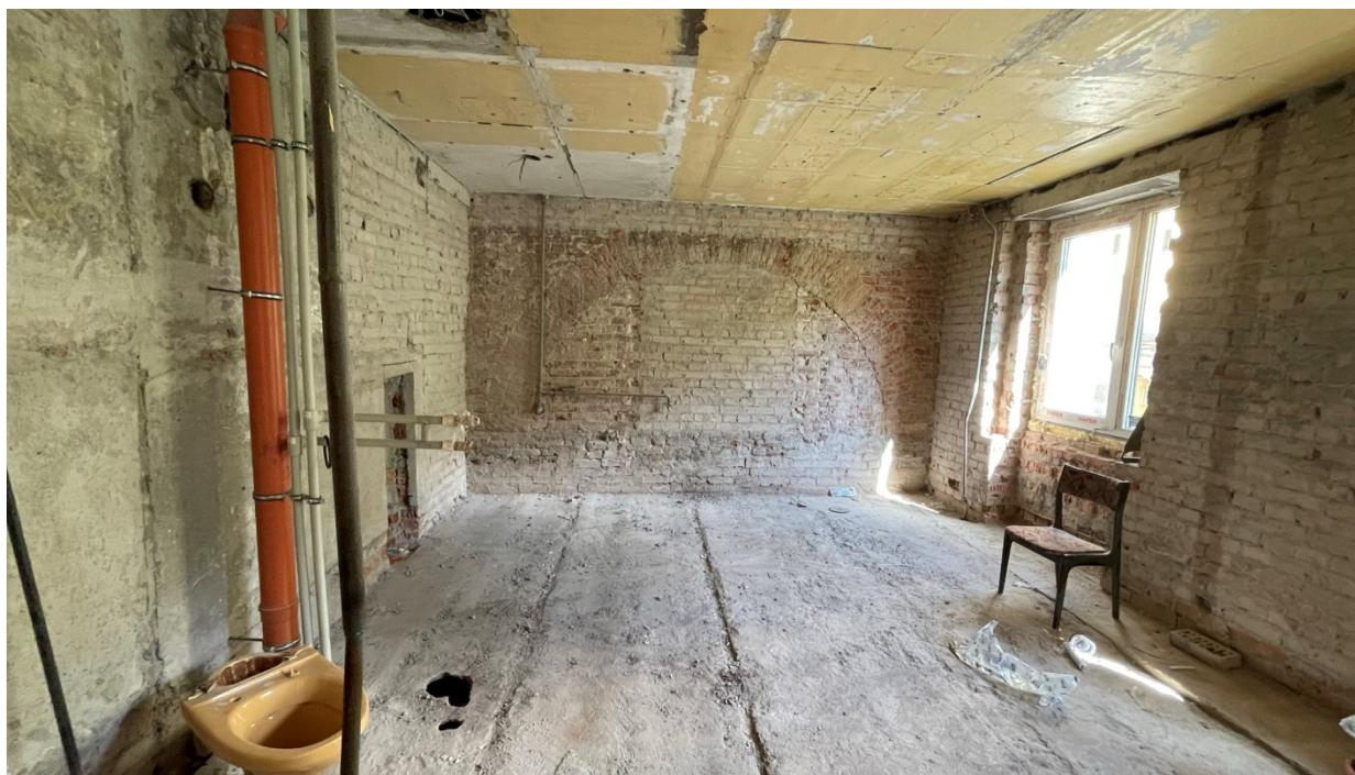
6. Фрагмент интерьера кухни столовой (помещение №3);
