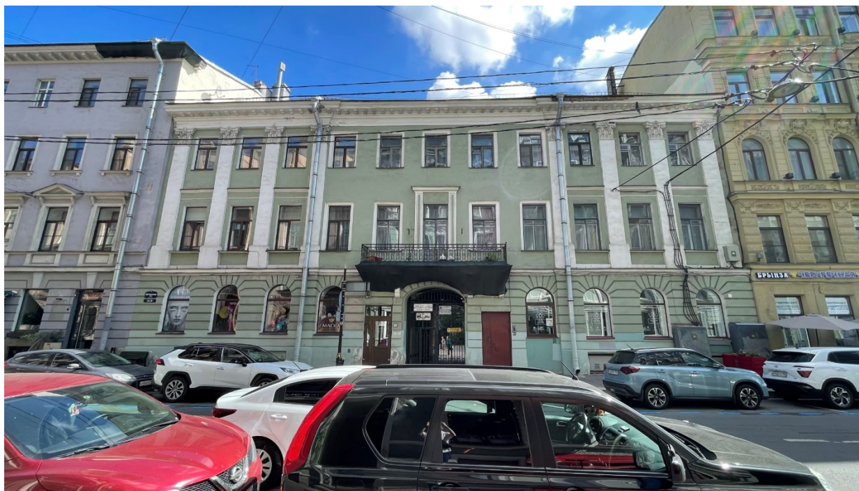
1. Вид на главный фасад дома по Караванной улице;
