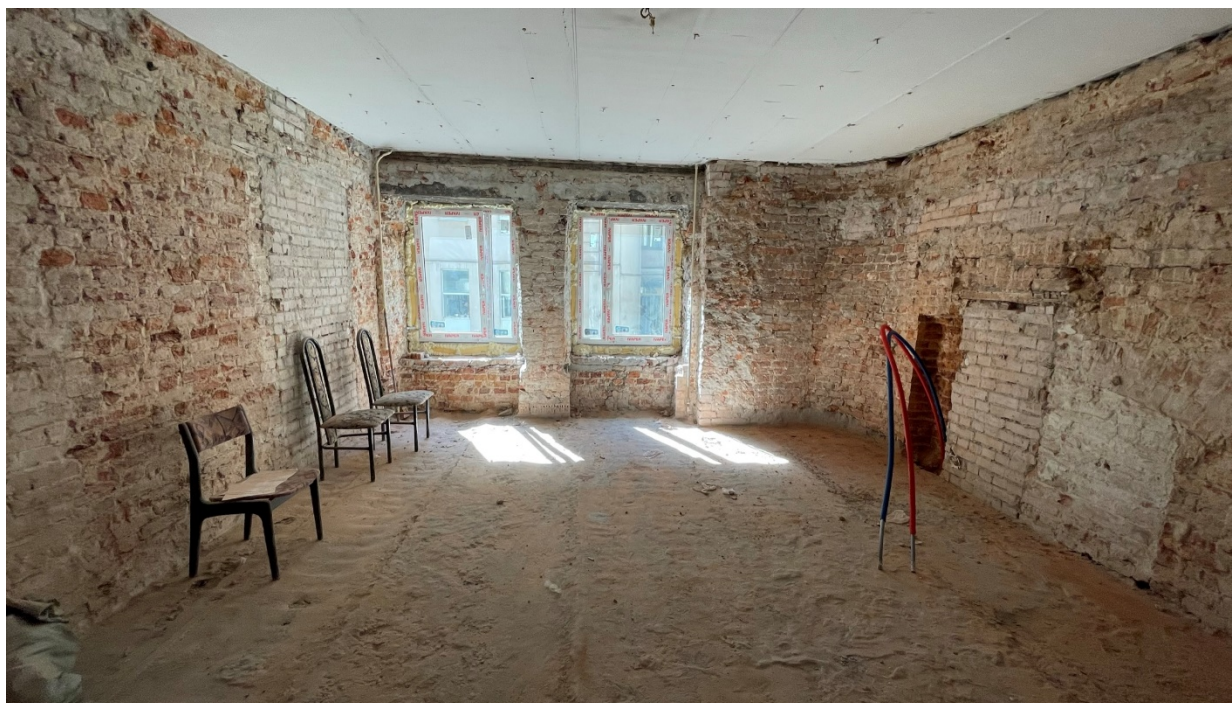
12. Фрагмент интеръера холла (помещение №6);
