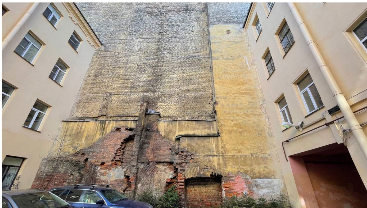
4. Вид на дворовой фасад;
