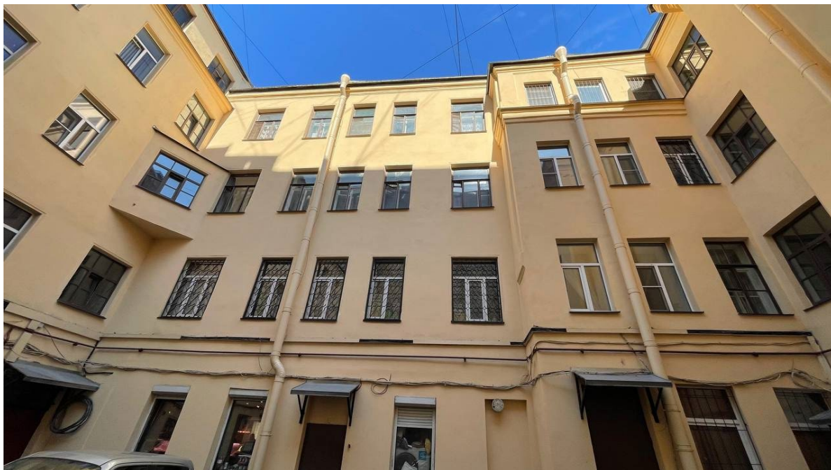
3. Вид на дворовой фасад;
