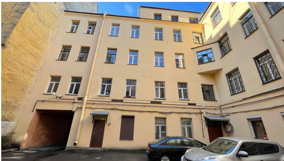
5. Вид на дворовой фасад;
