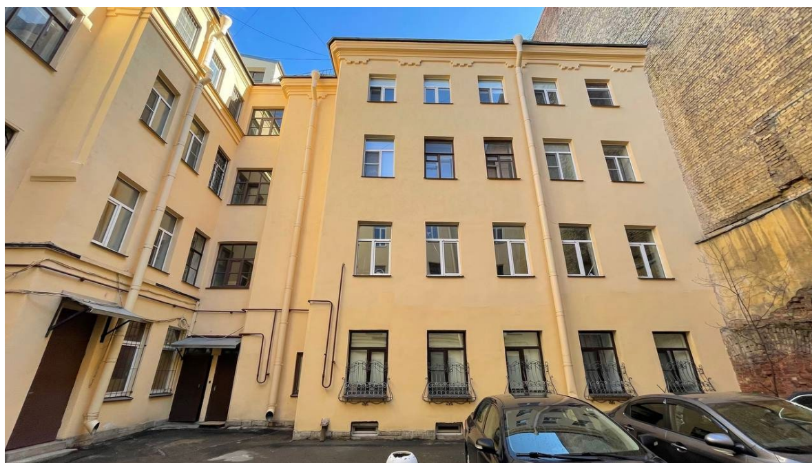
2. Вид на дворовой фасад;
