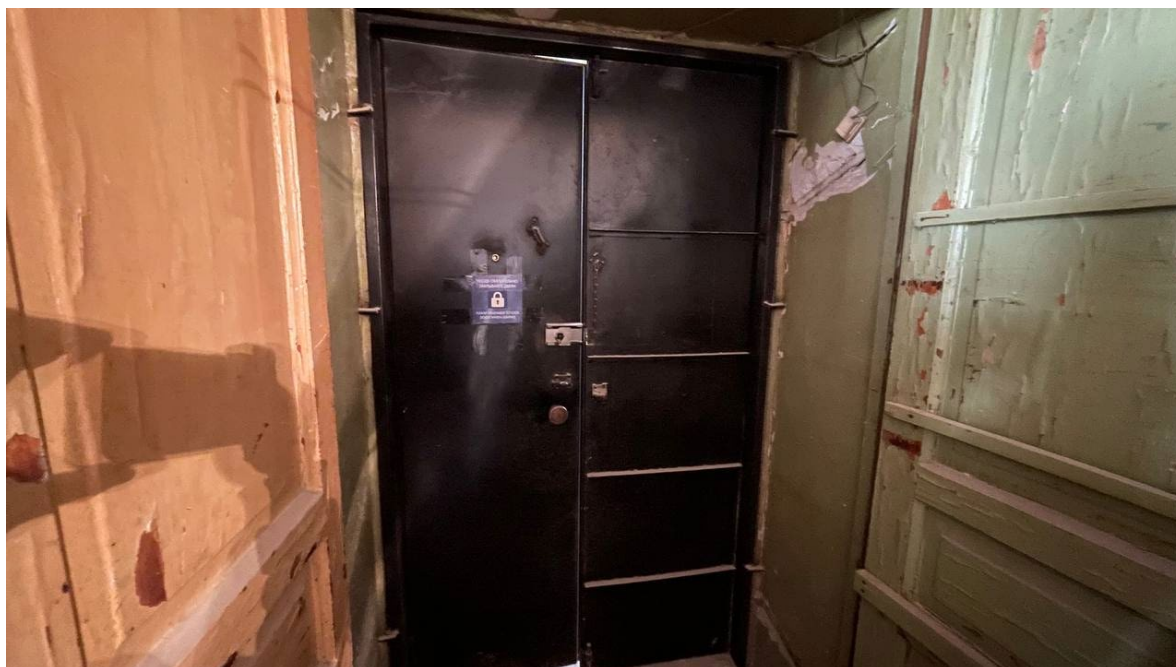
7. Вид на входную дверь в квартире;
