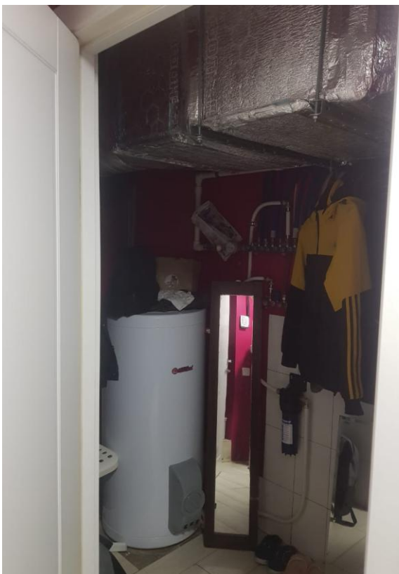
Фото 36. Интерьер помещения 1-Н, расположенного в выявленном объекте культурного наследия «Дом И. Жадимировского (К.А. Тура), ч.п.№13
