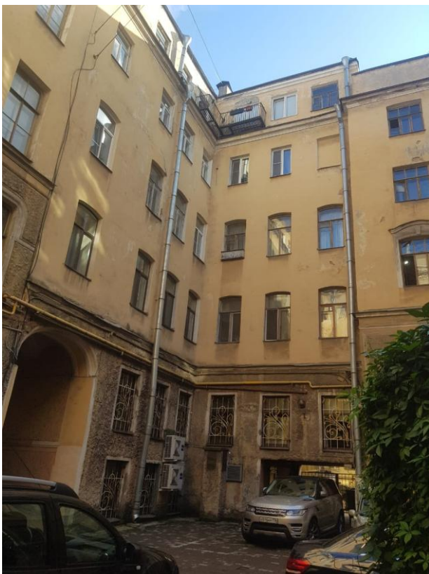
Фото 6. Фрагмент дворового фасада выявленного объекта культурного наследия «Дом И. Жадимировского (К.А. Тура)»
