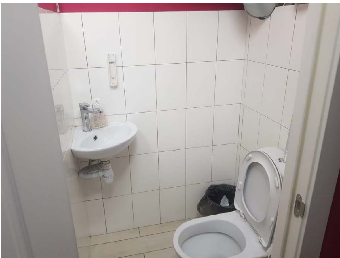
Фото 35. Интерьер помещения 1-Н, расположенного в выявленном объекте культурного наследия «Дом И. Жадимировского (К.А. Тура), ч.п. №4, вход в ч.п.№14
