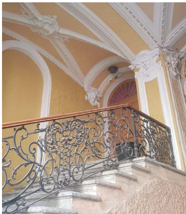
Фото 5. Входной дверной проем крыльца воротного проезда со стороны лицевого фасада выявленного объекта культурного наследия «Дом И. Жадимировского (К.А. Тура)»
