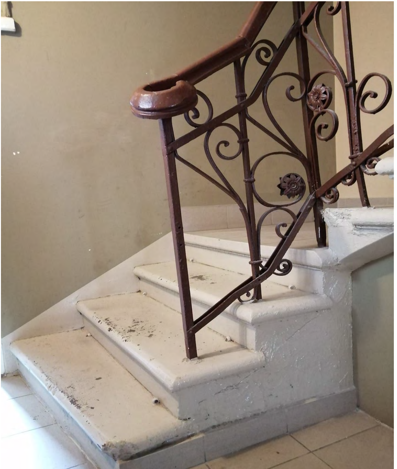
Фото 5. Объект культурного наследия регионального значения "Дом А. Сверчкова (Кушелевой)", расположенный в Санкт-Петербурге, 1-я линия В.О., дом 14, литера А. Помещение 1ЛК(1). Лестница одномаршевая, марш по металлическим косоурам, ступени и межэтажные площадки лещадной плиты (?); профиль ступеней с валиком; ограждение маршей лестницы между первым и вторым этажами – черного металла; рисунок – волнотобразные завитки с многолепестковыми розетками; поручни – деревянные профилированные.
