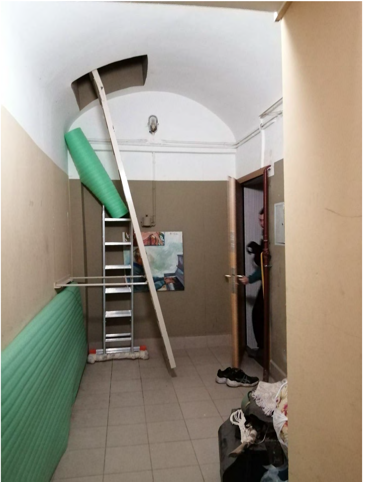
Фото 6. Объект культурного наследия регионального значения "Дом А. Сверчкова (Кушелевой)", расположенный в Санкт-Петербурге, 1-я линия В.О., дом 14, литера А. Помещение 1ЛК(2). Полуциркульный свод в завершении лестницы.
