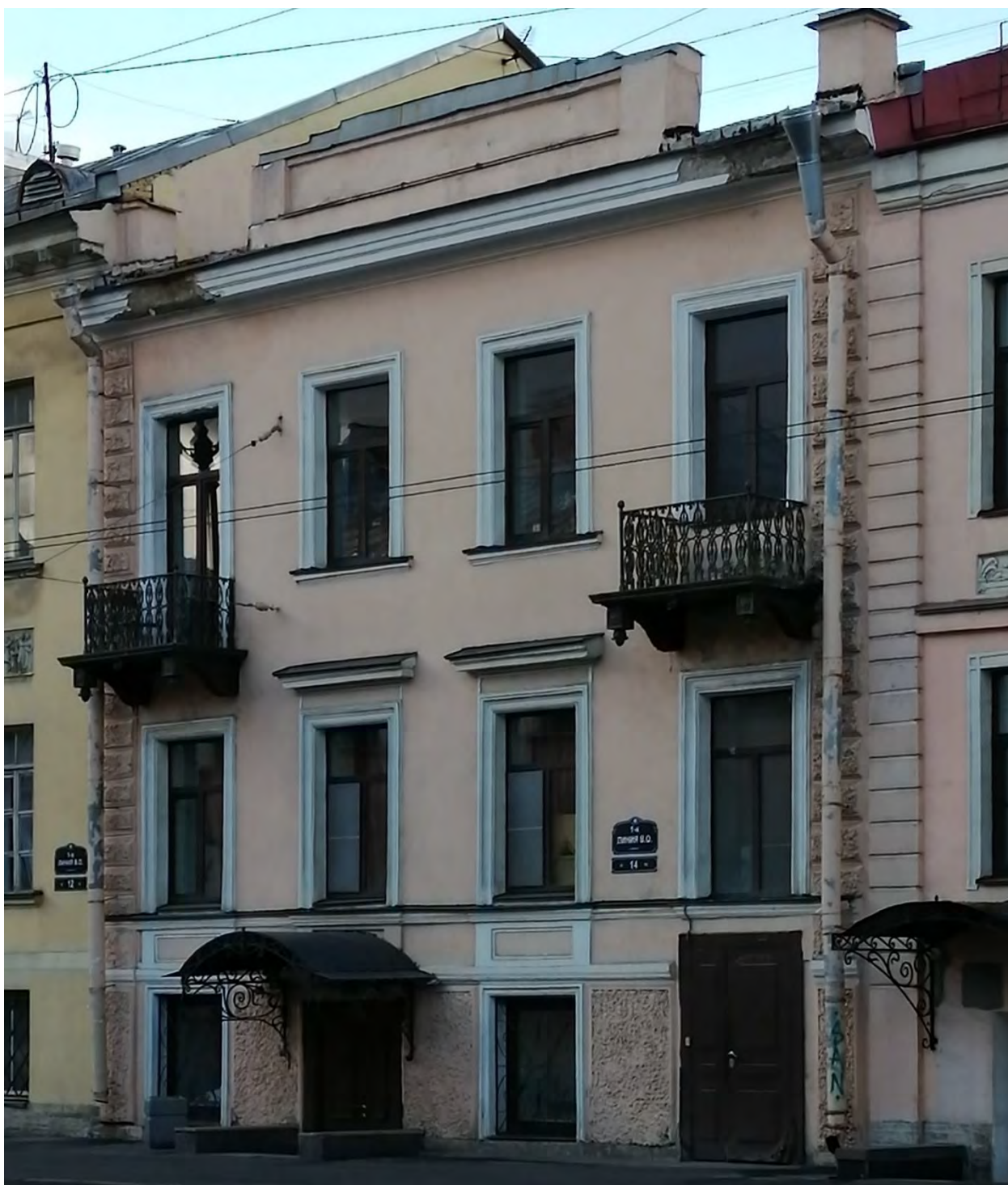
Фото 1. Объект культурного наследия регионального значения "Дом А. Сверчкова (Кушелевой)", расположенный в Санкт-Петербурге, 1-я линия В.О., дом 14, литера А. Лицевой фасад.
