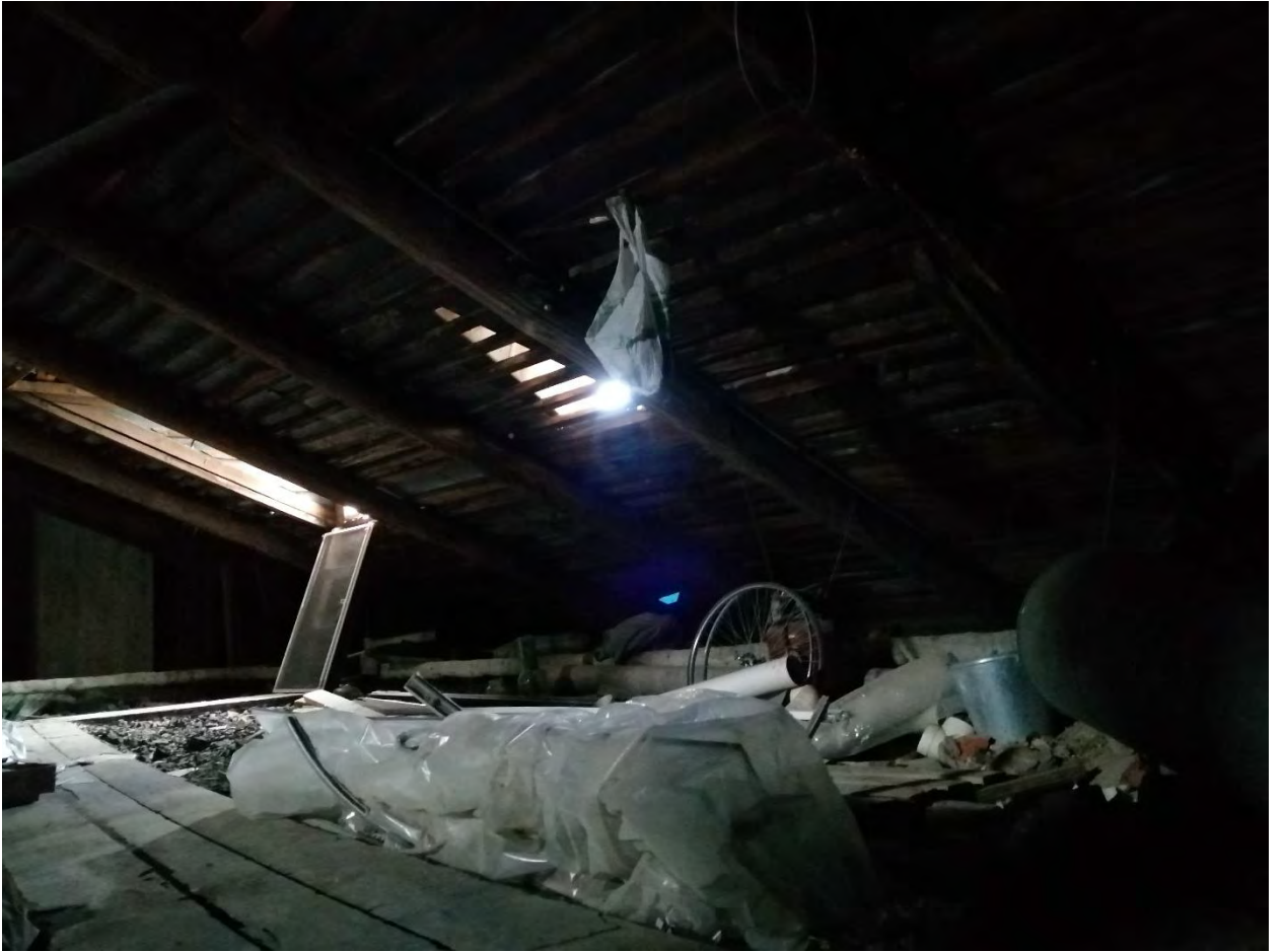
Фото 20. Объект культурного наследия регионального значения "Дом А. Сверчкова (Кушелевой)", расположенный в Санкт-Петербурге, 1-я линия В.О., дом 14, литера А. Чердачное помещение, стропильная система, дворовый скат крыши.
