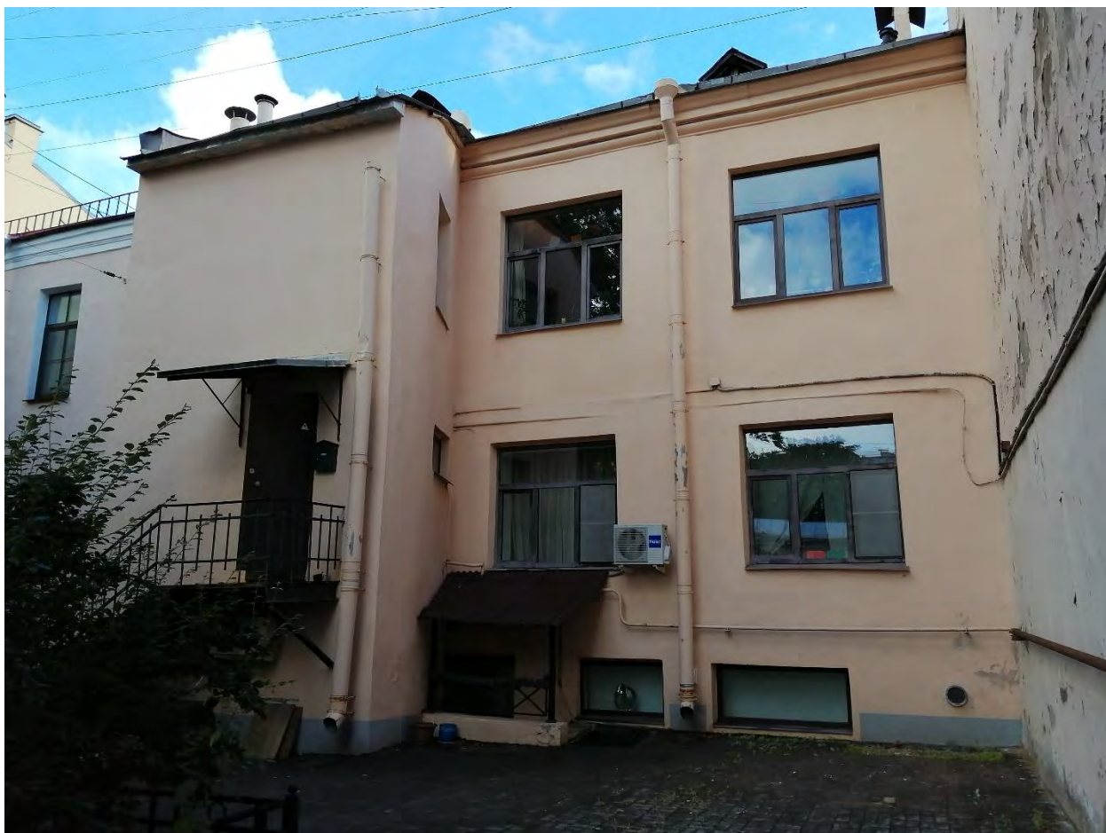
Фото 2. Объект культурного наследия регионального значения "Дом А. Сверчкова (Кушелевой)", расположенный в Санкт-Петербурге, 1-я линия В.О., дом 14, литера А. Дворовый фасад.
