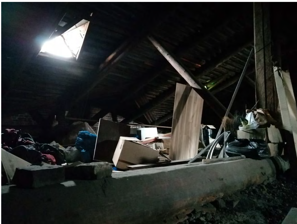
Фото 21. Объект культурного наследия регионального значения "Дом А. Сверчкова (Кушелевой)", расположенный в Санкт-Петербурге, 1-я линия В.О., дом 14, литера А. Чердачное помещение, стропильная система, лицевой скат крыши.
