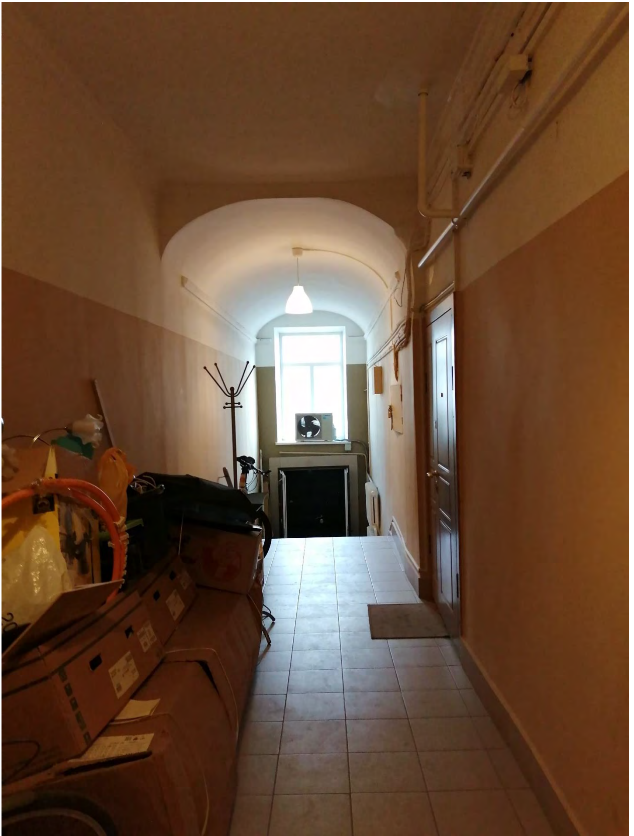
Фото 4. Объект культурного наследия регионального значения "Дом А. Сверчкова (Кушелевой)", расположенный в Санкт-Петербурге, 1-я линия В.О., дом 14, литера А. Помещение 1ЛК(1). Коробовый свод в вестибюле парадного входа.
