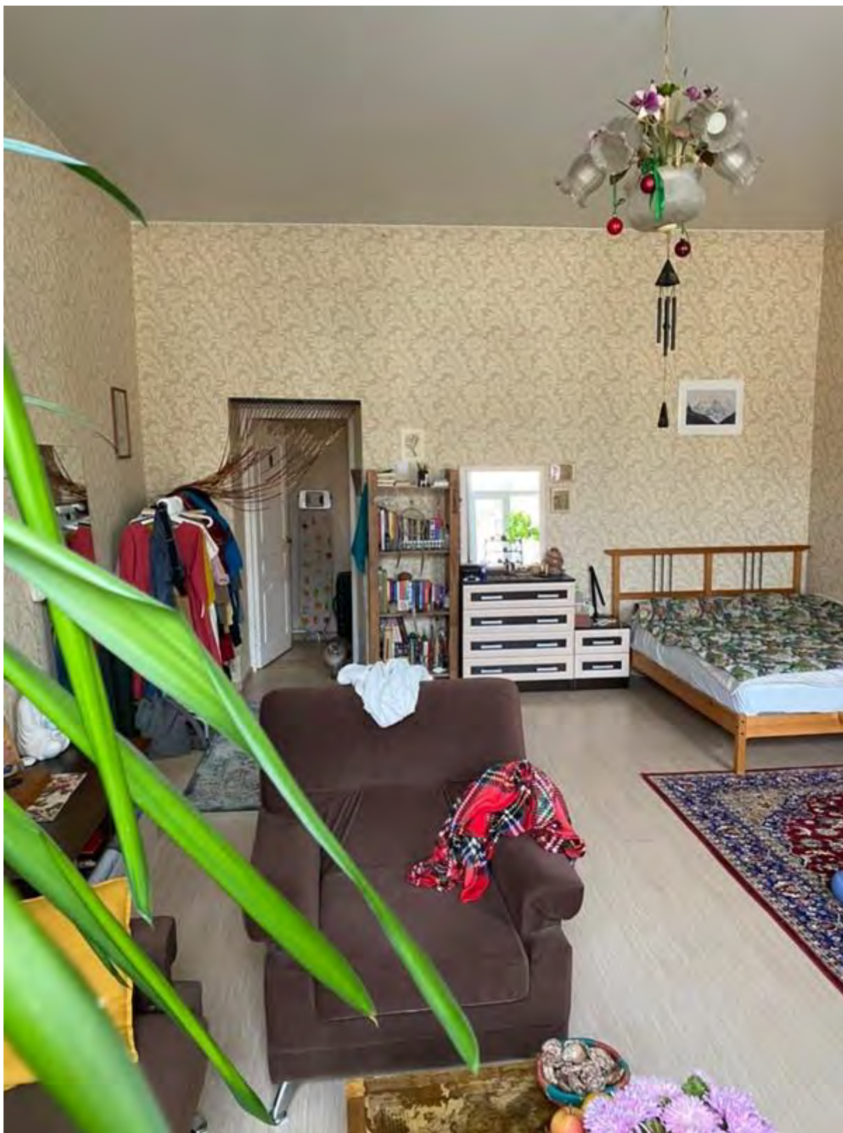
Фото 19. Объект культурного наследия регионального значения "Дом А. Сверчкова (Кушелевой)", расположенный в Санкт-Петербурге, 1-я линия В.О., дом 14, литера А. Квартира 2. Помещения 4, 3. Заполнение входного проема.
