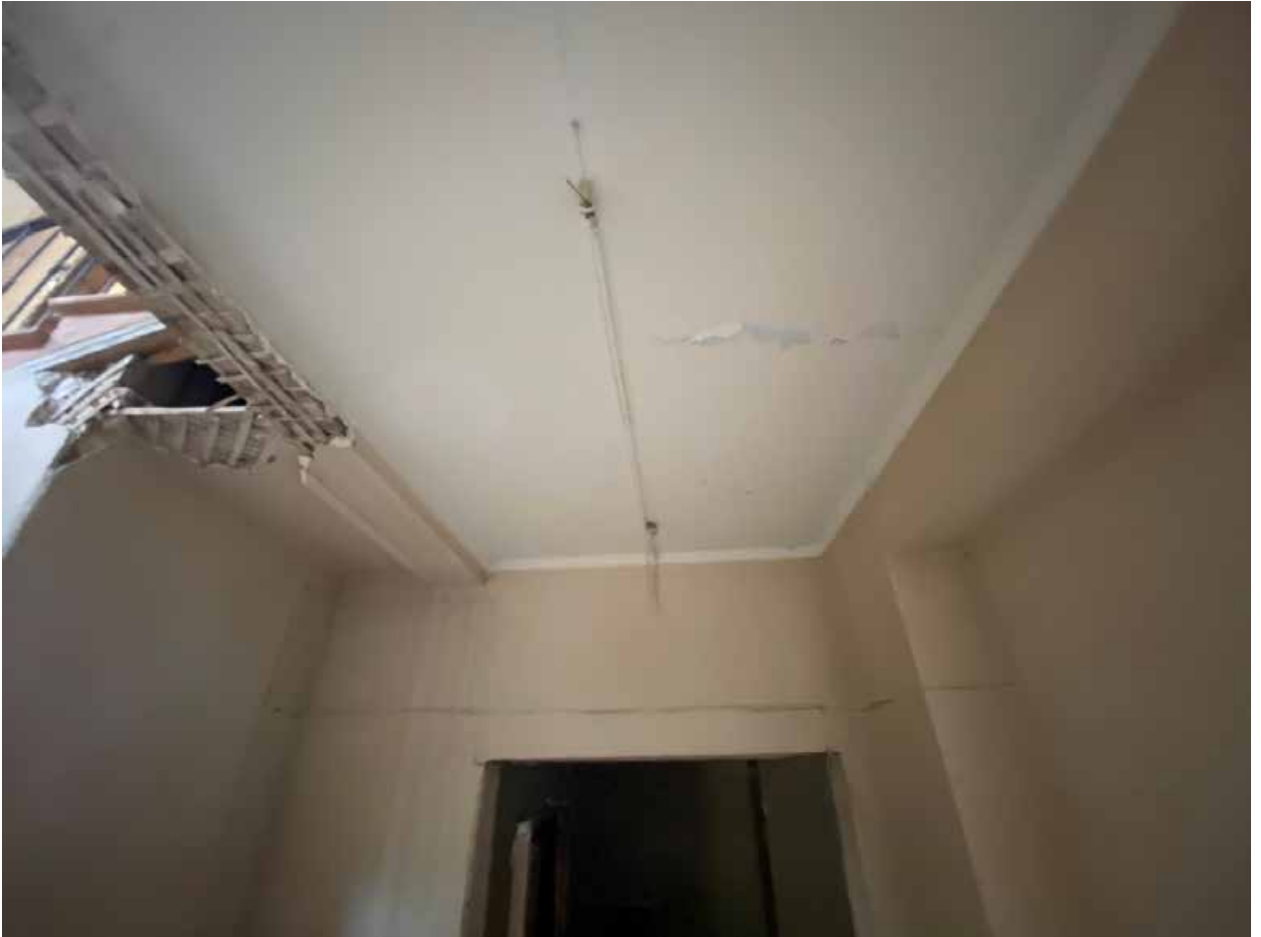
Фото 48. Помещение под лестничным маршем. Лестничная клетка в западном объеме здания.
