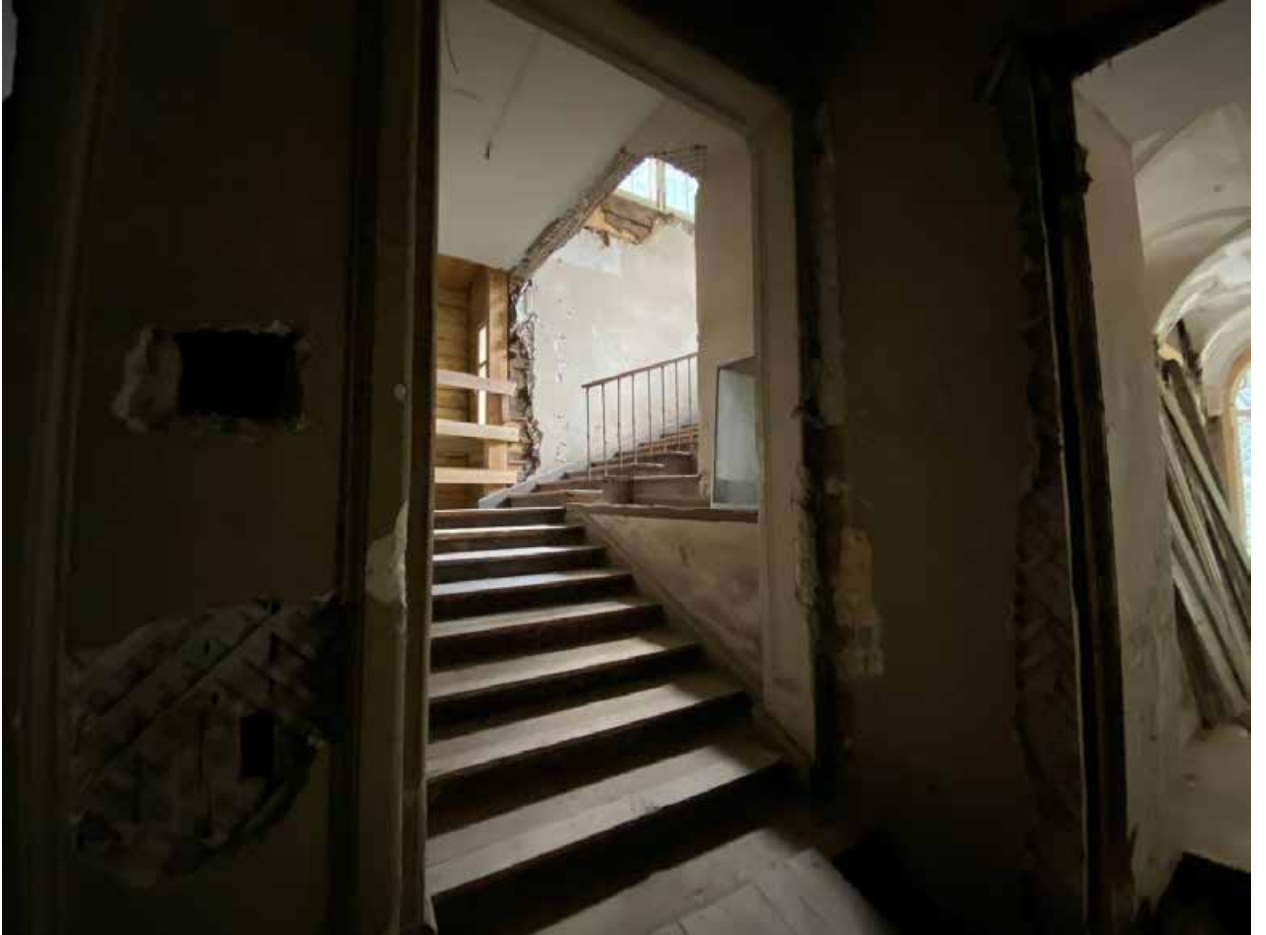
Фото 38. Лестничная клетка в западном объеме здания.
