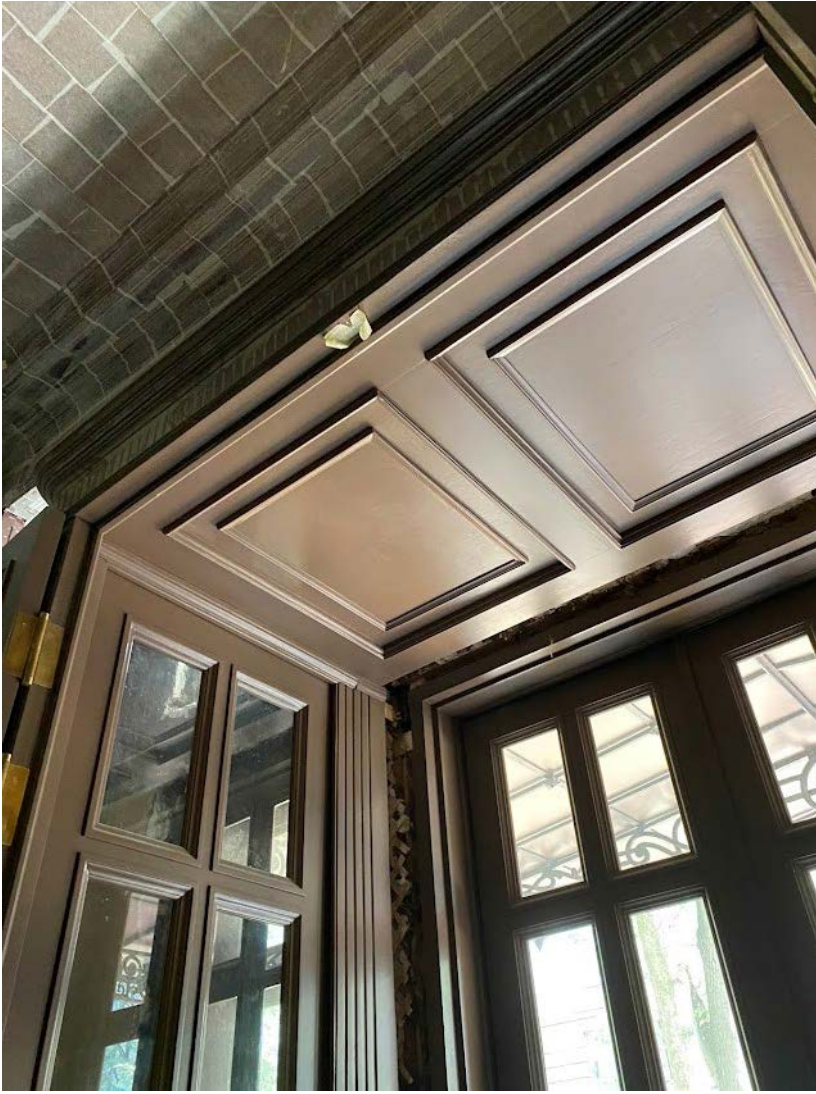
Фото 36. Помещение 1-Н(2). Тамбур главного входа.
