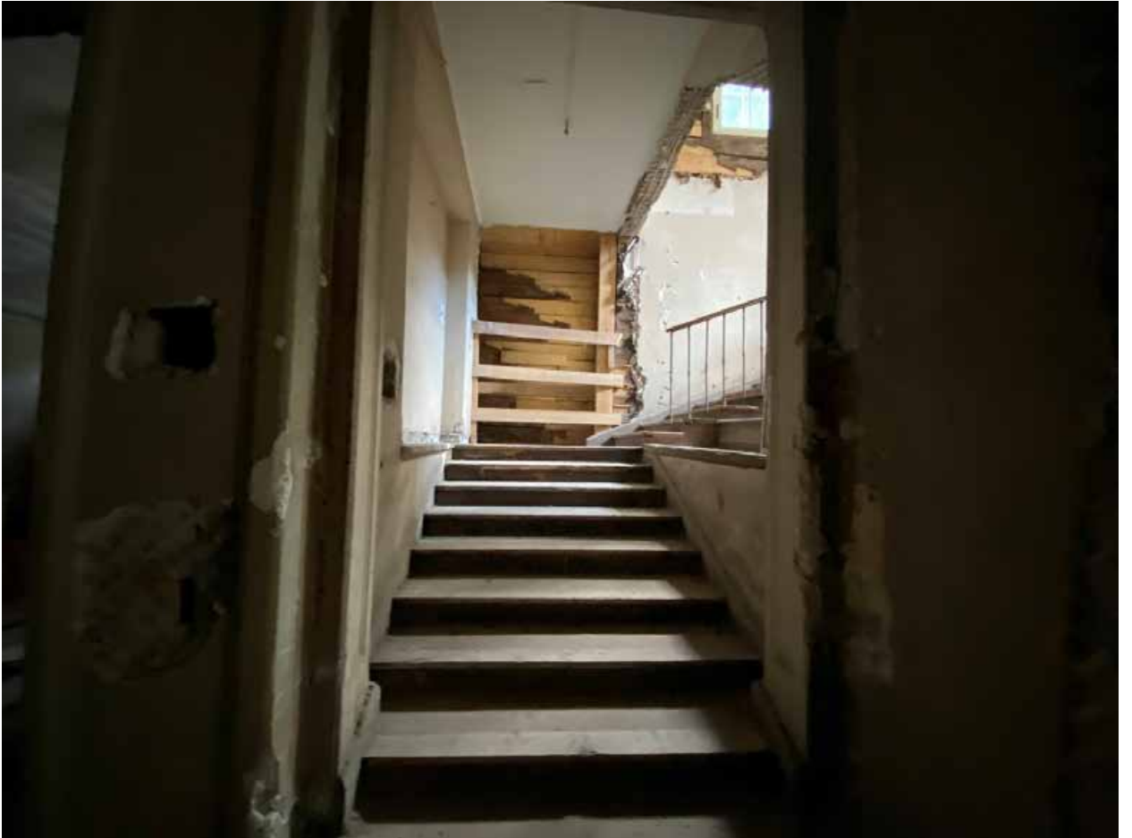
Фото 39. Лестничная клетка в западном объеме здания.
