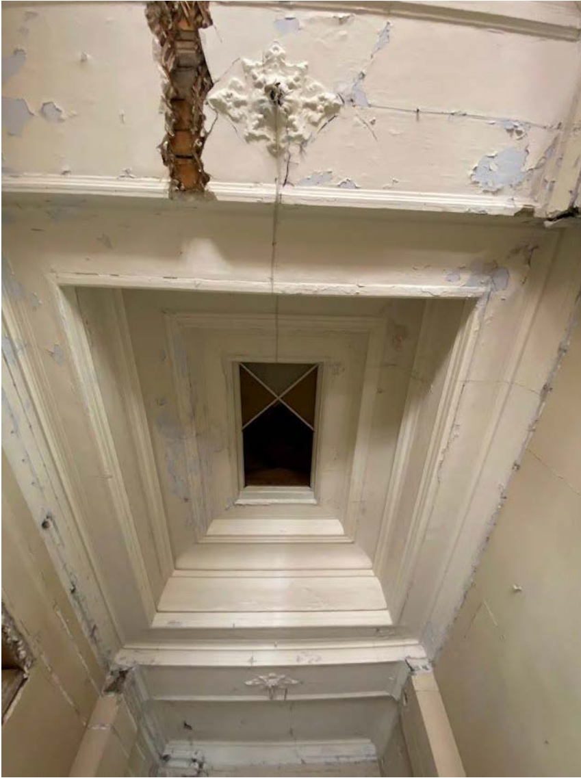
Фото 100. Световой фонарь. Помещение 1-Н(60).
