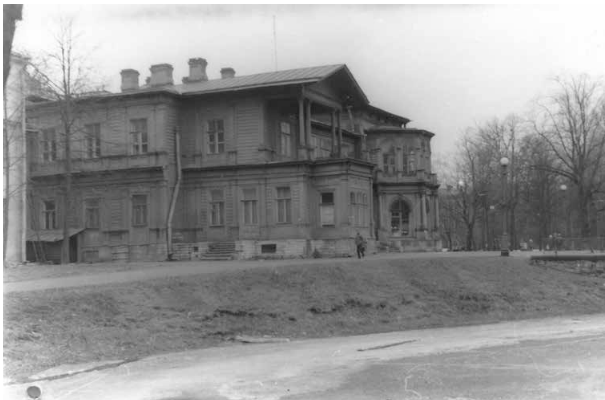
Илл. 27. Вид деревянной дачи на высокой террасе в саду имени Ф.Э.Дзержинского на ул. Академика Павлова, д. 13 (бывшая дача купца В.Ф. Громова, 1850- е гг., архитекторы Г.И. Винтергальтер и А.М. Горностаев). 1973 г. ЦГАКФФД СПб. Ар 238581.
