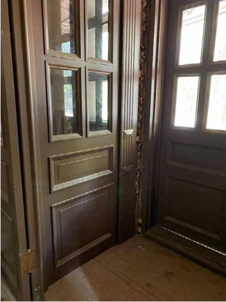
Фото 37. Помещение 1-Н(2). Тамбур главного входа.
