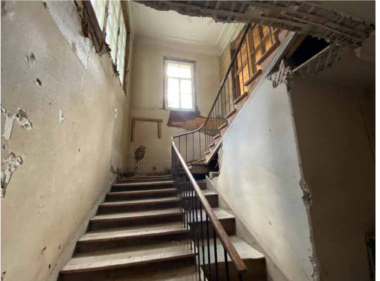
Фото 46. Лестничная клетка в западном объеме здания
