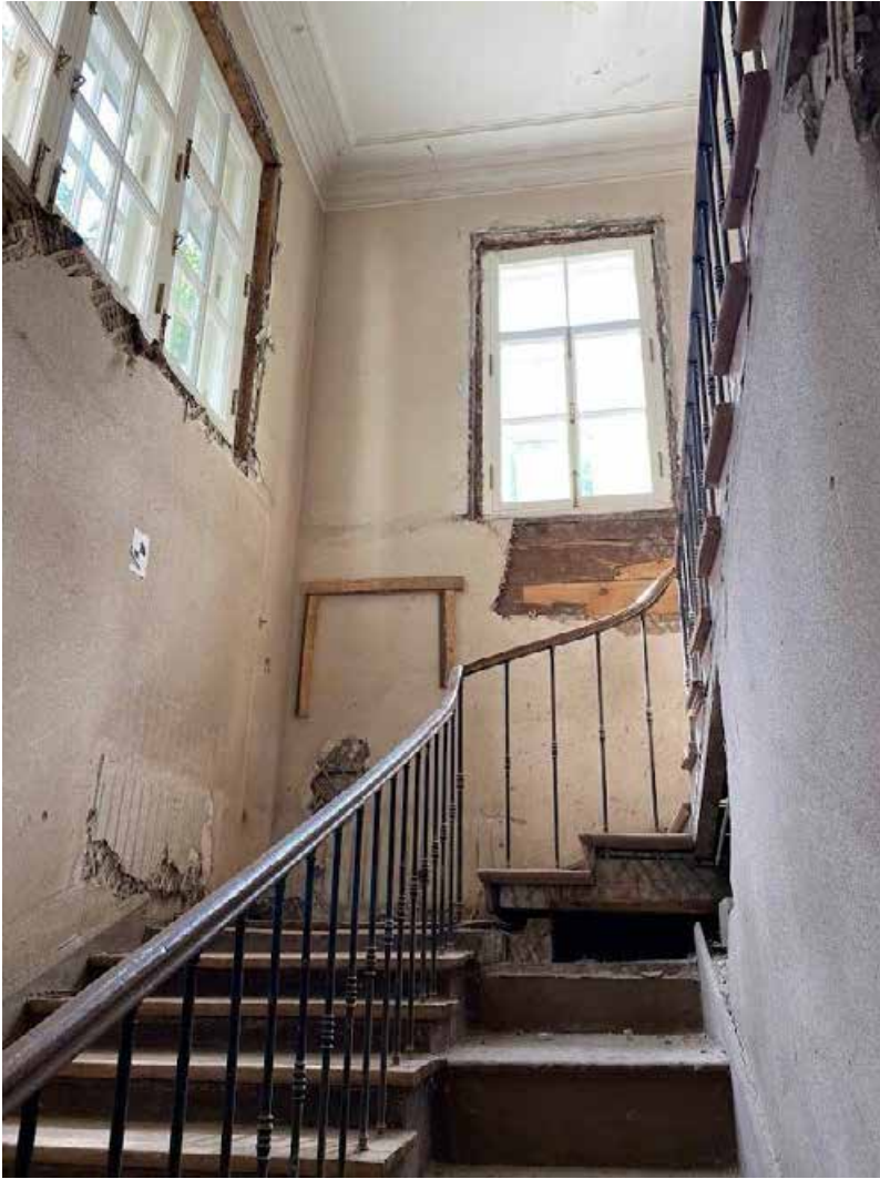
Фото 47. Лестничная клетка в западном объеме здания.
