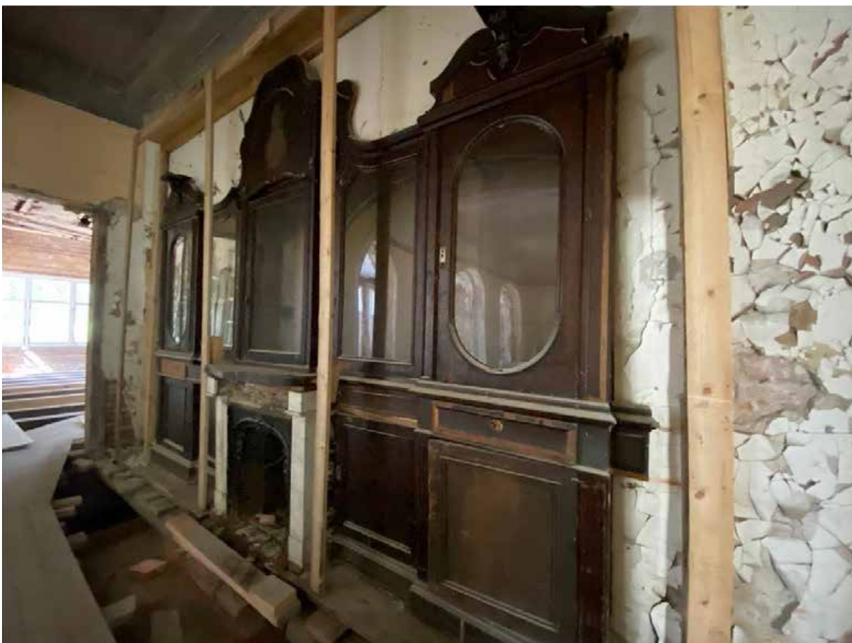
Фото 79. Встроенный шкаф. Помещение 1-Н(20).
