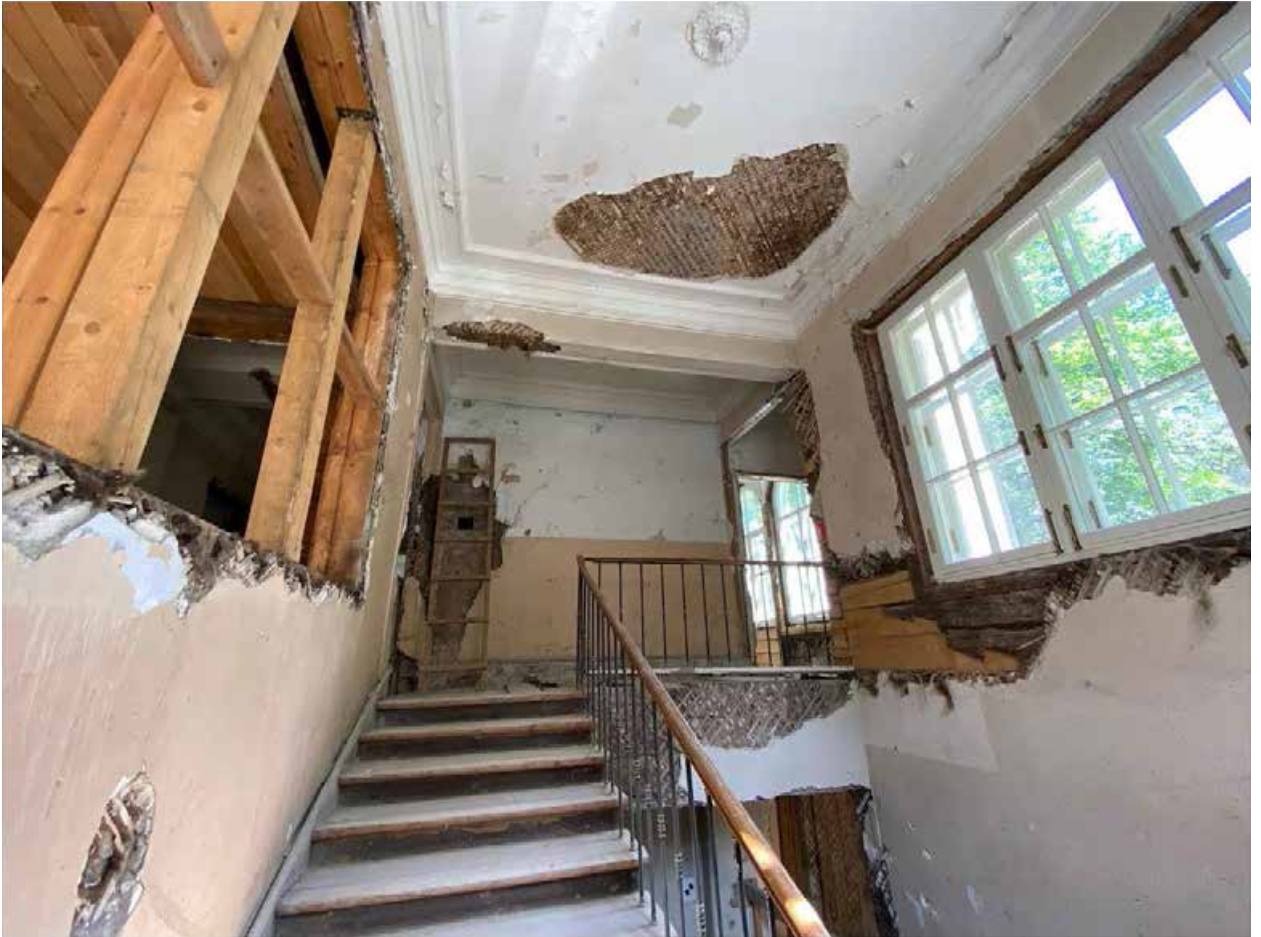
Фото 94. Лестничная клетка в западном объеме здания.
