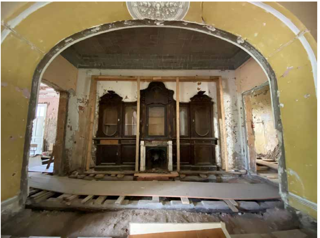
Фото 76. Встроенный шкаф. Помещение 1-Н(20).
