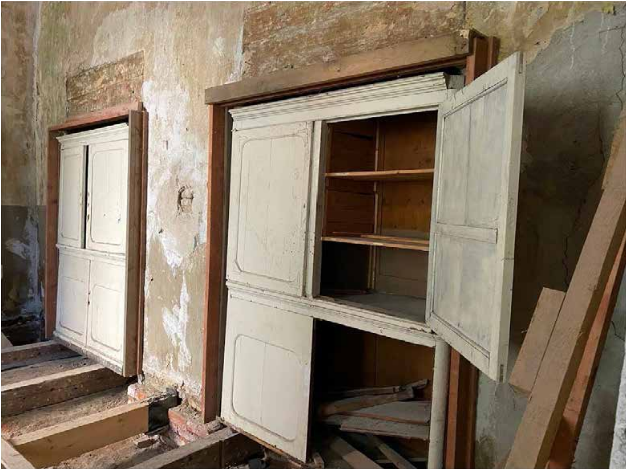
Фото 87. Встроенные шкафы. Помещение 1-Н(15).
