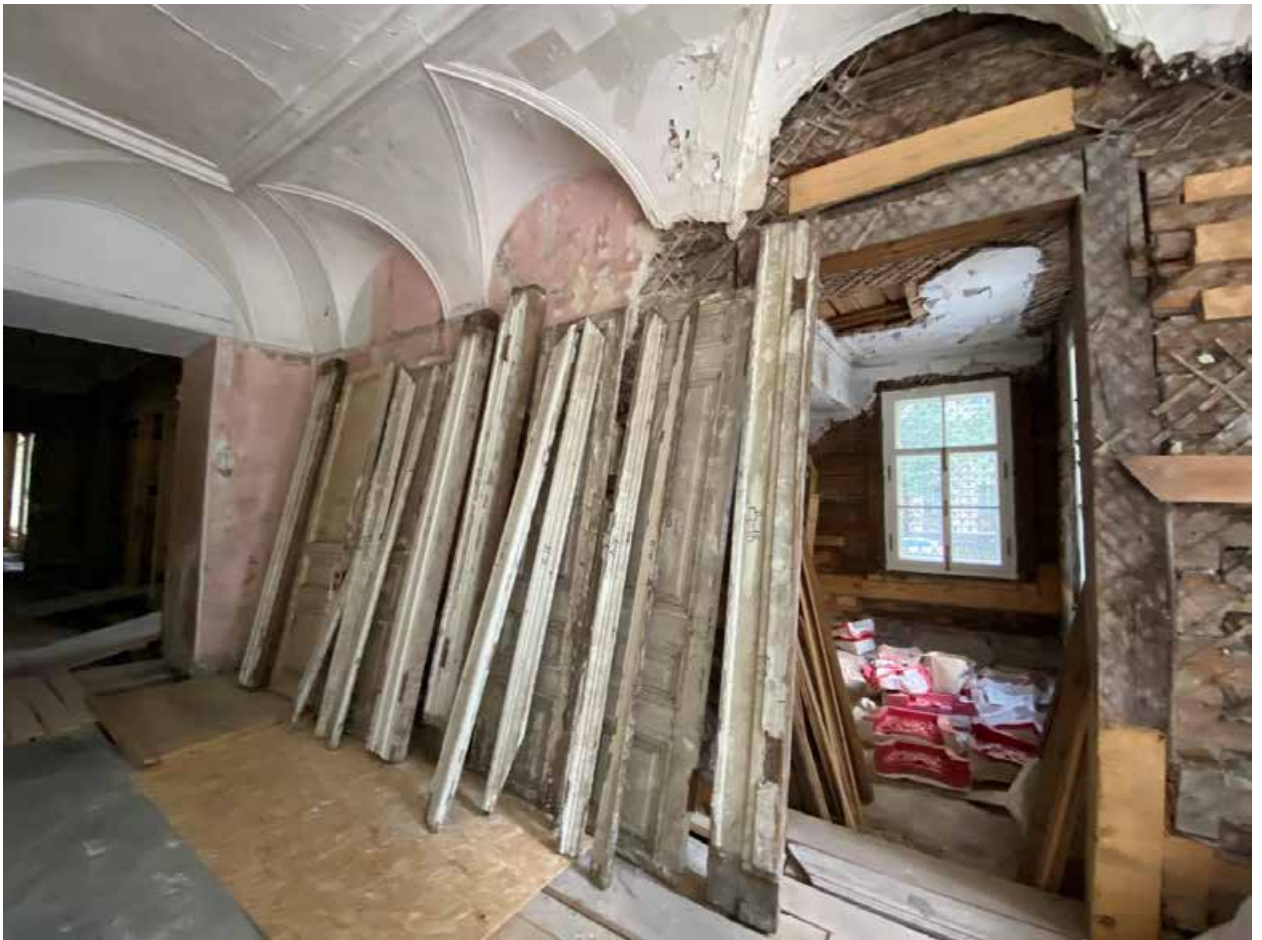
Фото 43. Помещение 1-Н(9), вход в Помещение 1-Н(8).
