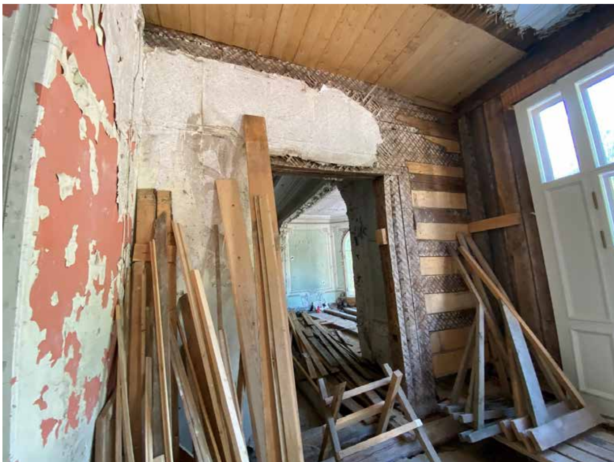
Фото 72. Вход в помещение 1-Н(12).
