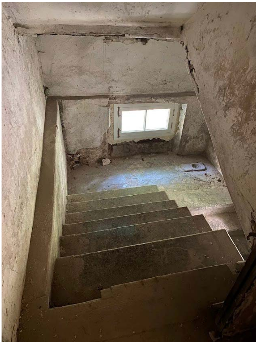
Фото 25. Лестничная клетка в восточном объеме здания. Вход в подвальные помещения.
