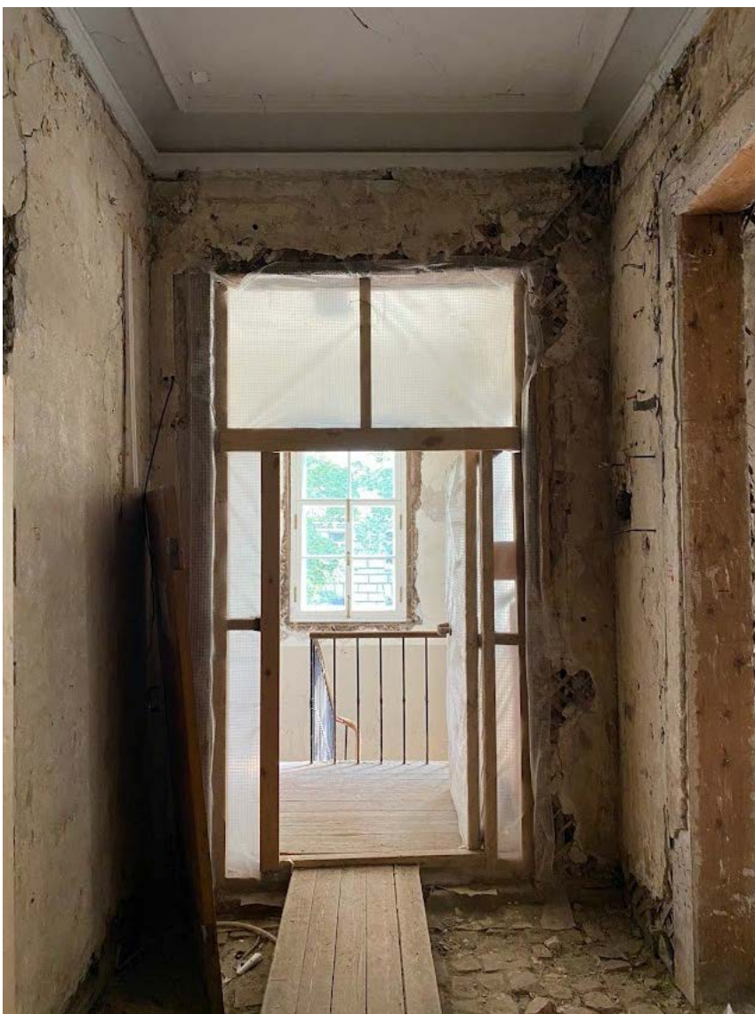
Фото 122. Помещение 1-Н(74), вход в лестничную клетку в восточном объеме здания.
