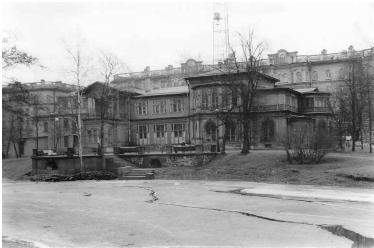
Илл. 28. Общий вид деревянного дачного дома в саду им. Дзержинского (бывшая дача В.Ф. Громова с садом, 1850-е годы). 1973 г. ЦГАКФФД СПб. Ар 225584.
