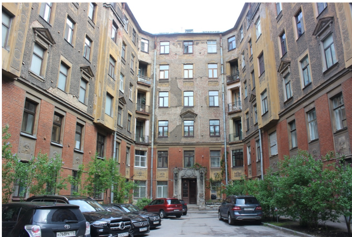
8. Фрагмент дворовых фасадов здания
