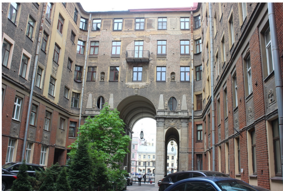
10. Фрагмент дворовых фасадов здания
