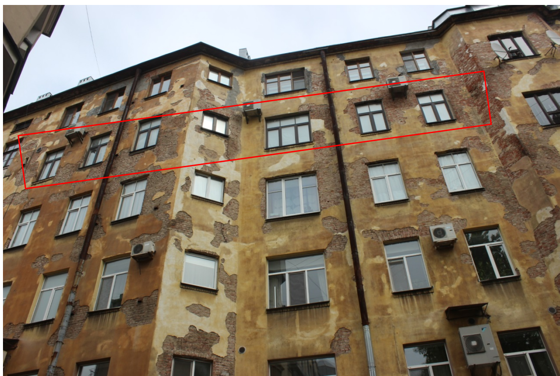
15. Фрагмент дворового фасада здания
