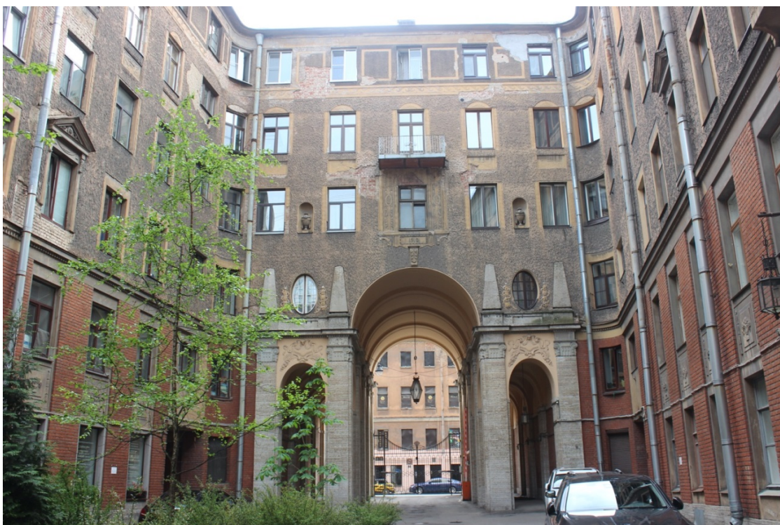
4. Фрагмент дворовых фасадов здания
