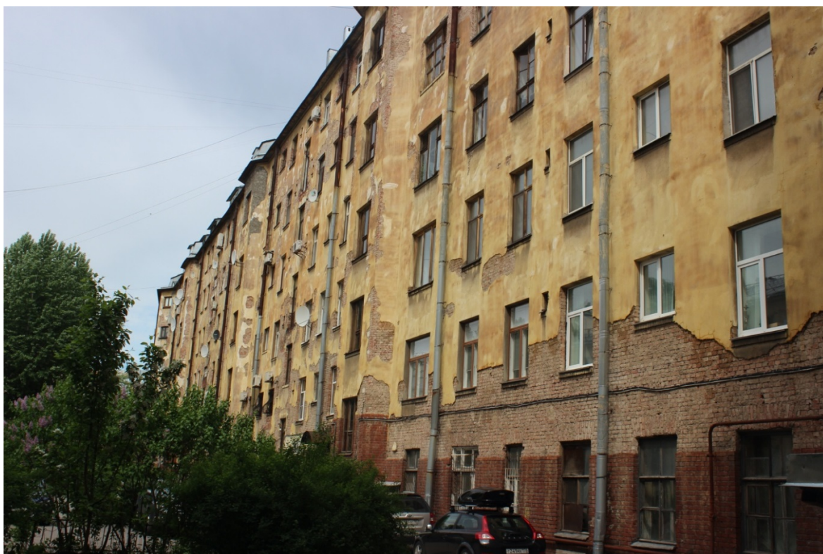
14. Фрагмент дворового фасада здания
