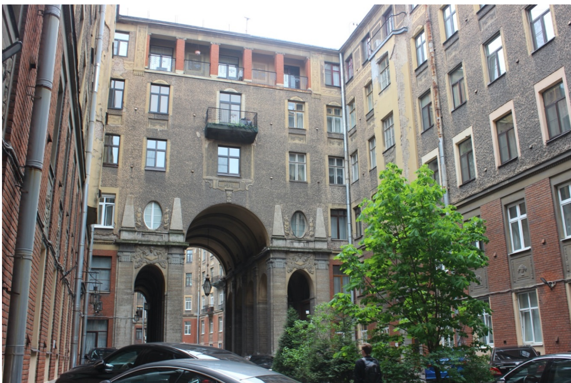
11. Фрагмент дворовых фасадов здания
