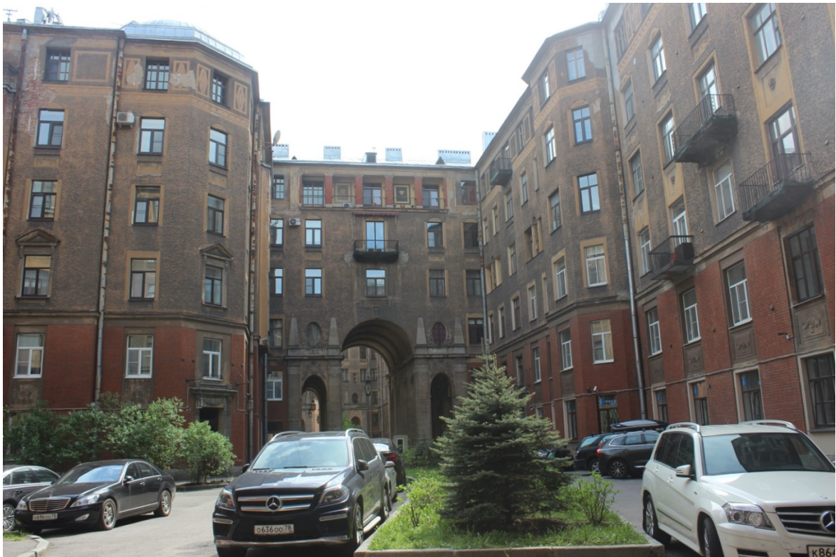
9. Фрагмент дворовых фасадов здания
