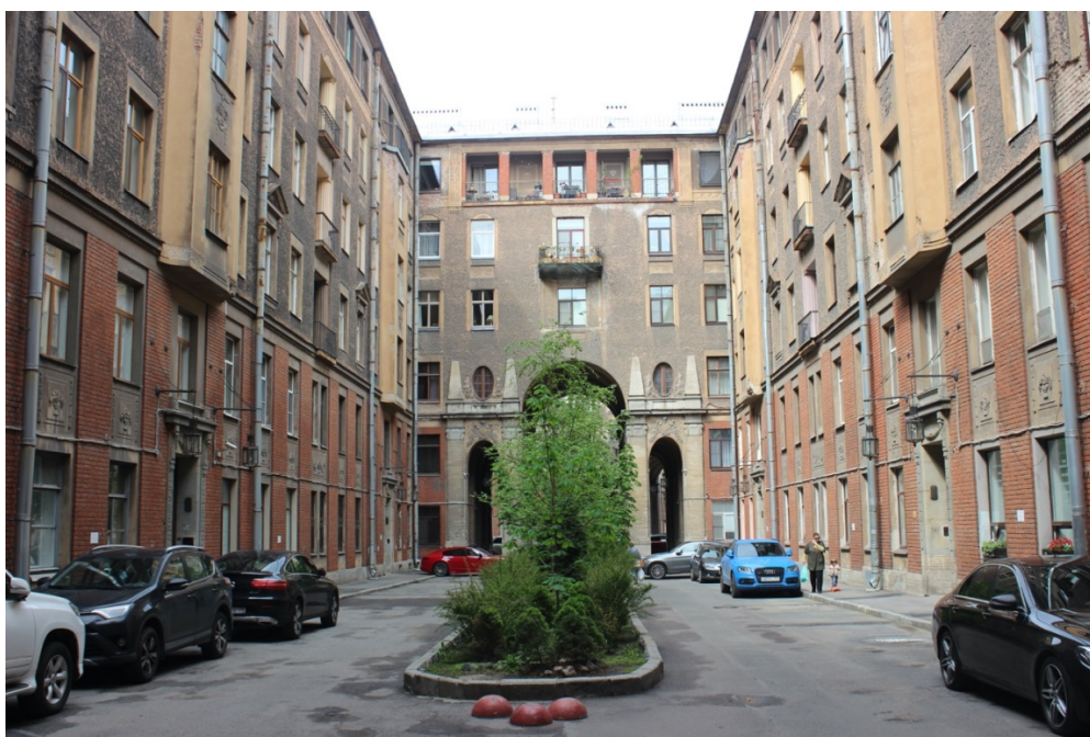
3. Фрагмент дворовых фасадов здания
