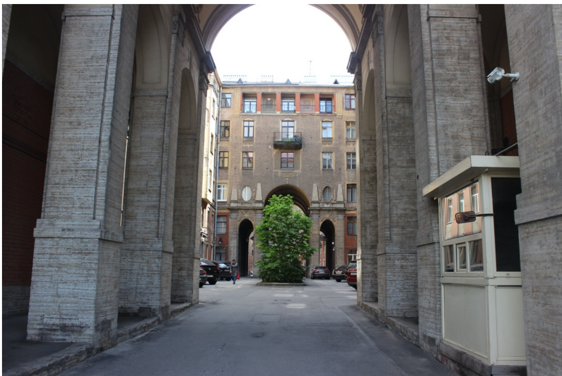
12. Фрагмент дворовых фасадов здания
