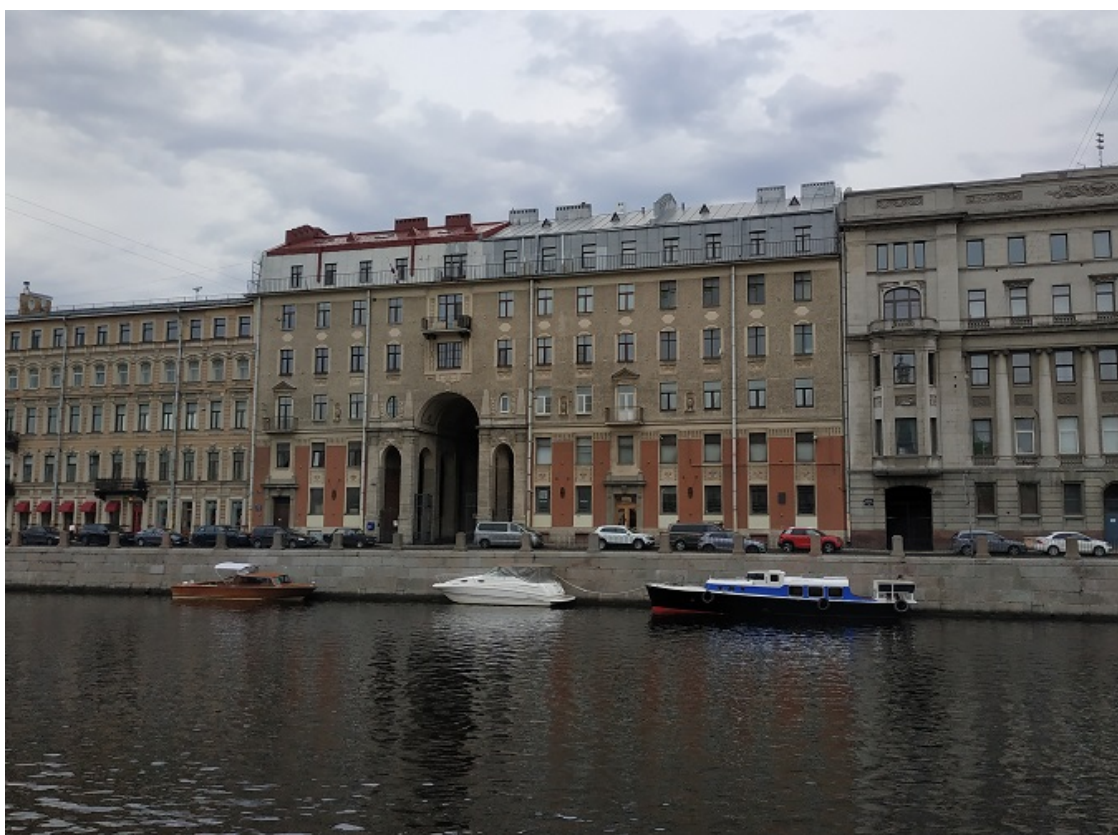
13. Общий вид лицевого фасада
