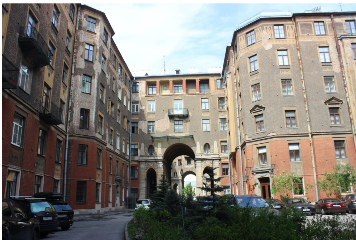
7. Общий вид дворовых фасадов здания
