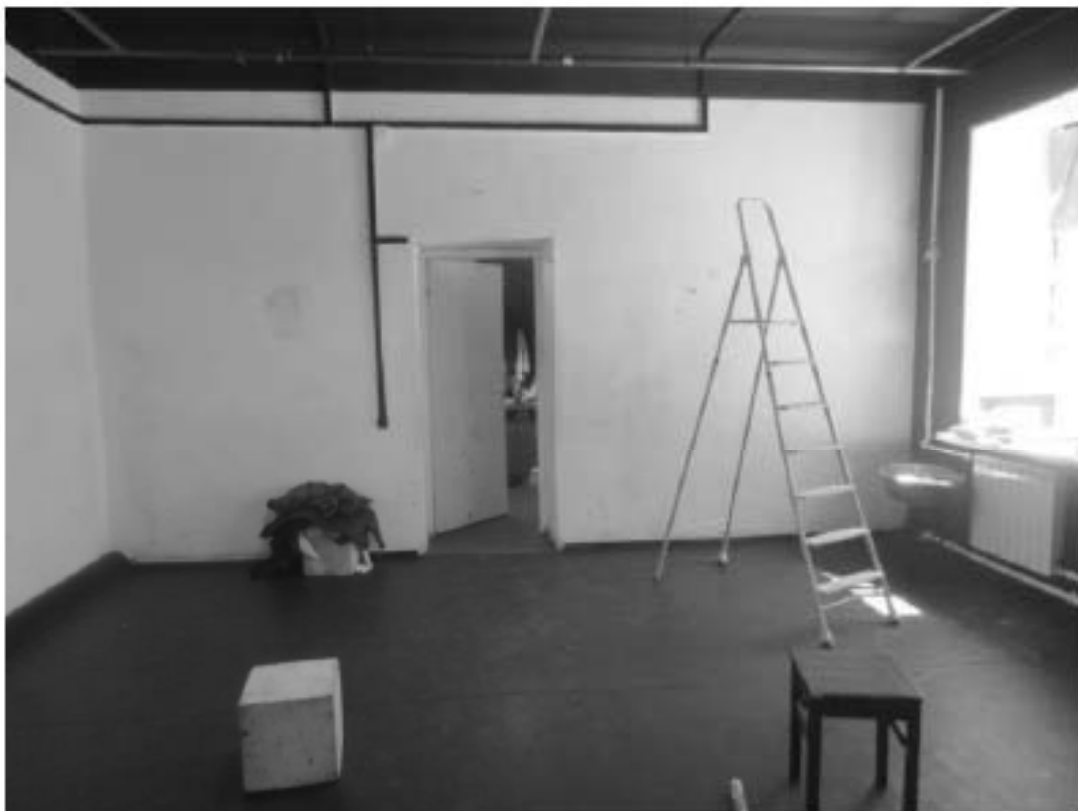
44. «Особняк Безобразовой». Санкт-Петербург, Моховая ул., 34, литера А (Моховая ул., 34). Лицевой корпус. 1-й этаж. Фрагмент помещения 12-Н(2). Фото: 21.09.2022.
