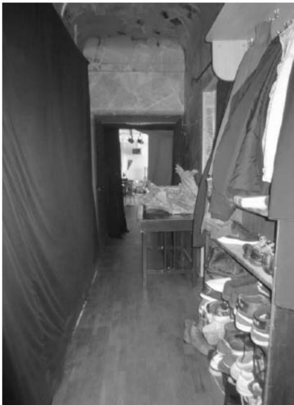
172. «Особняк Безобразовой». Санкт-Петербург, Моховая ул., 34, литера А (Моховая ул., 34). Дворовый корпус. 5-й этаж. Фрагмент помещения 27-Н(2). Фото: 21.09.2022.
