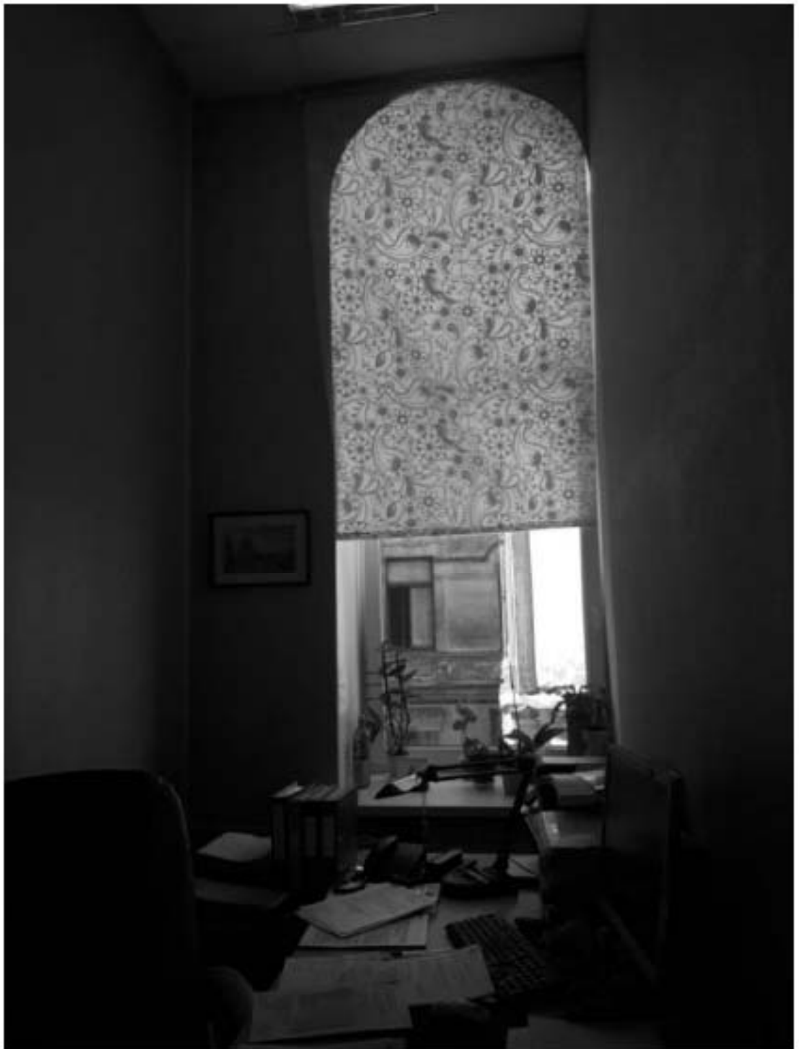
95. «Особняк Безобразовой». Санкт-Петербург, Моховая ул., 34, литера А (Моховая ул., 34). Дворовый корпус. 2-й этаж. Фрагмент помещения 19-Н(11). Фото: 21.09.2022.
