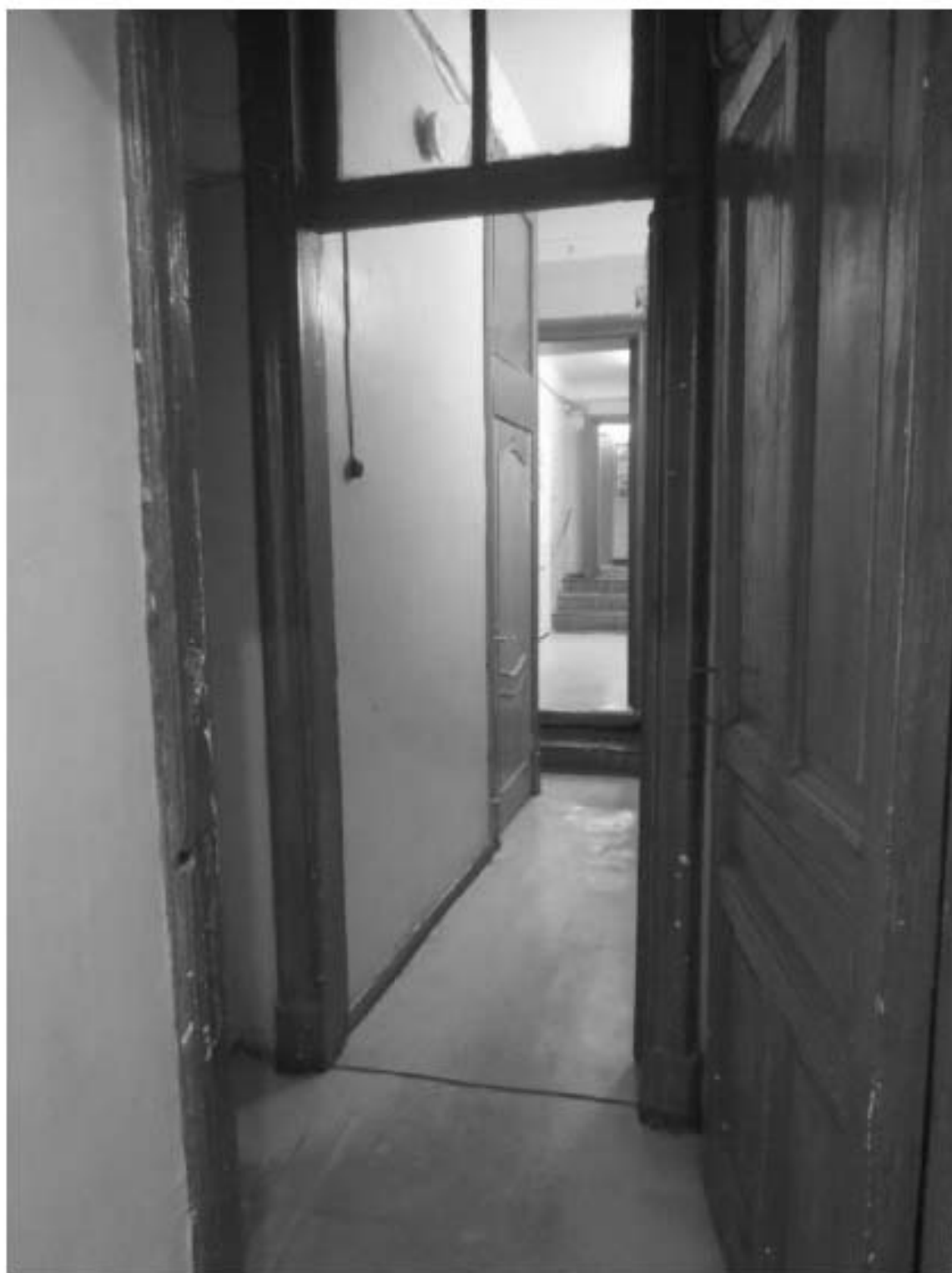
46. «Особняк Безобразовой». Санкт-Петербург, Моховая ул., 34, литера А (Моховая ул., 34). Лицевой корпус. 1-й этаж. Фрагмент помещения 15-Н(3). Фото: 21.09.2022.
