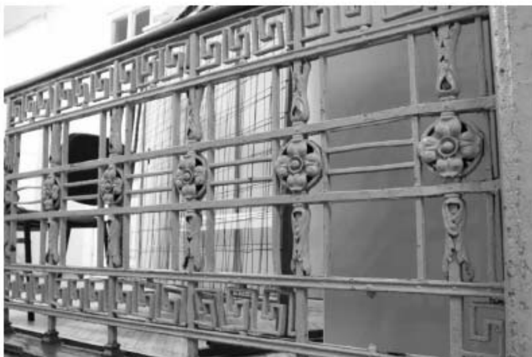
155. «Особняк Безобразовой». Санкт-Петербург, Моховая ул., 34, литера А (Моховая ул., 34). Дворовый корпус. 3-й этаж. Фрагмент помещения 21-Н(17). Фото: 21.09.2022.
