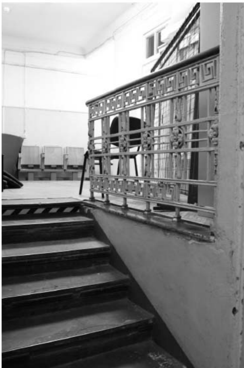
154. «Особняк Безобразовой». Санкт-Петербург, Моховая ул., 34, литера А (Моховая ул., 34). Дворовый корпус. 3-й этаж. Фрагмент помещения 21-Н(17). Фото: 21.09.2022.
