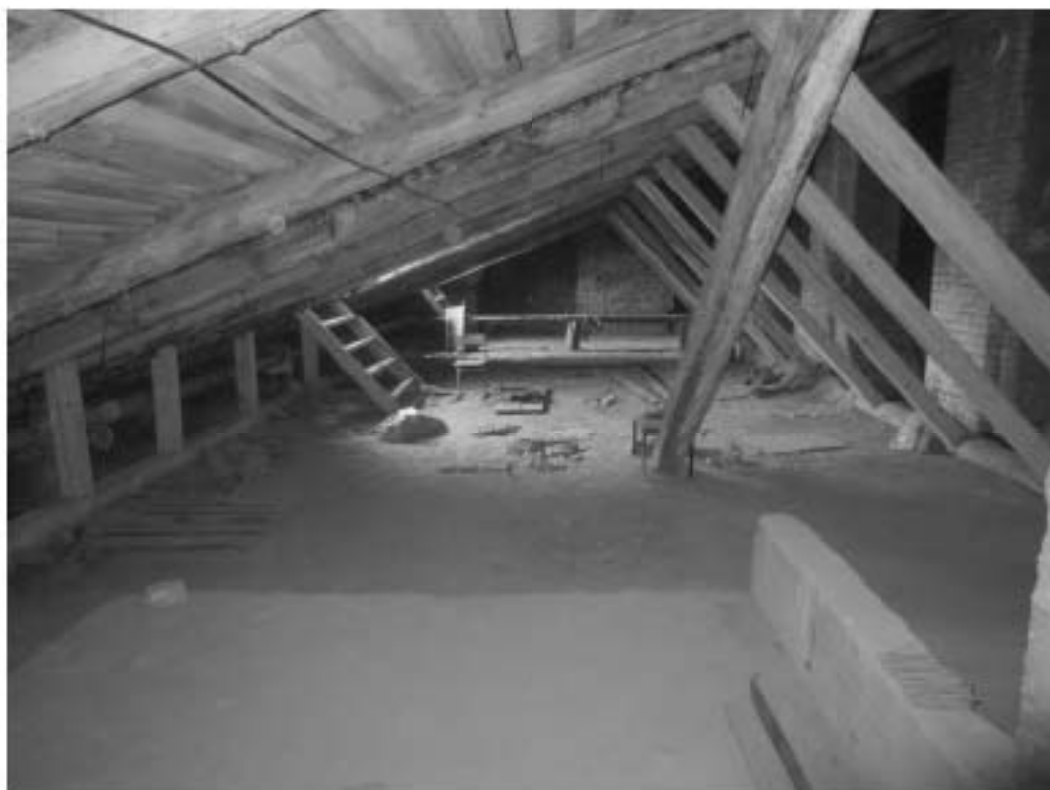
179. «Особняк Безобразовой». Санкт-Петербург, Молоховая ул., 34, литера А (Молоховая ул., 34). Фрагмент чердачного помещения. Фото: 21.09.2022.
