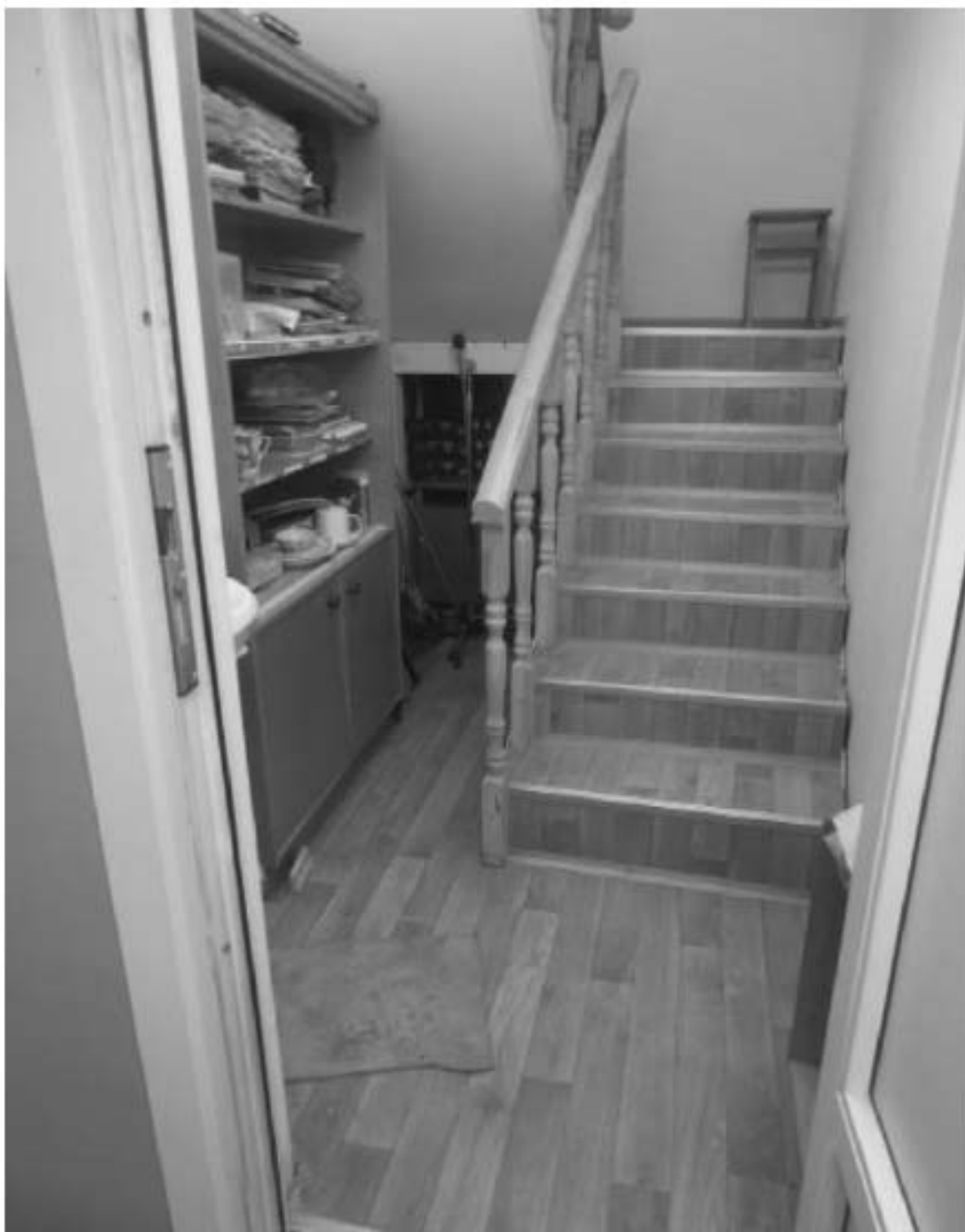
161. «Особняк Безобразовой». Санкт-Петербург, Моховая ул., 34, литера А (Моховая ул., 34). Дворовый корпус. 5-й этаж. Фрагмент помещения 26-Н(2). Фото: 21.09.2022.
