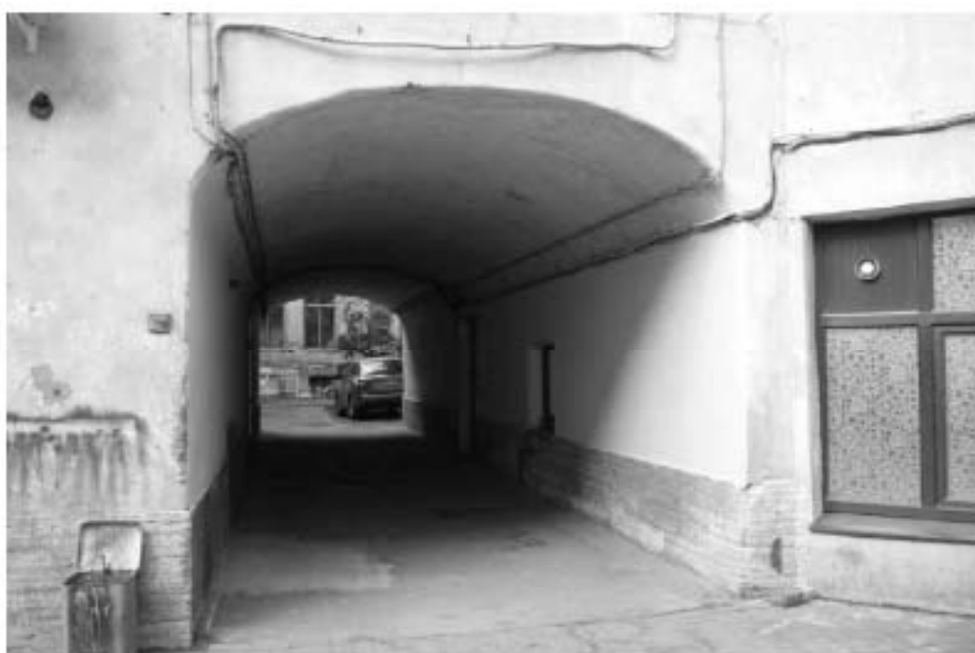
24. «Особняк Безобразовой». Санкт-Петербург, Моховая ул., 34, литера А (Моховая ул., 34). Восточный двор. Фрагмент западного дворового фасада. Фото: 21.09.2022.
