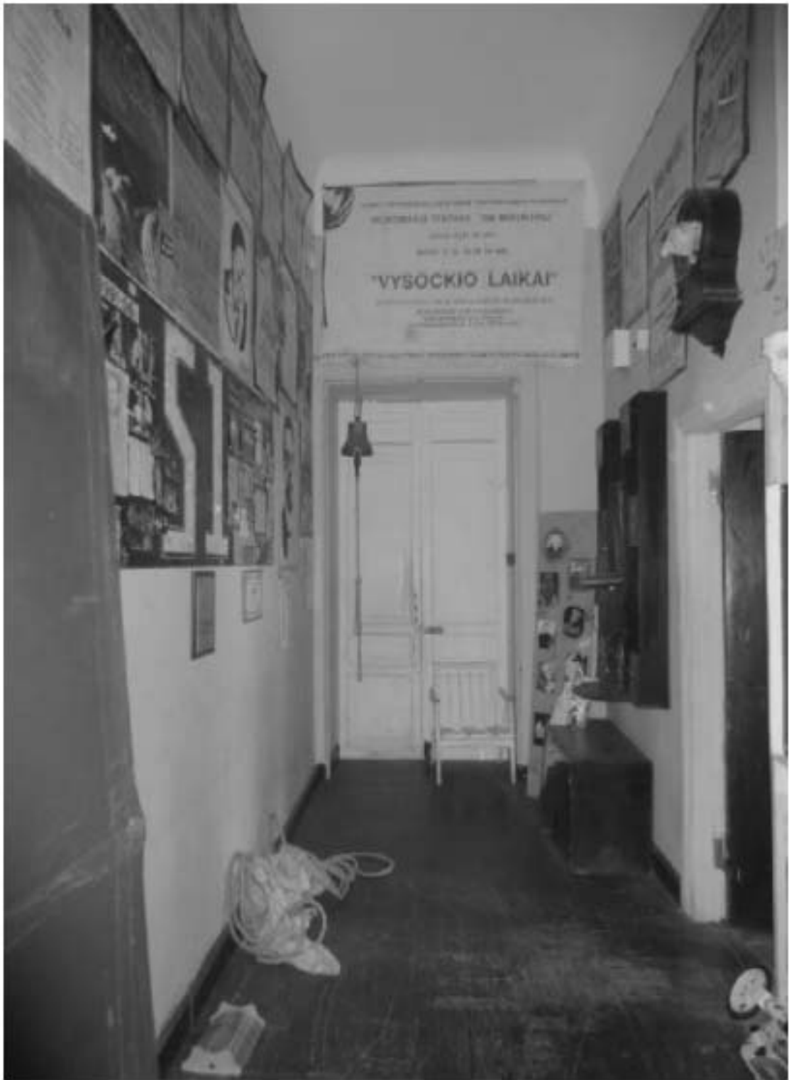
141. «Особняк Безобразовой». Санкт-Петербург, Моховая ул., 34, литера А (Моховая ул., 34). Дворовый корпус. 4-й этаж. Фрагмент помещения 23-Н(1). Фото: 21.09.2022.
