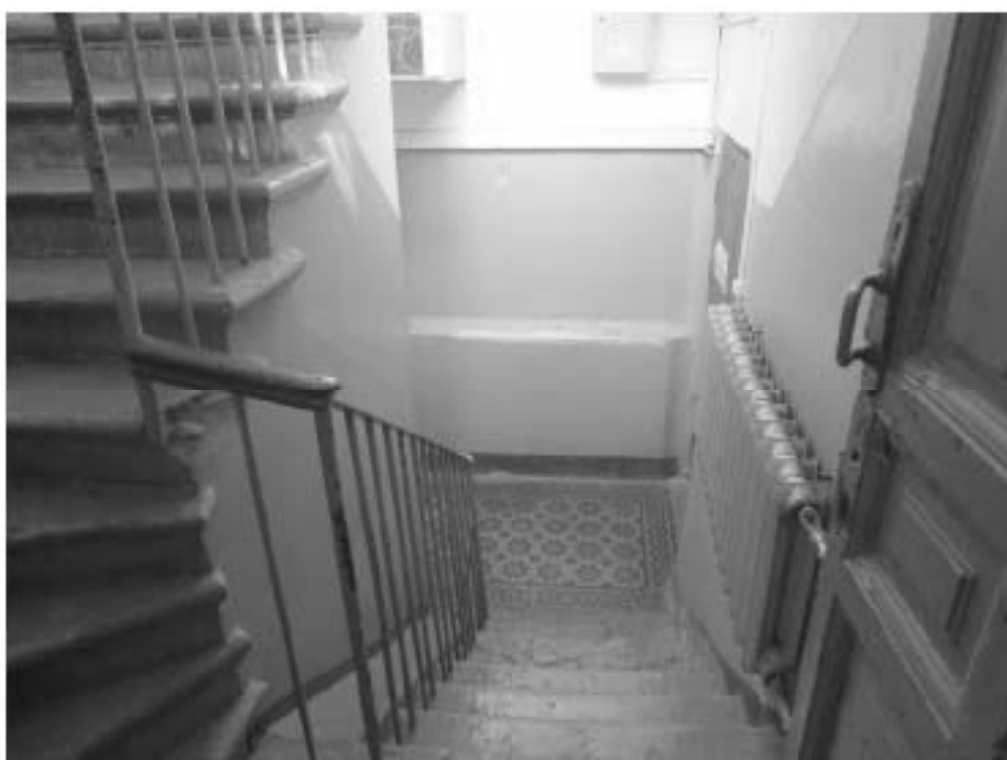
9. «Особняк Безобразовой». Санкт-Петербург, Моховая ул., 34, литера А (Моховая ул., 34). Дворовой корпус. Лестница 3 ЛК. Фото: 21.09.2022.
