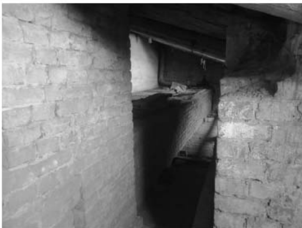
183. «Особняк Безобразовой». Санкт-Петербург, Моховая ул., 34, литера А (Моховая ул., 34). Фрагмент чердачного помещения. Фото: 21.09.2022.
