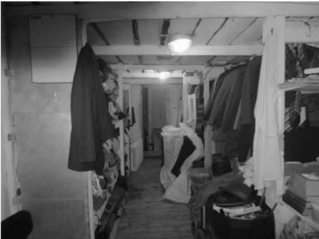
146. «Особняк Безобразовой». Санкт-Петербург, Моховая ул., 34, литера А (Моховая ул., 34). Дворовый корпус. 3-й этаж. Фрагмент помещения 21-Н(4). Фото: 21.09.2022.
