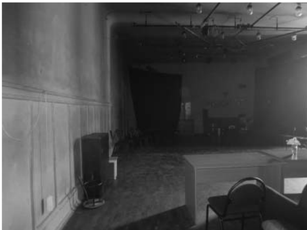
120. «Особняк Безобразовой». Санкт-Петербург, Моховая ул., 34, литера А (Моховая ул., 34). Лицевой корпус. 3-й этаж. Фрагмент помещения 21-Н(б). Фото: 21.09.2022.
