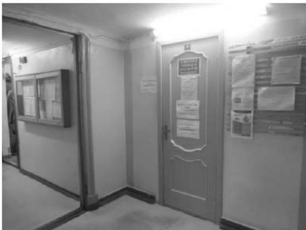
108. «Особняк Безобразовой». Санкт-Петербург, Моховая ул., 34, литера А (Моховая ул., 34). Лицевой корпус. 2-й этаж. Фрагмент помещения 15-Н(13). Фото: 21.09.2022.
