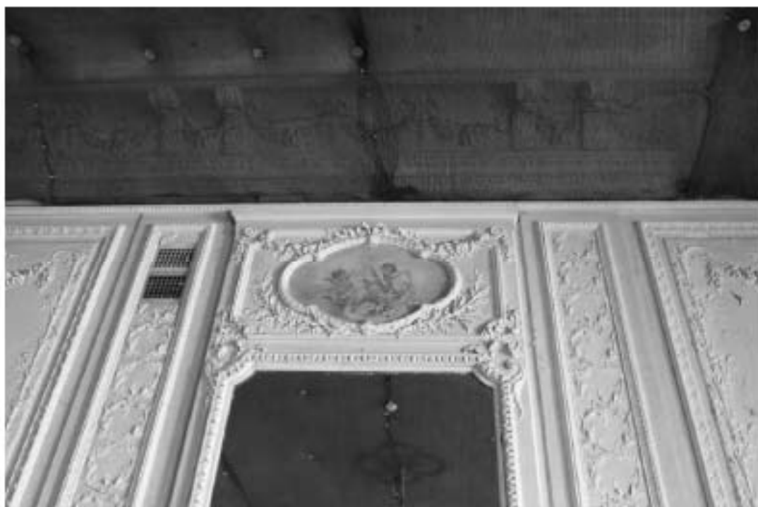
69. «Особняк Безобразовой». Санкт-Петербург, Моховая ул., 34, литера А (Моховая ул., 34). Лицевой корпус. 2-й этаж. Фрагмент помещения 18-Н(2). Фото: 21.09.2022.
