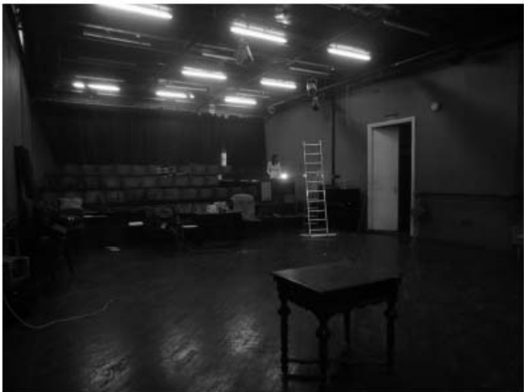
140. «Особняк Безобразовой». Санкт-Петербург, Моховая ул., 34, литера А (Моховая ул., 34). Дворовый корпус. 4-й этаж. Фрагмент помещения 23-Н(5). Фото: 21.09.2022.
