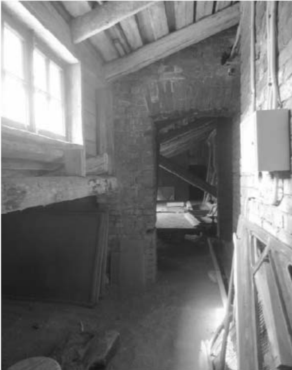
182. «Особняк Безобразовой». Санкт-Петербург, Моховая ул., 34, литера А (Моховая ул., 34). Фрагмент чердачного помещения. Фото: 21.09.2022.
