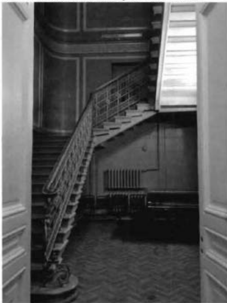
19. Лестница в северо-западной части здания.
