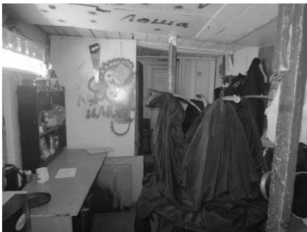
126. «Особняк Безобразовой». Санкт-Петербург, Моховая ул., 34, литера А (Моховая ул., 34). Лицевой корпус. 3-й этаж. Фрагмент помещения 21-Н(5). Фото: 21.09.2022.
