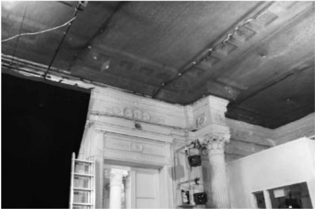
72. «Особняк Безобразовой». Санкт-Петербург, Моховая ул., 34, литера А (Моховая ул., 34). Лицевой корпус. 2-й этаж. Фрагмент помещения 19-Н(3). Фото: 21.09.2022.
