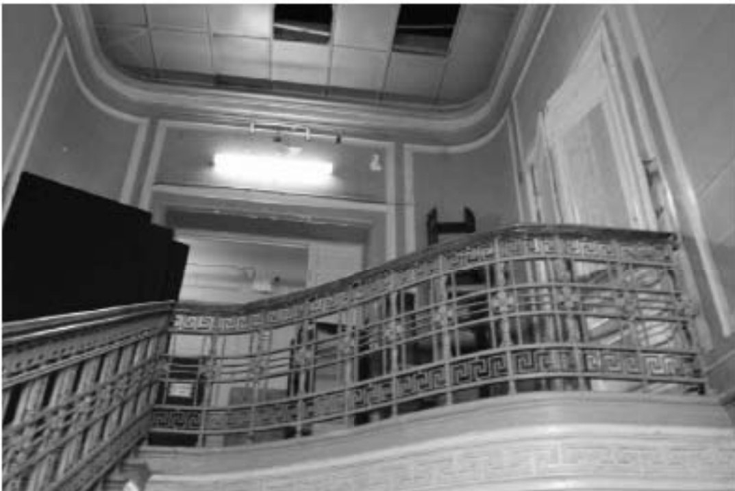
б. «Особняк Безобразовой». Санкт-Петербург, Моховая ул., 34, литера А (Моховая ул., 34). Лицевой корпус. Северная трехмаршевая лестница. Фото: 21.09.2022.
