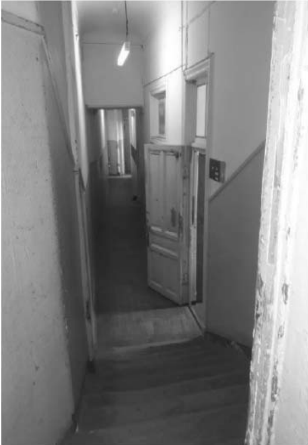
152. «Особняк Безобразовой». Санкт-Петербург, Моховая ул., 34, литера А (Моховая ул., 34). Дворовый корпус. 3-й этаж. Фрагмент помещения 21-Н(21). Фото: 21.09.2022.
