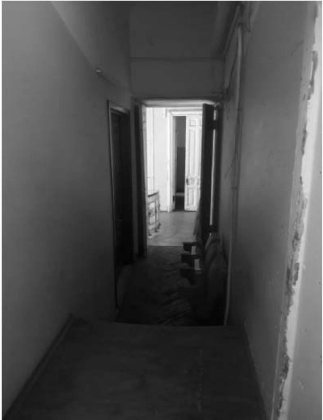
151. «Особняк Безобразовой». Санкт-Петербург, Моховая ул., 34, литера А (Моховая ул., 34). Дворовый корпус. 3-й этаж. Фрагмент помещения 21-Н(25,27). Фото: 21.09.2022.
