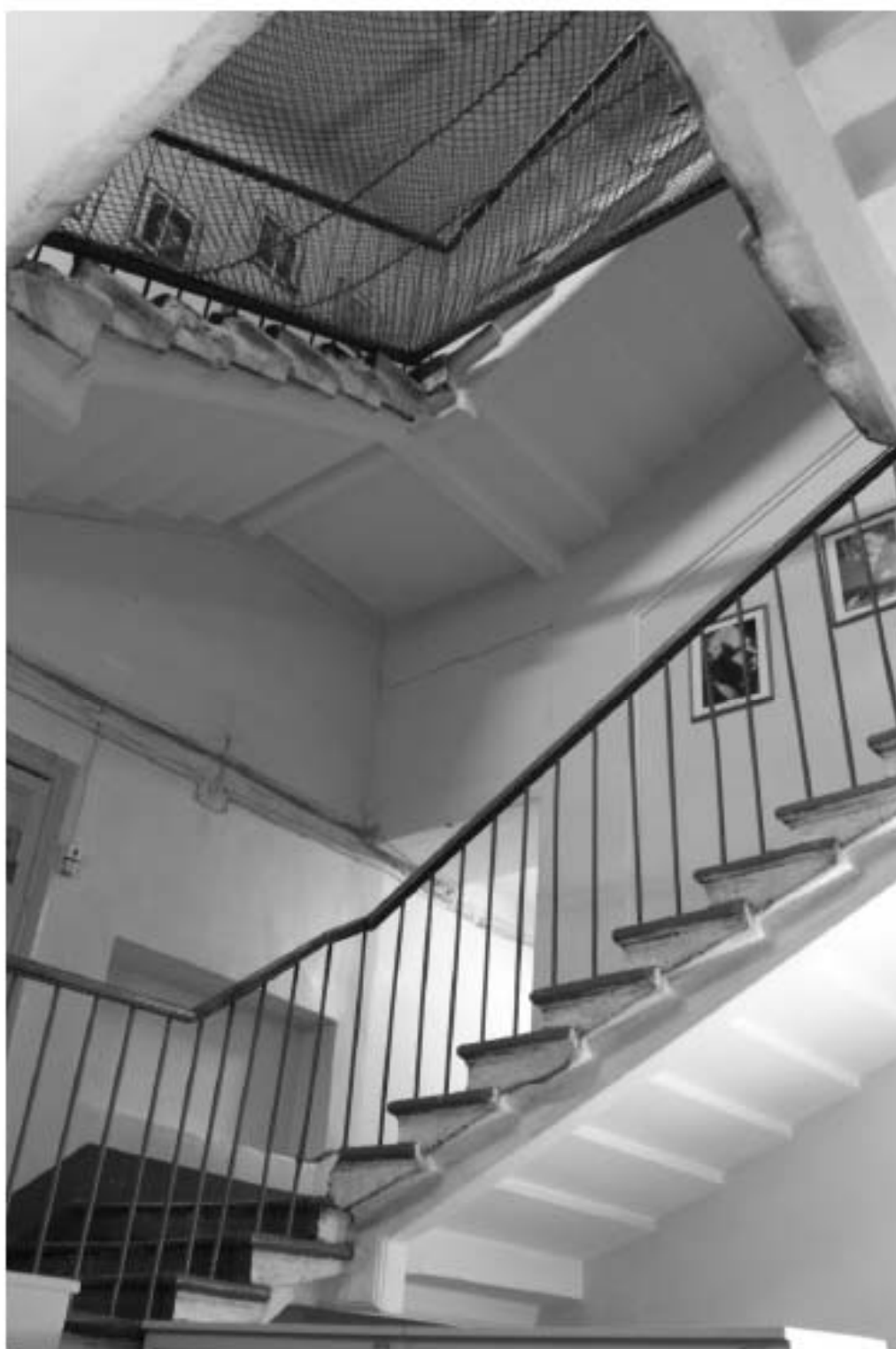
23. «Особняк Безобразовой». Санкт-Петербург, Моховая ул., 34, литера А (Моховая ул., 34). Дворовой корпус. Лестница 2 ЛК. Фото: 21.09.2022.
