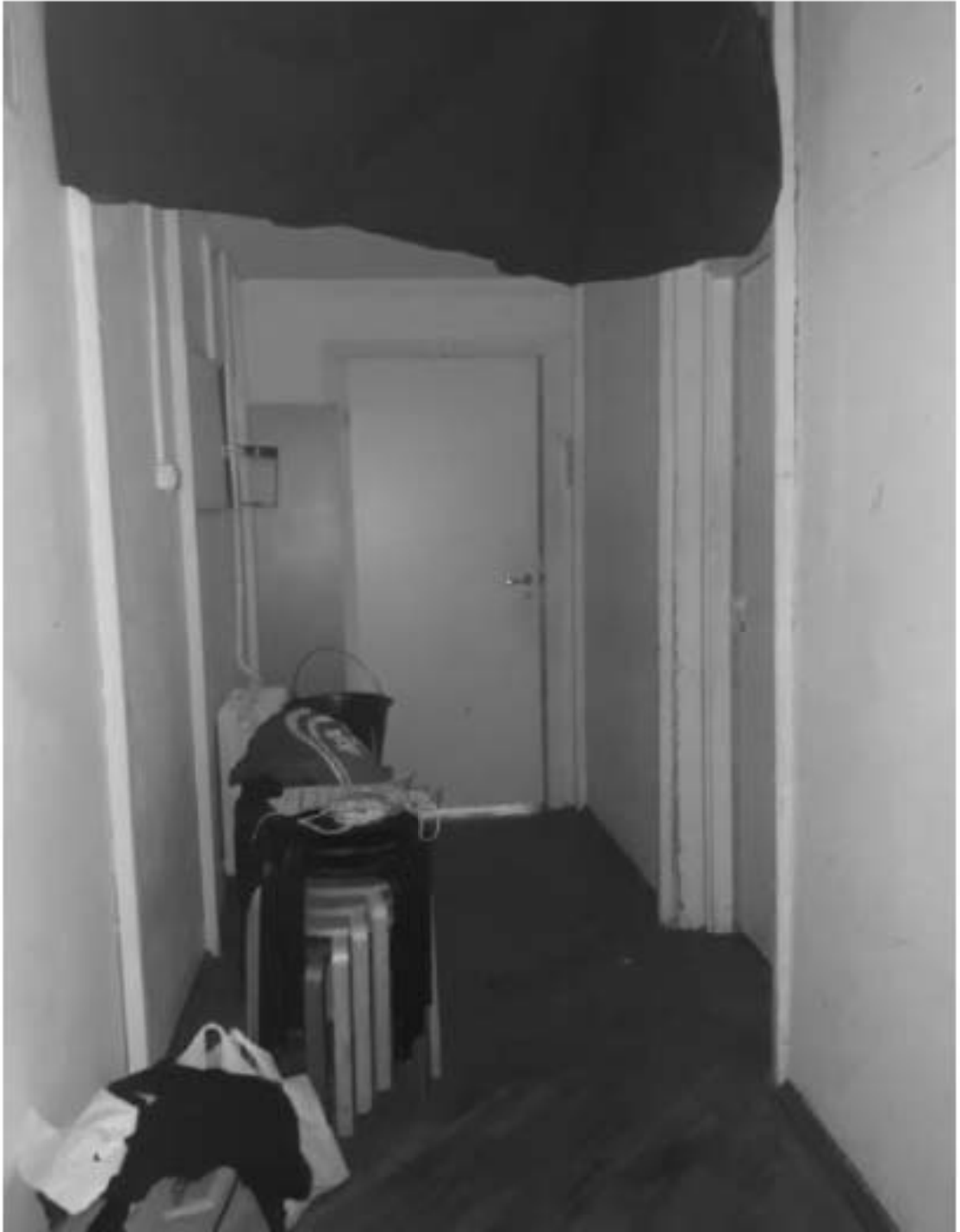
156. «Особняк Безобразовой». Санкт-Петербург, Моховая ул., 34, литера А (Моховая ул., 34). Дворовый корпус. 4-й этаж. Фрагмент помещения 22-Н(2). Фото: 21.09.2022.
