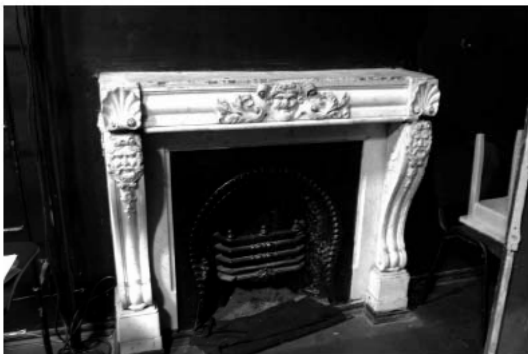
124. «Особняк Безобразовой». Санкт-Петербург, Моховая ул., 34, литера А (Моховая ул., 34). Лицевой корпус. 3-й этаж. Фрагмент помещения 21-Н(1). Фото: 21.09.2022.
