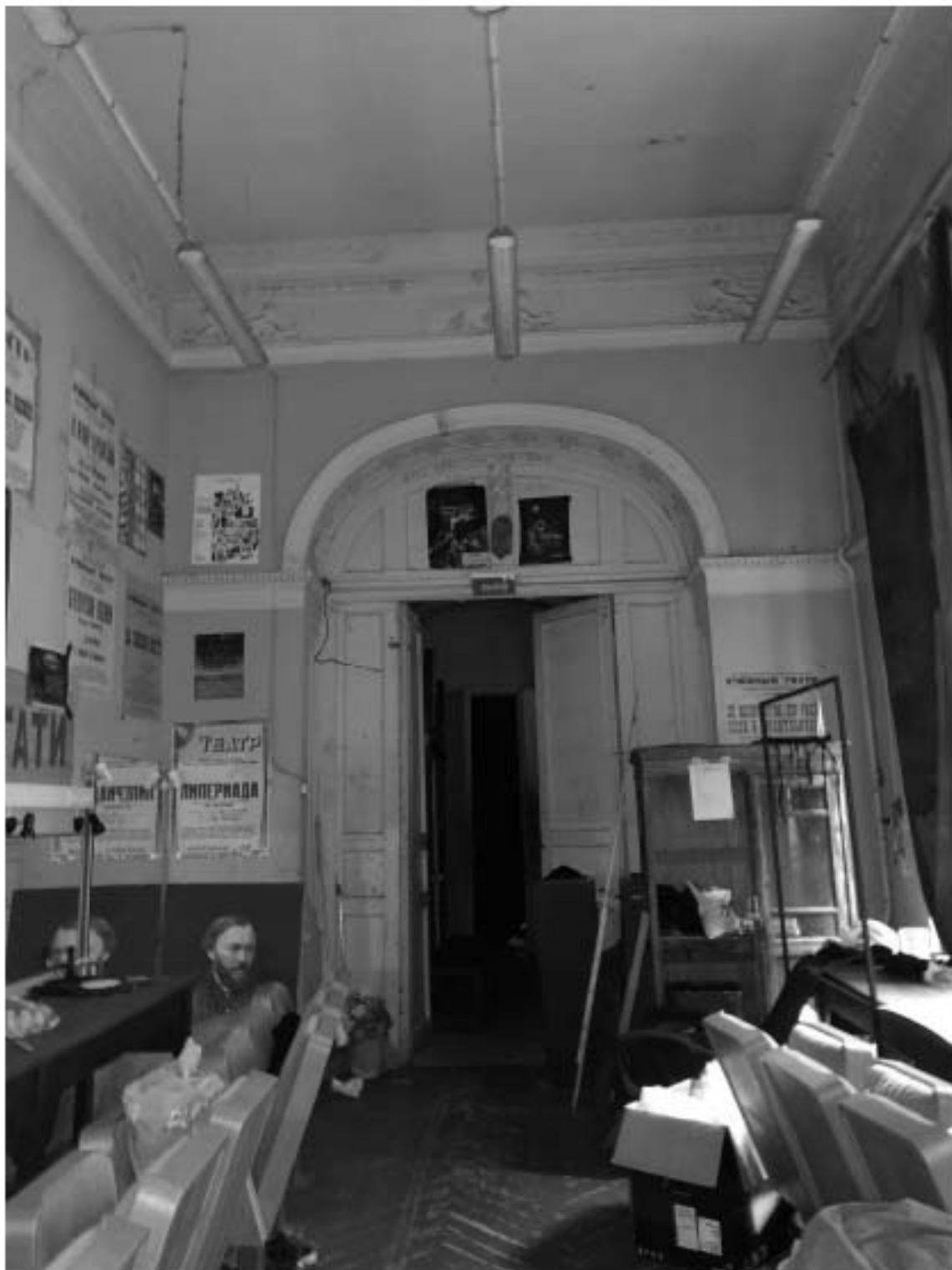
88. «Особняк Безобразовой». Санкт-Петербург, Моховая ул., 34, литера А (Моховая ул., 34). Лицевой корпус. 2-й этаж. Фрагмент помещения 19-Н(17). Фото: 21.09.2022.
