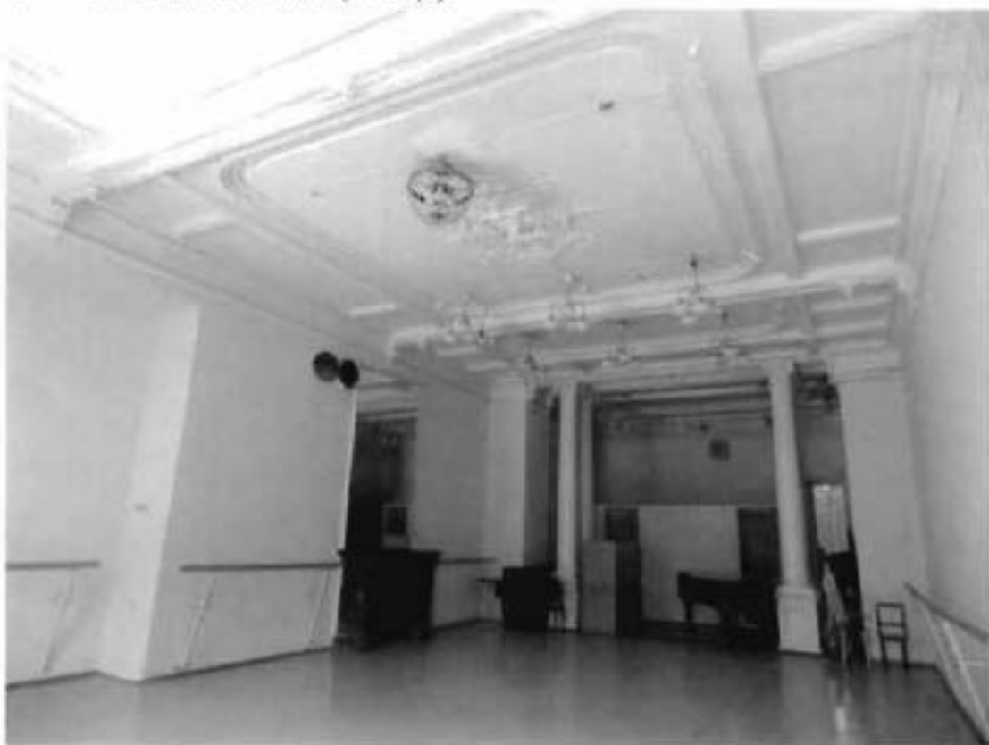
7. Помещение 1 этажа (10-Н(2)).
