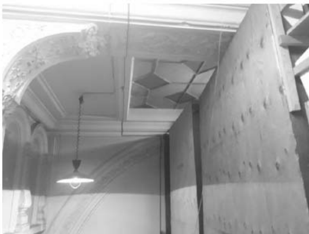
79. «Особняк Безобразовой». Санкт-Петербург, Моховая ул., 34, литера А (Моховая ул., 34). Лицевой корпус. 2-й этаж (антресоль). Фрагмент помещения 19-Н(2). Фото: 21.09.2022.
