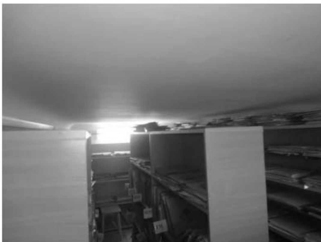
162. «Особняк Безобразовой». Санкт-Петербург, Моховая ул., 34, литера А (Моховая ул., 34). Дворовый корпус. 5-й этаж (антресоль). Фрагмент помещения 26-Н(3). Фото: 21.09.2022.
