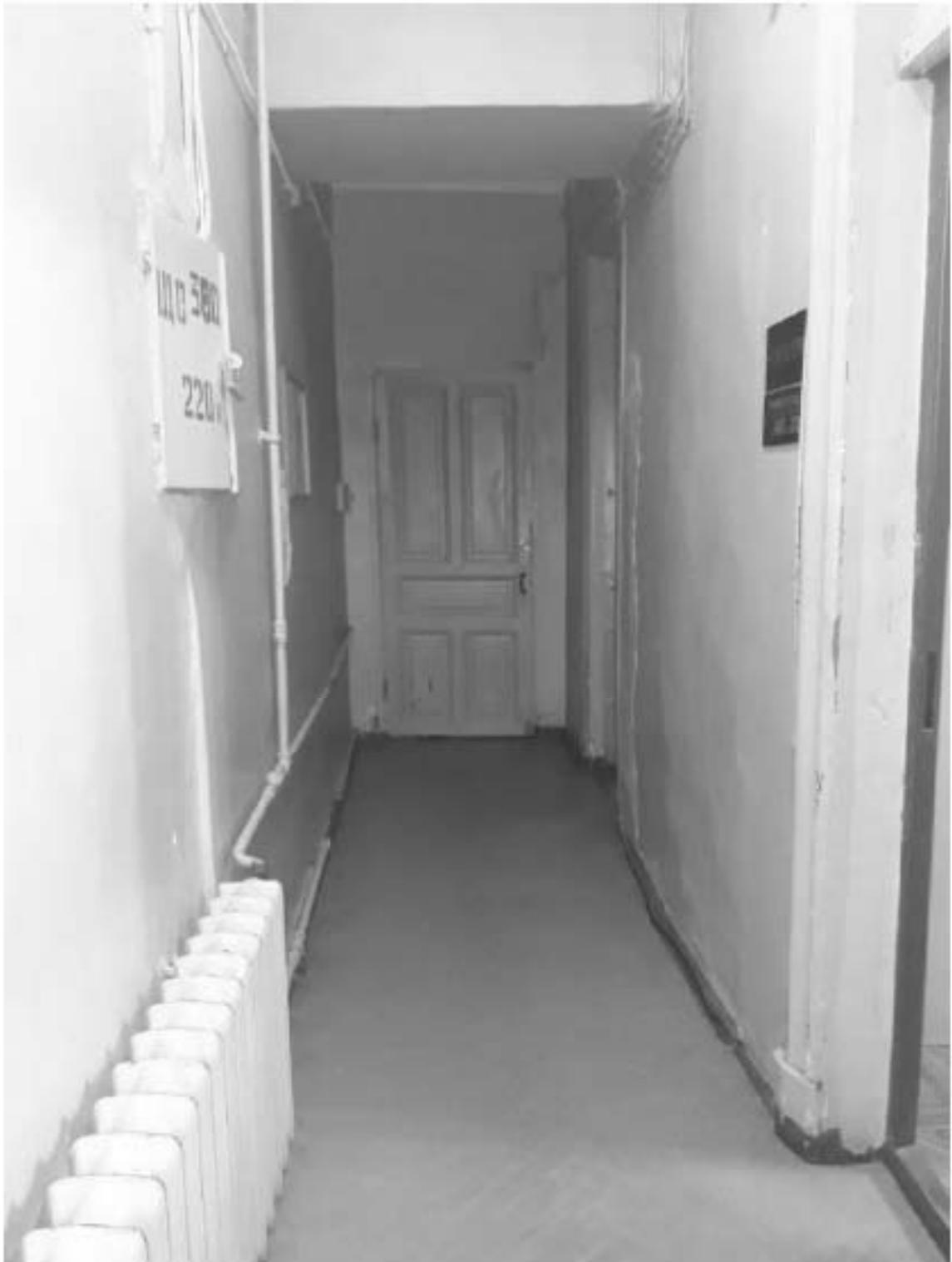
101. «Особняк Безобразовой». Санкт-Петербург, Моховая ул., 34, литера А (Моховая ул., 34). Дворовый корпус. 3-й этаж. Фрагмент помещения 20-Н(1). Фото: 21.09.2022.
