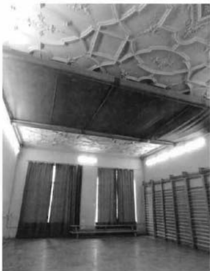
16. Помещение 2 этажа (19-Н (14)).
