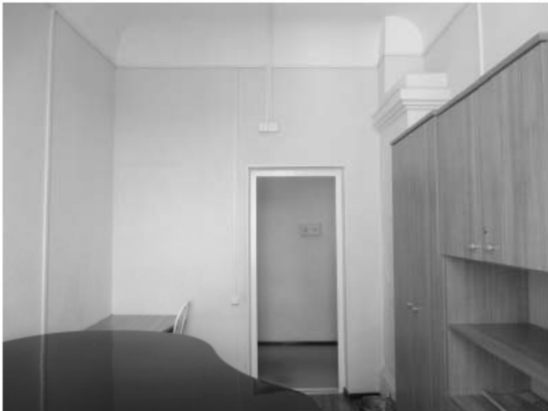
134. «Особняк Безобразовой». Санкт-Петербург, Моховая ул., 34, литера А (Моховая ул., 34). Дворовый корпус. 5-й этаж. Фрагмент помещения 24-Н(4). Фото: 21.09.2022.
