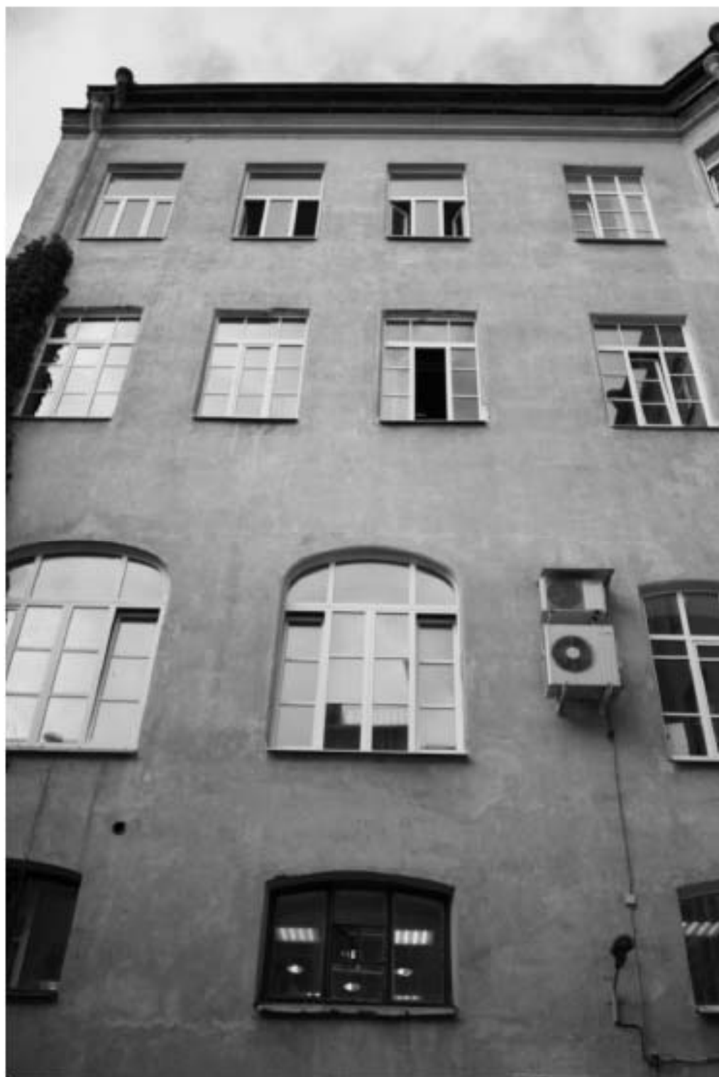
23. «Особняк Безобразовой». Санкт-Петербург, Моховая ул., 34, литера А (Моховая ул., 34). Восточный двор. Фрагмент западного дворового фасада. Фото: 21.09.2022.
