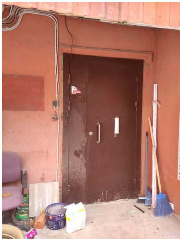
Фото 14. Фрагмент западного фасада выявленного объекта культурного наследия «Жилой дом для служащих», входное дверное заполнение
