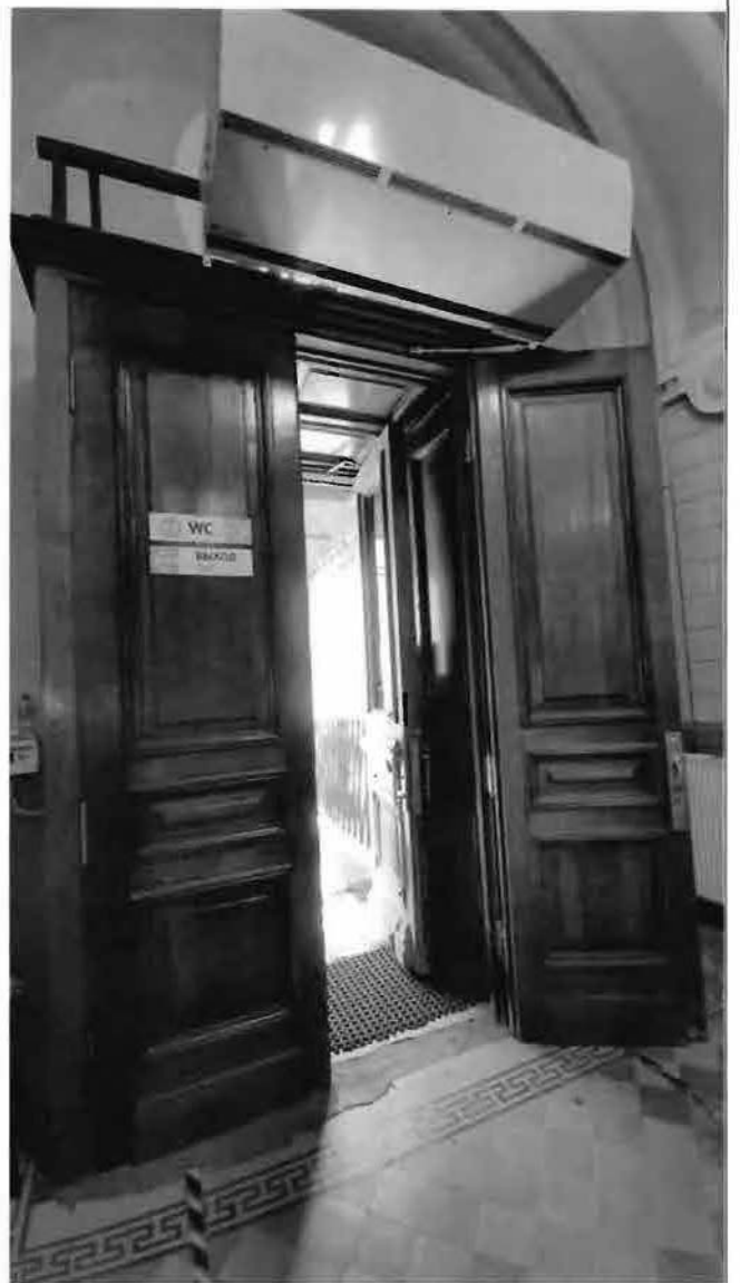
13. Тамбур парадного входа
