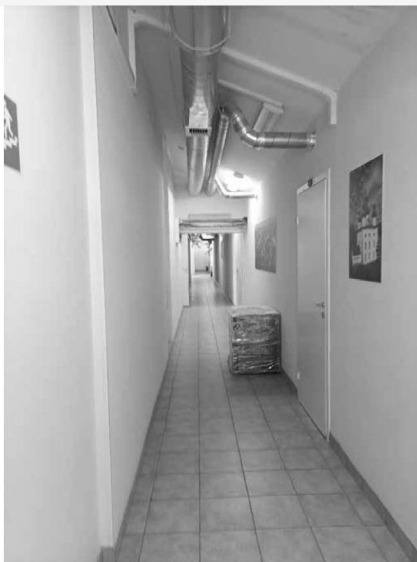
29. Объект культурного наследия федерального значения «Кунсткамера», по адресу: Санкт-Петербург, Университетская набережная, дом № 3, литера Б (Университетская наб., 3). Коридор 4 этажа. Дата съемки: 12.08.2022г.
