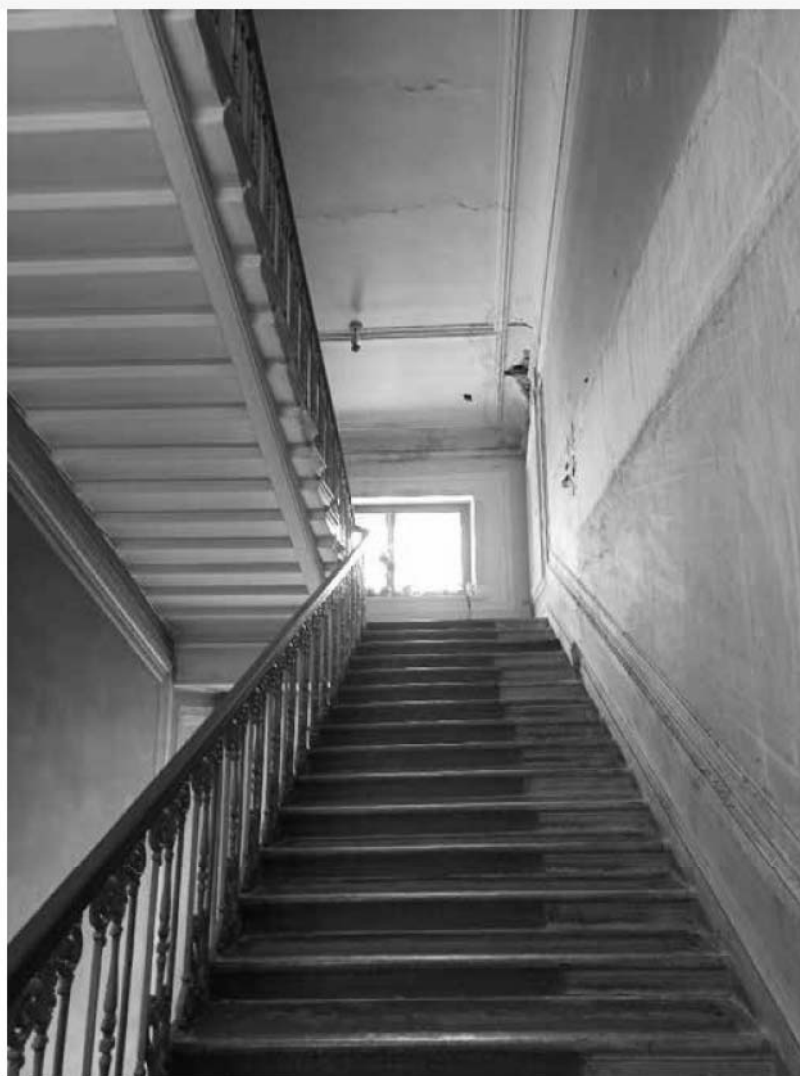
21. Объект культурного наследия федерального значения «Кунсткамера», по адресу: Санкт-Петербург, Университетская набережная, дом № 3, литера Б (Университетская наб., 3). Лестница в уровне 3 этажа. Дата съемки: 12.08.2022г.
