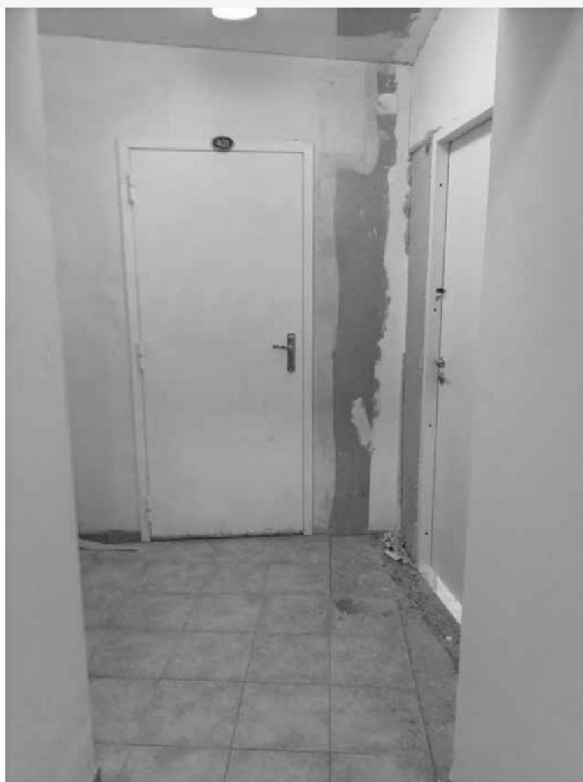
35. Объект культурного наследия федерального значения «Кунсткамера», по адресу: Санкт-Петербург, Университетская набережная, дом № 3, литера Б (Университетская наб., 3). Коридор 4 этажа. Дата съемки: 12.08.2022г.
