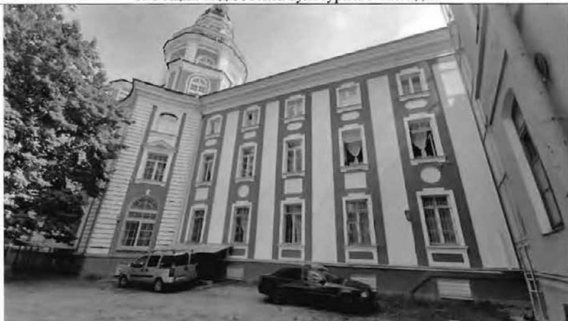
2. Фрагмент дворового фасада корпуса по Университетской набережной
