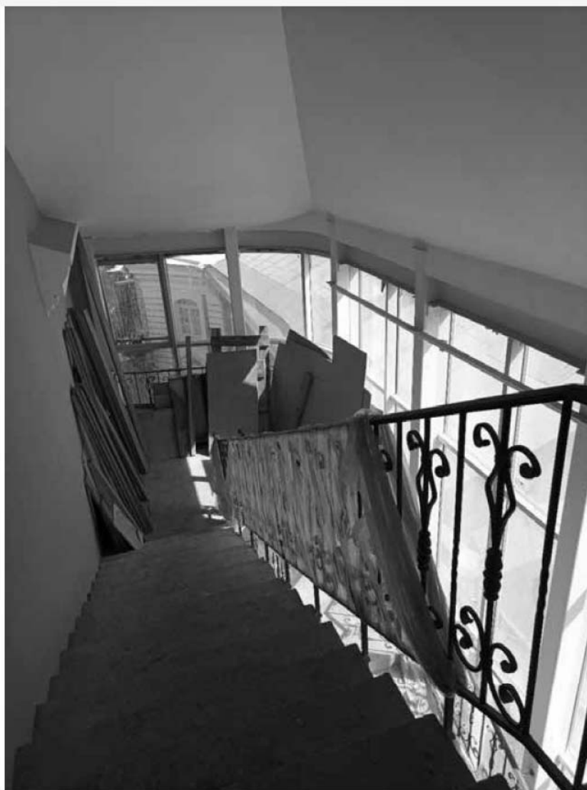
65. Объект культурного наследия федерального значения «Кунсткамера», по адресу: Санкт-Петербург, Университетская набережная, дом № 3, литера Б (Университетская наб., 3). Лестница. Дата съемки: 12.08.2022г.
