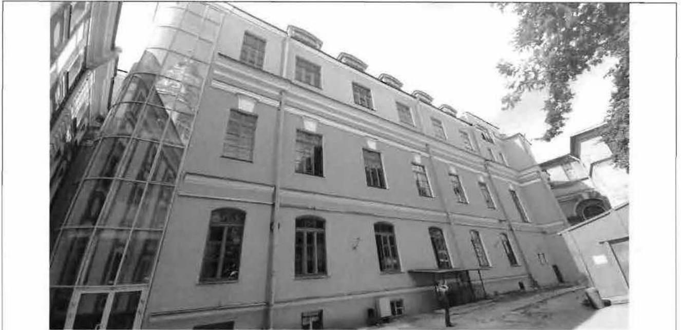
3. Дворовый фасад корпуса по Таможенному переулку
