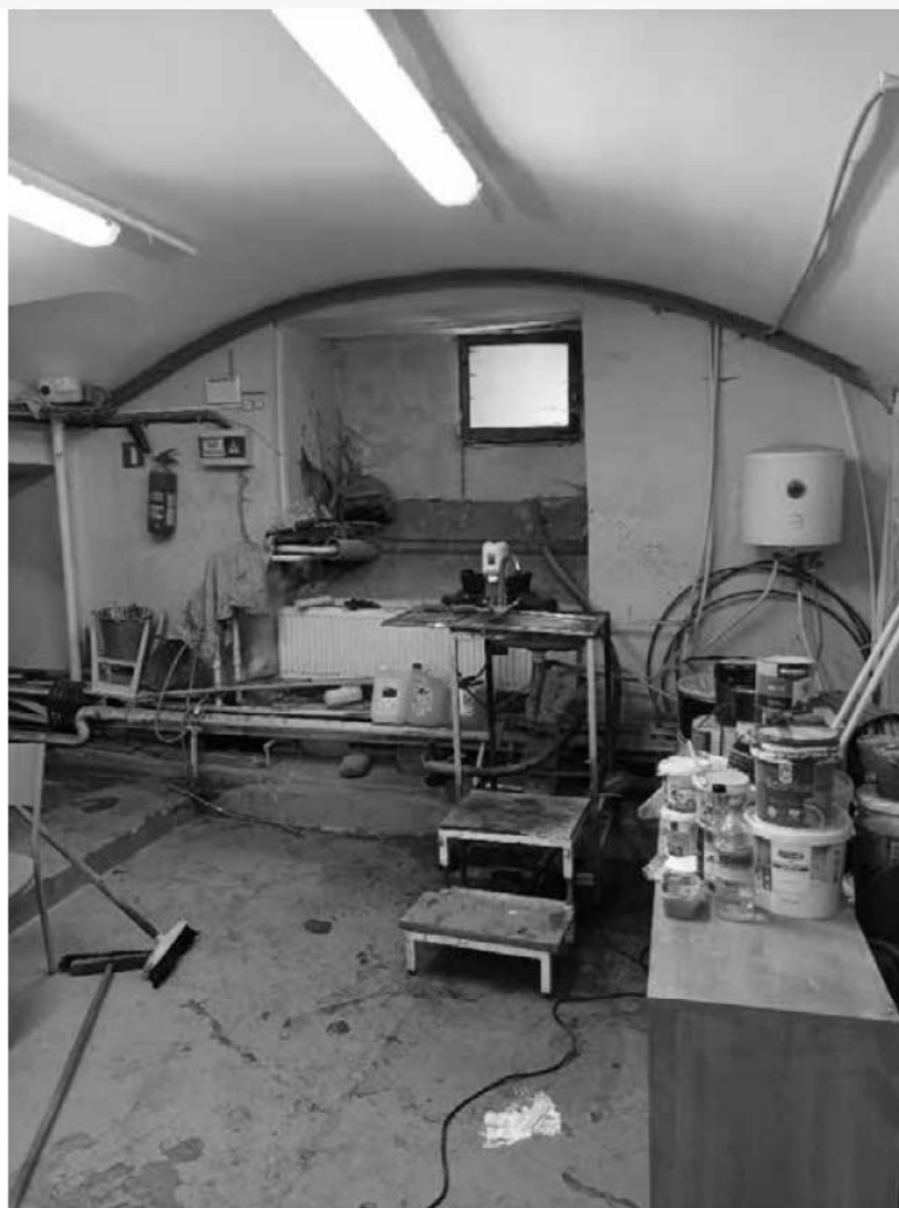
5. Объект культурного наследия федерального значения «Кунсткамера», по адресу: Санкт-Петербург, Университетская набережная, дом № 3, литера Б (Университетская наб., 3). Подвал. Дата съемки: 12.08.2022г.
