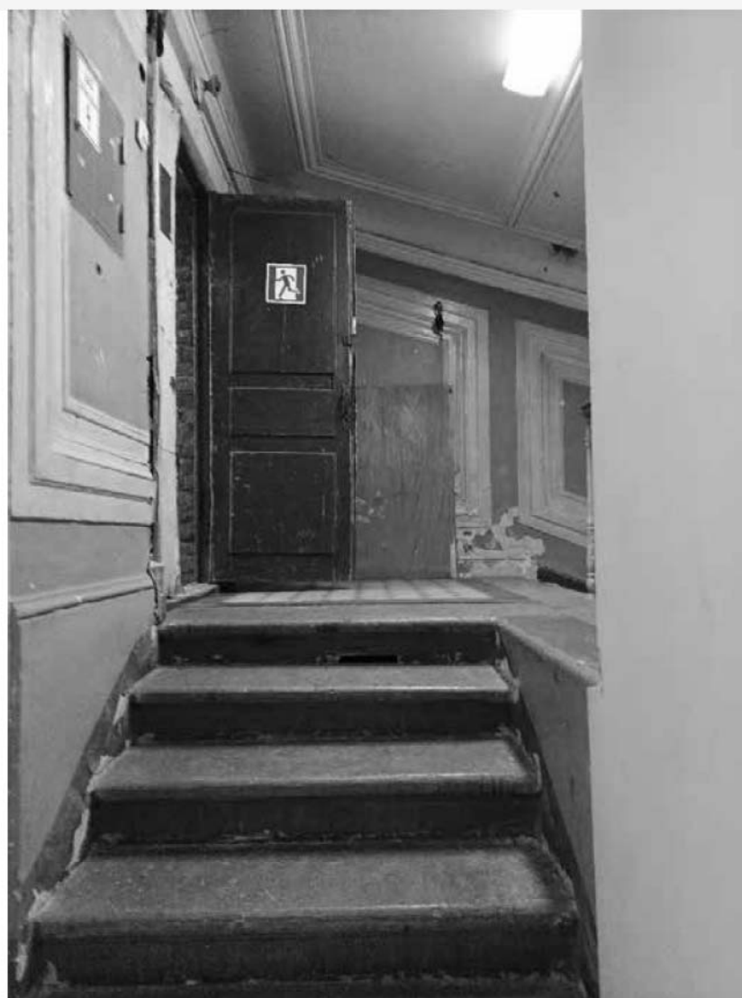
28. Объект культурного наследия федерального значения «Кунсткамера», по адресу: Санкт-Петербург, Университетская набережная, дом № 3, литера Б (Университетская наб., 3). Лестница в уровне 4 этажа. Дата съемки: 12.08.2022г.
