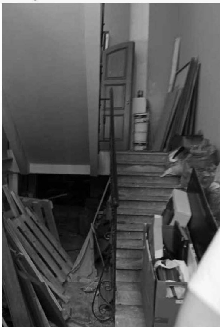
62. Объект культурного наследия федерального значения «Кунсткамера», по адресу: Санкт-Петербург, Университетская набережная, дом № 3, литера Б (Университетская наб., 3). Лестница. Дата съемки: 12.08.2022г.
