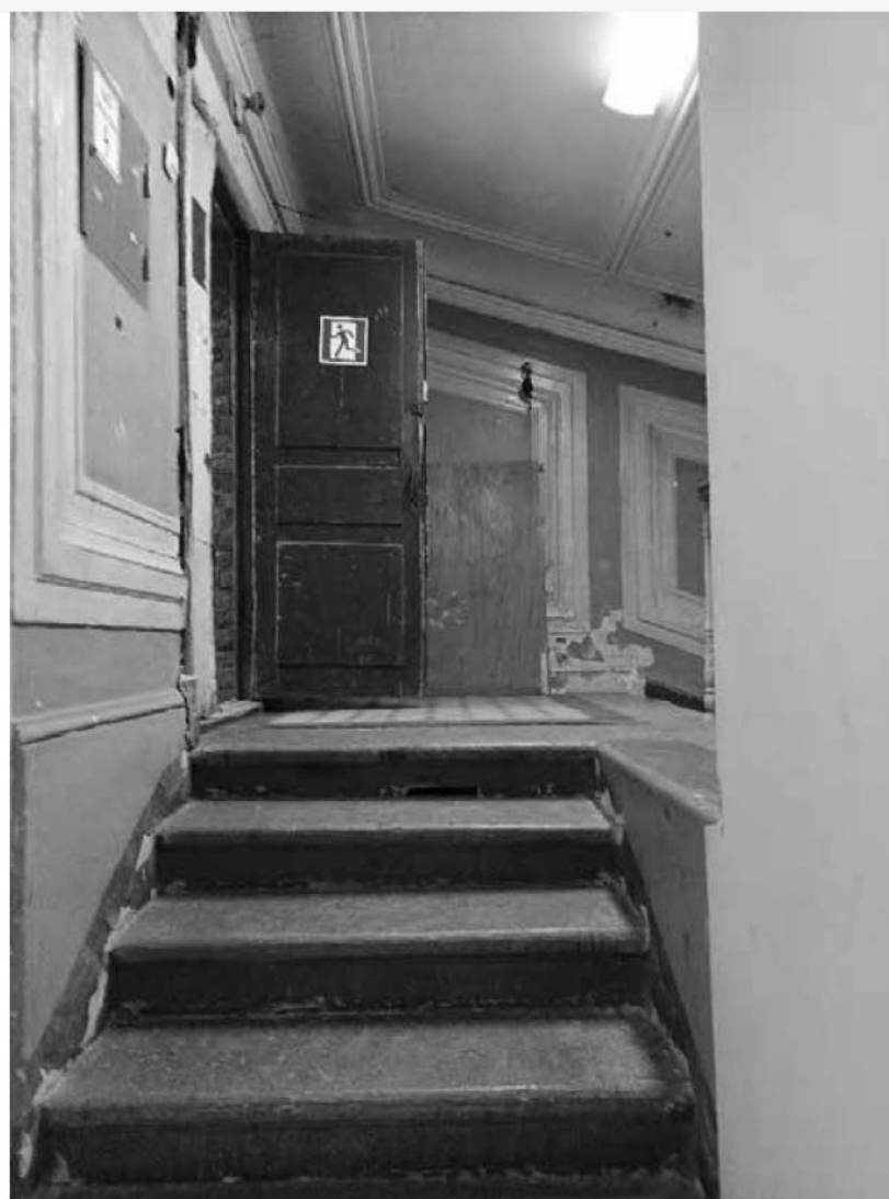
25. Объект культурного наследия федерального значения «Кунсткамера», по адресу: Санкт-Петербург, Университетская набережная, дом № 3, литера Б (Университетская наб., 3). Лестница в уровне 4 этажа. Дата съемки: 12.08.2022г.
