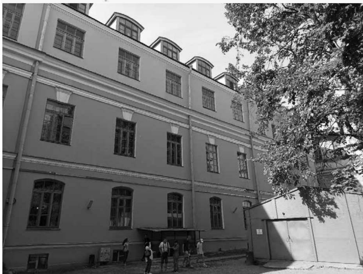
60. Объект культурного наследия федерального значения «Кунсткамера», по адресу: Санкт-Петербург, Университетская набережная, дом № 3, литера Б (Университетская наб., 3). Северо-восточный дворовый фасад. Дата съемки: 12.08.2022г.
