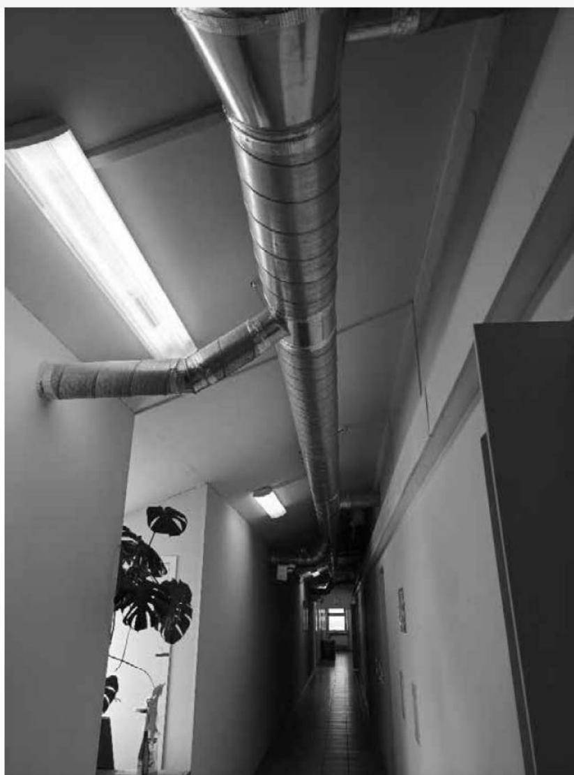
36. Объект культурного наследия федерального значения «Кунсткамера», по адресу: Санкт-Петербург, Университетская набережная, дом № 3, литера Б (Университетская наб., 3). Коридор 4 этажа. Дата съемки: 12.08.2022г.
