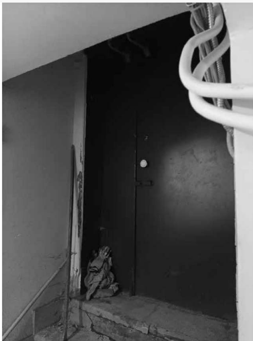
7. Объект культурного наследия федерального значения «Кунсткамера», по адресу: Санкт-Петербург, Университетская набережная, дом № 3, литера Б (Университетская наб., 3). Подвал. Дата съемки: 12.08.2022г.
