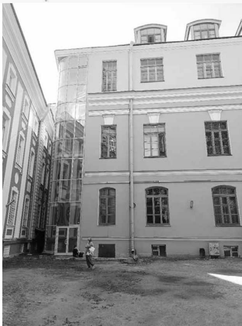
61. Объект культурного наследия федерального значения «Кунсткамера», по адресу: Санкт-Петербург, Университетская набережная, дом № 3, литера Б (Университетская наб., 3). Северо-восточный дворовый фасад. Дата съемки: 12.08.2022г.
