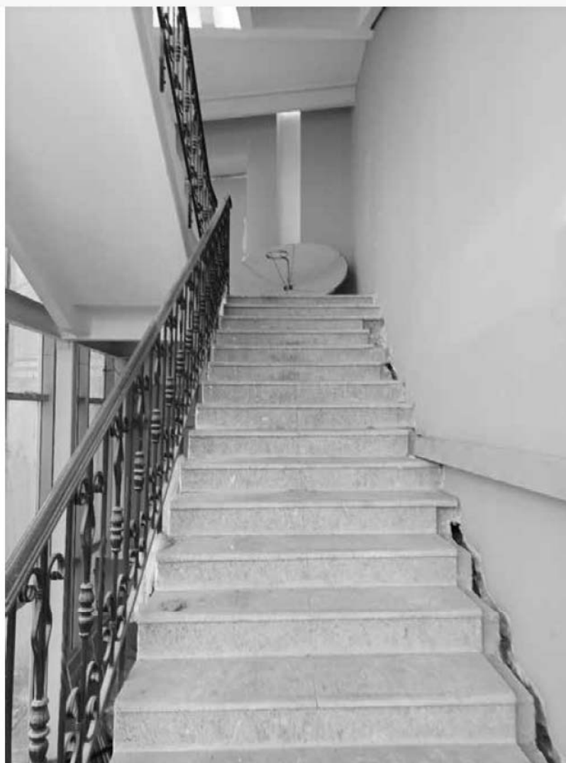
63. Объект культурного наследия федерального значения «Кунсткамера», по адресу: Санкт-Петербург, Университетская набережная, дом № 3, литера Б (Университетская наб., 3). Лестница. Дата съемки: 12.08.2022г.
