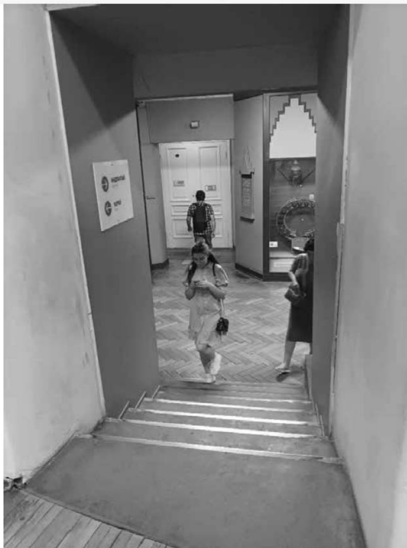
49. Объект культурного наследия федерального значения «Кунсткамера», по адресу: Санкт-Петербург, Университетская набережная, дом № 3, литера Б (Университетская наб., 3). Лестница. Дата съемки: 12.08.2022г.
