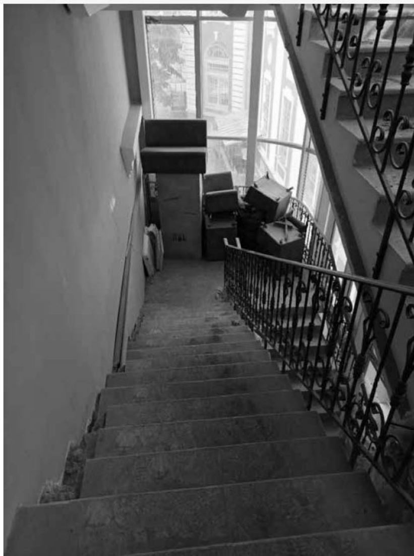
64. Объект культурного наследия федерального значения «Кунсткамера», по адресу: Санкт-Петербург, Университетская набережная, дом № 3, литера Б (Университетская наб., 3). Лестница. Дата съемки: 12.08.2022г.
