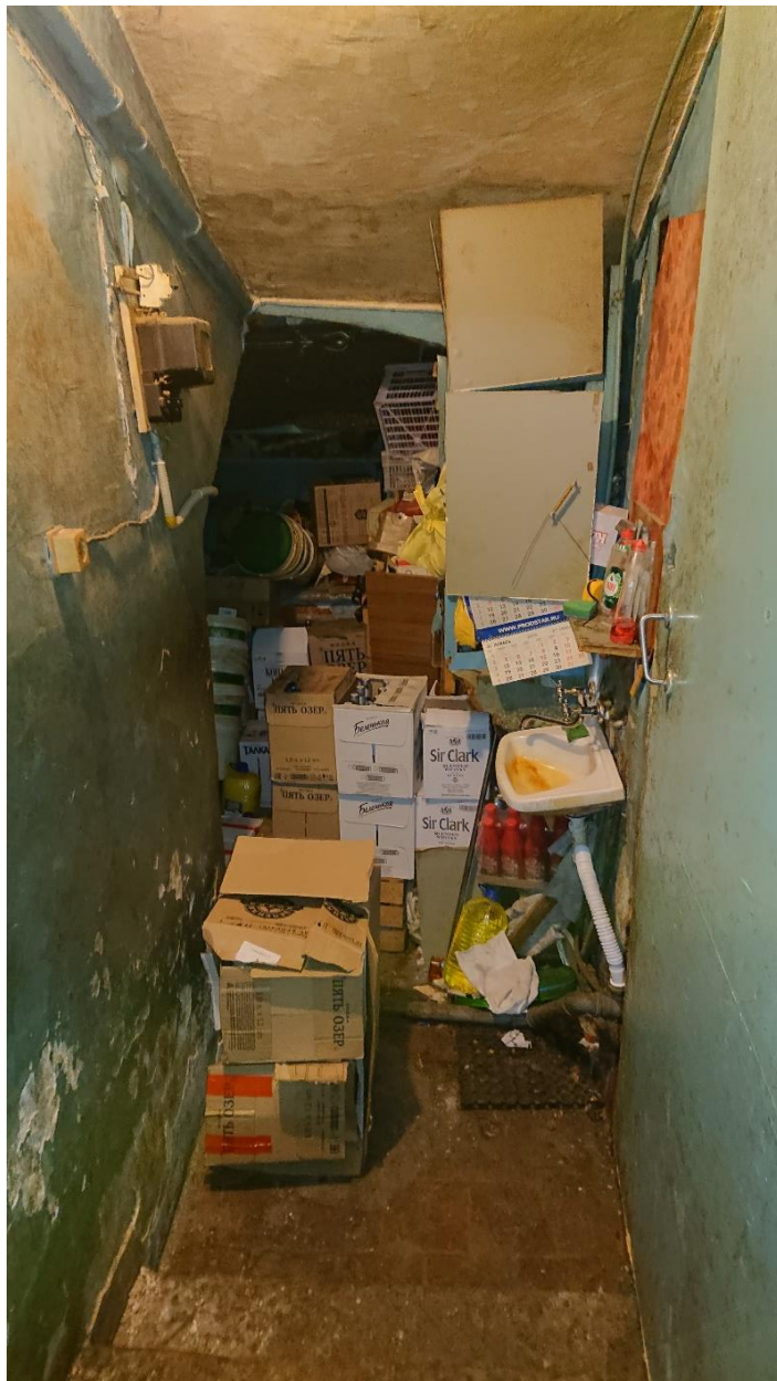
7. Объекта культурного наследия регионального значения «Дом А.И. Кракау» по адресу: Санкт-Петербург, 8-я линия В.О., д. 43, лит. А, Б. Дворовый фасад. Помещение 1-Н. Фрагмент интерьера.
