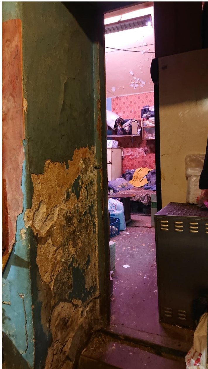
9. Объекта культурного наследия регионального значения «Дом А.И. Кракау» по адресу: Санкт-Петербург, 8-я линия В.О., д. 43, лит. А, Б. Дворовый фасад. Помещение 1-Н. Фрагмент интерьера.
