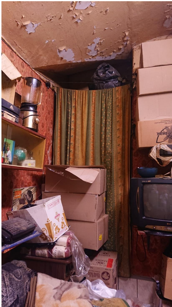
12. Объекта культурного наследия регионального значения «Дом А.И. Кракау» по адресу: Санкт-Петербург, 8-я линия В.О., д. 43, лит. А, Б. Дворовый фасад. Помещение 1-Н. Фрагмент интерьера.
