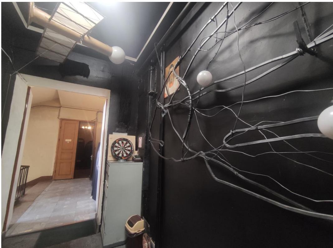
13. Выявленный объект культурного наследия «Здание Центрального управления Главного общества Российских железных дорог», расположенный по адресу: г. Санкт-Петербург, Итальянская улица, дом 17, литера А. Фрагмент пом. № 47-Н(48), 2-й этаж.
