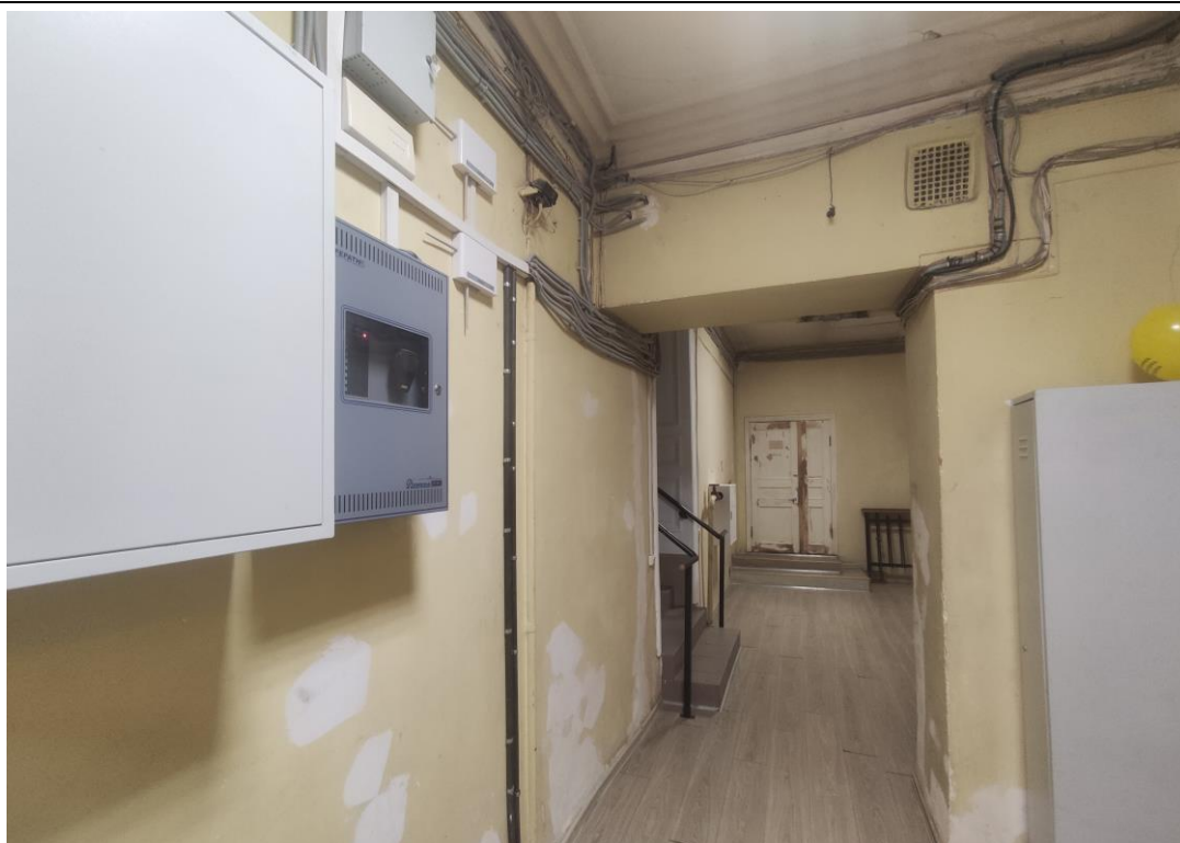
15. Выявленный объект культурного наследия «Здание Центрального управления Главного общества Российских железных дорог», расположенный по адресу: г. Санкт-Петербург, Итальянская улица, дом 17, литера А. Фрагмент пом. № 52-Н(1), 3-й этаж.
