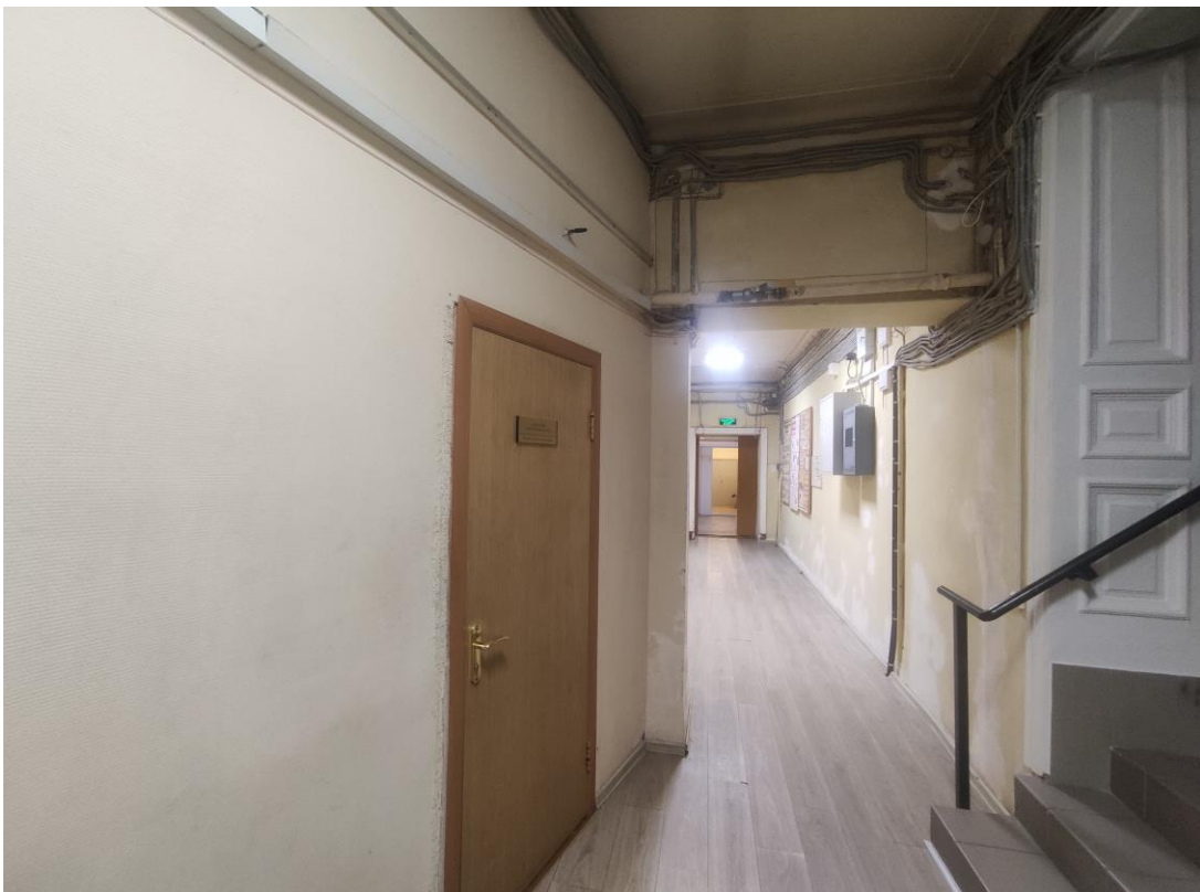
14. Выявленный объект культурного наследия «Здание Центрального управления Главного общества Российских железных дорог», расположенный по адресу: г. Санкт-Петербург, Итальянская улица, дом 17, литера А. Фрагмент пом. № 52-Н(6), 3-й этаж.
