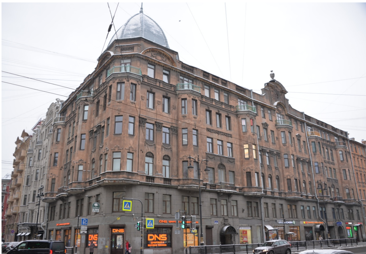
1. Общий вид выявленного объекта культурного наследия «Дом А.М. Александрова»
