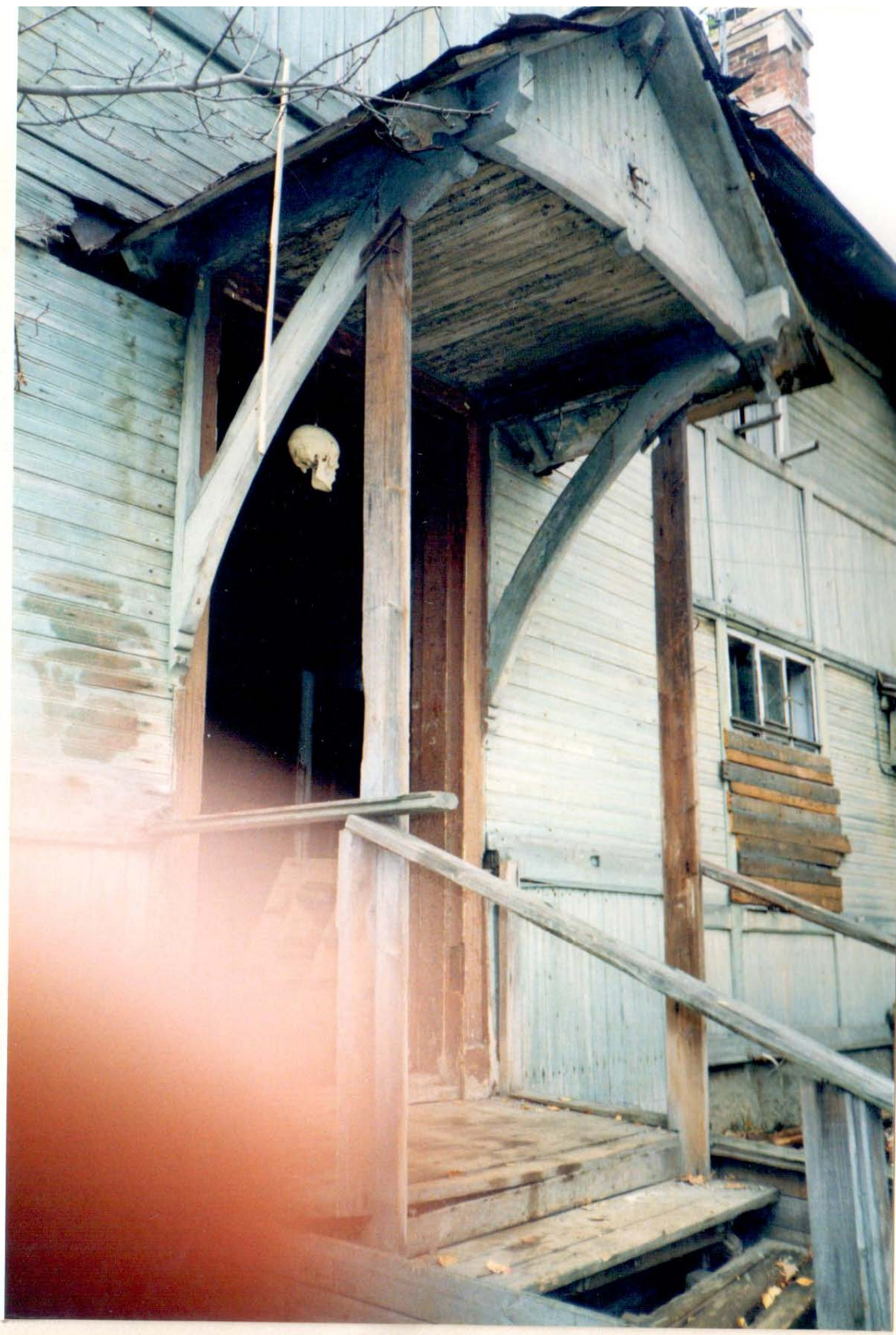
35. Натурные исследования дачи Н.В. Граве по ул. Софийской, 11 в Санкт-Петербурге. СПб., 1999. (архив КГИОП).
