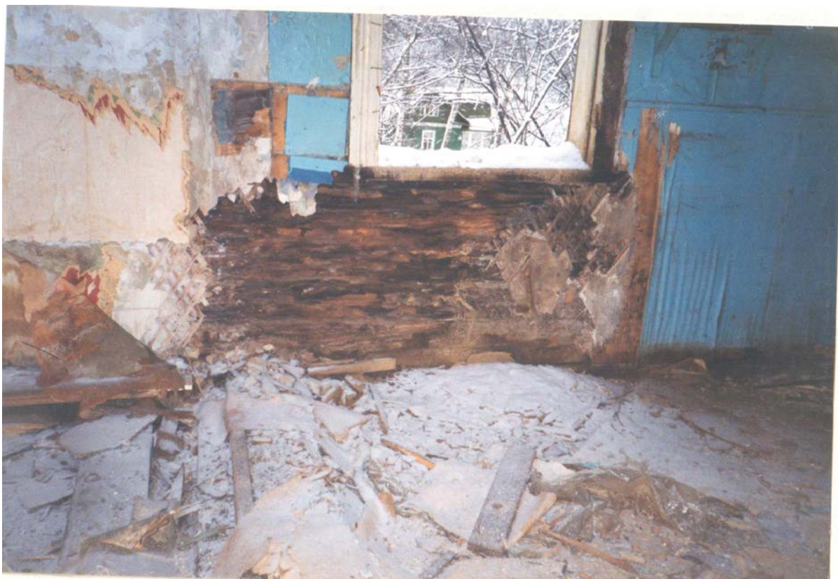
57. Натурные исследования дачи Н.В. Граве по ул. Софийской, 11 в Санкт-Петербурге. СПб., 1999. (архив КГИОП).
