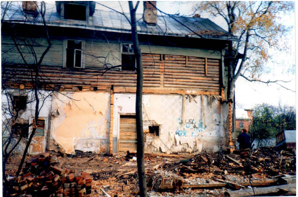
39. Натурные исследования дачи Н.В. Граве по ул. Софийской, 11 в Санкт-Петербурге. СПб., 1999. (архив КГИОП).
