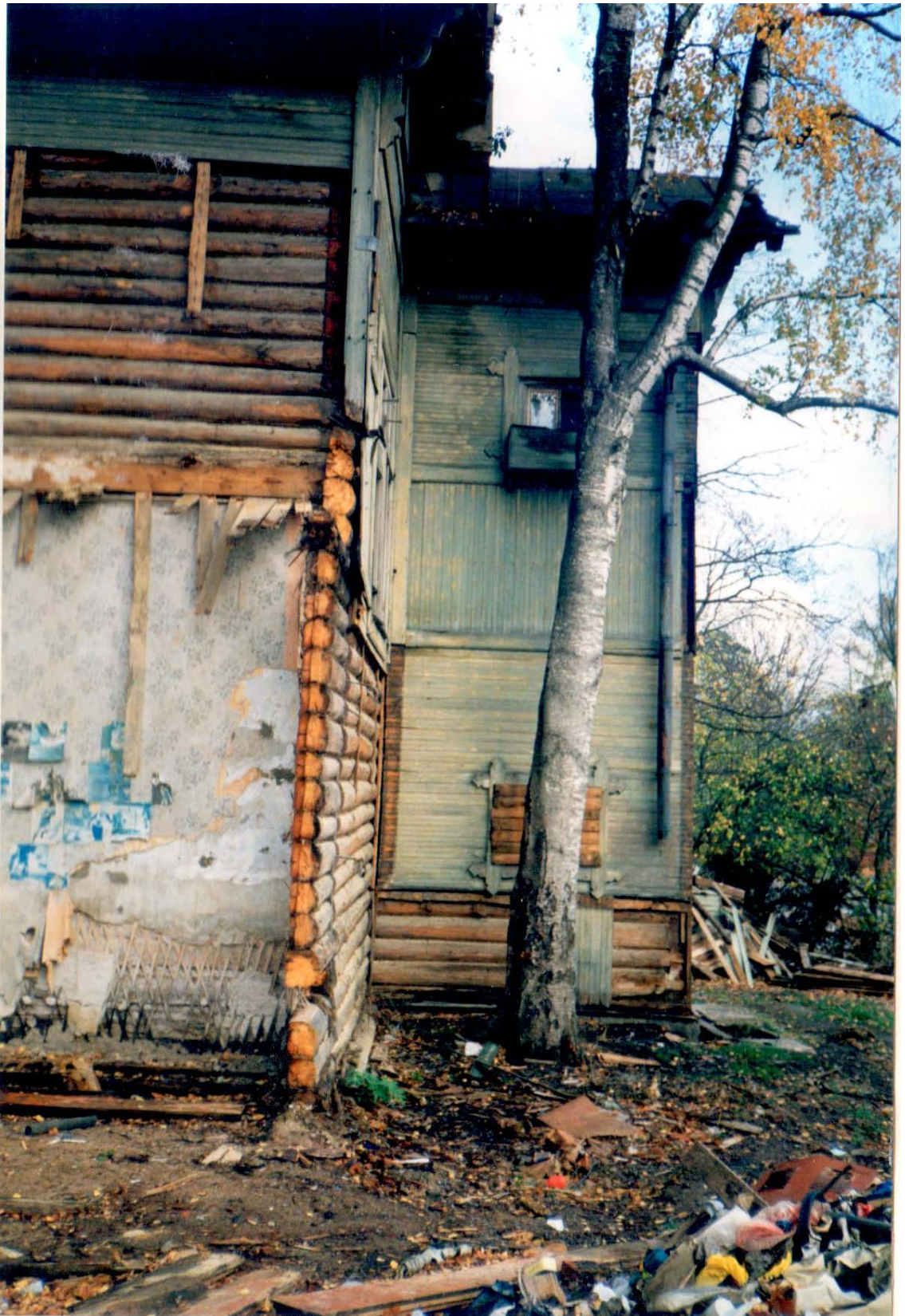
37. Натурные исследования дачи Н.В. Граве по ул. Софийской, 11 в Санкт-Петербурге. СПб., 1999. (архив КГИОП).
