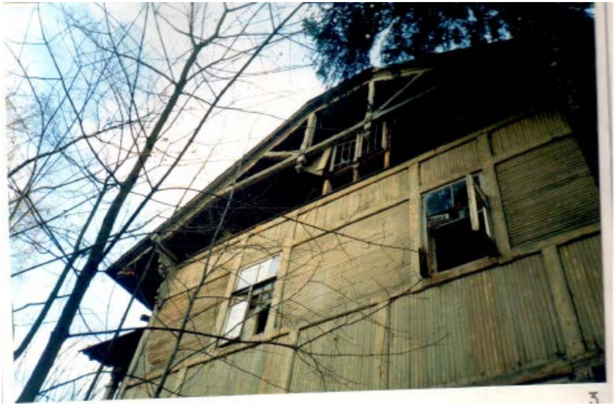
25. Натурные исследования дачи Н.В. Граве по ул. Софийской, 11 в Санкт-Петербурге. СПб., 1999. (архив КГИОП).
