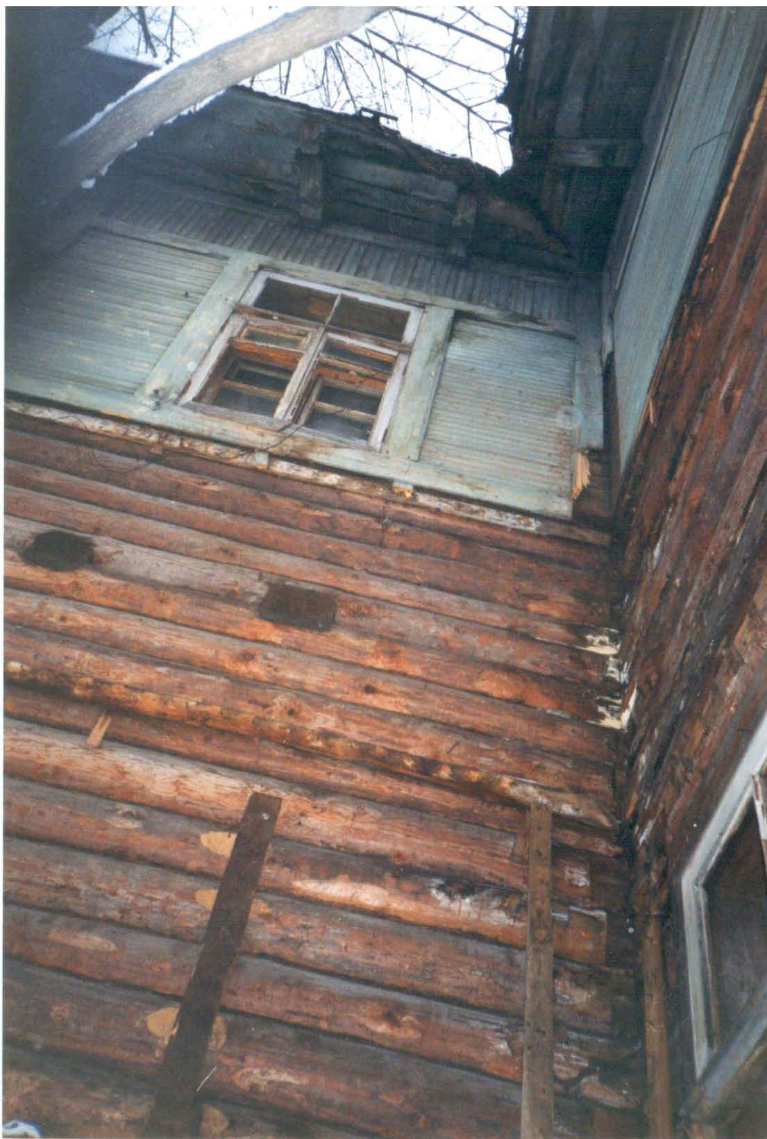
47. Натурные исследования дачи Н.В. Граве по ул. Софийской, 11 в Санкт-Петербурге. СПб., 1999. (архив КГИОП).
