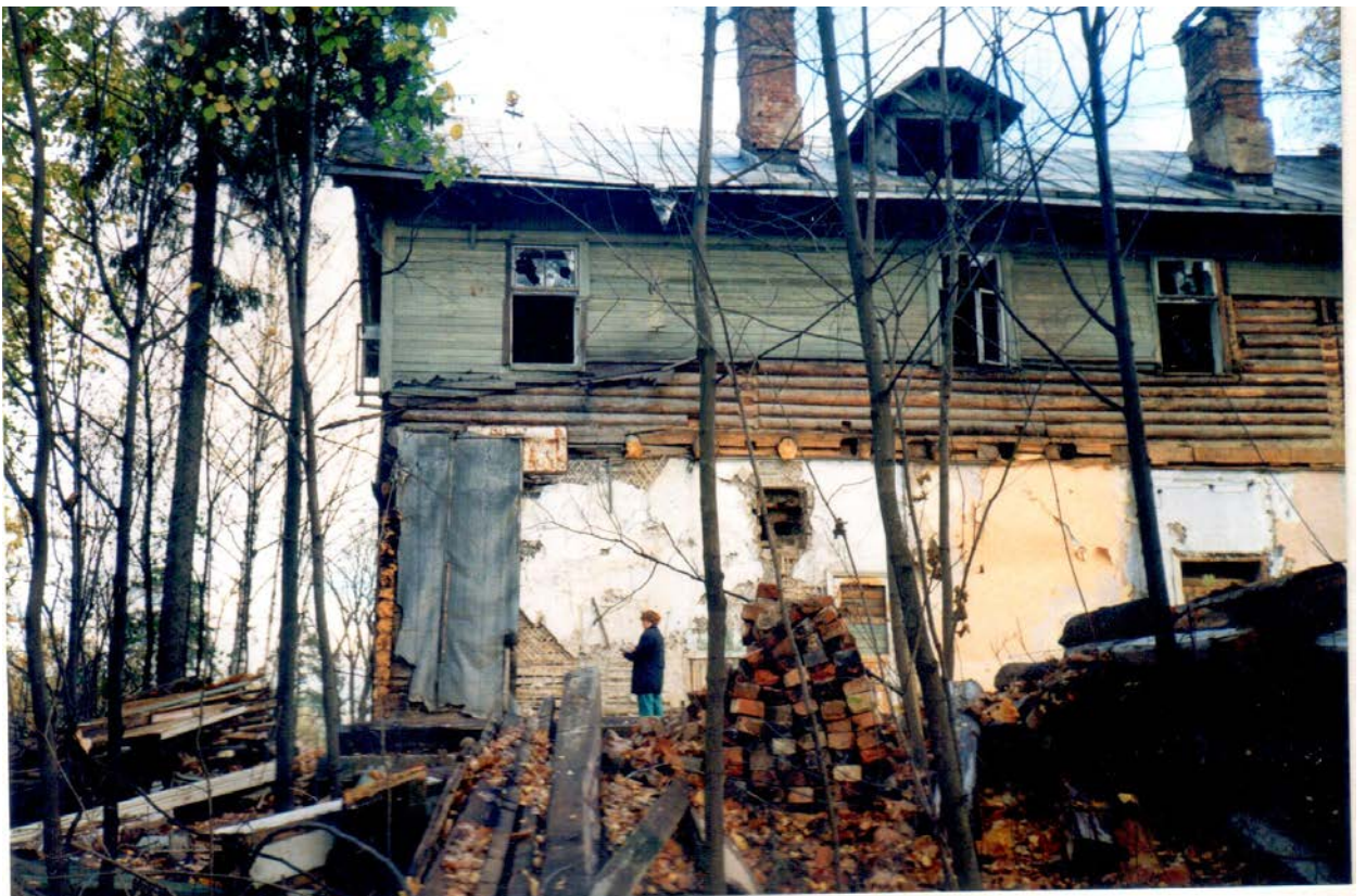
40. Натурные исследования дачи Н.В. Граве по ул. Софийской, 11 в Санкт-Петербурге. СПб., 1999. (архив КГИОП).
