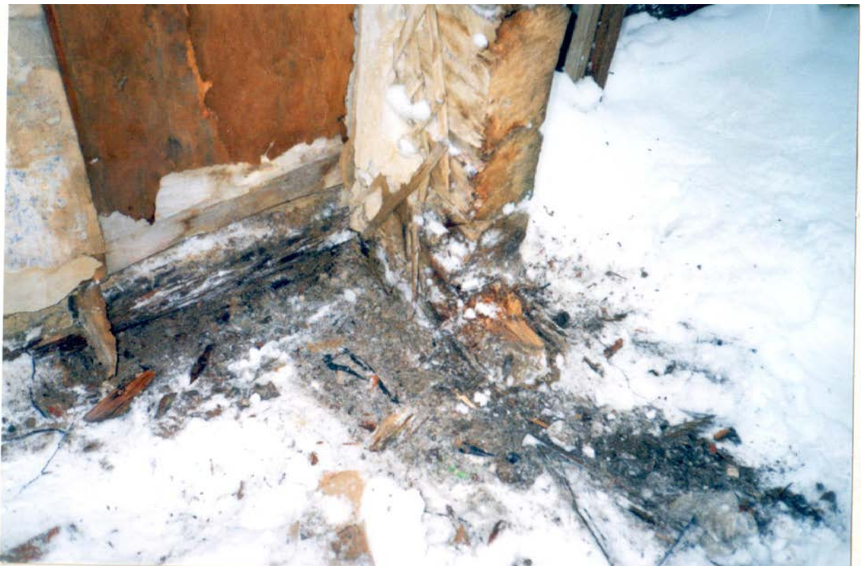
51. Натурные исследования дачи Н.В. Граве по ул. Софийской, 11 в Санкт-Петербурге. СПб., 1999. (архив КГИОП).
