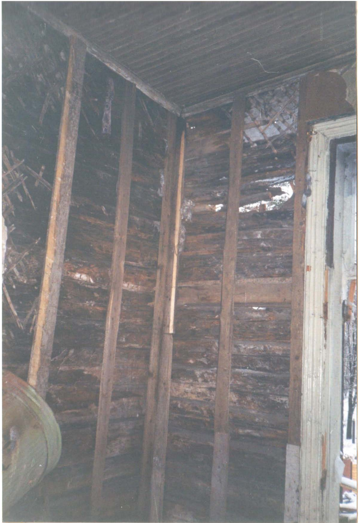
54. Натурные исследования дачи Н.В. Граве по ул. Софийской, 11 в Санкт-Петербурге. СПб., 1999. (архив КГИОП).
