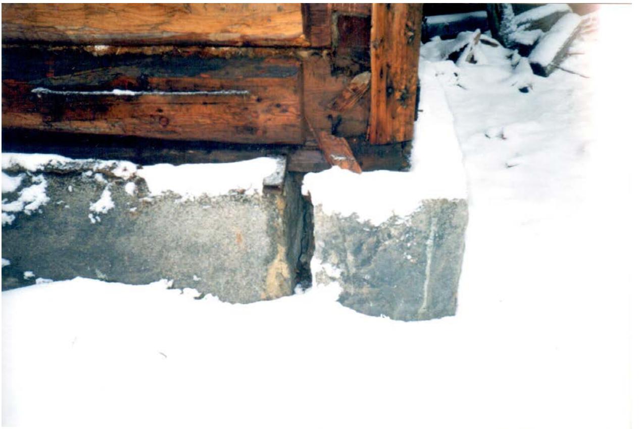
49. Натурные исследования дачи Н.В. Граве по ул. Софийской, 11 в Санкт-Петербурге. СПб., 1999. (архив КГИОП).
