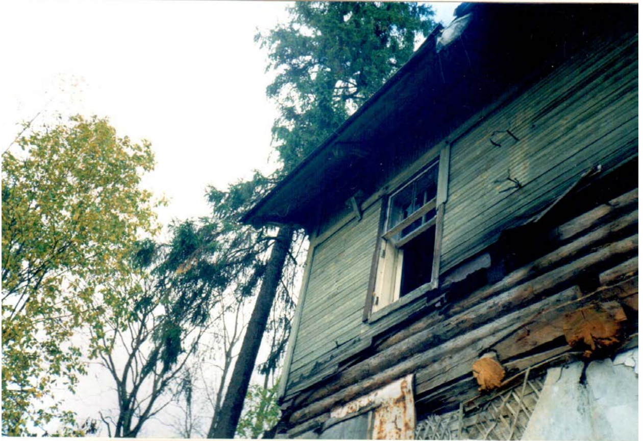
41. Натурные исследования дачи Н.В. Граве по ул. Софийской, 11 в Санкт-Петербурге. СПб., 1999. (архив КГИОП).
