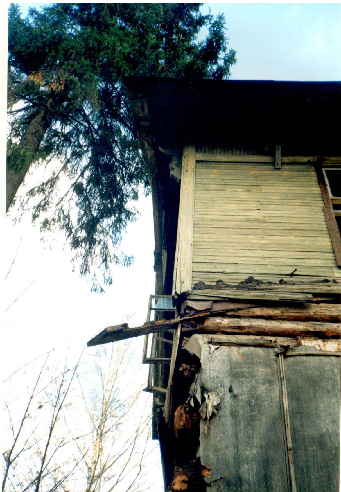
43. Натурные исследования дачи Н.В. Граве по ул. Софийской, 11 в Санкт-Петербурге. СПб., 1999. (архив КГИОП).
