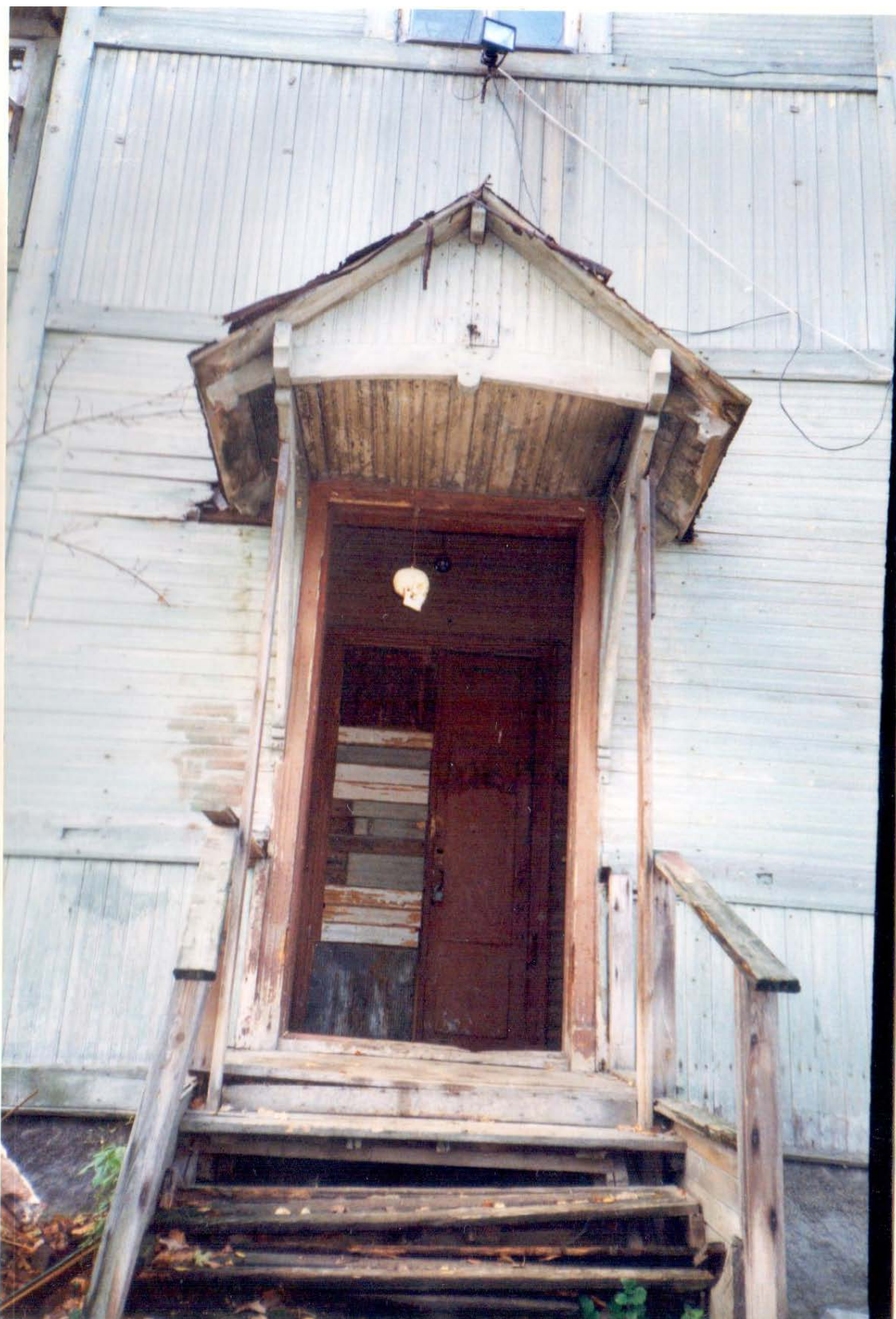
34. Натурные исследования дачи Н.В. Граве по ул. Софийской, 11 в Санкт-Петербурге. СПб., 1999. (архив КГИОП).
