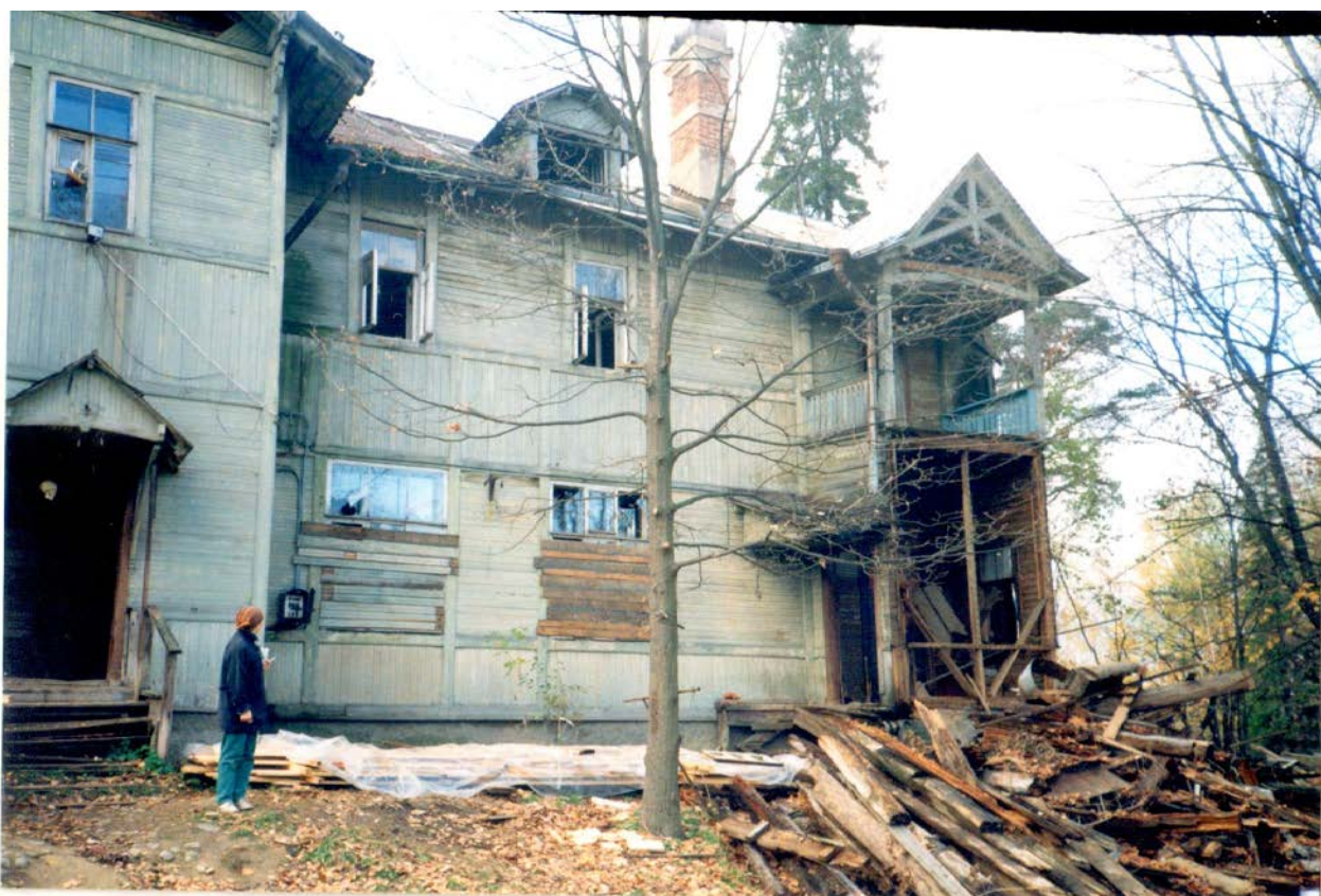
31. Натурные исследования дачи Н.В. Граве по ул. Софийской, 11 в Санкт-Петербурге. СПб., 1999. (архив КГИОП).
