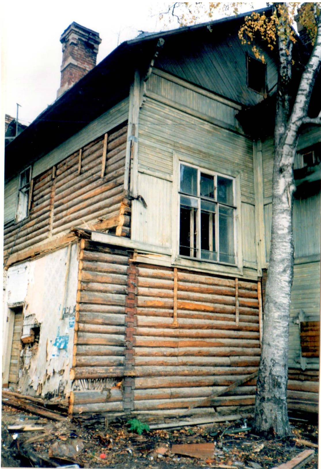
38. Натурные исследования дачи Н.В. Граве по ул. Софийской, 11 в Санкт-Петербурге. СПб., 1999. (архив КГИОП).
