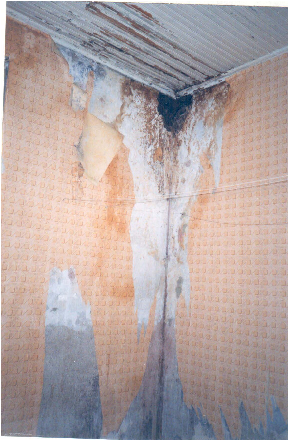
56. Натурные исследования дачи Н.В. Граве по ул. Софийской, 11 в Санкт-Петербурге. СПб., 1999. (архив КГИОП).
