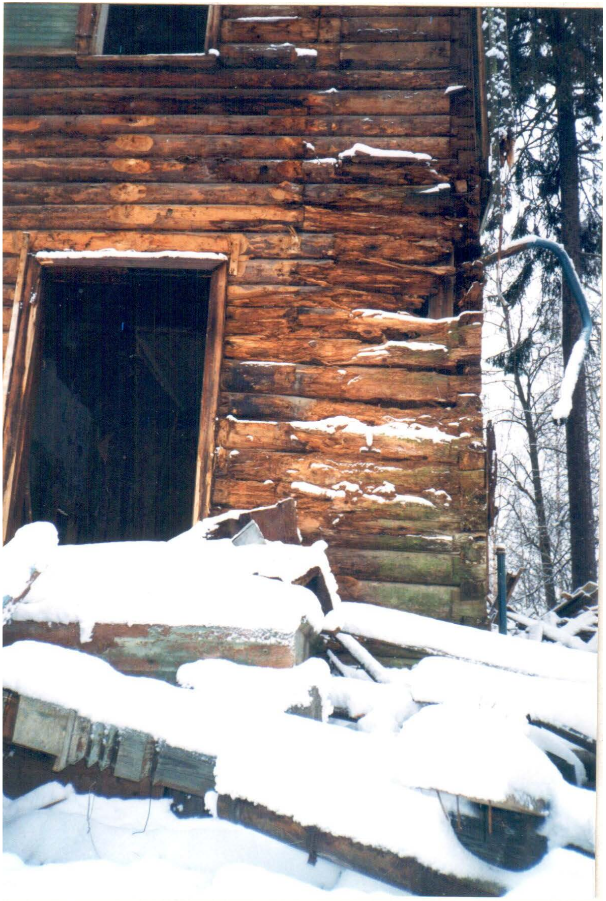
45. Натурные исследования дачи Н.В. Граве по ул. Софийской, 11 в Санкт-Петербурге. СПб., 1999. (архив КГИОП).
