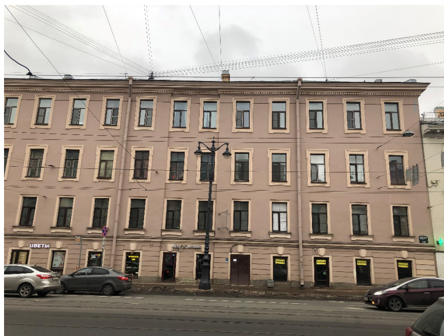
2. Вид на главный фасад здания с Кадетской линии;
