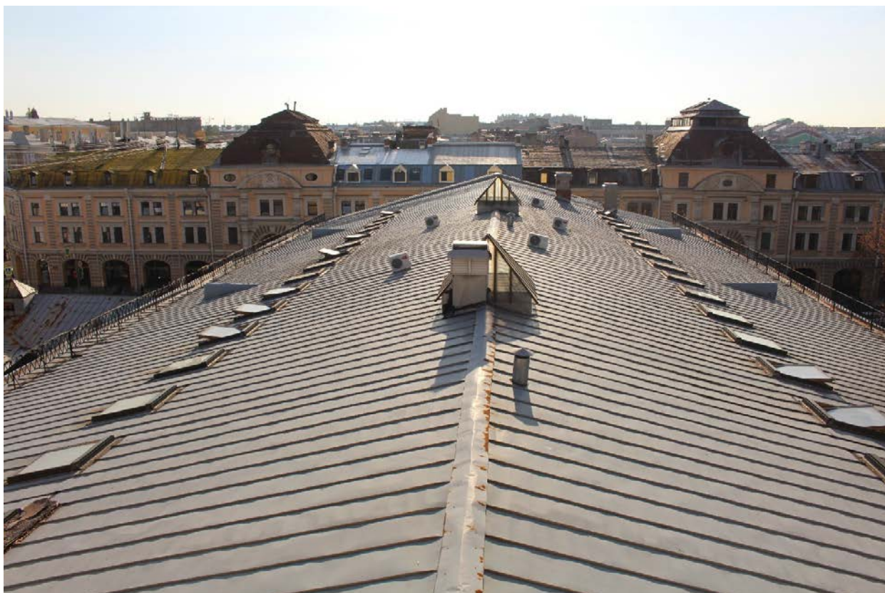
Фото 11. Общий вид крыши северного крыла.
