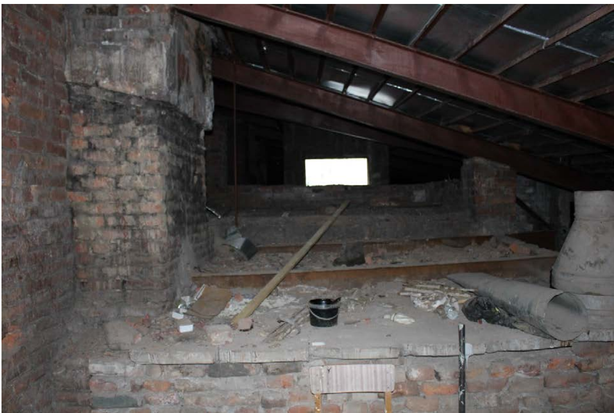
Фото 37. Фрагмент стен на южной части чердака центрального корпуса.
