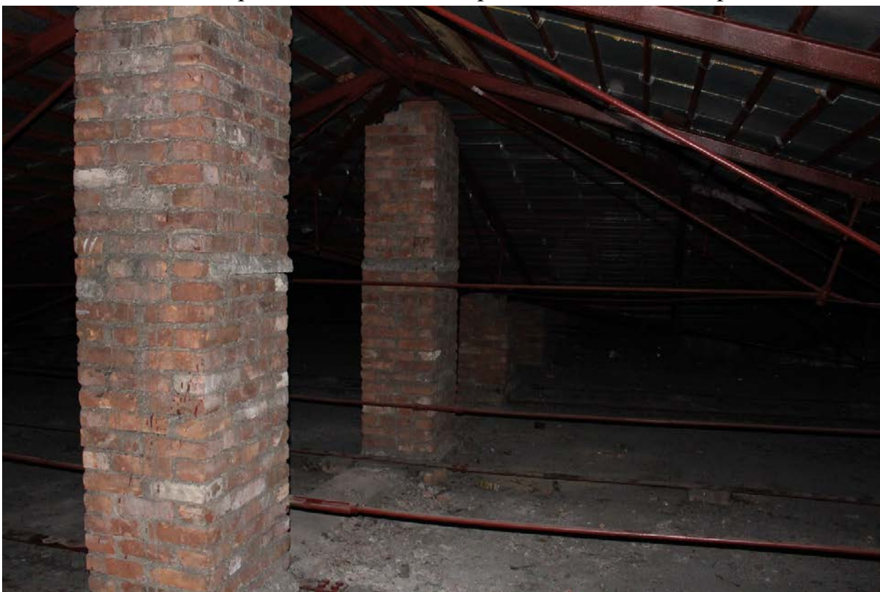
Фото 42. Кирпичные столбы чердака.
