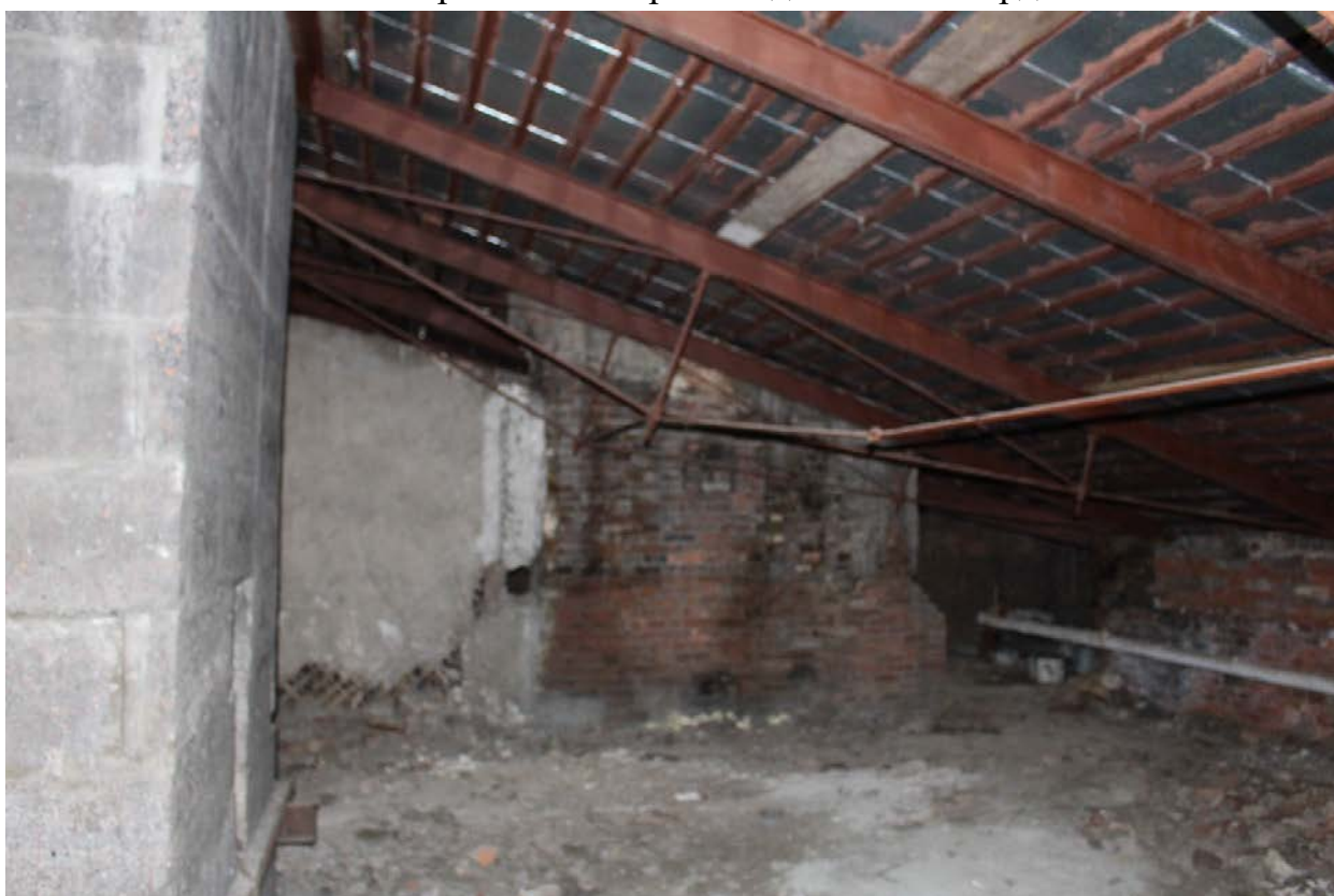
Фото 36. Вид юго-западной части чердака.
