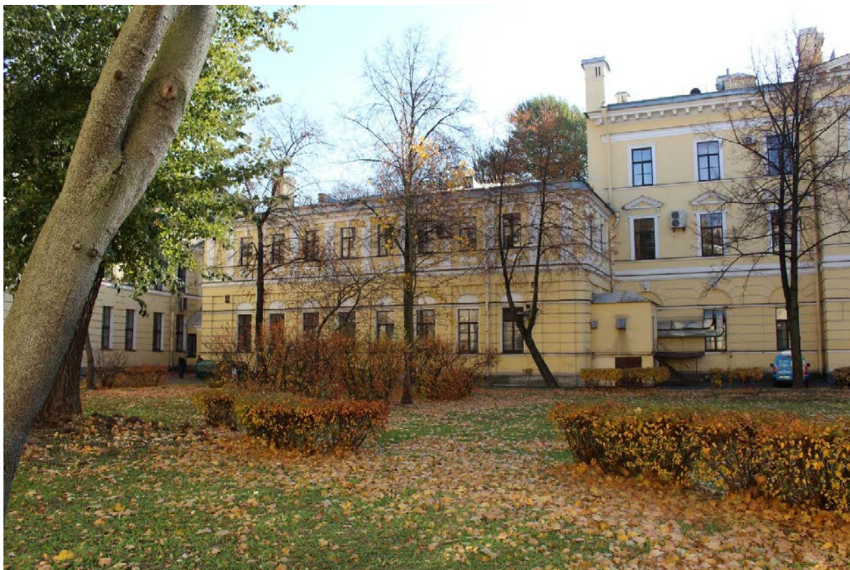
Фото 1. Общий вид северно-восточного флигеля.
