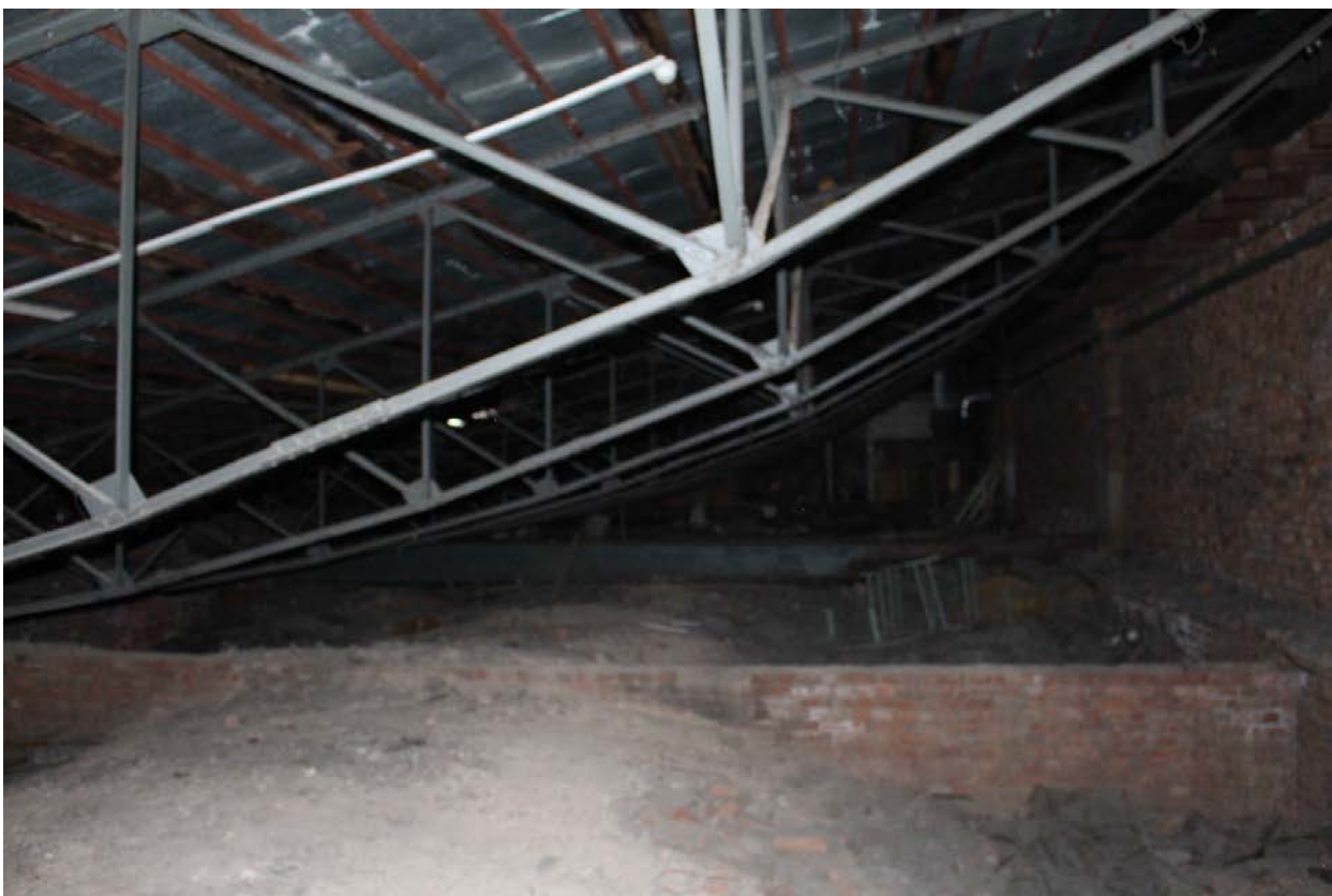
Фото 51. Вид на конструкции крыши южного чердака.
