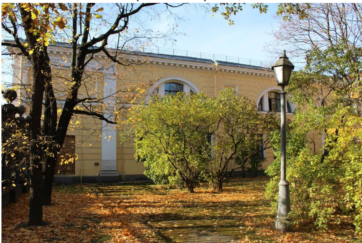
Фото 6. Фрагмент южного крыла, вид со двора.
