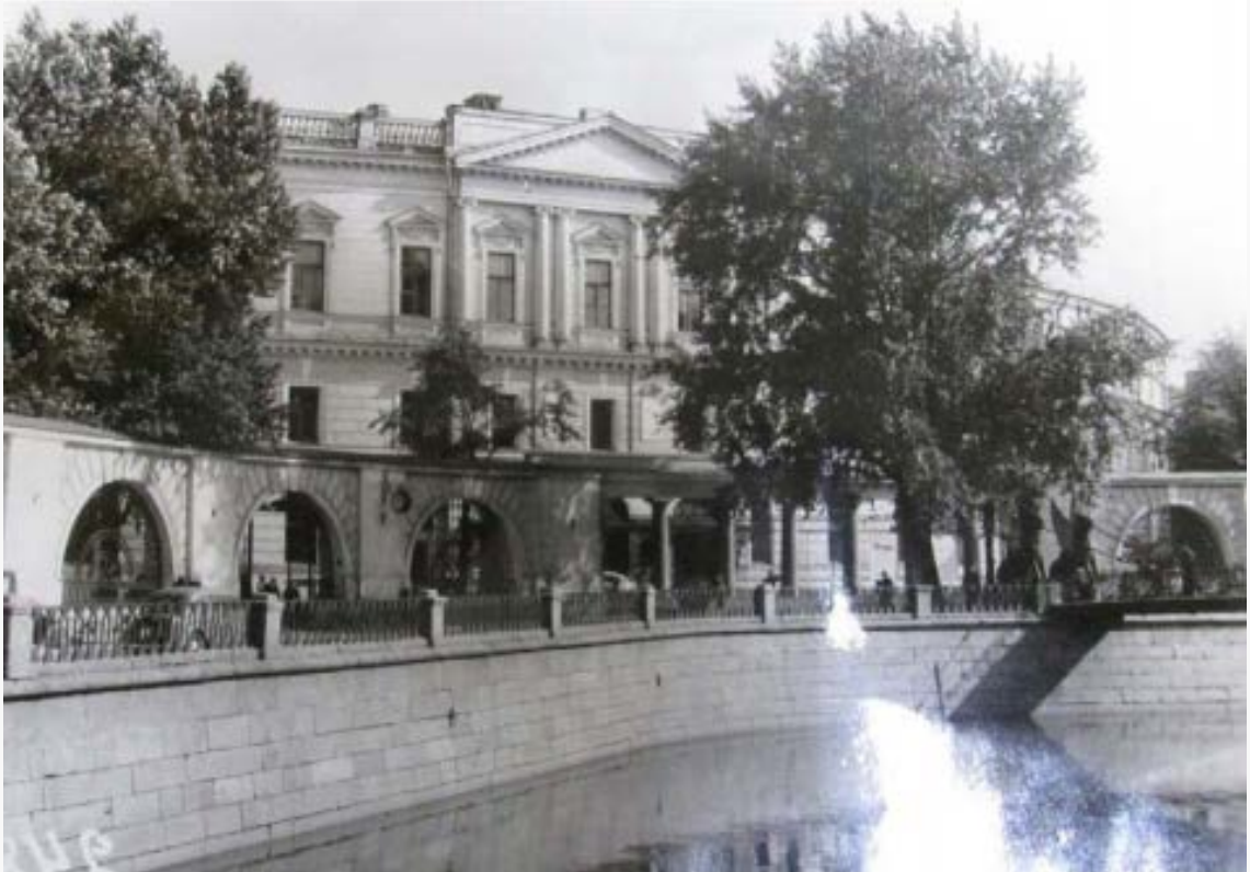
Илл. 37. Фасад здания и ограда со стороны канала Грибоедова. 1953 г. Паспорт. Здание Assignационного банка с двумя оградами. Ленинград. 1982 г.
