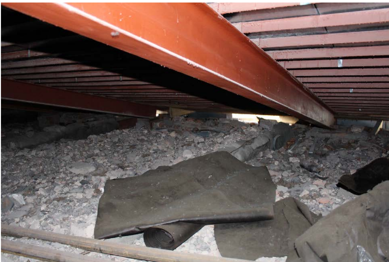
Фото 17. Фрагмент стропильной системы северного крыла.
