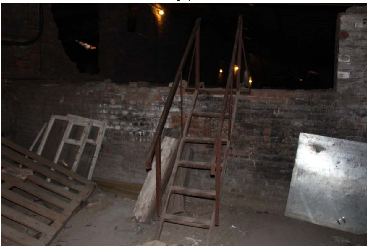
Фото 32. Фрагмент стены на чердаке.
