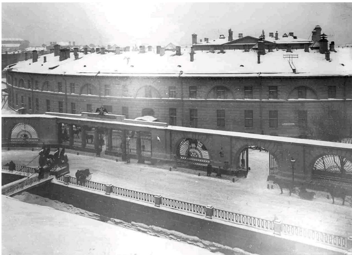
Илл. 24. Здание Государственного банка со стороны Екатерининского канала. 1893 г. ЦГАКФФД СПб: Е 4852.
