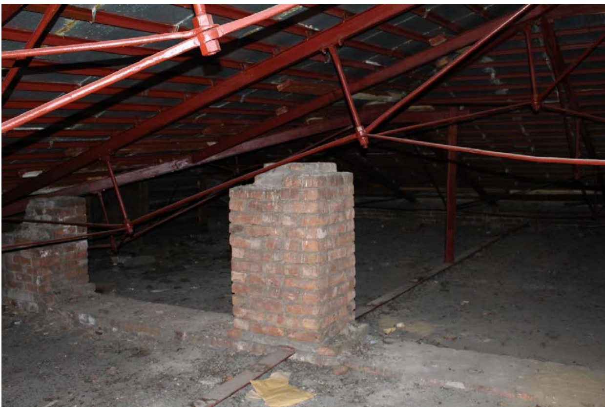
Фото 41. Северо-восточная часть чердака юго-западного флигеля.
