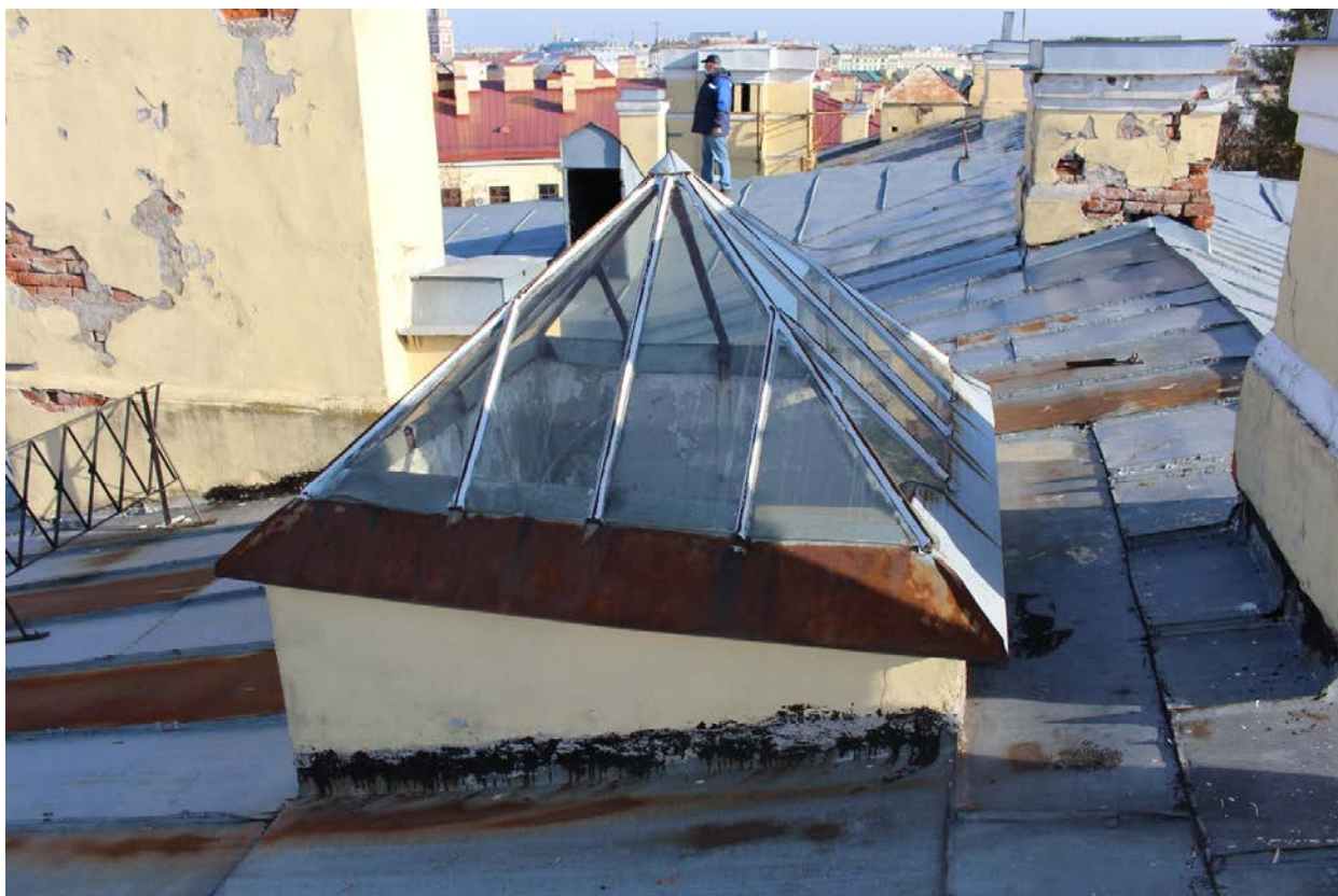
Фото 31. Фонарь и вид вдоль северной (дворовой) части крыши центрального корпуса.
