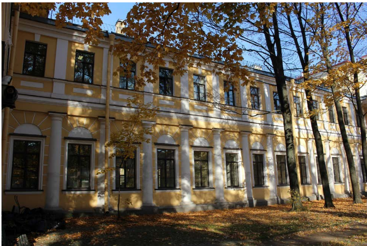
Фото 5. Северо-восточный флигель, вид с юга.
