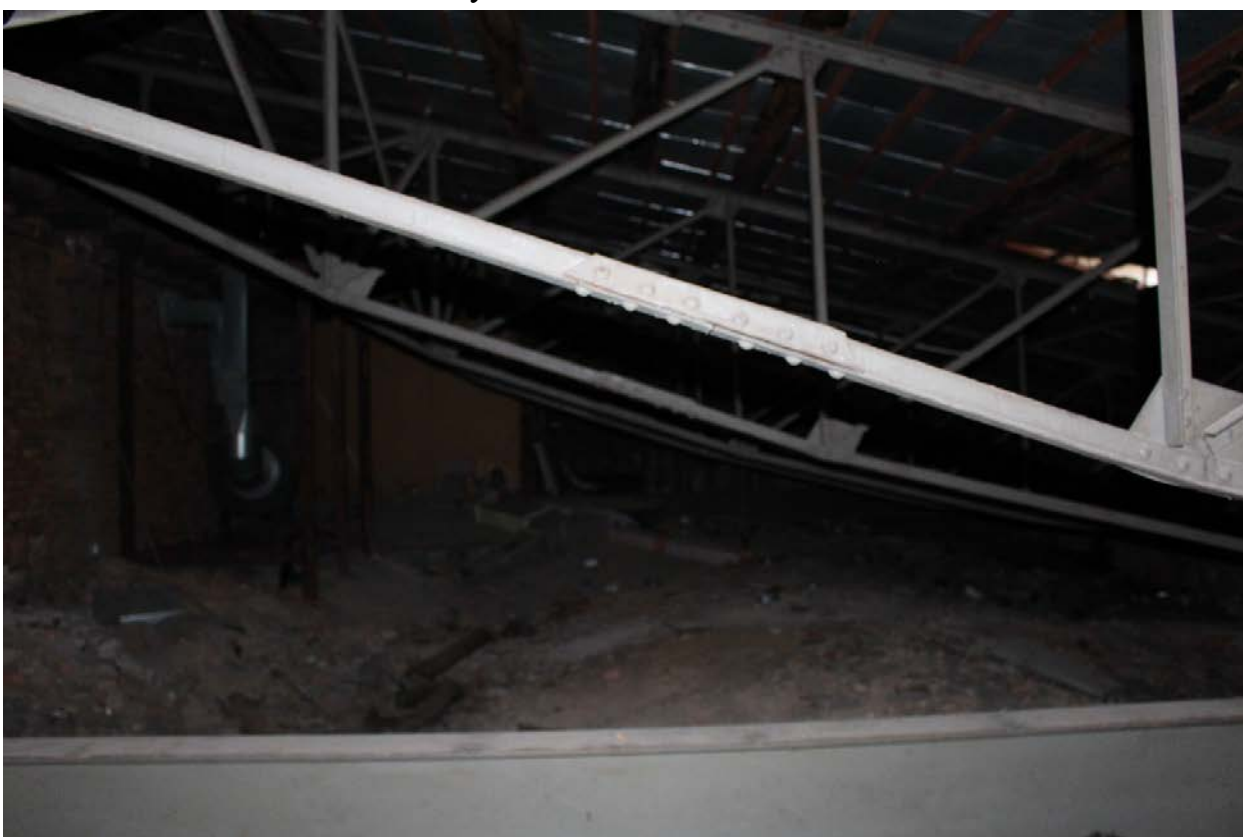
Фото 56. Конструкции восточной части чердака.
