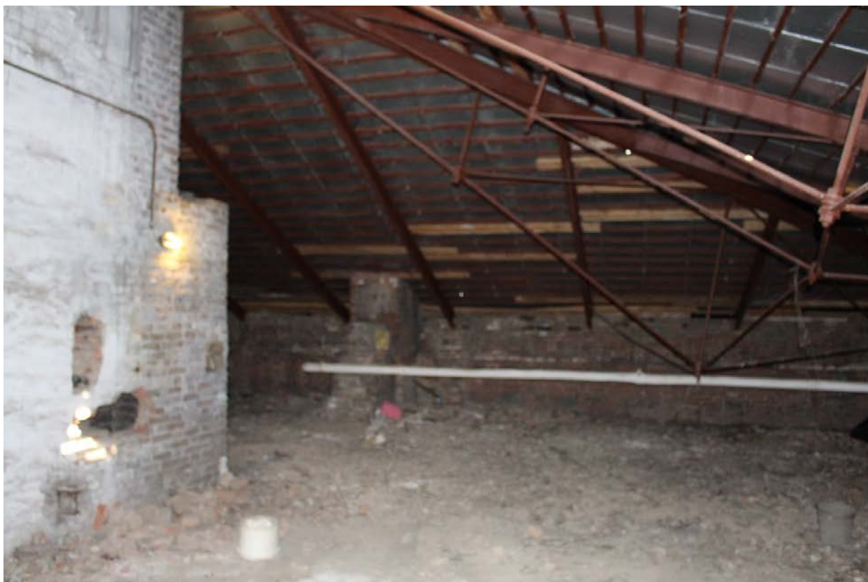
Фото 35. Фрагмент северо-западной части чердака.
