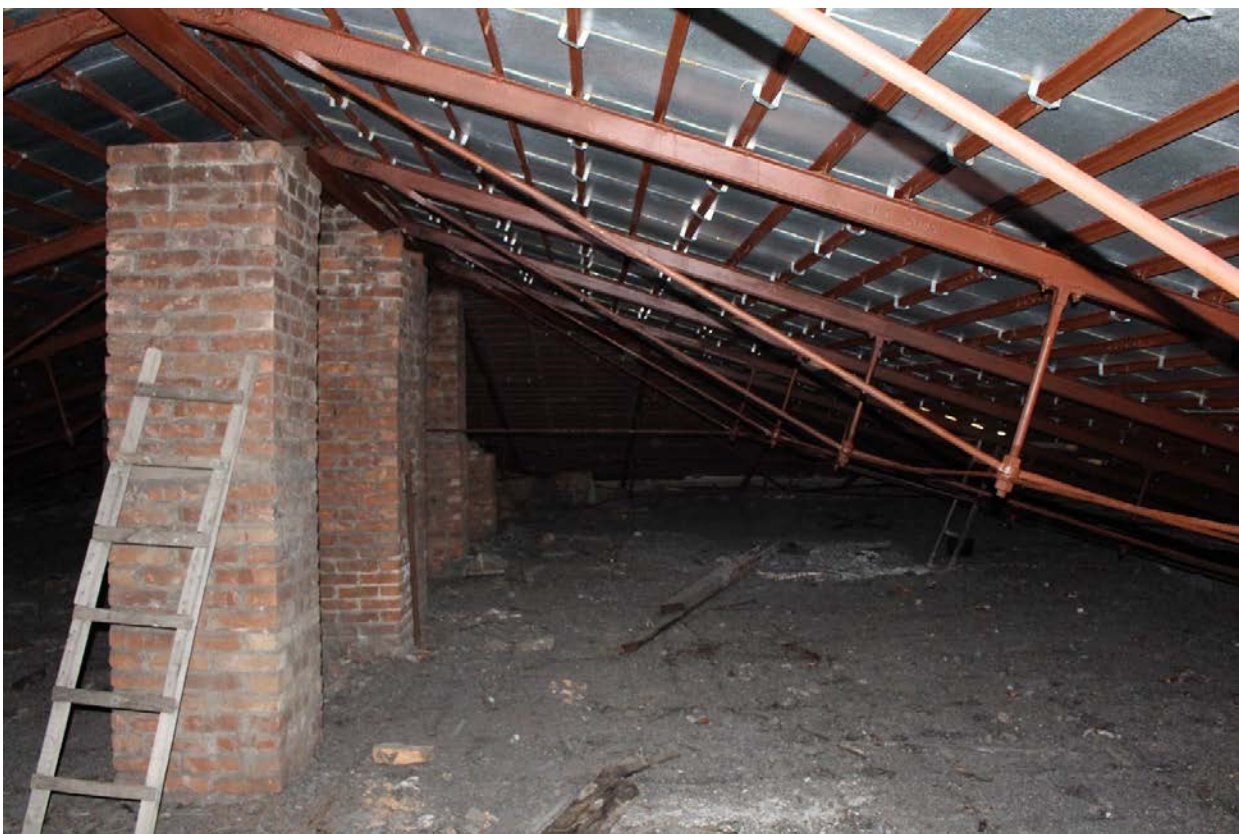
Фото 25. Общий вид чердака северо-восточного флигеля.
