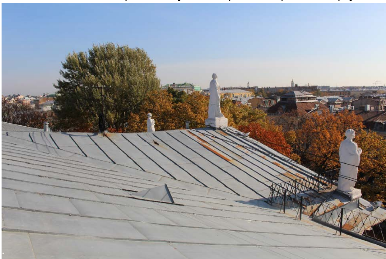
Фото 30. Вид на южную (лицевую) часть крыши центрального корпуса.
