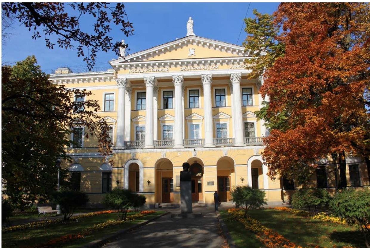
Фото 3. Лицевой фасад центрального корпуса.
