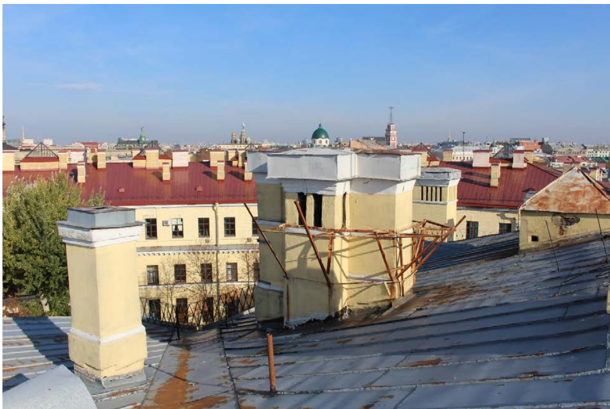
Фото 29. Вид на северо-восточную часть крыши центрального корпуса.
