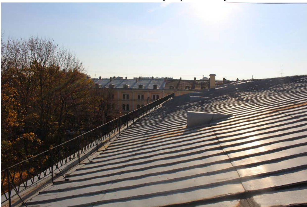
Фото 46. Вид вдоль восточного ската крыши южного крыла.
