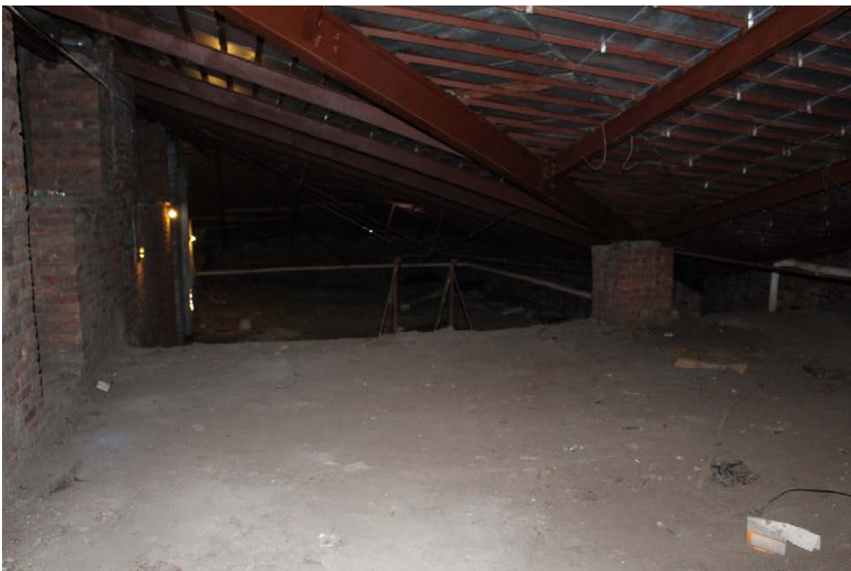
Фото 33. Вид северного помещения чердака центрального корпуса.
