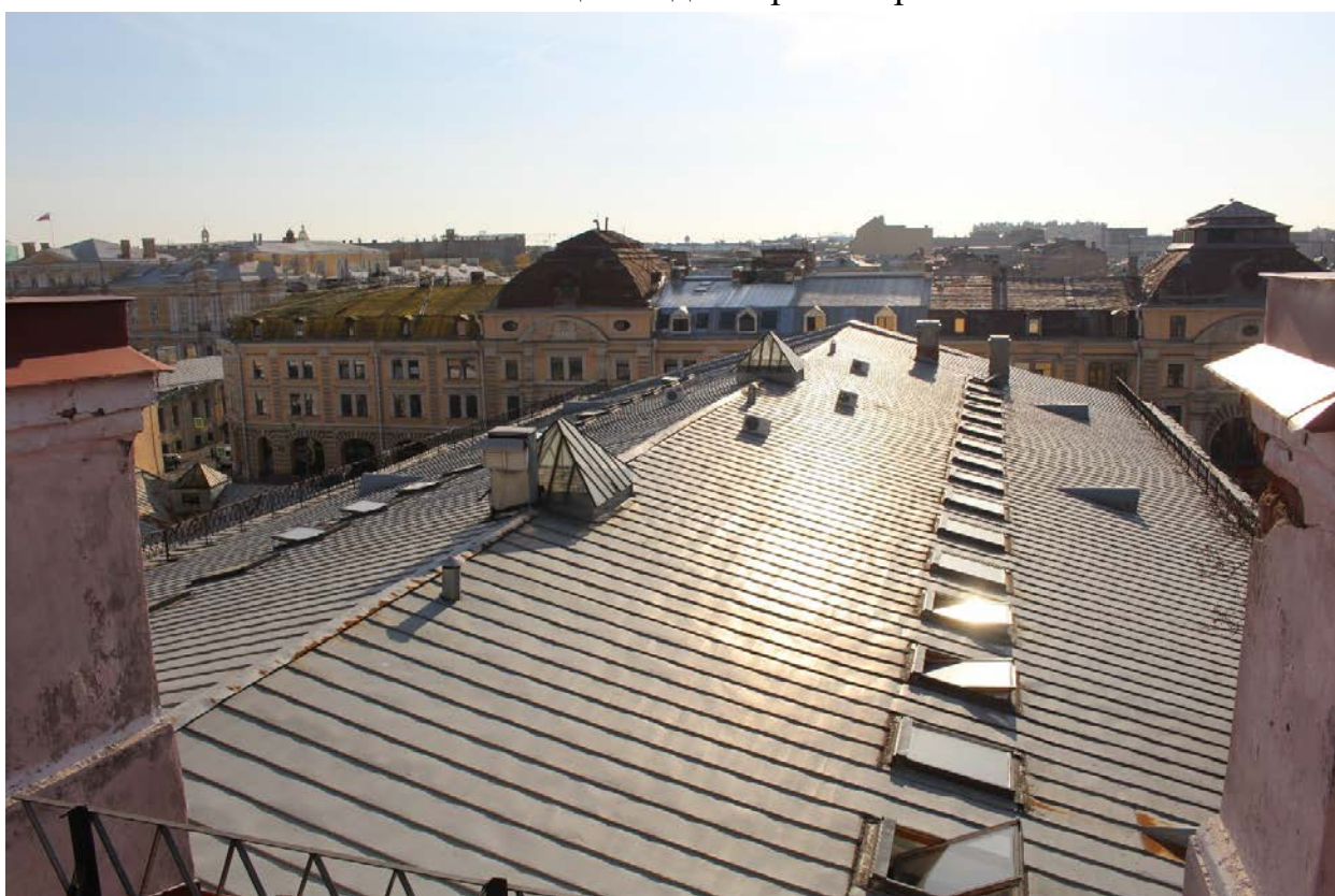
Фото 10. Вид на западный скат крыши северного крыла.
