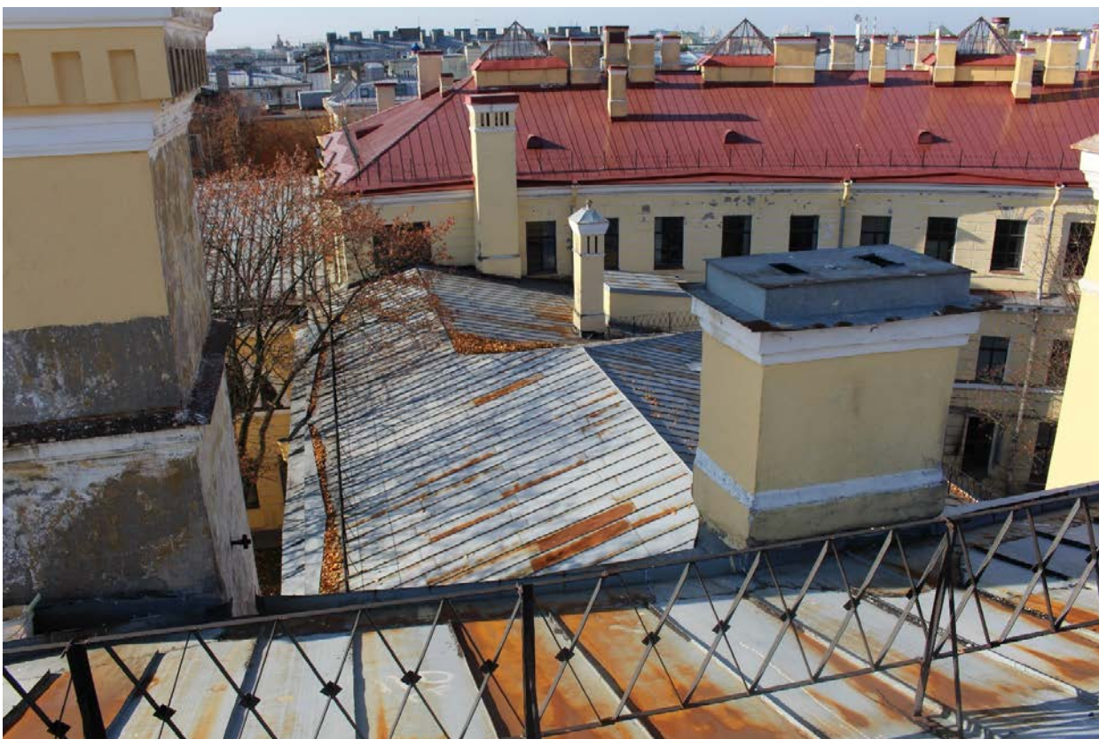
Фото 39. Общий вид на крышу юго-западного флигеля.
