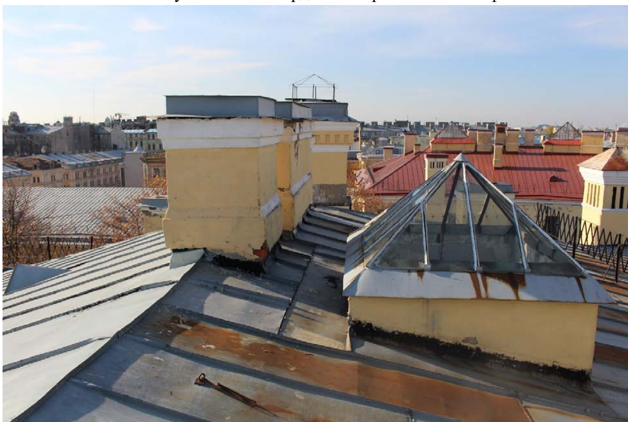
Фото 28. Трубы и фонарь центрального корпуса.
