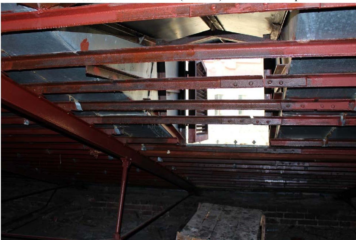
Фото 44. Слуховое окно на чердаке юго-западного флигеля.
