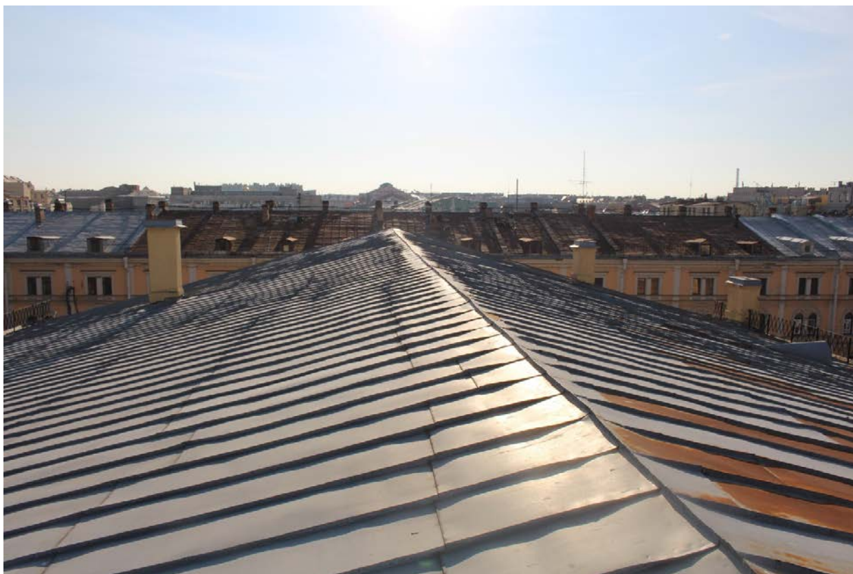
Фото 45. Общий вид на крышу южного крыла.
