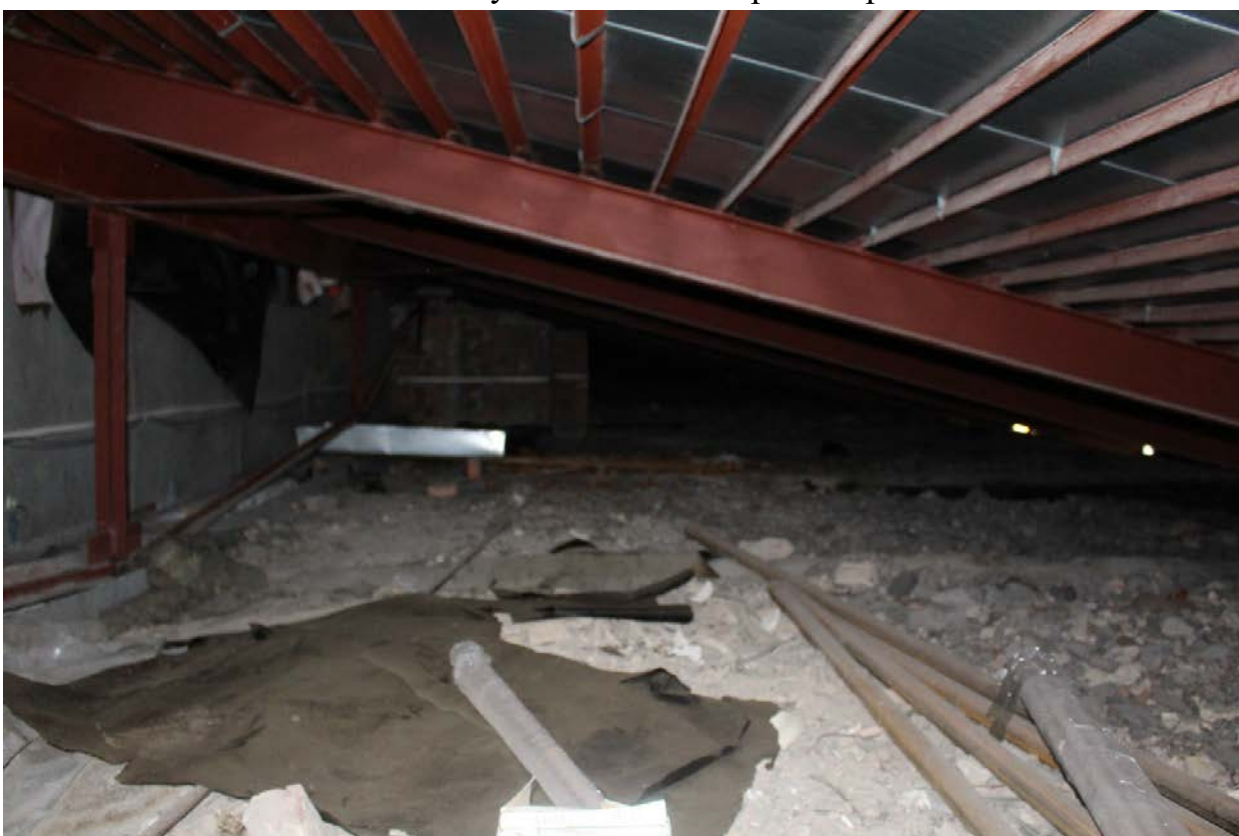
Фото 16. Общий вид западной части северного крыла.
