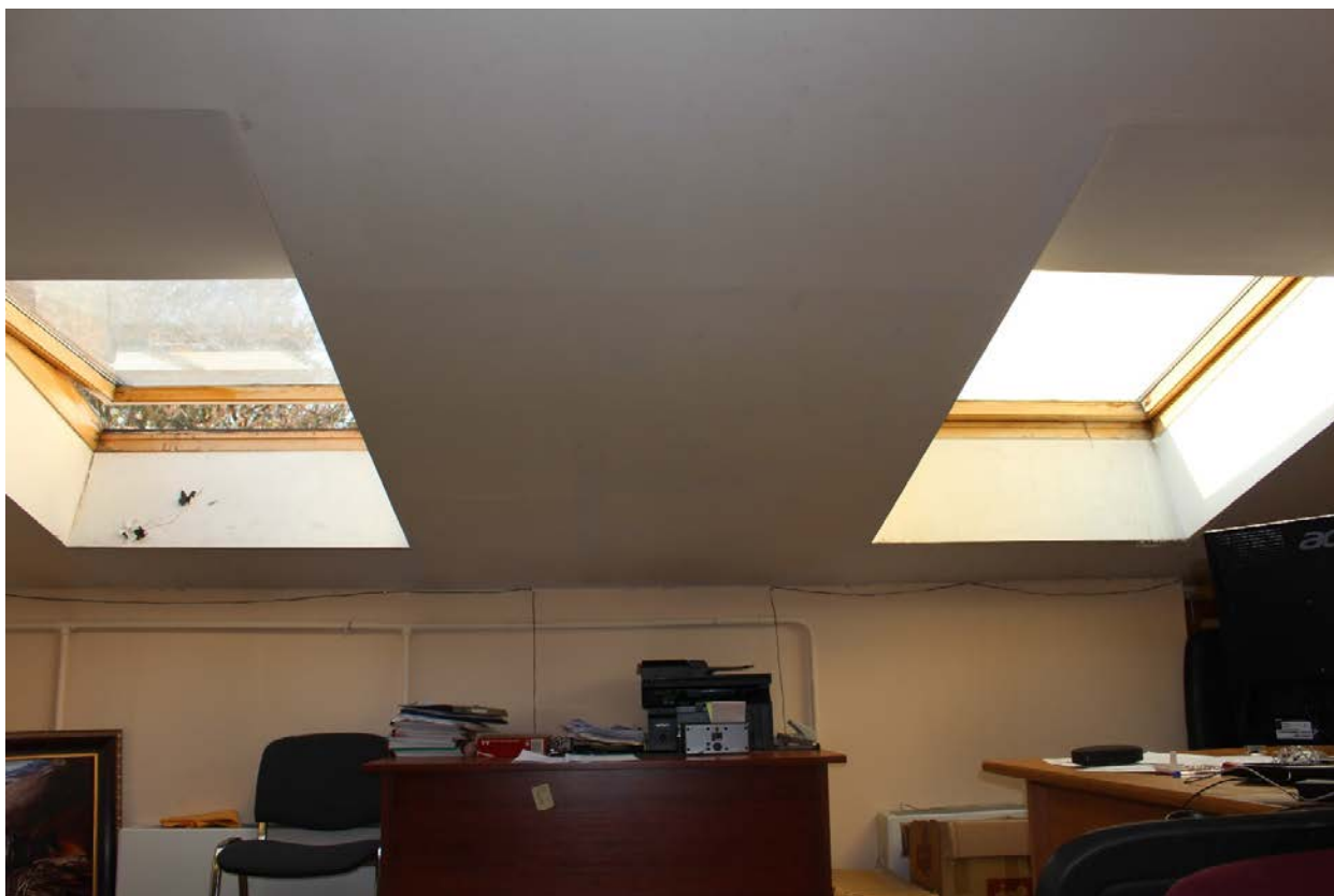
Фото 21. Мансардные окна северного крыла.
