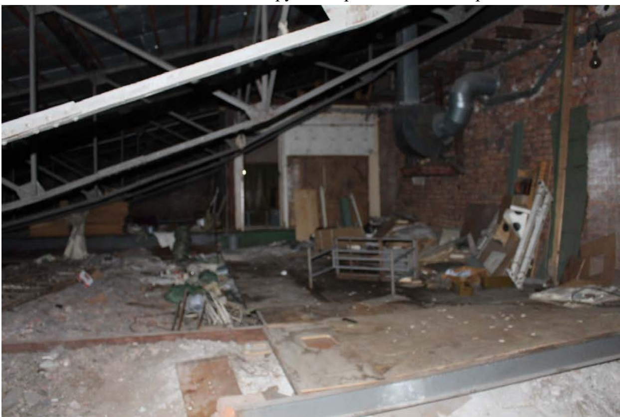
Фото 52. Вид стены и входа на чердак.
