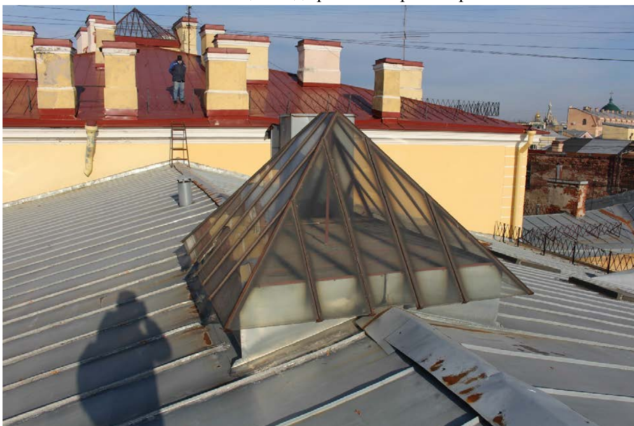
Фото 12. Световой фонарь северного крыла.
