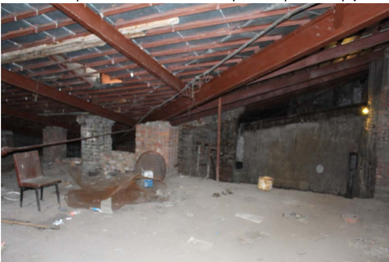
Фото 38. Вид на стропильную систему центрального корпуса.
