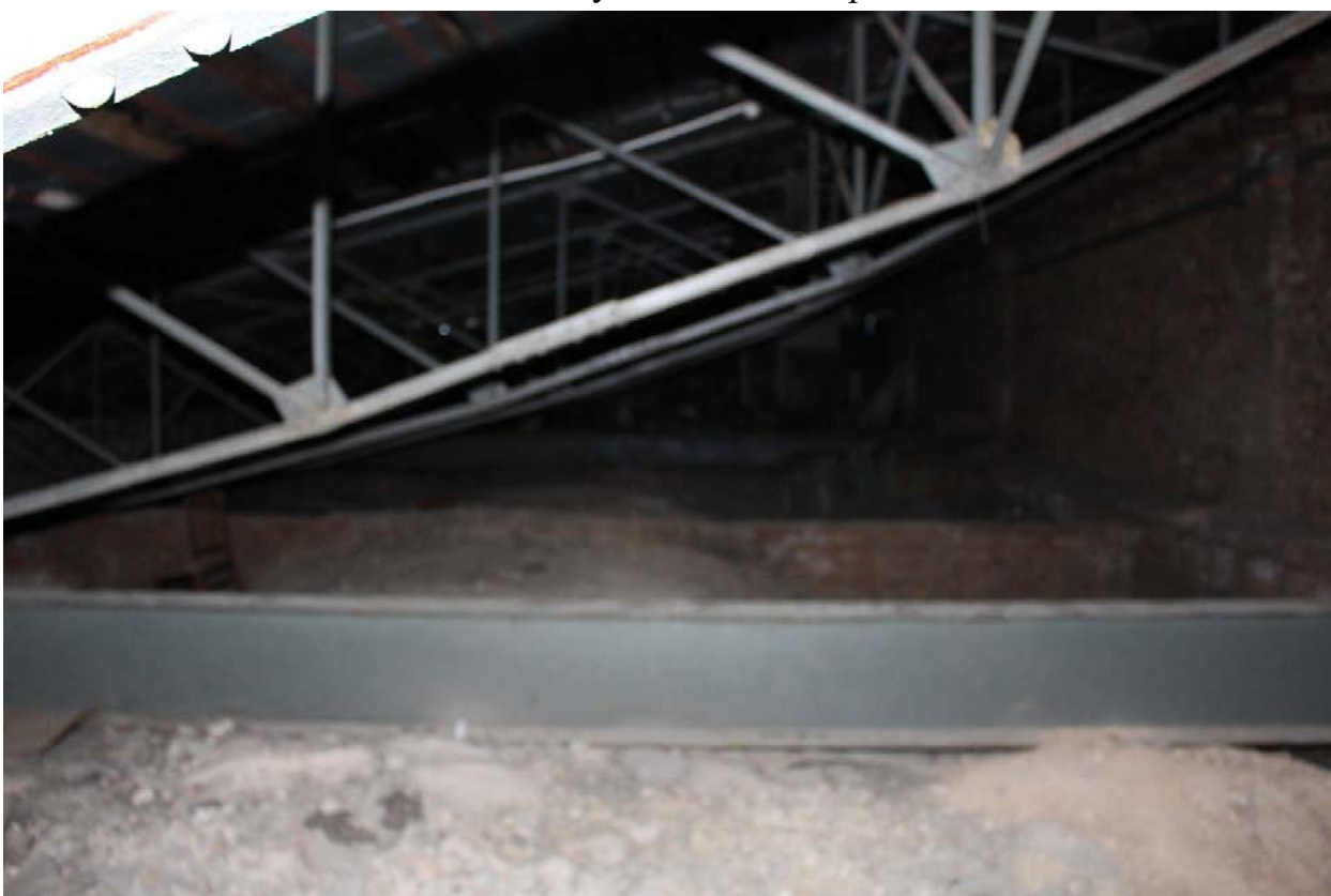
Фото 50. Фрагмент западной части чердака.
