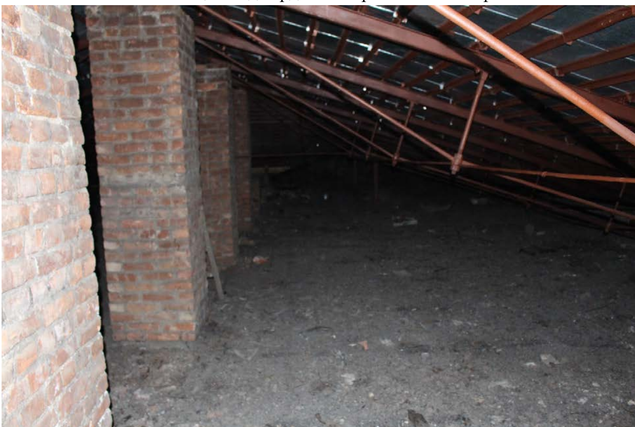
Фото 26. Вид чердака северо-восточного флигеля с юго-запада.
