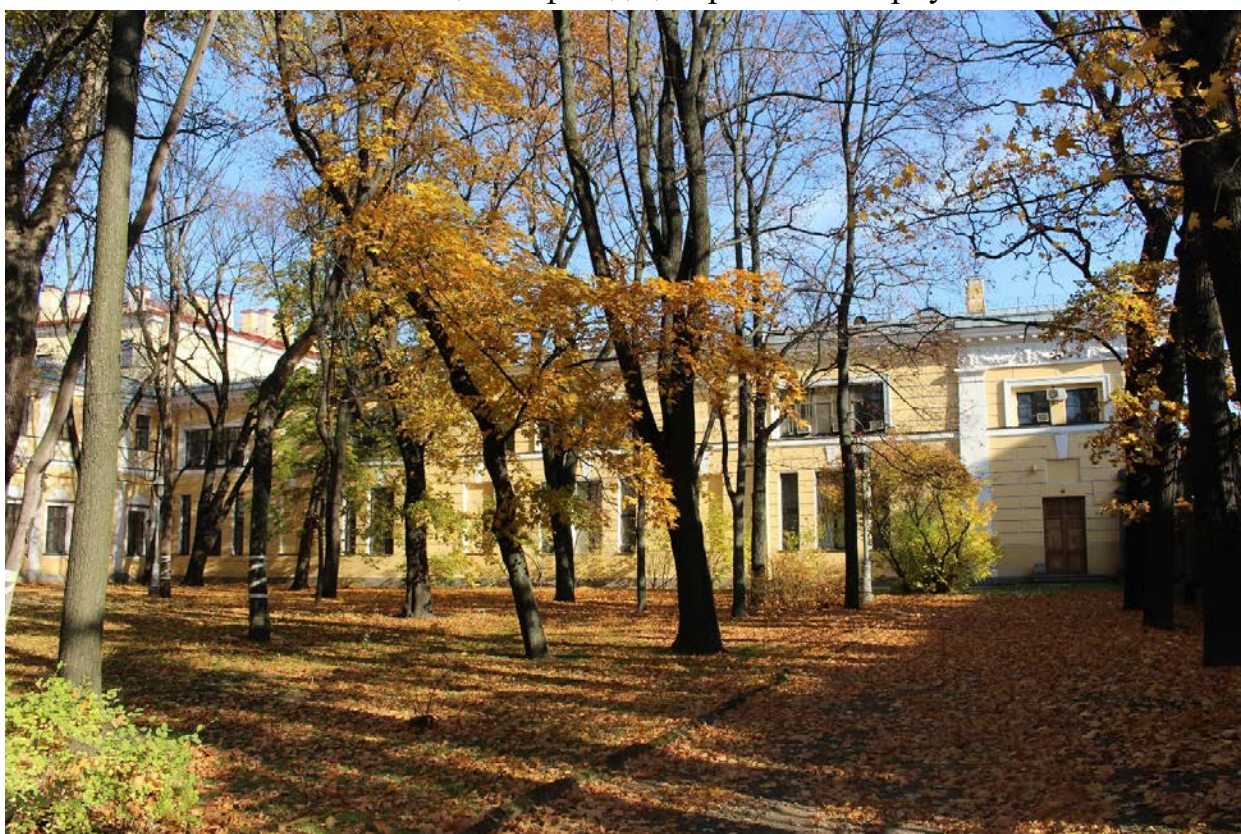
Фото 4. Вид северного крыла со двора.
