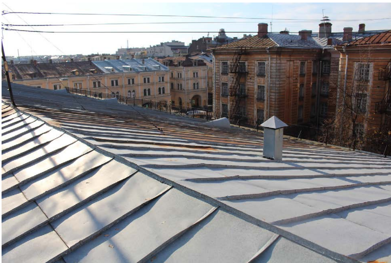
Фото 47. Вид на западный скат крыши южного крыла.
