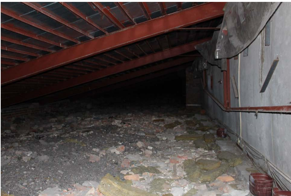
Фото 13. Восточная часть чердака северного крыла.
