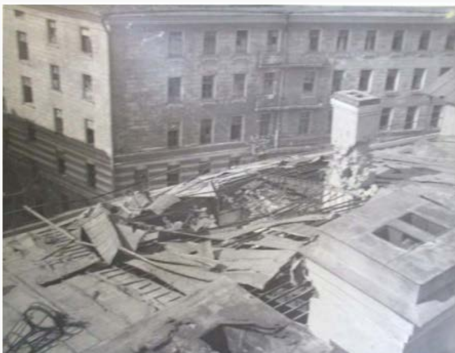
Илл. 35. Разрушение крыши полуциркульной части памятника. Октябрь 1943 г. Следы разрушений. Акт обследования здания б. Госбанка. Ленинград. Архив КГИОП.
