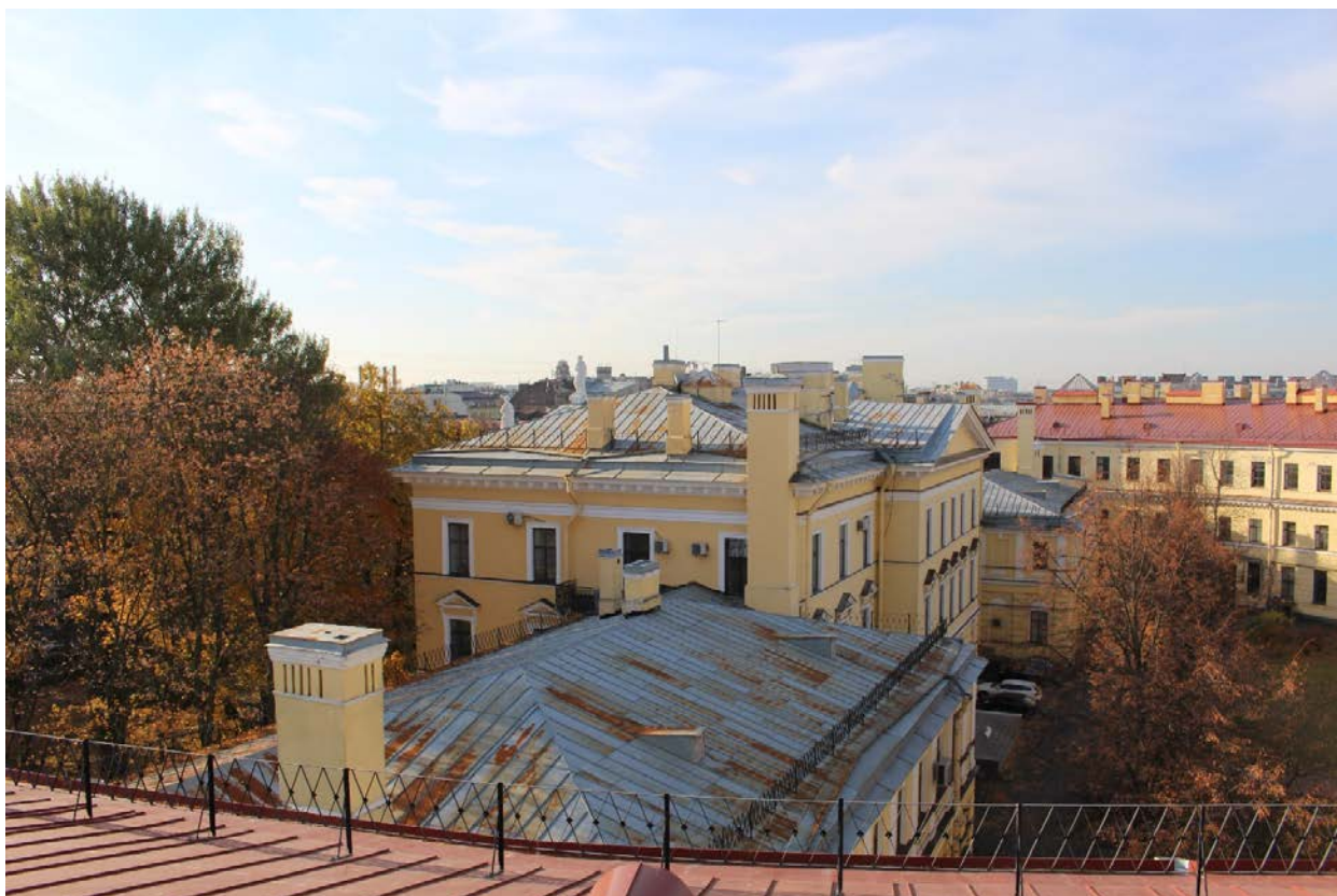
Фото 23. Общий вид на крыши центрального корпуса с флигелями.
