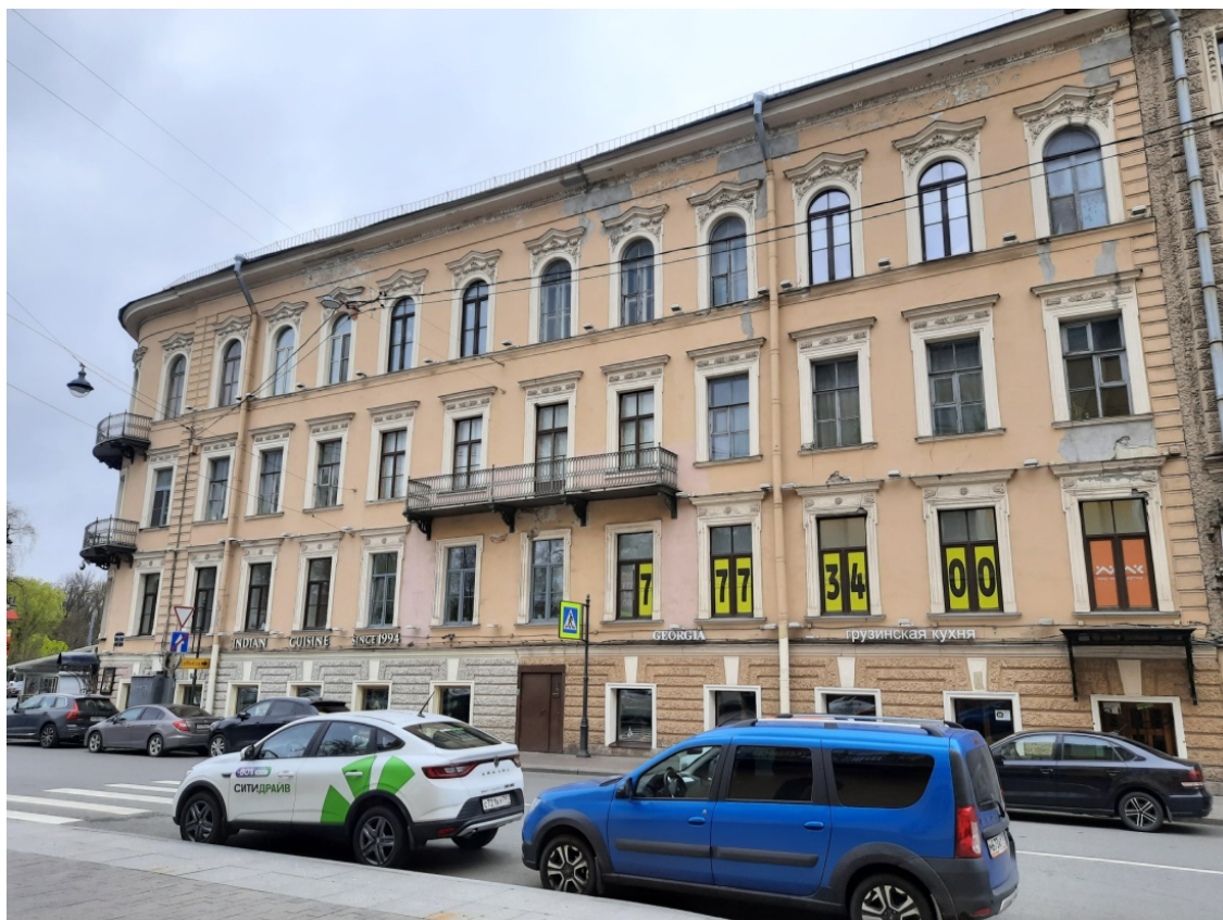
Фото 1 Лицевой фасад объекта культурного наследия федерального значения «Дом, где в 1866-1870 гг. находилась «Артель художников» и жил художник Крамской И. Н.»
