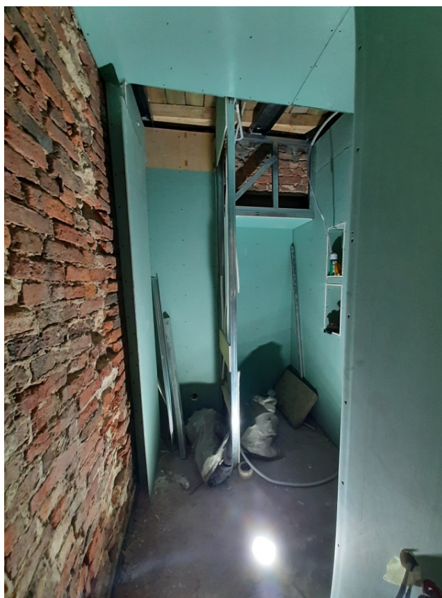
Фото 16 Интерьер квартиры № 32 объекта культурного наследия федерального значения «Дом, где в 1866-1870 гг. находилась «Артель художников» и жил художник Крамской И. Н.»
