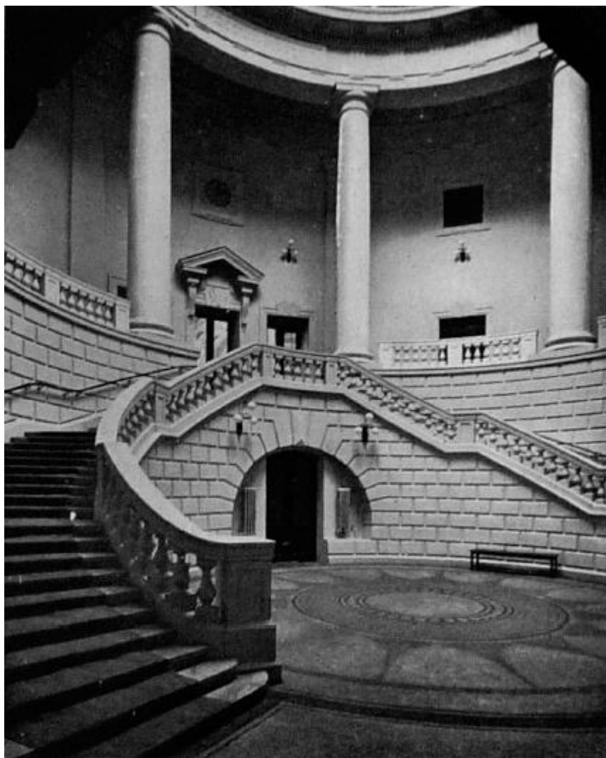
27. Главное Казначейство. Главный вестибюль. 1916 г. Фотография. Автор съемки: К. Булла. ЦГА КФФД СПб.
