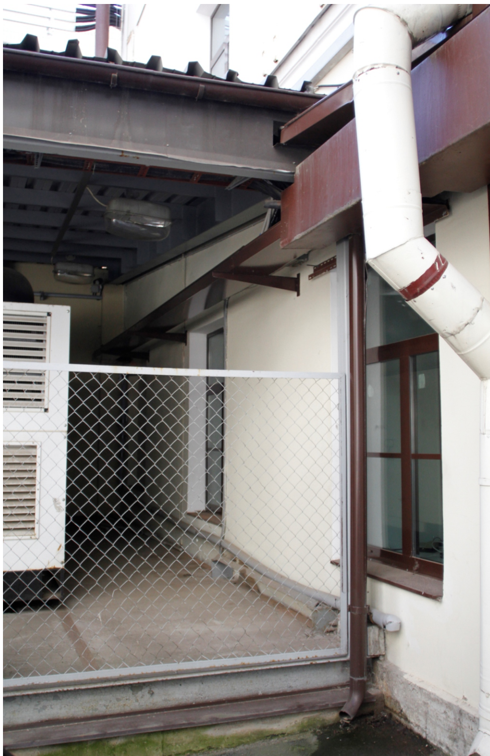
7. «Главное казначейство». Санкт-Петербург, наб. р. Фонтанки, дом 70-72-74, литера А. Фрагмент стены со стороны двора. Фото: 09.09.2022.
