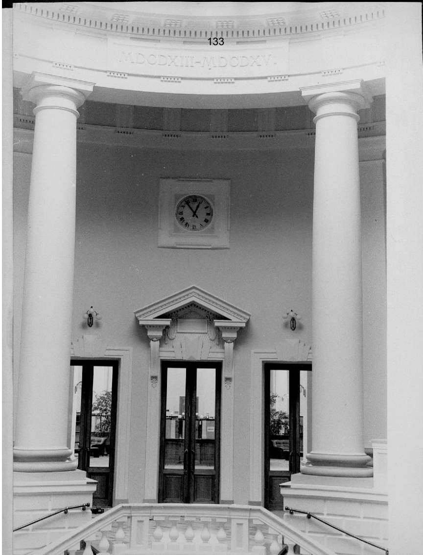
С.Петербург. Центральный р-н. Наб.рек.Фонтанки, 70-72. 3.3 1.29.1 Главное казначейство. 1913-1915 гг. Вестибюль. Вход в операционный зал. Фото 1999 г. В.Ф.Егоровский. № 5.
