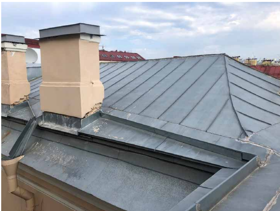
Фото 4. Юго-западный участок кровли.
