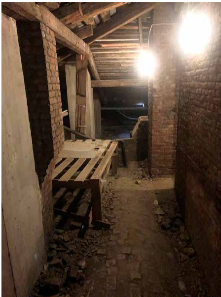
Фото 3. Северо-западная часть чердачного помещения.
