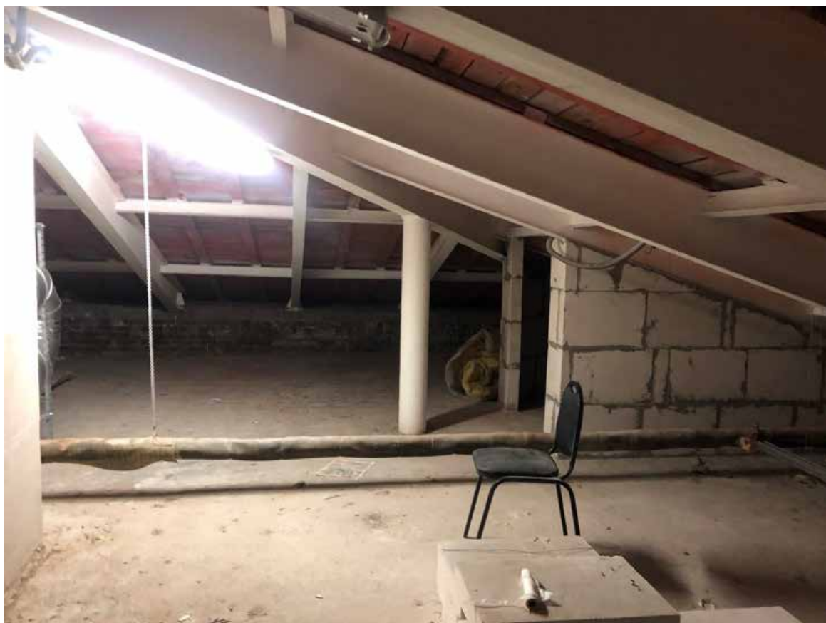
Фото 7. Северо-восточное чердачное помещение.
