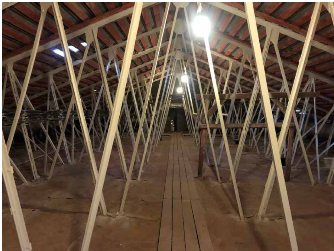
Фото 9. Центральная часть здания. Вид с юга на север.
