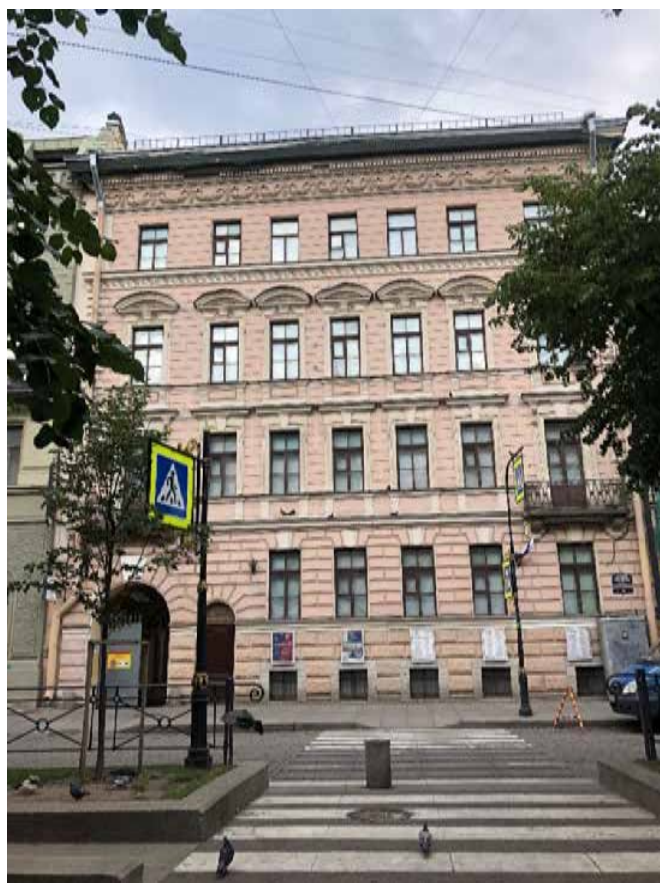
Фото 10. Лицевой фасад объекта культурного наследия по ул. Большая Конюшенная.
