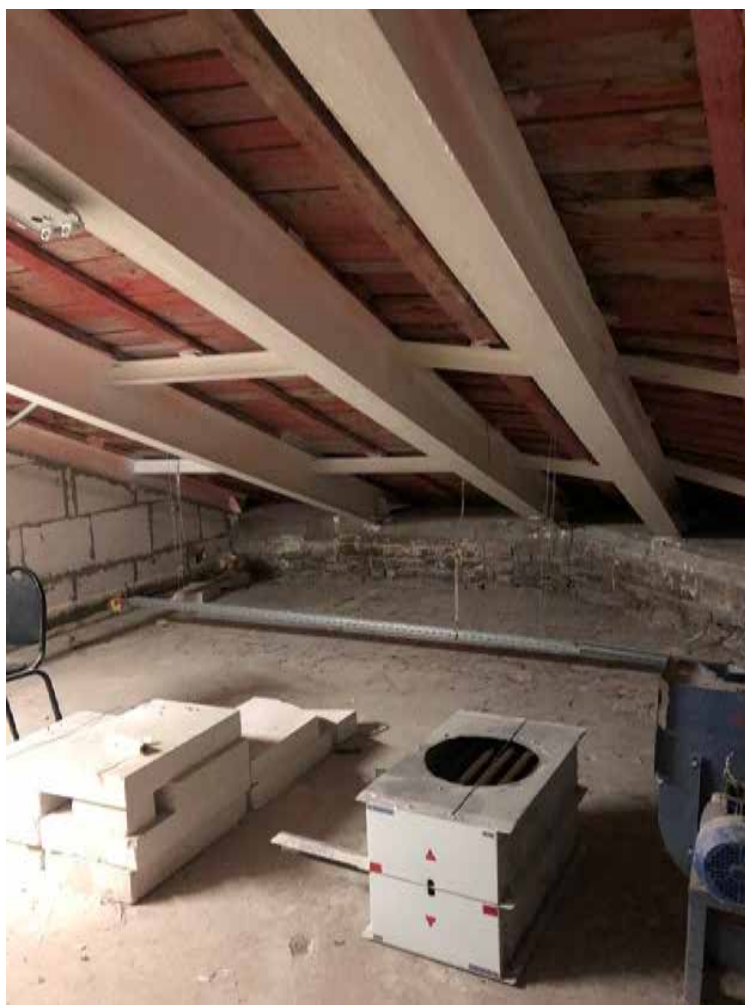
Фото 6. Северо-восточное чердачное помещение.
