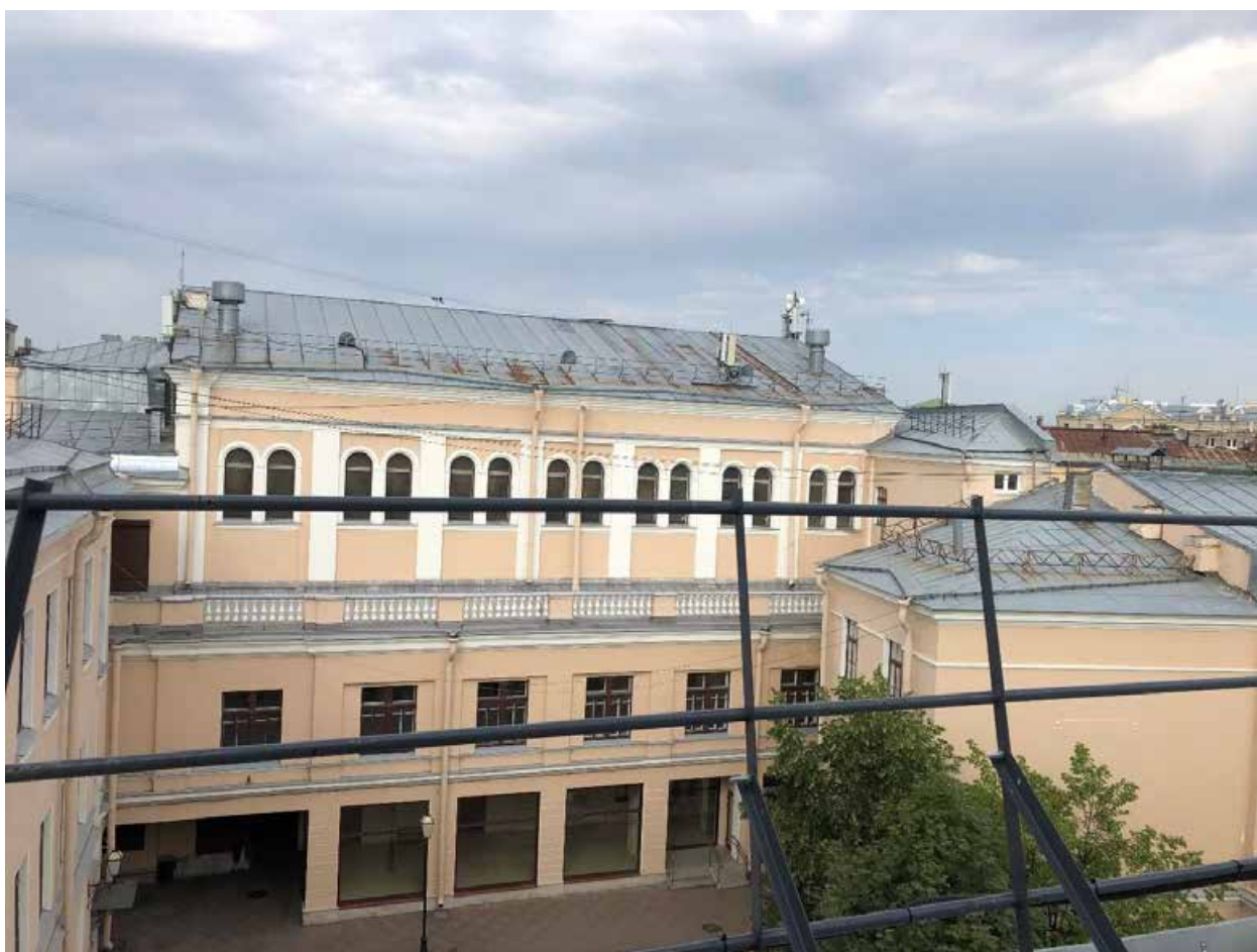
Фото 7. Вид на кровлю центрального корпуса.
