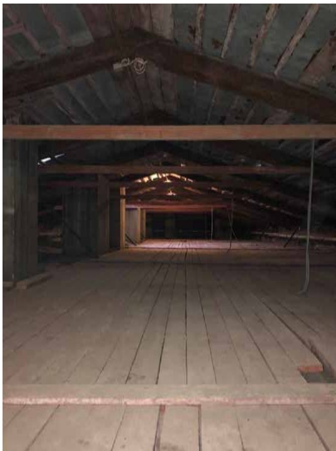
Фото 15. Юго-восточное чердачное помещение. Вид на запад.
