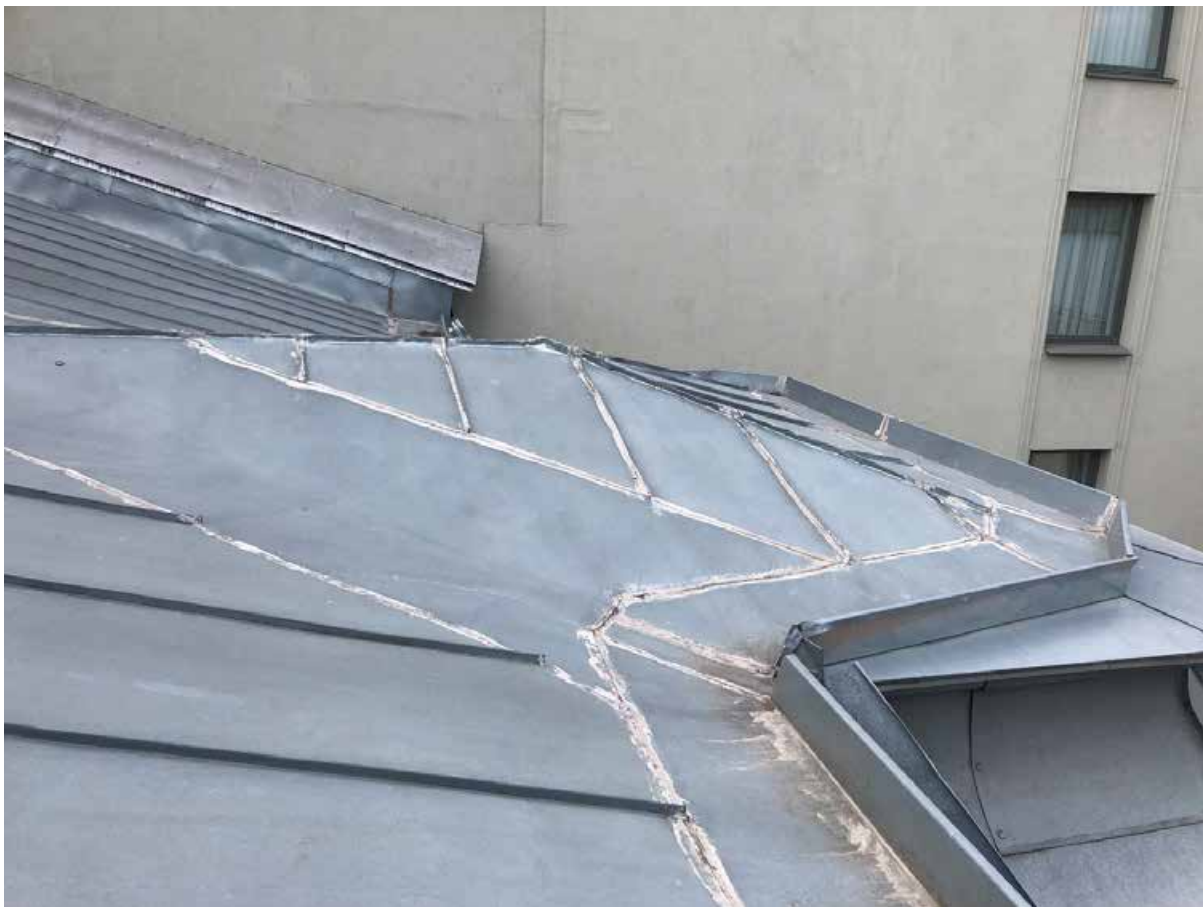
Фото 3. Юго-западный участок кровли.
