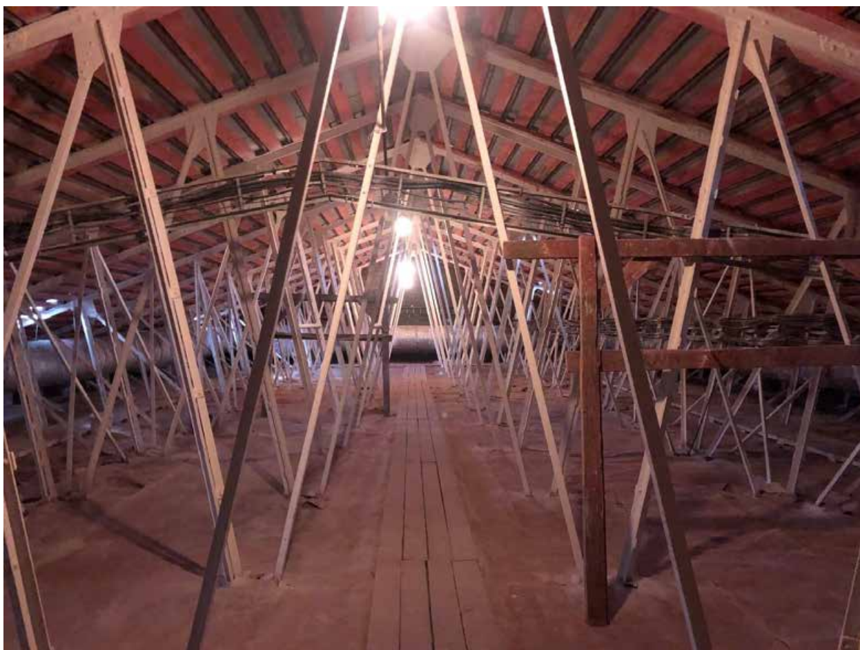
Фото 8. Центральная часть здания. Вид с севера на юг.
