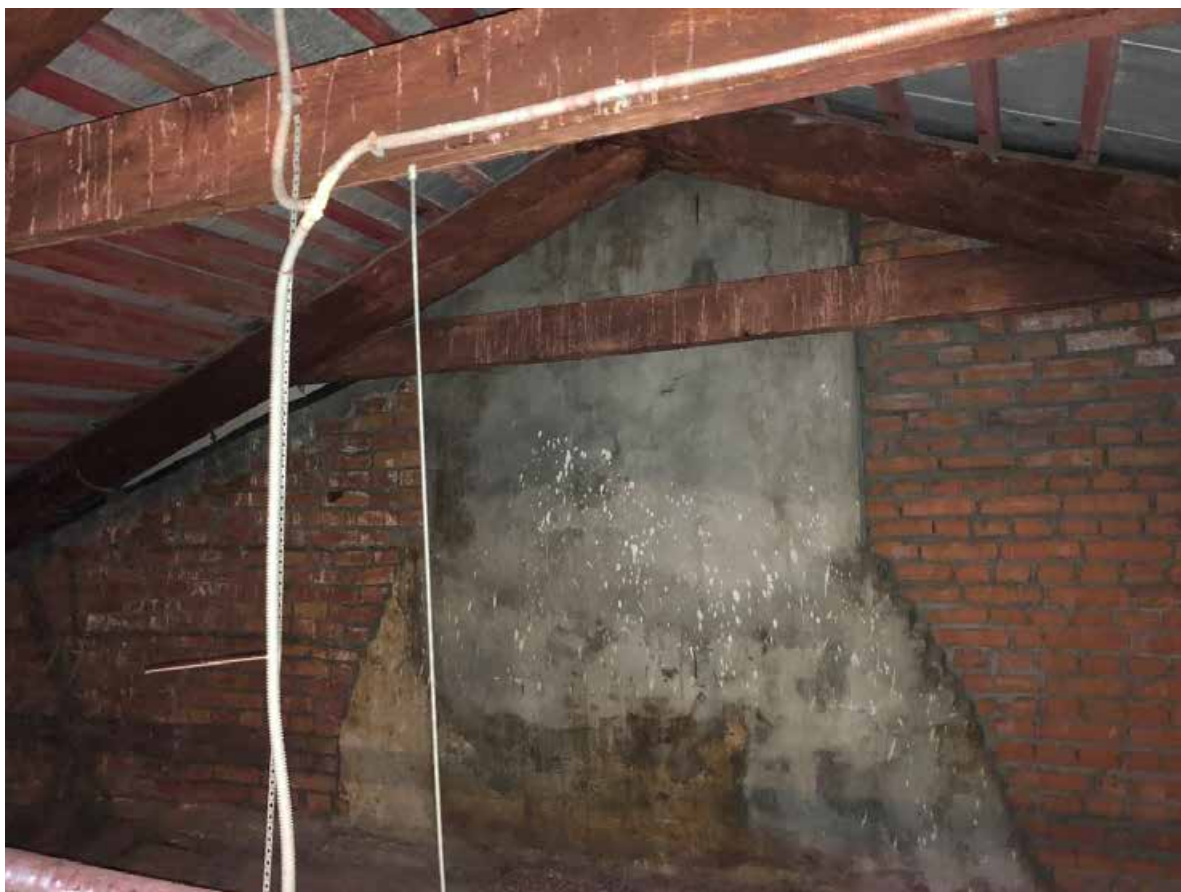
Фото 13. Юго-западное чердачное помещение.
