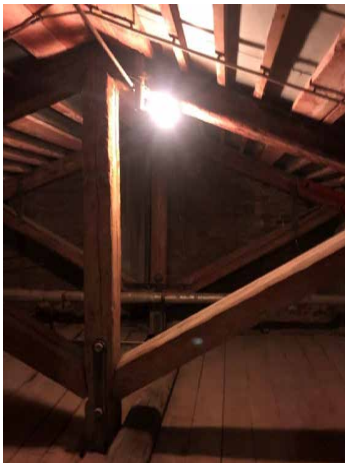
Фото 16. Юго-восточное чердачное помещение. Вид на юг.
