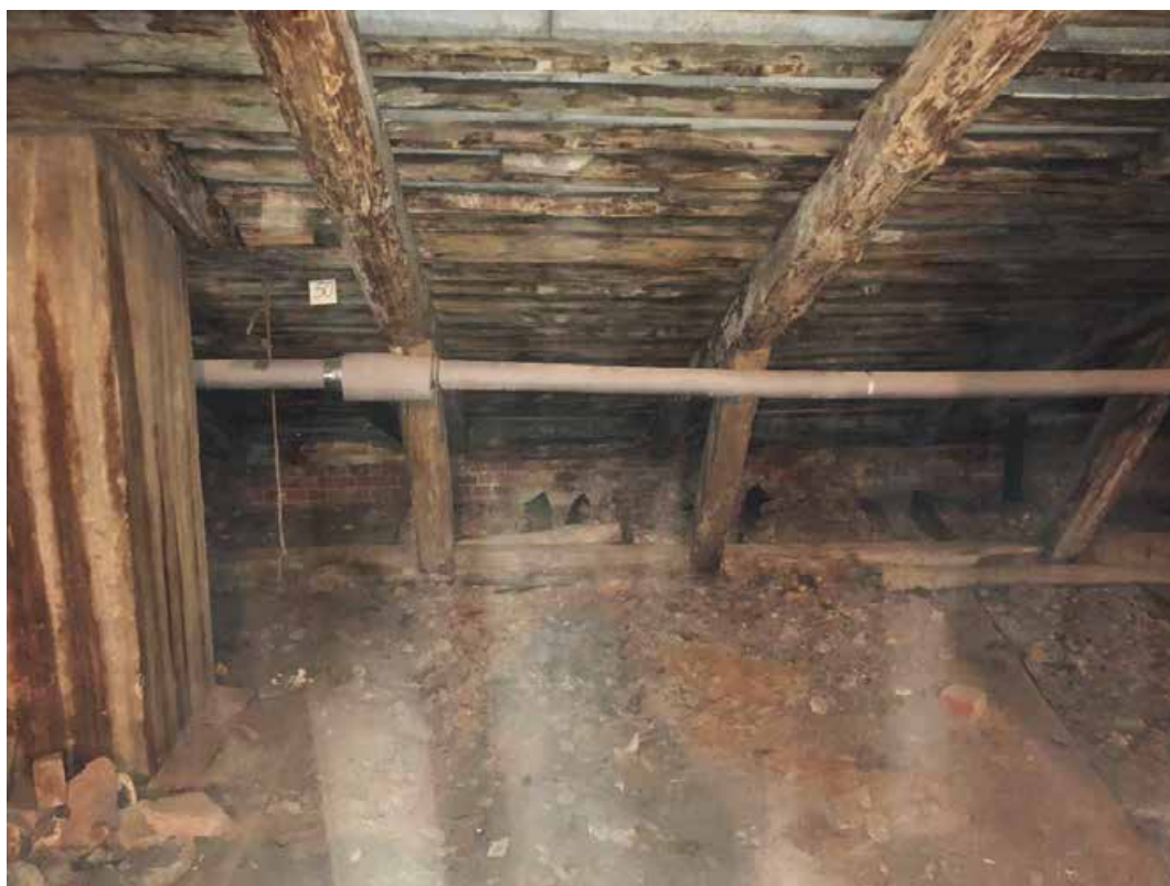
Фото 4. Северо-западная часть чердачного помещения.
