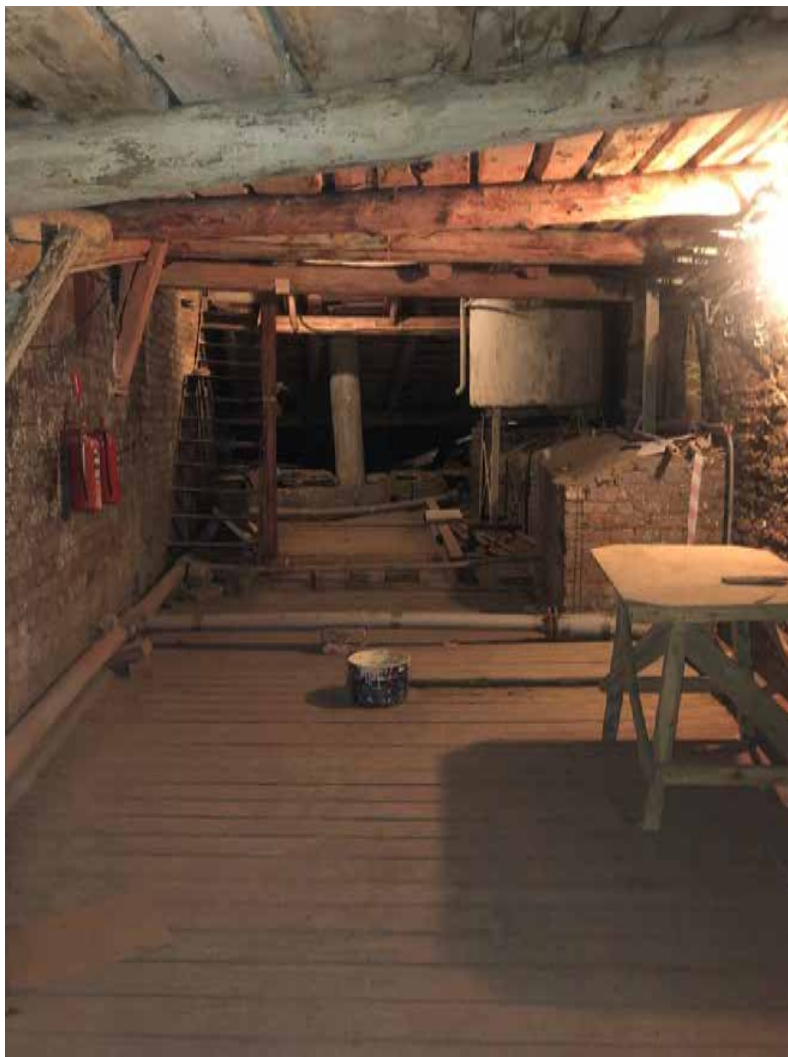
Фото 1. Вид северной центральной части чердачного помещения.
