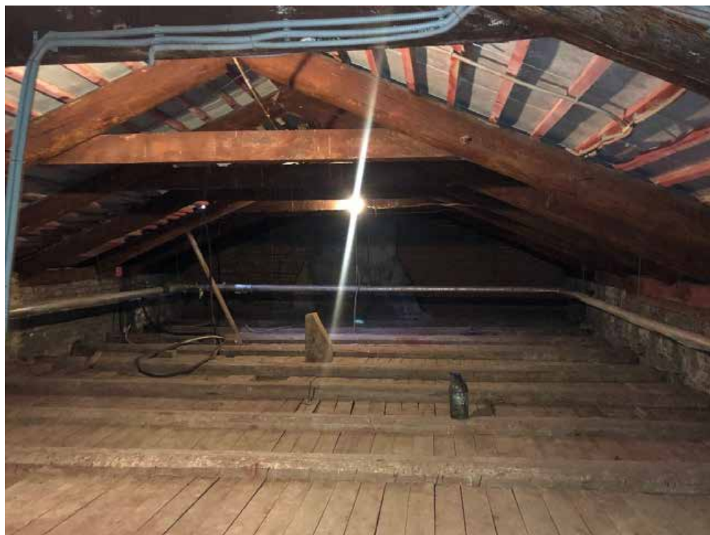
Фото 12. Юго-западное чердачное помещение.
