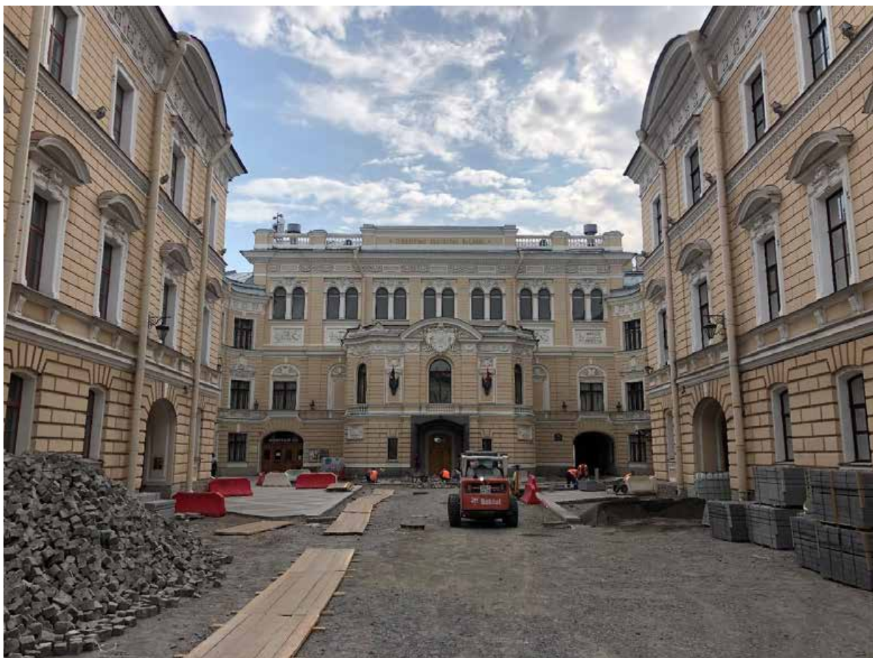
Фото 3. Лицевой фасад центрального корпуса.
