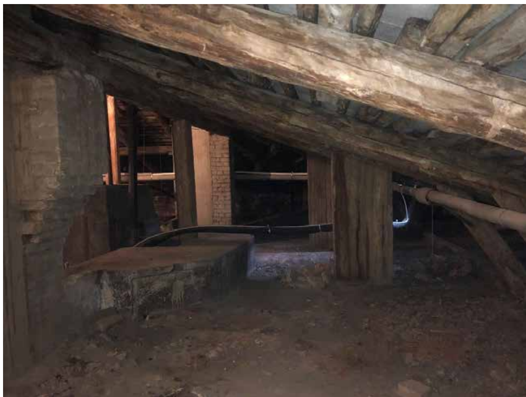
Фото 5. Северо-западная часть чердачного помещения. Вид на юг.
