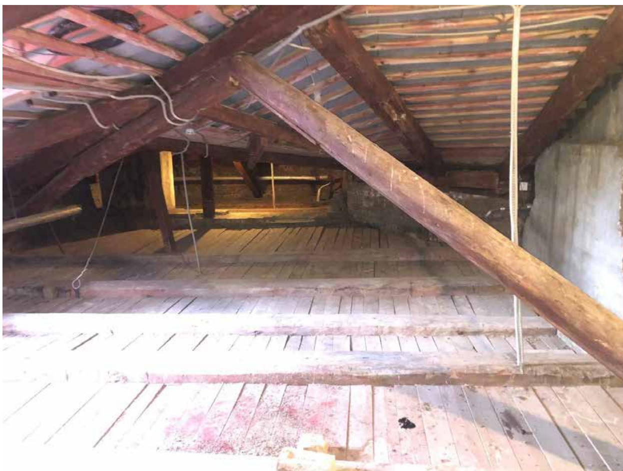
Фото 10. Юго-западное чердачное помещение. Вид на север.
