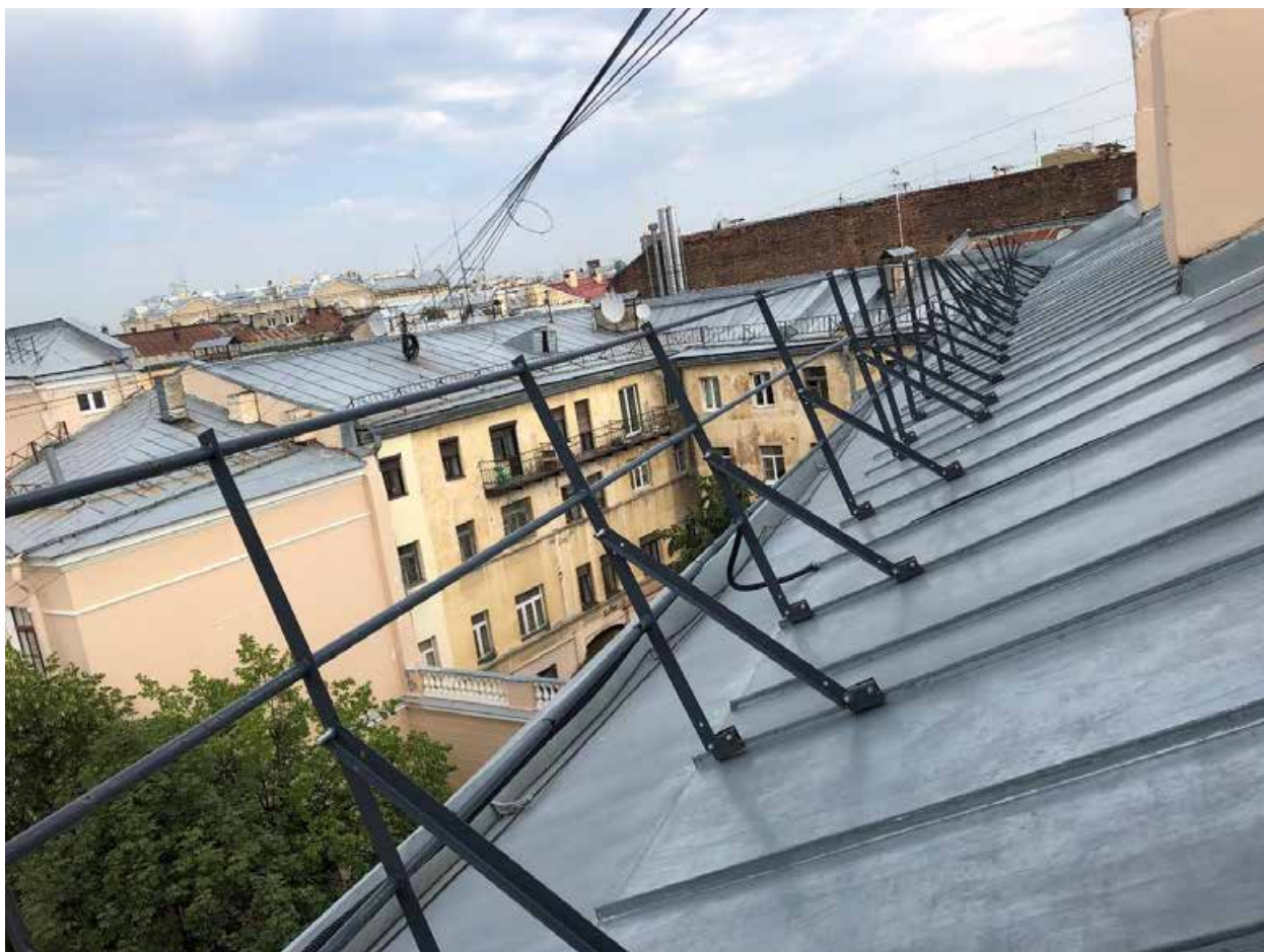
Фото 8. Вид на северо-восточный участок кровли.
