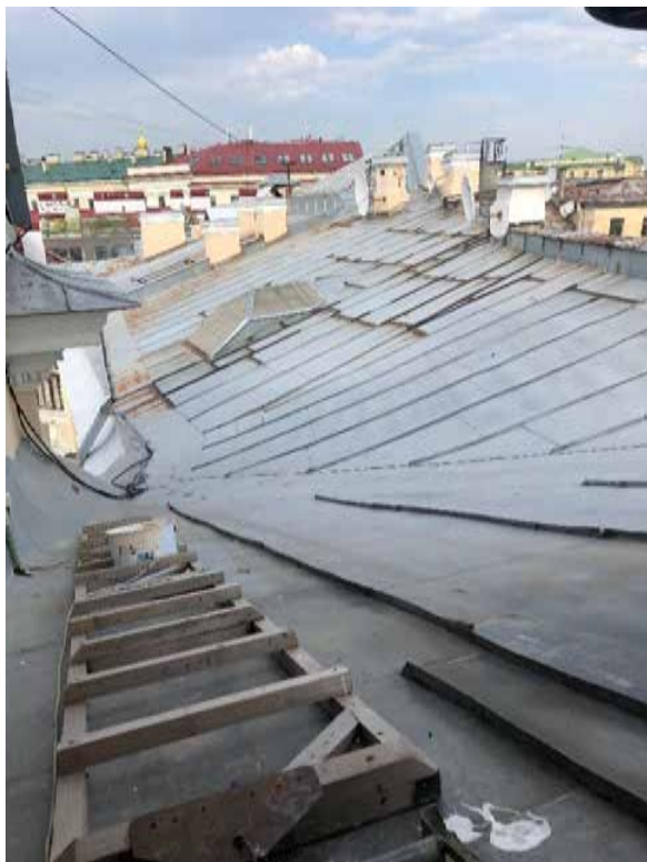
Фото 1. Северо-центральный участок кровли. Вид на световые фонари.
