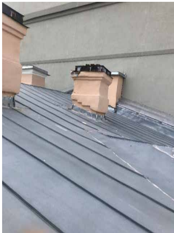
Фото 2. Юго-западный участок кровли.
