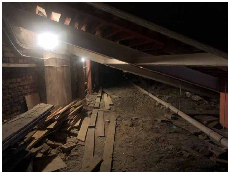
Фото 2. Вид с северо-западной части на восток.
