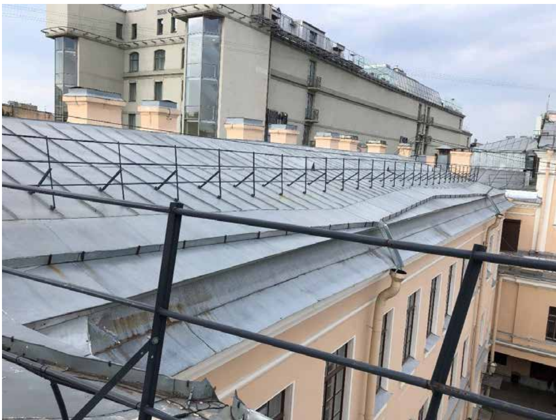
Фото 6. Вид на юго-восточный участок кровли.
