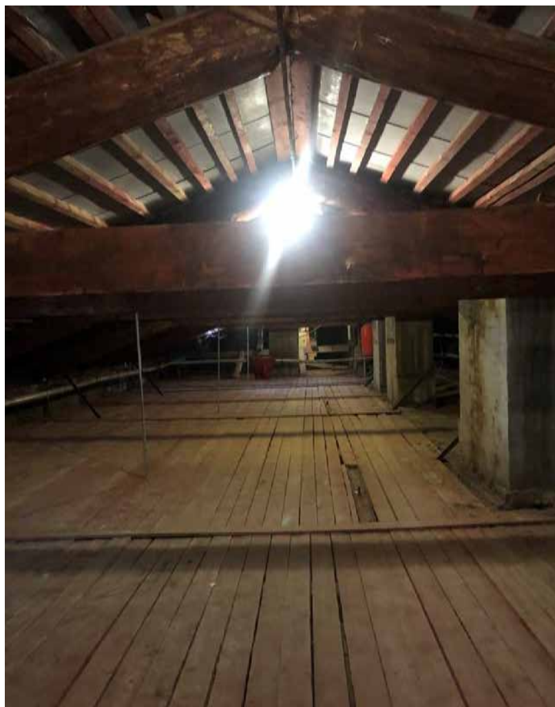
Фото 11. Юго-западное чердачное помещение. Вид на восток.
