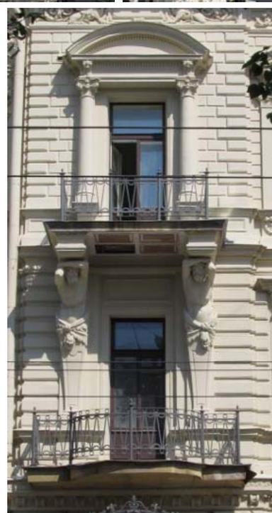
пять балконов в одну световую ось, на оштукатуренных кронштейнах, поддерживаемых гермами с торсом Геракла, в уровне 3-го этажа, с балконной плитой, декорированной в поле подшивки филенками;
