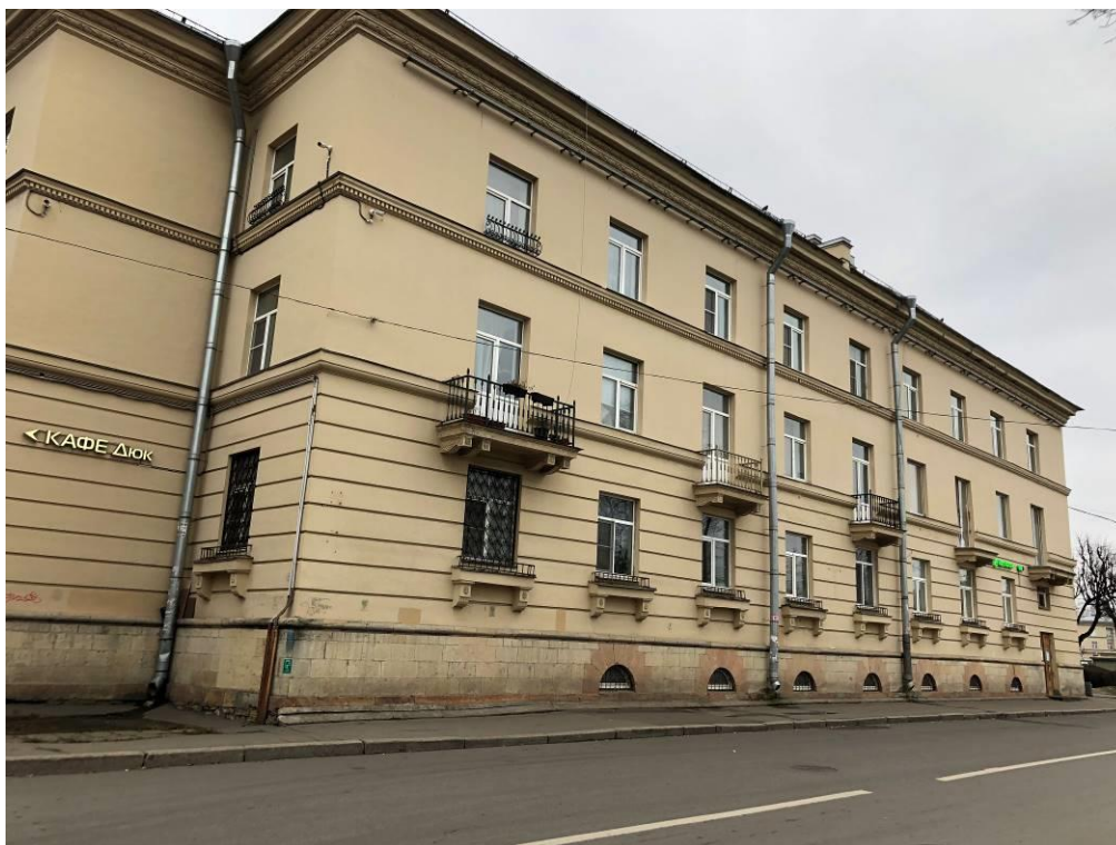
3. Объект культурного наследия регионального значения «Жилой дом», входящий в состав объекта культурного наследия регионального значения «Ансамбль Привокзальной площади: жилые дома (пять)», по адресу: Санкт-Петербург, Пушкинский район, г. Пушкин, Привокзальная пл., д. 2, литера А. Вид со стороны Железнодорожной улицы.
