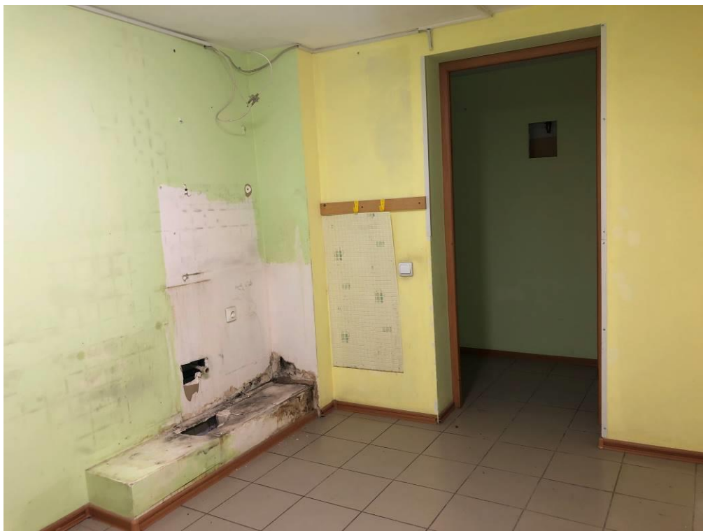
37. Объект культурного наследия регионального значения «Жилой дом», входящий в состав объекта культурного наследия регионального значения «Ансамбль Привокзальной площади: жилые дома (пять)», по адресу: Санкт-Петербург, Пушкинский район, г. Пушкин, Привокзальная пл., д. 2, литера А. Подвал здания (помещение 4-Н.3). Фрагмент интерьера.
