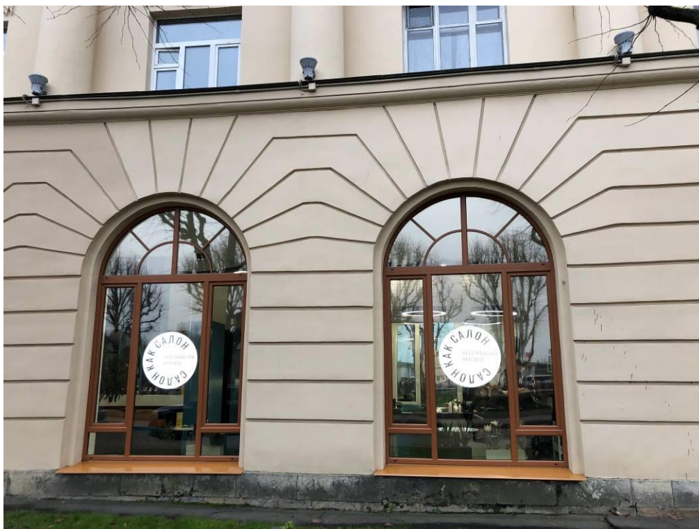
16. Объект культурного наследия регионального значения «Жилой дом», входящий в состав объекта культурного наследия регионального значения «Ансамбль Привокзальной площади: жилые дома (пять)», по адресу: Санкт-Петербург, Пушкинский район, г. Пушкин, Привокзальная пл., д. 2, литера А. Фрагмент фасада со стороны Привокзальной площади. Оформление оконных проемов.
