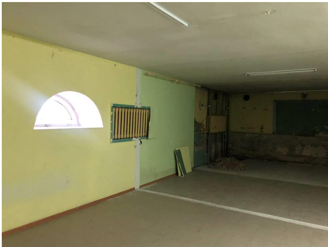
31. Объект культурного наследия регионального значения «Жилой дом», входящий в состав объекта культурного наследия регионального значения «Ансамбль Привокзальной площади: жилые дома (пять)», по адресу: Санкт-Петербург, Пушкинский район, г. Пушкин, Привокзальная пл., д. 2, литера А. Подвал здания (помещение 12-Н.1). Общий вид.
