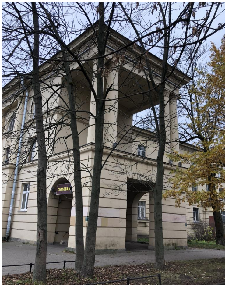
13. Объект культурного наследия регионального значения «Жилой дом», входящий в состав объекта культурного наследия регионального значения «Ансамбль Привокзальной площади: жилые дома (пять)», по адресу: Санкт-Петербург, Пушкинский район, г. Пушкин, Привокзальная пл., д. 2, литера А. Лоджия с колоннами на углу Софийского бульвара и Привокзальной площади.
