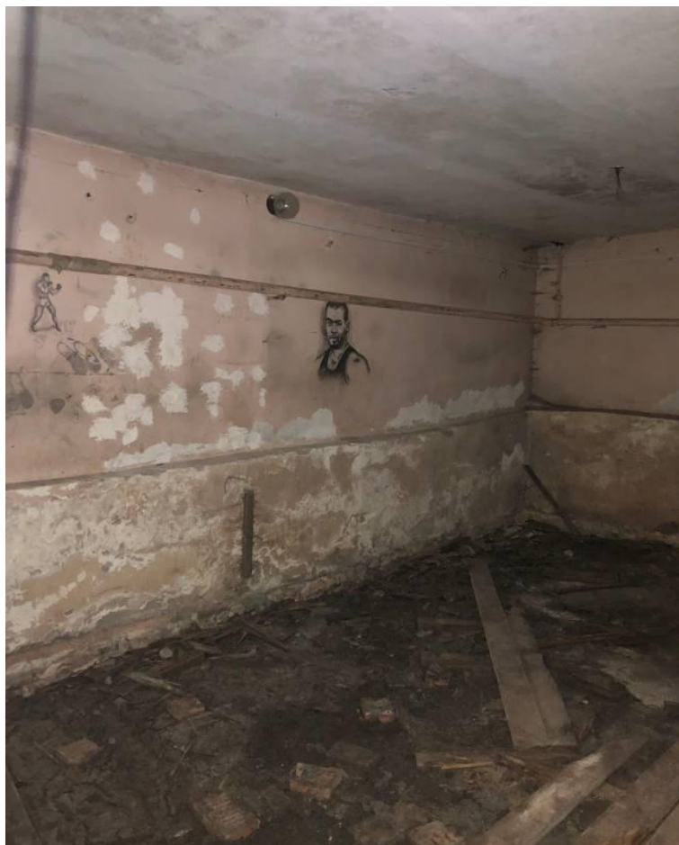
36. Объект культурного наследия регионального значения «Жилой дом», входящий в состав объекта культурного наследия регионального значения «Ансамбль Привокзальной площади: жилые дома (пять)», по адресу: Санкт-Петербург, Пушкинский район, г. Пушкин, Привокзальная пл., д. 2, литера А. Подвал здания (помещение 13-Н.5). Фрагмент интерьера.
