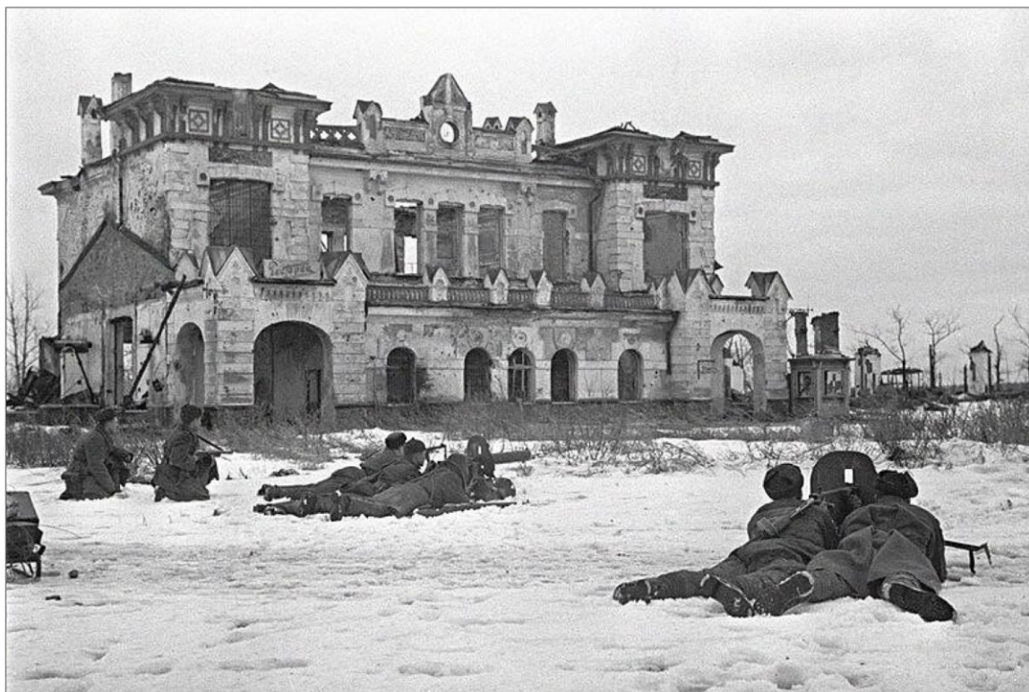
15. г. Пушкин. Разрушенное здания вокзала во время боевых действий Великой Отечественной войны (1941-1945 гг.). Фотография.
