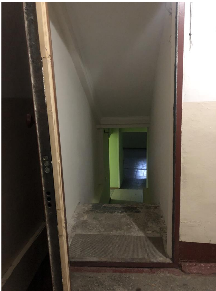
30. Объект культурного наследия регионального значения «Жилой дом», входящий в состав объекта культурного наследия регионального значения «Ансамбль Привокзальной площади: жилые дома (пять)», по адресу: Санкт-Петербург, Пушкинский район, г. Пушкин, Привокзальная пл., д. 2, литера А. Подвал здания (помещение 4-Н). Лестничная клетка.
