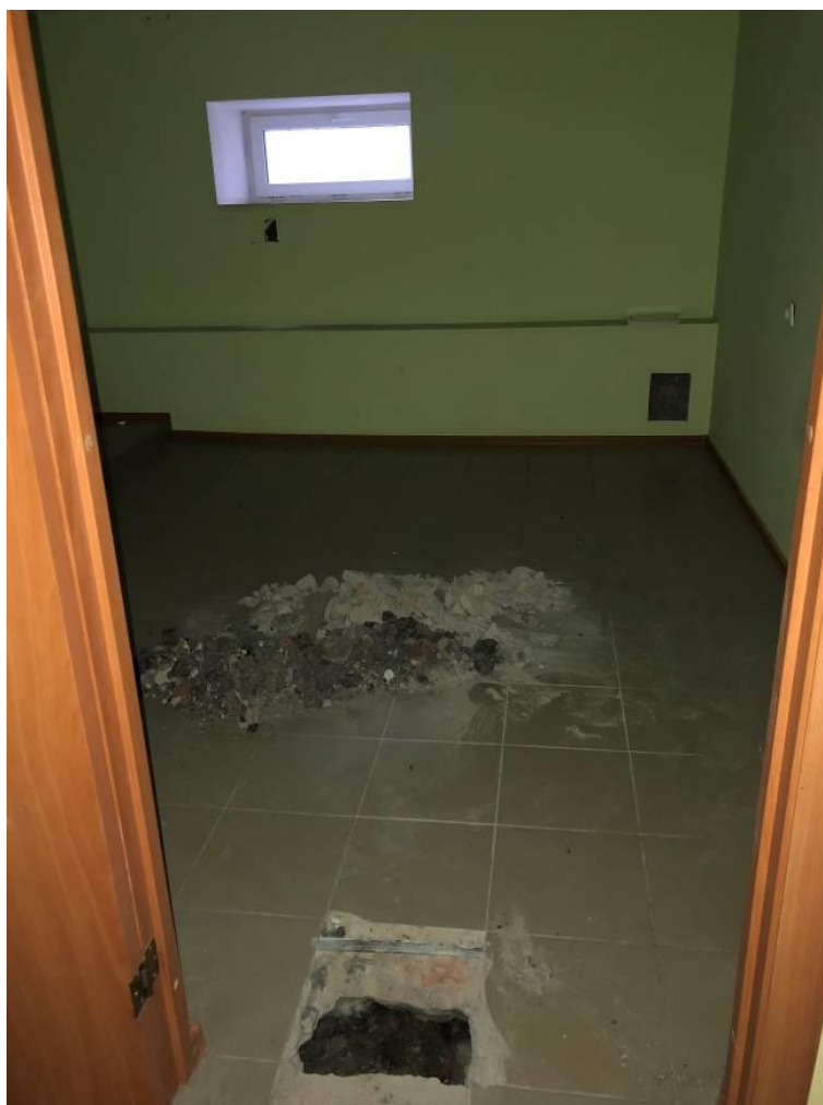
39. Объект культурного наследия регионального значения «Жилой дом», входящий в состав объекта культурного наследия регионального значения «Ансамбль Привокзальной площади: жилые дома (пять)», по адресу: Санкт-Петербург, Пушкинский район, г. Пушкин, Привокзальная пл., д. 2, литера А. Подвал здания (помещение 4-Н.4). Фрагмент интерьера.
