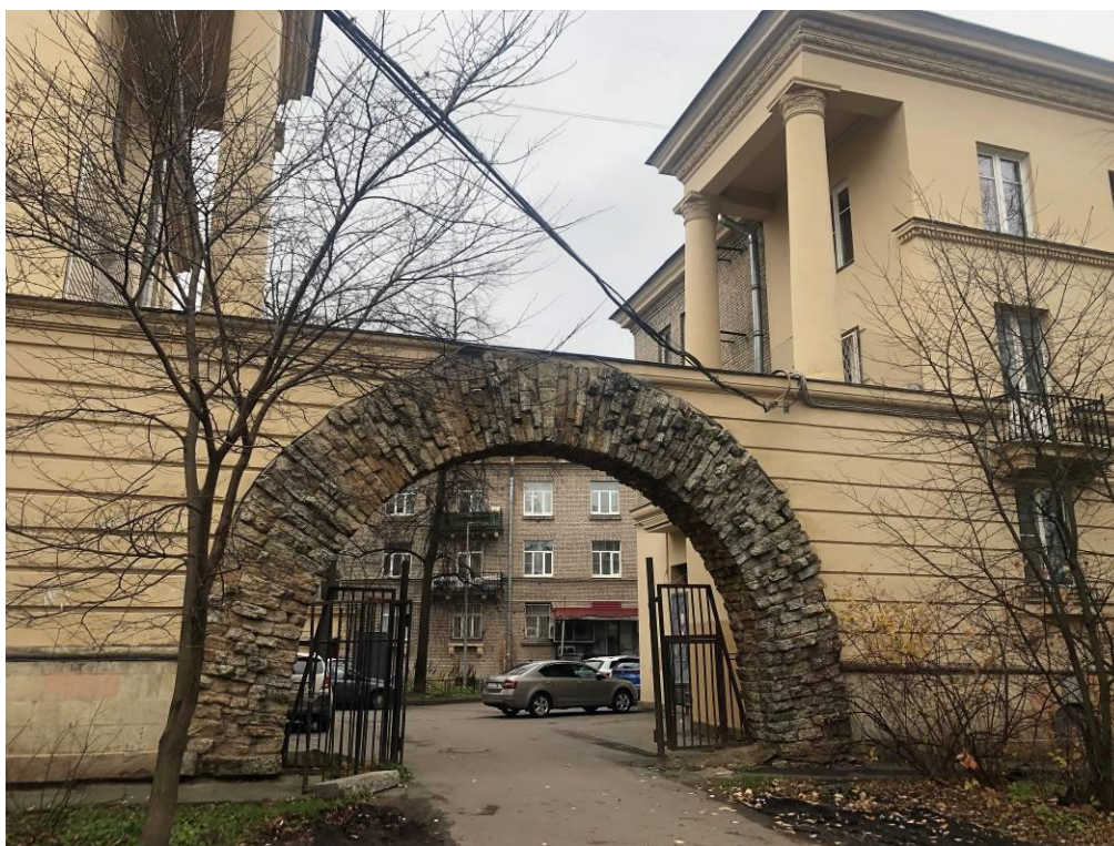
7. Объект культурного наследия регионального значения «Жилой дом», входящий в состав объекта культурного наследия регионального значения «Ансамбль Привокзальной площади: жилые дома (пять)», по адресу: Санкт-Петербург, Пушкинский район, г. Пушкин, Привокзальная пл., д. 2, литера А. Воротный проезд со стороны Новодеревенской улицы. Ограда двора с полуциркульной аркой, облицованной известняком с металлическими воротами.
