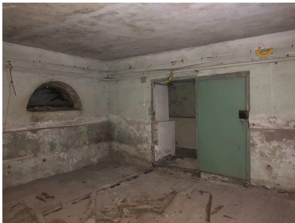
34. Объект культурного наследия регионального значения «Жилой дом», входящий в состав объекта культурного наследия регионального значения «Ансамбль Привокзальной площади: жилые дома (пять)», по адресу: Санкт-Петербург, Пушкинский район, г. Пушкин, Привокзальная пл., д. 2, литера А. Подвал здания (помещение 13-Н.4). Фрагмент интерьера.
