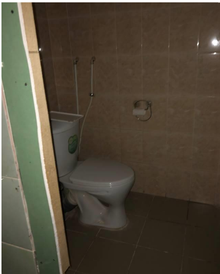
42. Объект культурного наследия регионального значения «Жилой дом», входящий в состав объекта культурного наследия регионального значения «Ансамбль Привокзальной площади: жилые дома (пять)», по адресу: Санкт-Петербург, Пушкинский район, г. Пушкин, Привокзальная пл., д. 2, литера А. Подвал здания (помещение 4-Н.13). Санузел.
