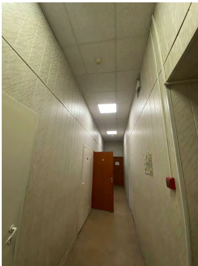
Фото №11. Коридор на первом этаже здания.
