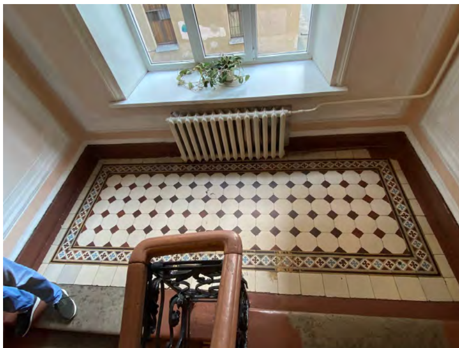
Фото №13. Покрытие пола междуэтажной площадки между 1 и 2 этажами.
