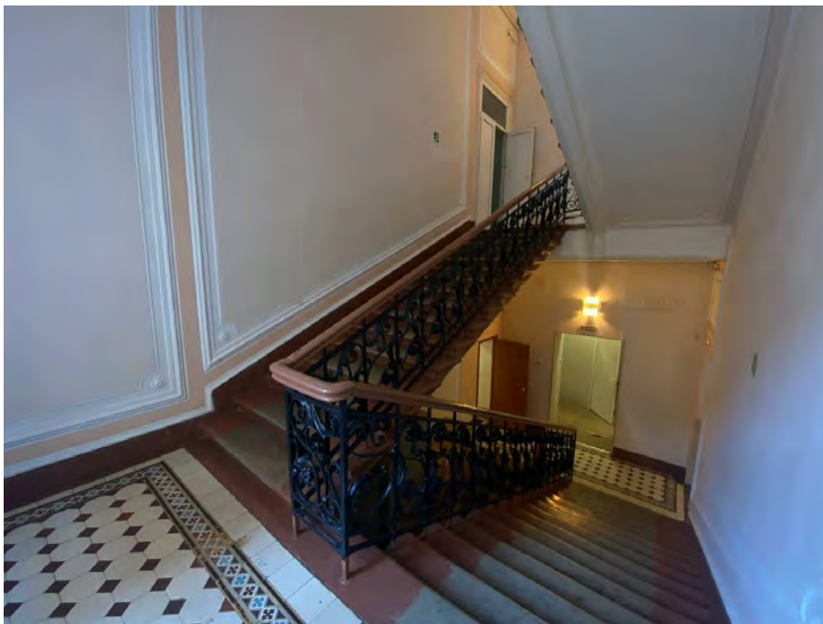
Фото №35. Парадная лестница, вид с междуэтажной площадки между 1 и 2 этажами.
