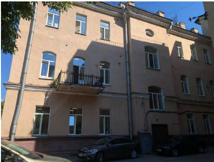
Фото №7. Западный фасад здания.
