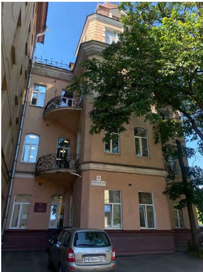
Фото №1. Лицевой северный фасад здания, вид с Большой Пороховской улицы.
