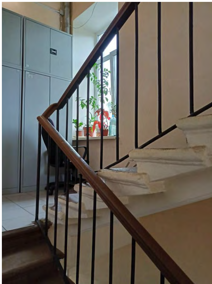
Фото №37. Запасная лестница, лестничная площадка второго этажа.
