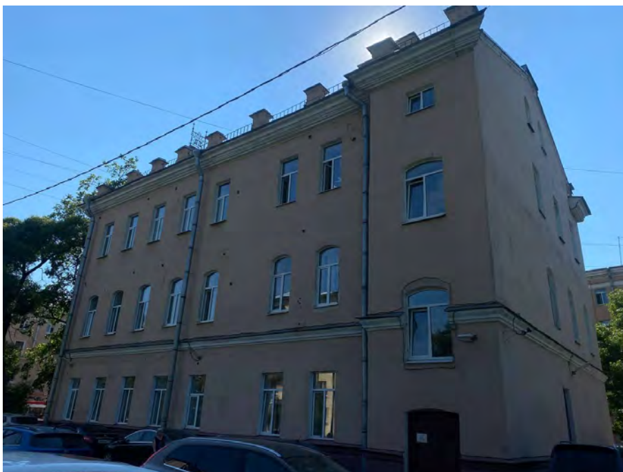
Фото №5. Восточный фасад здания.
