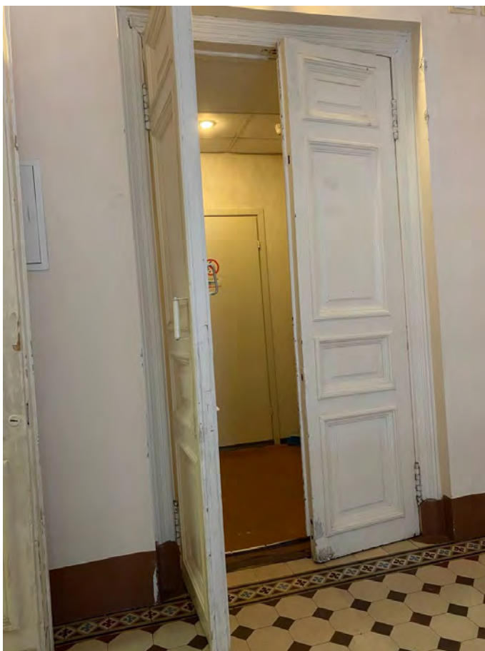
Фото №33. Оформление дверных проемов на третьем этаже.
