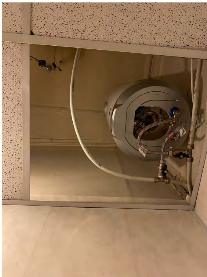
Фото №15. Оформление потолка в санузле третьего этажа.
