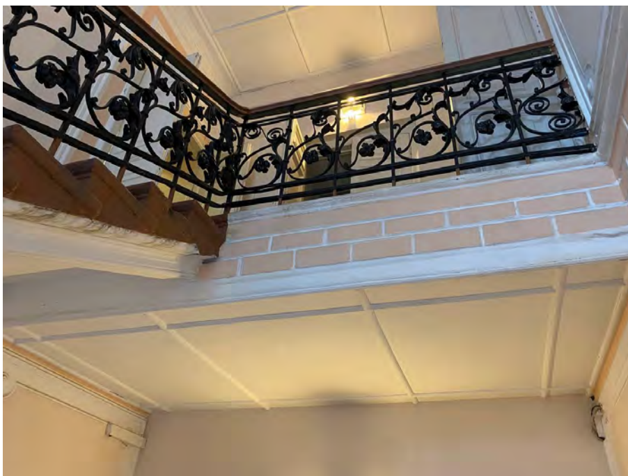
Фото №31. Лестничная площадка третьего этажа.
