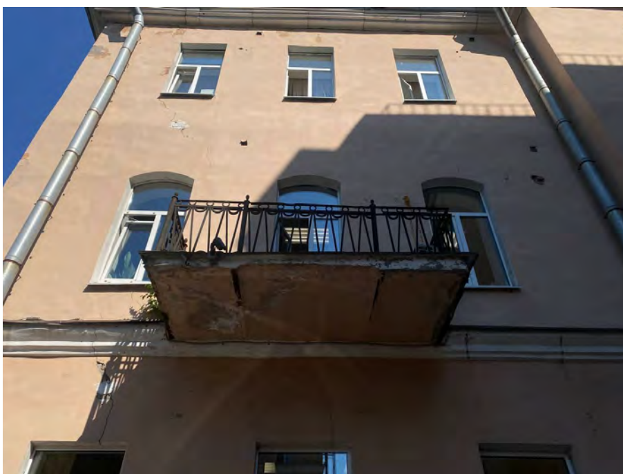
Фото №8. Балкон на западном фасаде здания.
