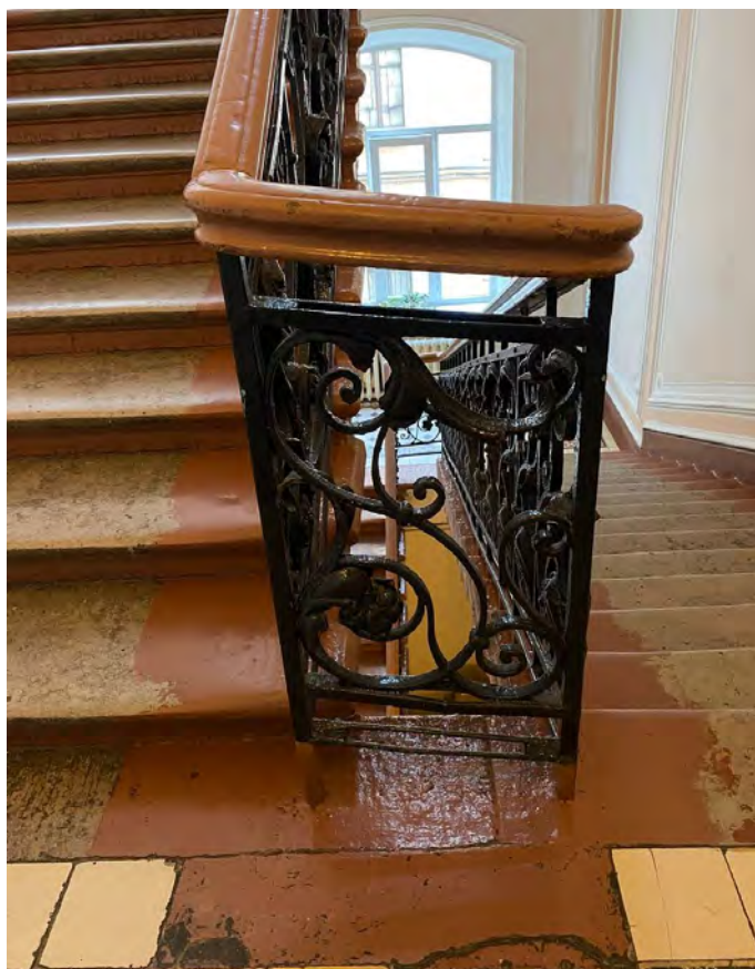
Фото №27. Металлическое ограждение парадной лестницы.
