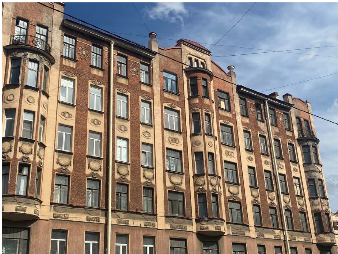
5. Вид на лицевой фасад со стороны 8-ой линии В.О.
