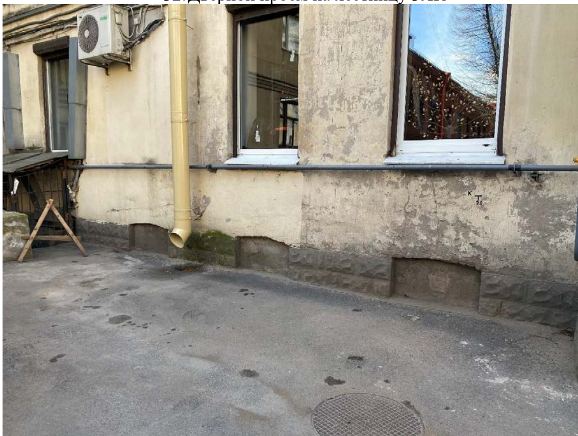
33. Фрагмент дворового фасада
