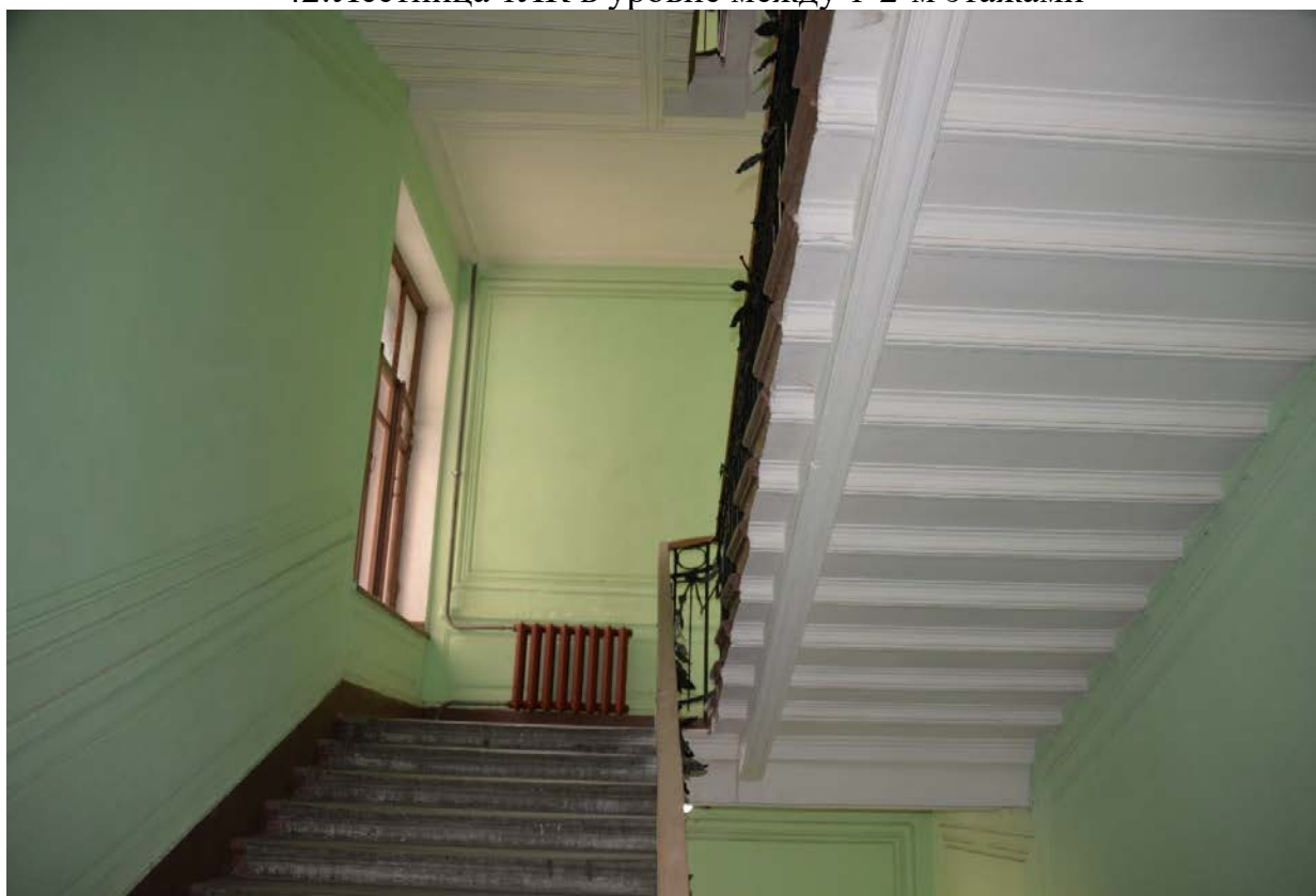
43. Лестница 1ЛК в уровне между 2-3-м этажами
