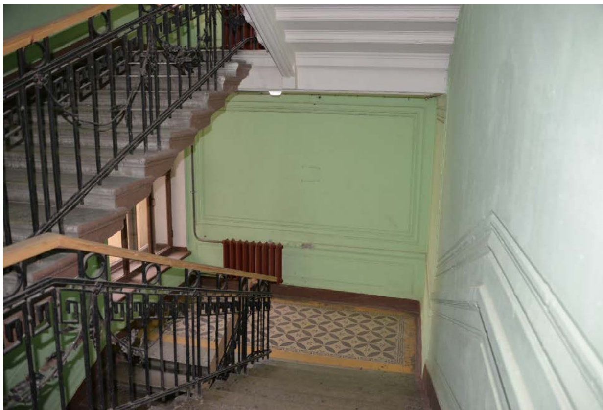
42. Лестница 1ЛК в уровне между 1-2-м этажами
