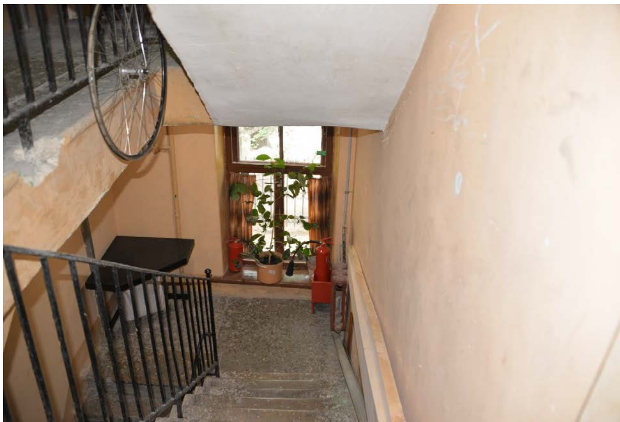
67. Лестница 4ЛК в уровне между 1-2-м этажами
