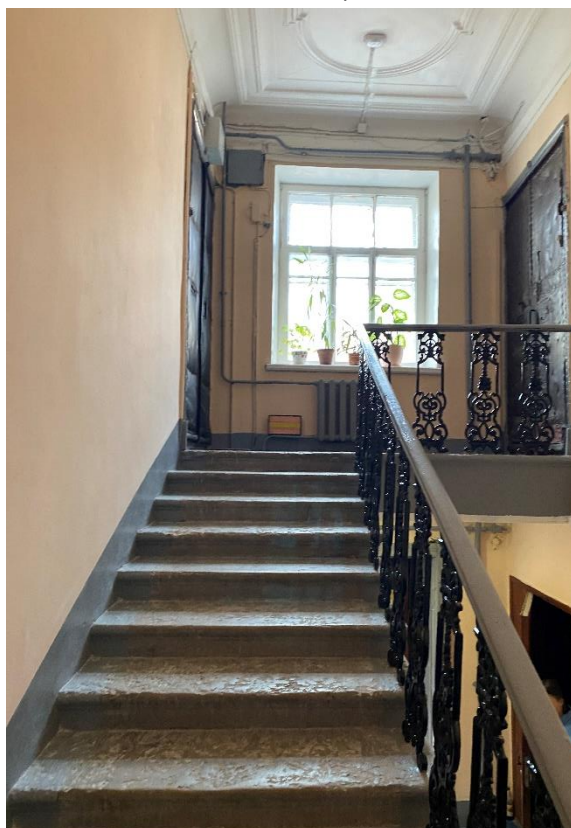
72. Лестница 5ЛК в уровне 2-го этажа
