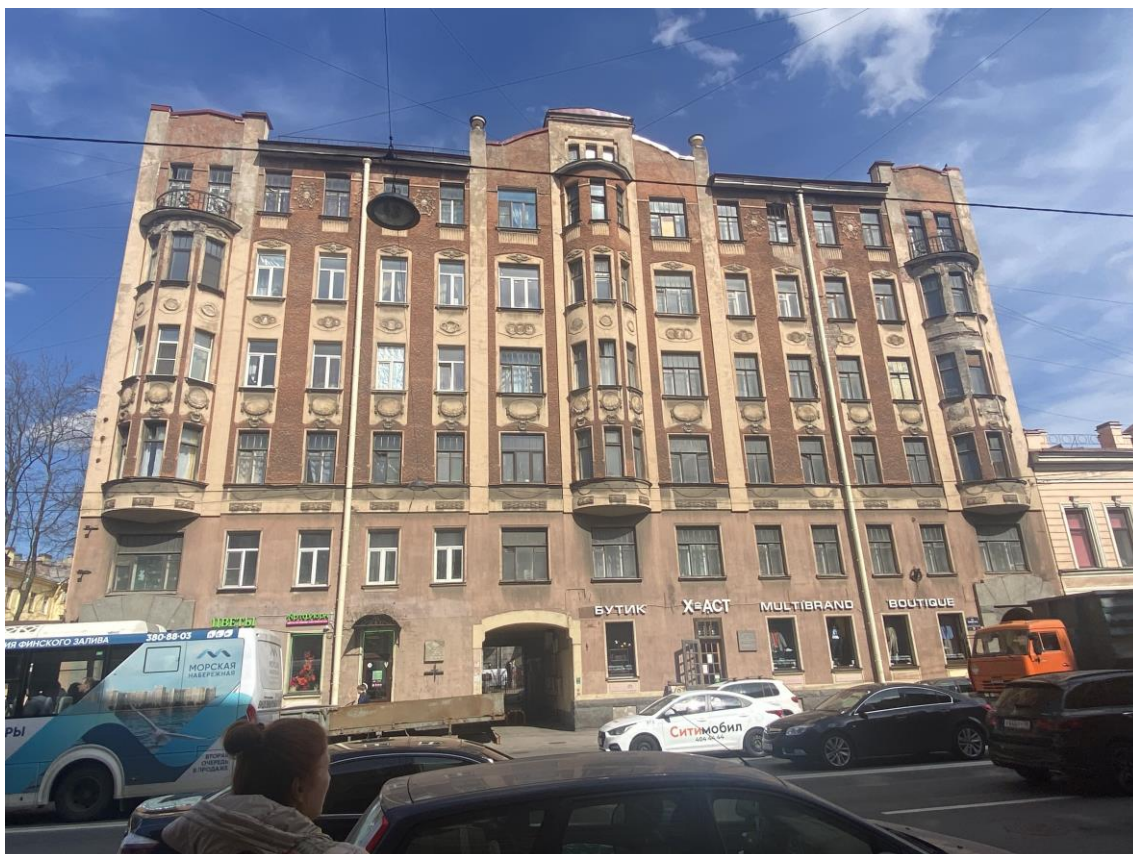
3. Вид на лицевой фасад со стороны 8-ой линии В.О.
