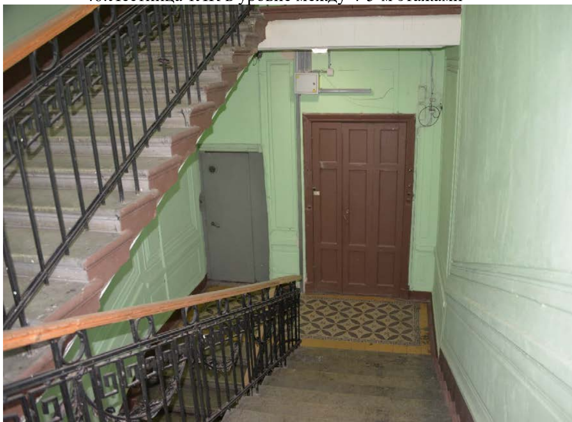
47. Лестница 1ЛК в уровне 5-го этажа
