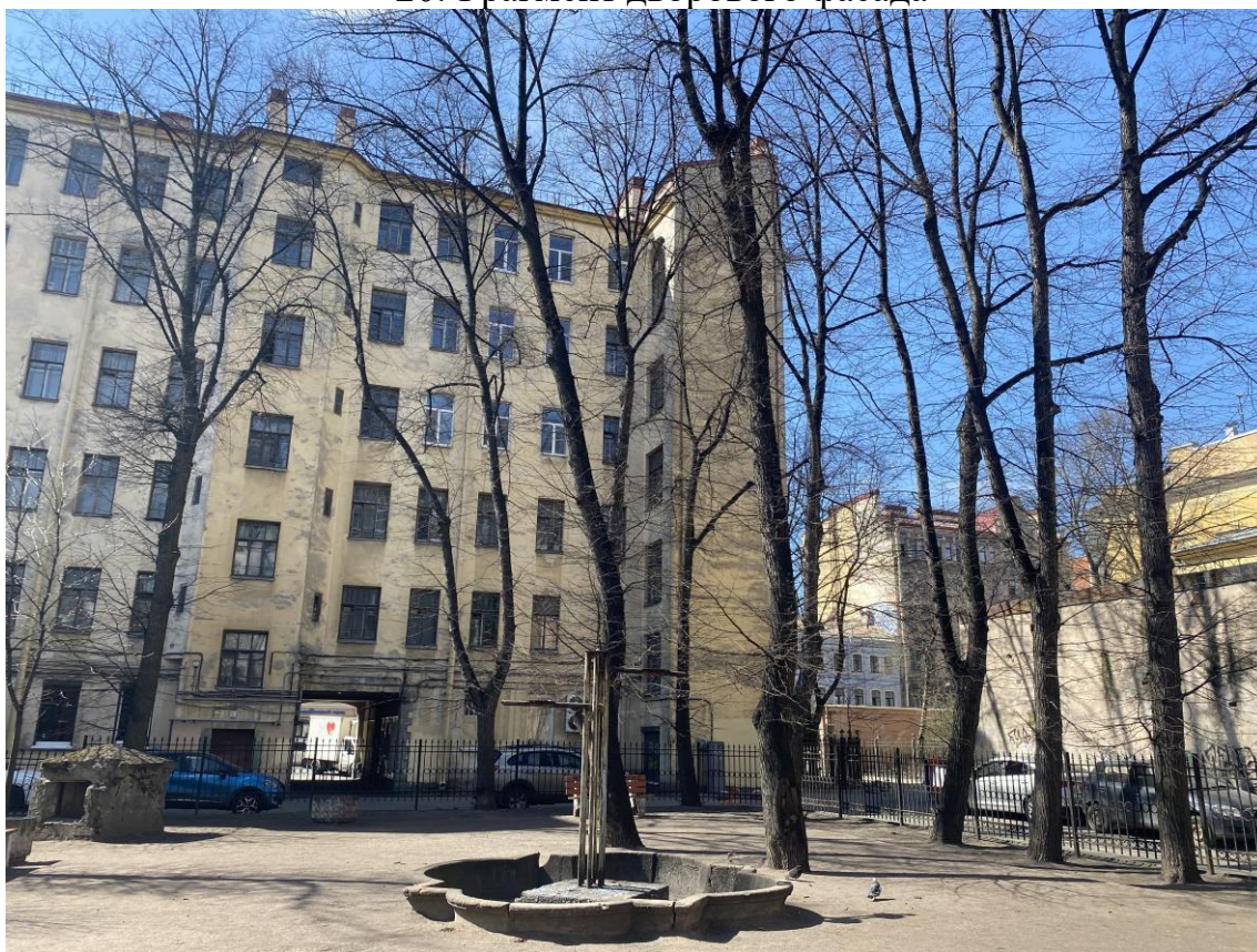
21. Фрагмент дворового фасада с садиком.
