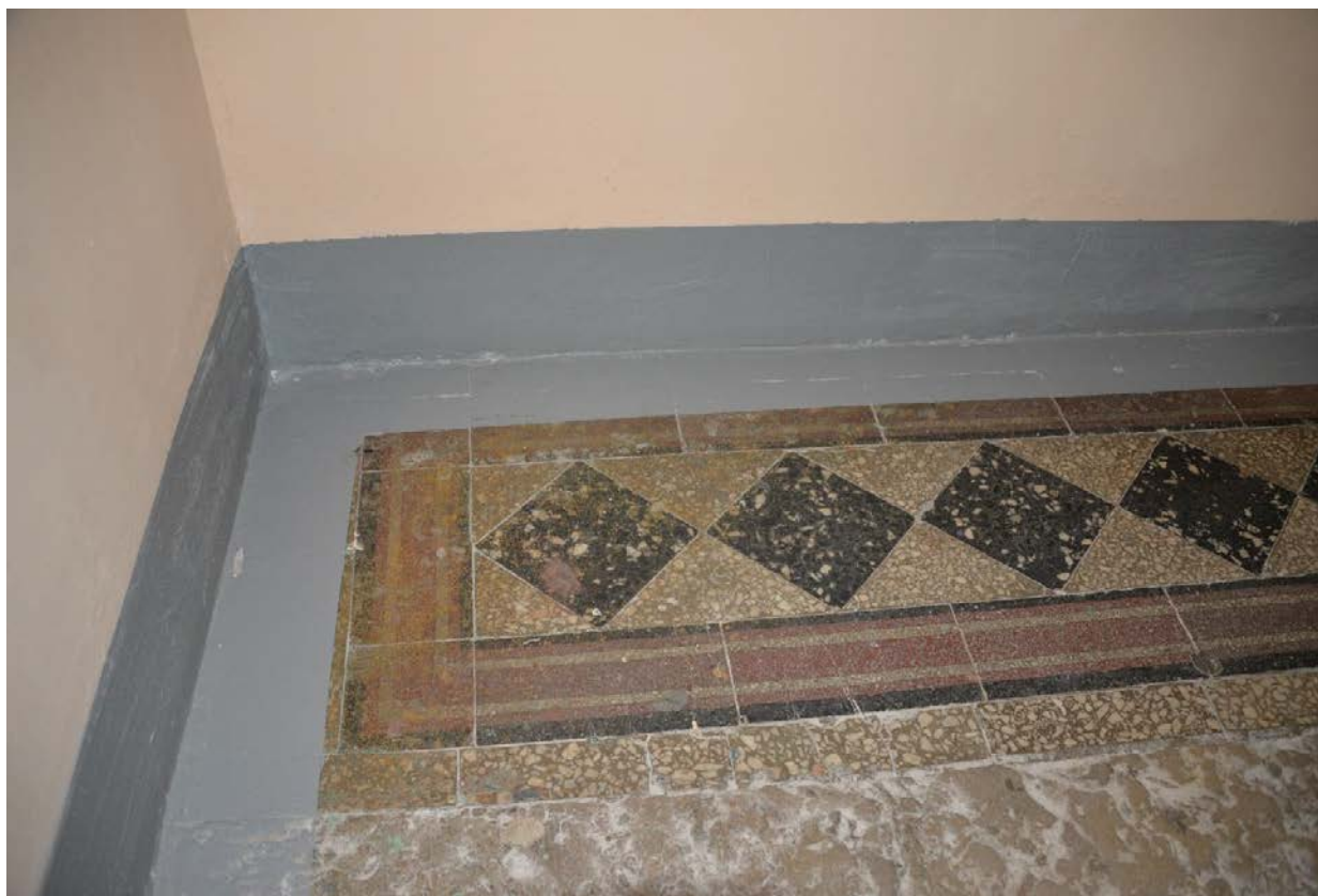
71. Напольное покрытие лестницы 5ЛК
