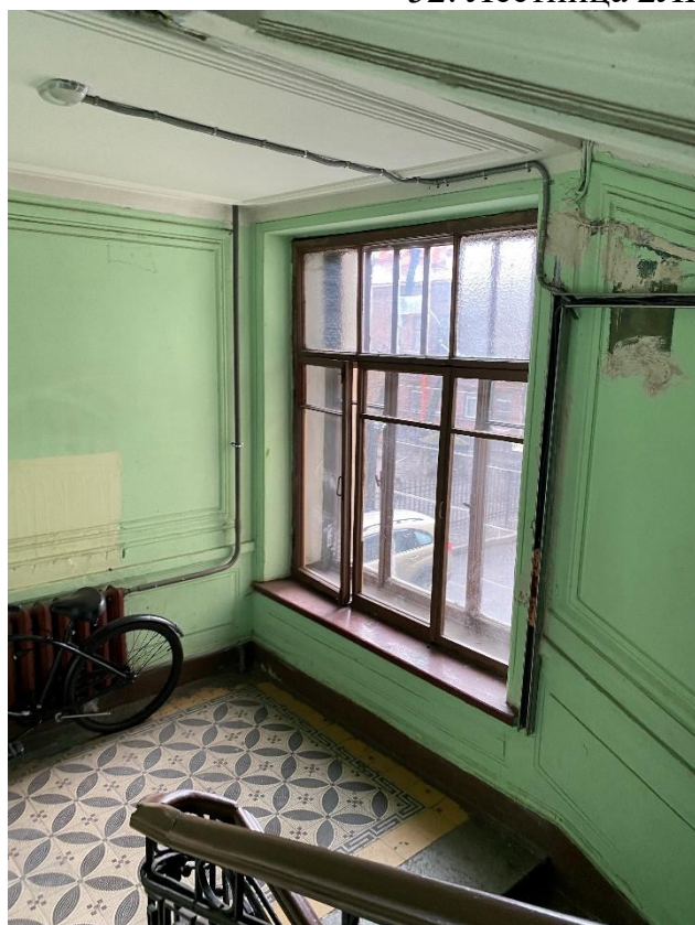
53. Лестница 2ЛК в уровне между 1-2-м этажами
