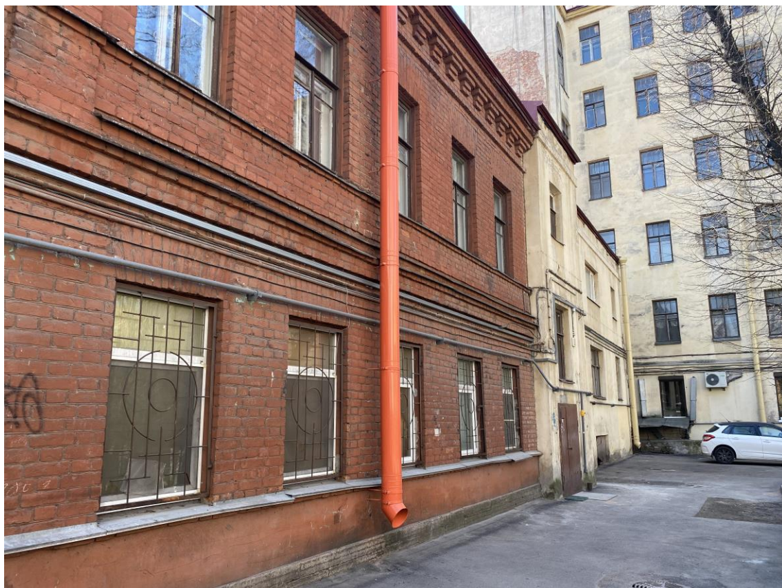
26. Фрагмент фасада дворового двухэтажного флигеля.
