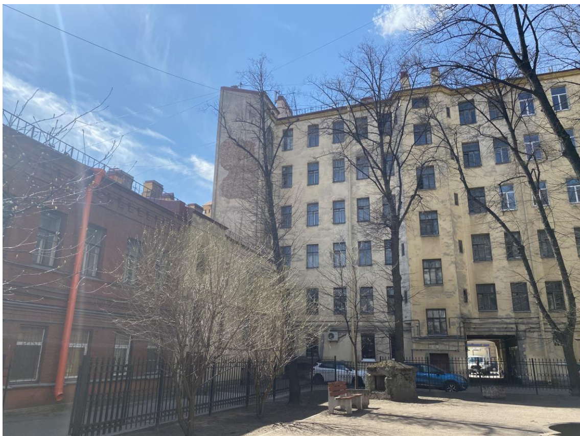
22. Фрагмент дворового фасада с садиком.
