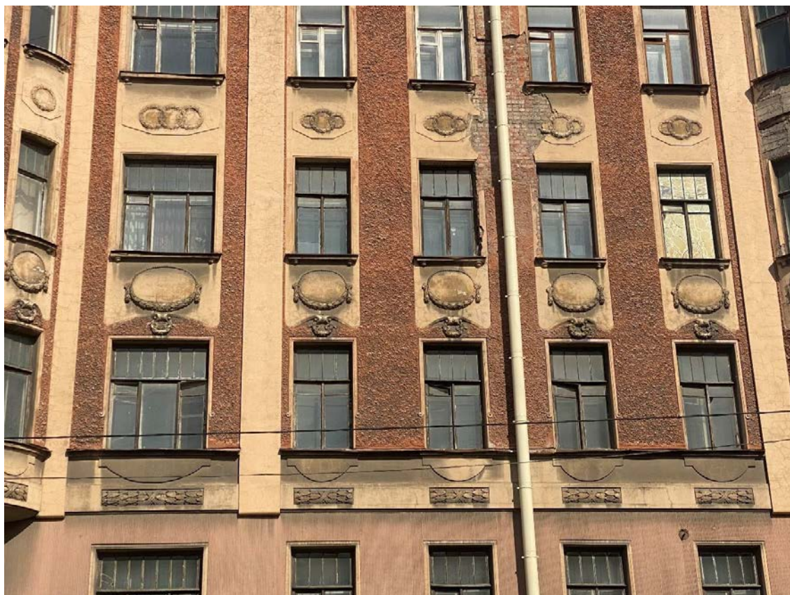
7. Фрагмент лицевого фасада со стороны 8-ой линии В.О.
