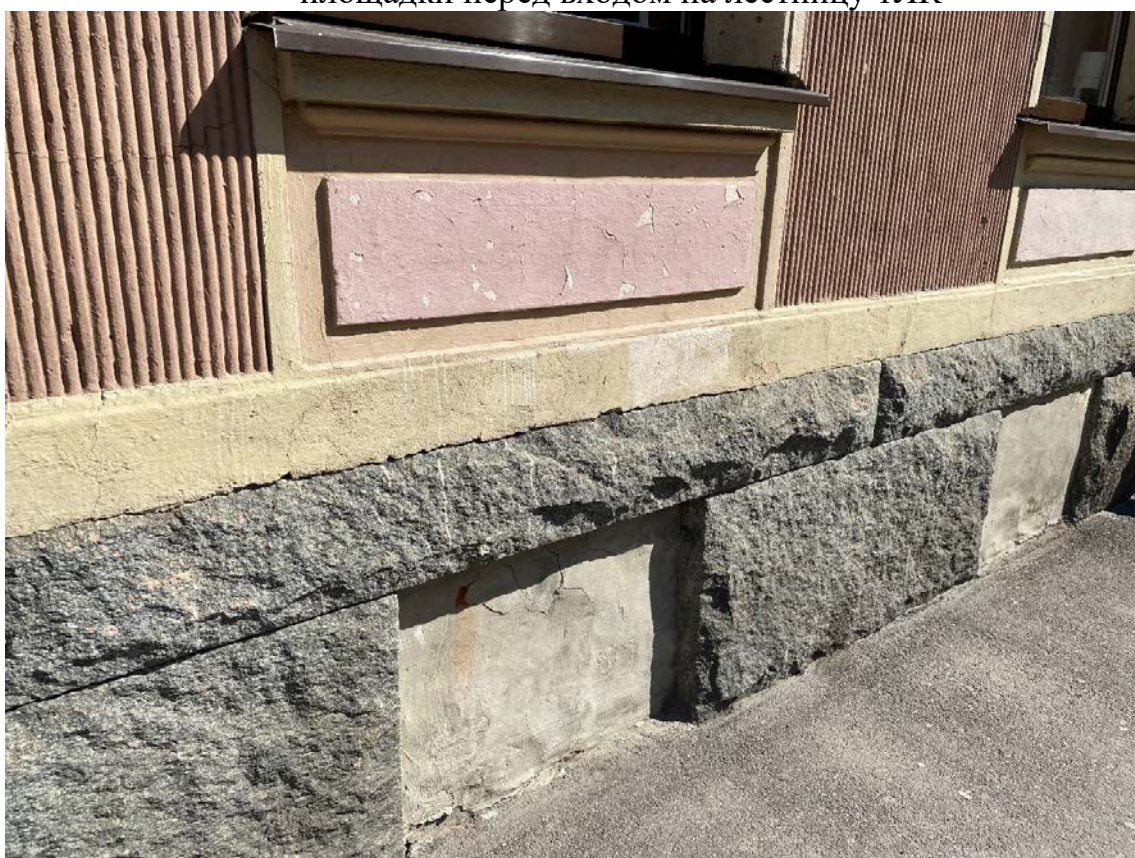
15. Фрагмент лицевого фасада со стороны 8-ой линии В.О. Цоколь
