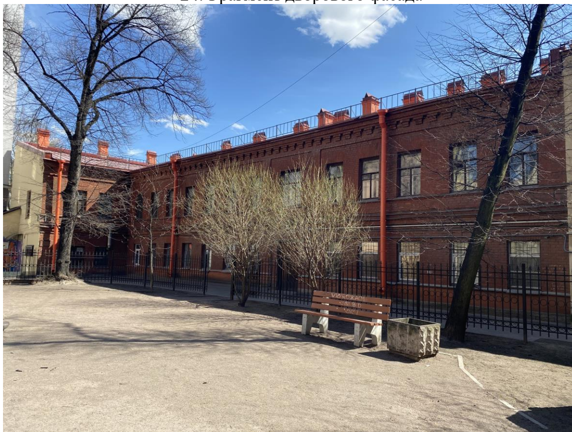
25. Фрагмент фасада дворового двухэтажного флигеля.
