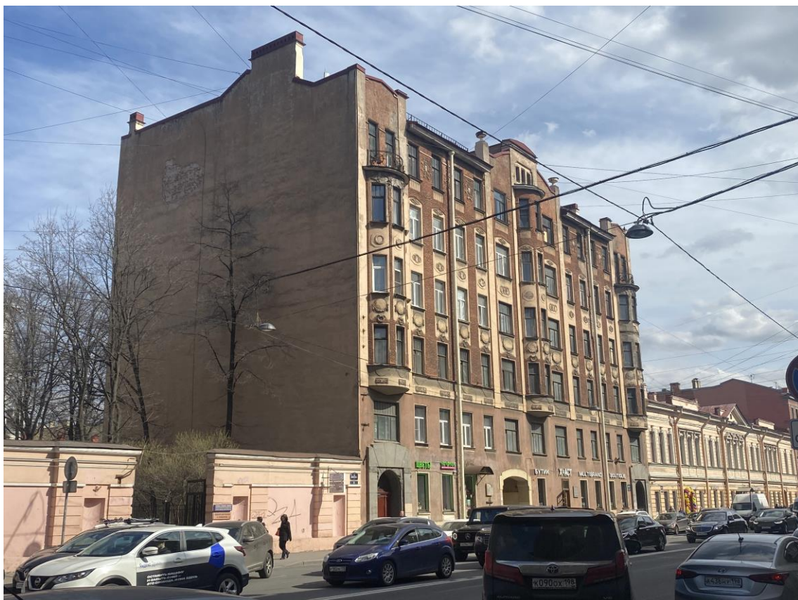
1. Вид на лицевой фасад со стороны 8-ой линии В.О.
