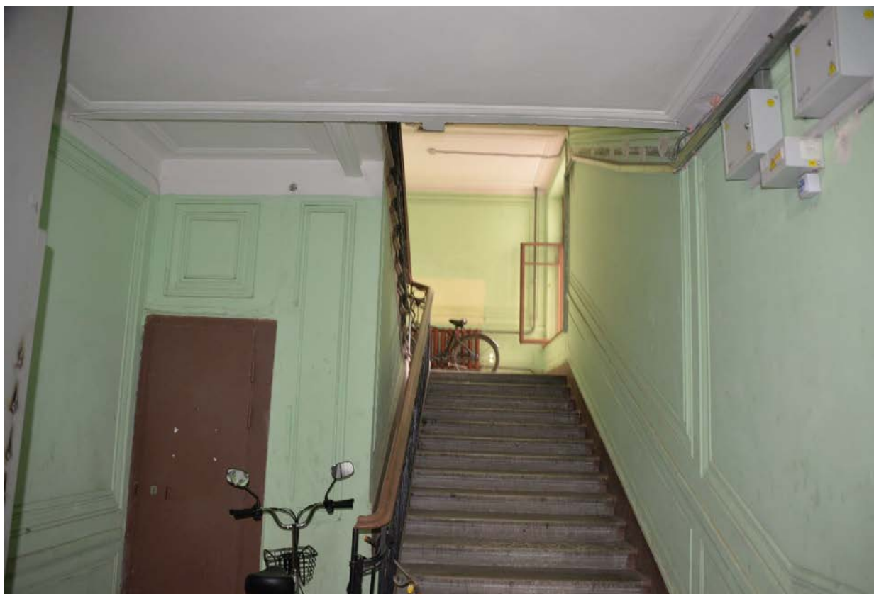
52. Лестница 2ЛК в уровне 1-го этажа
