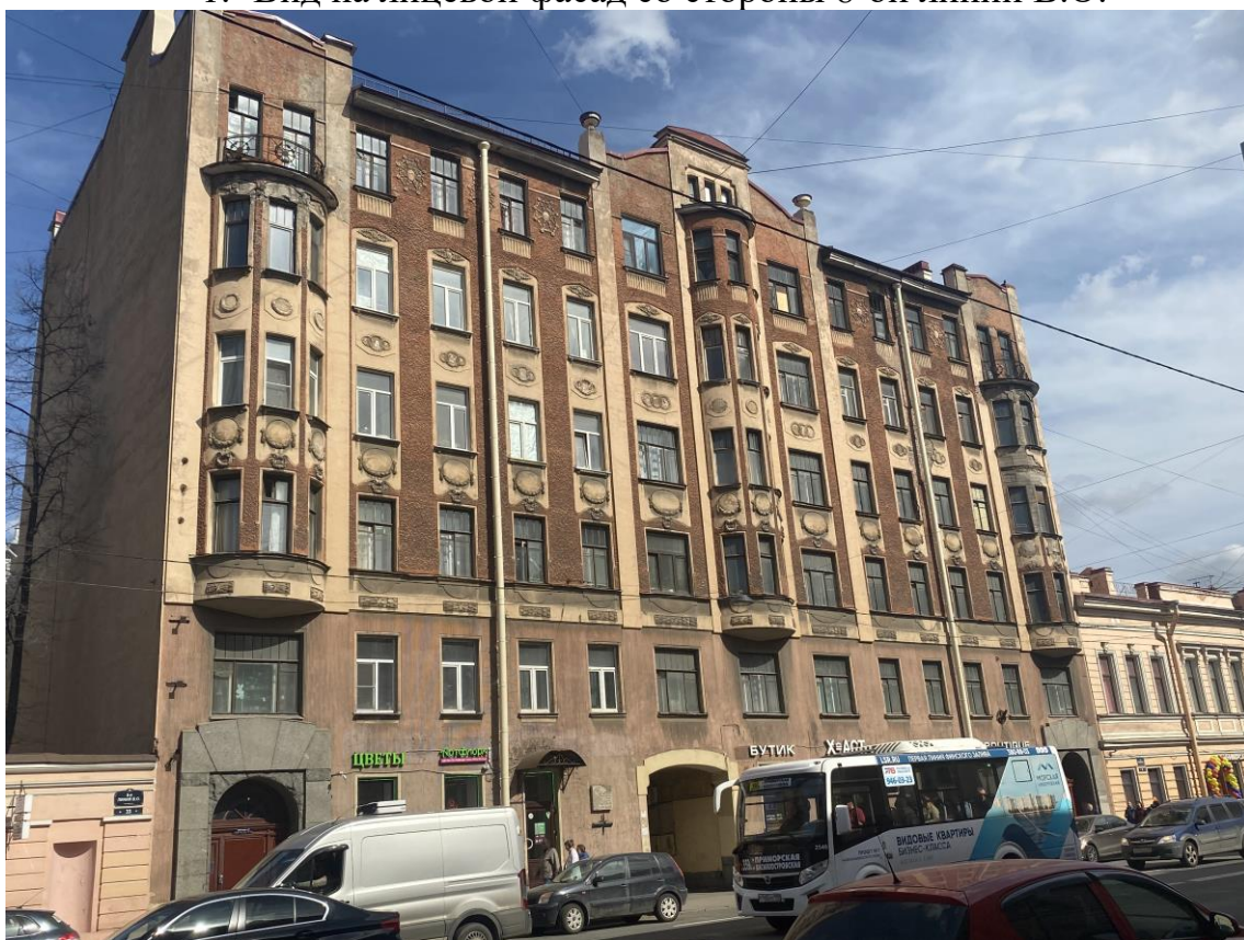
2. Вид на лицевой фасад со стороны 8-ой линии В.О.
