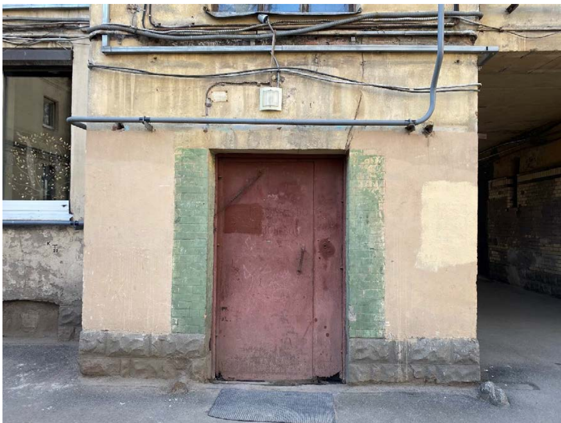
32. Дверной проем на лестницу ЗЛК
