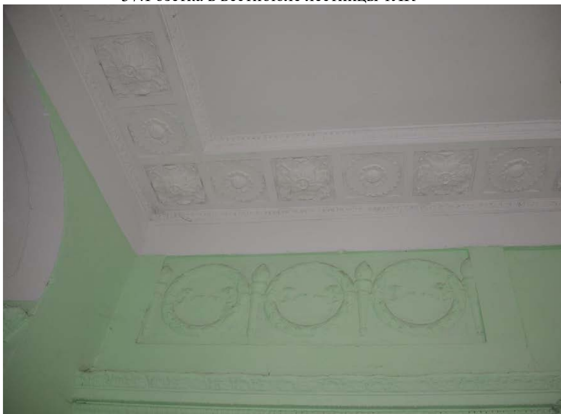
38. Декор стен и потолка в вестибюле лестницы 1ЛК
