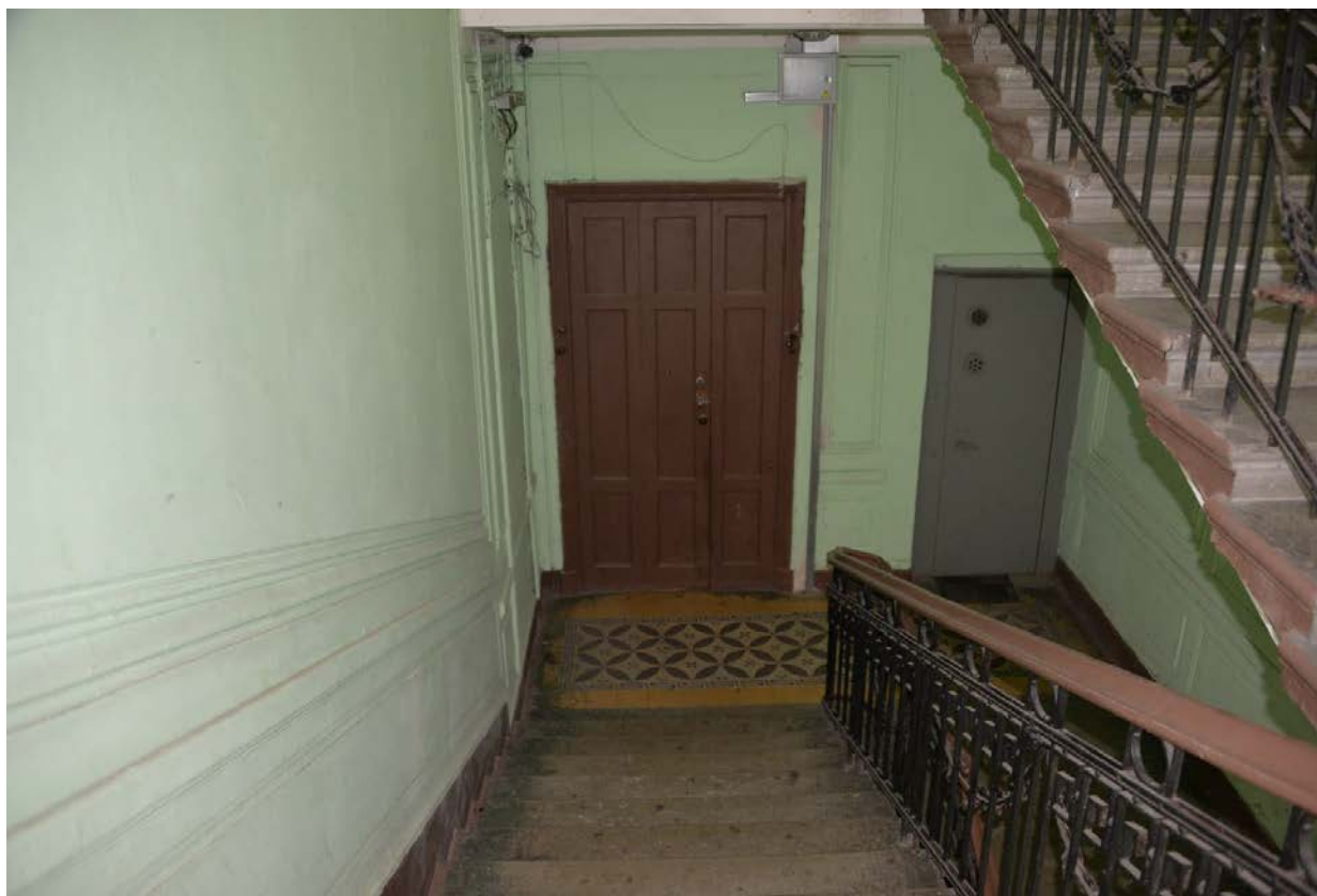
55. Лестница 2ЛК в уровне 2-го этажа
