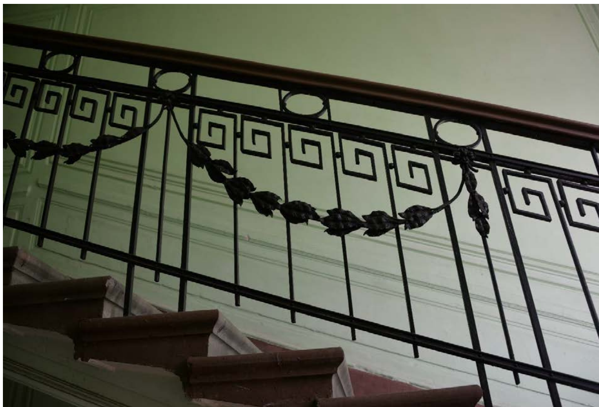
61. Ограждение лестницы 2ЛК
