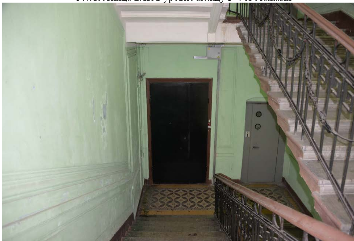
58. Лестница 2ЛК в уровне 4-го этажа
