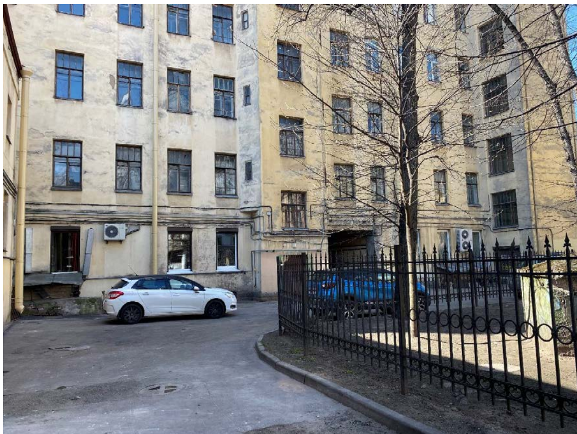
24. Фрагмент дворового фасада
