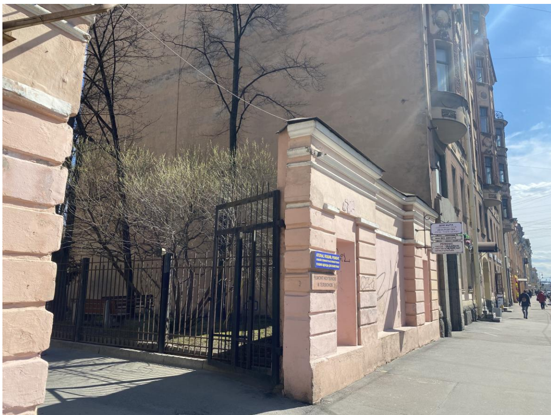
16. Ограждение, прилегающее к дому №31 со стороны дома №33.
