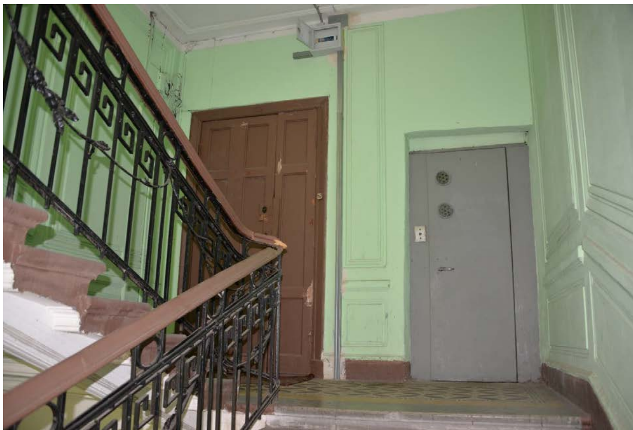
59. Лестница 2ЛК в уровне 5-го этажа
