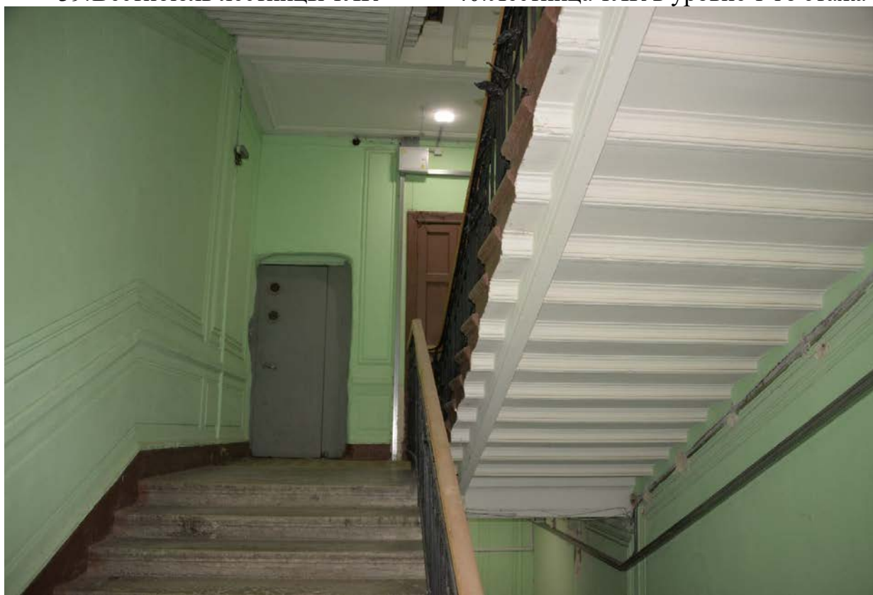
41. Лестница 1ЛК в уровне 2-го этажа
