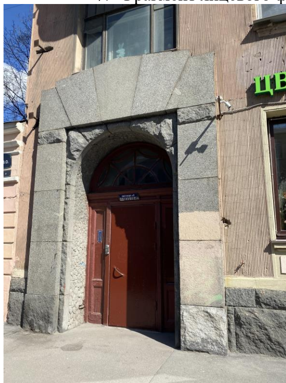
8. Фрагмент лицевого фасада со стороны 8-ой линии В.О. Исторический дверной проем на лестницу 2ЛК.
