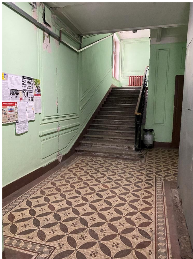
40. Лестница 1ЛК в уровне 1-го этажа
