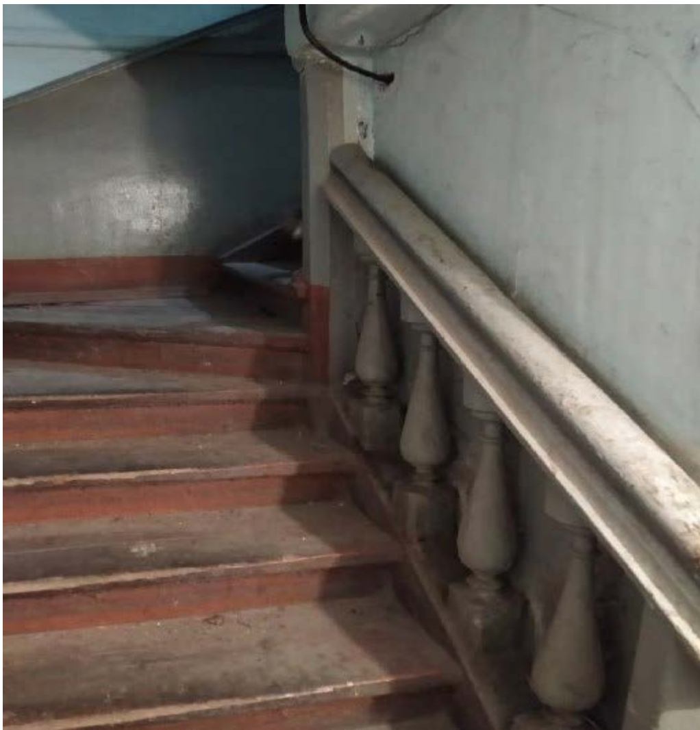
14. Межэтажная лестница с балюстрадным ограждением (пом. 1-Н (39,40). 03.06.2022
