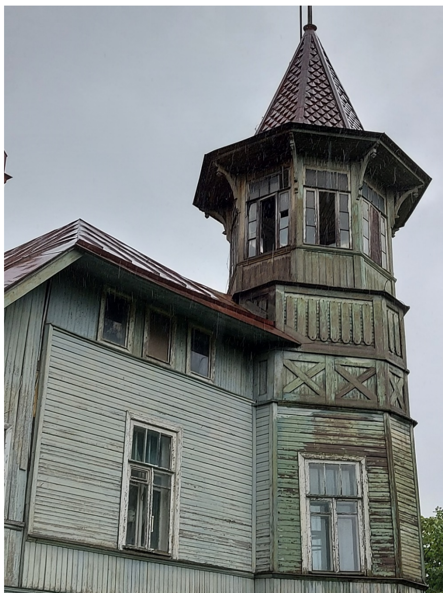
10. Верхняя часть башни и второй этаж северного фасада. 03.06.2022
