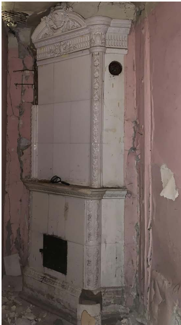
13. Печь в помещении 1-го этажа (пом. 1-Н (7)). 03.06.2022
