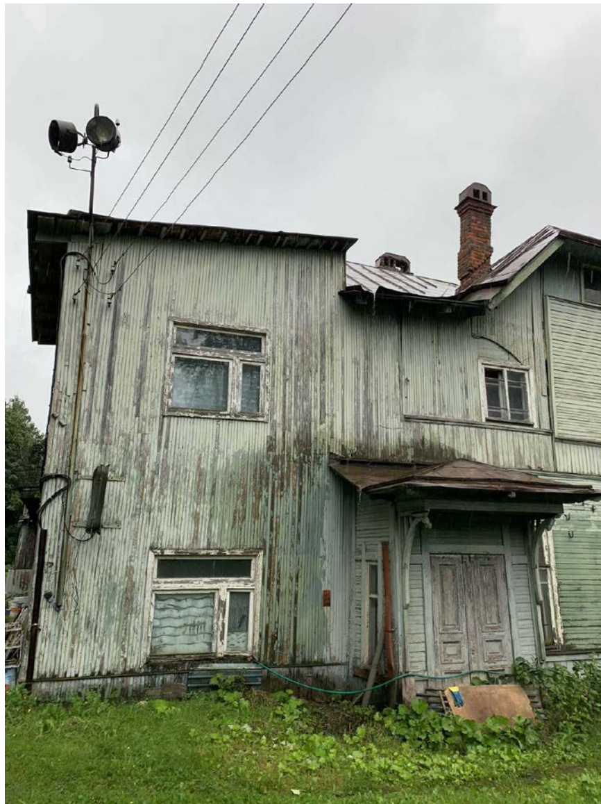
3. Вид на северо-восточную часть здания и тамбур входного проема. 03.06.2022.
