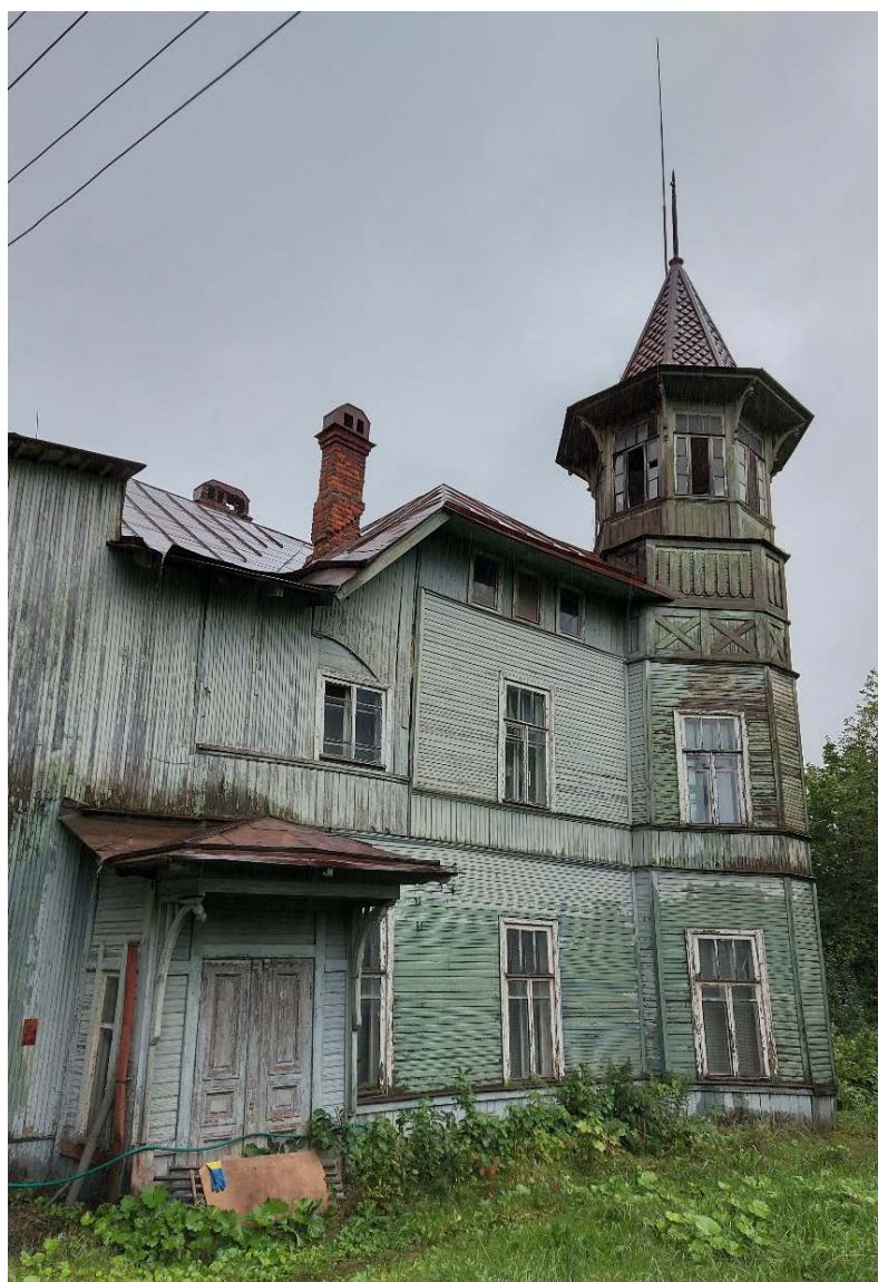
5. Вид на северный фасад. 03.06.2022
