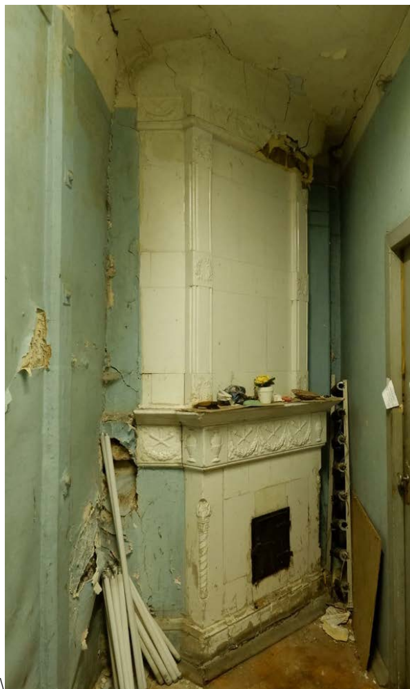
12. Печь в помещении 1-го этажа (пом. 1-Н (37)). 03.06.2022
