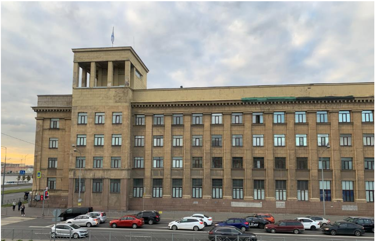
2. Южный фасад. Вид с моста Александра Невского. 03.06.2022
