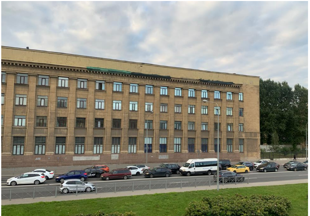
3. Южный фасад. Вид с моста Александра Невского. 03.06.2022
