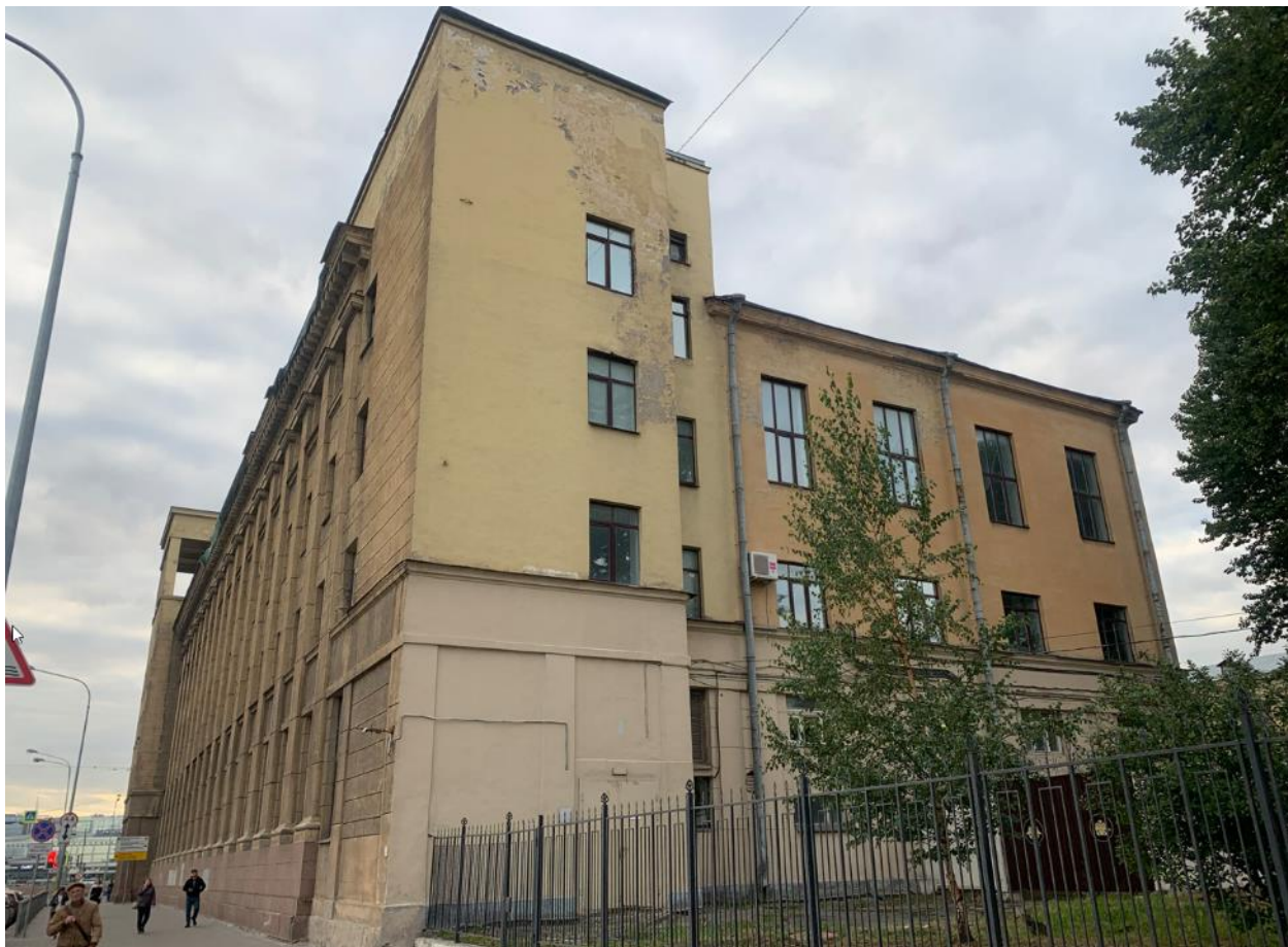
4. Восточный торцевой фасад. 03.06.2022
