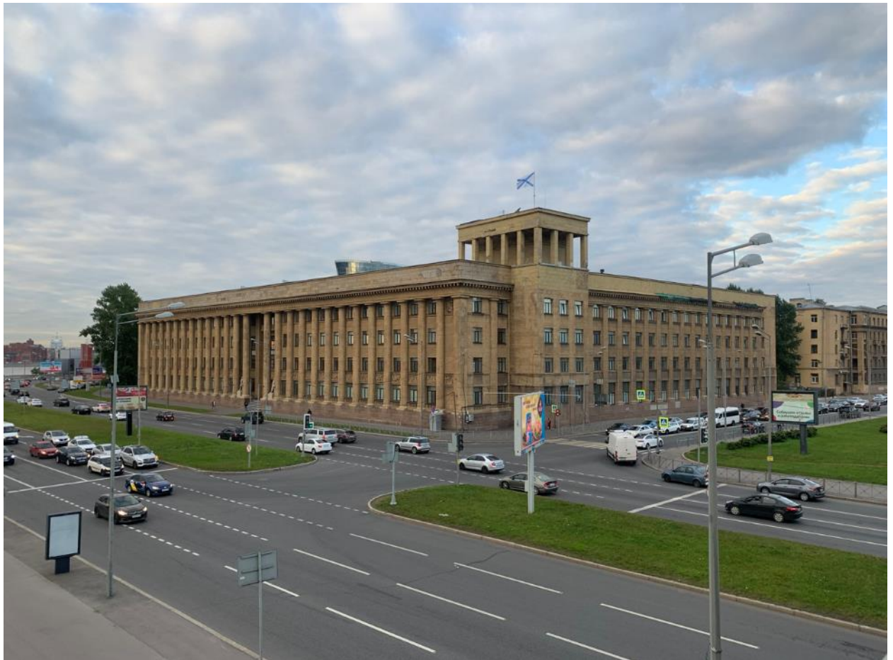
1. Выявленный объект культурного наследия «Здание Специальных курсов усовершенствования командного состава», расположенный по адресу: Санкт-Петербург, Малоохтинский проспект, дом 80/2, литера А. Общий вид. Вид с моста Александра Невского. 03.06.2022
