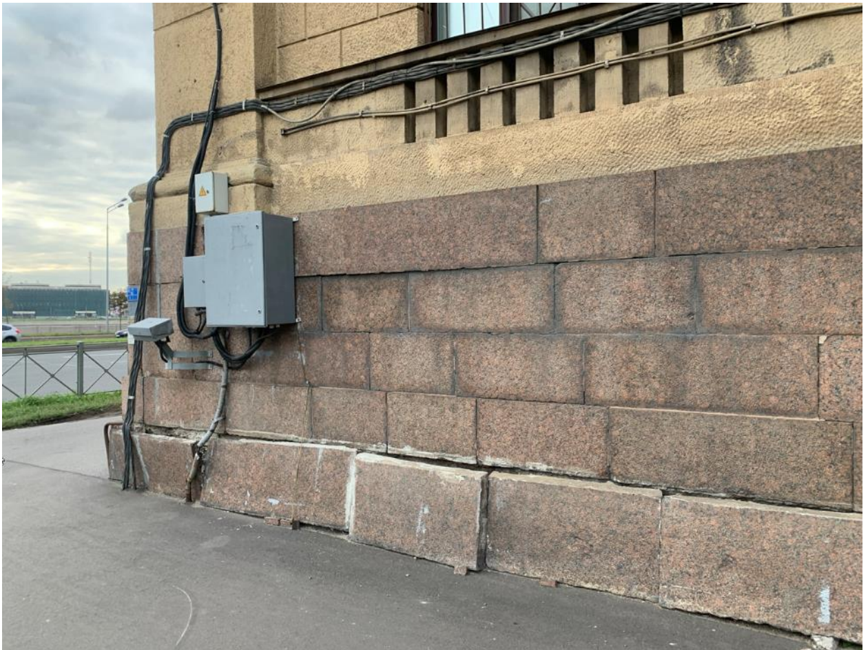
8. Южный фасад. Фрагмент цоколя в угловой части. 03.06.2022
