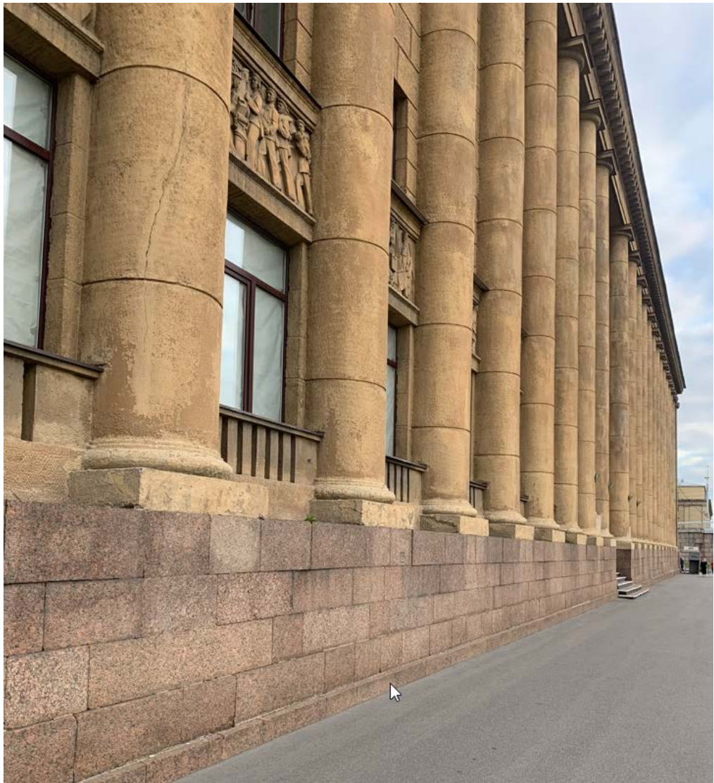
22. Западный фасад. Вид с севера. 03.06.2022
