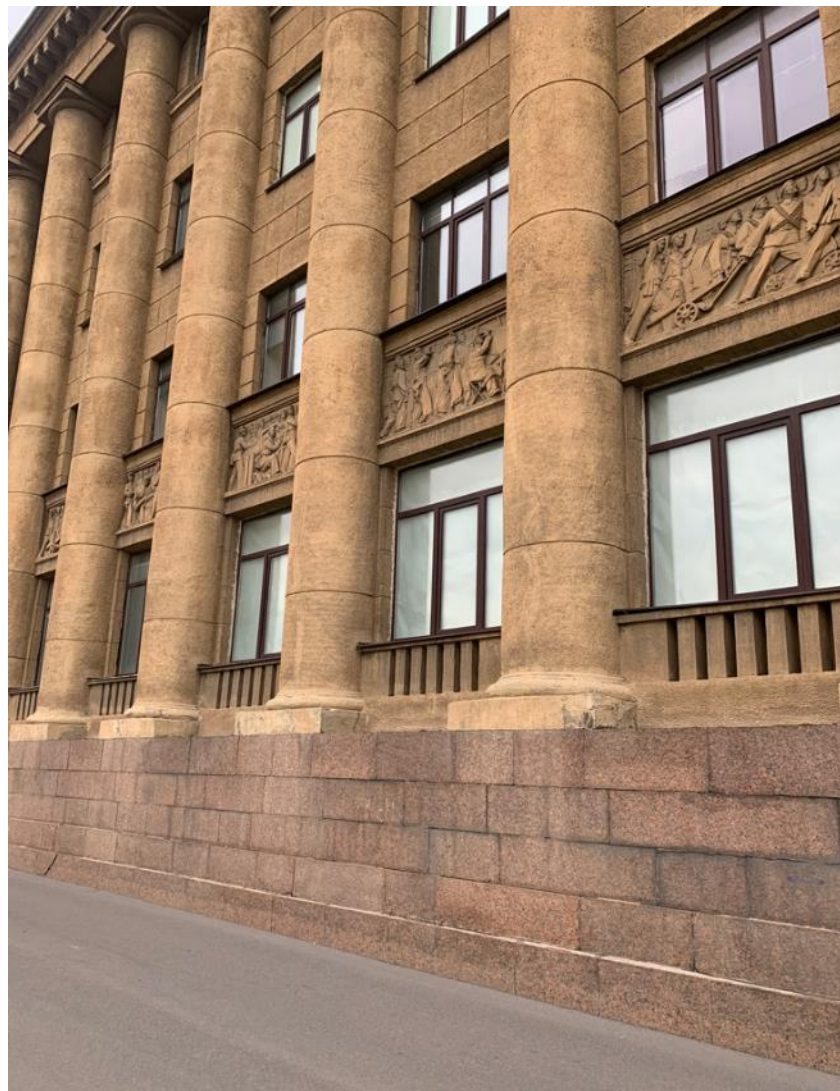
13. Западный фасад. Фрагмент. 03.06.2022
