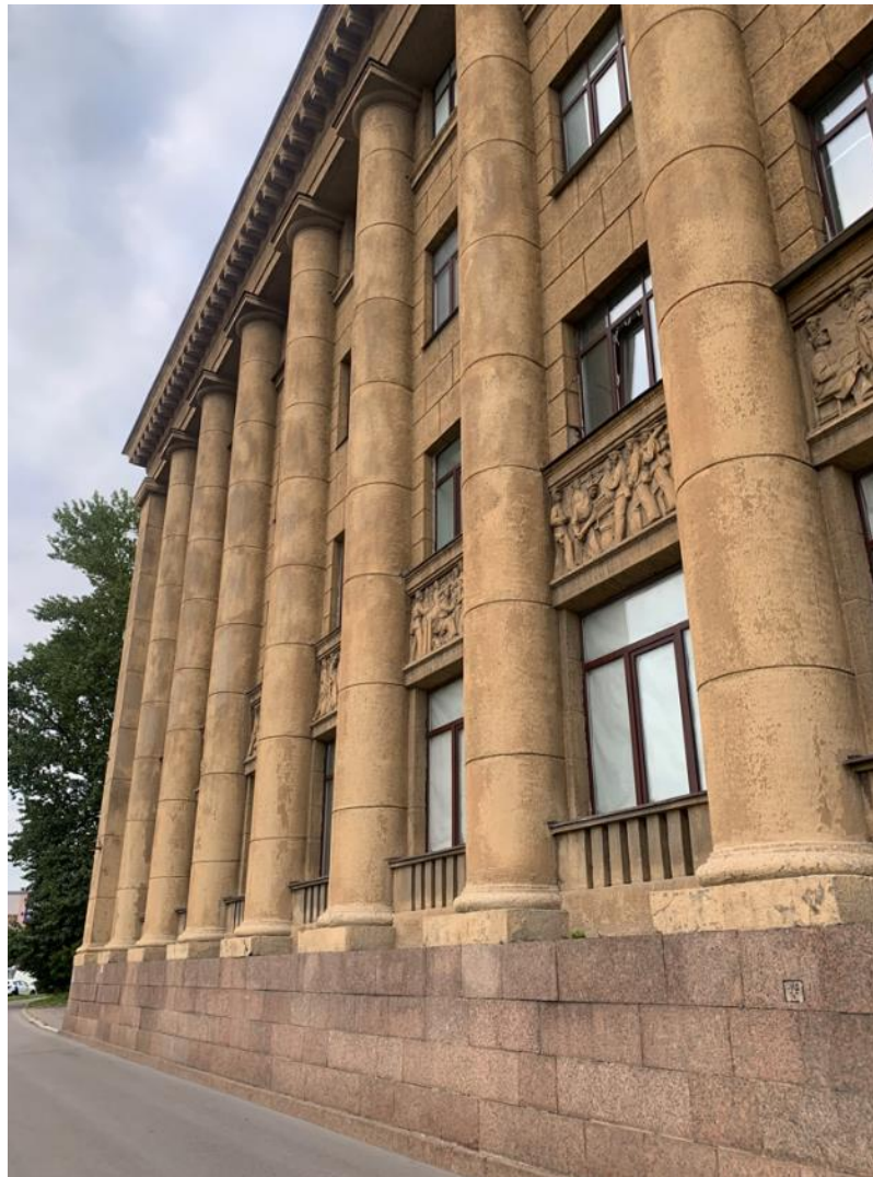
21. Западный фасад. Фрагмент. 03.06.2022
