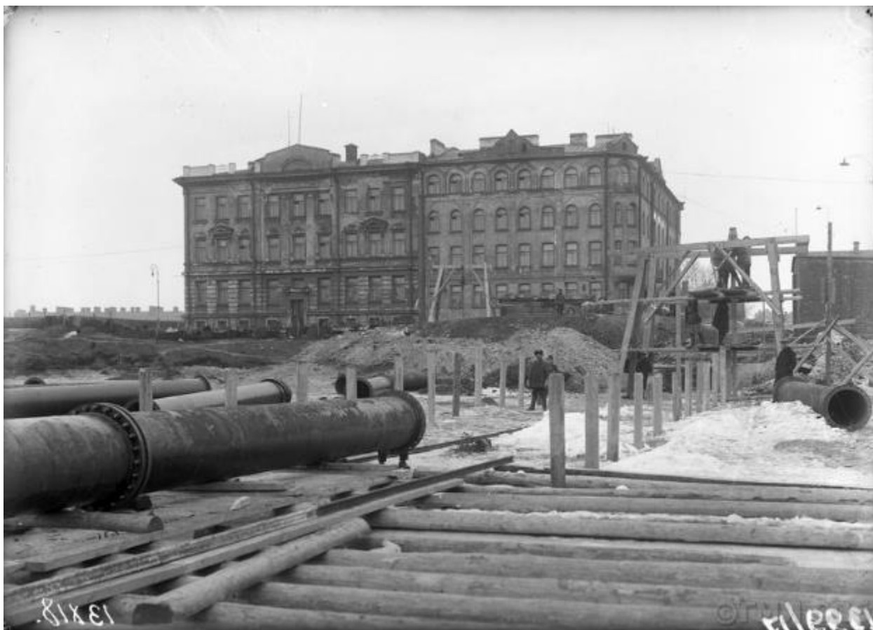
16. Водопроводные работы. Переход через Неву. Вид на береговую часть работ. 1928 г. ГМИ СПб 221781.
