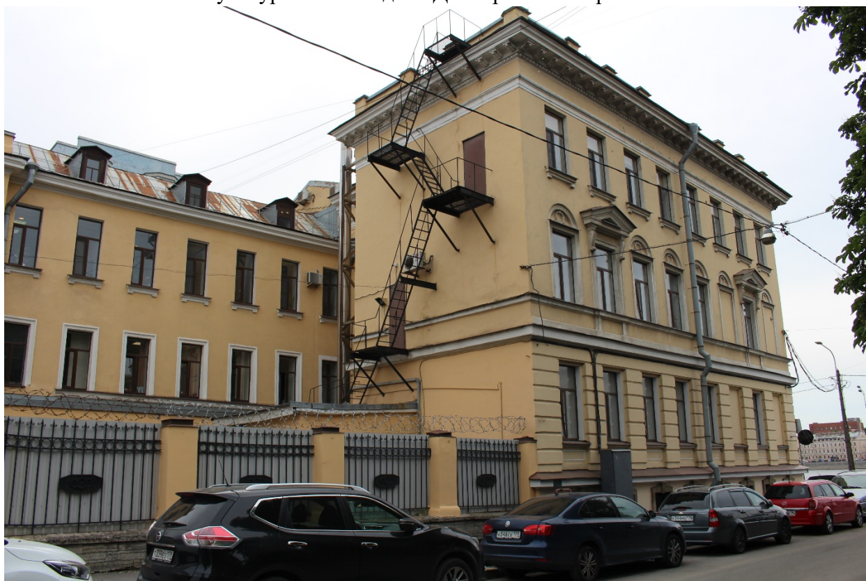
Фото 6. Вид на восточный фасад лицевого корпуса выявленного объекта культурного наследия «Дом-приют Кокоревых».
