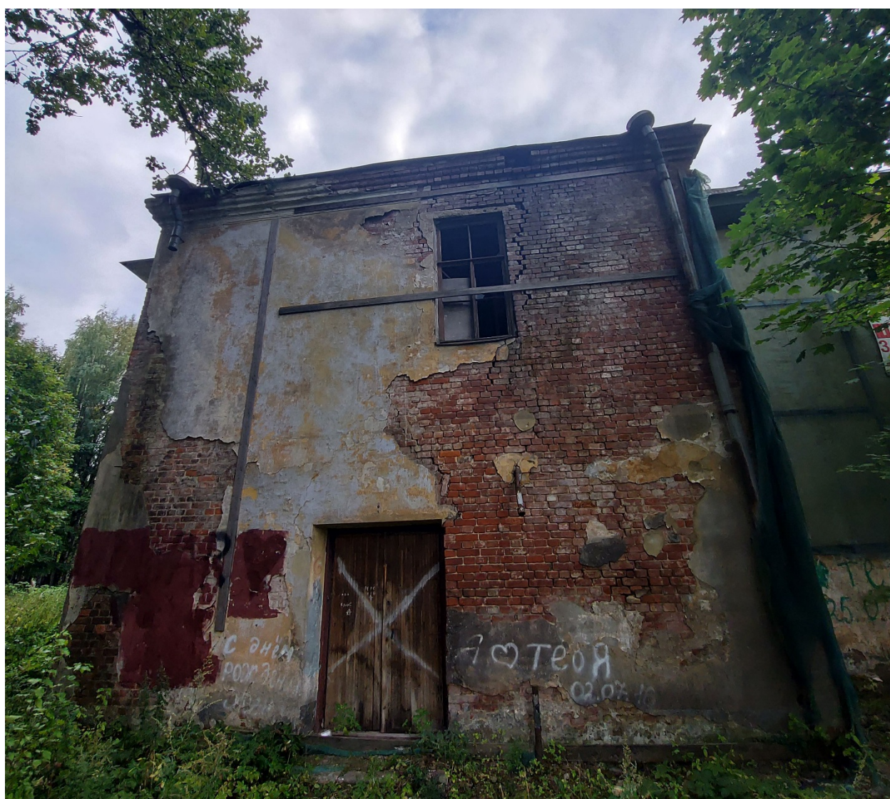
4. Вид на восточный фасад. 03.06.2022
