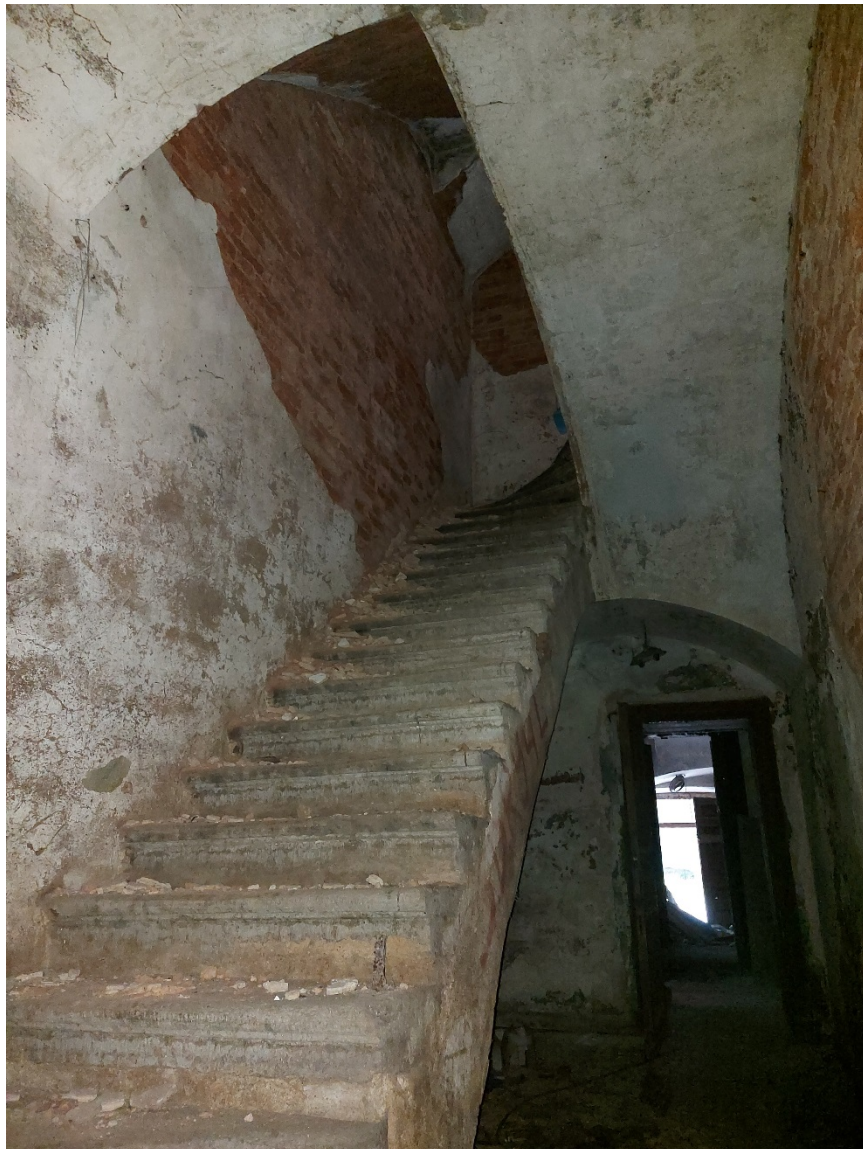
10. Лестница ЛК-1 в южной части здания. 03.06.2022
