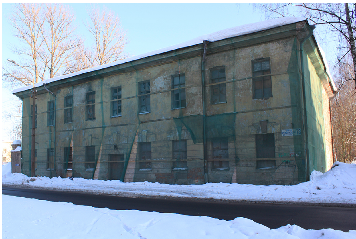
23. Офицерская казарма служащих Охтинского порохового завода. Февраль 2011 // /Электронный ресурс CITYWALLS. URL: https://www.citywalls.ru/house3556.html
