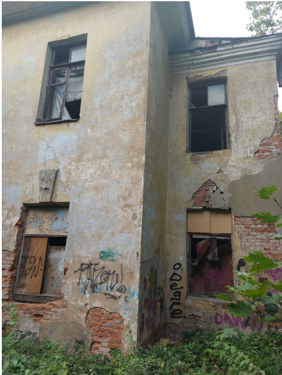
8. Юго-восточный угол здания. 03.06.2022
