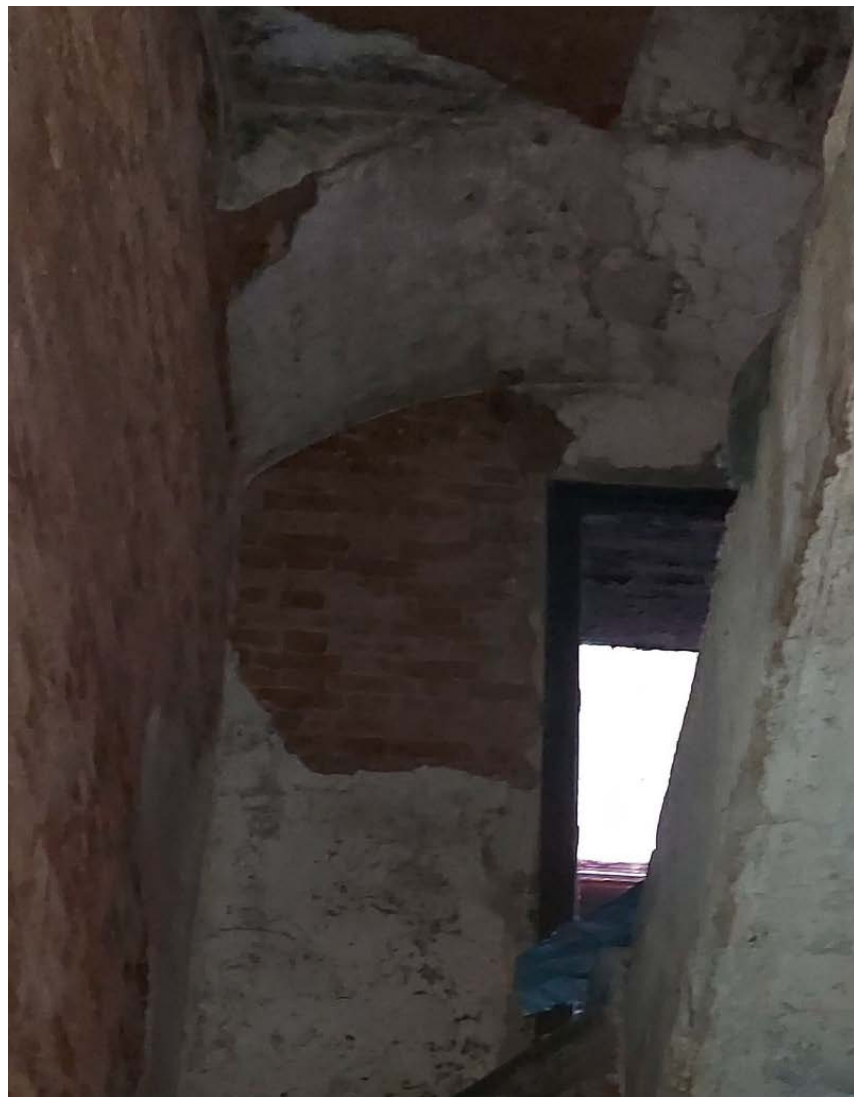
11. Своды над межэтажной лестничной площадкой лестницы ЛК-1. 03.06.2022
