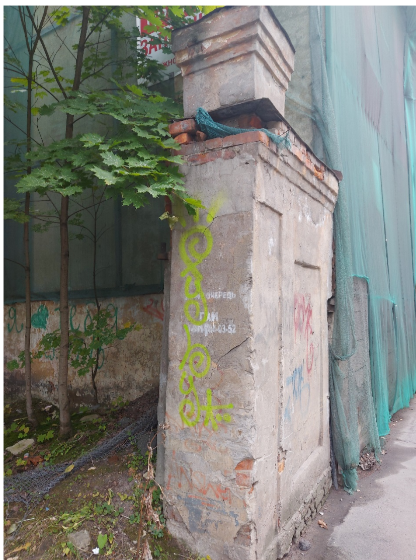
5. Вид на фрагмент исторической ограды у восточного фасада. 03.06.2022
