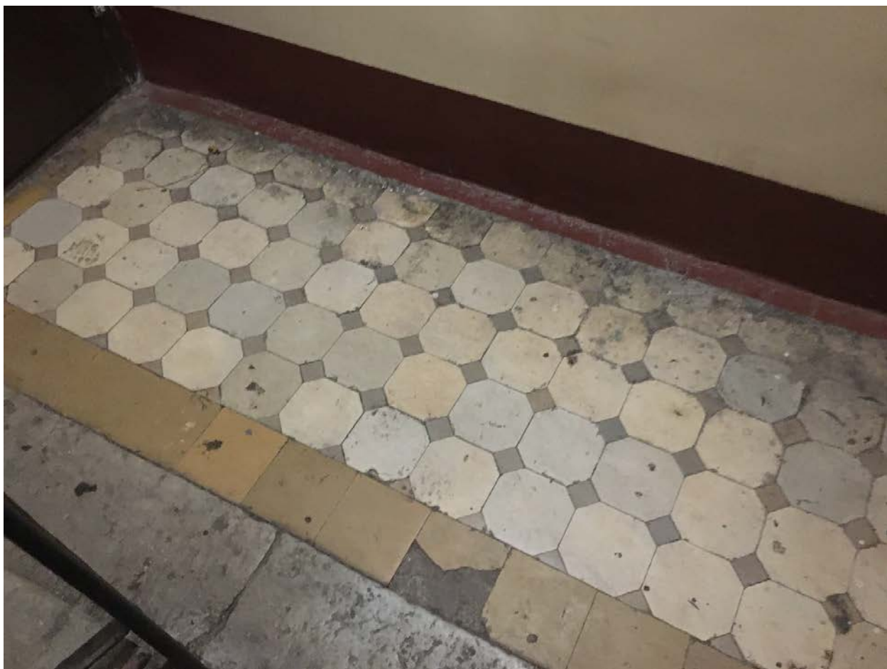
Фото 85. Вид на пол лестничной площадки ЗЛК в уровне 1-го этажа.
