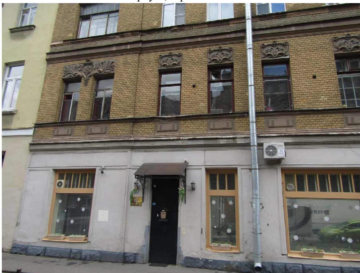
Фото 4. Вид на северную часть западного фасада лицевого корпуса в уровне 1-го – 2-го этажей.
