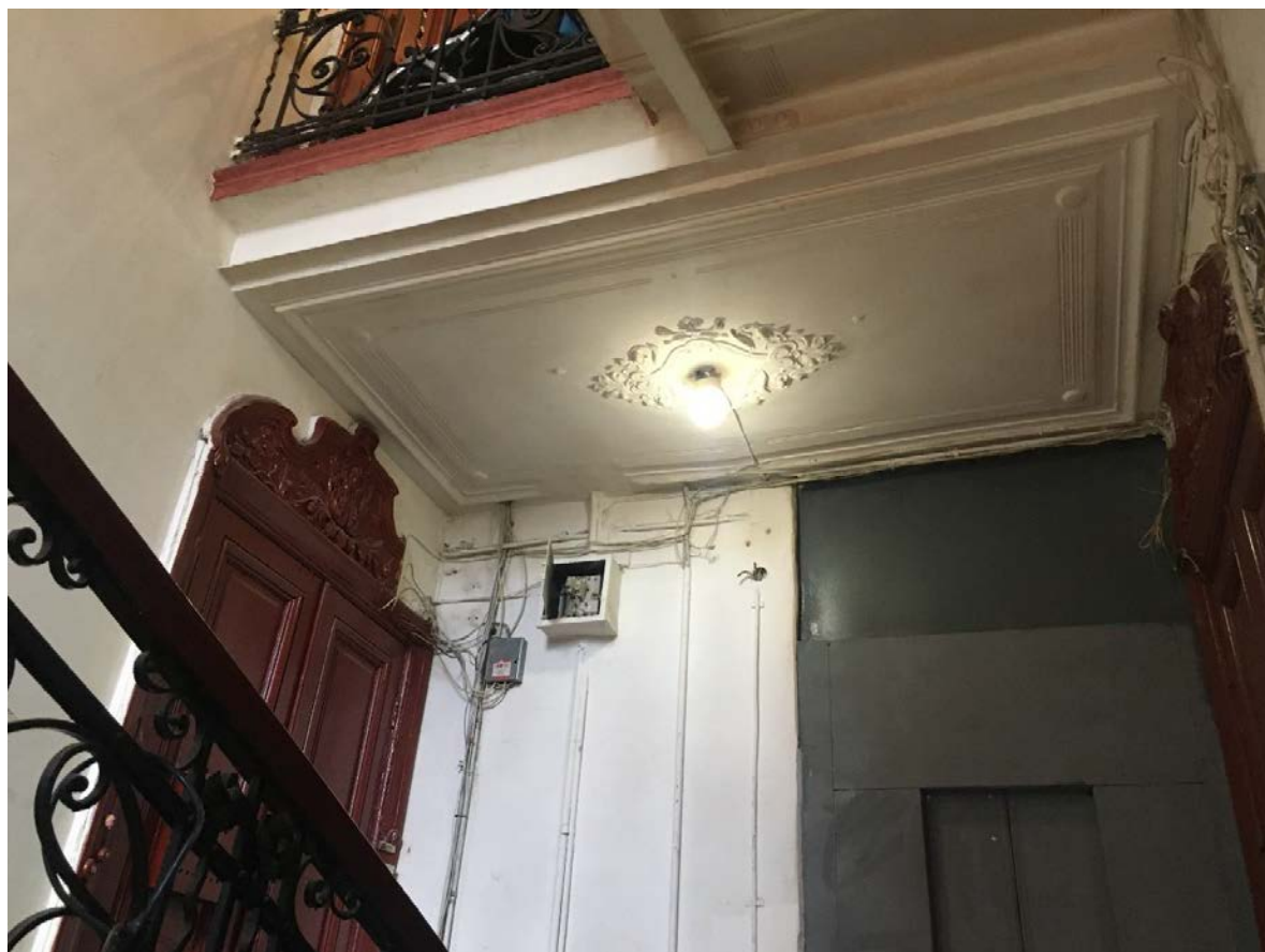
Фото 63. Вид на лестничную площадку 1ЛК в уровне 5-го этажа.
