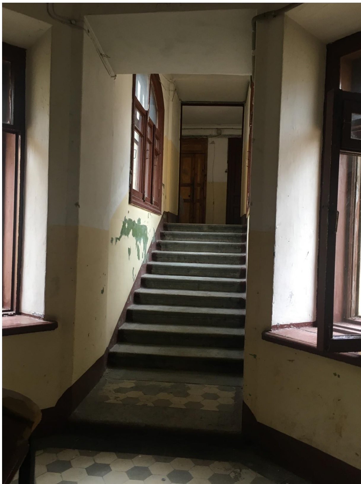
Фото 75. Вид на междуэтажную площадку 2ЛК в уровне 2-го – 3-го этажей.
