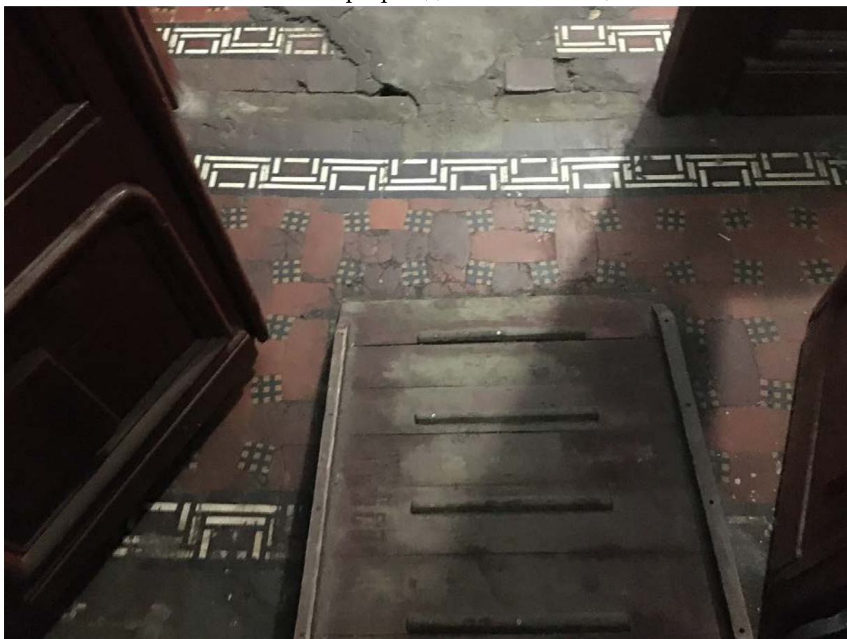
Фото 28. 1ЛК, вид на пол тамбура.
