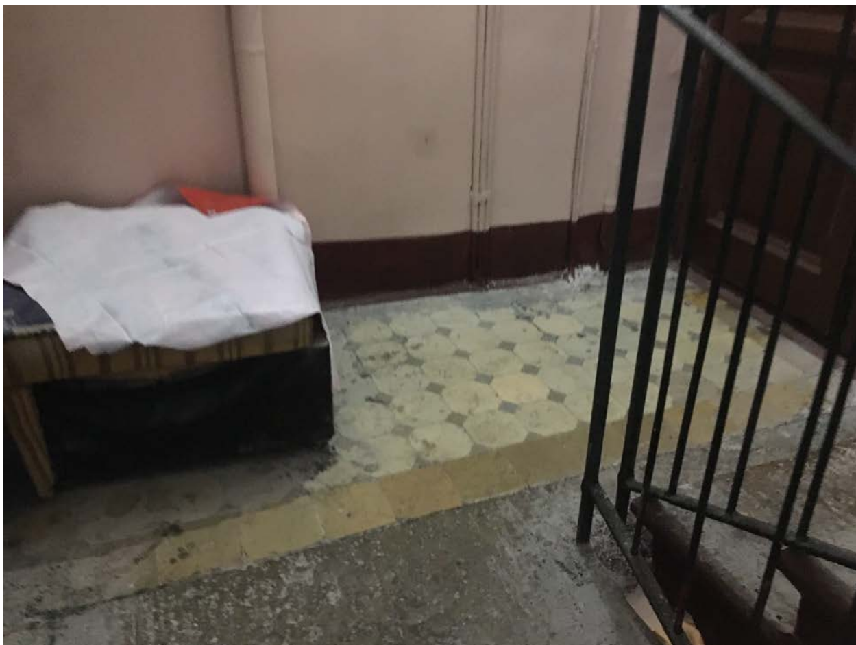
Фото 95. Вид на лестничную площадку 5ЛК в уровне 2-го этажа.
