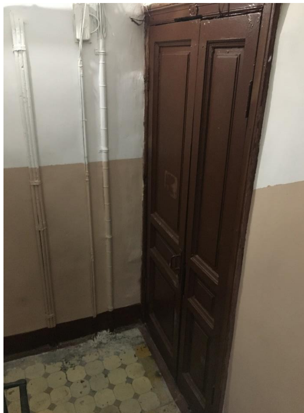
Фото 97. Вид на двери лестничной площадки 5ЛК в уровне 2-го этажа.
