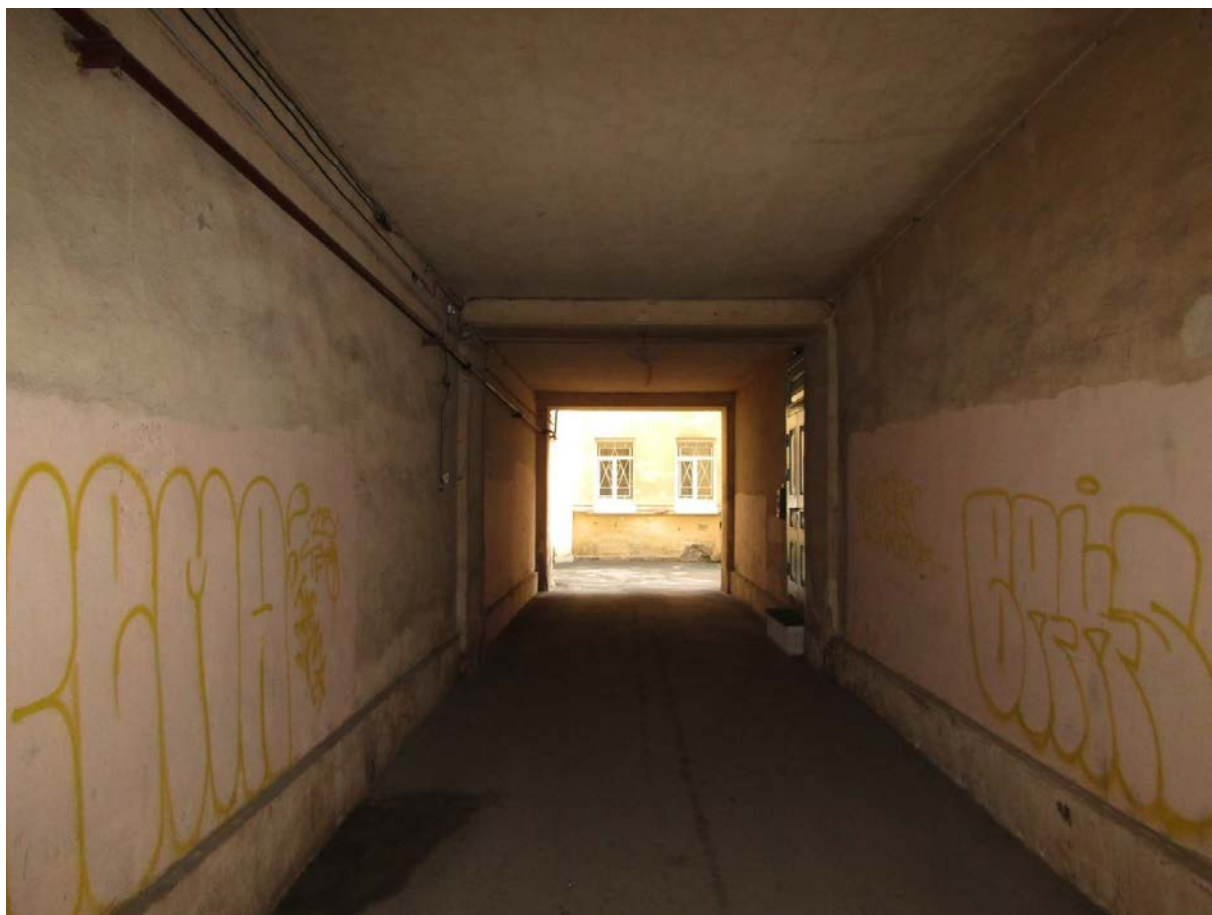
Фото 17. Арка воротного проезда в среднем флигеле, вид с запада.
