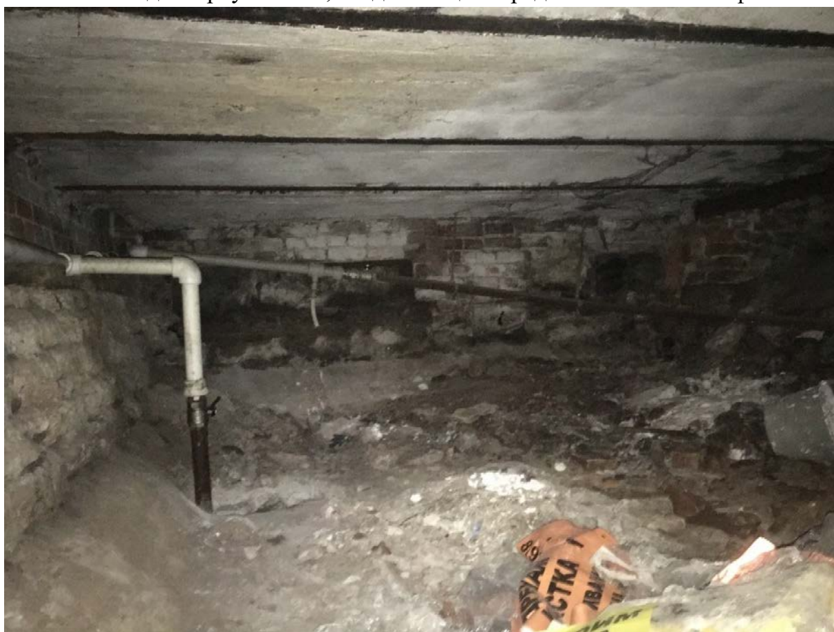
Фото 26. Интерьер подвальных помещений.
