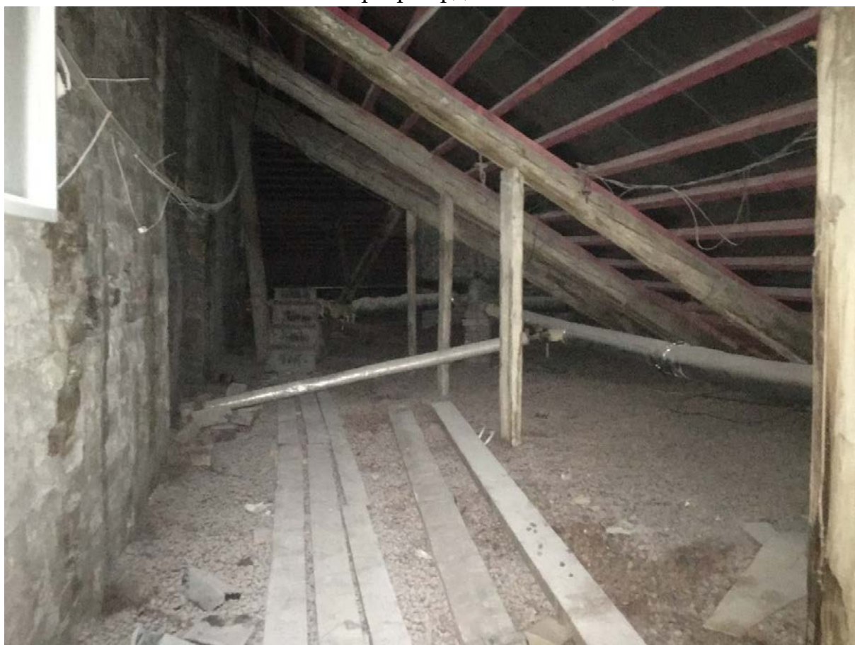
Фото 111. Интерьер чердачных помещений.
