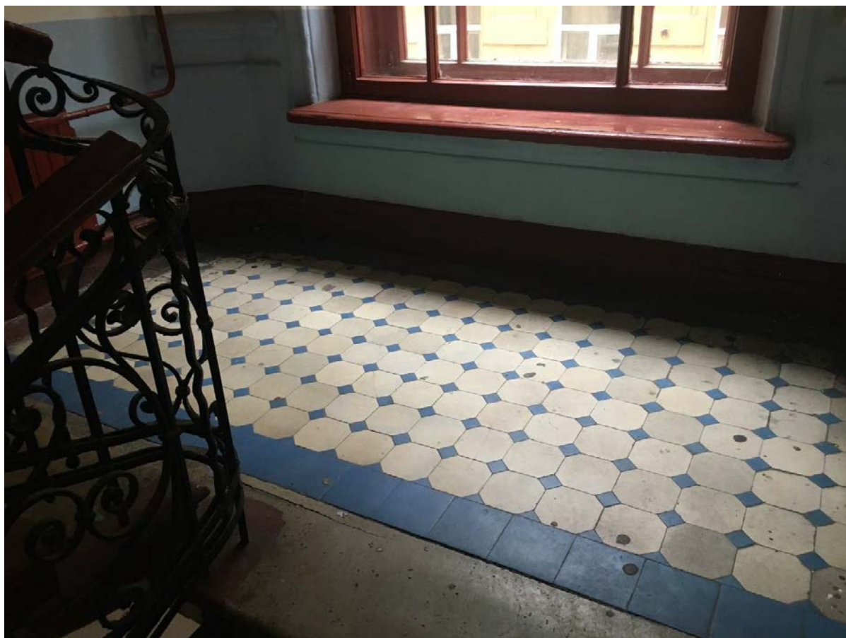
Фото 50. Вид на пол междуэтажной площадки 1ЛК в уровне 2-го – 3-го этажей.
