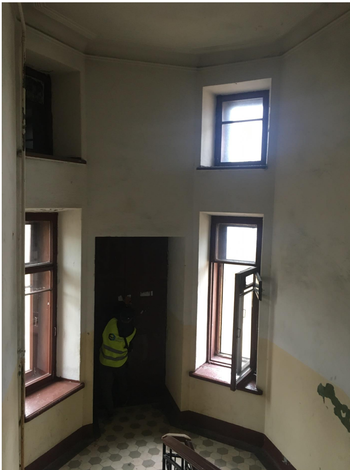
Фото 80. Вид на междуэтажную площадку 2ЛК в уровне 4-го – 5-го этажей.
