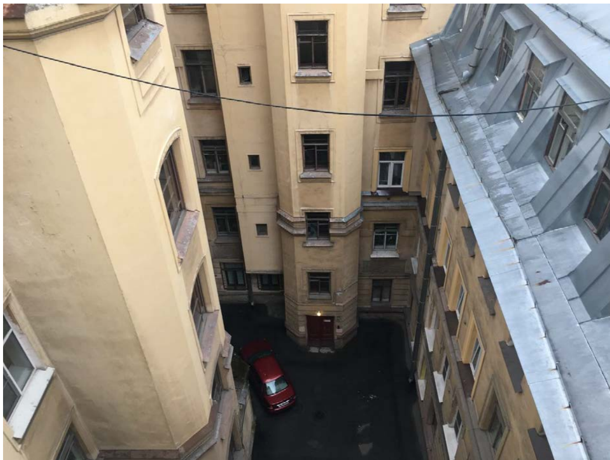
Фото 16. Северный шестиэтажный флигель, вид с 5-го этажа.
