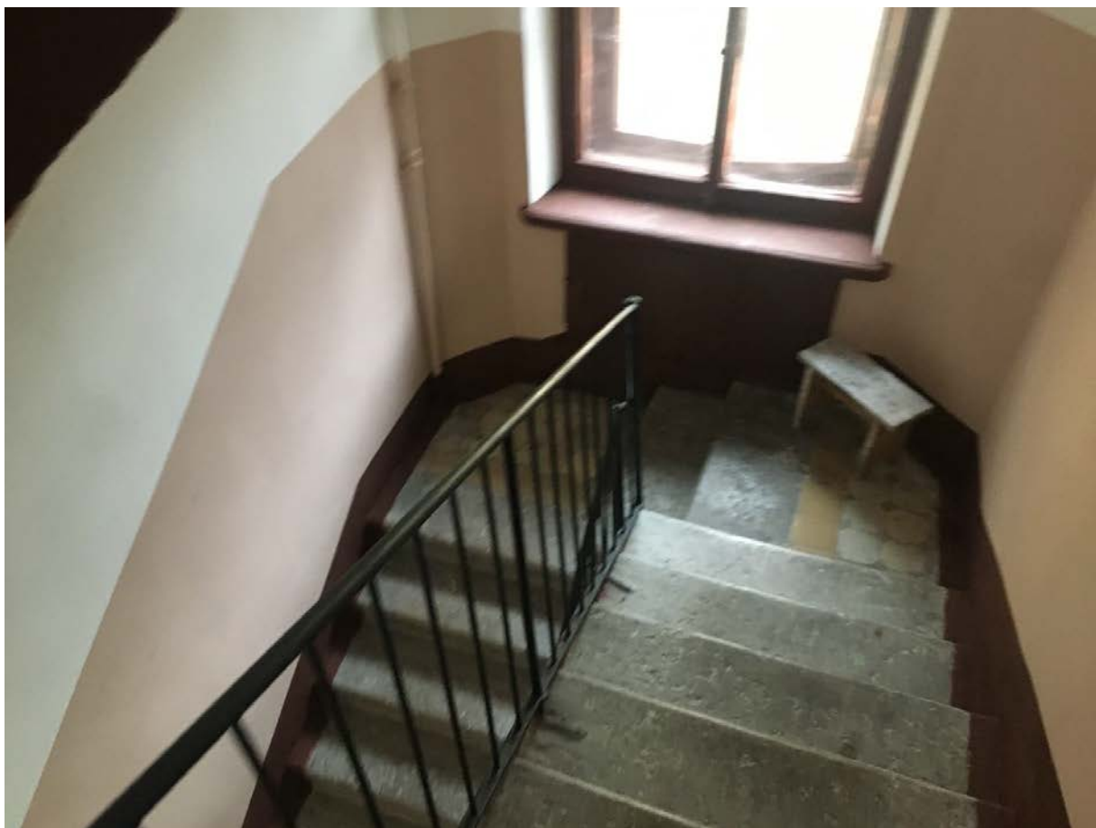
Фото 104. Вид на междуэтажную площадку в уровне 5-го – 6-го этажей.
