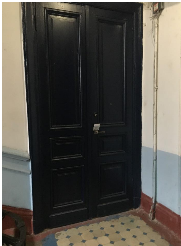
Фото 59. Вид на двери лестничной площадки 1ЛК в уровне 4-го этажа.
