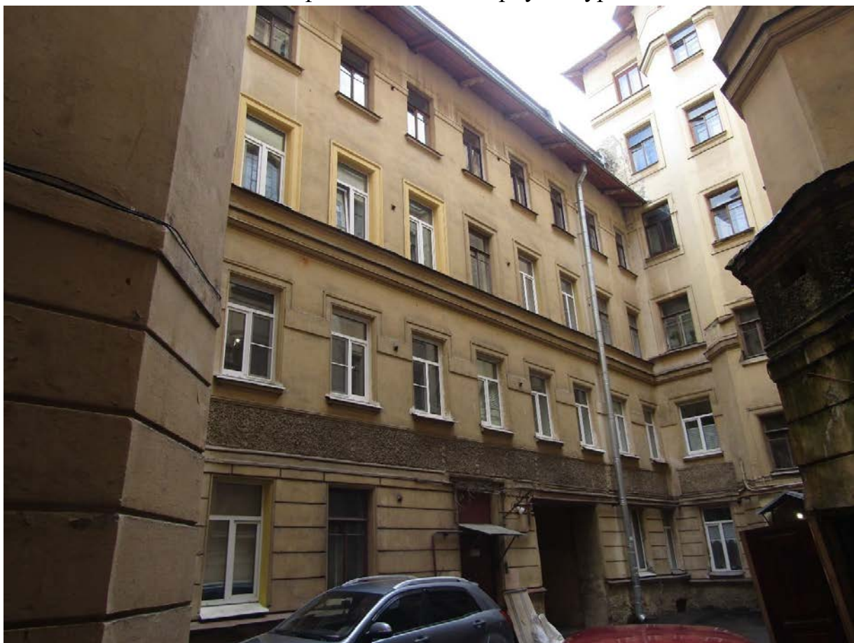
Фото 14. Вид на западный фасад среднего флигеля.
