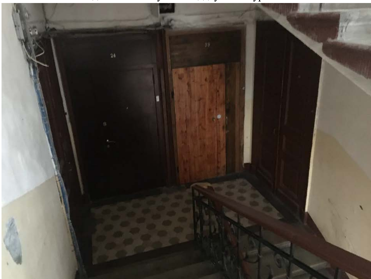
Фото 79. Вид на лестничную площадку 2ЛК в уровне 4-го этажа.
