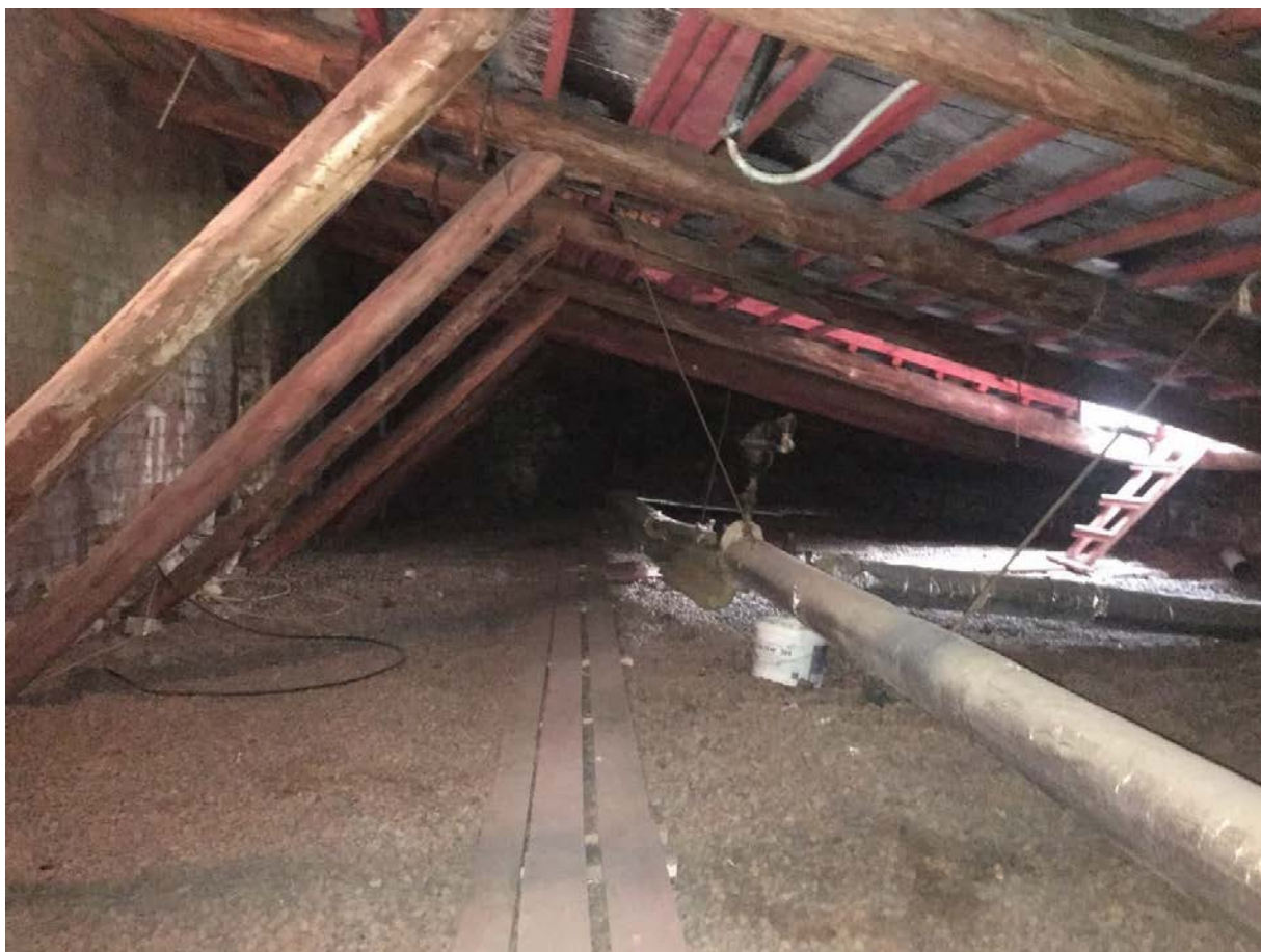
Фото 110. Интерьер чердачных помещений.
