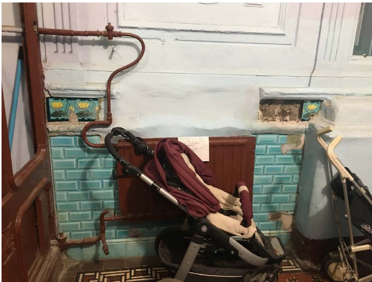
Фото 35. Вестибюль 1ЛК, северная стена, фрагмент.
