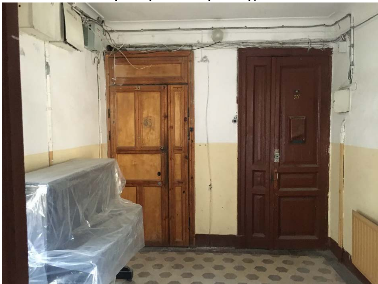
Фото 77. Вид на лестничную площадку 4ЛК в уровне 3-го этажа.
