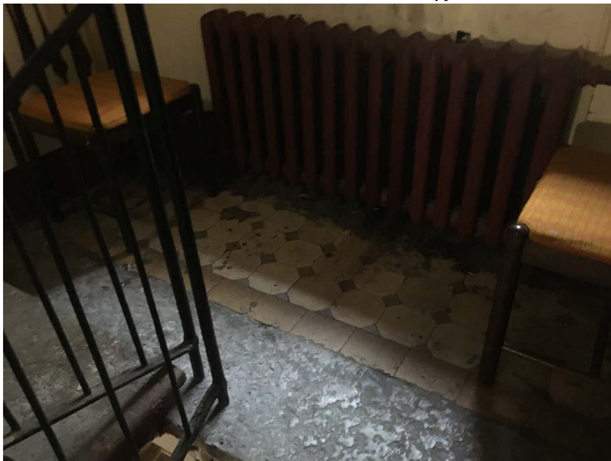
Фото 86. Вид на пол междуэтажной площадки ЗЛК в уровне 1-го – 2-го этажей.
