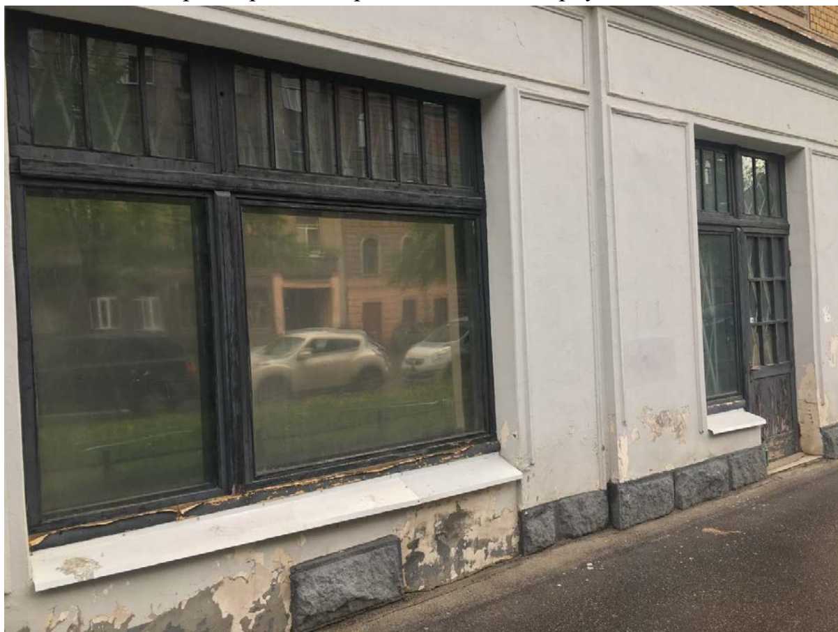
Фото 8. Вид на южную часть западного лицевого корпуса в уровне 1-го этажа.
