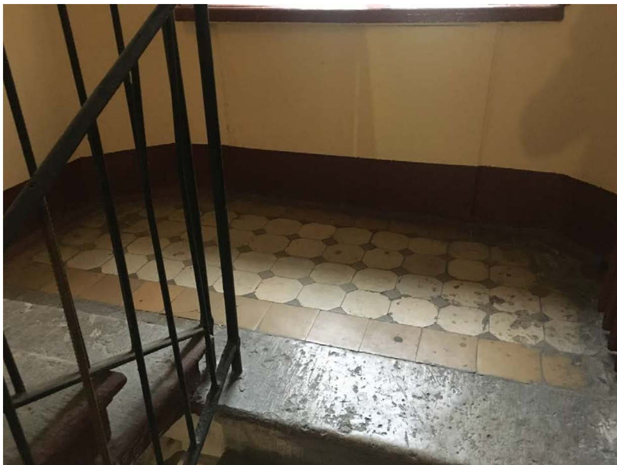
Фото 89. Вид на пол междуэтажной площадки ЗЛК в уровне 3-го – 4-го этажей.
