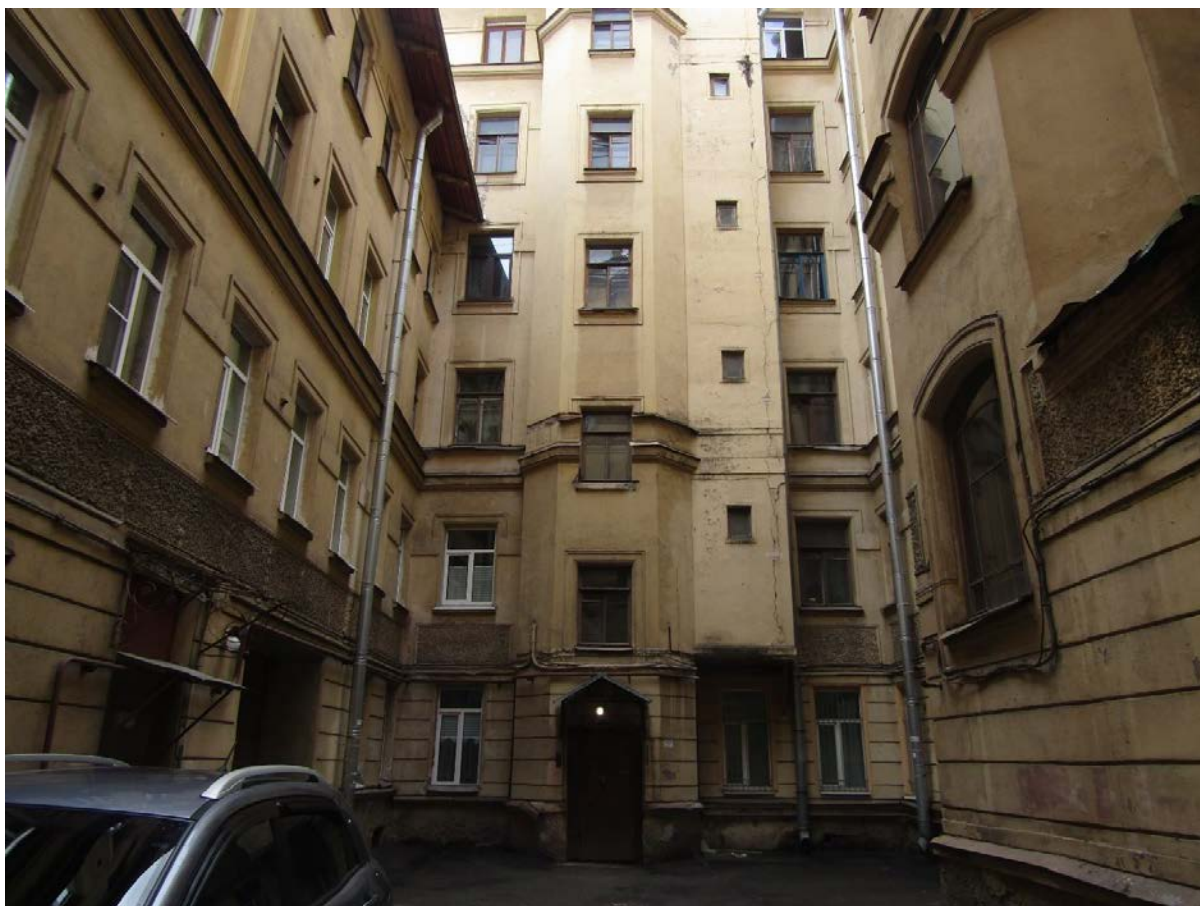
Фото 11. Вид на южный шестиэтажный корпус (нижняя часть).
