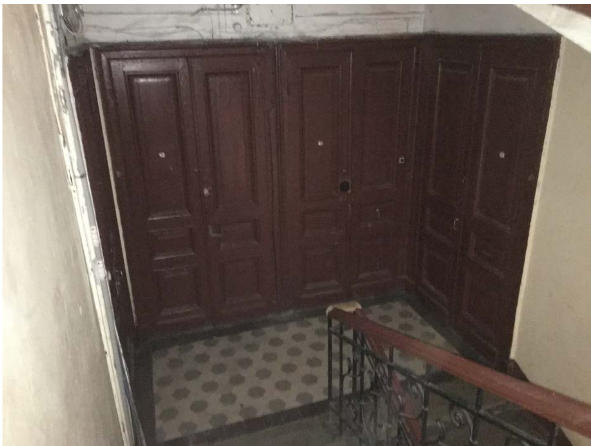
Фото 78. Вид на лестничную площадку 2ЛК в уровне 3-го этажа.
