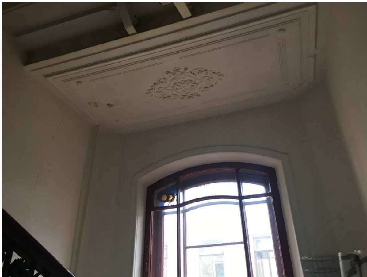
Фото 62. Вид на потолок междуэтажной площадки 1ЛК в уровне 4-го – 5-го этажей.
