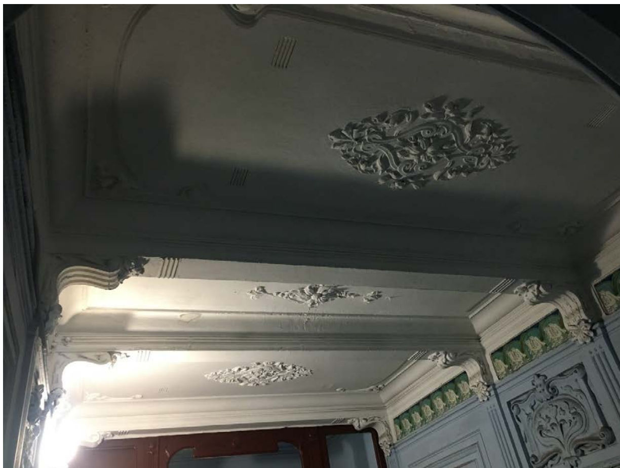
Фото 37. Вид на потолок вестибюля 1ЛК.
