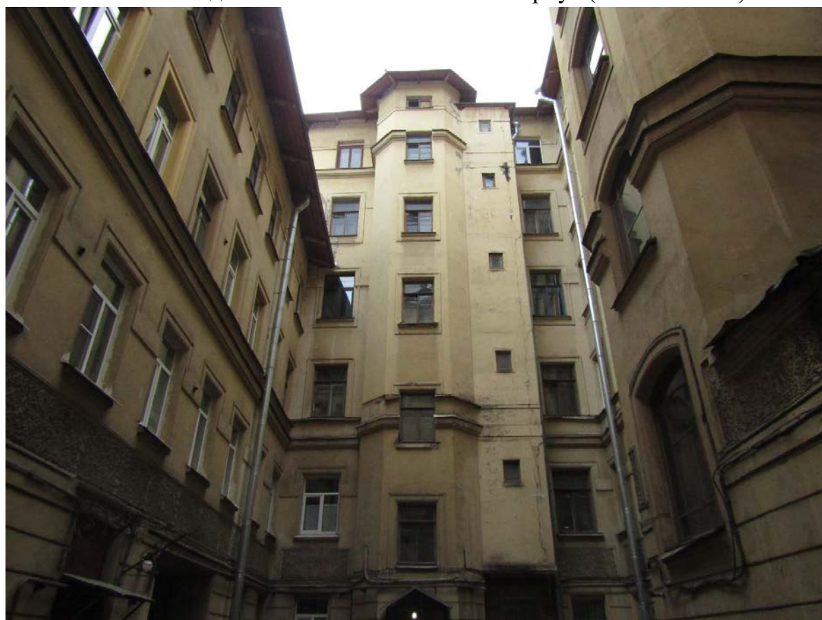
Фото 12. Вид на южный шестиэтажный корпус (верхняя часть).
