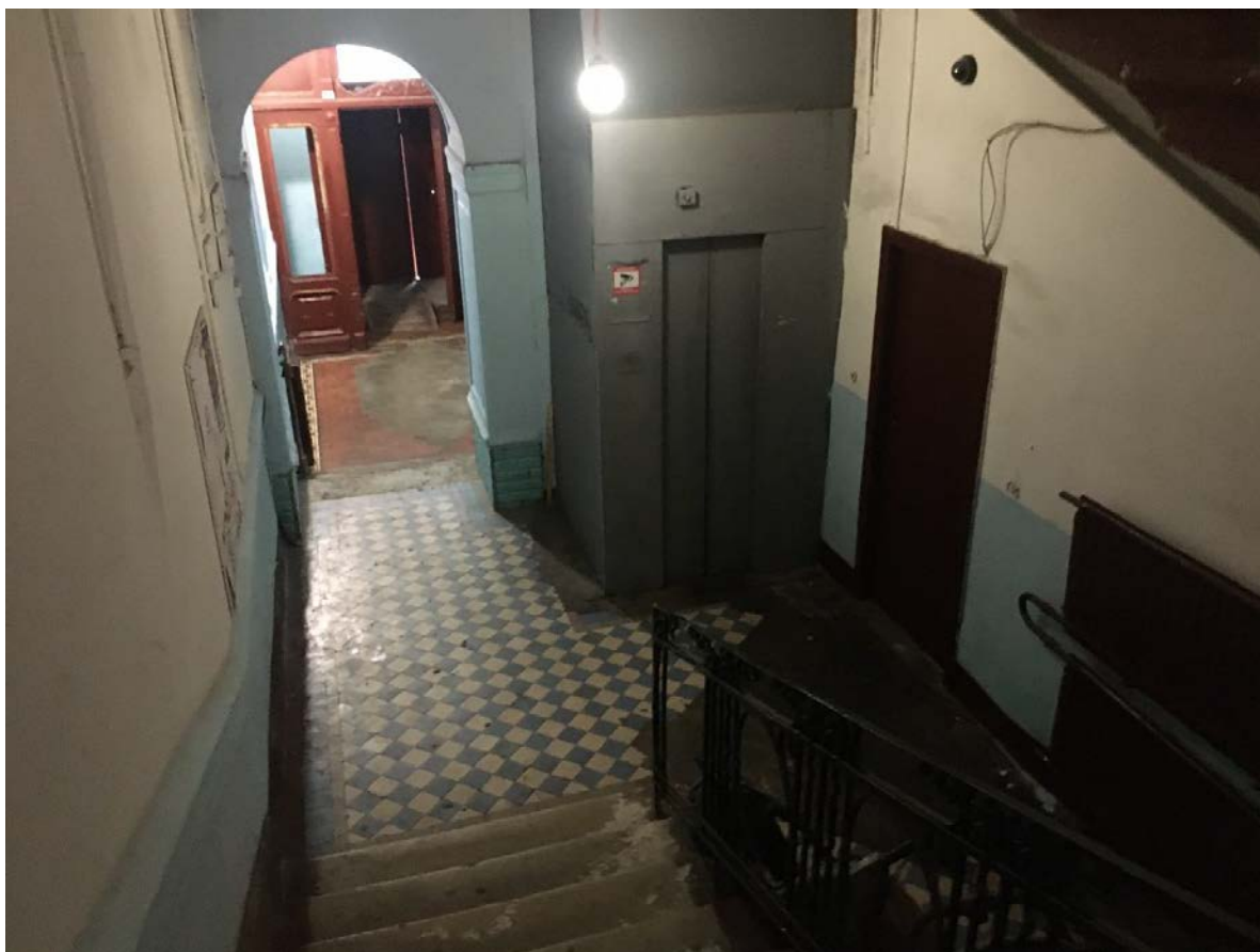
Фото 39. Вид на лестничную клетку 1ЛК в уровне 1-го этажа.
