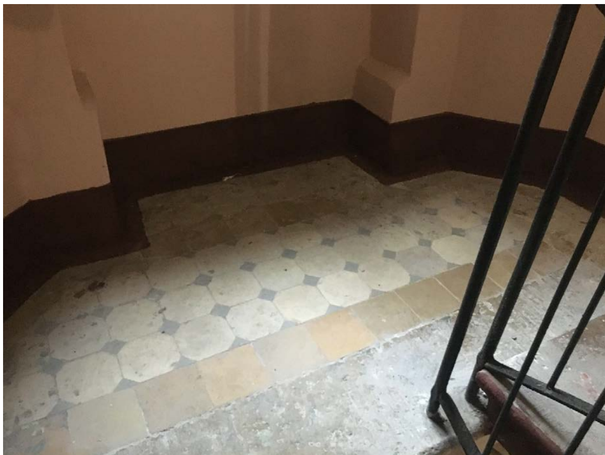
Фото 98. Вид на пол междуэтажной площадки 5ЛК в уровне 2-го – 3-го этажей.
