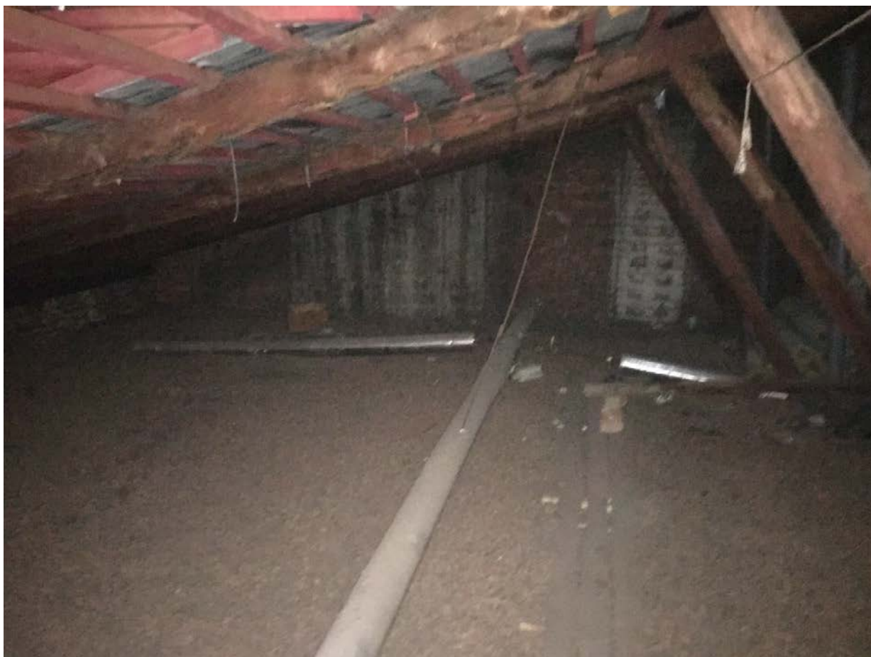
Фото 108. Интерьер чердачных помещений.
