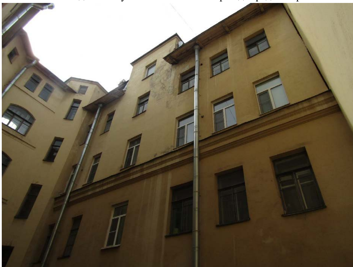
Фото 20. Вид на северную часть восточного фасада среднего флигеля.
