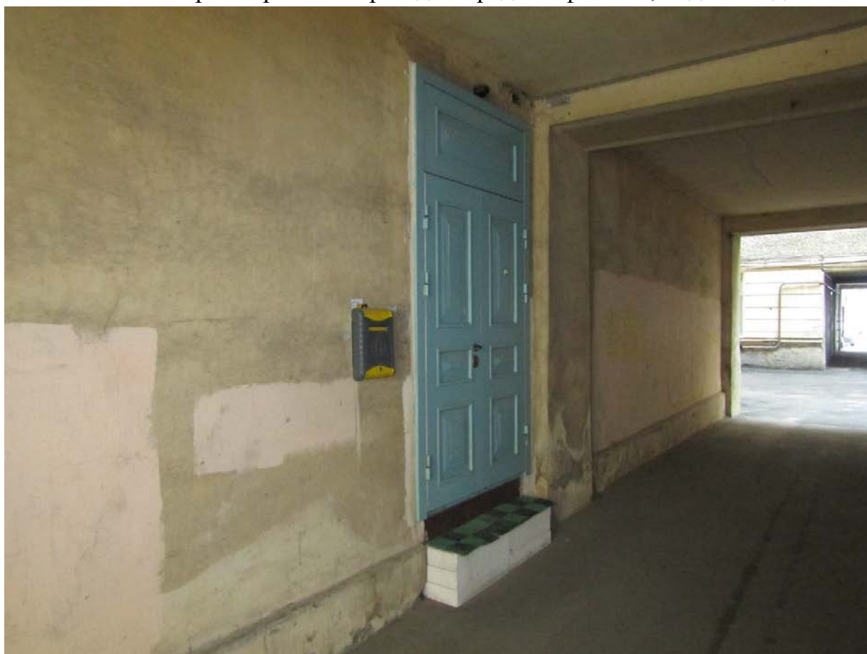
Фото 18. Вход в помещение № 1 среднего флигеля.
