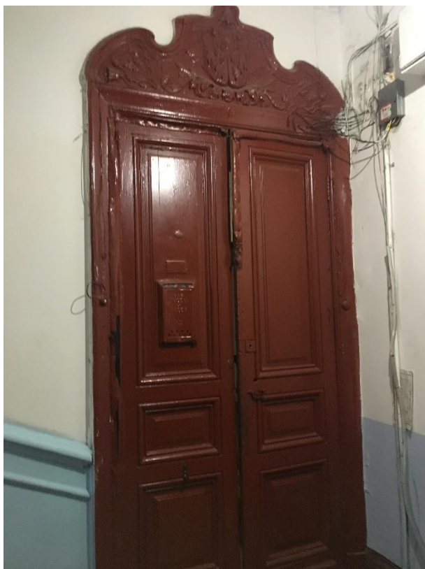
Фото 53. Вид на двери лестничной площадки 1ЛК в уровне 3-го этажа.
