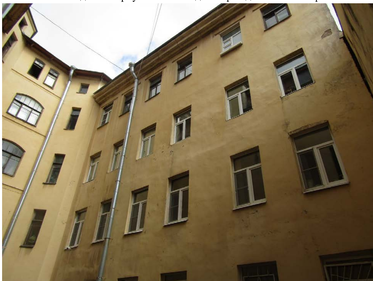
Фото 24. Вид на южную часть западного фасада восточного флигеля.
