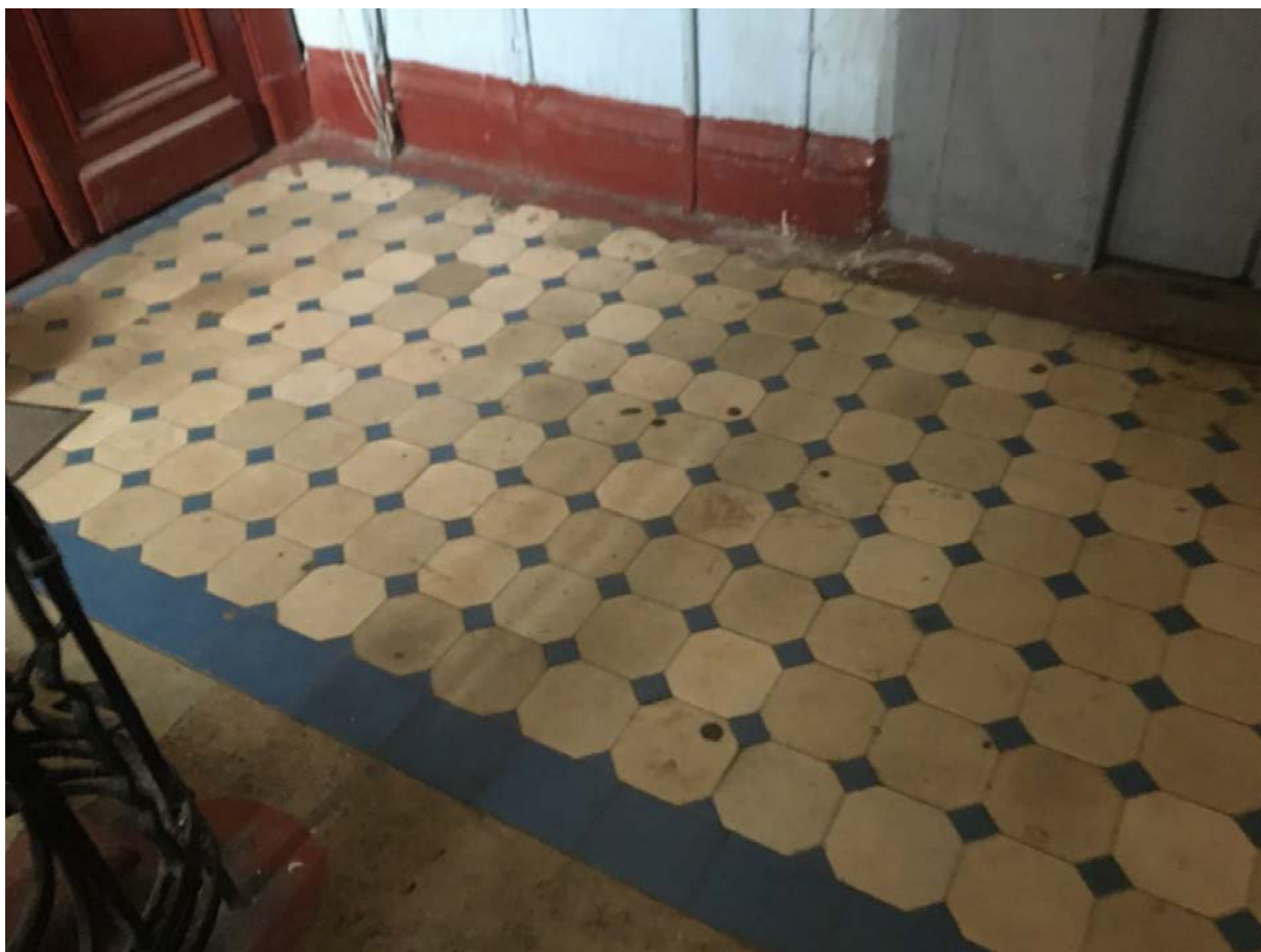
Фото 64. Вид на пол лестничной площадки 1ЛК в уровне 5-го этажа.
