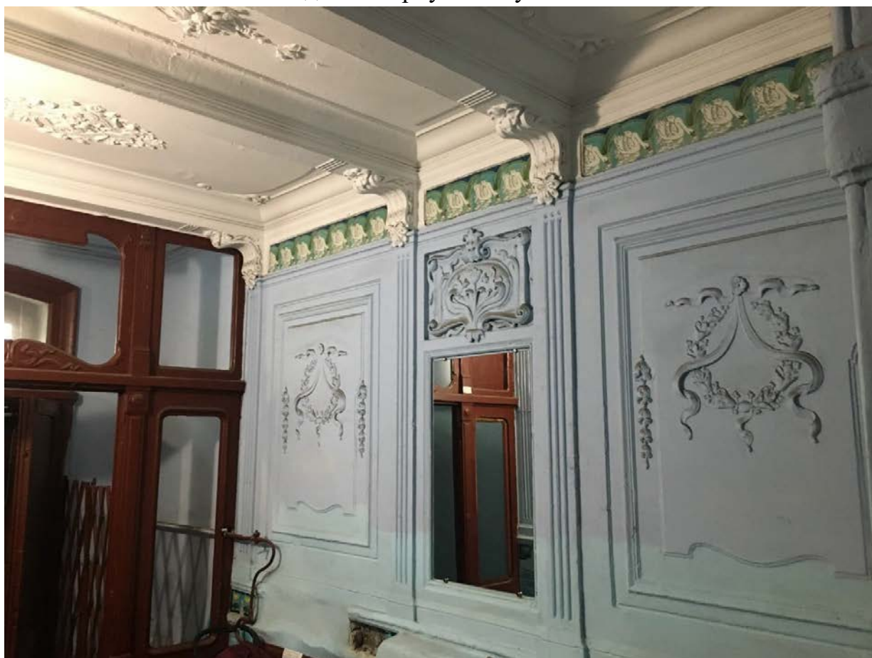
Фото 32. Вид на северную стену вестибюля 1ЛК.
