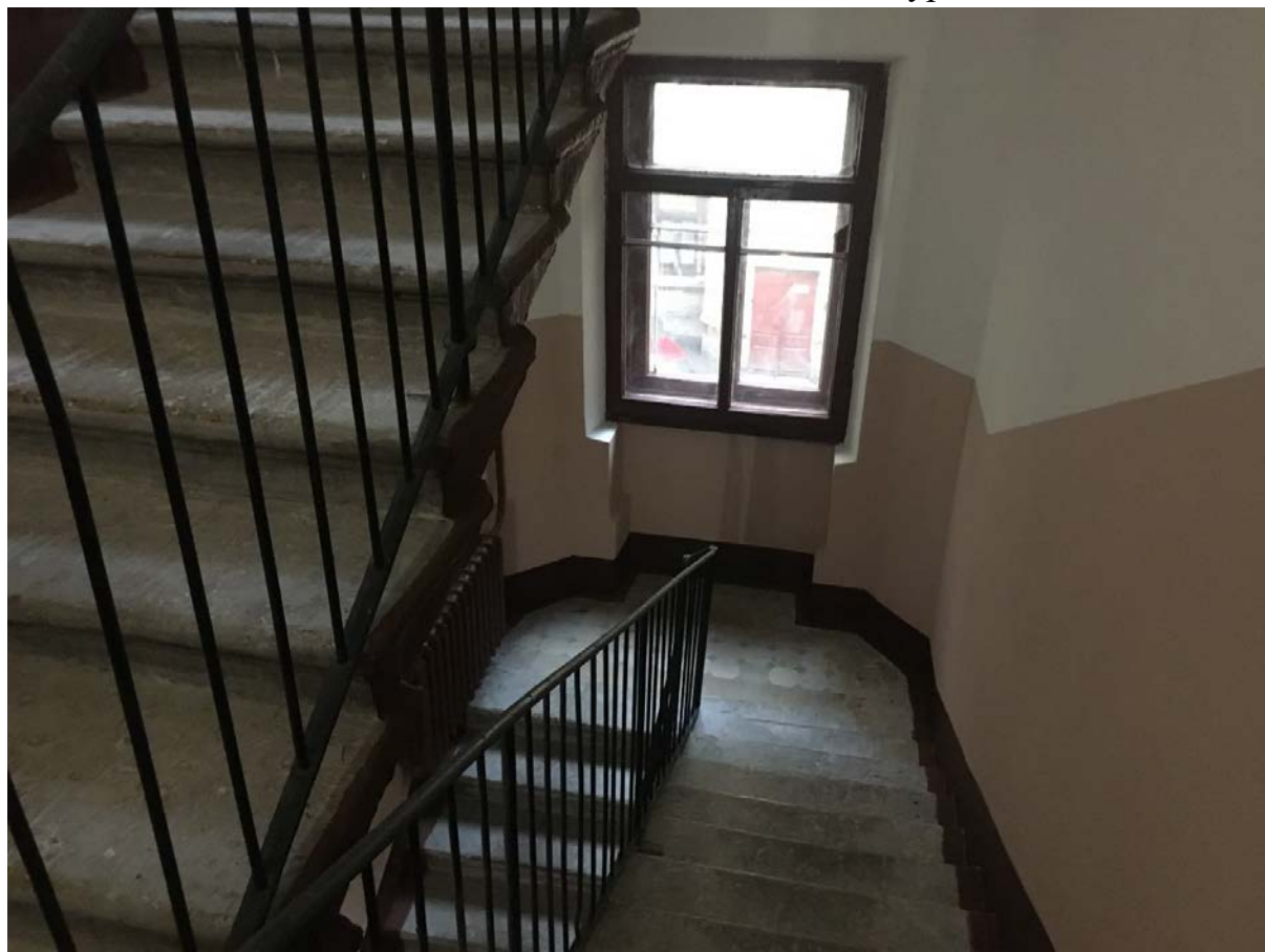
Фото 101. Вид на междуэтажную площадку 5ЛК в уровне 3-го – 4-го этажей.
