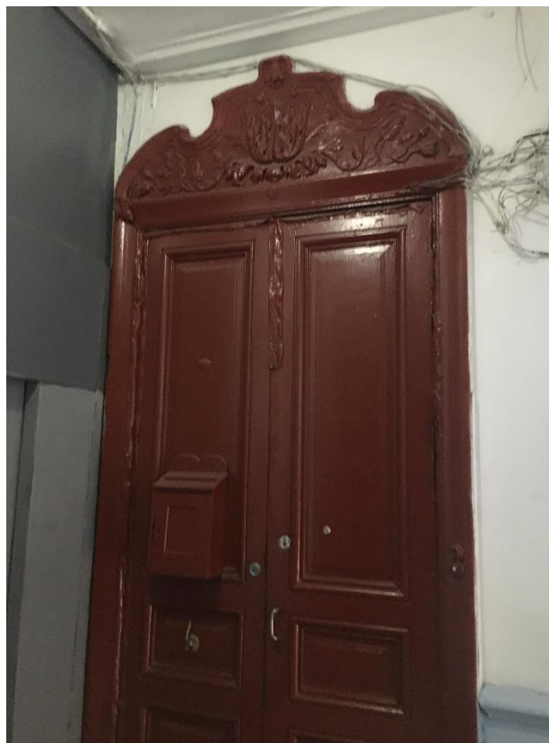
Фото 60. Вид на двери лестничной площадки 1ЛК в уровне 4-го этажа.
