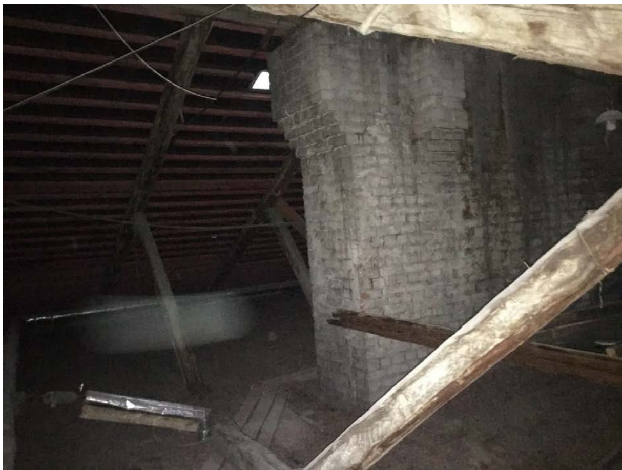
Фото 112. Интерьер чердачных помещений.
