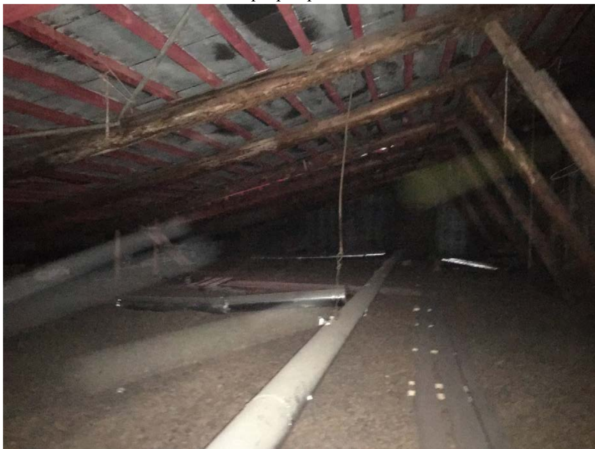
Фото 107. Интерьер чердачных помещений.
