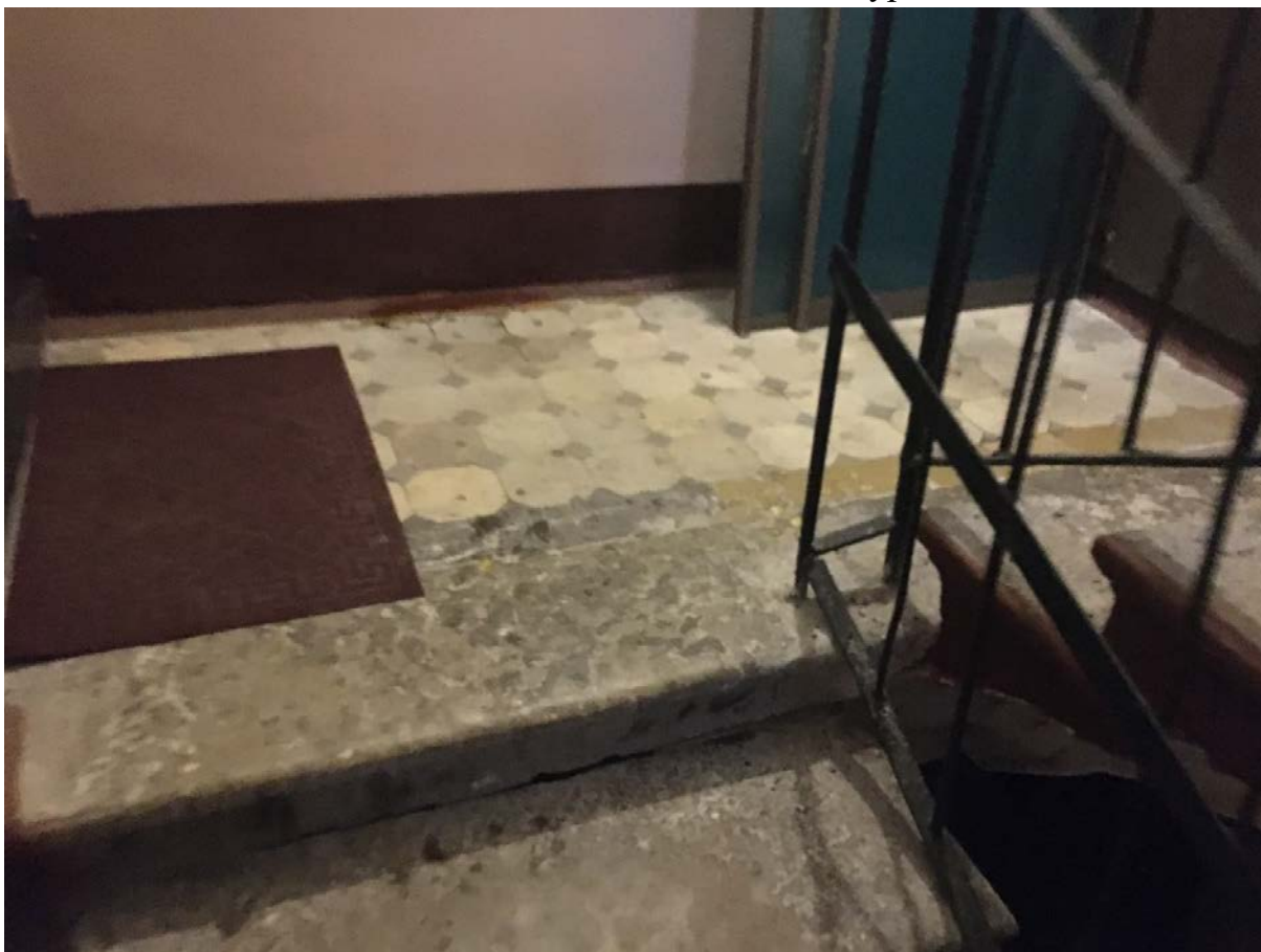
Фото 92. Вид на пол лестничной площадки 5ЛК в уровне 1-го этажа.
