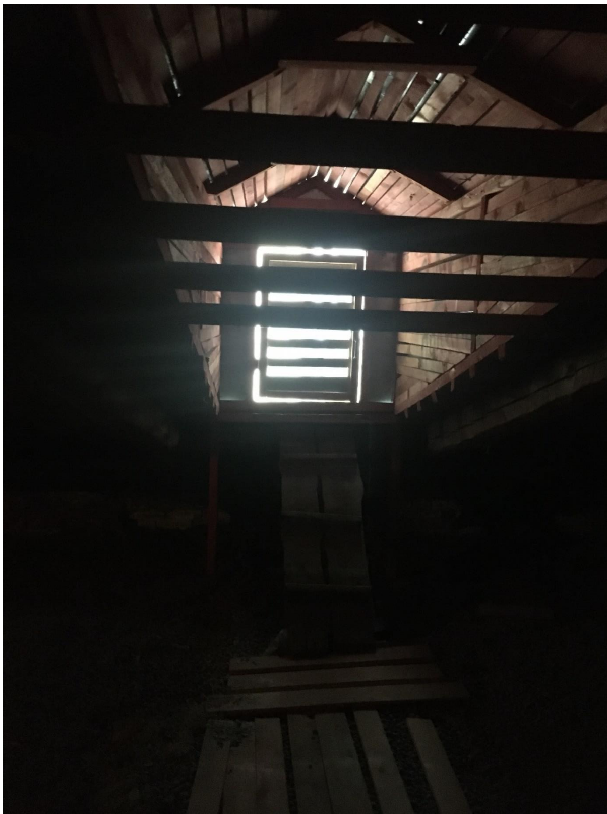
Фото 109. Интерьер чердачных помещений, вид слуховое окно.
