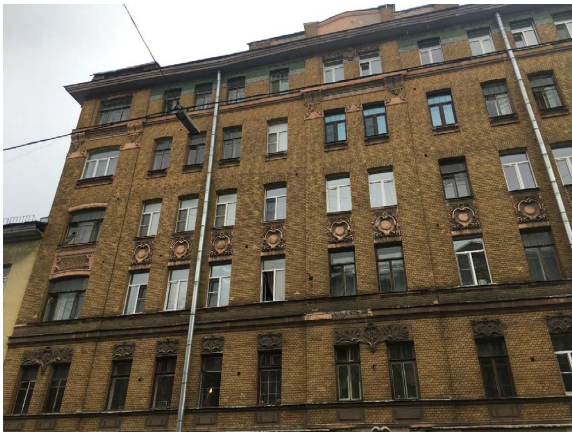
Фото 3. Вид на северную и центральную части западного фасада лицевого корпуса, верхняя часть.
