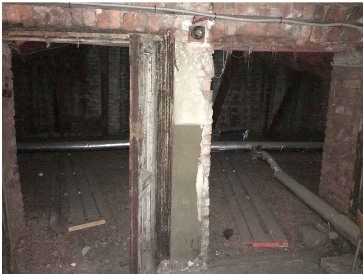
Фото 106. Интерьер чердачных помещений.
