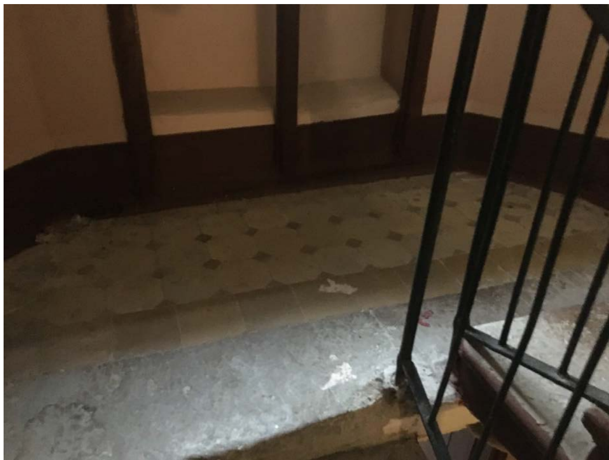
Фото 93. Вид на пол междуэтажной площадки 5ЛК в уровне 1-го – 2-го этажей.
