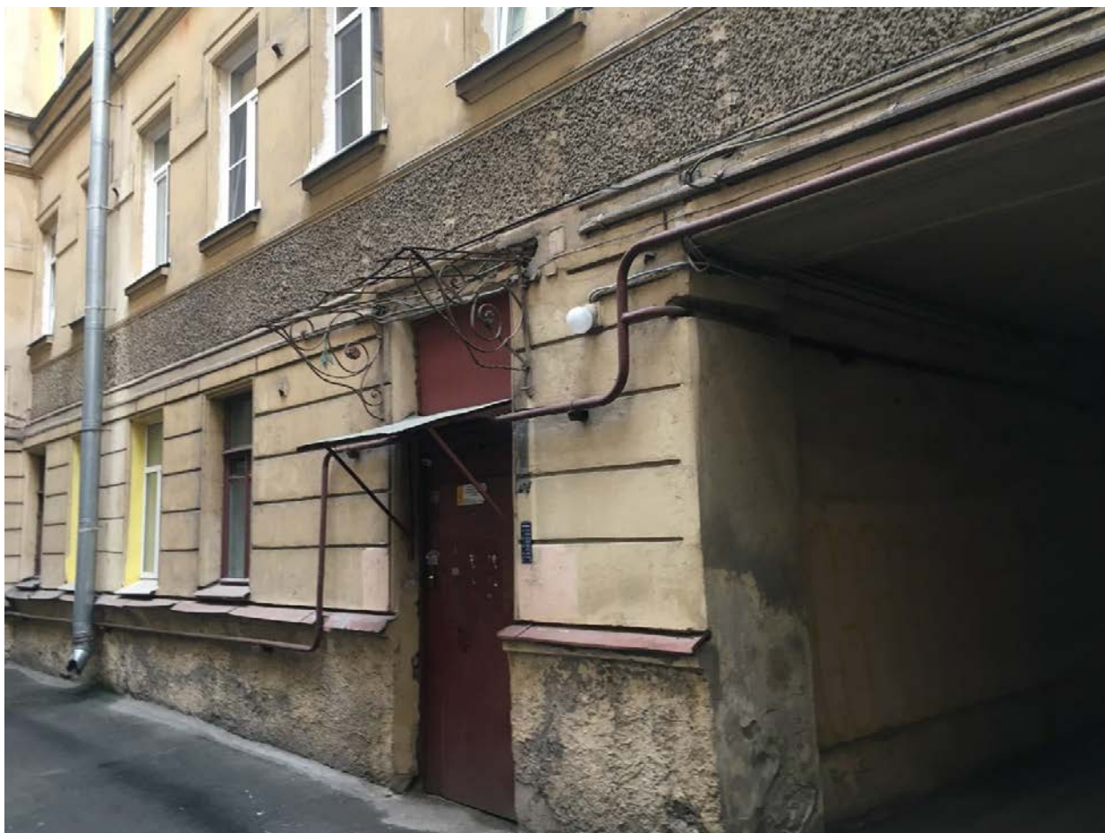
Фото 15. Вход в 2ЛК.
