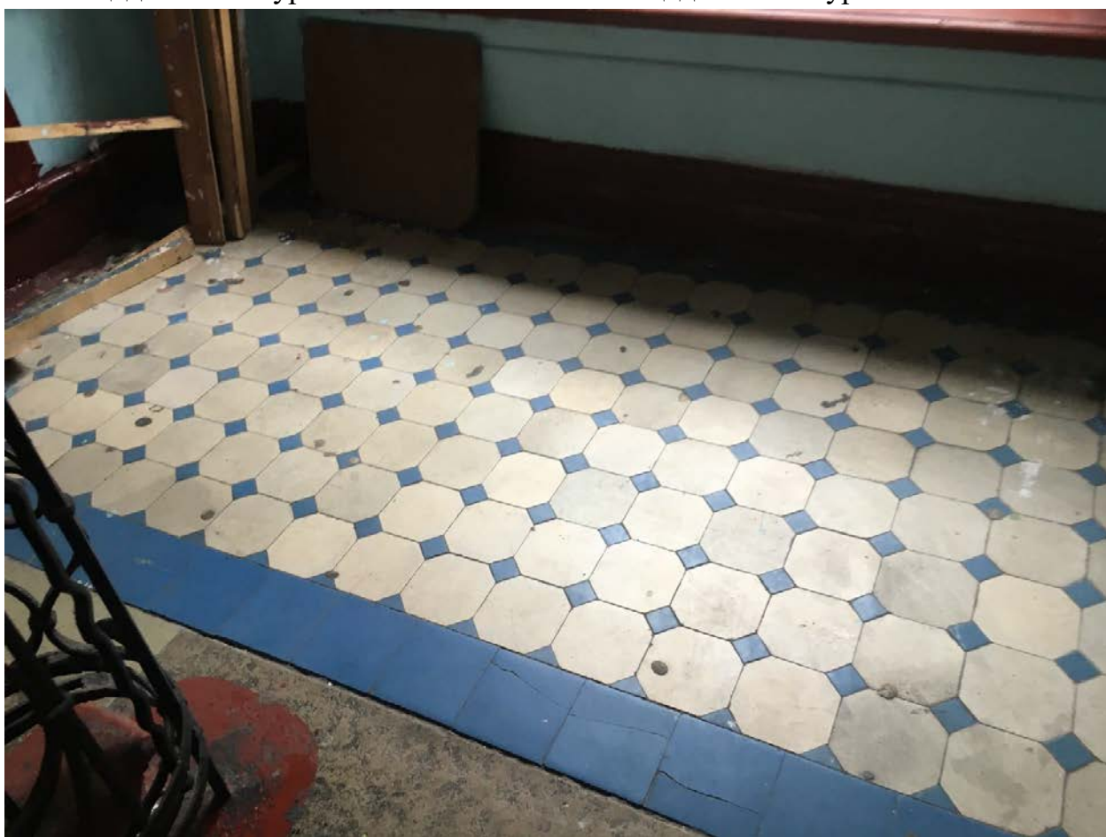
Фото 55. Вид на пол междуэтажной площадки 1ЛК в уровне 3-го – 4-го этажей.
