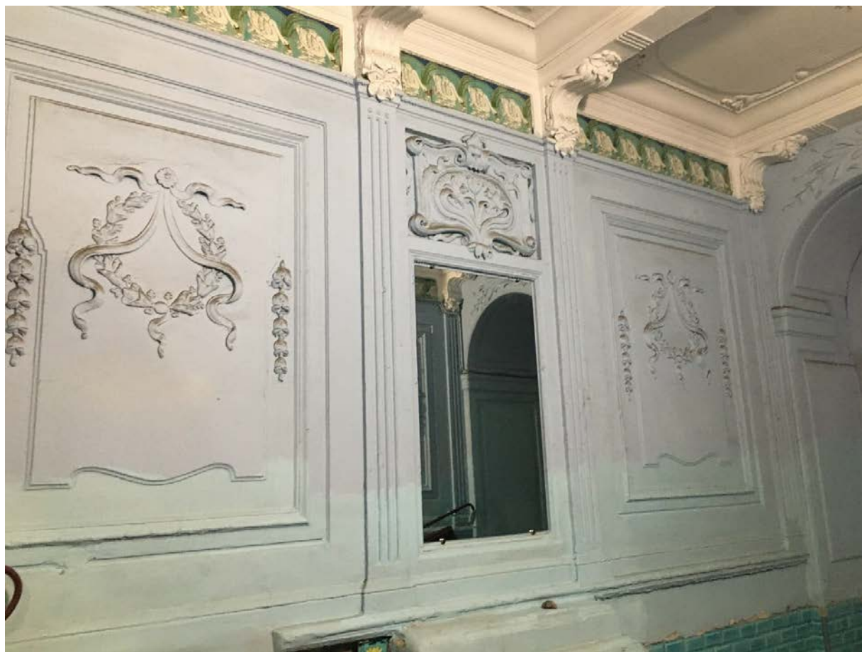
Фото 31. Вид на северную стену вестибюля 1ЛК.
