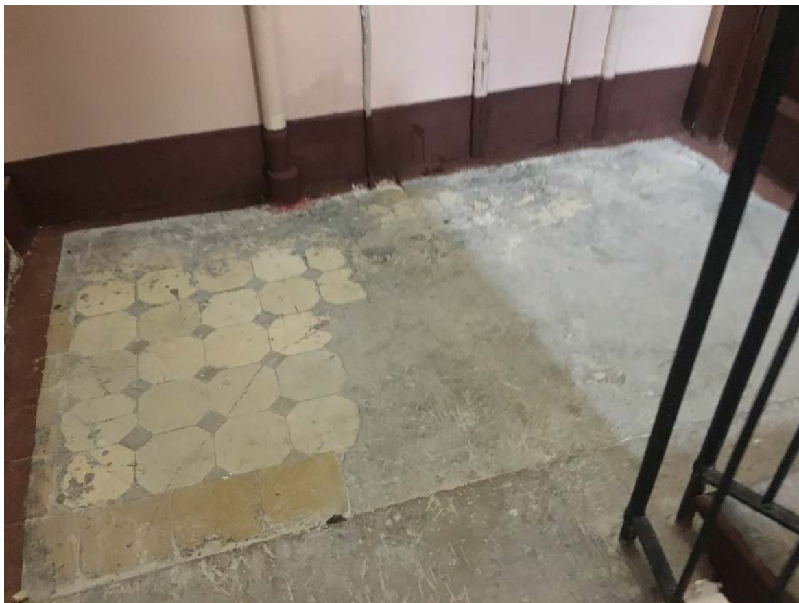
Фото 102. Вид на пол лестничной площадки в уровне 4-го этажа.
