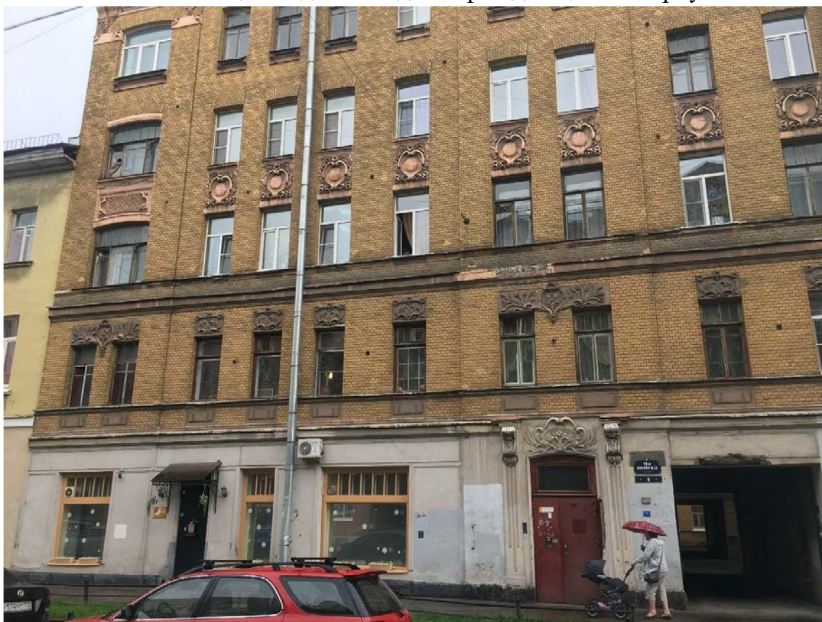
Фото 2. Вид на западную и центральную части западного фасада лицевого корпуса.
