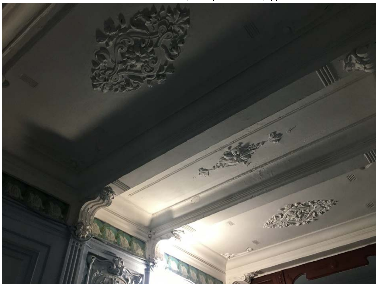
Фото 36. Вид на потолок вестибюля 1ЛК.
