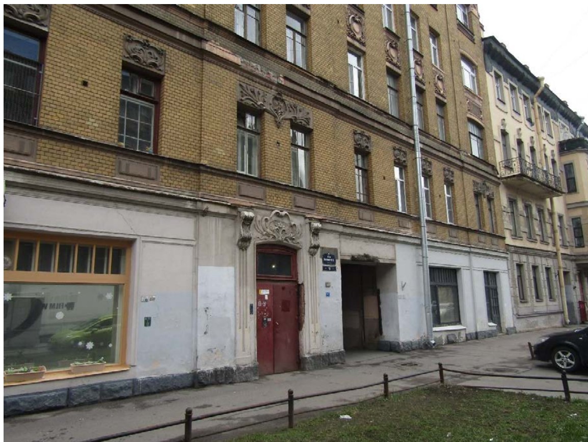
Фото 5. Вид на центральную и южную части западного фасада лицевого корпуса в уровне 1-го – 3-го этажей.
