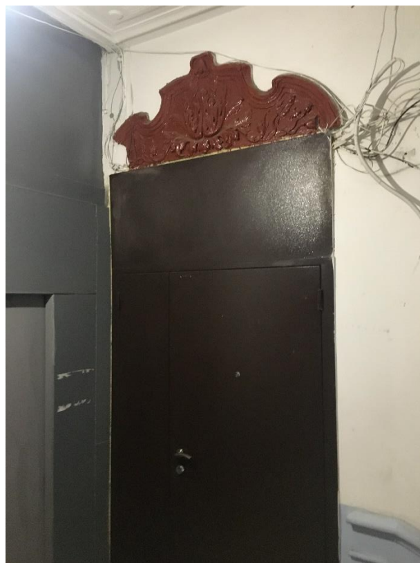
Фото 54. Вид на двери лестничной площадки 1ЛК в уровне 3-го этажа.
