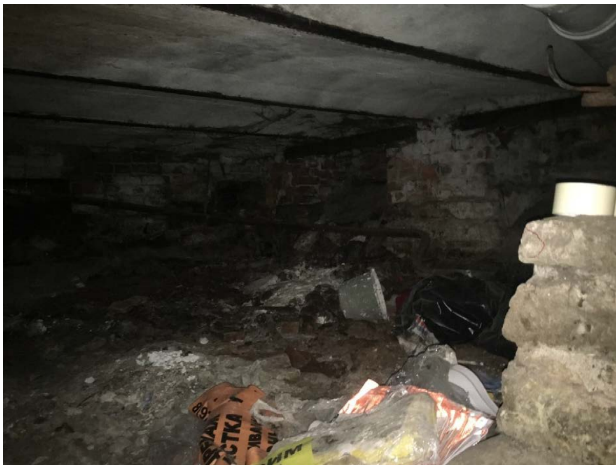
Фото 27. Интерьер подвальных помещений.
