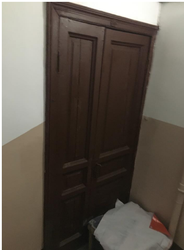
Фото 96. Вид на двери лестничной площадки 5ЛК в уровне 2-го этажа.
