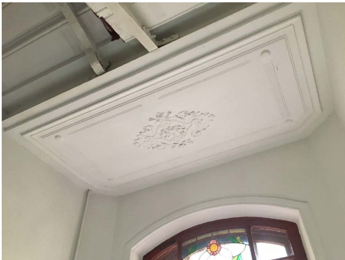
Фото 57. Вид на потолок междуэтажной площадки 1ЛК в уровне 3-го – 4-го этажей.
