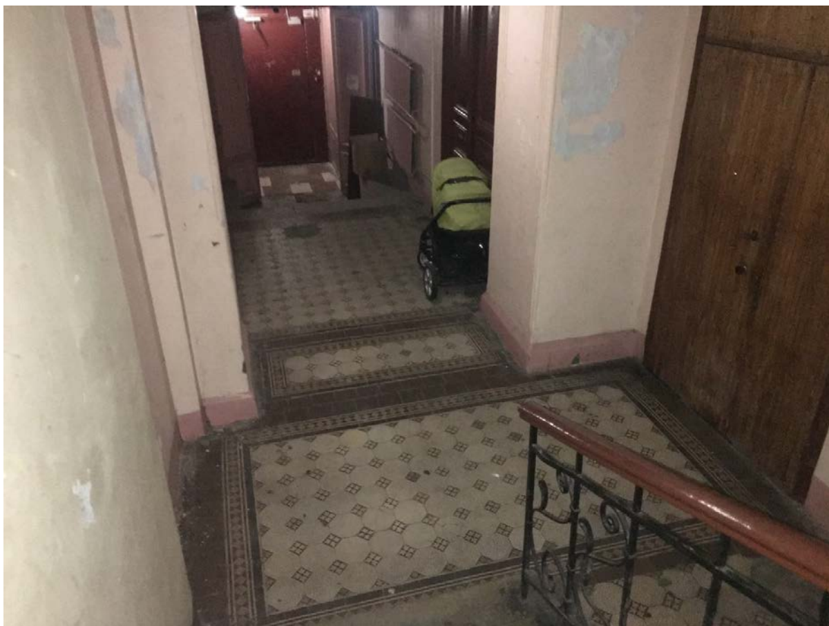
Фото 70. Вид на лестничную площадку и вестибюль 2ЛК.
