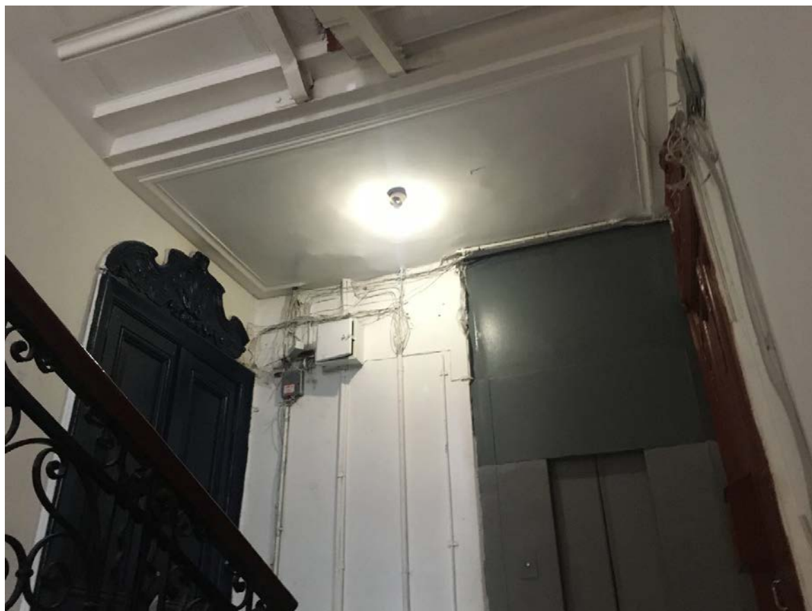
Фото 58. Вид на лестничную площадку 1ЛК в уровне 4-го этажа.
