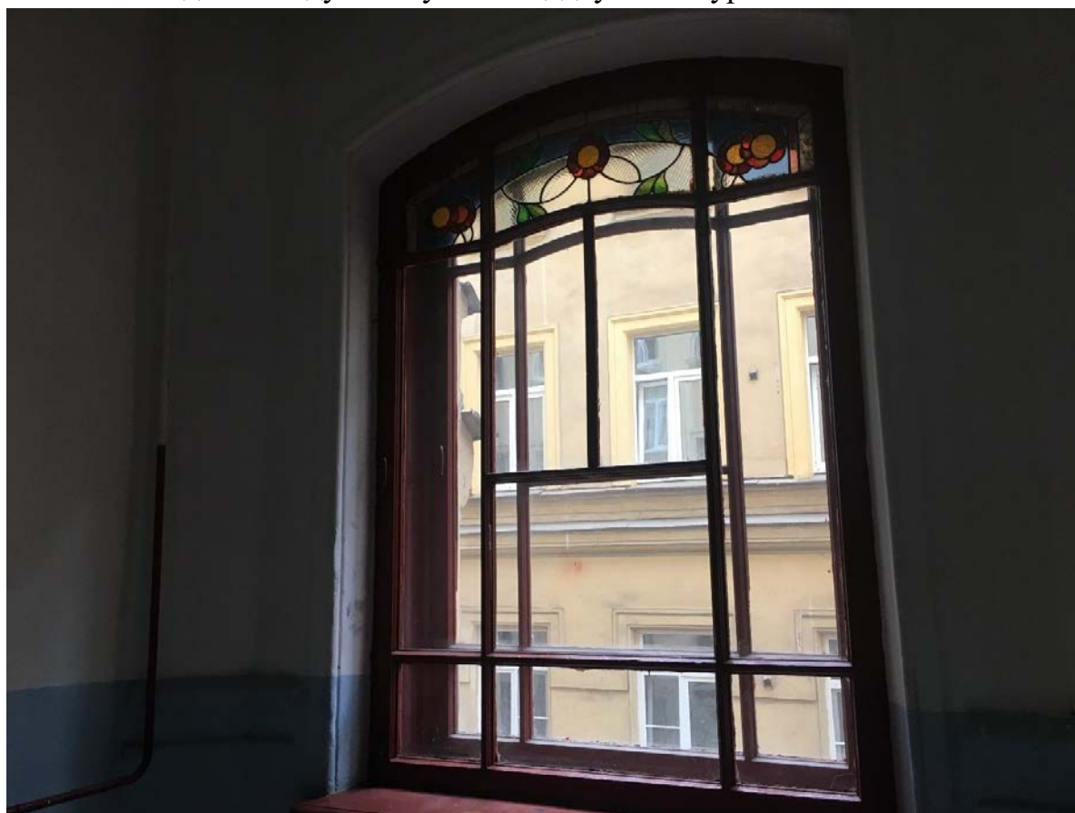
Фото 48. Оконный проем междуэтажной площадки 1ЛК в уровне 2-го – 3-го этажей.
