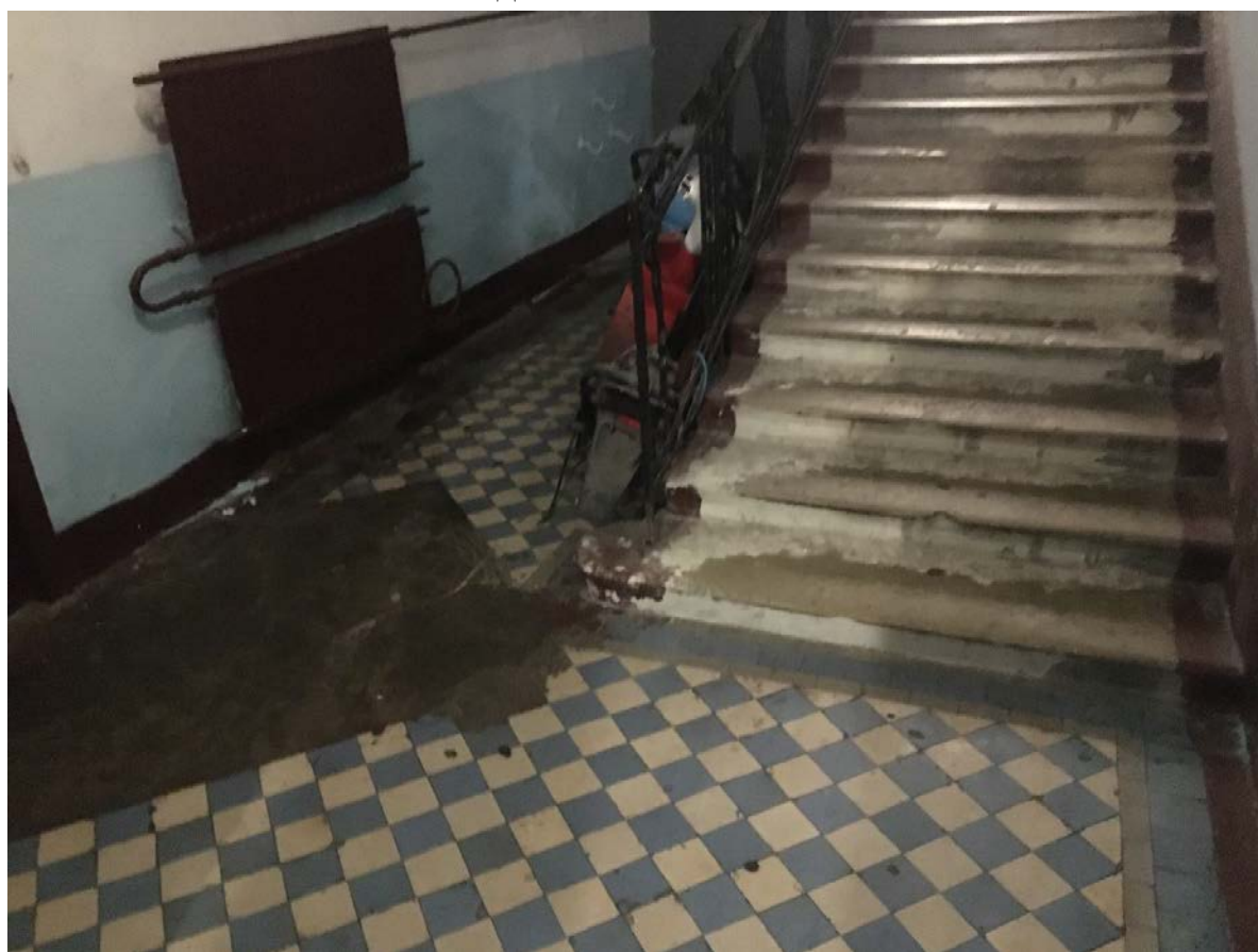
Фото 38. Вид на лестничную клетку 1ЛК в уровне 1-го этажа.
