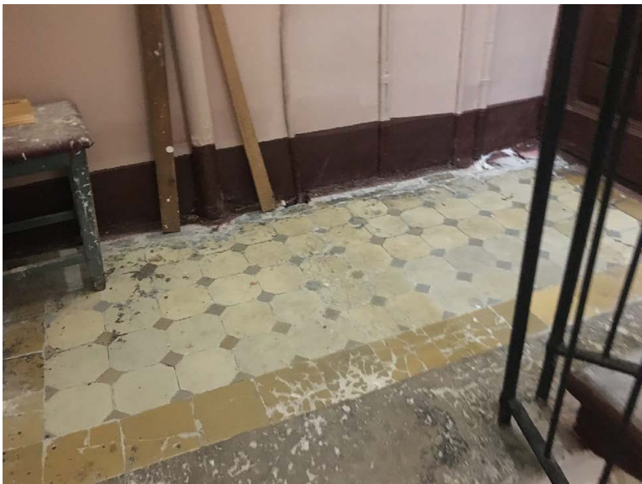
Фото 100. Вид на пол лестничной площадки 5ЛК в уровне 3-го этажа.
