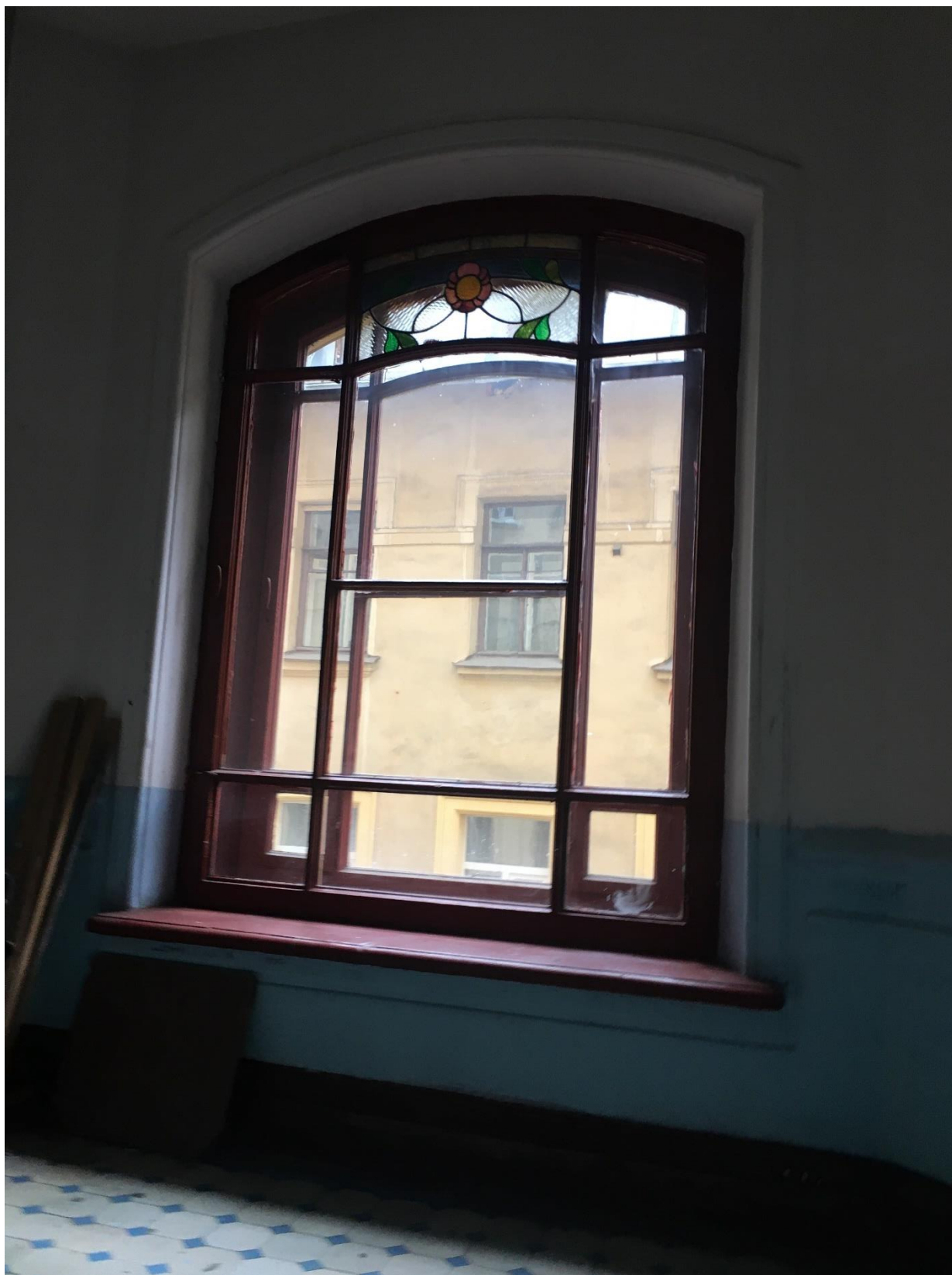
Фото 56. Вид на оконный проем междуэтажной площадки 1ЛК в уровне 3-го – 4-го этажей.
