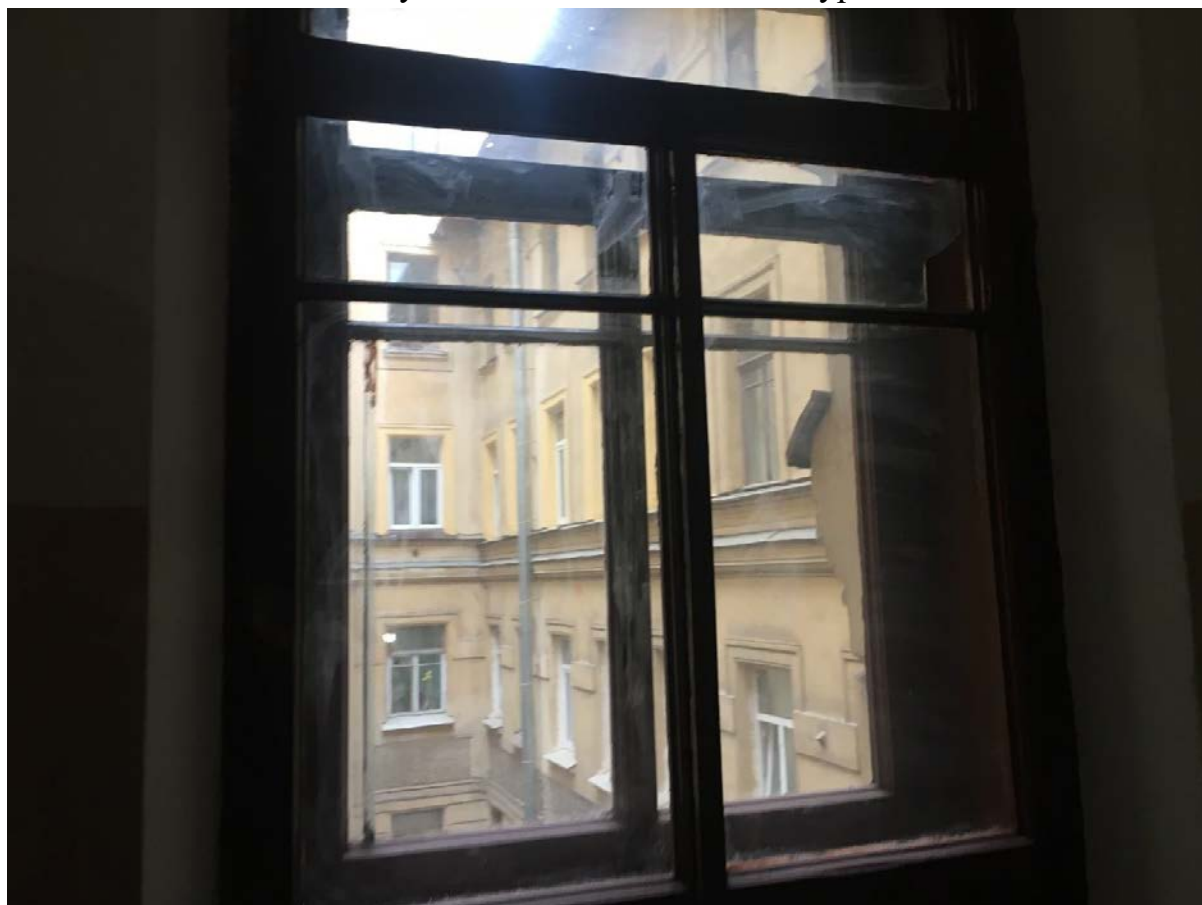
Фото 99. Вид на окно междуэтажной площадки 5ЛК в уровне 2-го – 3-го этажей.
