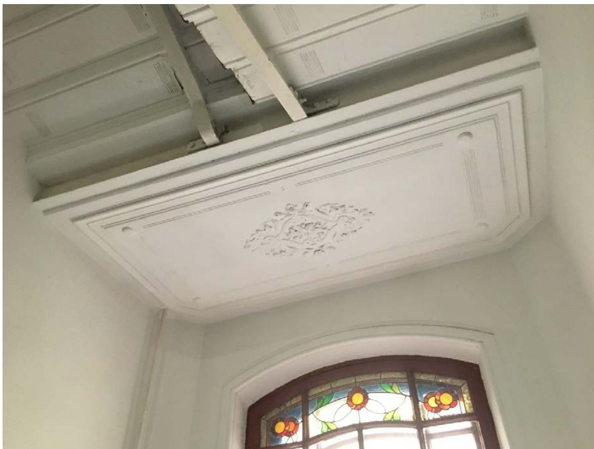
Фото 49. Вид на потолок междуэтажной площадки 1ЛК в уровне 2-го – 3-го этажей.
