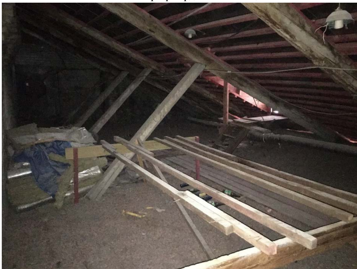
Фото 113. Интерьер чердачных помещений.
