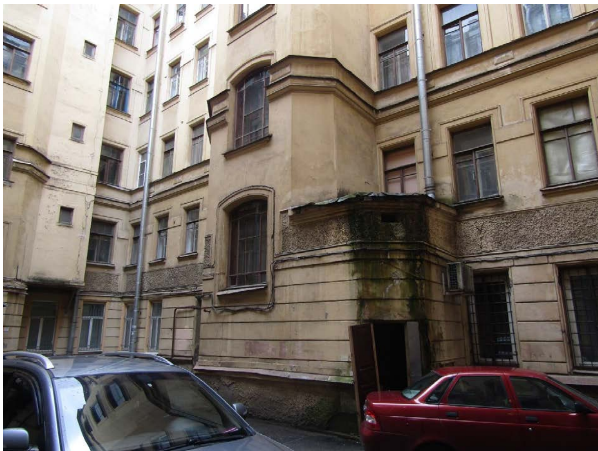
Фото 13. Вид на восточный фасад лицевого корпуса в уровне 1-го – 3-го этажей.
