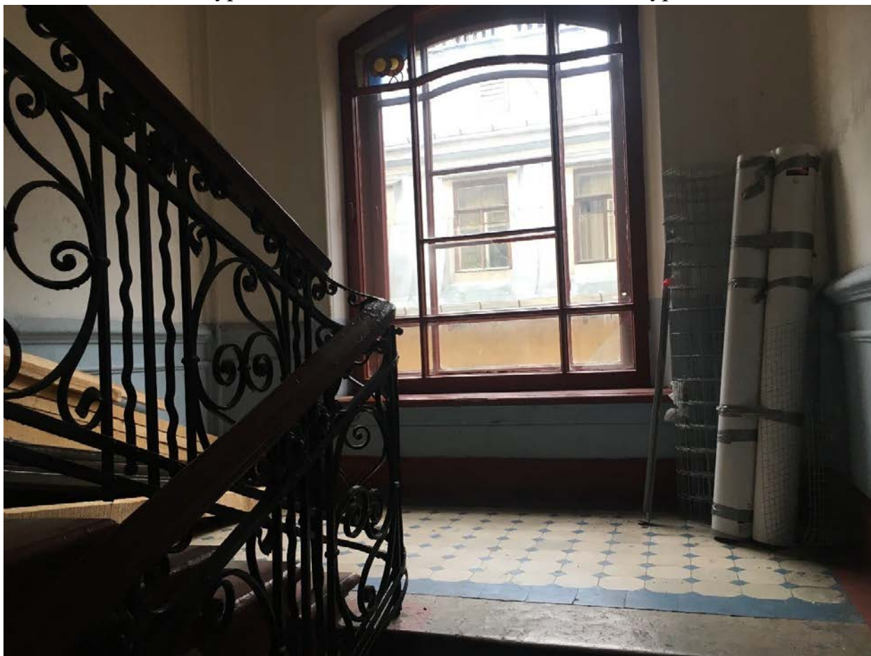
Фото 61. Вид на междуэтажную площадку 1ЛК в уровне 4-го – 5-го этажей.
