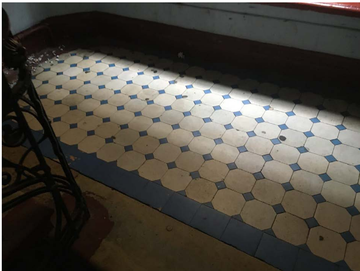
Фото 41. Пол междуэтажной площадки в уровне 1-го – 2-го этажей 1ЛК.
