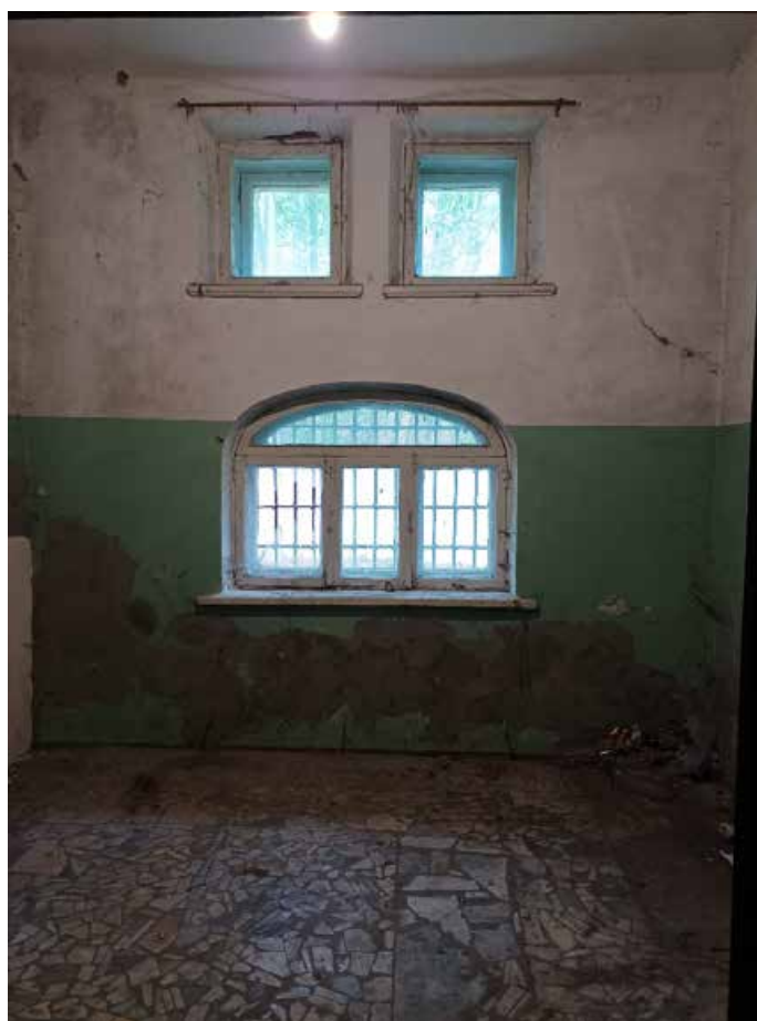
20. Выявленный объект культурного наследия «Здание Константиновской обсерватории», по адресу: Санкт-Петербург, г. Павловск, ул. Садовая, д. 49, лит. Б. Тамбур. Дата съемки: 15.08.2022г.
