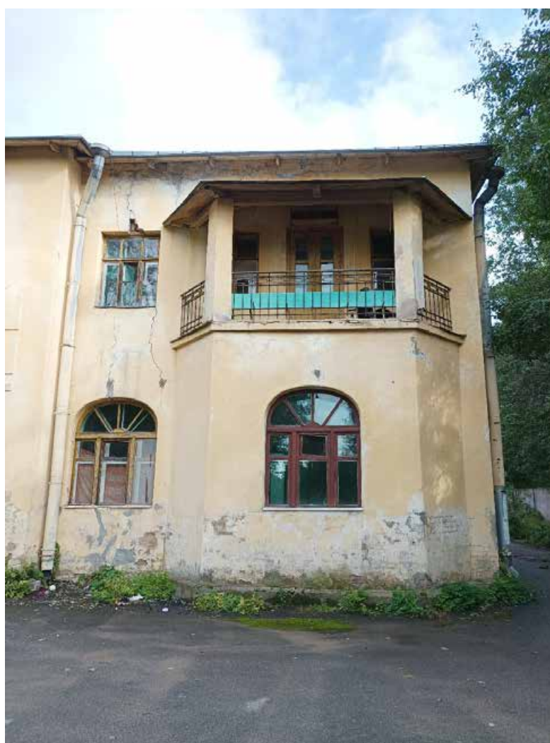
3. Выявленный объект культурного наследия «Здание Константиновской обсерватории», по адресу: Санкт-Петербург, г. Павловск, ул. Садовая, д. 49, лит. Б. Фрагмент фасада. Дата съемки: 15.08.2022г.
