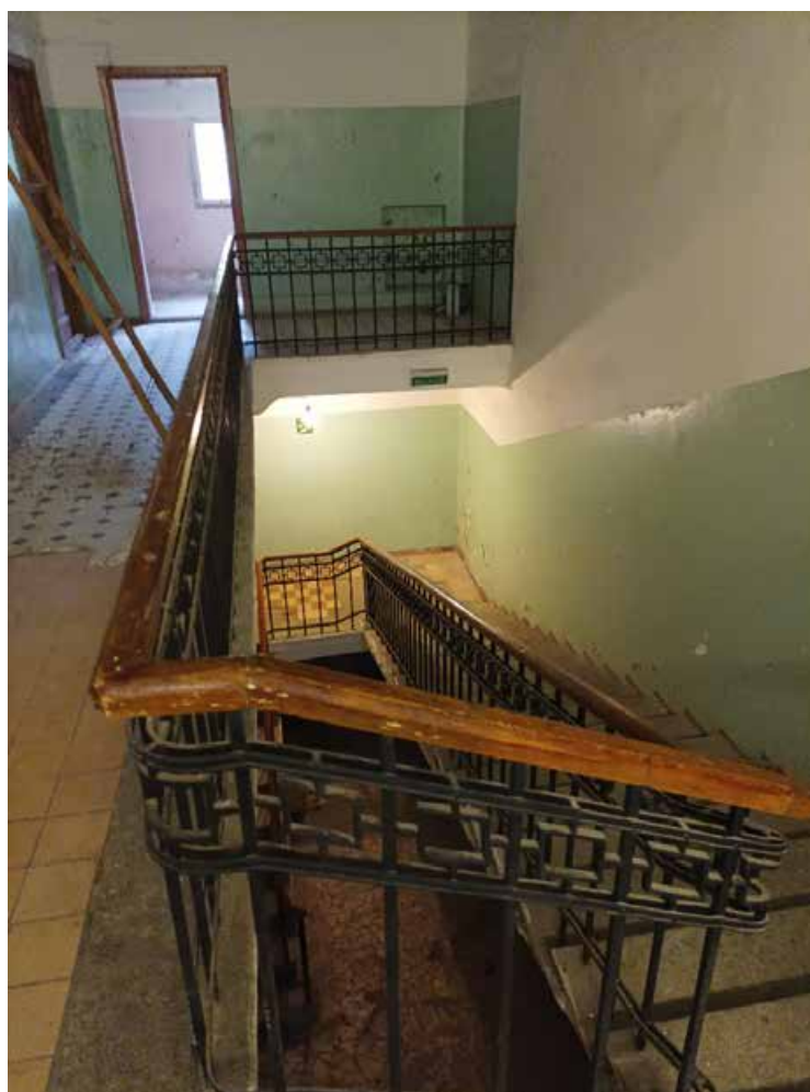
25. Выявленный объект культурного наследия «Здание Константиновской обсерватории», по адресу: Санкт-Петербург, г. Павловск, ул. Садовая, д. 49, лит. Б. Лестничная клетка. Дата съемки: 15.08.2022г.
