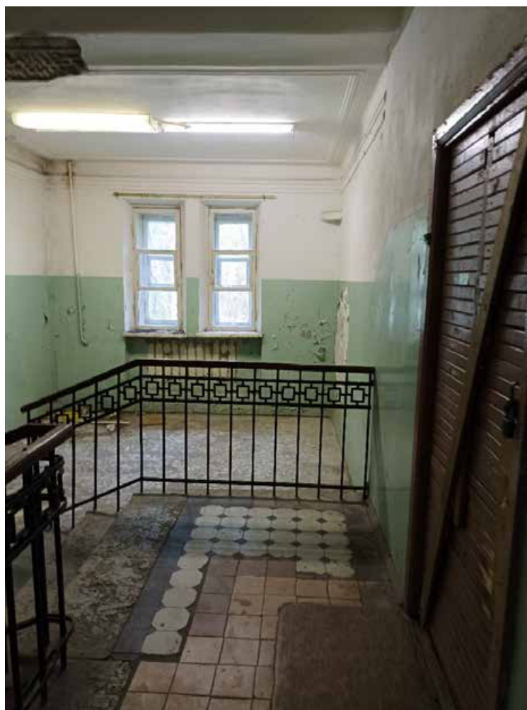
24. Выявленный объект культурного наследия «Здание Константиновской обсерватории», по адресу: Санкт-Петербург, г. Павловск, ул. Садовая, д. 49, лит. Б. Лестничная клетка. Дата съемки: 15.08.2022г.
