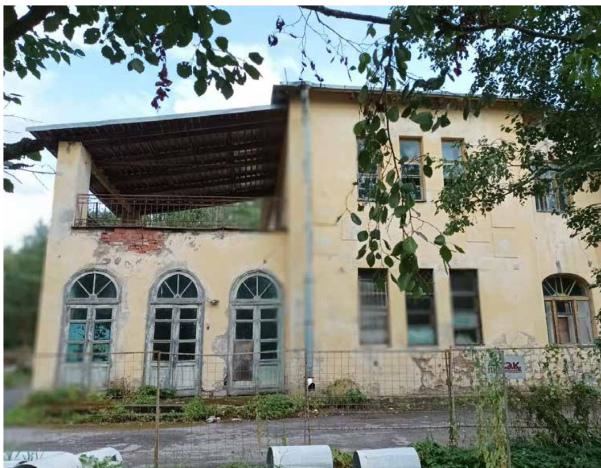
12. Выявленный объект культурного наследия «Здание Константиновской обсерватории», по адресу: Санкт-Петербург, г. Павловск, ул. Садовая, д. 49, лит. Б. Фрагмент фасада. Дата съемки: 15.08.2022г.
