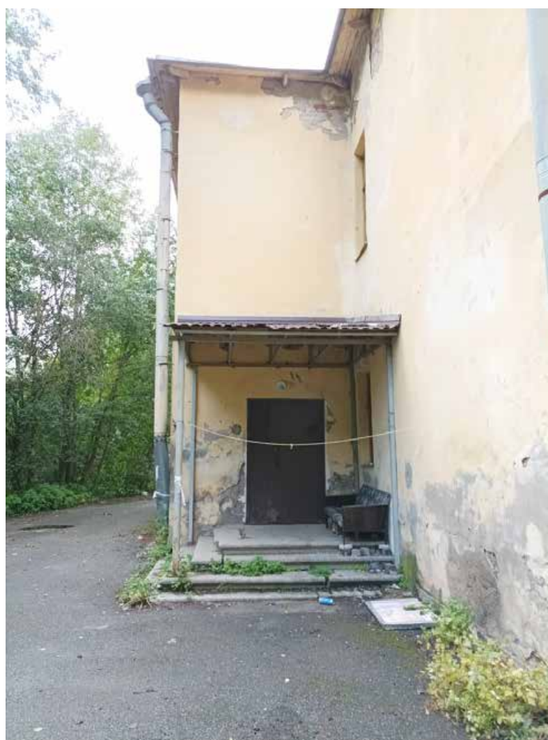
7. Выявленный объект культурного наследия «Здание Константиновской обсерватории», по адресу: Санкт-Петербург, г. Павловск, ул. Садовая, д. 49, лит. Б. Фрагмент фасада. Дата съемки: 15.08.2022г.
