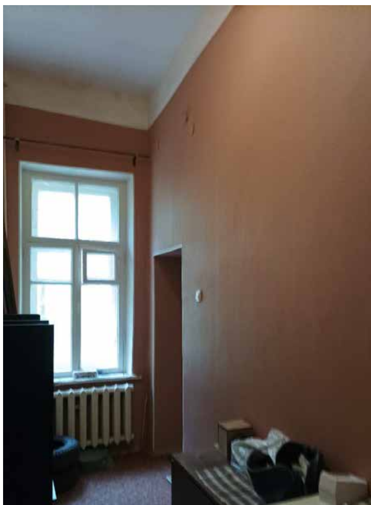
28. Выявленный объект культурного наследия «Здание Константиновской обсерватории», по адресу: Санкт-Петербург, г. Павловск, ул. Садовая, д. 49, лит. Б. Помещение второго этажа. Дата съемки: 15.08.2022г.
