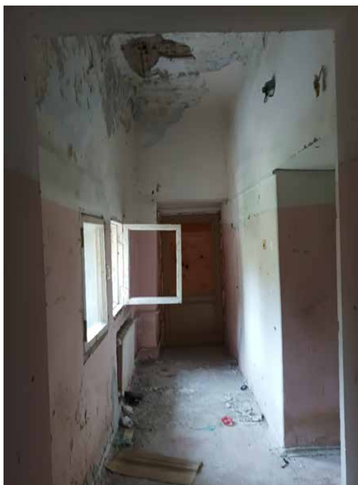
27. Выявленный объект культурного наследия «Здание Константиновской обсерватории», по адресу: Санкт-Петербург, г. Павловск, ул. Садовая, д. 49, лит. Б. Коридор. Дата съемки: 15.08.2022г.
