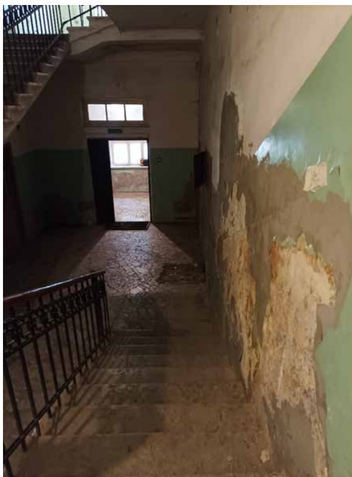
19. Выявленный объект культурного наследия «Здание Константиновской обсерватории», по адресу: Санкт-Петербург, г. Павловск, ул. Садовая, д. 49, лит. Б. Лестничная клетка. Дата съемки: 15.08.2022г.
