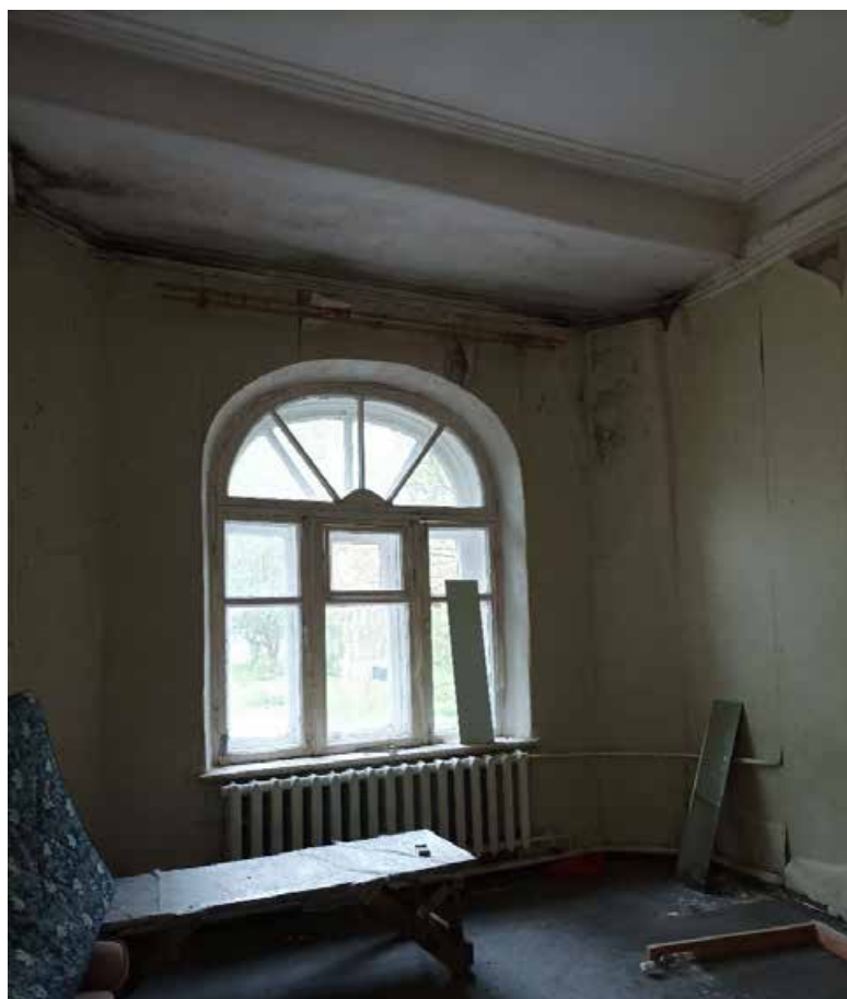
14. Выявленный объект культурного наследия «Здание Константиновской обсерватории», по адресу: Санкт-Петербург, г. Павловск, ул. Садовая, д. 49, лит. Б. Помещение первого этажа. Дата съемки: 15.08.2022г.
