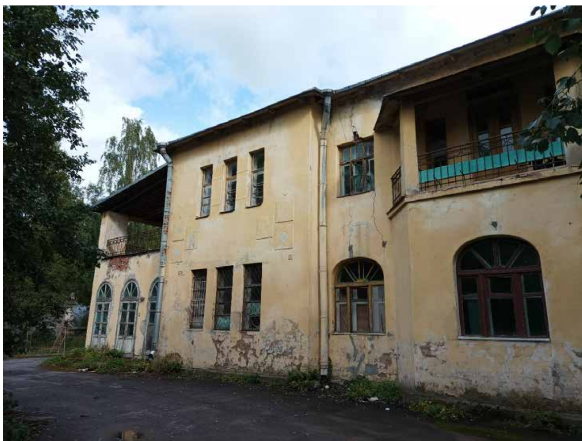
4. Выявленный объект культурного наследия «Здание Константиновской обсерватории», по адресу: Санкт-Петербург, г. Павловск, ул. Садовая, д. 49, лит. Б. Фрагмент фасада. Дата съемки: 15.08.2022г.
