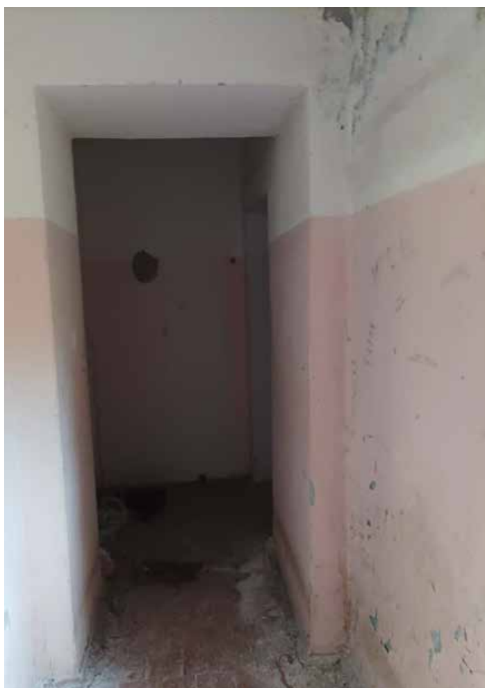
26. Выявленный объект культурного наследия «Здание Константиновской обсерватории», по адресу: Санкт-Петербург, г. Павловск, ул. Садовая, д. 49, лит. Б. Коридор. Дата съемки: 15.08.2022г.
