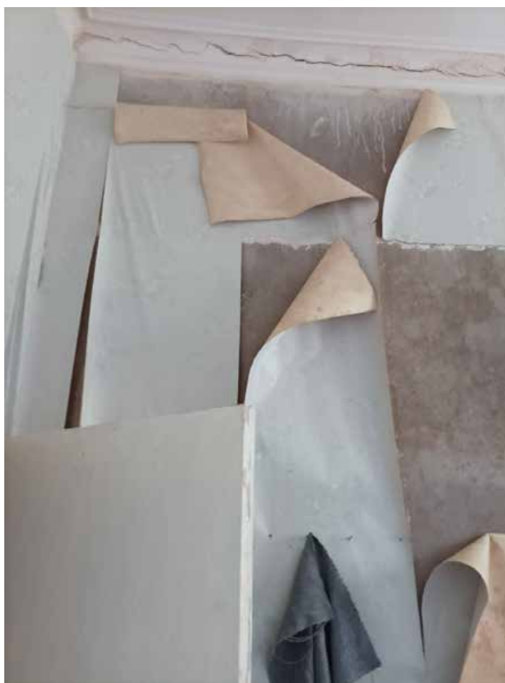
17. Выявленный объект культурного наследия «Здание Константиновской обсерватории», по адресу: Санкт-Петербург, г. Павловск, ул. Садовая, д. 49, лит. Б. Помещение первого этажа. Дата съемки: 15.08.2022г.
