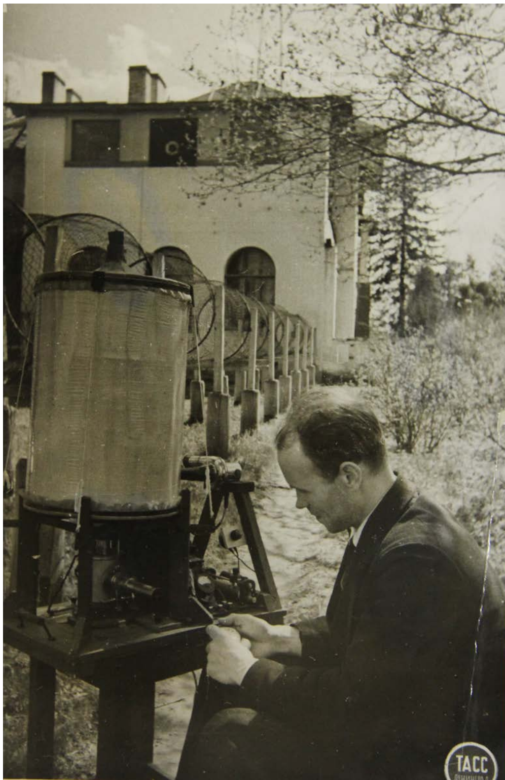
20. Кандидат физико-математических наук Р.А. Аллик, сотрудник отдела атмосферного электричества за исследованием процесса образования ионов в сконструированном им приборе. 31 мая 1941 г. ЦГА КФФД СПб. Шифр: Ар 9169
