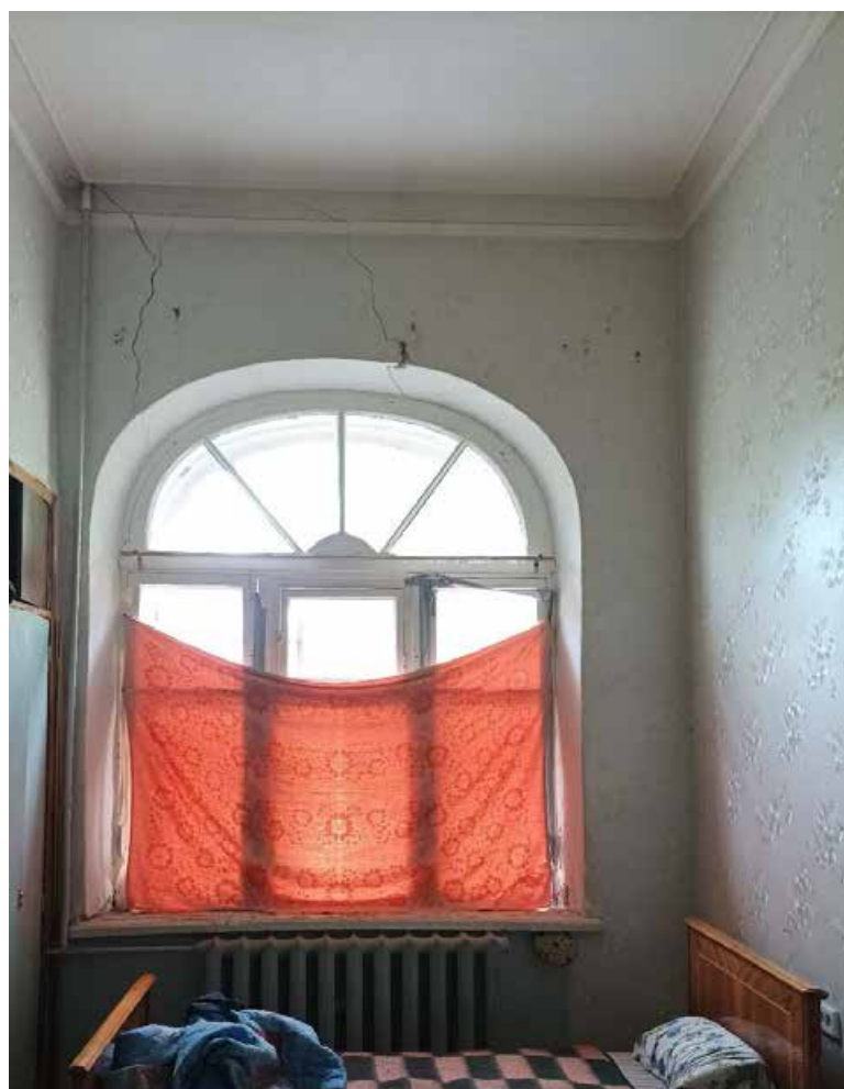
16. Выявленный объект культурного наследия «Здание Константиновской обсерватории», по адресу: Санкт-Петербург, г. Павловск, ул. Садовая, д. 49, лит. Б. Помещение первого этажа. Дата съемки: 15.08.2022г.
