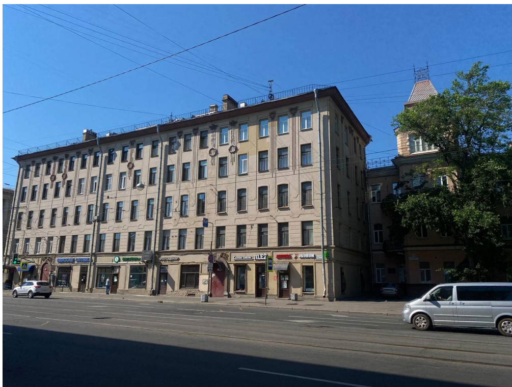
Фото №3. Лицевой фасад по ул. Большая Пороховская.
