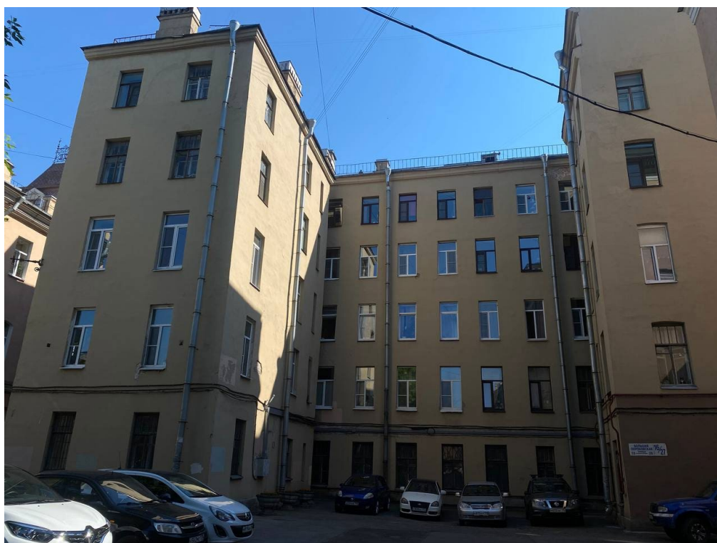
Фото №6. Дворовой фасад, западный фасад флигеля.
