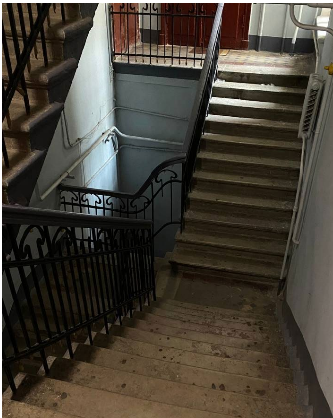
Фото №16. Вид с площадки 2 этажа на междуэтажную площадку 1 и 2 этажа.
