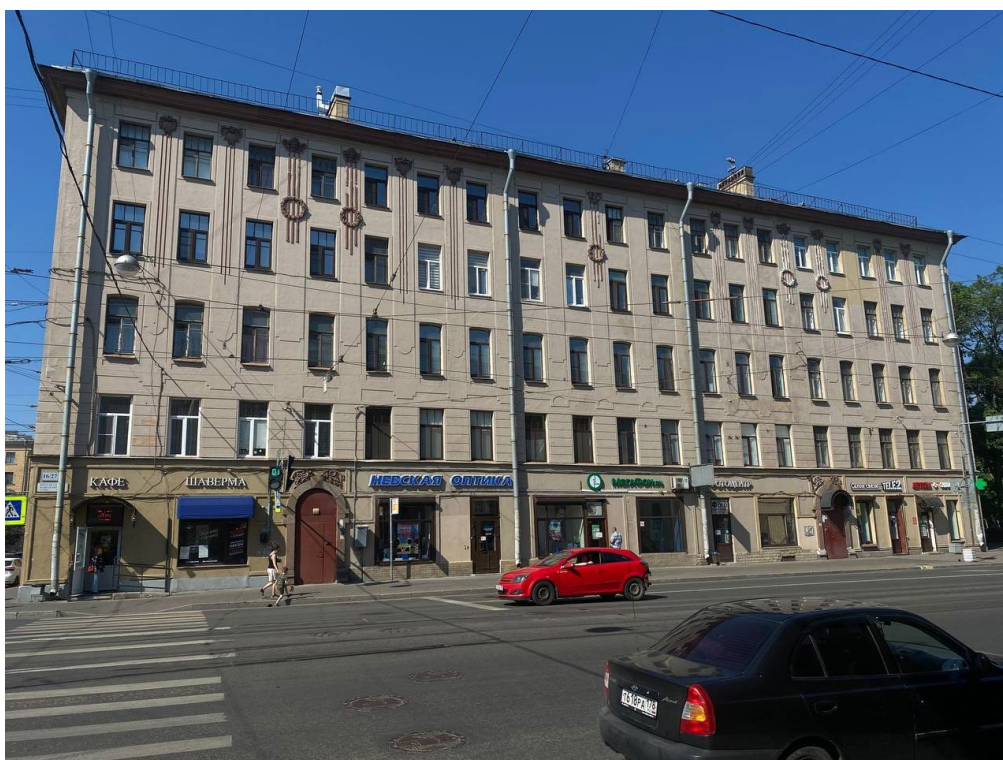
Фото №2. Лицевой фасад по Большой Пороховской ул., вид с перекрестка.
