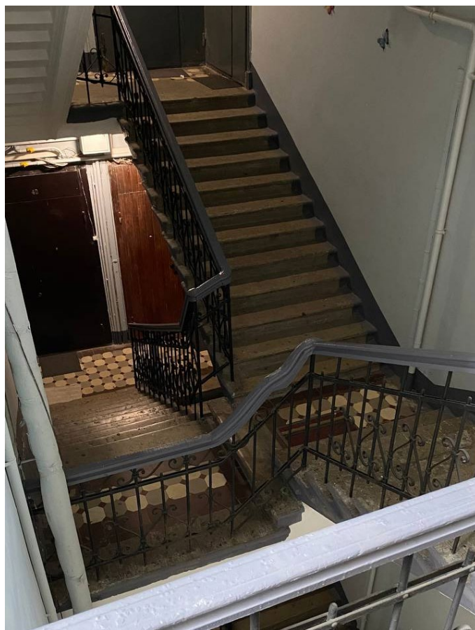
Фото №41. Вид с площадки 5 этажа на 4 этаж.
