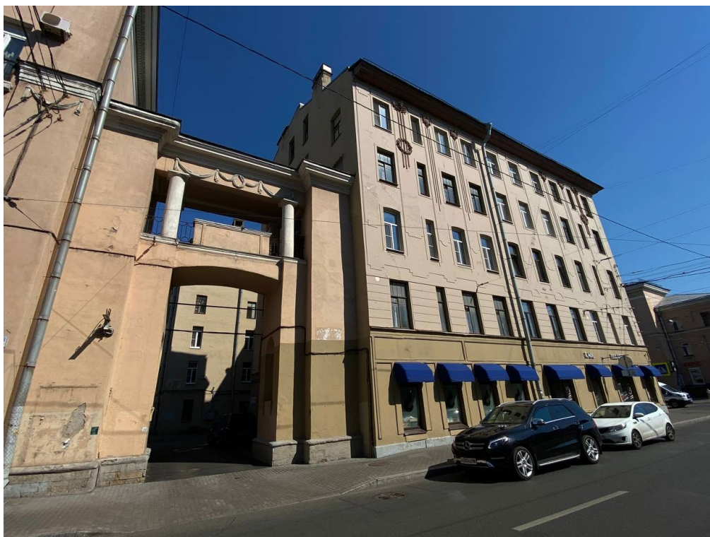
Фото №9. Лицевой фасад по Среднеохтинскому проспекту, арка во двор.
