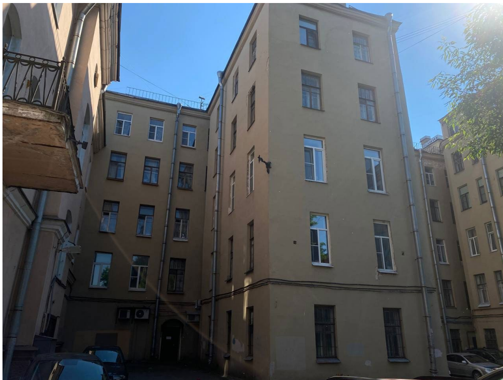
Фото №5. Дворовой фасад, восточный фасад флигеля.
