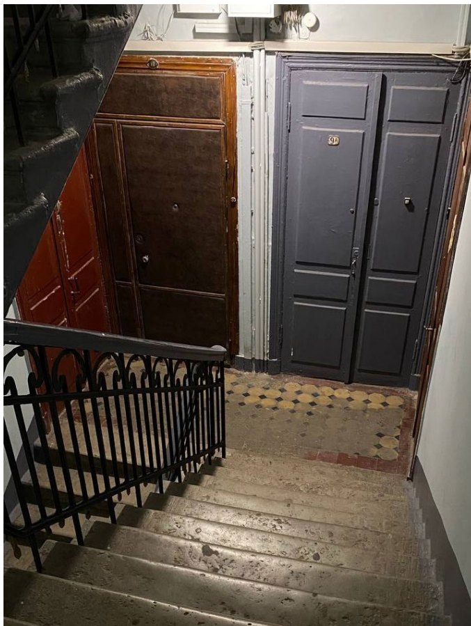
Фото №21. Квартиры 3 этажа, площадка 3 этажа.
