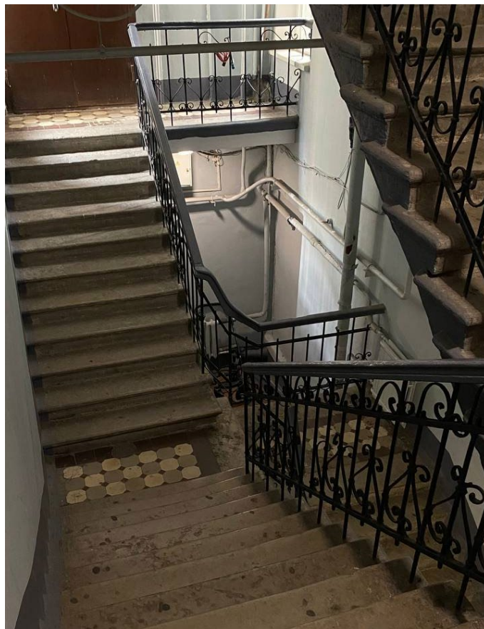
Фото №32. Вид с площадки 2 этажа на междуэтажную площадку 1 и 2 этажа.
