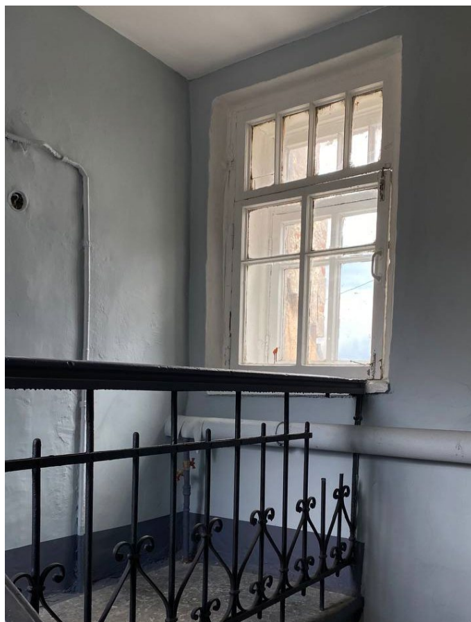
Фото №45. Оконный проем лестничной площадки на 6 этаже.
