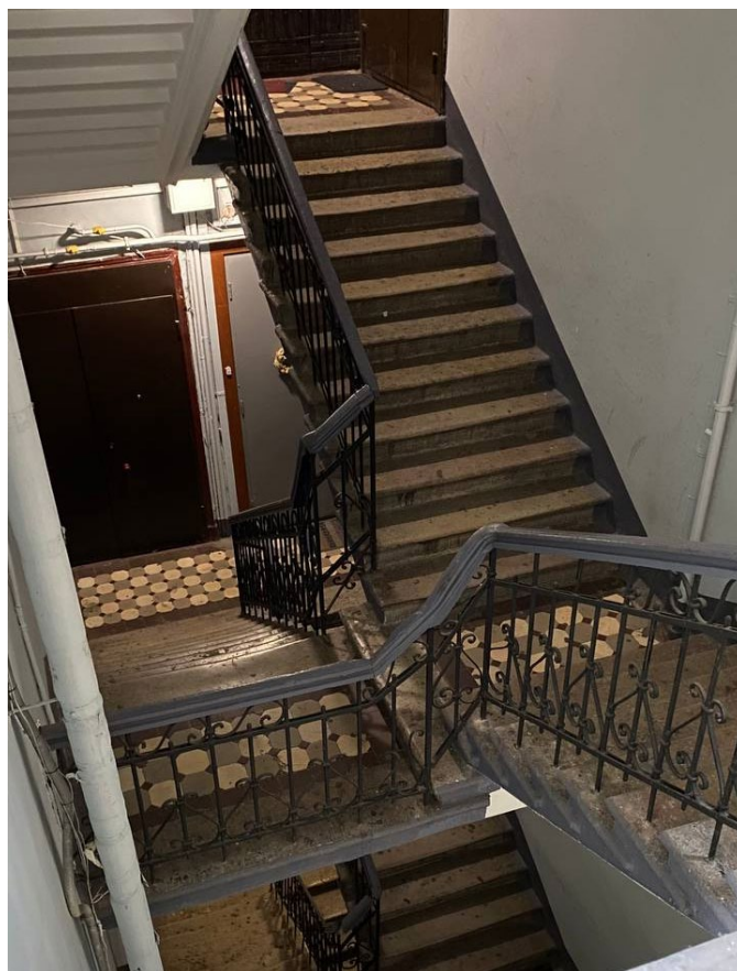
Фото №34. Вид с площадки 3 этажа на 2 этаж. Метлахская плитка междуэтажной площадок
