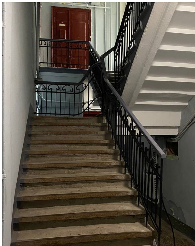
Фото №13. Лестница с известняковыми ступенями на 2 этаж, вид от тамбура.
