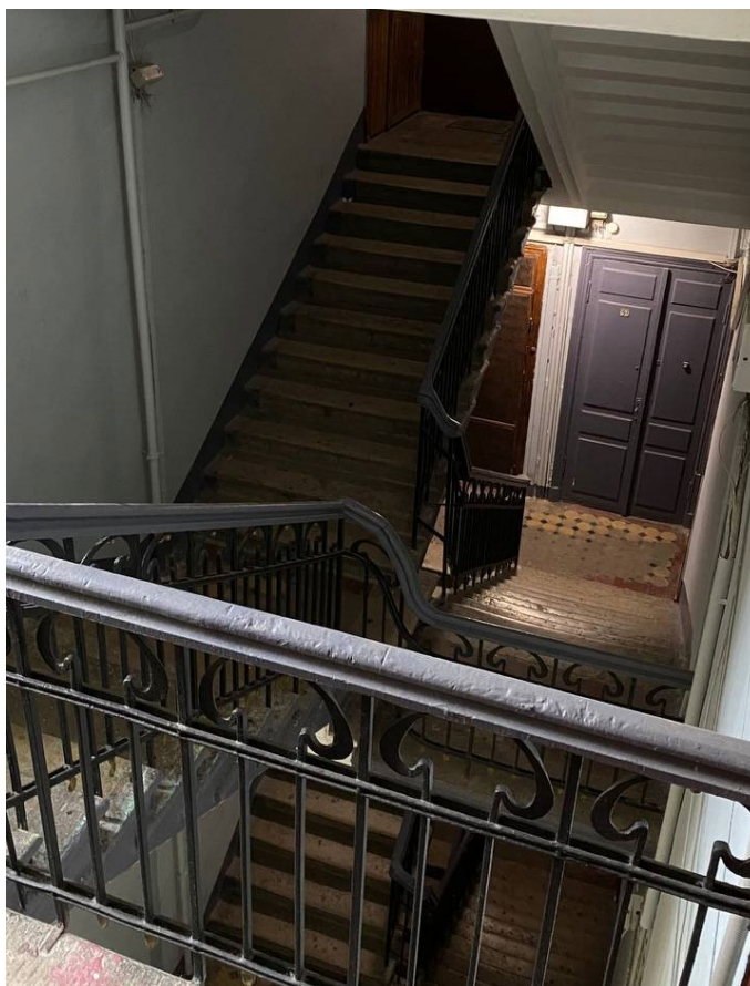
Фото №22. Вид с площадки 4 этажа на 3 этаж.
