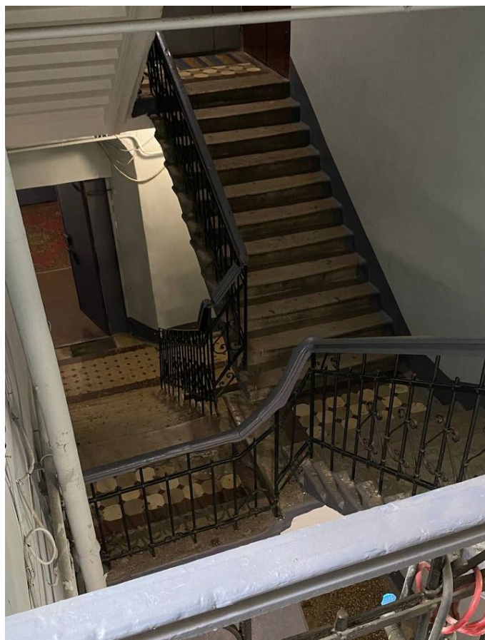
Фото №31. Вид с площадки 2 этажа на 1 этаж, тамбур.
