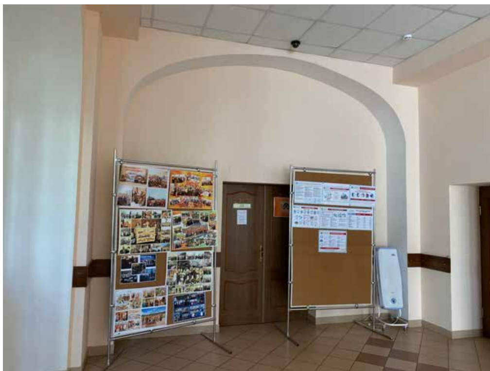
Фото №32. Зашивка исторической светопрозрачной перегородки на втором этаже главного корпуса в осях 1-2.
