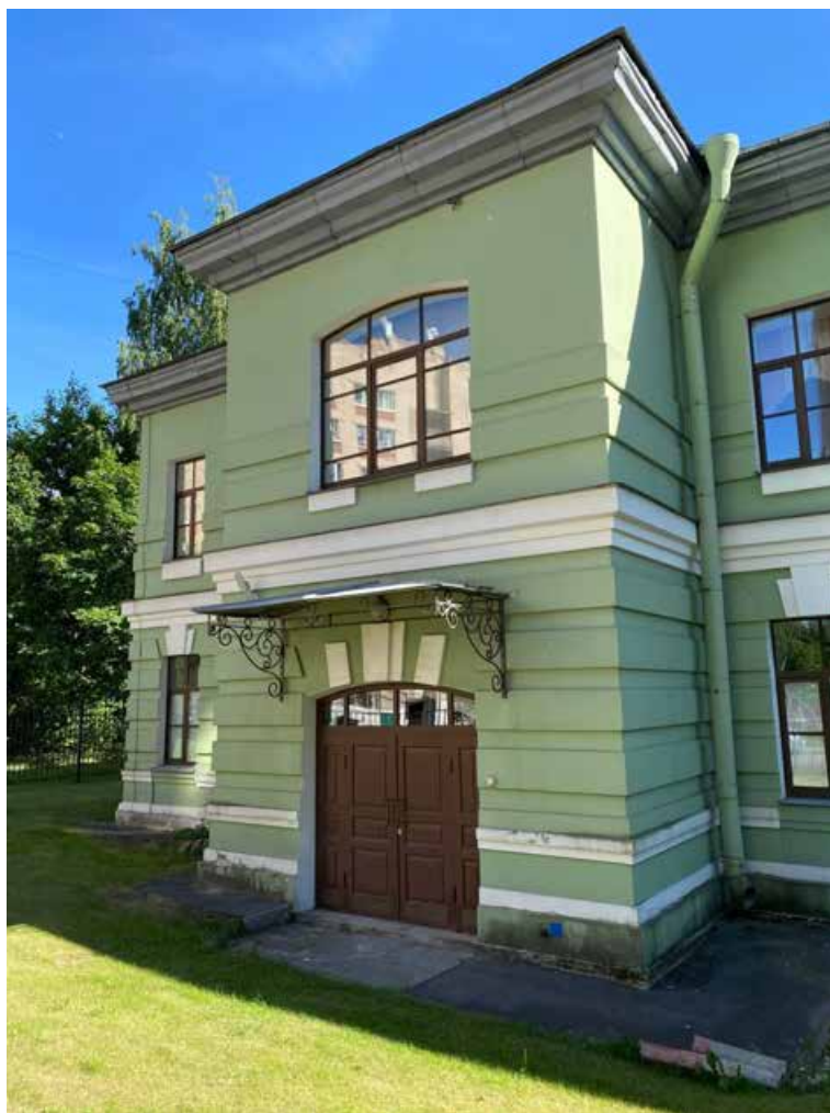
Фото №5. Вход в здание с северной стороны в осях 7-8.
