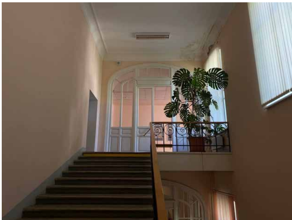
Фото №31. Главная лестница, площадка второго этажа, историческое заполнение дверных проемов.
