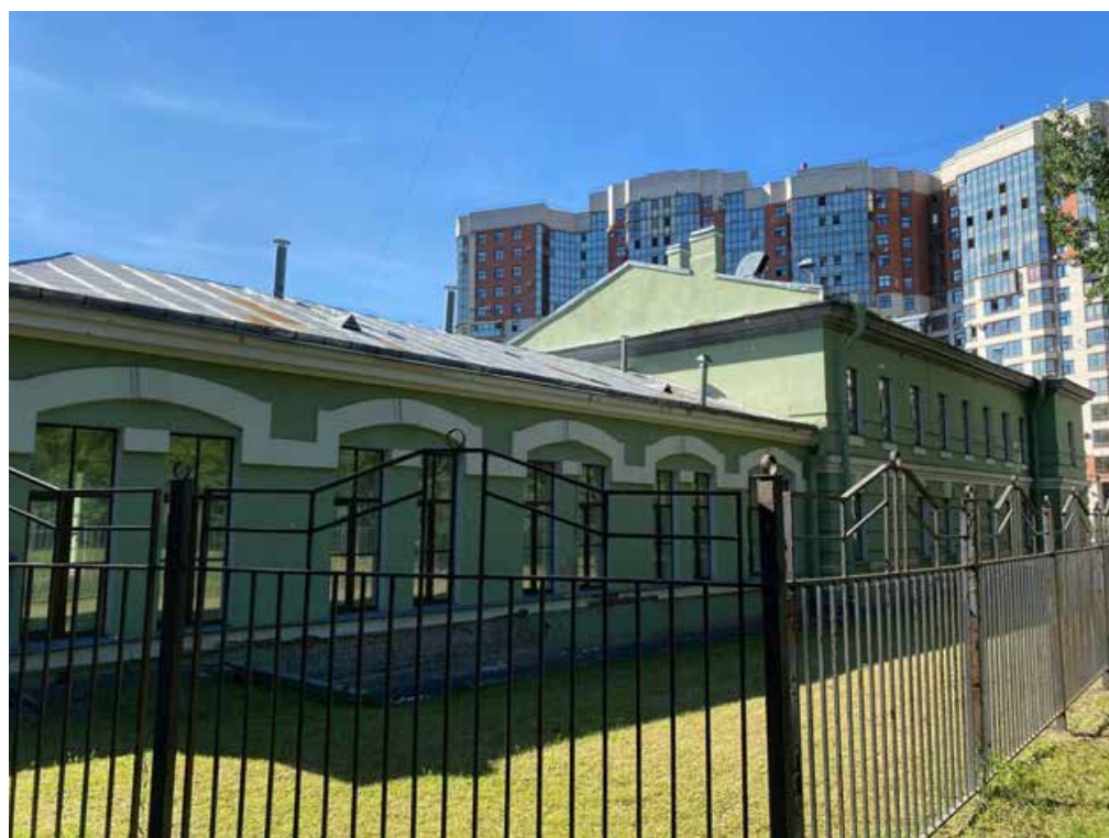
Фото №2. Восточный фасад здания в осях Б-Е.
