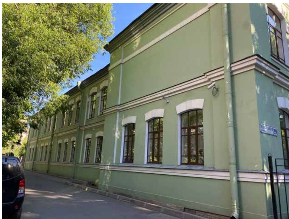
Фото №8. Северный фасад здания в осях 1-5, вид от северо-западного угла.
