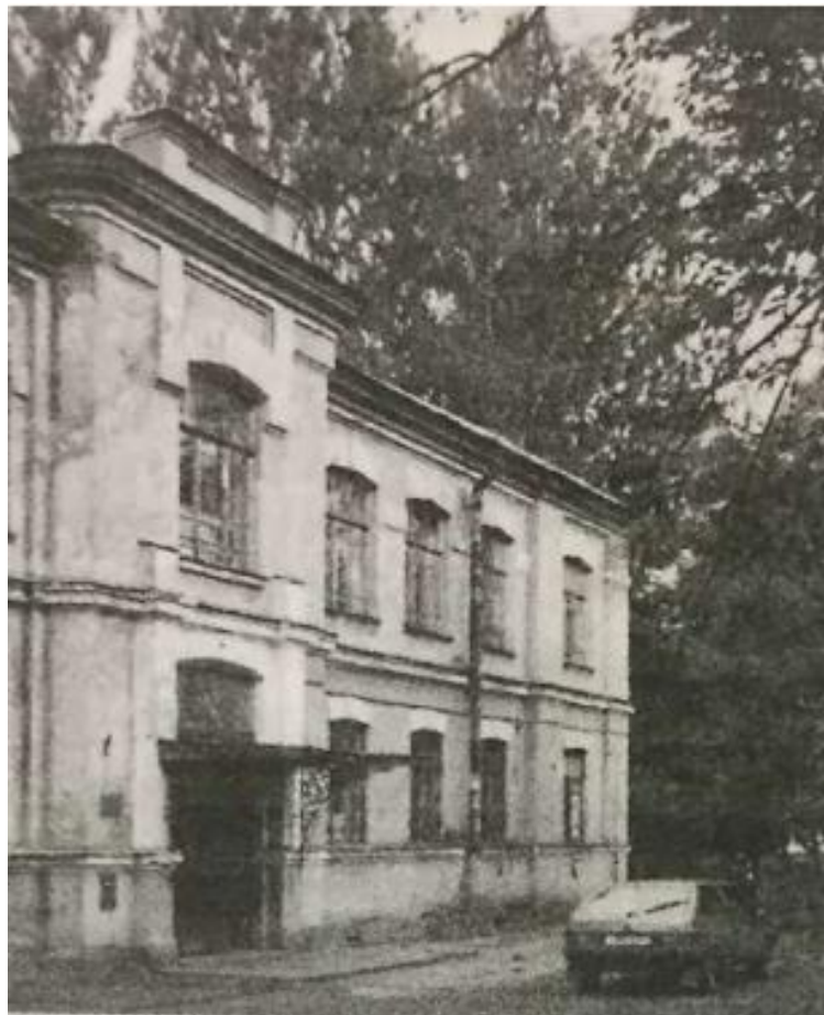
Илл.20. Здание Отхинского механико – технического училища училища. Фото до 2008 г (?). Источник: «Охта. Старейшая окраина Санкт-Петербурга». Наталья Столбова.
