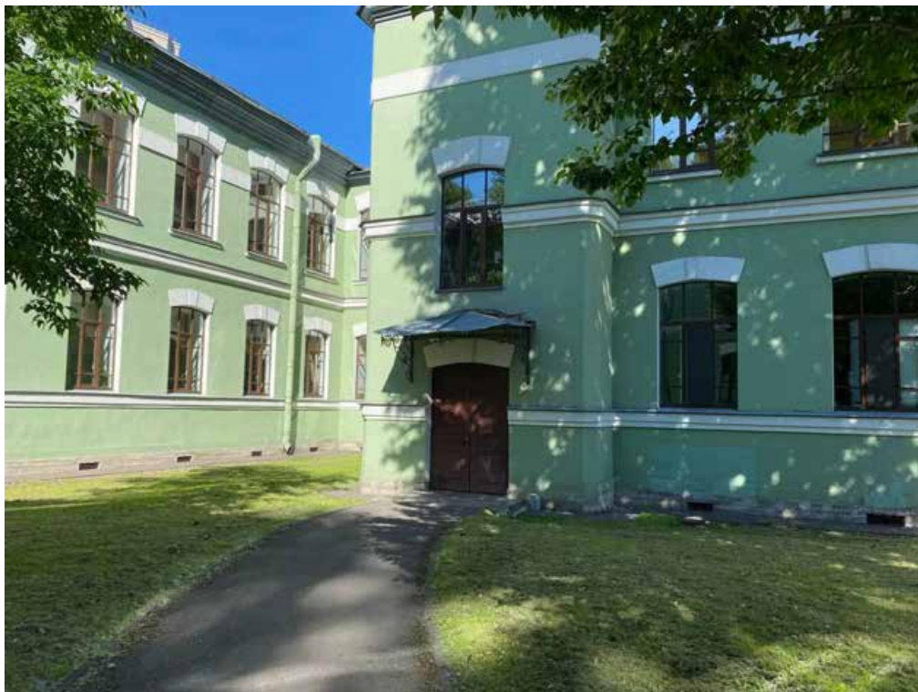
Фото №13. Юго-западный двор здания, западный фасад здания в осях Е-Д, вход в здание.
