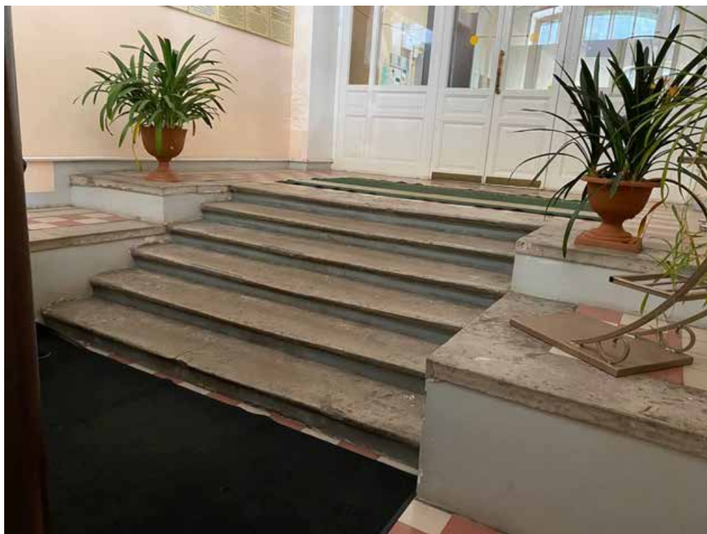
Фото №23. Лестница в парадном вестибюле.
