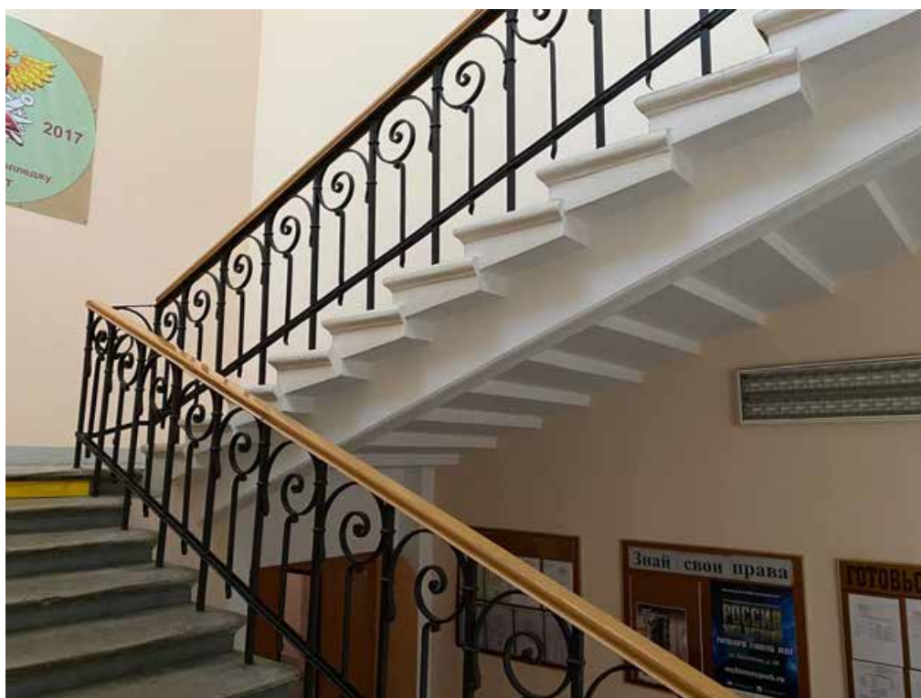
Фото №30. Главная лестница, ограждение.
