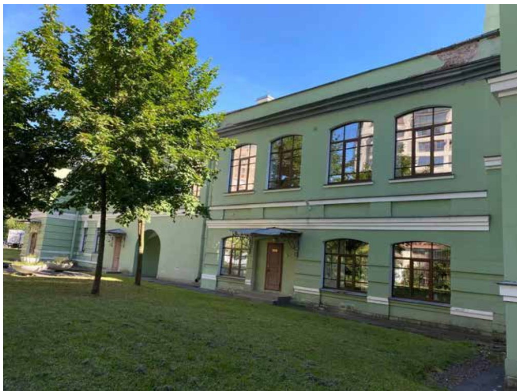
Фото №6. Северный фасад здания в осях 5-8.
