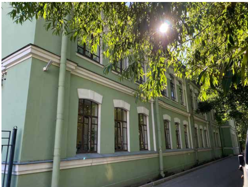
Фото №7. Северный фасад здания в осях 1-5.
