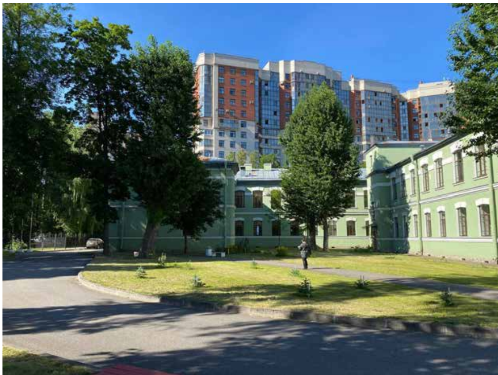
Фото №15. Общий вид юго-западного двора здания с южной стороны.
