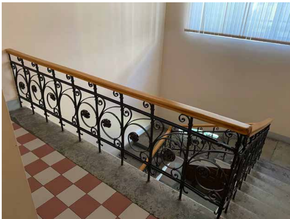
Фото №36. Лестница восточного корпуса в осях 7-8, площадка второго этажа, ограждения отреставрированы.
