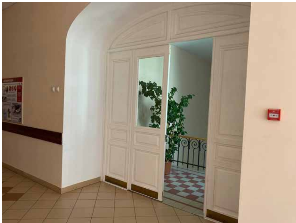
Фото №41. Главная лестница центрального корпуса, вид из вестибюля в осях Д-Е, историческое заполнение дверного проема.
