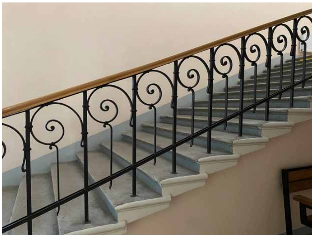
Фото №29. Ограждение главной лестницы, отреставрированы.
