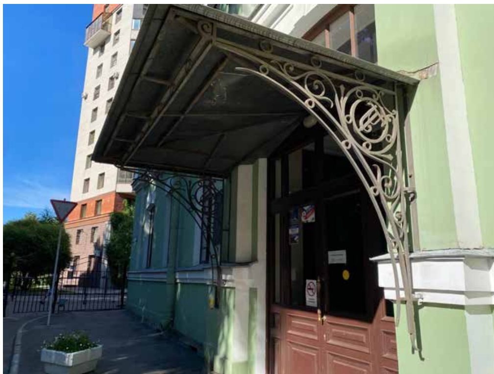
Фото №10. Исторический металлодекор козырек парадного входа.
