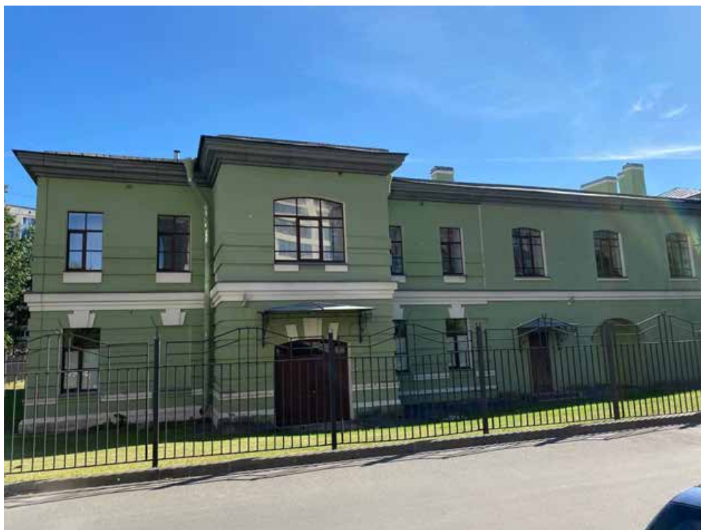
Фото №4. Северный фасад здания в осях 6-8.
