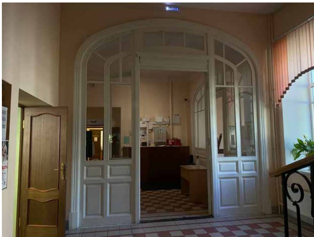
Фото №27. Парадный вестибюль, историческое заполнение дверных проемов, вид от главной лестницы.
