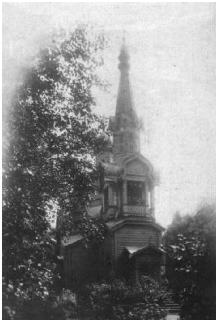
Илл.17. Церковь Александра Невского при Охтинском механико-техническом ремесленном училище XX в.
