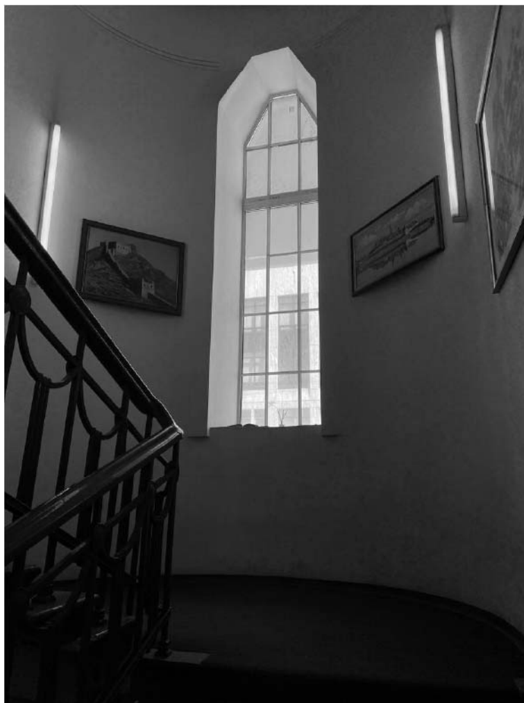
Фото №20. Оконный проем башнеобразного выступа.
