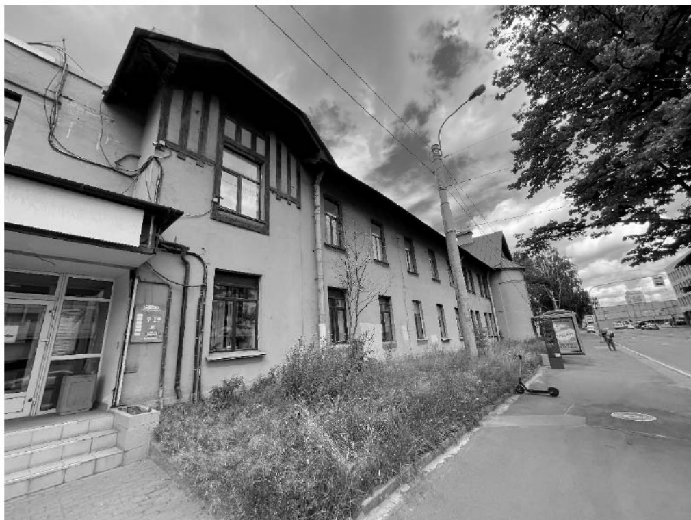
Фото №3. Северо-восточный лицевой фасад, вид от пристройки.
