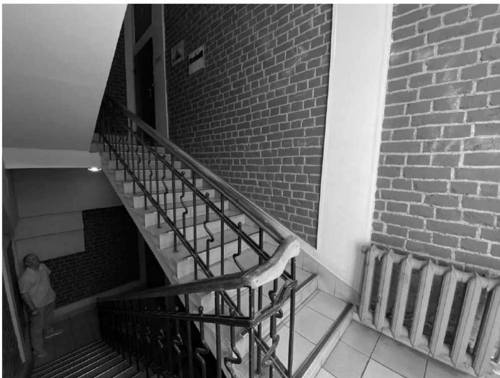
Фото №25. Лестница в южной части здания, вид с междуэтажной площадки.
