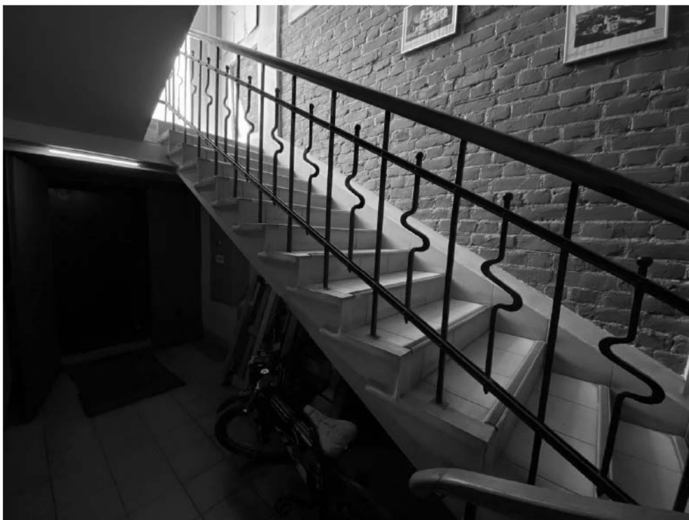
Фото №23. Лестница в южной части здания, вид с первого этажа.
