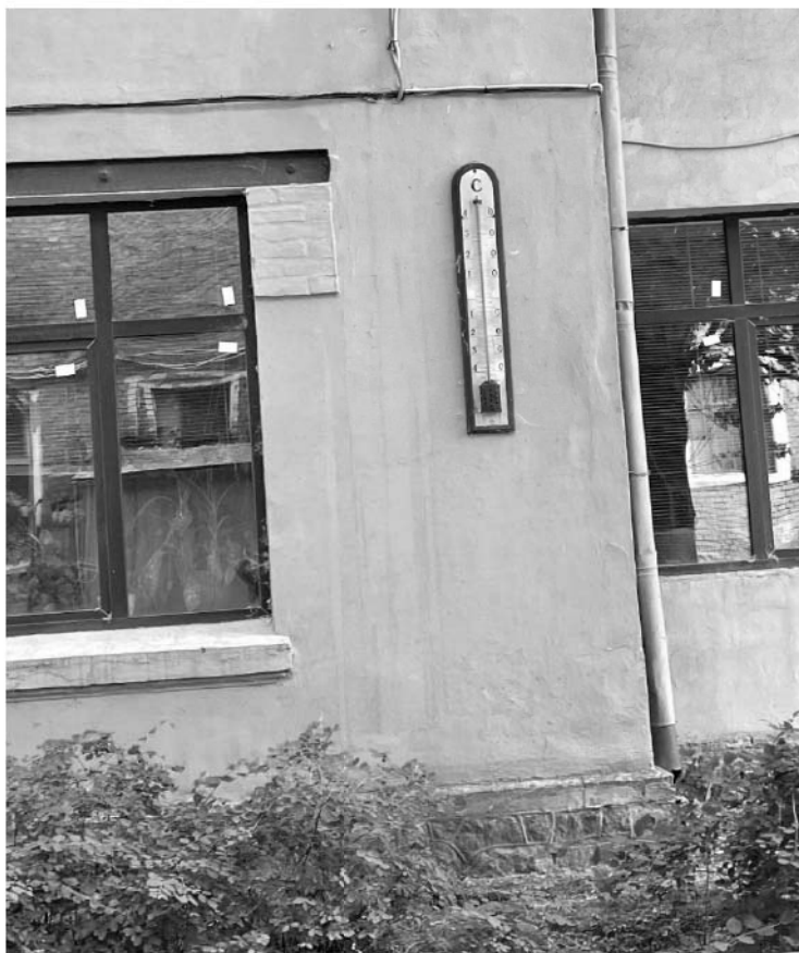
Фото №17. Металлическая перемычка из проката над окном дворового фасада.
