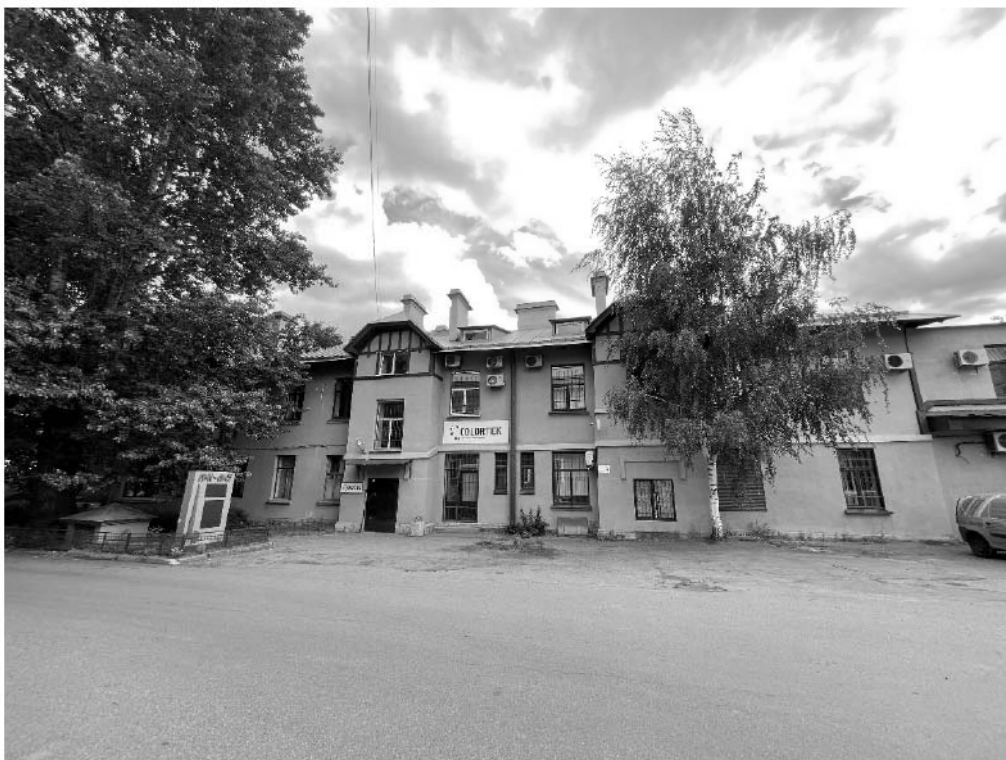
Фото №15. Северо-западный фасад здания, вид с дворовой территории.
