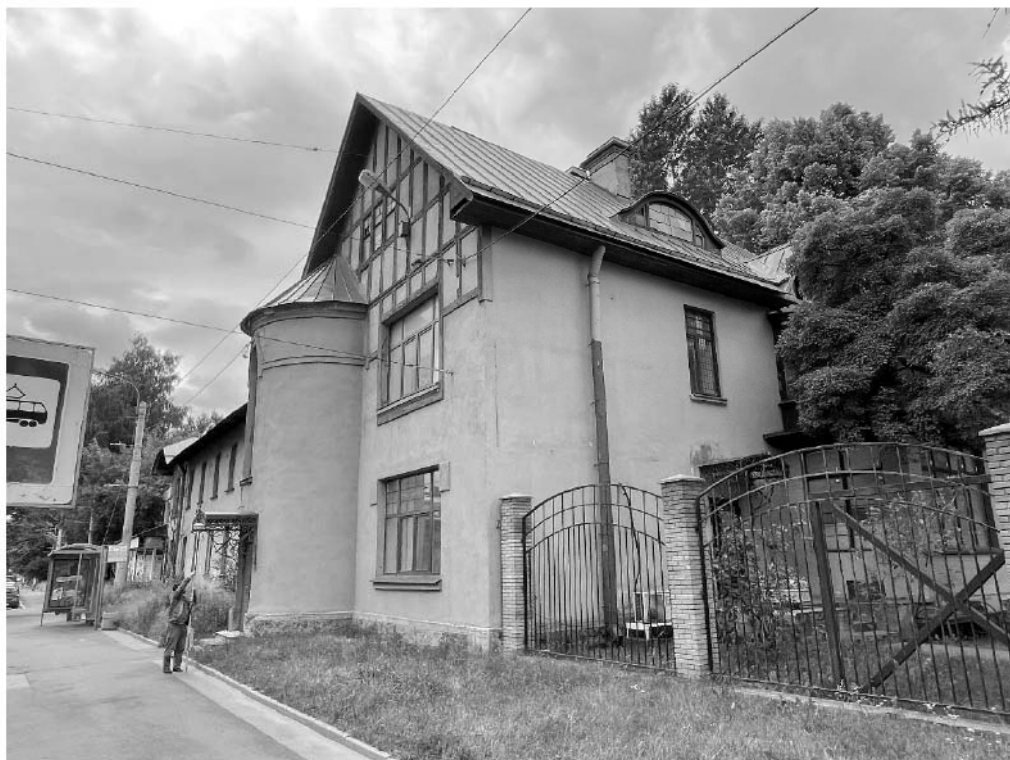
Фото №9. Северо-восточный лицевой и северный фасады.
