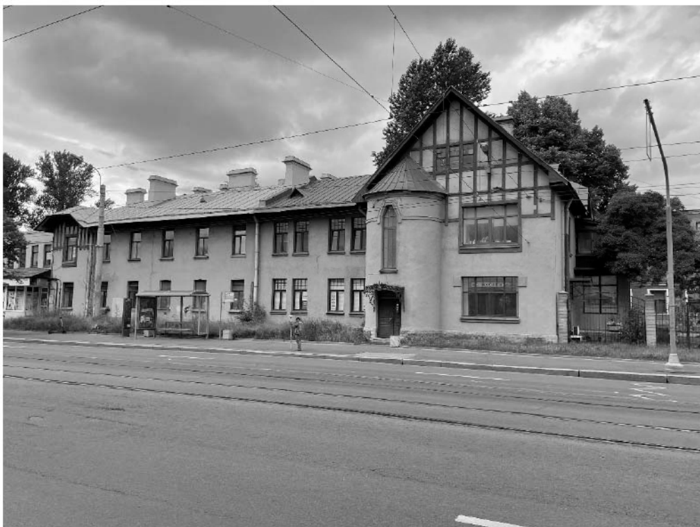
Фото №1. Северо-восточный лицевой фасад здания, вид с Новочеркасского проспекта.
