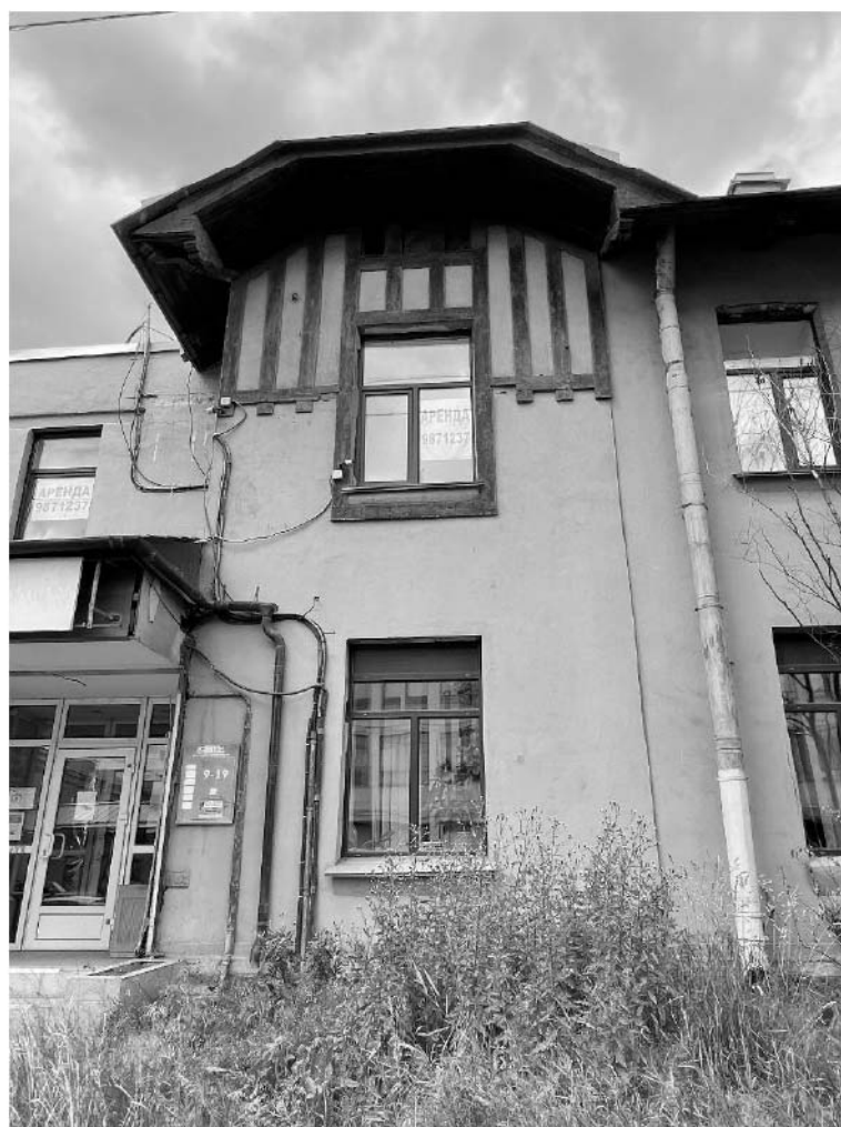
Фото №4. Фрагмент северо-восточного лицевого фасада.
