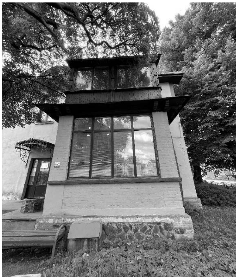
Фото №12. Северный фасад здания, остекленная веранда.
