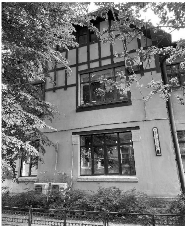
Фото №18. Дворовый фасад здания, фронтон с отделкой фахверком, оформление перемычки над окном 1-го этажа.
