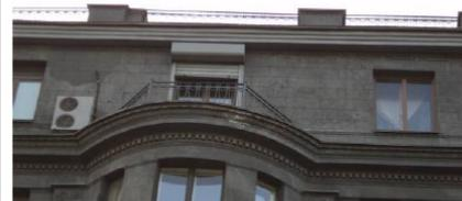
три балкона – в завершении эркеров – конфигурация, местоположение, габариты, ограждение – материал (металл), техника исполнения (литье), рисунок;
