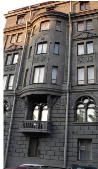
четыре балкона – в основании эркеров и на скругленном углу фасадов – конфигурация, местоположение, габариты, ограждение – материал (штукатурка), рисунок;
